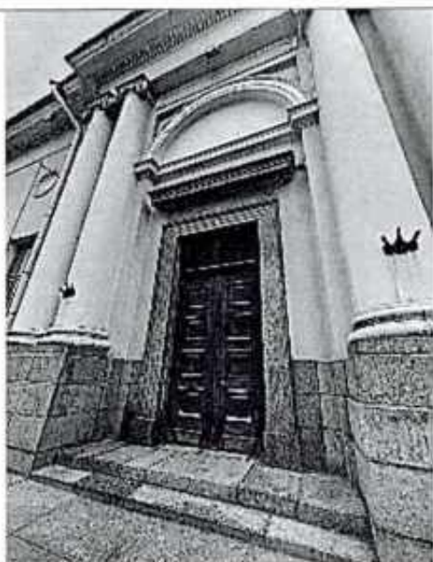
Фото 4. Фрагмент портала (по Инженерной ул.)
