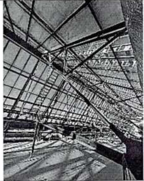
Фото 13. Фрагмент конструкций светового фонаря
