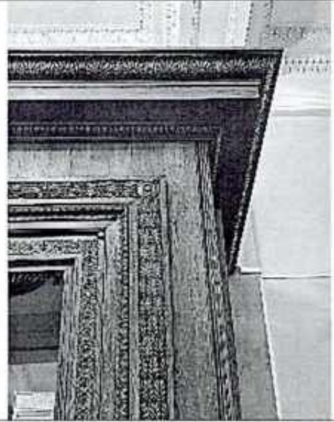
Фото 17. Фрагмент интерьера. Тамбур
