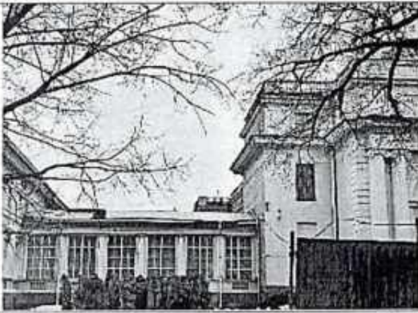
Фото 10. Фрагмент фасада с галереей
