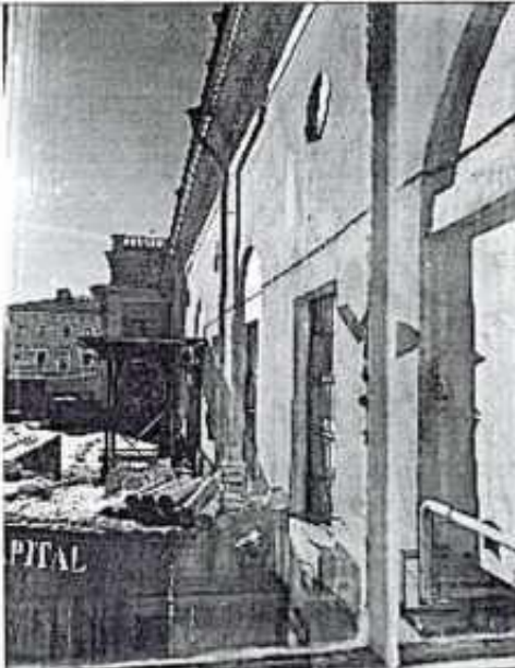
Фото 12. Фрагмент дворового фасада
