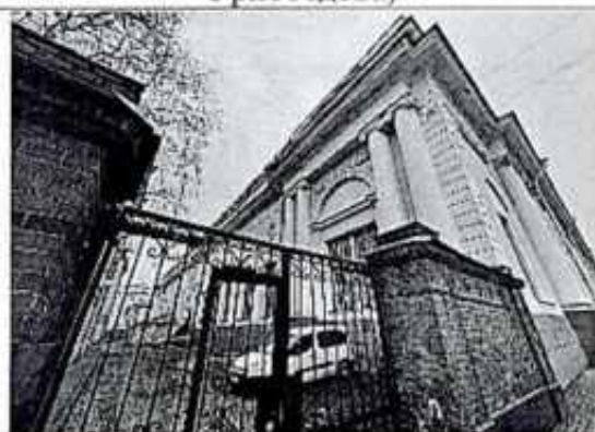
Фото 8. Фрагмент фасада во внутреннем дворе
