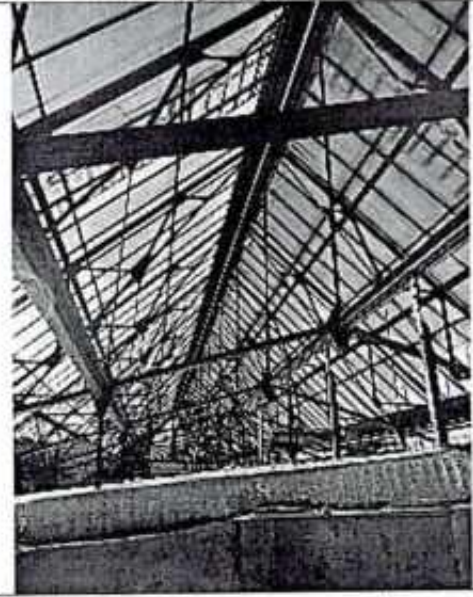
Фото 15. Фрагмент конструкций светового фонаря
