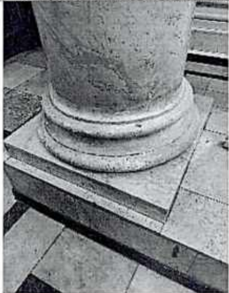
Фото 18. Фрагмент интерьера. База колонны
