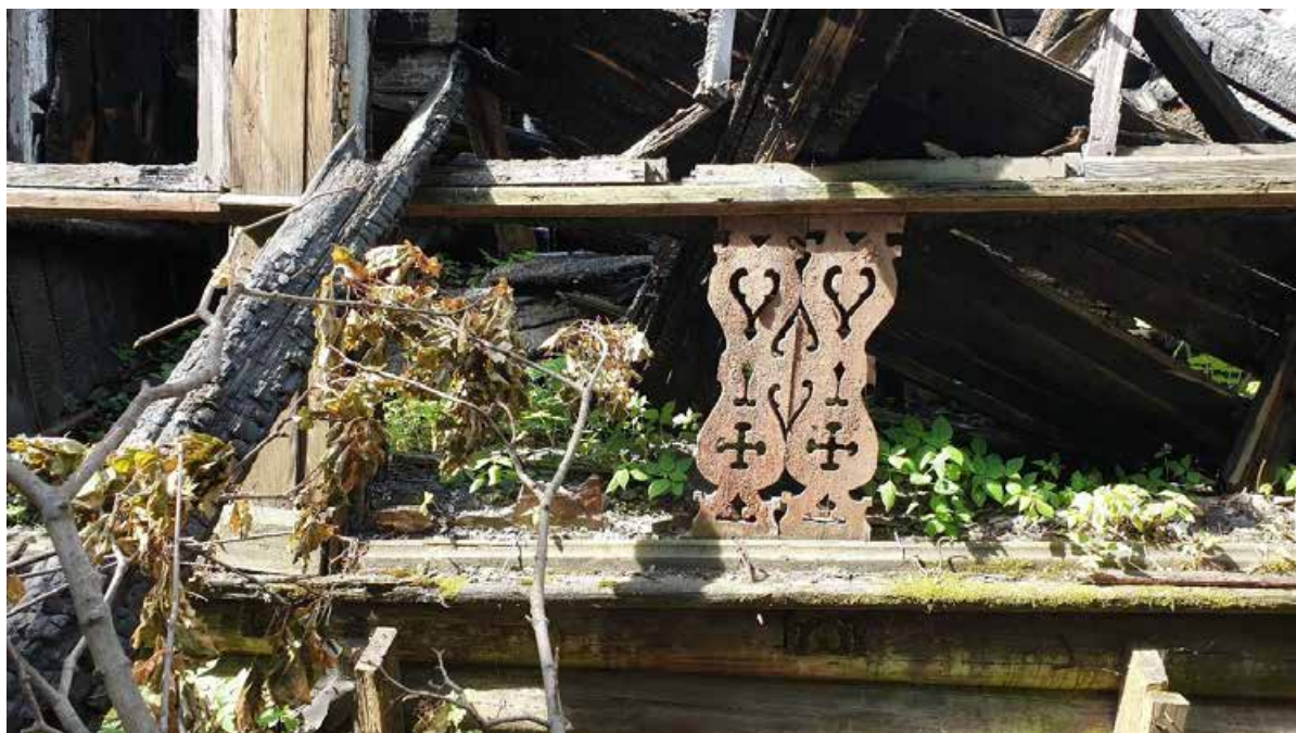
28. ОКН РЗ «Дача Гербель» по адресу: г. Санкт-Петербург, ул. Межозёрная, дом 4, литера А. Фрагмент декоративной панели. Дата съёмки: 19.06.2019 г.
