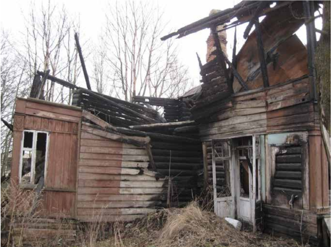
11. ОКН РЗ «Дача Гербель» по адресу: г.Санкт-Петербург, ул. Межозёрная, дом 4, литера А. Северный фасад. Дата съёмки: 06.04.2016 г.
