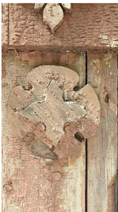
34. ОКН РЗ «Дача Гербель» по адресу: г. Санкт-Петербург, ул. Межозёрная, дом 4, литера А. Фрагмент декоративной панели. Дата съёмки: 19.06.2019 г.
