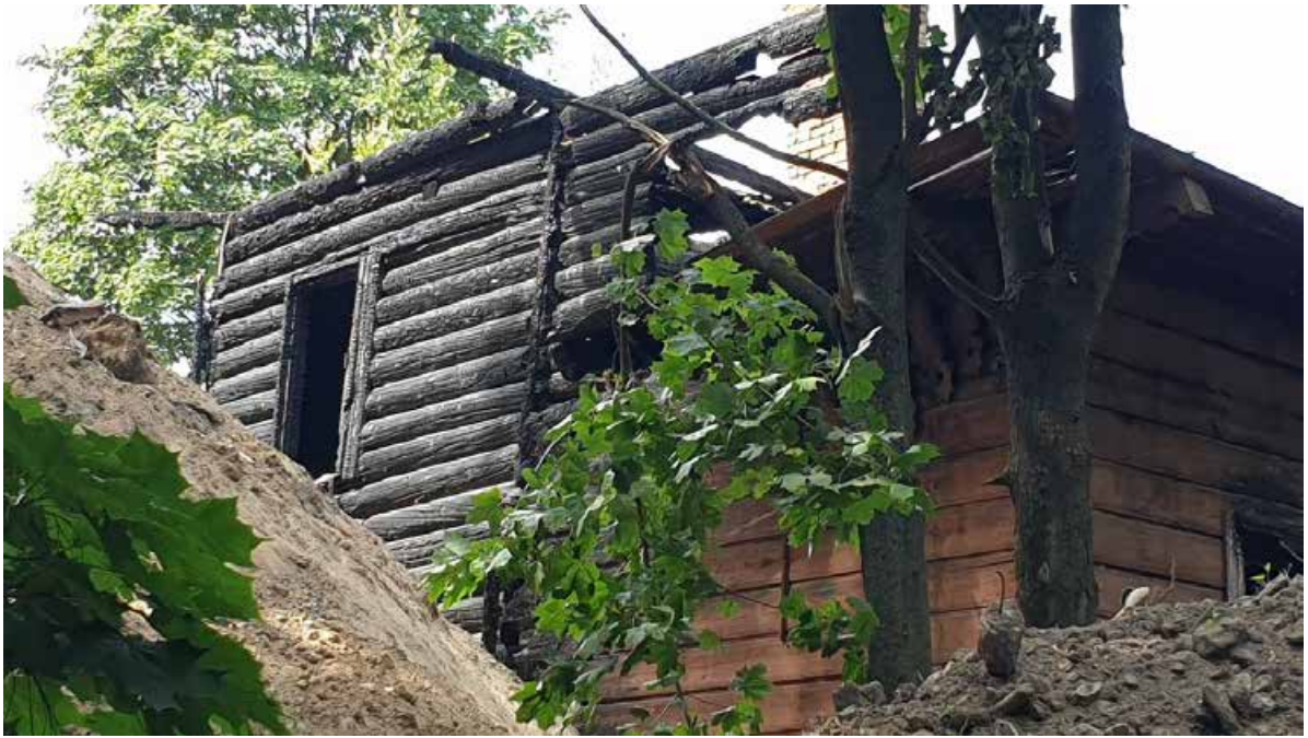
37. ОКН РЗ «Дача Гербель» по адресу: г. Санкт-Петербург, ул. Межозёрная, дом 4, литера А. Западный фасад. Дата съёмки: 19.06.2019 г.
