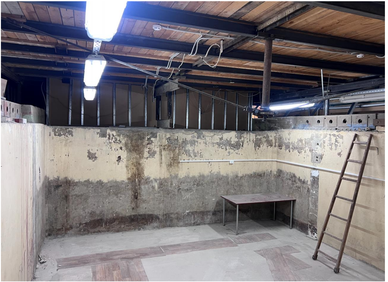
Фото 13. Объект культурного наследия регионального значения «Гидротехнический институт им. Б.Е. Веденеева (лицевой корпус с примыкающими дворовыми флигелями)», расположенный по адресу: Санкт-Петербург, Гжатская д. 21, лит. А. Помещение 143. Съёмка 01.04.2026 г.
