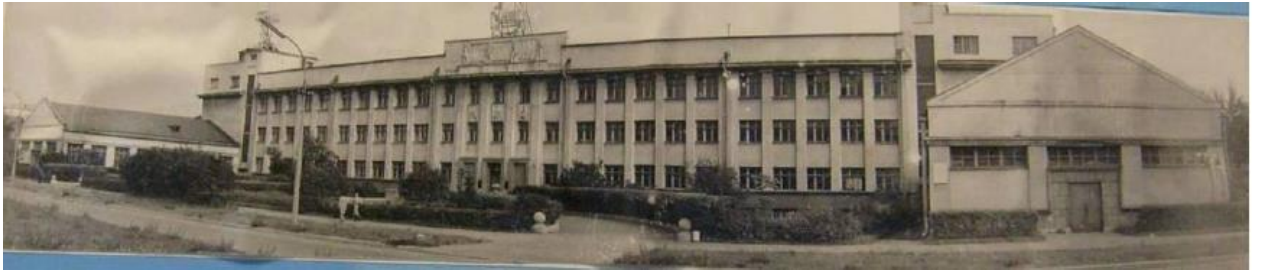
34. ВНИИГ им. Веденеева. Лицевой корпус. Фото 1971 г. По материалам музея ОАО ВНИИГ им. Б.Е. Веденеева
