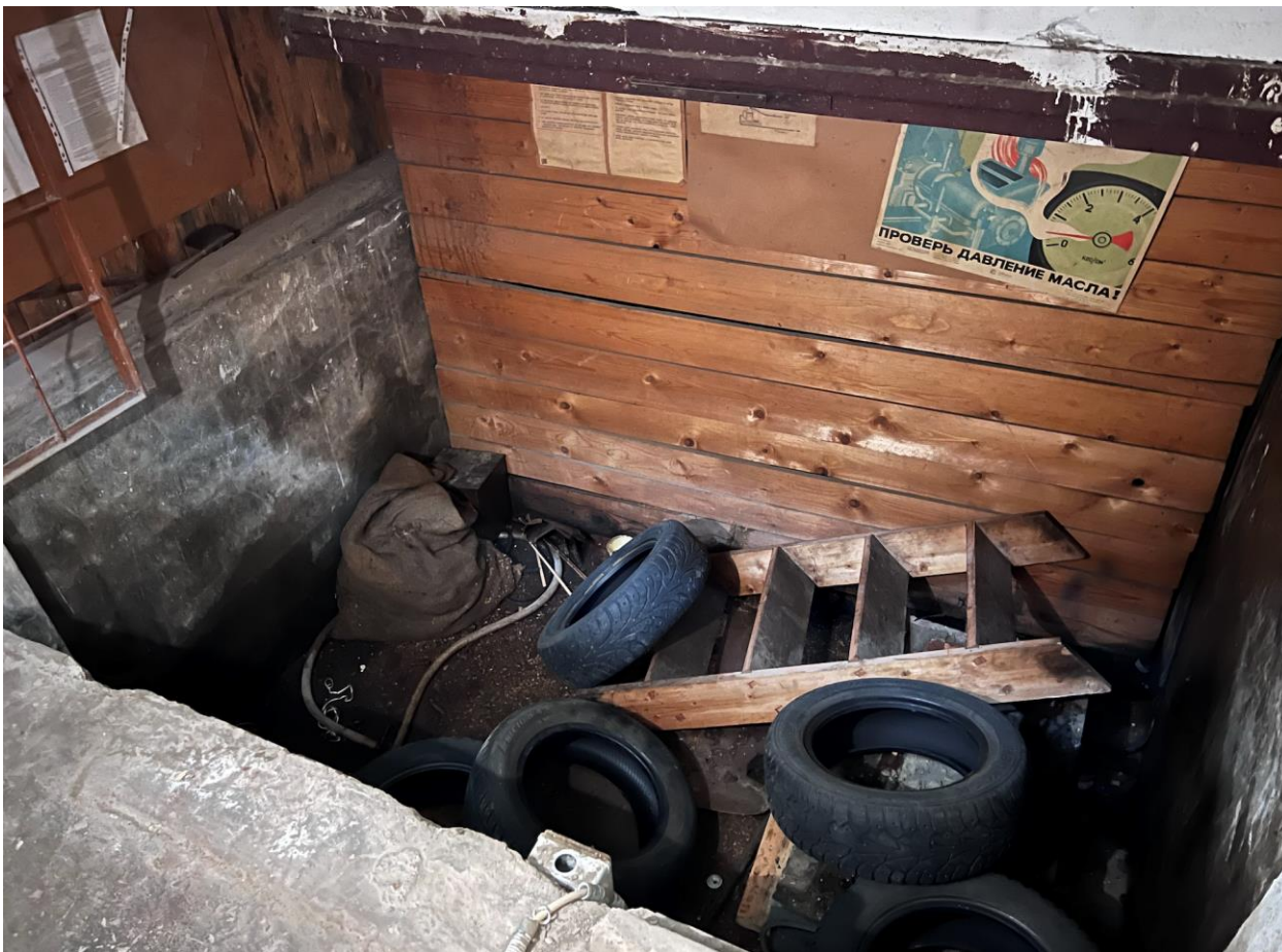
Фото 8. Объект культурного наследия регионального значения «Гидротехнический институт им. Б.Е. Веденеева (лицевой корпус с примыкающими дворовыми флигелями)», расположенный по адресу: Санкт-Петербург, Гжатская д. 21, лит. А. Помещение 143. Съёмка 01.04.2026 г.
