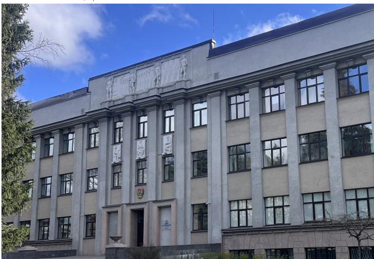
Фото 1. Объект культурного наследия регионального значения «Гидротехнический институт им. Б.Е. Веденеева (лицевой корпус с примыкающими дворовыми флигелями)», расположенный по адресу: Санкт-Петербург, Гжатская д. 21, лит. А. Лицевой фасад. Фрагмент. Съёмка 01.04.2026 г.
