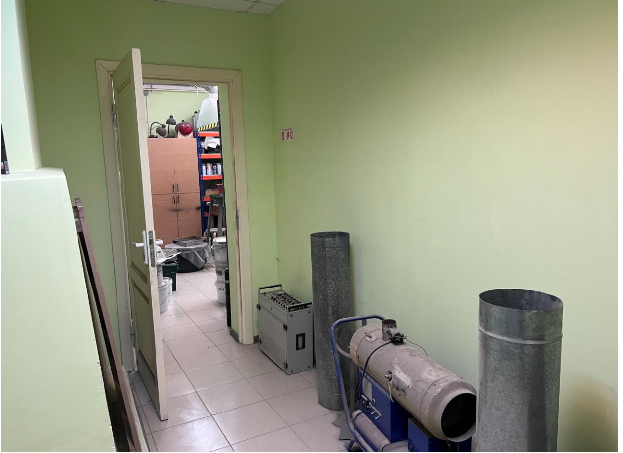
Фото 20. Объект культурного наследия регионального значения «Гидротехнический институт им. Б.Е. Веденеева (лицевой корпус с примыкающими дворовыми флигелями)», расположенный по адресу: Санкт-Петербург, Гжатская д. 21, лит. А. Помещение 140. Съёмка 01.04.2026 г.
