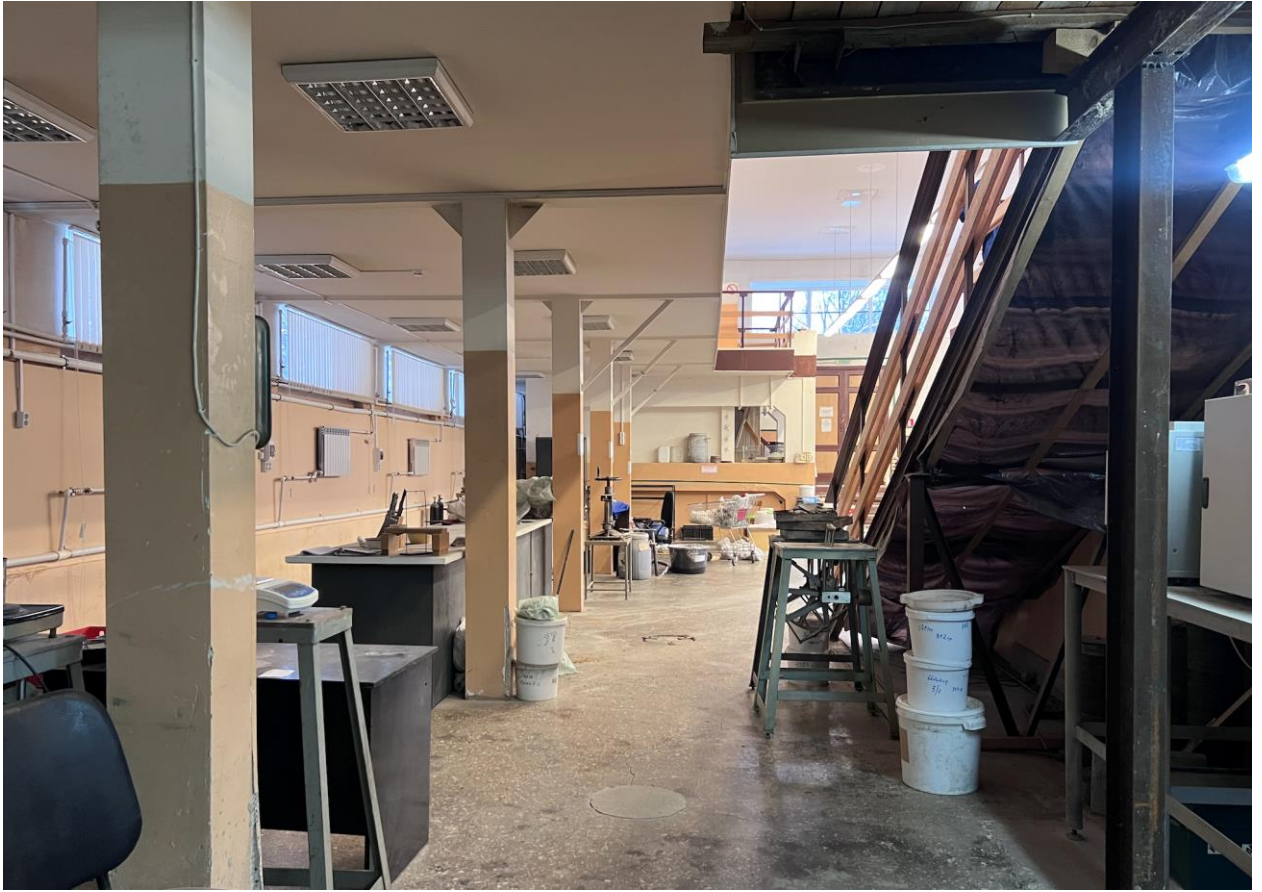
Фото 9. Объект культурного наследия регионального значения «Гидротехнический институт им. Б.Е. Веденеева (лицевой корпус с примыкающими дворовыми флигелями)», расположенный по адресу: Санкт-Петербург, Гжатская д. 21, лит. А. Помещение 143. Съёмка 01.04.2026 г.
