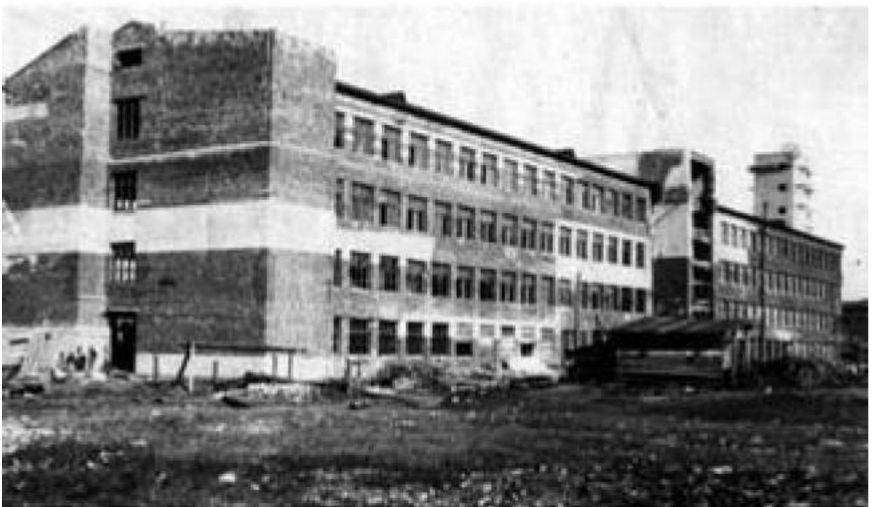
60. Учебный корпус в процессе строительства. 1934 г.
