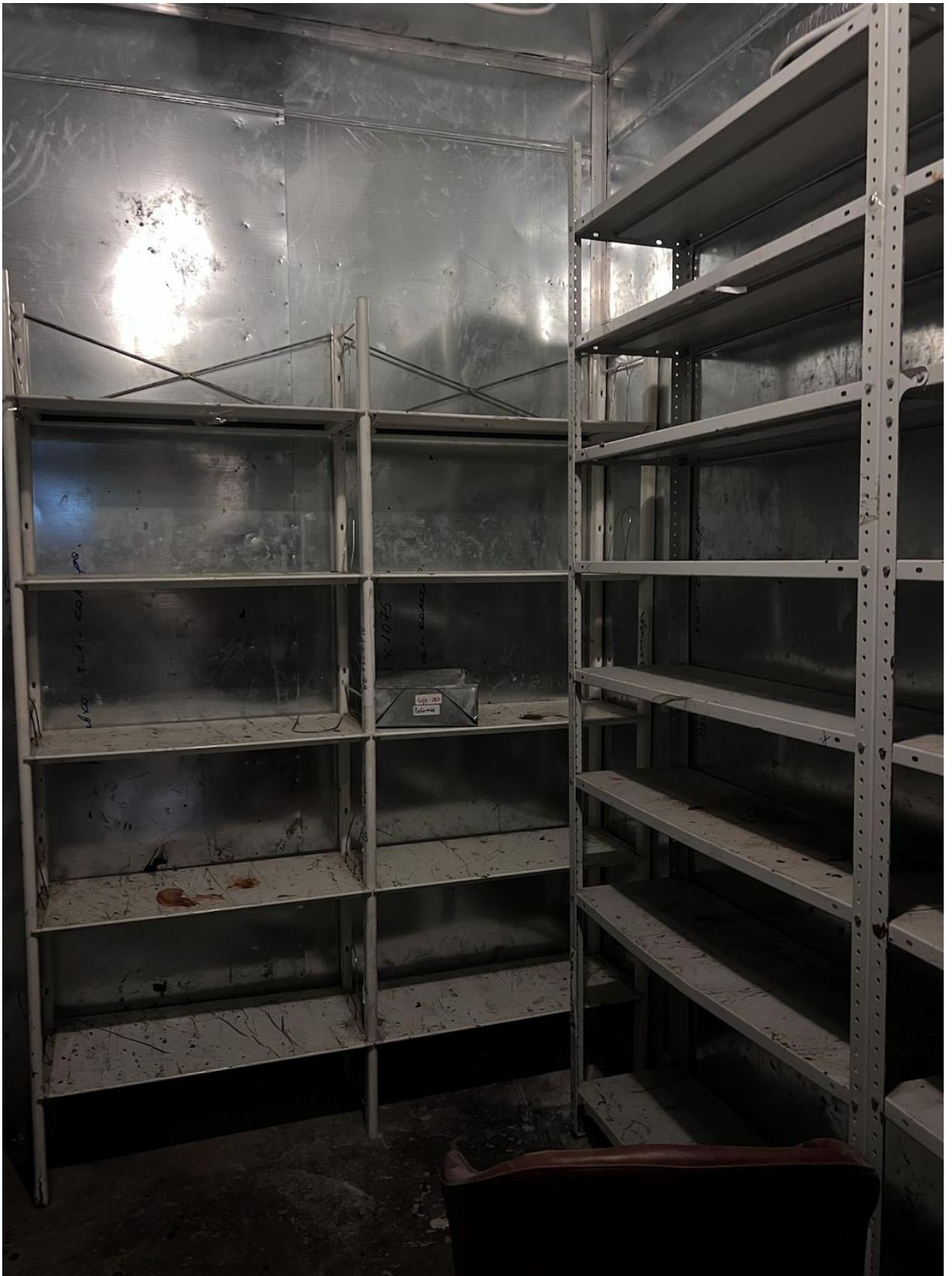
Фото 16. Объект культурного наследия регионального значения «Гидротехнический институт им. Б.Е. Веденеева (лицевой корпус с примыкающими дворовыми флигелями)», расположенный по адресу: Санкт-Петербург, Гжатская д. 21, лит. А. Помещение 146. Съёмка 01.04.2026 г.
