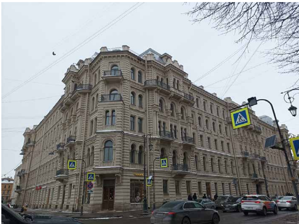
Фото 5. Северный и восточный фасады.
