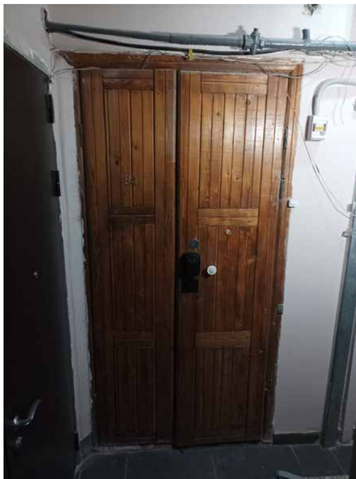
Фото 16. Входная дверь в квартиру № 84.
