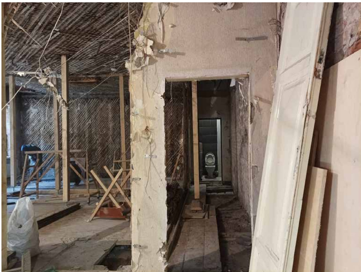
Фото 22. Помещения 3,4,6. Вид на помещение 5.
