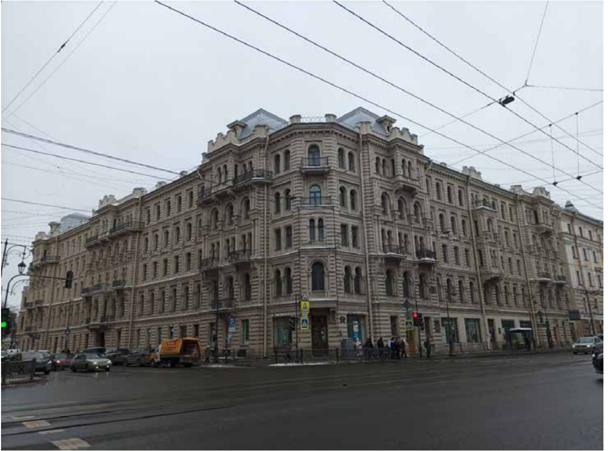
Фото 1. Западный и северный фасады.
