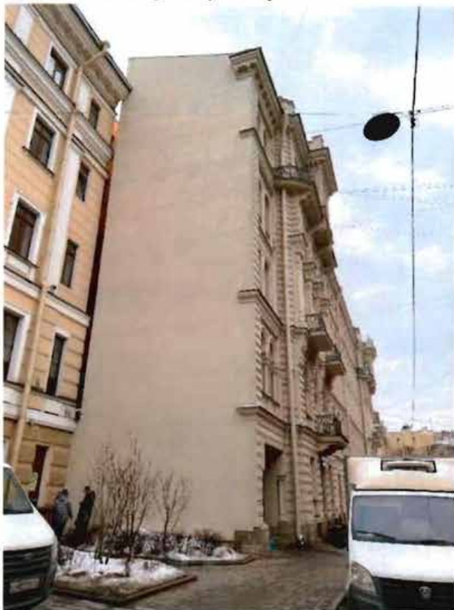
4. Вид на брандмауэрный фасад культурного наследия со стороны ул. Короленко.
