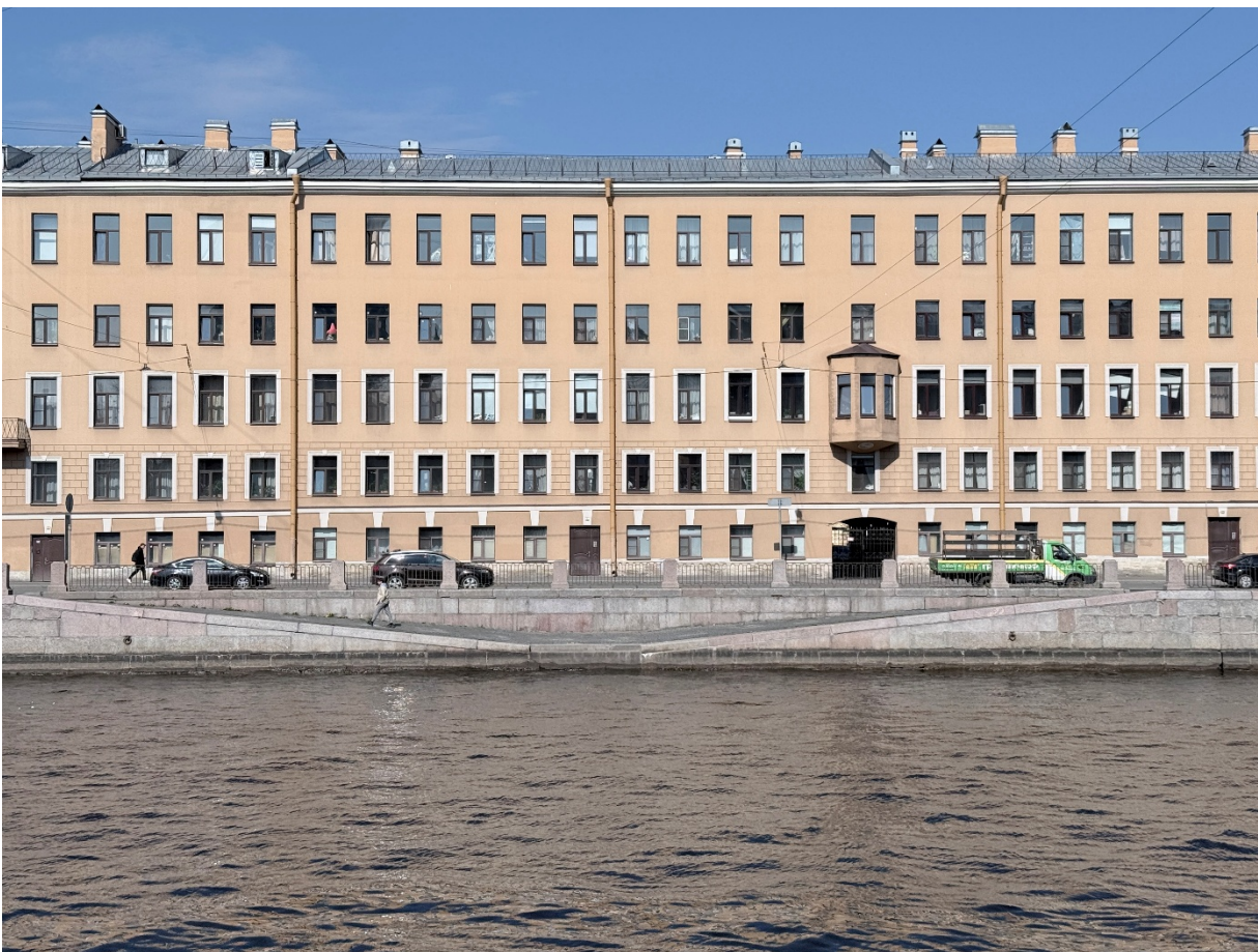
Фото 1. Общий вид на часть объекта культурного наследия федерального значения «Набережные и мосты реки Фонтанки» в границах проектирования.
