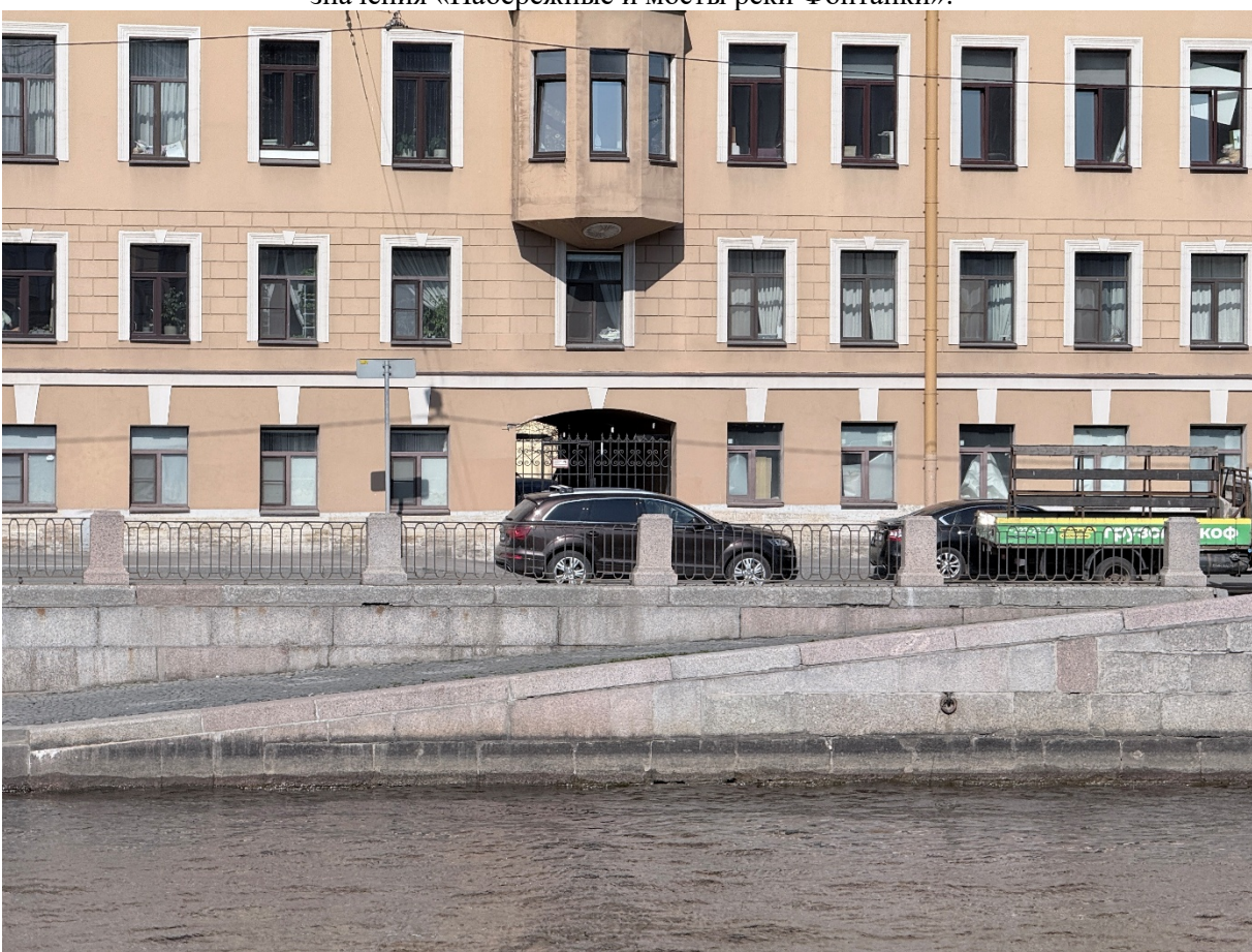
Фото 4. Общий вид на спуск № 13 в границах объекта культурного наследия федерального значения «Набережные и мосты реки Фонтанки».
