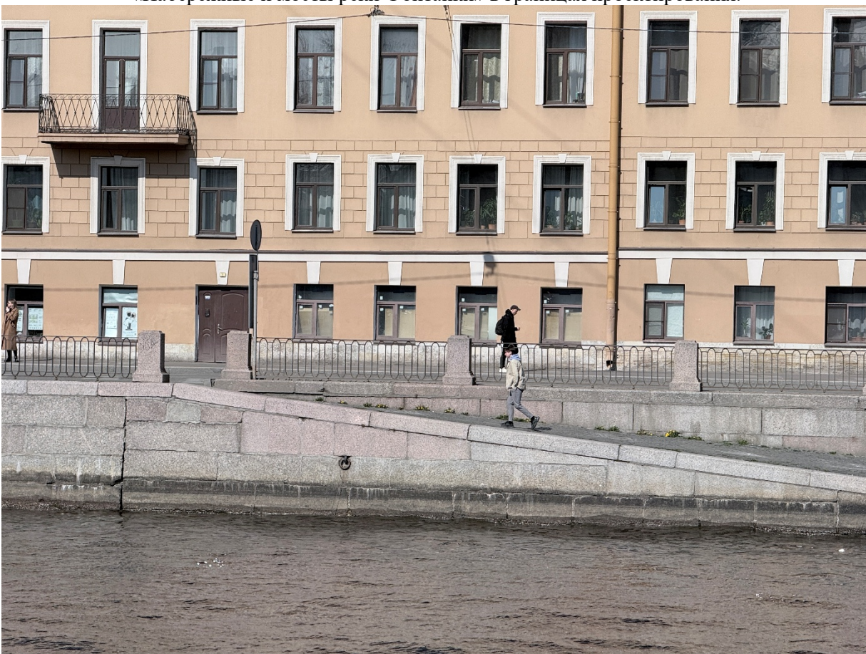
Фото 2. Общий вид на спуск № 13 в границах объекта культурного наследия федерального значения «Набережные и мосты реки Фонтанки».
