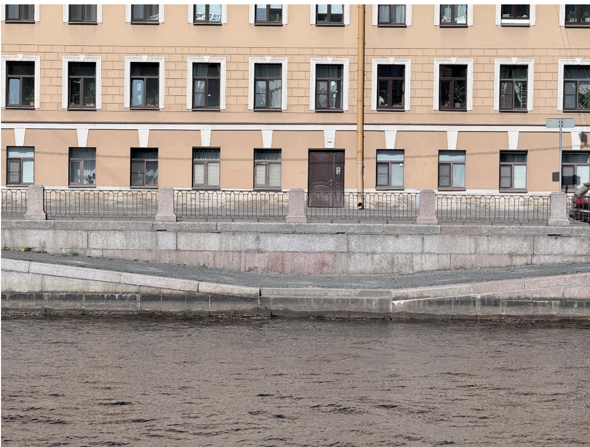
Фото 3. Общий вид на спуск № 13 в границах объекта культурного наследия федерального значения «Набережные и мосты реки Фонтанки».
