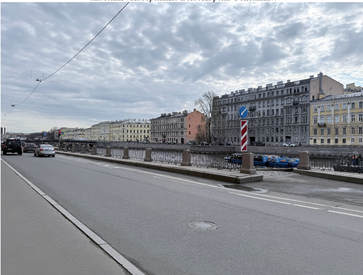
Фото 12. Общий вид на спуск № 13 в границах объекта культурного наследия федерального значения «Набережные и мосты реки Фонтанки».
