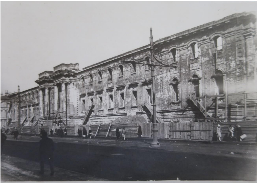
31. Сектор хранения документированной информации (архив) КГИОП. Фото №24084. Окружной суд после пожара. Ведется разборка здания.
