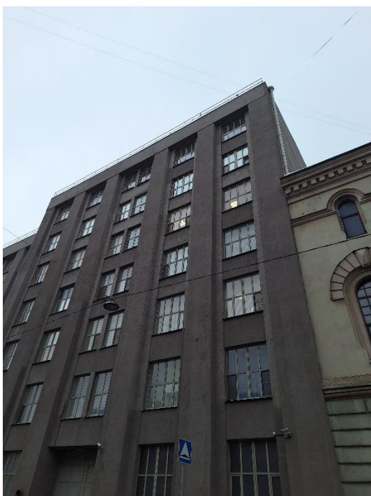
14. «Административное здание», Литейный проспект, дом 4, литера А. Южный фасад. Фрагмент. Фото 20.03.2026г.
