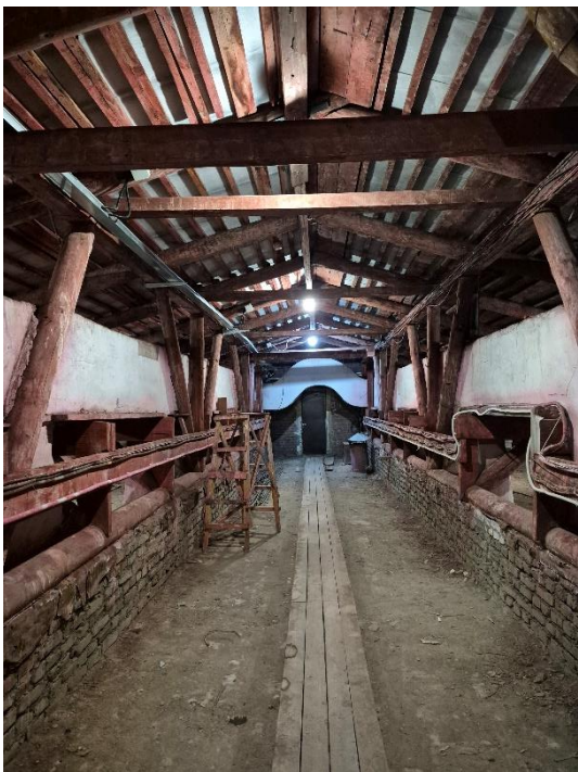
31. «Административное здание», Литейный проспект, дом 4, литера А. Чердак. Общий вид. Фото 20.03.2026г.
