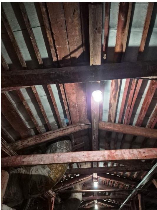
32. «Административное здание», Литейный проспект, дом 4, литера А. Чердак. Общий вид. Фото 20.03.2026г.
