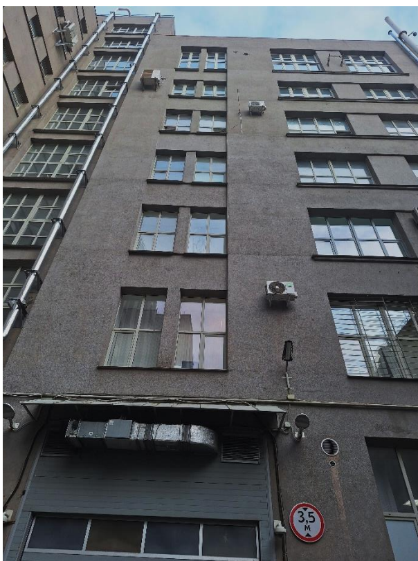
26. «Административное здание», Литейный проспект, дом 4, литера А. Дворовый фасад. Общий вид. Фото 20.03.2026г.
