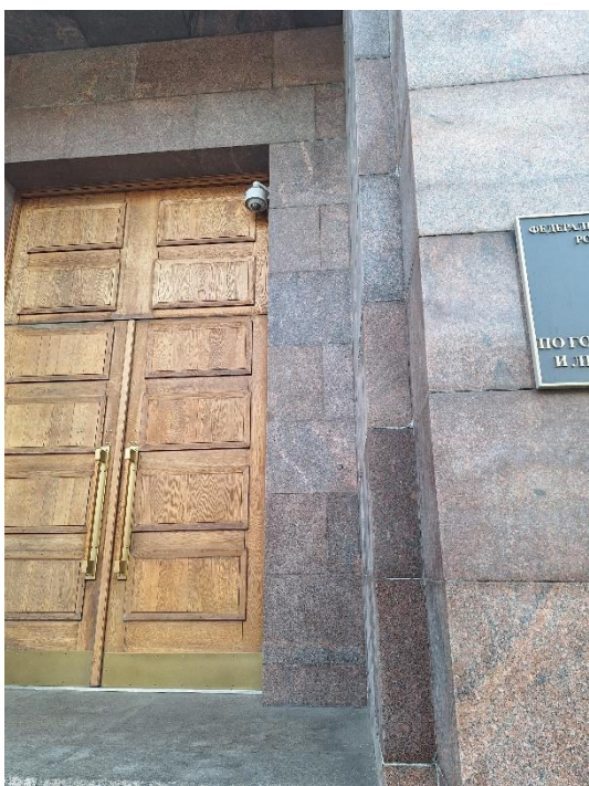
10. «Административное здание», Литейный проспект, дом 4, литера А. Западный фасад. Фрагмент. Фото 20.03.2026г.
