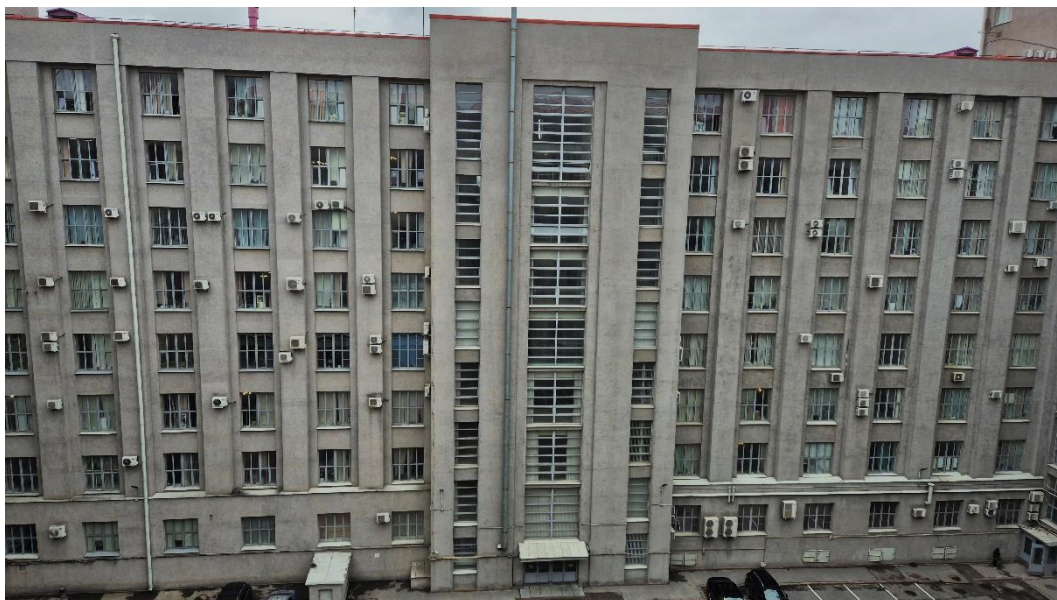
22. «Административное здание», Литейный проспект, дом 4, литера А. Дворовый фасад. Общий вид. Фото 20.03.2026г.
