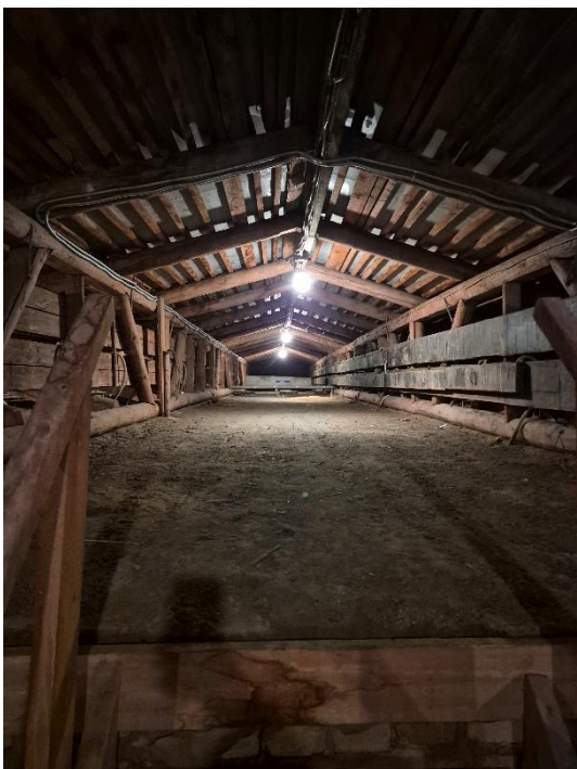
28. «Административное здание», Литейный проспект, дом 4, литера А. Чердак. Общий вид. Фото 20.03.2026г.
