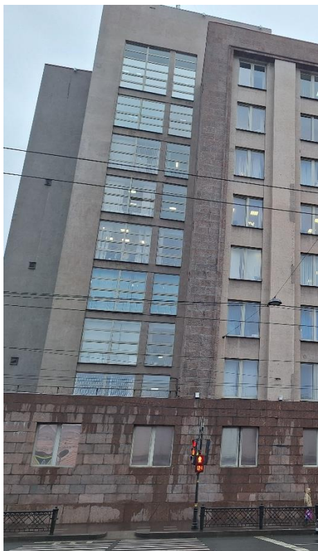
4. «Административное здание», Литейный проспект, дом 4, литера А. Западный фасад. Фрагмент. Фото 20.03.2026г.
