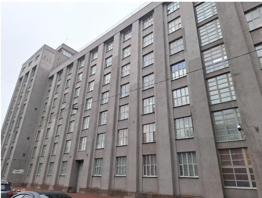
13. «Административное здание», Литейный проспект, дом 4, литера А. Южный фасад. Фрагмент. Фото 20.03.2026г.
