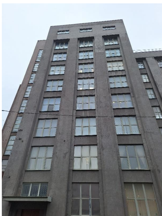
12. «Административное здание», Литейный проспект, дом 4, литера А. Южный фасад. Фрагмент. Фото 20.03.2026г.
