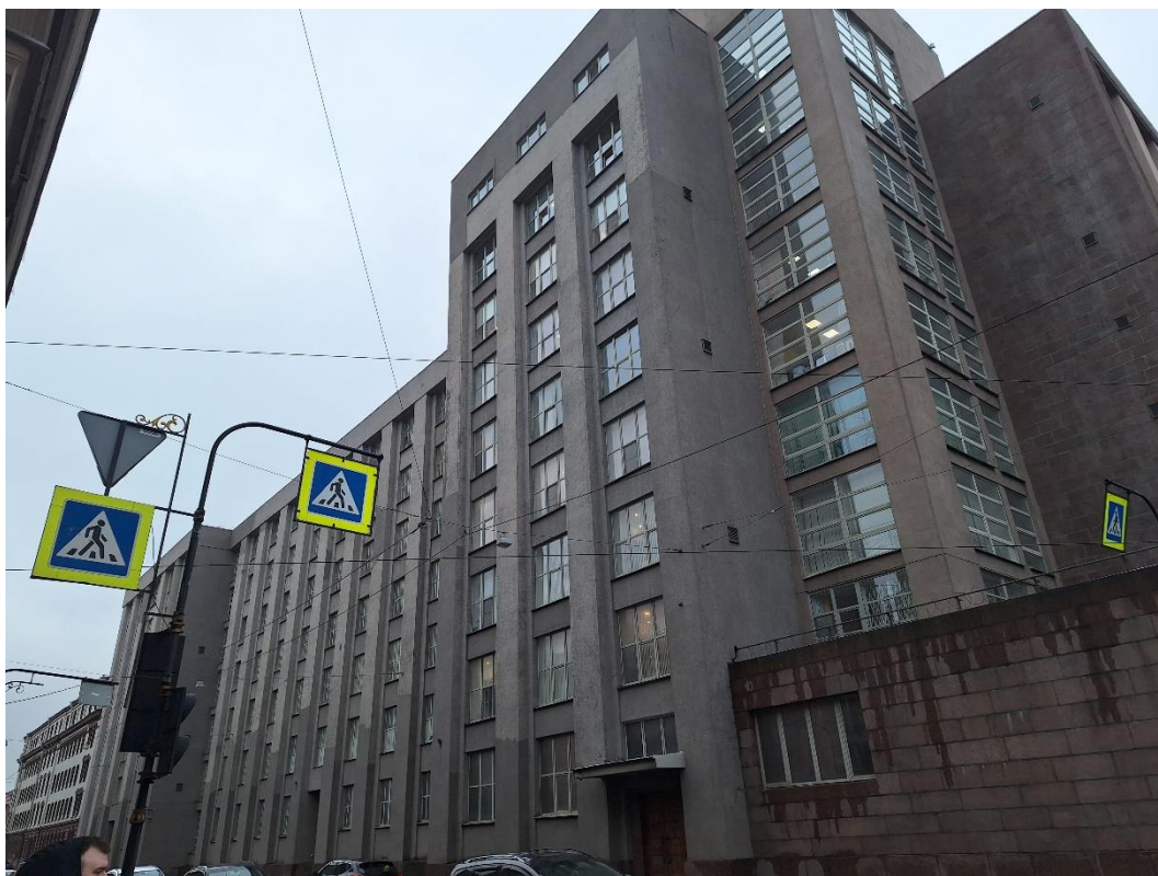
3. «Административное здание», Литейный проспект, дом 4, литера А. Северный фасад. Общий вид. Фото 20.03.2026г.
