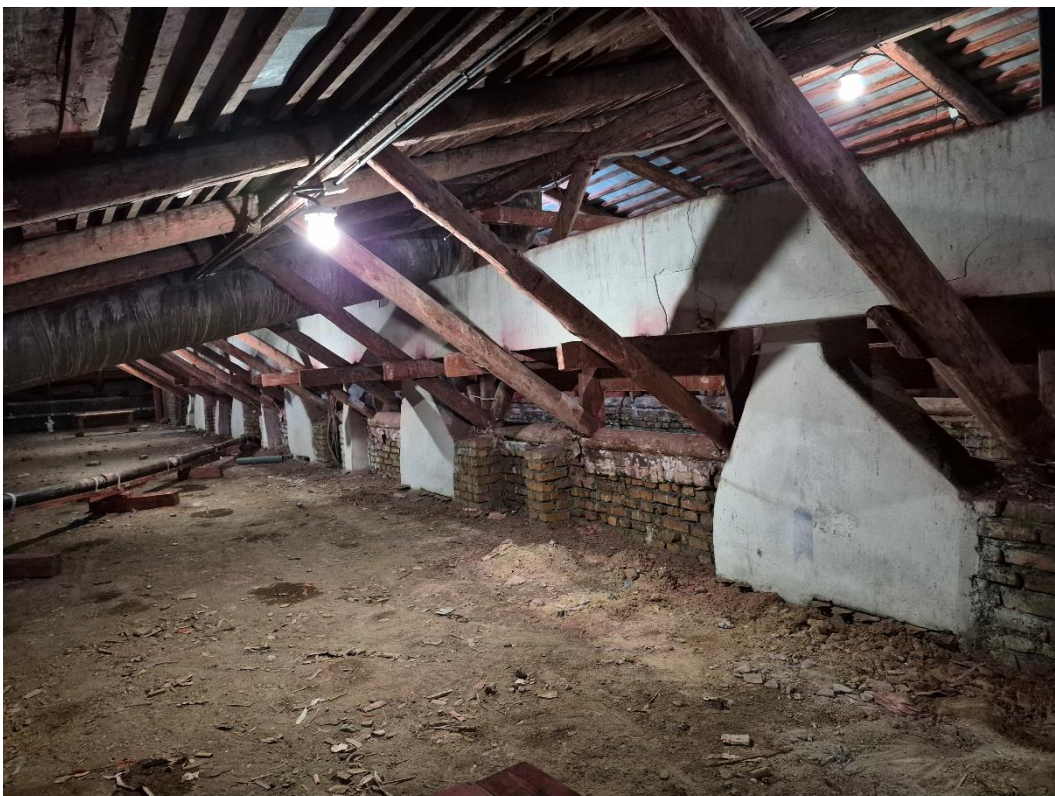
30. «Административное здание», Литейный проспект, дом 4, литера А. Чердак. Общий вид. Фото 20.03.2026г.
