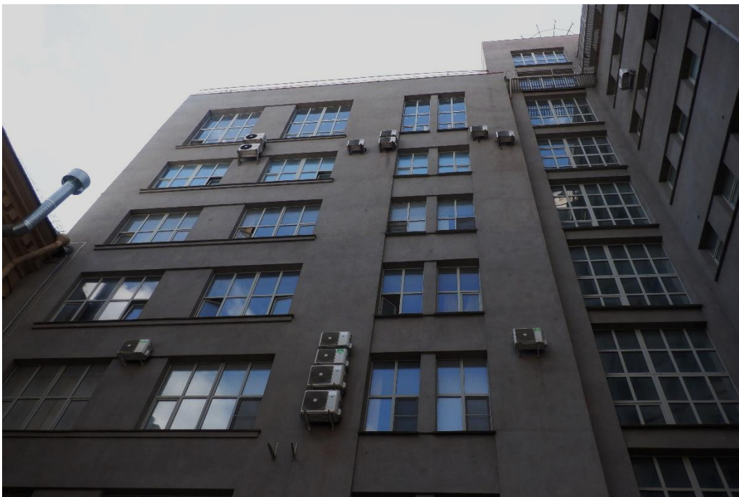
27. «Административное здание», Литейный проспект, дом 4, литера А. Дворовый фасад. Общий вид. Фото 20.03.2026г.
