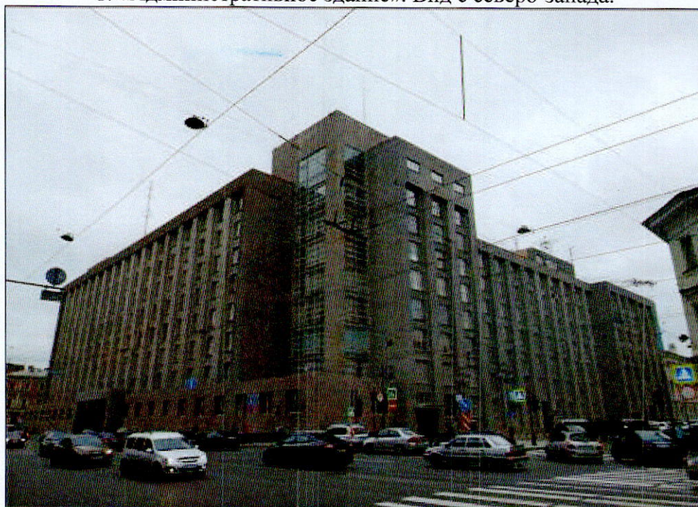
2. «Административное здание». Вид с юго-запада.
