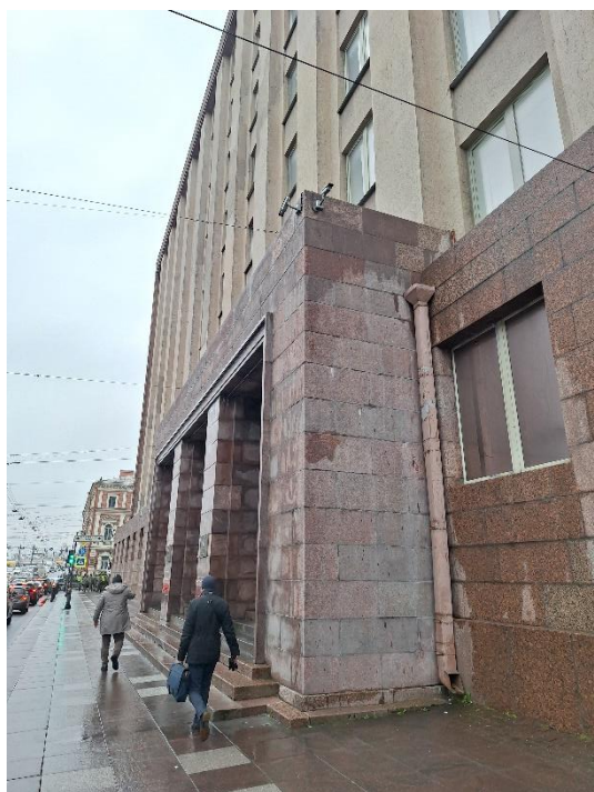
8. «Административное здание», Литейный проспект, дом 4, литера А. Западный фасад. Фрагмент. Фото 20.03.2026г.
