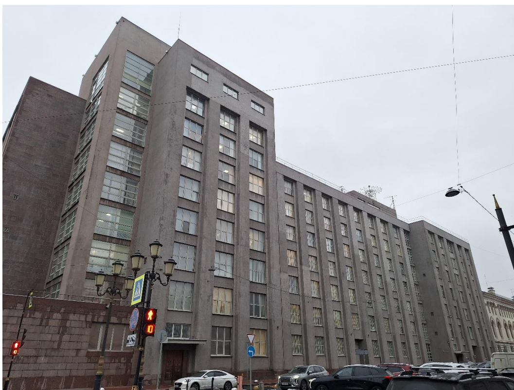
2. «Административное здание», Литейный проспект, дом 4, литера А. Южный фасад. Общий вид. Фото 20.03.2026г.
