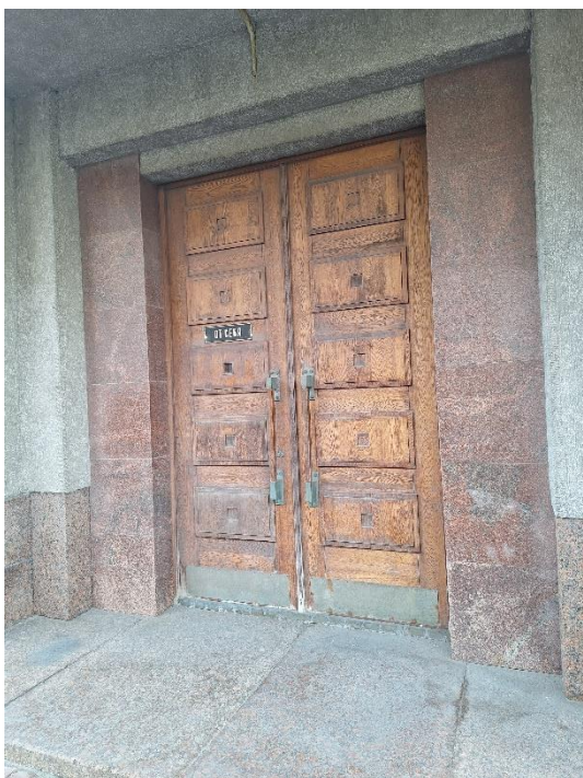
15. «Административное здание», Литейный проспект, дом 4, литера А. Южный фасад. Фрагмент. Фото 20.03.2026г.
