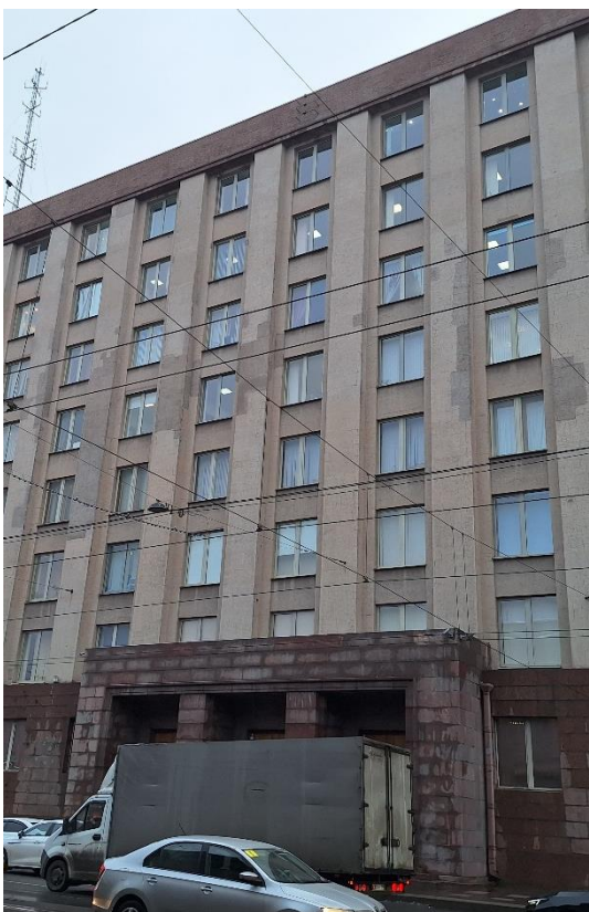
6. «Административное здание», Литейный проспект, дом 4, литера А. Западный фасад. Фрагмент. Фото 20.03.2026г.
