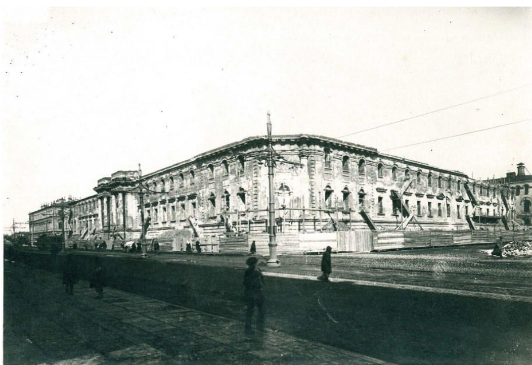
30. Сектор хранения документированной информации (архив) КГИОП. Фото №24083. Окружной суд после пожара. Ведется разборка здания.
