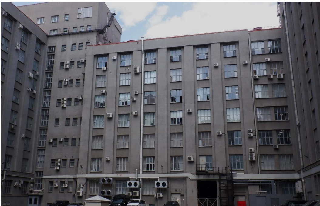
23. «Административное здание», Литейный проспект, дом 4, литера А. Дворовый фасад. Общий вид. Фото 20.03.2026г.
