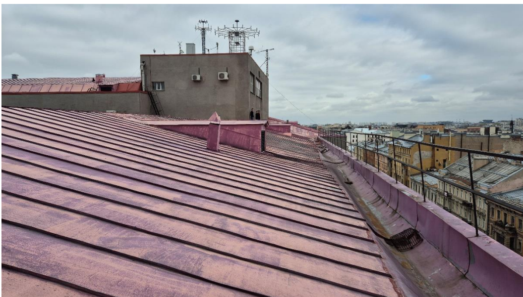
34. «Административное здание», Литейный проспект, дом 4, литера А. Кровля. Общий вид. Фото 20.03.2026г.
