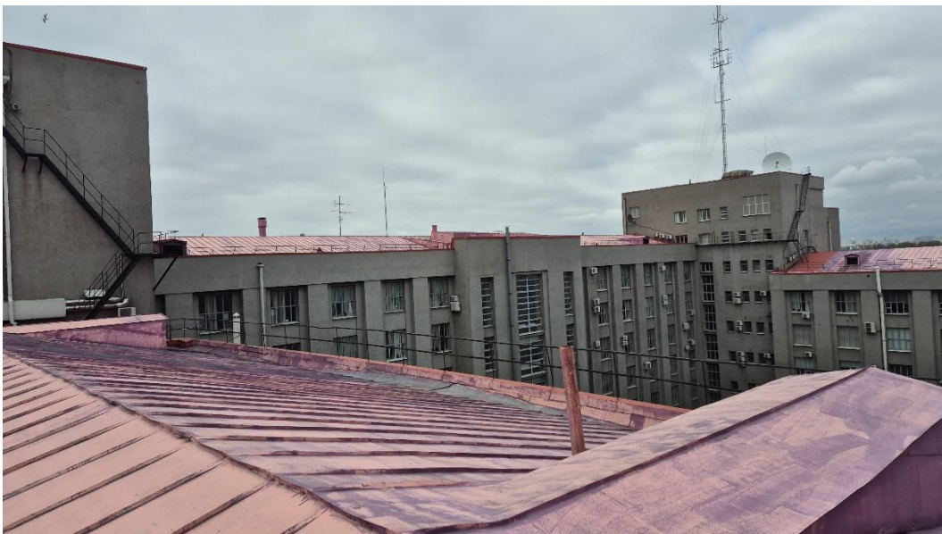
33. «Административное здание», Литейный проспект, дом 4, литера А. Кровля. Общий вид. Фото 20.03.2026г.
