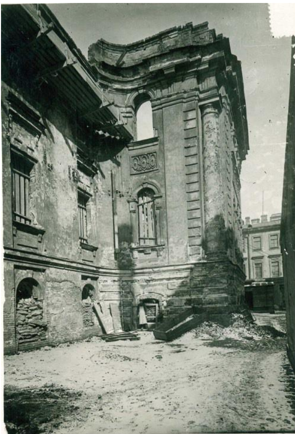
35. Сектор хранения документированной информации (архив) КГИОП. Фото №24086. Окружной суд после пожара 1917. Угловой вид со стороны Шпалерной ул.
