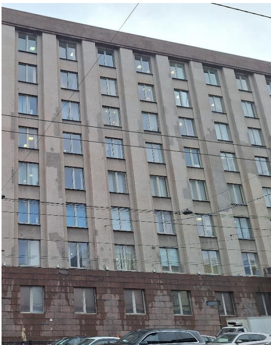
5. «Административное здание», Литейный проспект, дом 4, литера А. Западный фасад. Фрагмент. Фото 20.03.2026г.
