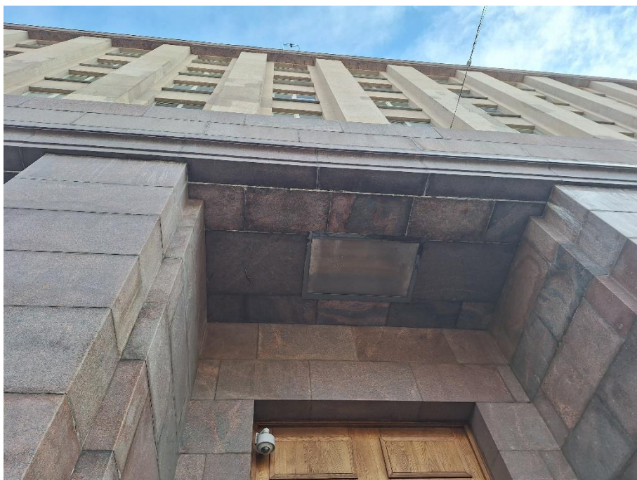
11. «Административное здание», Литейный проспект, дом 4, литера А. Западный фасад. Фрагмент. Фото 20.03.2026г.
