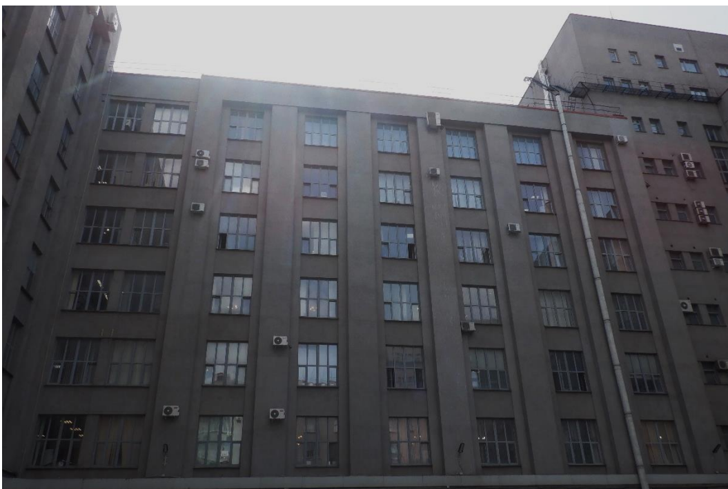
24. «Административное здание», Литейный проспект, дом 4, литера А. Дворовый фасад. Общий вид. Фото 20.03.2026г.
