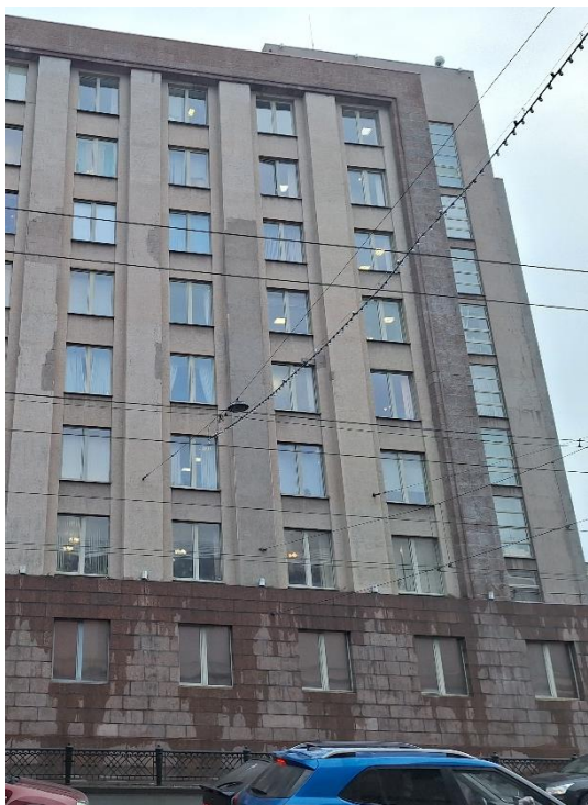
7. «Административное здание», Литейный проспект, дом 4, литера А. Западный фасад. Фрагмент. Фото 20.03.2026г.
