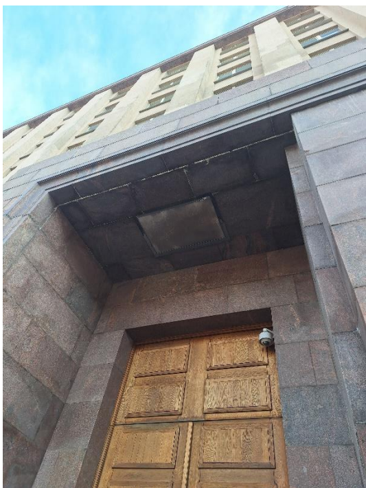
9. «Административное здание», Литейный проспект, дом 4, литера А. Западный фасад. Фрагмент. Фото 20.03.2026г.
