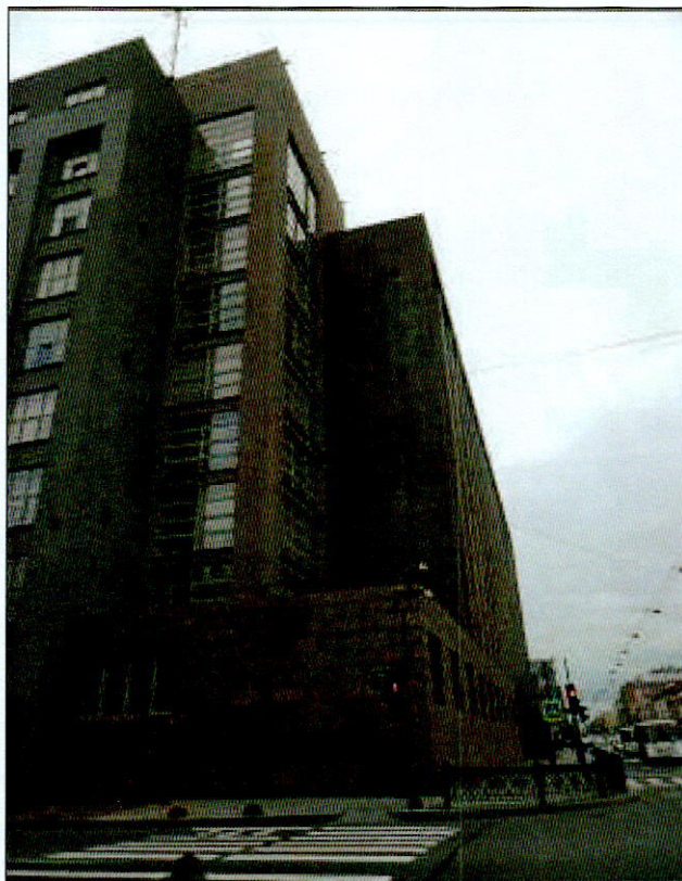
3. Терраса. Вид с юго-запада.
