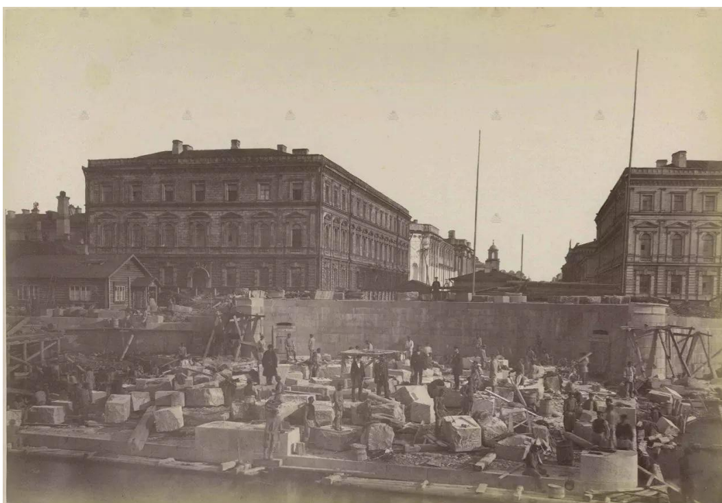
78. Начало строительства Литейного моста. 1878 г. Начало строительства Литейного моста - заложение южного берегового устоя. Источник: spb-projects.ru https://pastvu.com/p/122867 .
