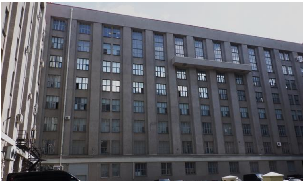
21. «Административное здание», Литейный проспект, дом 4, литера А. Дворовый фасад. Общий вид. Фото 20.03.2026г.
