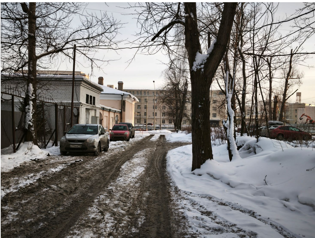
Фото 5. Проезд, здание 7А, выходящее на наб. Обводного канала на заднем плане.
