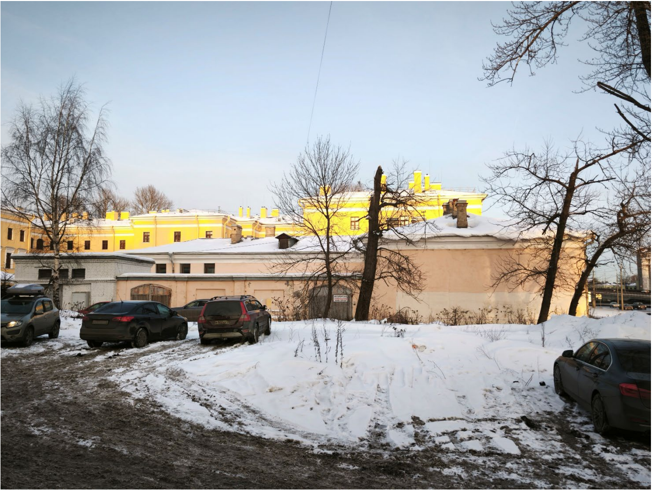
Фото 7. Западный фасад здания Больничный Флигель наб. Обводного канала 7А.
