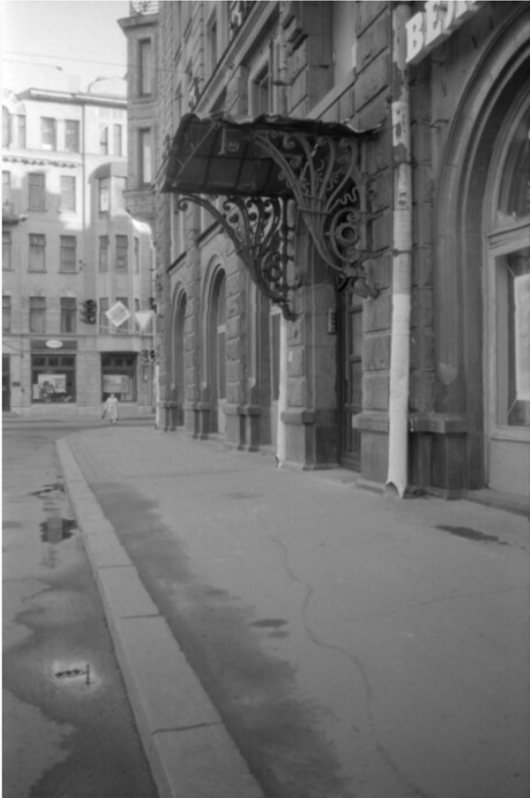
25. 2000 г. Звенигородская улица, 2. Доходный дом М. А. Стенбок-Фермора. Лицевой корпус по Звенигородской улице. Парадный вход с металлическим козырьком (левый). Автор: Доспехов Сергей Владимирович. Источник: https://pastvu.com/p/2546760 .
