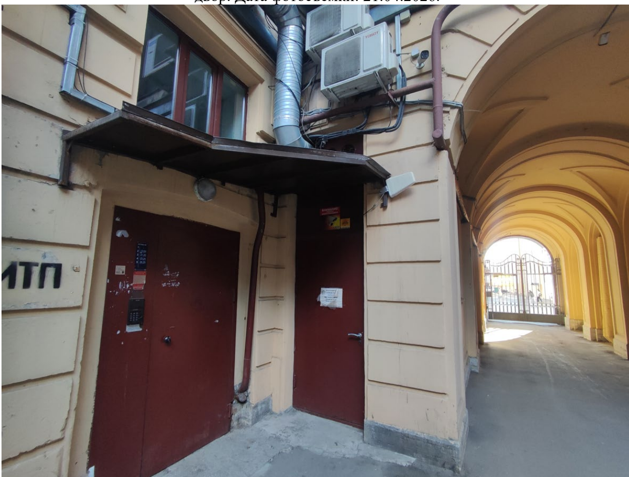
Фото 27. Выявленный объект культурного наследия «Дом М.А. Стенбок-Фермор» (г. Санкт-Петербург, Звенигородская ул., д.2/44, лит. А). Внутренний двор. Дата фотосъемки: 21.04.2026.
