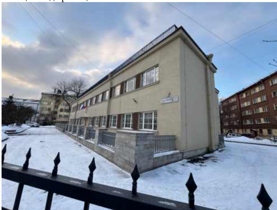
8. Общий вид объекта культурного наследия регионального значения «Здание механической прачечной», 1929–1933 гг., входящего в состав объекта культурного наследия регионального значения «Батенинский жилмассив», 1929–1933 гг., расположенного по адресу: Санкт–Петербург, Лесной проспект, дом 37, литера К.
