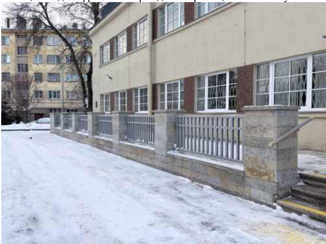
2. Общий вид на фрагмент ограждения крыльца К-1.
