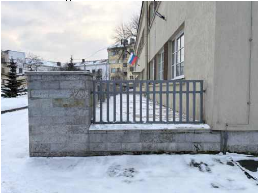
4. Общий вид на фрагмент ограждения крыльца К-1.
