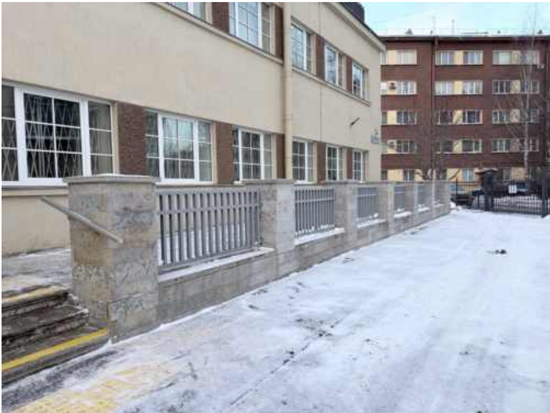
3. Общий вид на фрагмент ограждения крыльца К-1.
