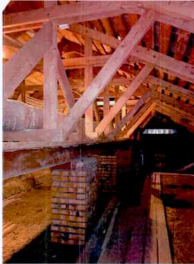
7. Конструкции крыши объекта культурного наследия.
