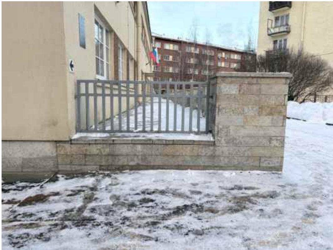
5. Общий вид на фрагмент ограждения крыльца К-1.
