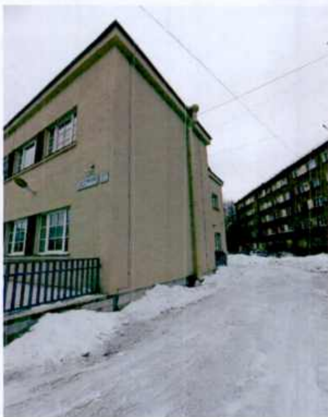
3. Вид на северо-восточный фасад объекта культурного наследия.
