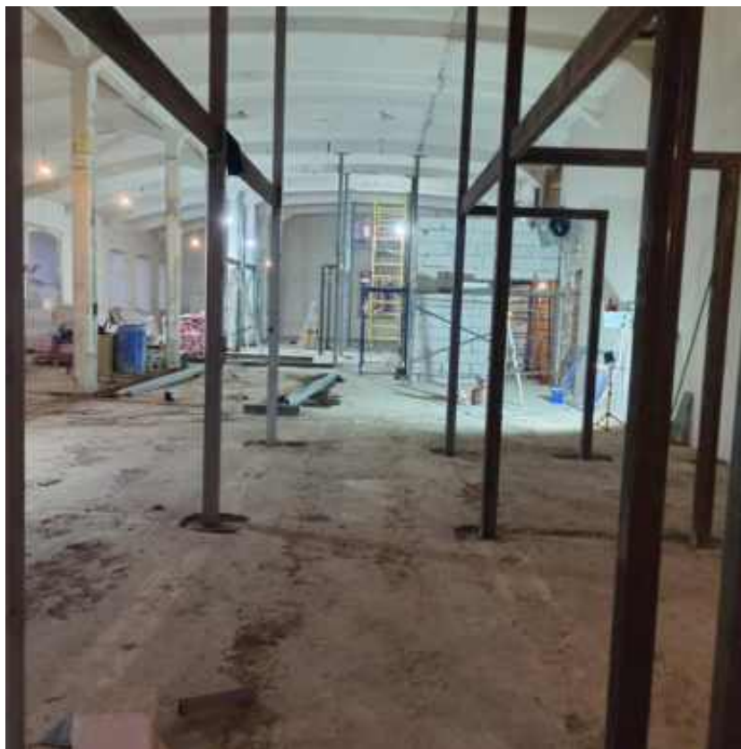
Фото 23. Интерьер 4 этажа объекта культурного наследия регионального значения «Конторское здание», входящего в состав объекта культурного наследия регионального значения «Постройки товарищества механического производства обуви «Скороход»
