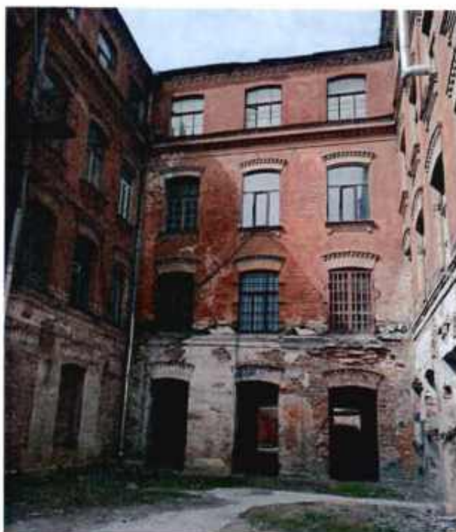
5. Общий вид. Восточный фасад объекта культурного наследия.
