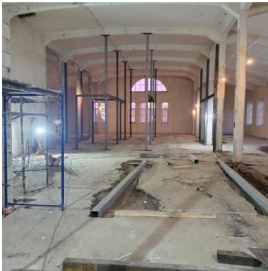
Фото 22. Интерьер 4 этажа объекта культурного наследия регионального значения «Конторское здание», входящего в состав объекта культурного наследия регионального значения «Постройки товарищества механического производства обуви «Скорород»
