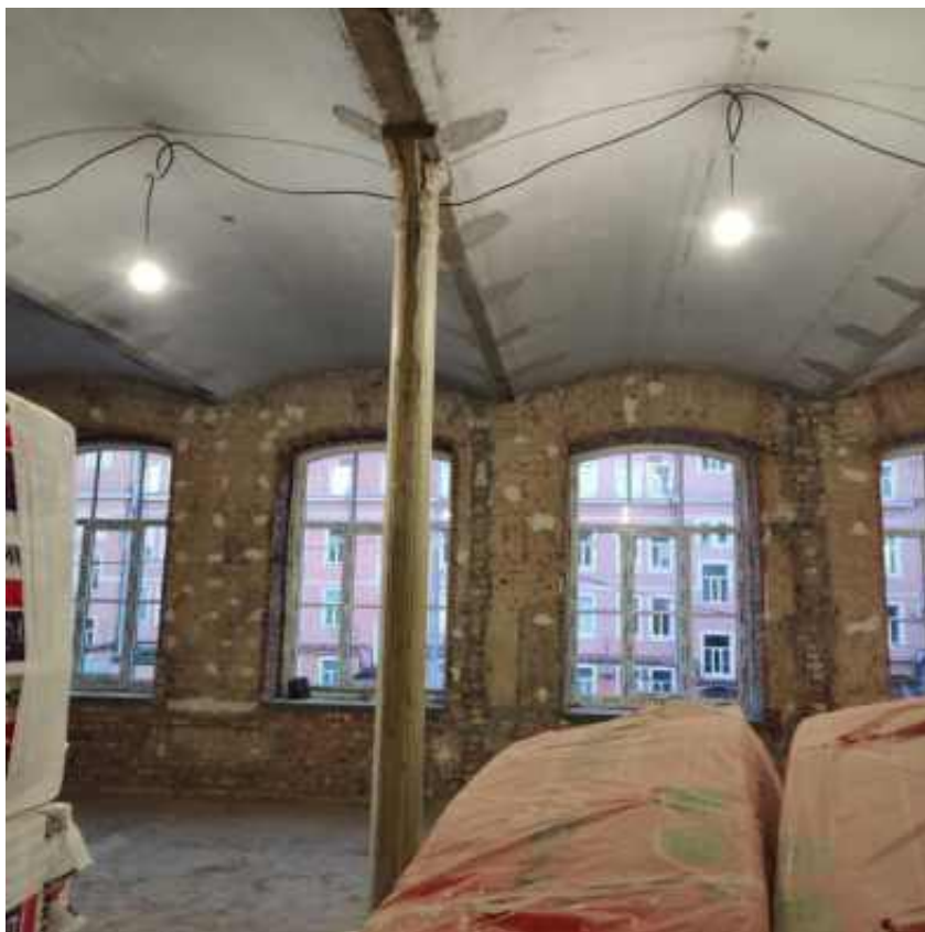
Фото 15. Интерьер 2 этажа объекта культурного наследия регионального значения «Конторское здание», входящего в состав объекта культурного наследия регионального значения «Постройки товарищества механического производства обуви «Скорород»
