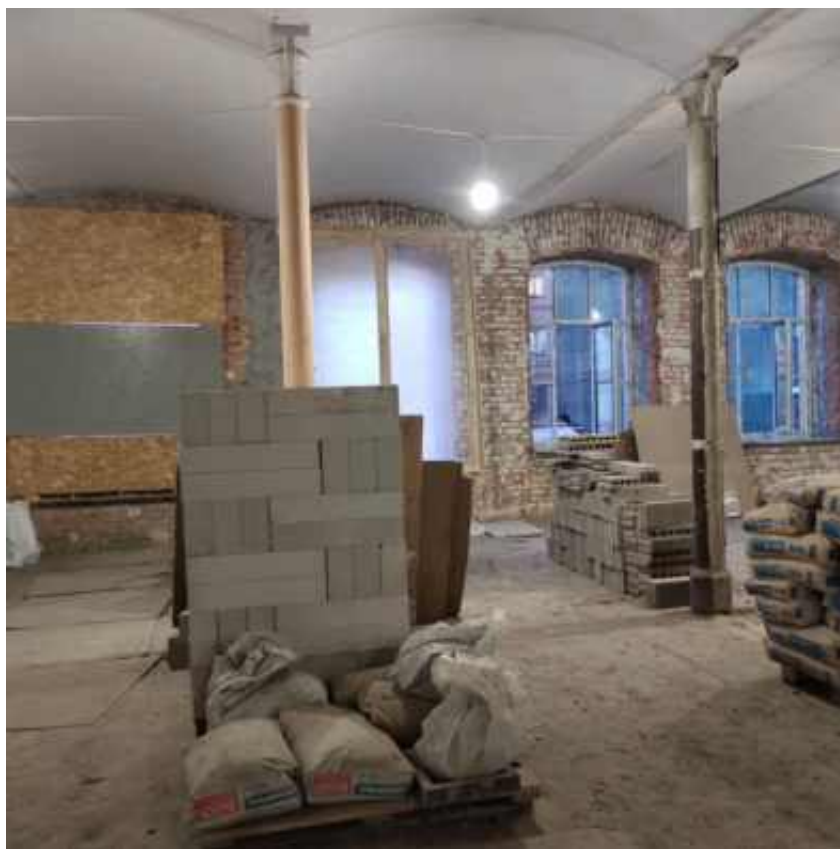
Фото 12. Интерьер 2 этажа объекта культурного наследия регионального значения «Конторское здание», входящего в состав объекта культурного наследия регионального значения «Постройки товарищества механического производства обуви «Скорород»
