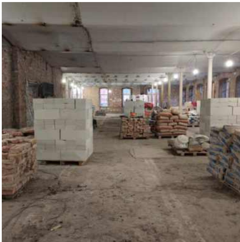
Фото 13. Интерьер 2 этажа объекта культурного наследия регионального значения «Конторское здание», входящего в состав объекта культурного наследия регионального значения «Постройки товарищества механического производства обуви «Скорород»
