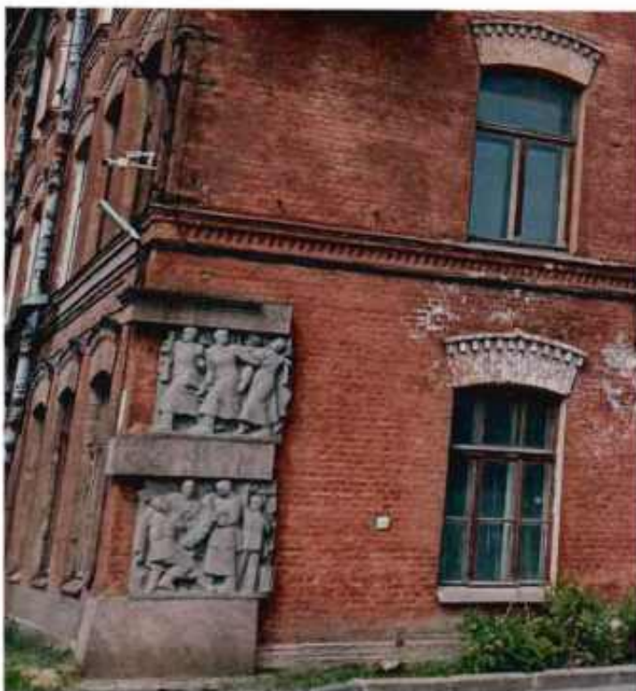
7. Фрагмент. Восточный фасад объекта культурного наследия, барельеф.
