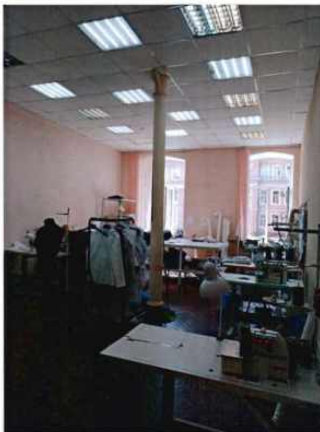
12. Интерьер объекта культурного наследия. Помещение 6-Н(7) в уровне второго этажа.
