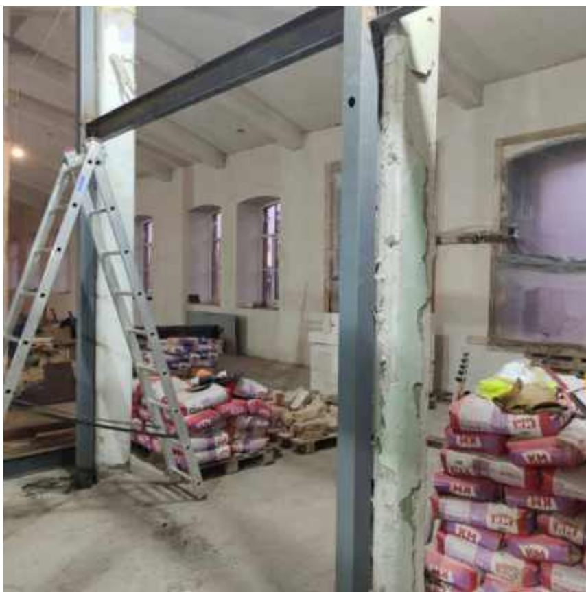
Фото 26. Интерьер 4 этажа объекта культурного наследия регионального значения «Конторское здание», входящего в состав объекта культурного наследия регионального значения «Постройки товарищества механического производства обуви «Скороход»
