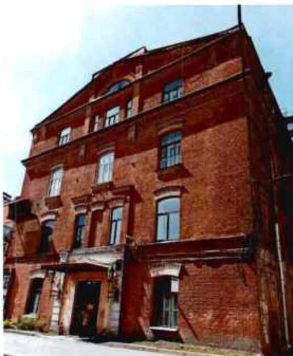
2. Общий вид. Восточный фасад объекта культурного наследия.
