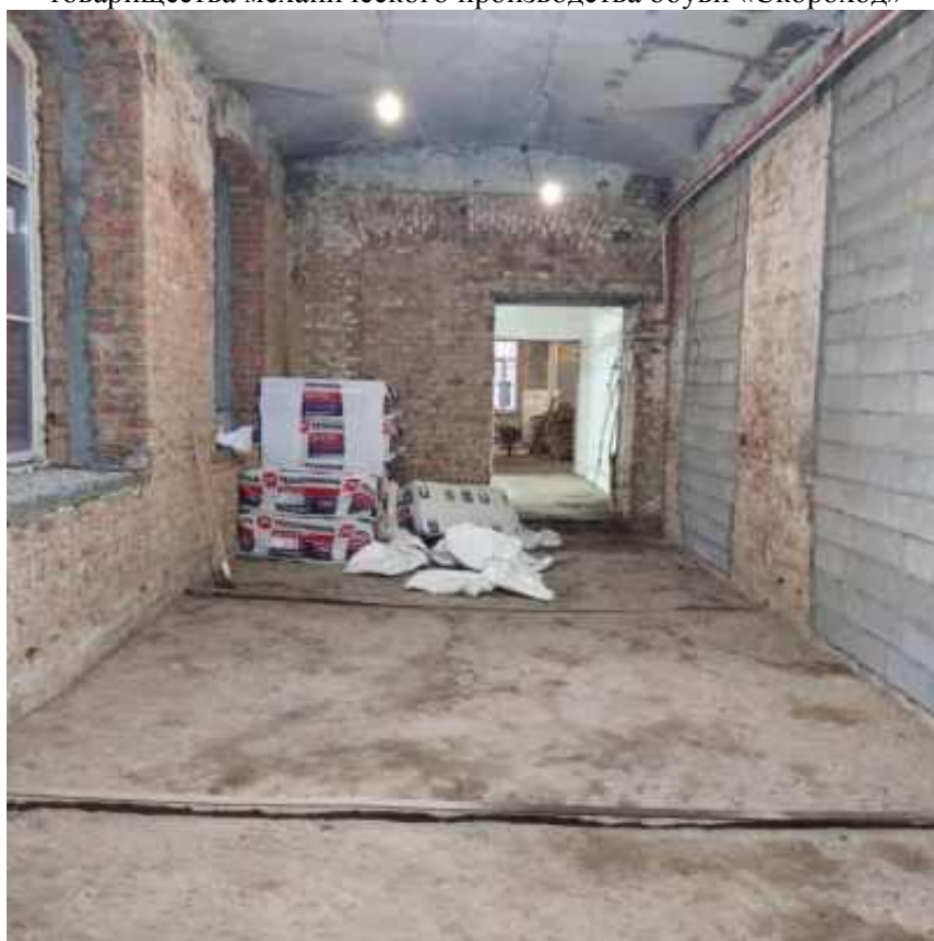
Фото 10. Интерьер 2 этажа объекта культурного наследия регионального значения «Конторское здание», входящего в состав объекта культурного наследия регионального значения «Постройки товарищества механического производства обуви «Скорород»
