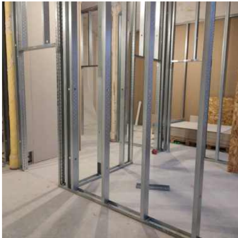
Фото 17. Интерьер 3 этажа объекта культурного наследия регионального значения «Конторское здание», входящего в состав объекта культурного наследия регионального значения «Постройки товарищества механического производства обуви «Скорород»
