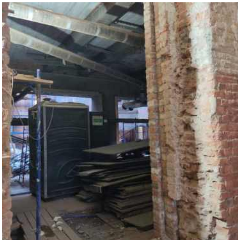
Фото 6. Интерьер 1 этажа объекта культурного наследия регионального значения «Конторское здание», входящего в состав объекта культурного наследия регионального значения «Постройки товарищества механического производства обуви «Скорород»
