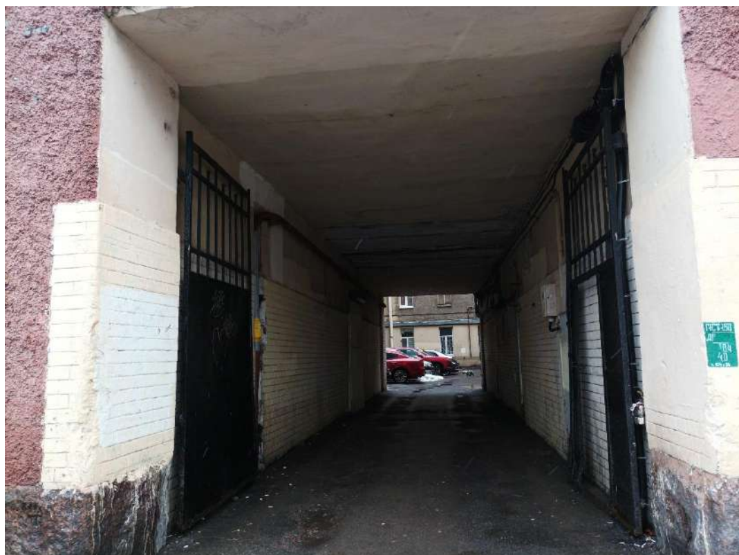
Фото 4. Вид на воротный проезд выявленного объекта культурного наследия «Дом Х.Г. Борхова».
