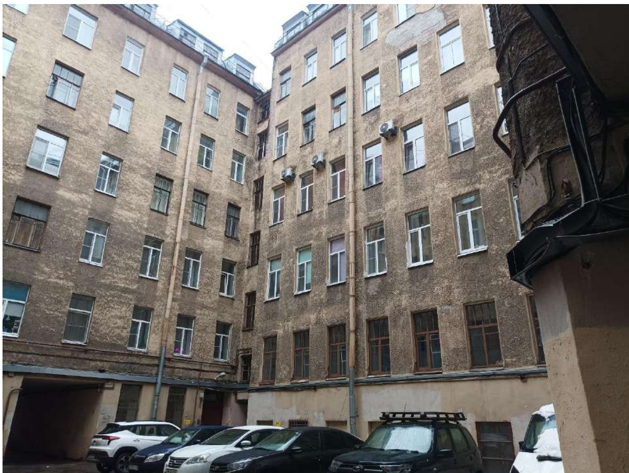
Фото 7. Вид на дворовые фасады выявленного объекта культурного наследия «Дом Х.Г. Борхова».
