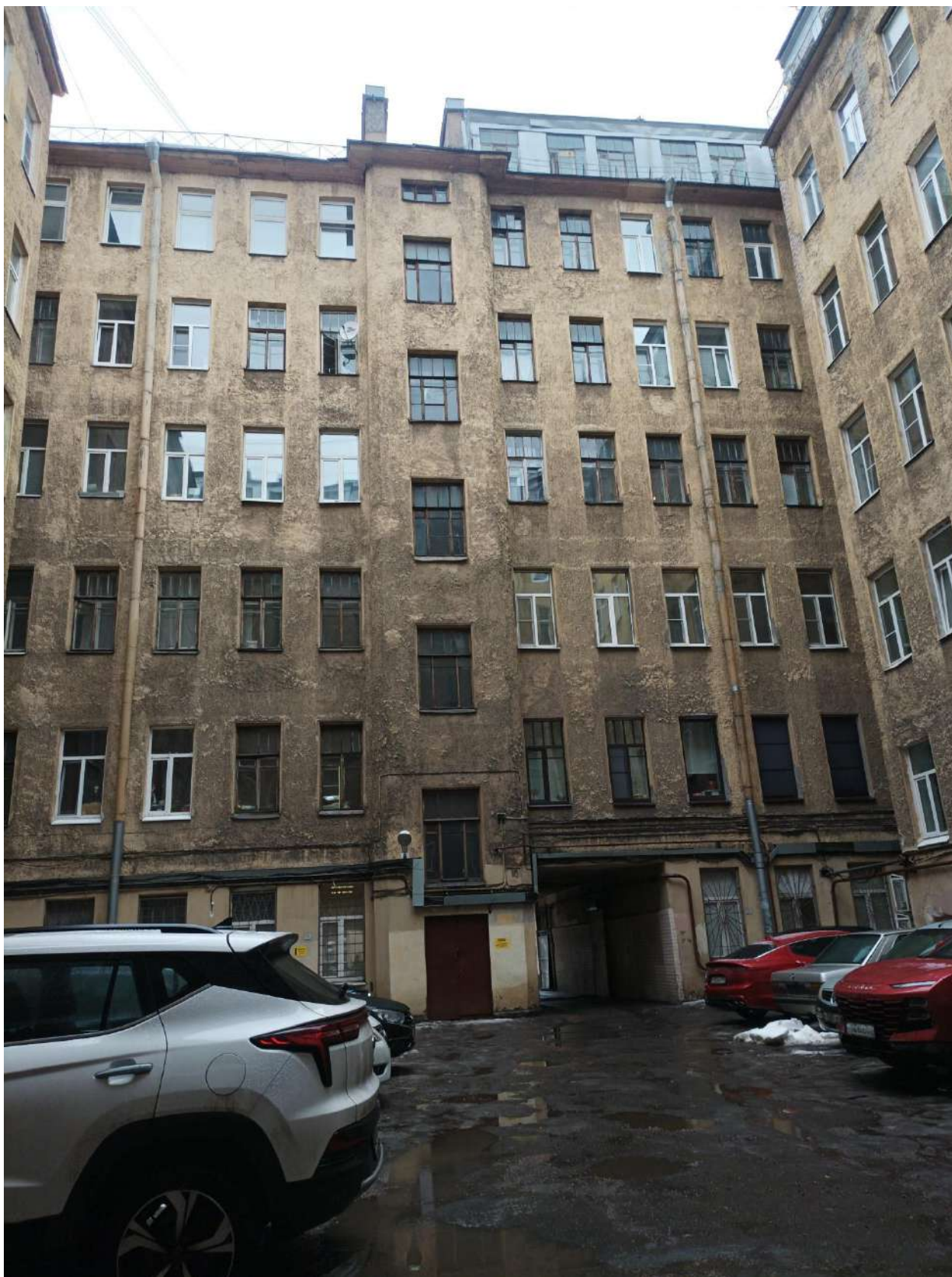
Фото 6. Вид на дворовые фасады выявленного объекта культурного наследия «Дом Х.Г. Борхова».
