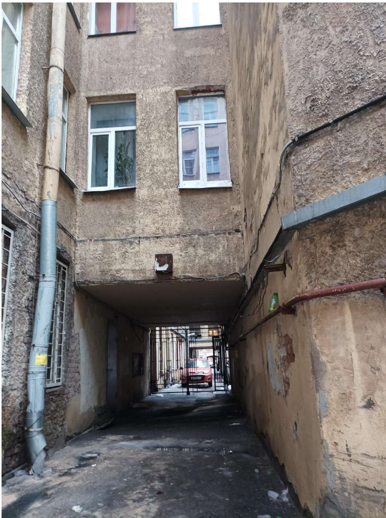
Фото 9. Вид на дворовые фасады выявленного объекта культурного наследия «Дом Х.Г. Борхова».
