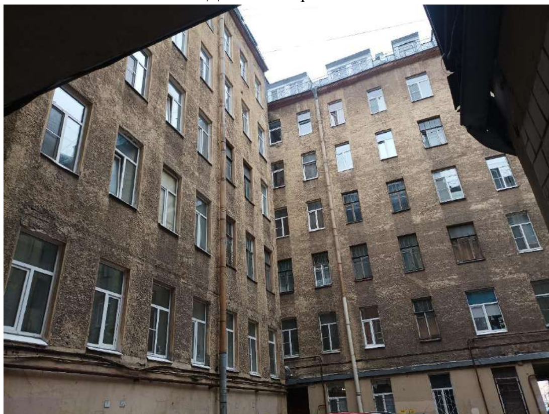
Фото 8. Вид на дворовые фасады выявленного объекта культурного наследия «Дом Х.Г. Борхова».
