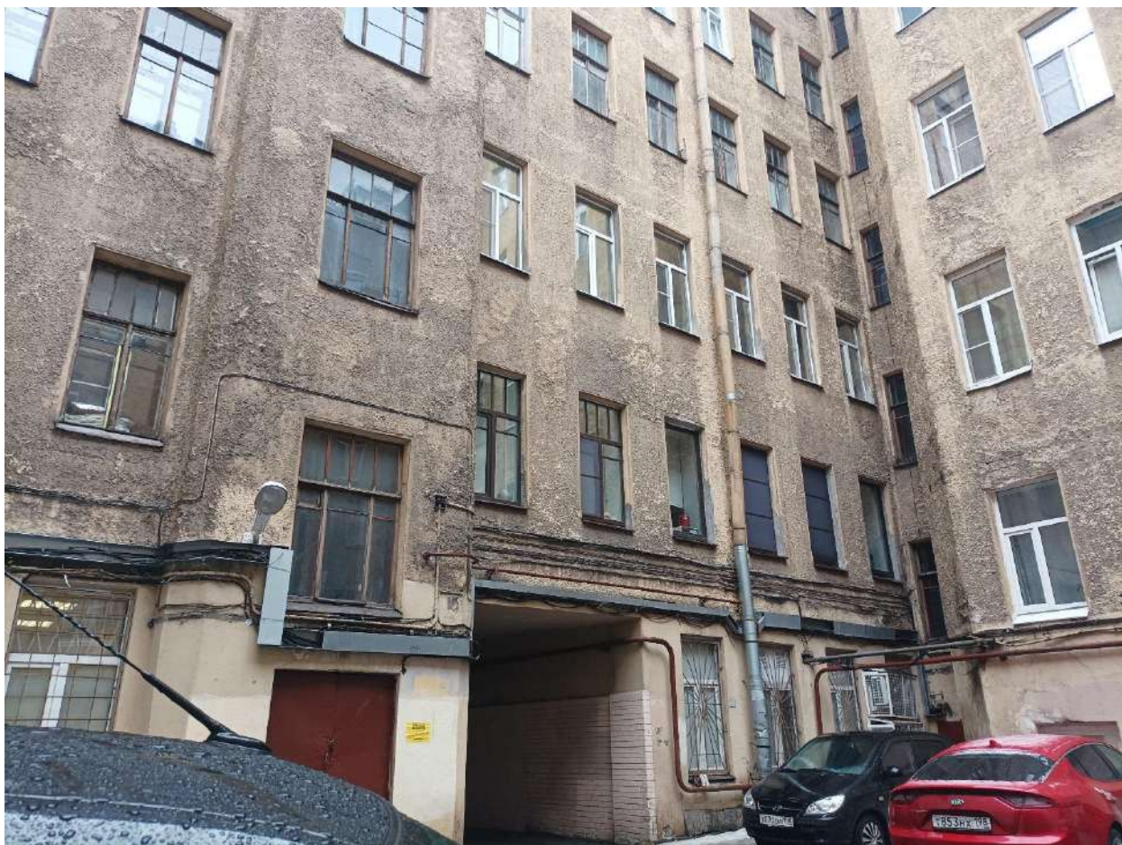
Фото 5. Вид на дворовые фасады выявленного объекта культурного наследия «Дом Х.Г. Борхова».
