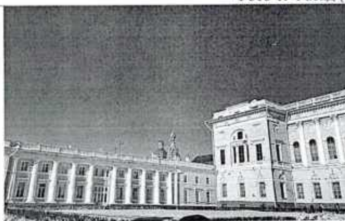
Фото 2. Фасад фрагмент (по ул. Инженерной)
