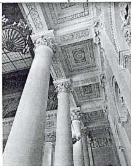
Фото 14. Фрагмент интерьера парадной лестницы
