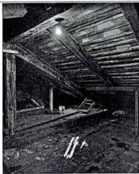
Фото 11. Фрагмент конструкций крыши
