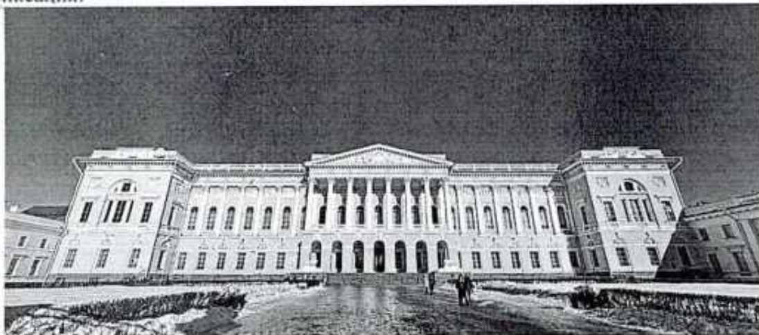
Фото 1. Фасад (по ул. Инженерной)
