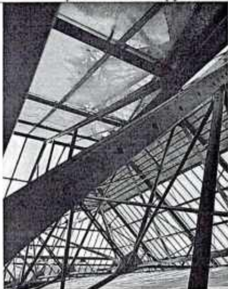
Фото 12. Фрагмент конструкций светового фонаря
