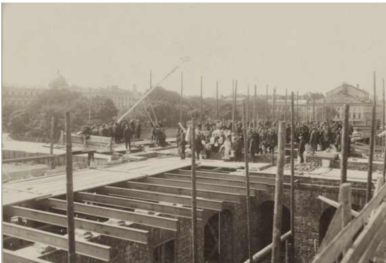
23. Строительство здания этнографического отдела. 1900-е гг. Государственный Эрмитаж (инв. № ЭРФт-124)
