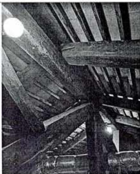
Фото 10. Фрагмент конструкций крыши
