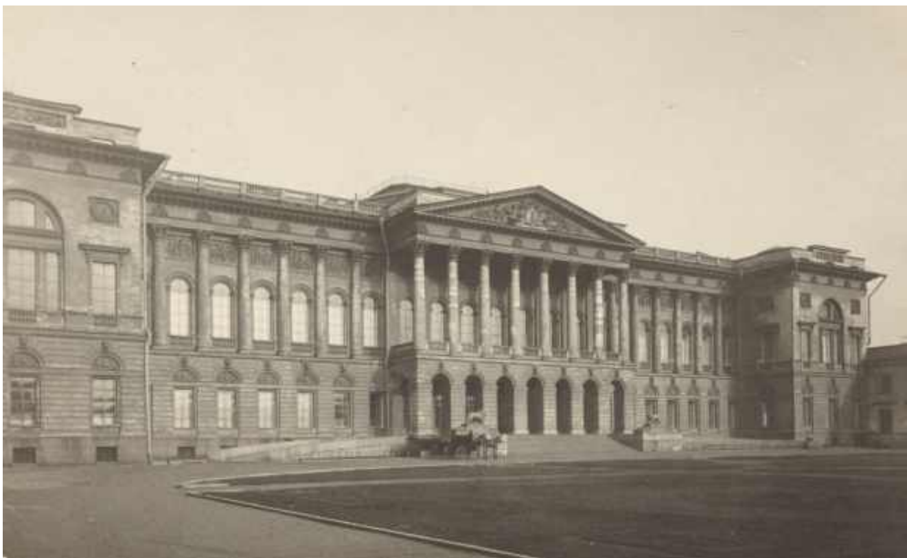
28. Вид Михайловского дворца из курдонера с юго-западной стороны. Фотография. 1910-е гг. (?) Государственный Эрмитаж (инв. № ЭРФТ-20)
