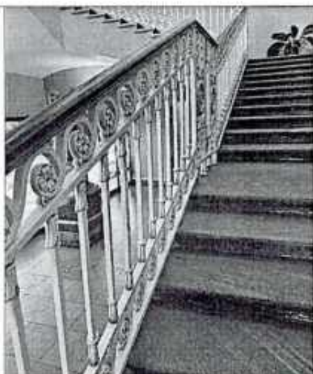
Фото 46. Фрагмент интерьера парадной лестницы
