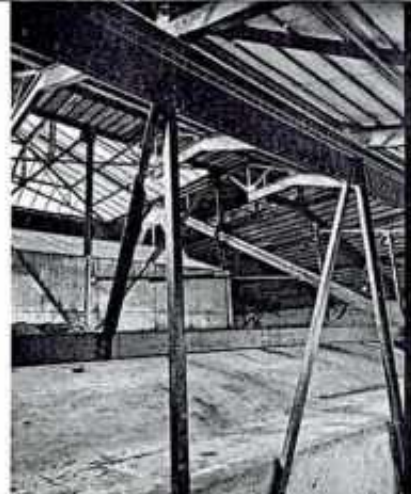
Фото 9. Фрагмент конструкций светового фонаря
