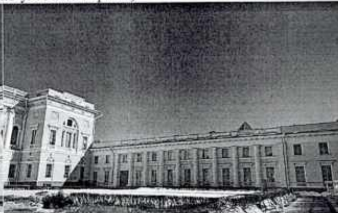
Фото 3. Фасад фрагмент (по ул. Инженерной)
