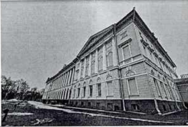
Фото 4. Фасад фрагмент (со стороны Михайловского сада)
