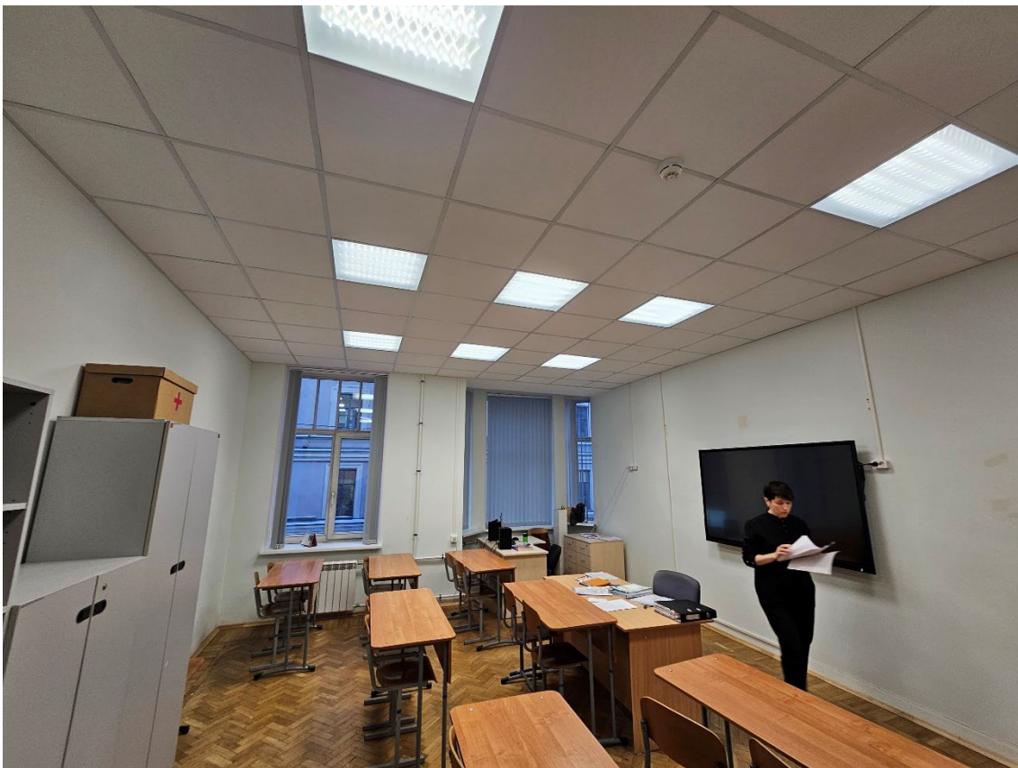
98. Объект культурного наследия регионального значения «Здание второй гимназии императора Александра I с жилым домом», по адресу: г. Санкт-Петербург, Казанская ул., д. 27, лит. А. Общий вид пом. 16-Н (6) в уровне 2-го этажа.
