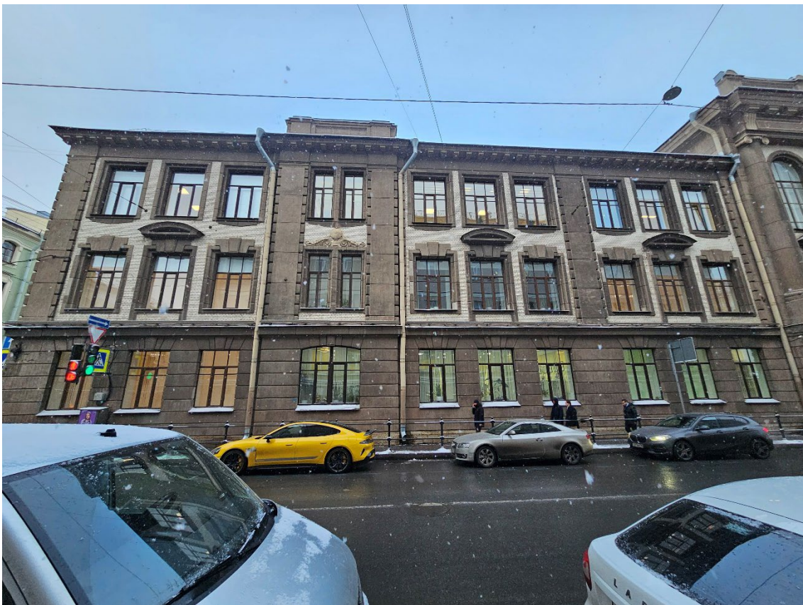
5. Объект культурного наследия регионального значения «Здание второй гимназии императора Александра I с жилым домом», по адресу: г. Санкт-Петербург, Казанская ул., д. 27, лит. А. Фрагмент лицевого фасада (западная часть) корпуса по Казанской улице.
