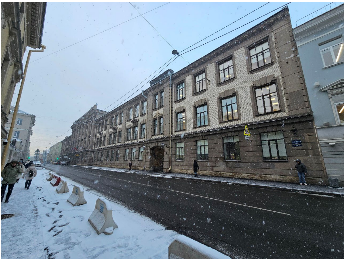
1. Объект культурного наследия регионального значения «Здание второй гимназии императора Александра I с жилым домом», по адресу: г. Санкт-Петербург, Казанская ул., д. 27, лит. А. Общий вид здания в перспективе Казанской улицы.
