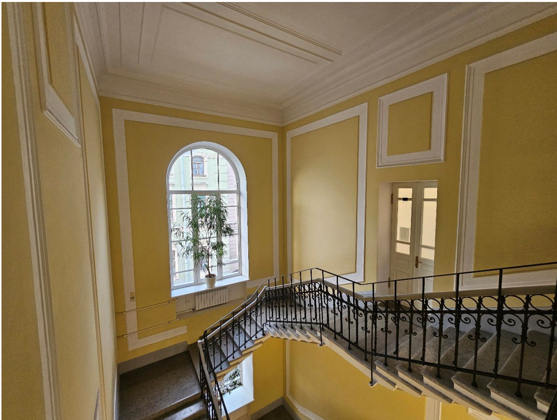
129. Объект культурного наследия регионального значения «Здание второй гимназии императора Александра I с жилым домом», по адресу: г. Санкт-Петербург, Казанская ул., д. 27, лит. А. Общий вид трехмаршевой лестницы в пом. 9-Н (101) в уровне 3-го этажа.
