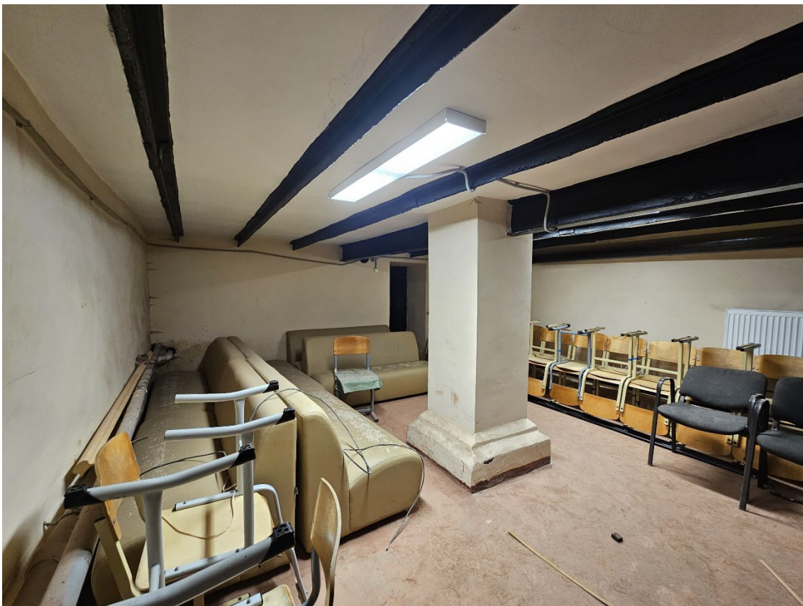
26. Объект культурного наследия регионального значения «Здание второй гимназии императора Александра I с жилым домом», по адресу: г. Санкт-Петербург, Казанская ул., д. 27, лит. А. Общий вид пом. 5-Н (4) в уровне подвала.
