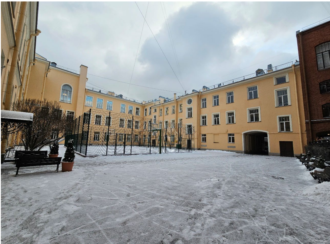
16. Объект культурного наследия регионального значения «Здание второй гимназии императора Александра I с жилым домом», по адресу: г. Санкт-Петербург, Казанская ул., д. 27, лит. А. Общий вид северо-западного дворового фасада лицевого корпуса по Казанской улице и северо-восточного дворового фасада лицевого корпуса по переулку Гривцова.
