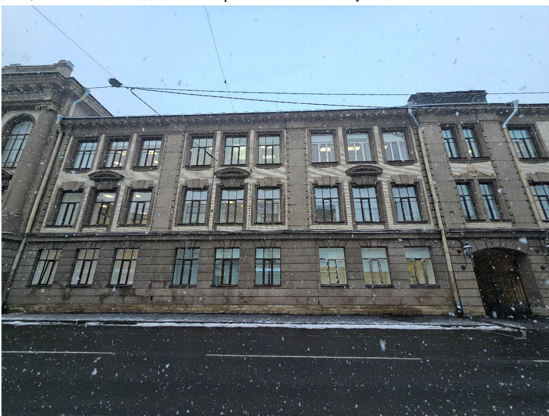
2. Объект культурного наследия регионального значения «Здание второй гимназии императора Александра I с жилым домом», по адресу: г. Санкт-Петербург, Казанская ул., д. 27, лит. А. Фрагмент лицевого фасада (восточная часть) корпуса по Казанской улице.
