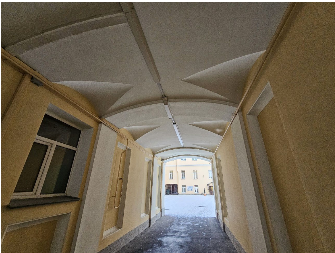
11. Объект культурного наследия регионального значения «Здание второй гимназии императора Александра I с жилым домом», по адресу: г. Санкт-Петербург, Казанская ул., д. 27, лит. А. Общий вид воротного проезда лицевого корпуса по переулку Гривцова.
