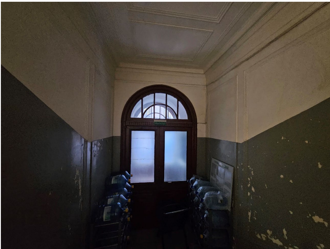
44. Объект культурного наследия регионального значения «Здание второй гимназии императора Александра I с жилым домом», по адресу: г. Санкт-Петербург, Казанская ул., д. 27, лит. А. Общий вид пом. 2ЛК (2) в уровне 1-го этажа.
