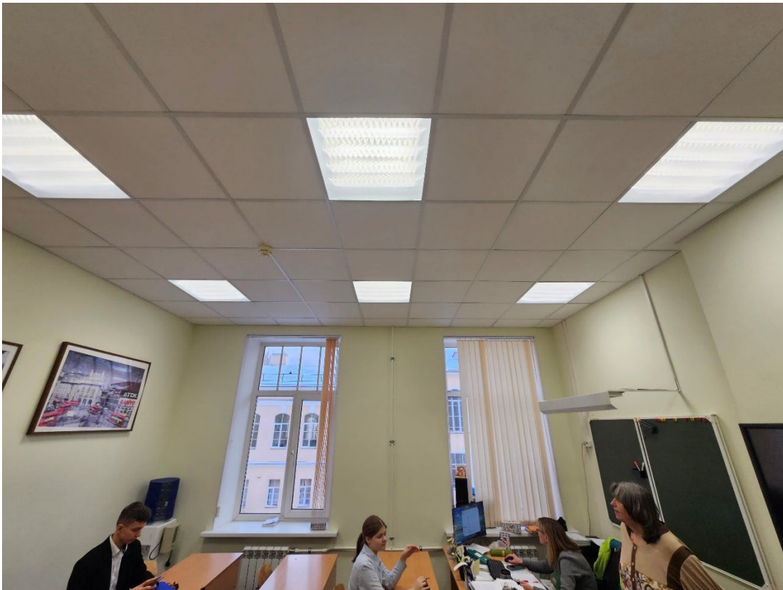
133. Объект культурного наследия регионального значения «Здание второй гимназии императора Александра I с жилым домом», по адресу: г. Санкт-Петербург, Казанская ул., д. 27, лит. А. Общий вид пом. 17-Н (3) в уровне 3-го этажа.
