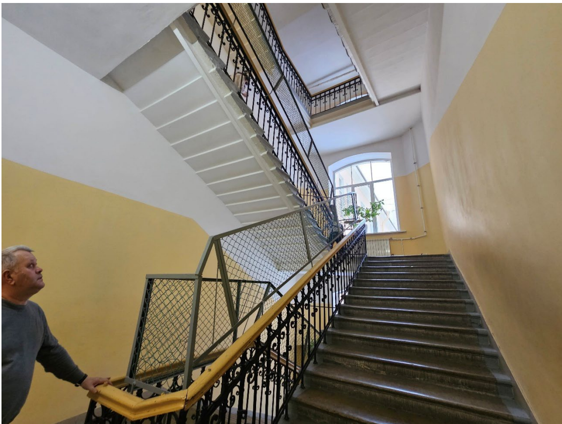
74. Объект культурного наследия регионального значения «Здание второй гимназии императора Александра I с жилым домом», по адресу: г. Санкт-Петербург, Казанская ул., д. 27, лит. А. Общий вид пом. 7ЛК (3) в уровне 2-го этажа.
