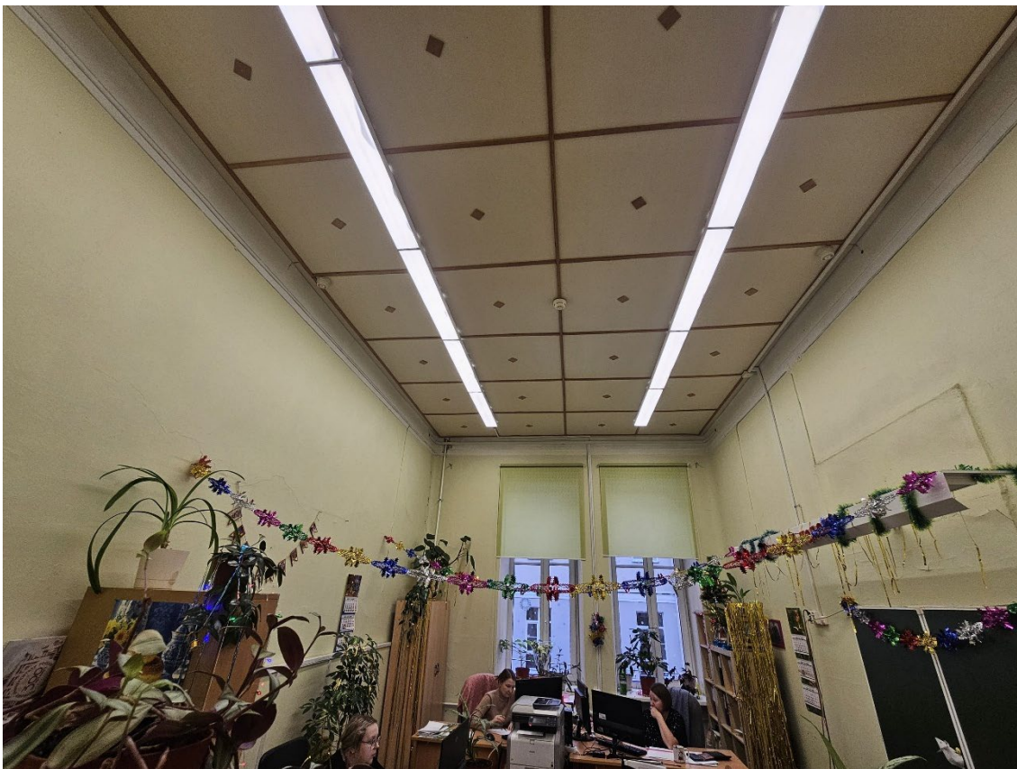
127. Объект культурного наследия регионального значения «Здание второй гимназии императора Александра I с жилым домом», по адресу: г. Санкт-Петербург, Казанская ул., д. 27, лит. А. Общий вид пом. 9-Н (104) в уровне 3-го этажа.
