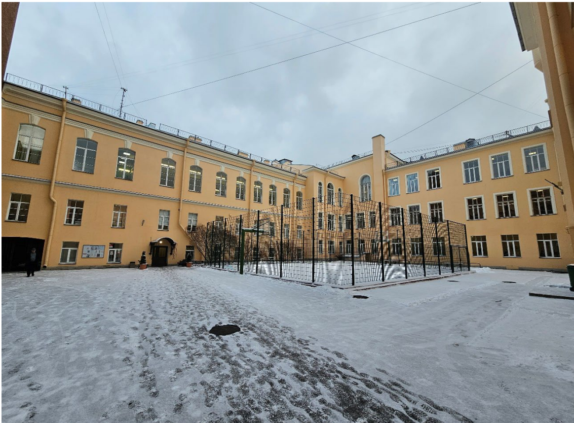
13. Объект культурного наследия регионального значения «Здание второй гимназии императора Александра I с жилым домом», по адресу: г. Санкт-Петербург, Казанская ул., д. 27, лит. А. Общий вид юго-западного дворового фасада поперечного (западного) дворового корпуса и северо-западного дворового фасада лицевого корпуса по Казанской улице.
