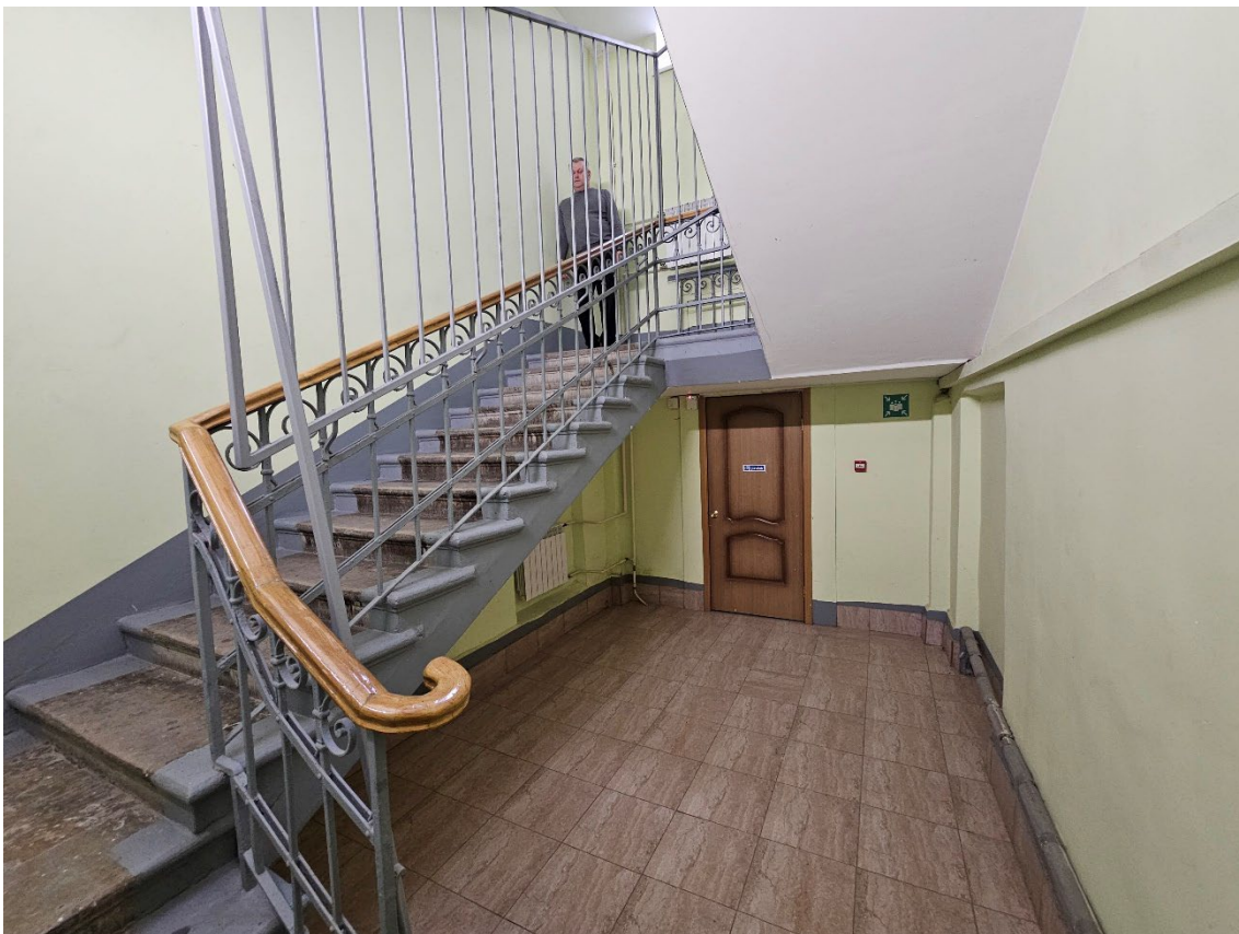
69. Объект культурного наследия регионального значения «Здание второй гимназии императора Александра I с жилым домом», по адресу: г. Санкт-Петербург, Казанская ул., д. 27, лит. А. Общий вид пом. 5ЛК (1) в уровне 1-го этажа.
