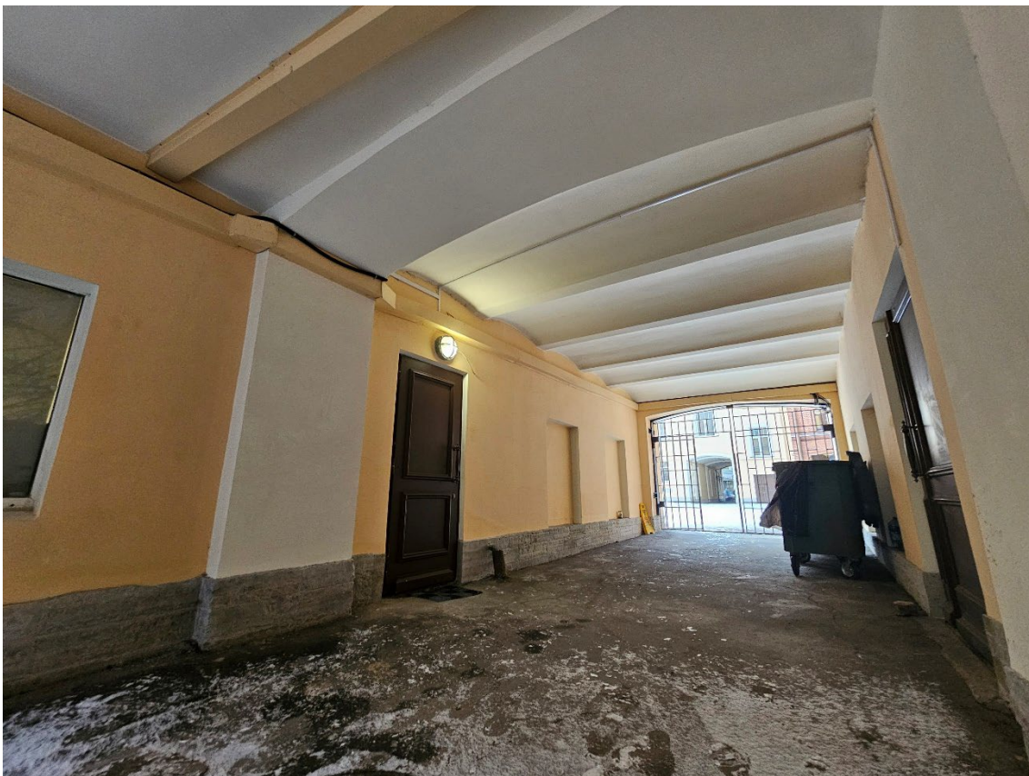
17. Объект культурного наследия регионального значения «Здание второй гимназии императора Александра I с жилым домом», по адресу: г. Санкт-Петербург, Казанская ул., д. 27, лит. А. Общий вид воротного проезда поперечного (западного) дворового корпуса.
