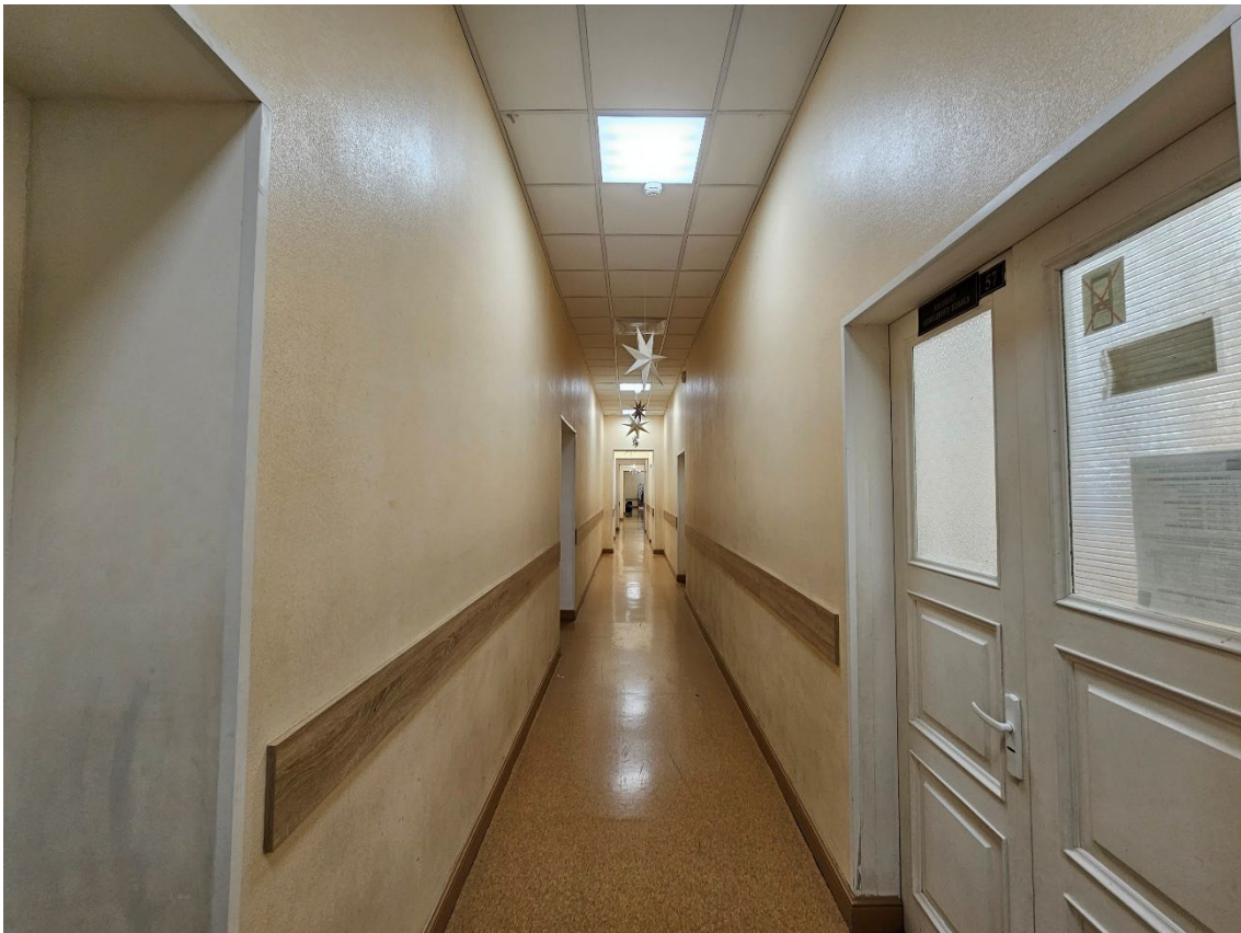
112. Объект культурного наследия регионального значения «Здание второй гимназии императора Александра I с жилым домом», по адресу: г. Санкт-Петербург, Казанская ул., д. 27, лит. А. Общий вид пом. 9-Н (71) в уровне 2-го этажа.
