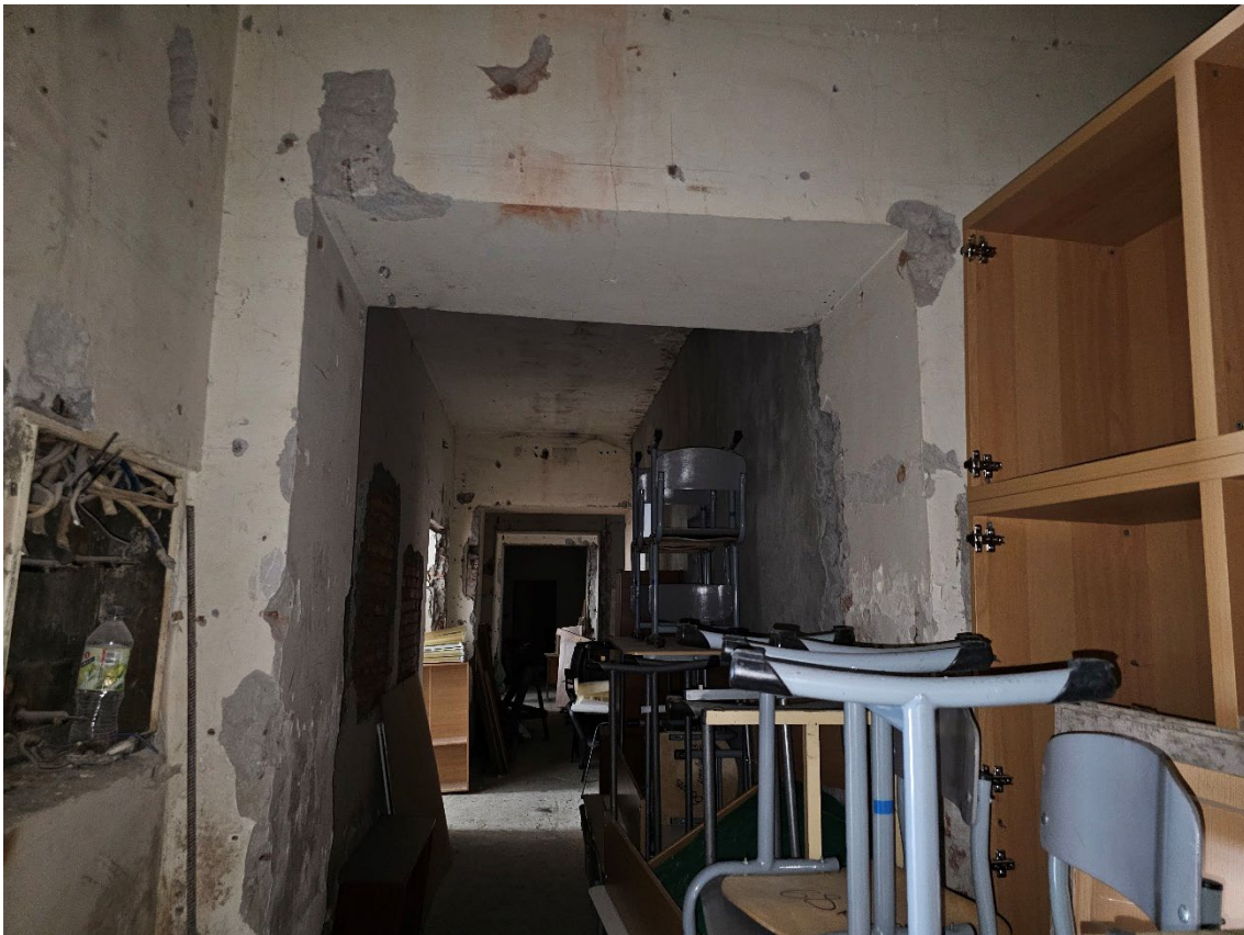
71. Объект культурного наследия регионального значения «Здание второй гимназии императора Александра I с жилым домом», по адресу: г. Санкт-Петербург, Казанская ул., д. 27, лит. А. Общий вид пом. 13-Н (4) в уровне 1-го этажа.
