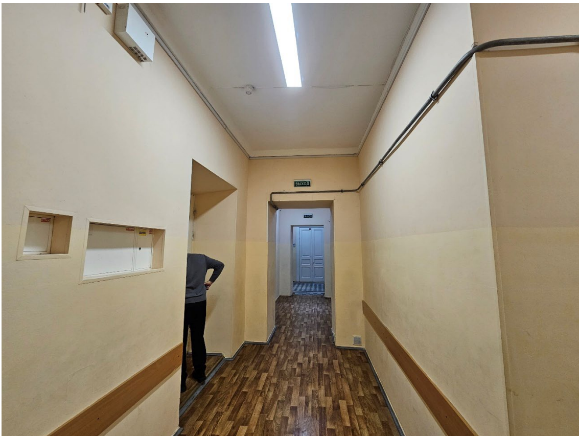
105. Объект культурного наследия регионального значения «Здание второй гимназии императора Александра I с жилым домом», по адресу: г. Санкт-Петербург, Казанская ул., д. 27, лит. А. Фрагмент пом. 9-Н (60) в уровне 2-го этажа.
