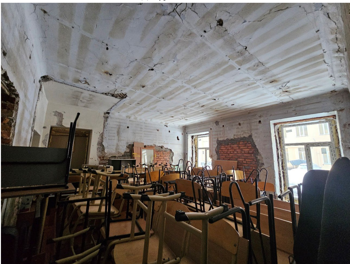
72. Объект культурного наследия регионального значения «Здание второй гимназии императора Александра I с жилым домом», по адресу: г. Санкт-Петербург, Казанская ул., д. 27, лит. А. Общий вид пом. 13-Н (21) в уровне 1-го этажа.
