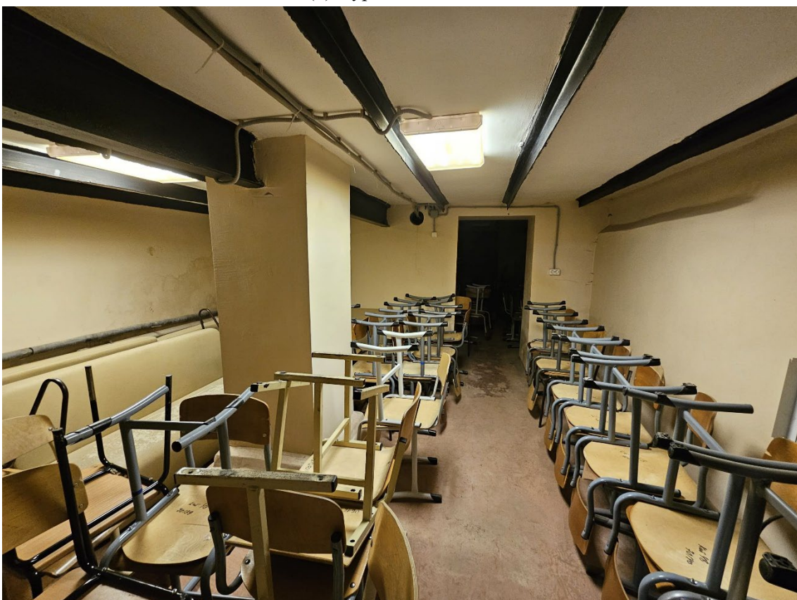
27. Объект культурного наследия регионального значения «Здание второй гимназии императора Александра I с жилым домом», по адресу: г. Санкт-Петербург, Казанская ул., д. 27, лит. А. Общий вид пом. 5-Н (3) в уровне подвала.
