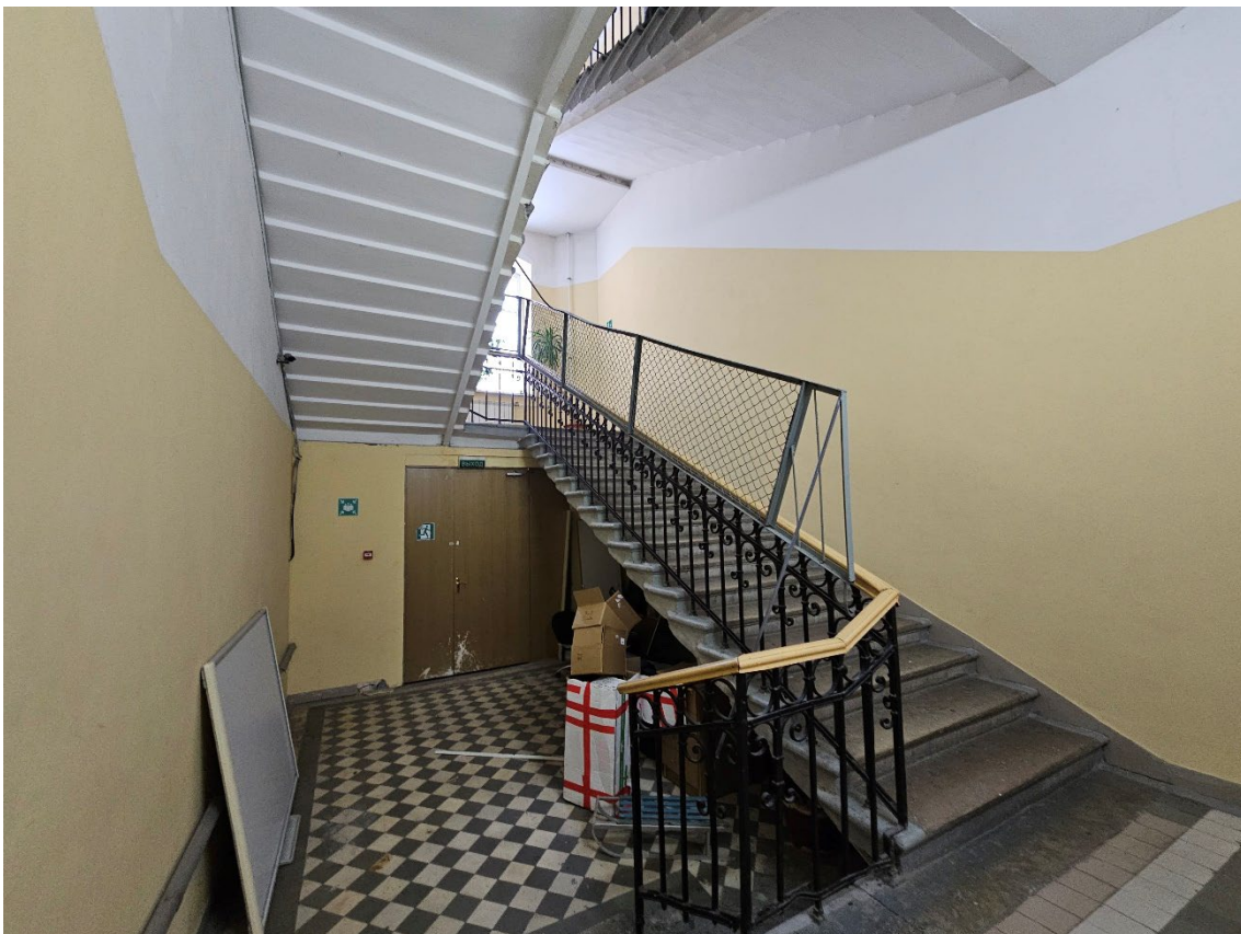
52. Объект культурного наследия регионального значения «Здание второй гимназии императора Александра I с жилым домом», по адресу: г. Санкт-Петербург, Казанская ул., д. 27, лит. А. Общий вид пом. 7ЛК (2) в уровне 1-го этажа.
