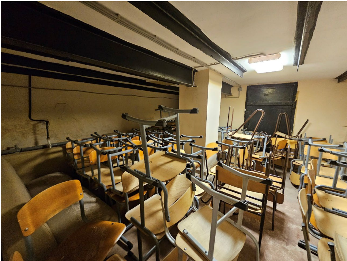
28. Объект культурного наследия регионального значения «Здание второй гимназии императора Александра I с жилым домом», по адресу: г. Санкт-Петербург, Казанская ул., д. 27, лит. А. Общий вид пом. 5-Н (2) в уровне подвала.
