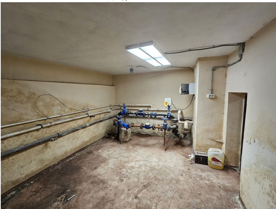
25. Объект культурного наследия регионального значения «Здание второй гимназии императора Александра I с жилым домом», по адресу: г. Санкт-Петербург, Казанская ул., д. 27, лит. А. Общий вид пом. 5-Н (8) в уровне подвала.
