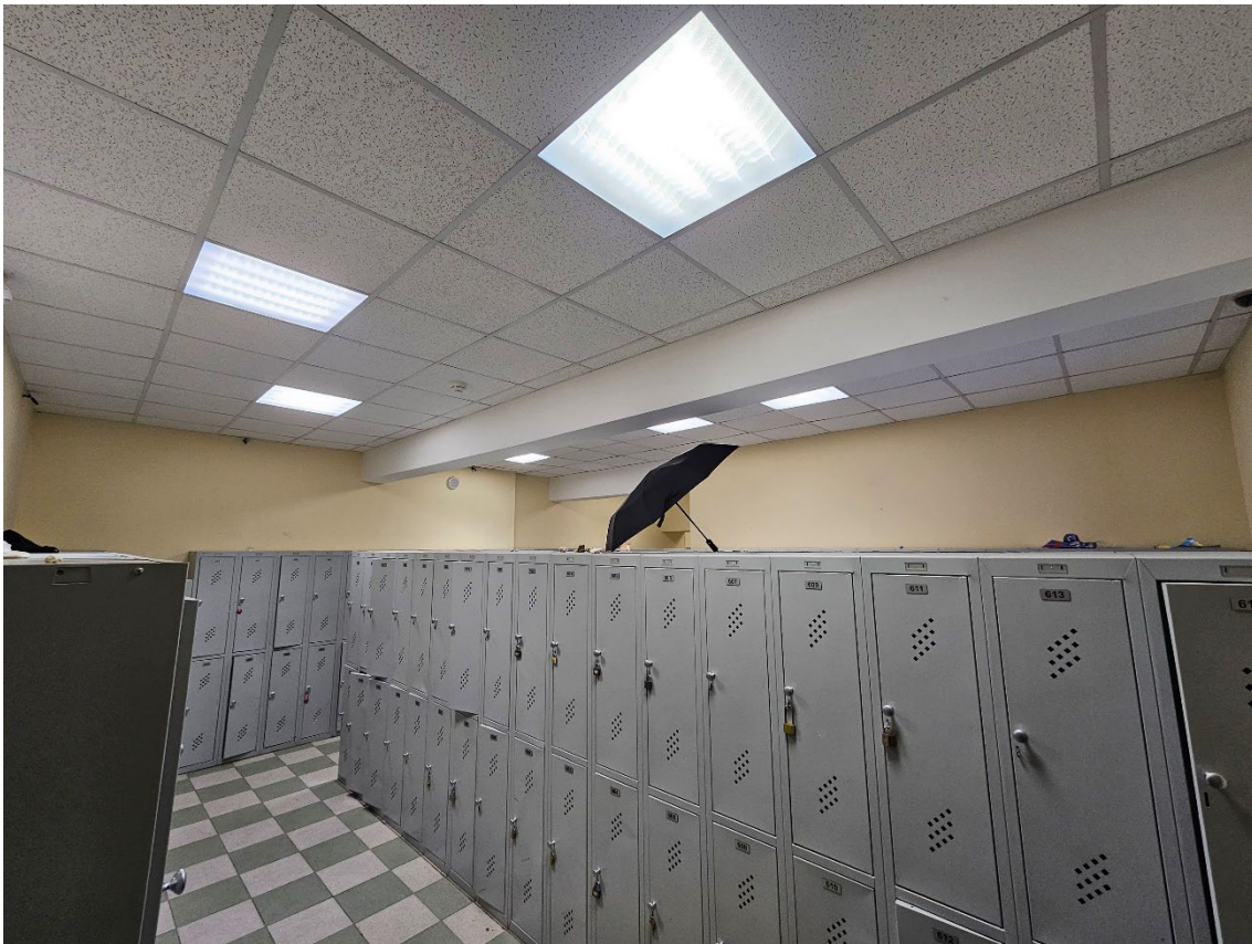
63. Объект культурного наследия регионального значения «Здание второй гимназии императора Александра I с жилым домом», по адресу: г. Санкт-Петербург, Казанская ул., д. 27, лит. А. Общий вид пом. 9-Н (26) в уровне 1-го этажа.
