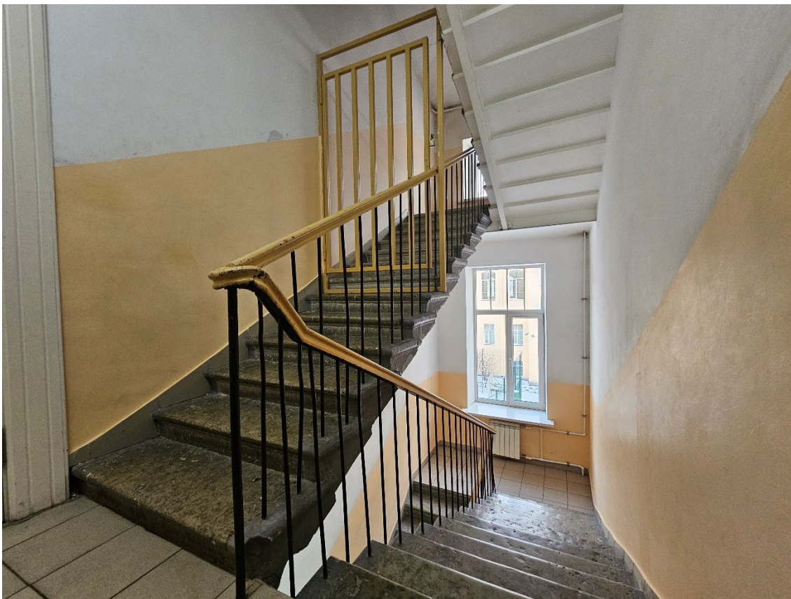
131. Объект культурного наследия регионального значения «Здание второй гимназии императора Александра I с жилым домом», по адресу: г. Санкт-Петербург, Казанская ул., д. 27, лит. А. Общий вид пом. 3ЛК (3) в уровне 3-го этажа.
