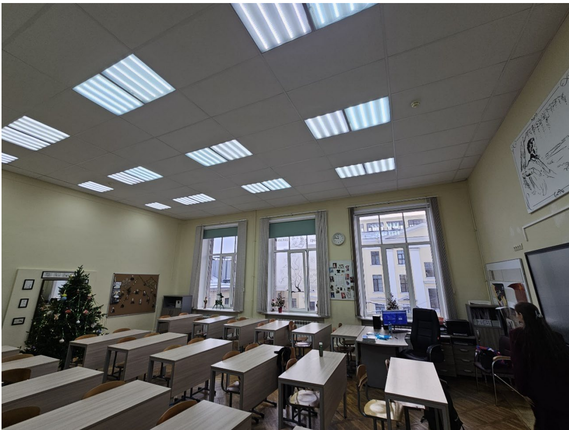
119. Объект культурного наследия регионального значения «Здание второй гимназии императора Александра I с жилым домом», по адресу: г. Санкт-Петербург, Казанская ул., д. 27, лит. А. Общий вид пом. 9-Н (127) в уровне 3-го этажа.
