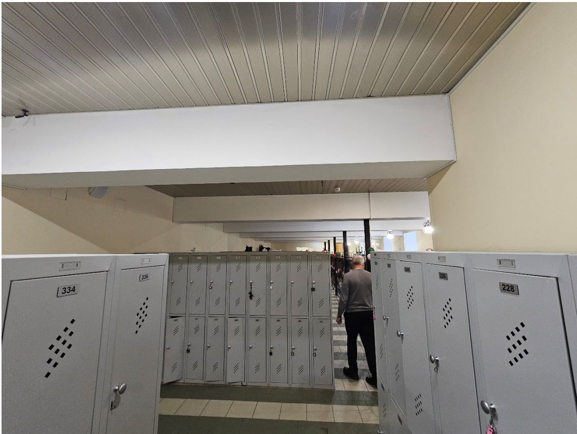
65. Объект культурного наследия регионального значения «Здание второй гимназии императора Александра I с жилым домом», по адресу: г. Санкт-Петербург, Казанская ул., д. 27, лит. А. Фрагмент пом. 9-Н (20) в уровне 1-го этажа.
