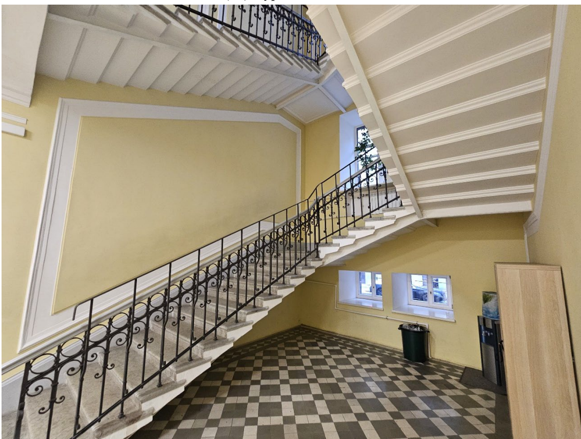
40. Объект культурного наследия регионального значения «Здание второй гимназии императора Александра I с жилым домом», по адресу: г. Санкт-Петербург, Казанская ул., д. 27, лит. А. Общий вид трехмаршевой лестницы в пом. 9-Н (2) в уровне 1-го этажа.
