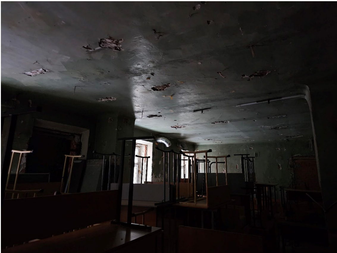
73. Объект культурного наследия регионального значения «Здание второй гимназии императора Александра I с жилым домом», по адресу: г. Санкт-Петербург, Казанская ул., д. 27, лит. А. Общий вид пом. 13-Н (17) в уровне 1-го этажа.
