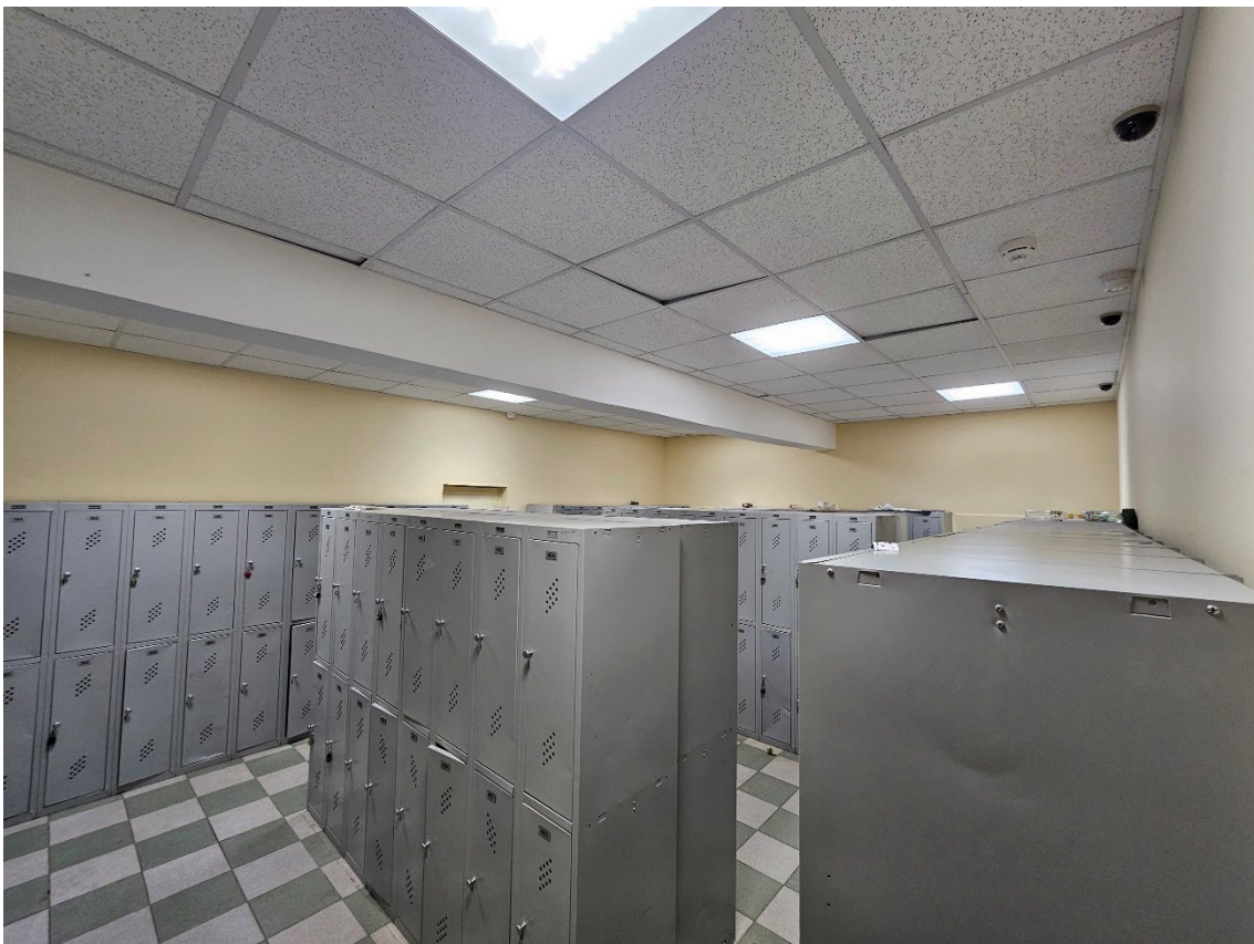
64. Объект культурного наследия регионального значения «Здание второй гимназии императора Александра I с жилым домом», по адресу: г. Санкт-Петербург, Казанская ул., д. 27, лит. А. Общий вид пом. 9-Н (24) в уровне 1-го этажа.
