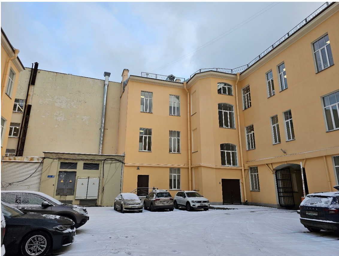
19. Объект культурного наследия регионального значения «Здание второй гимназии императора Александра I с жилым домом», по адресу: г. Санкт-Петербург, Казанская ул., д. 27, лит. А. Угловой ризалит со срезанным углом дворового фасада корпуса по Казанской улице (восточный двор).
