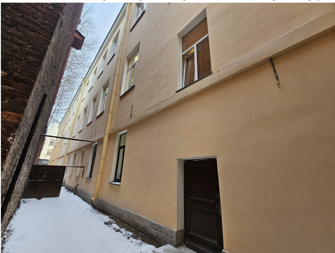
18. Объект культурного наследия регионального значения «Здание второй гимназии императора Александра I с жилым домом», по адресу: г. Санкт-Петербург, Казанская ул., д. 27, лит. А. Общий вид северо-западного дворового фасада продольного (восточного) дворового корпуса.
