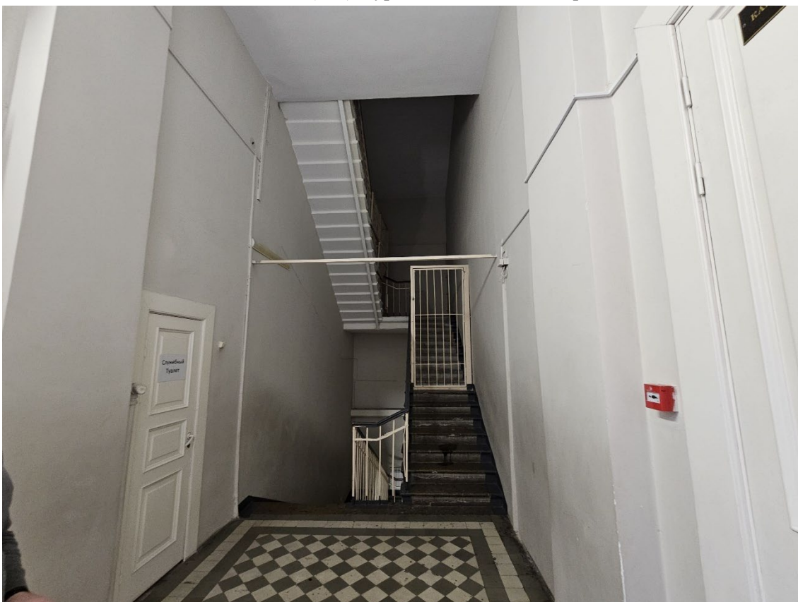
138. Объект культурного наследия регионального значения «Здание второй гимназии императора Александра I с жилым домом», по адресу: г. Санкт-Петербург, Казанская ул., д. 27, лит. А. Общий вид пом. 4ЛК (3) в уровне 3-го этажа.
