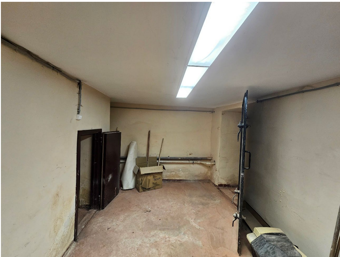
24. Объект культурного наследия регионального значения «Здание второй гимназии императора Александра I с жилым домом», по адресу: г. Санкт-Петербург, Казанская ул., д. 27, лит. А. Общий вид пом. 5-Н (7) в уровне подвала.
