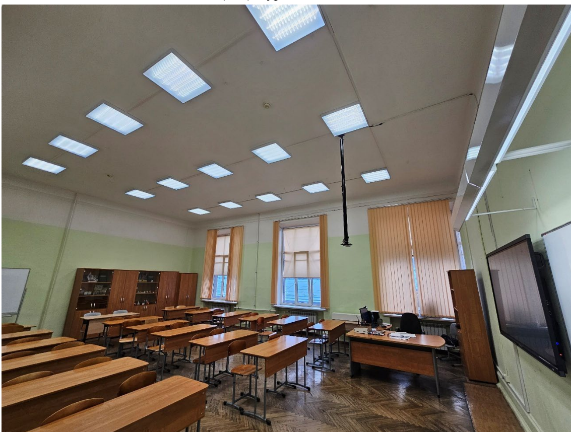
116. Объект культурного наследия регионального значения «Здание второй гимназии императора Александра I с жилым домом», по адресу: г. Санкт-Петербург, Казанская ул., д. 27, лит. А. Общий вид пом. 9-Н (124) в уровне 3-го этажа.
