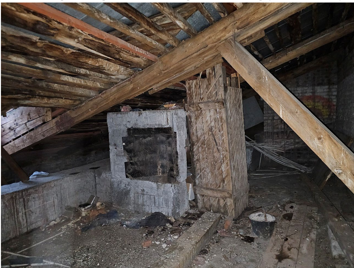
154. Объект культурного наследия регионального значения «Здание второй гимназии императора Александра I с жилым домом», по адресу: г. Санкт-Петербург, Казанская ул., д. 27, лит. А. Фрагмент стропильной системы крыши лицевого корпуса по Казанской ул.
