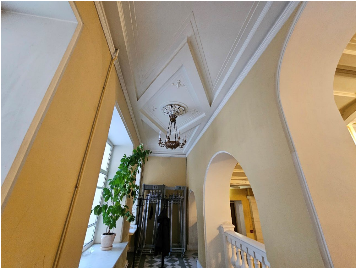
59. Объект культурного наследия регионального значения «Здание второй гимназии императора Александра I с жилым домом», по адресу: г. Санкт-Петербург, Казанская ул., д. 27, лит. А. Фрагмент пом. 9-Н (12) в уровне 1-го этажа.
