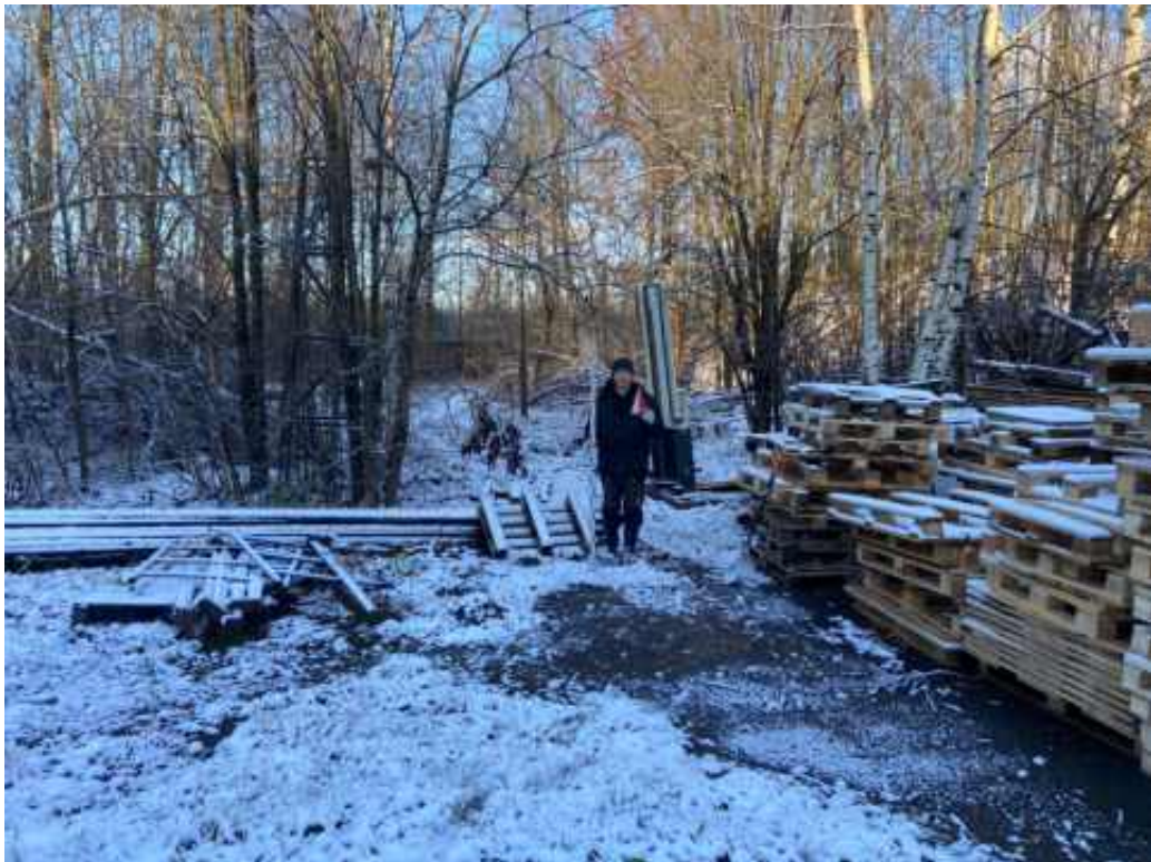
Рис. 26. Санкт-Петербург, земельный участок по объекту: «Проектирование строительства автомобильной дороги № 2 на участке от автомобильной дороги № 1 до кругового движения продолжения проспекта Маршала Блюхера». Photo 7. Общий вид территории обследования. Вид с юга.
