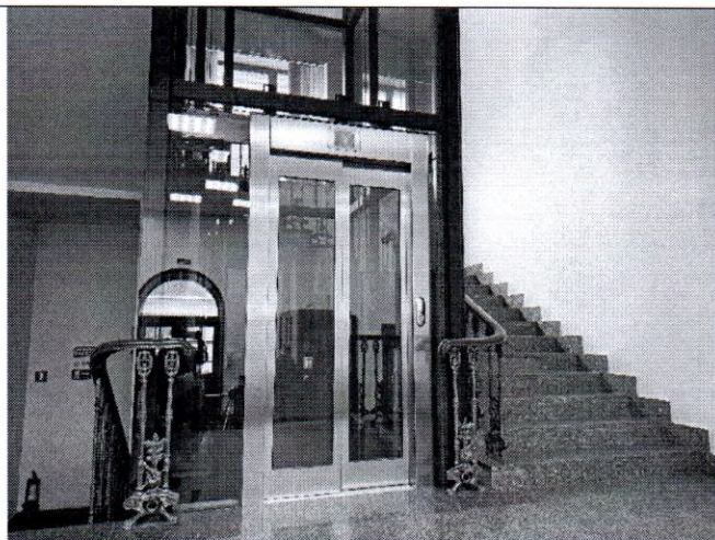
Фото 25. Лестница (2ЛК) (фото от 12.05.2022).
