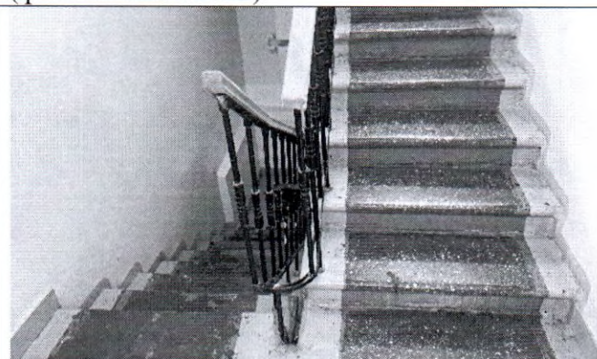
Фото 18. Лестница (пом. 2-Н (25) (фото от 12.05.2022).
