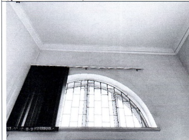
Фото 57. Помещение 1 этажа (пом. 2-Н (45) (фото от 12.05.2022).
