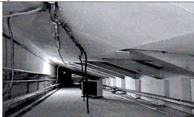
Фото 17. Фрагмент конструкции крыши (фото от 12.05.2022).
