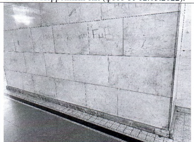
Фото 42. Перронный зал (фото от 12.05.2022).
