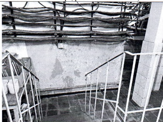
Фото 28. Помещение подвала (2-Н (21) (фото от 05.09.2022).
