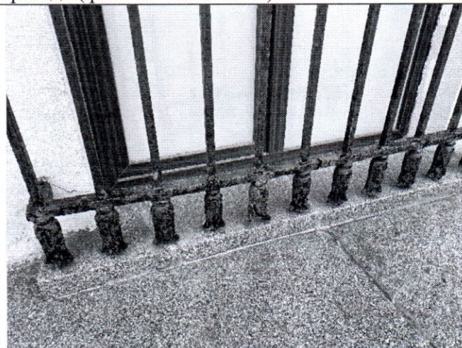
Фото 10. Фрагмент северо-западного фасада (фото от 12.05.2022).
