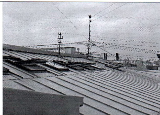
Фото 16. Фрагмент кровли (фото от 12.05.2022).
