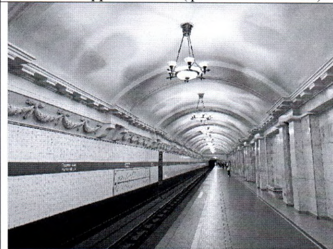
Фото 39. Перронный зал (фото от 12.05.2022).
