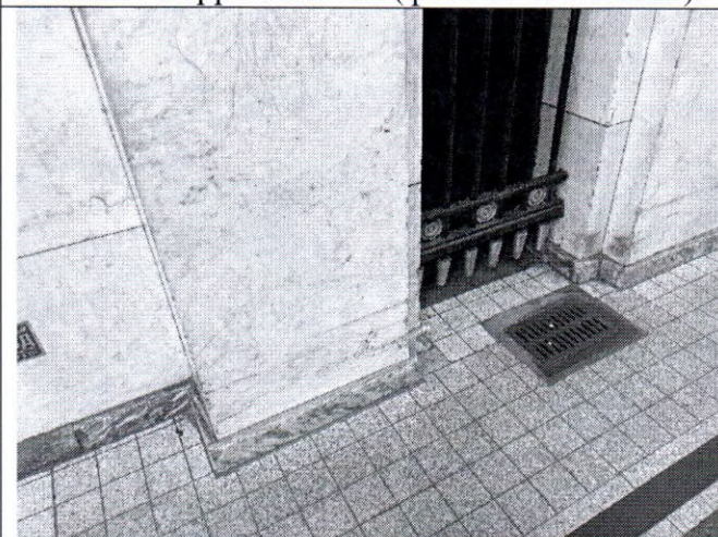
Фото 41. Перронный зал (фото от 12.05.2022).
