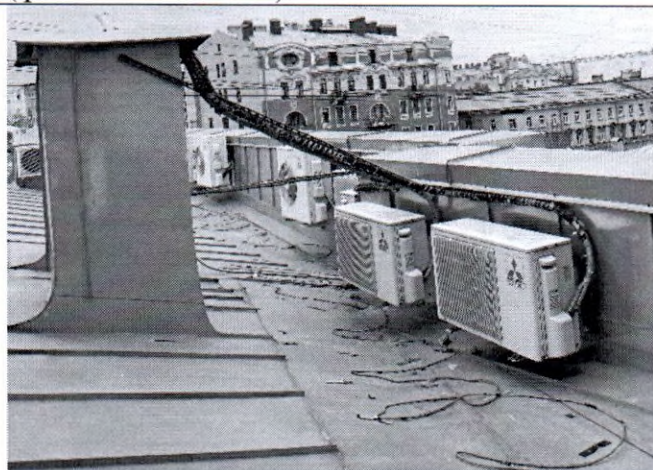
Фото 15. Фрагмент кровли (фото от 12.05.2022).
