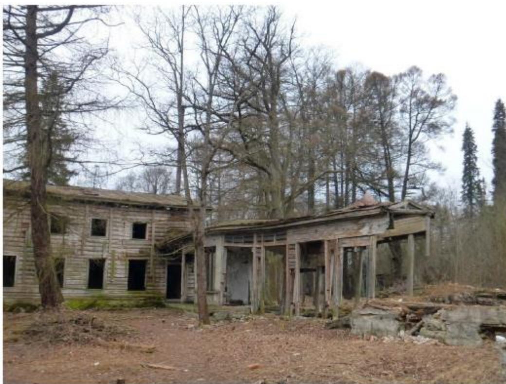
Илл.81. Галерея левого флигеля до разрушения.
