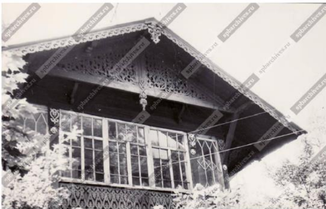
Илл.89. Вид части фасада деревянного дачного дома по улице Межозерной, 4 (бывшая дача Гербель, конец 19 века. Второй этаж поврежден при пожаре 1997-1998 гг.). 28 июля 1976 г. Центральный государственный архив кинофотофонодокументов Санкт-Петербурга Ар 224551
