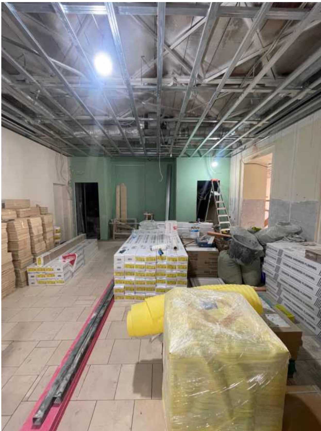
16. Помещение 3 (согласно техническому паспорту). 1 этаж.
