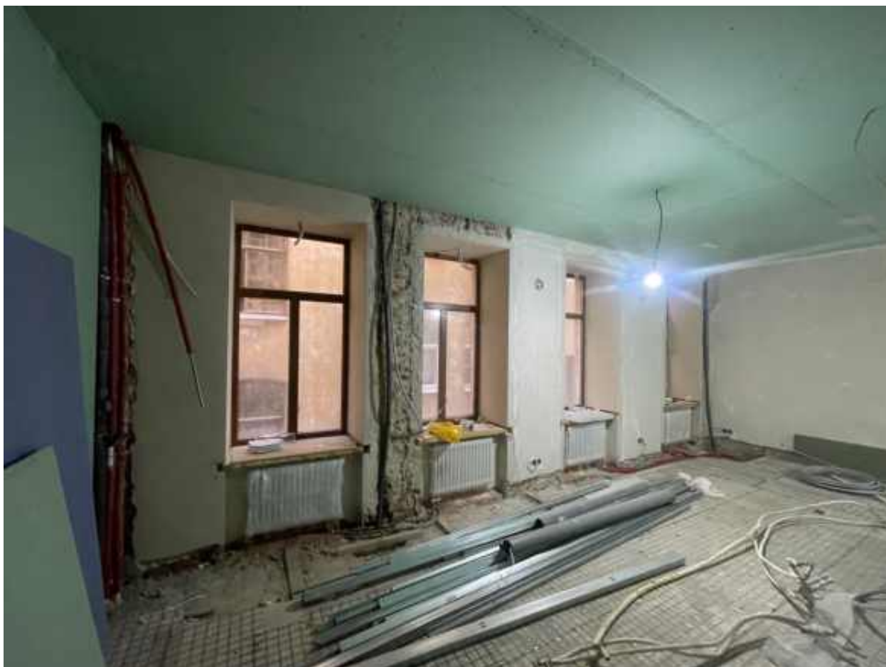
26. Помещение 10 (согласно техническому паспорту). 2 этаж.
