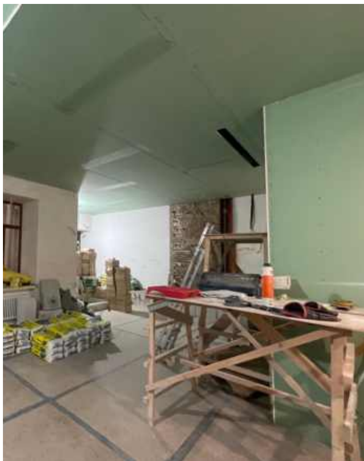
22. Помещение 9 (согласно техническому паспорту). 2 этаж.
