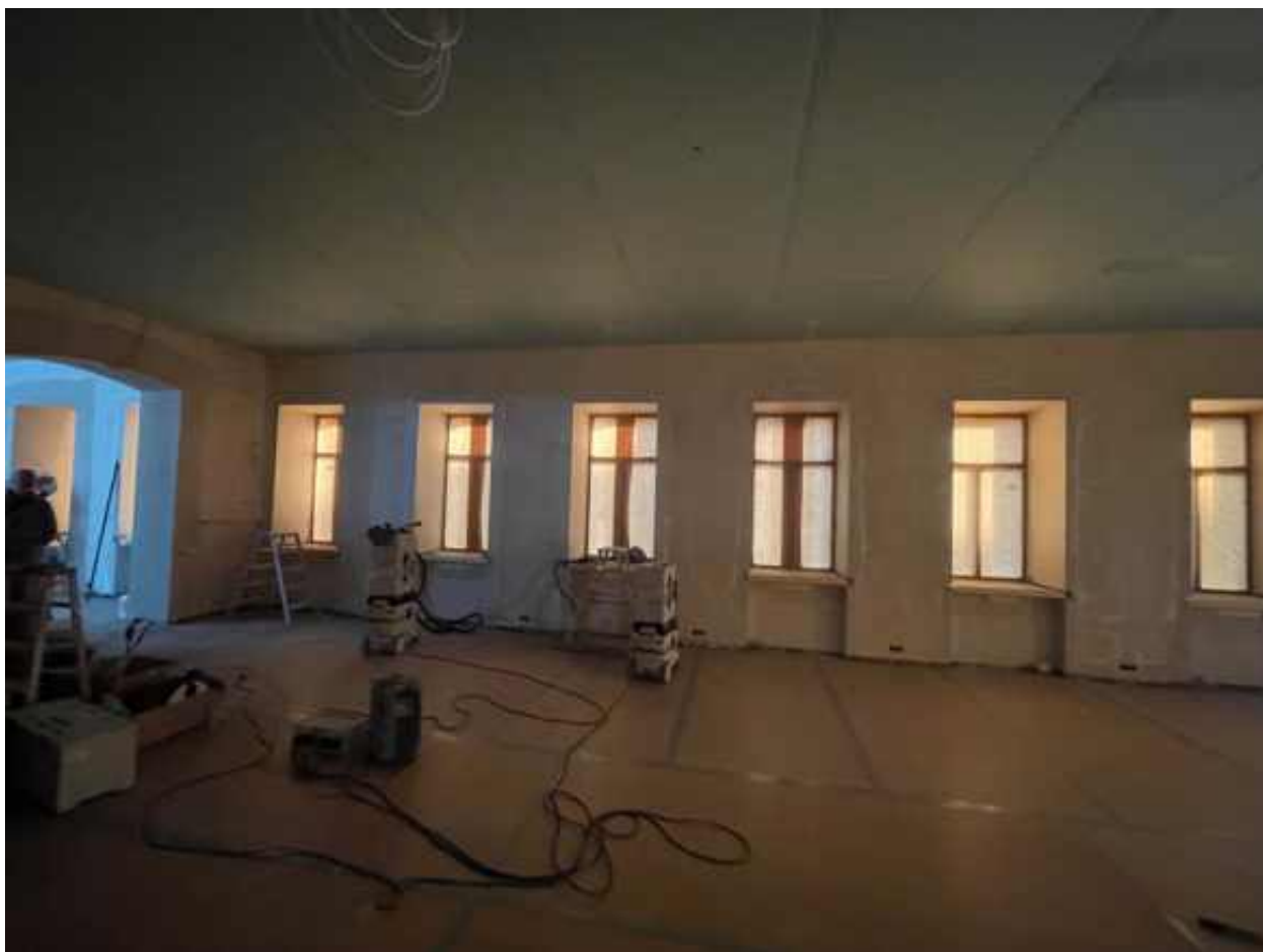
34. Помещение 12 (согласно техническому паспорту). 2 этаж.
