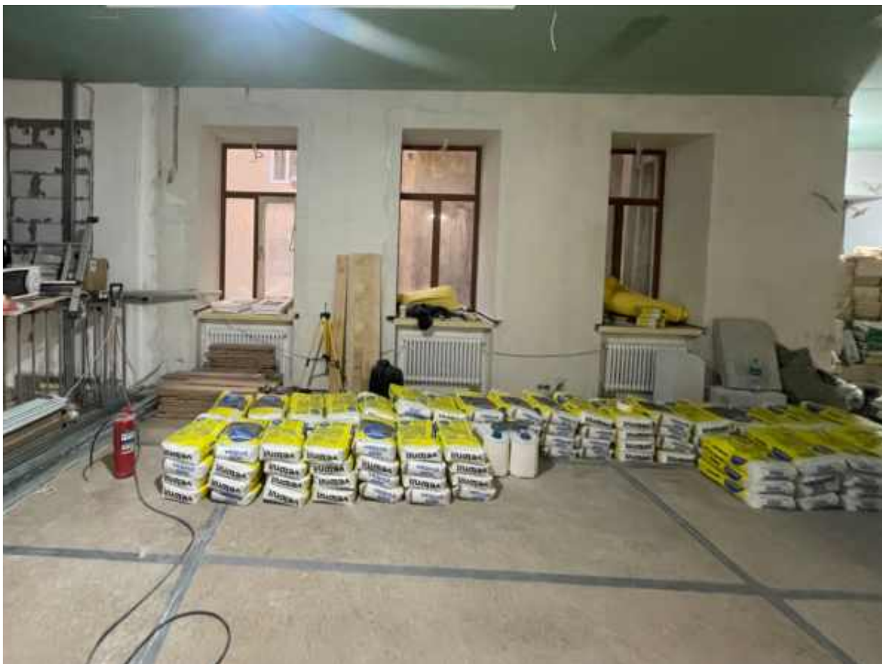
21. Помещение 9 (согласно техническому паспорту). 2 этаж.
