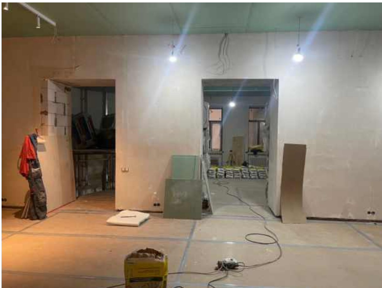
32. Помещение 11 (согласно техническому паспорту). 2 этаж.
