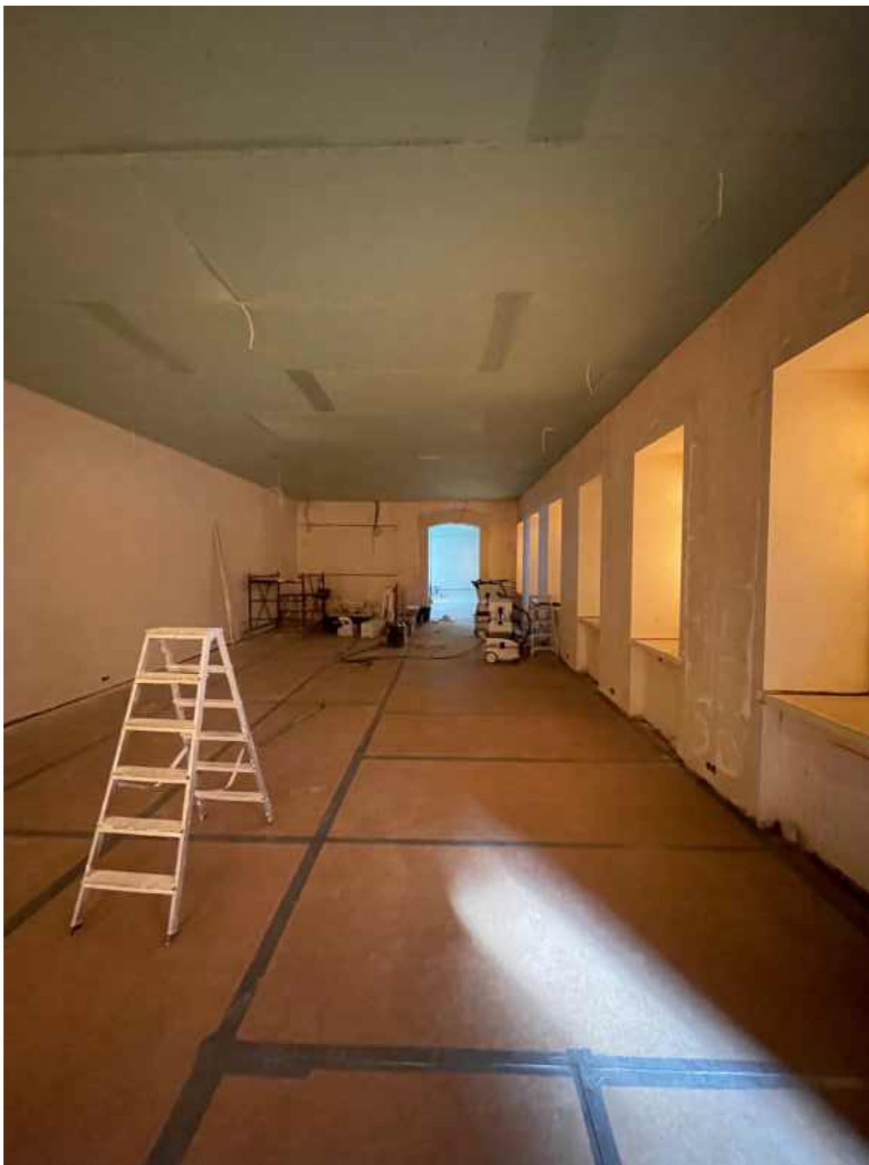
37. Помещение 12 (согласно техническому паспорту). 2 этаж.
