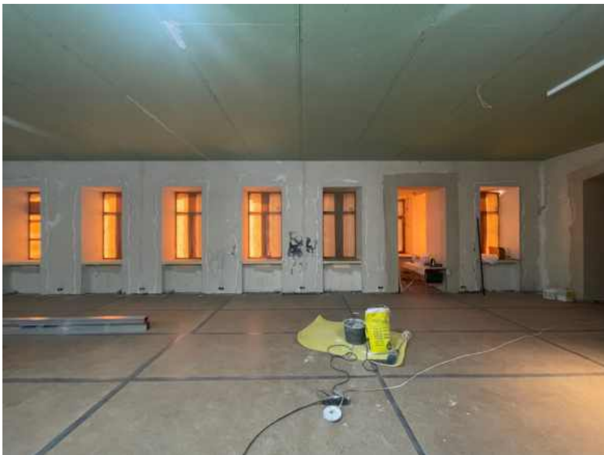
30. Помещение 11 (согласно техническому паспорту). 2 этаж.
