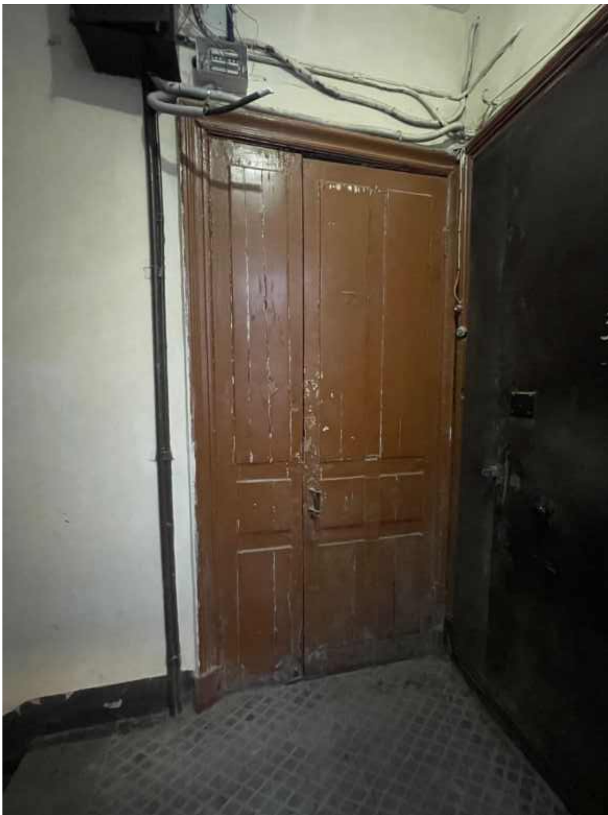
39. Входные двери в помещение 41-Н со стороны лестничной клетки в уровне 2 этажа.
