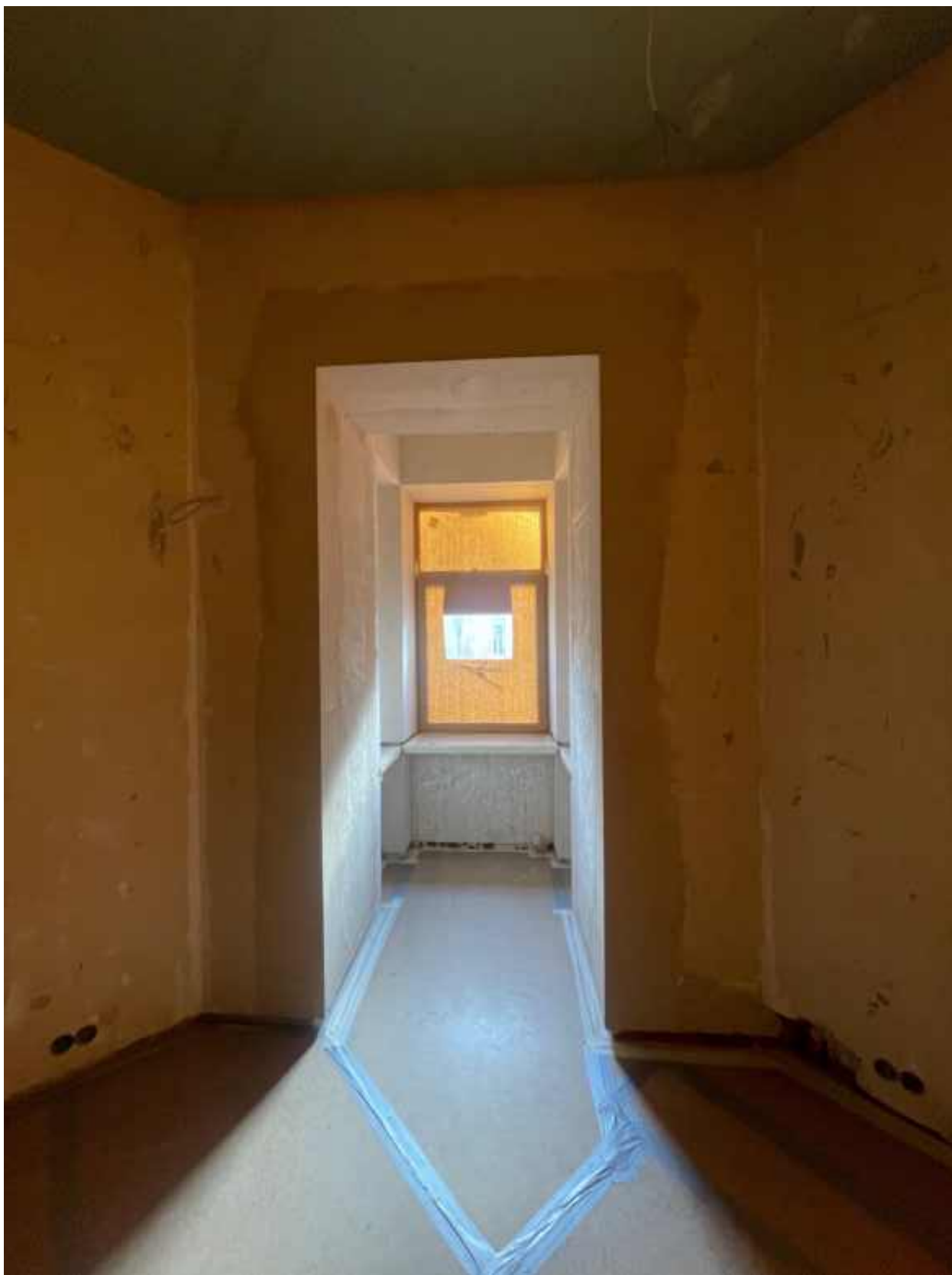
36. Помещение 12 (согласно техническому паспорту). 2 этаж.
