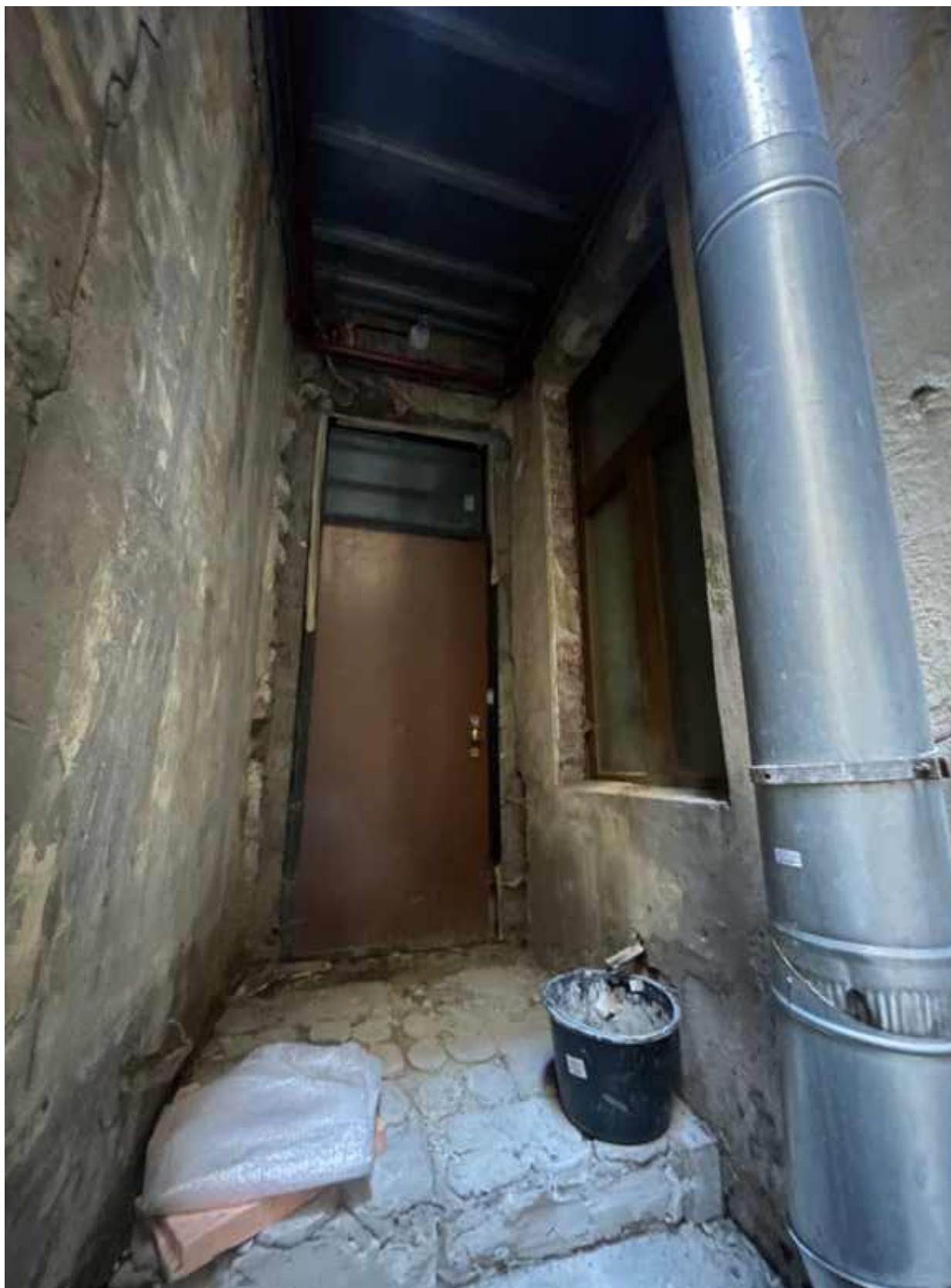
8. Дверной проем помещения 41-Н со стороны дворового помещения.
