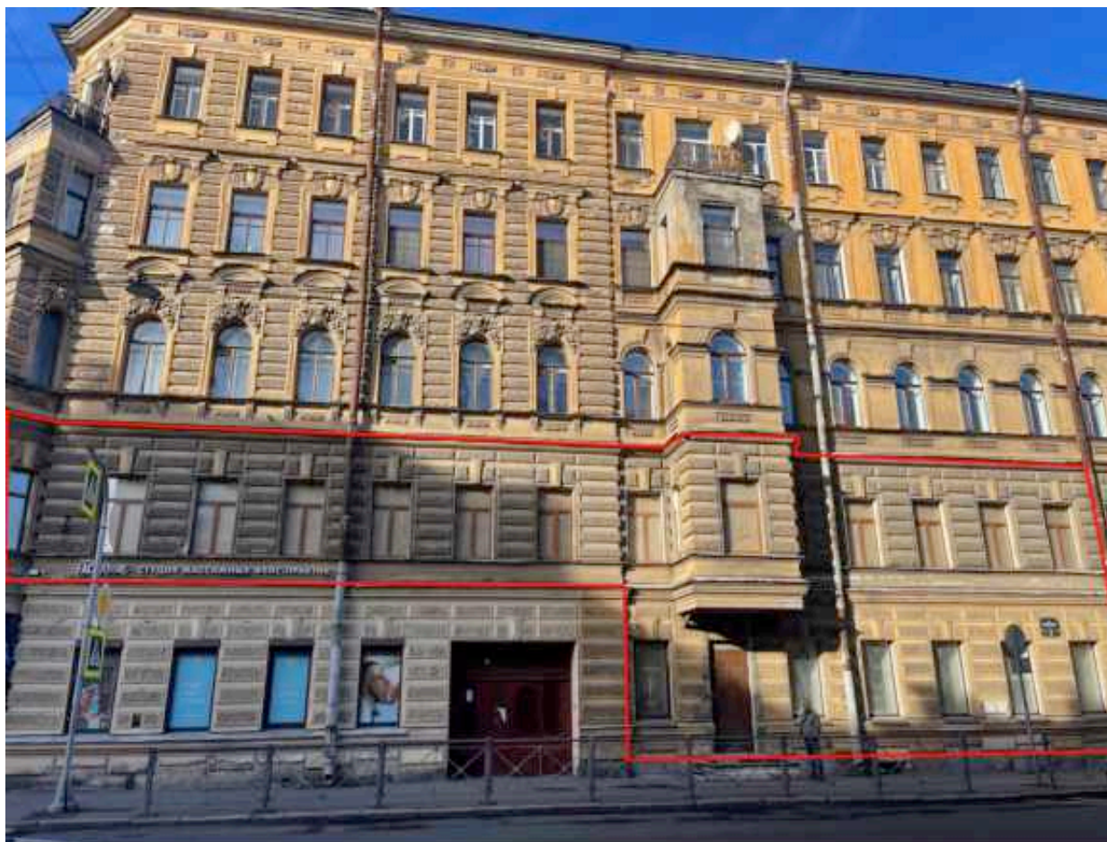
2. Фрагмент лицевого фасада со стороны Радищева переулка. Красной линией выделены оконные проемы помещения 41-Н.
