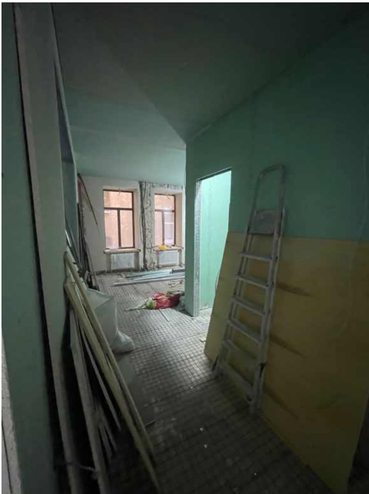
24. Помещение 10 (согласно техническому паспорту). 2 этаж.
