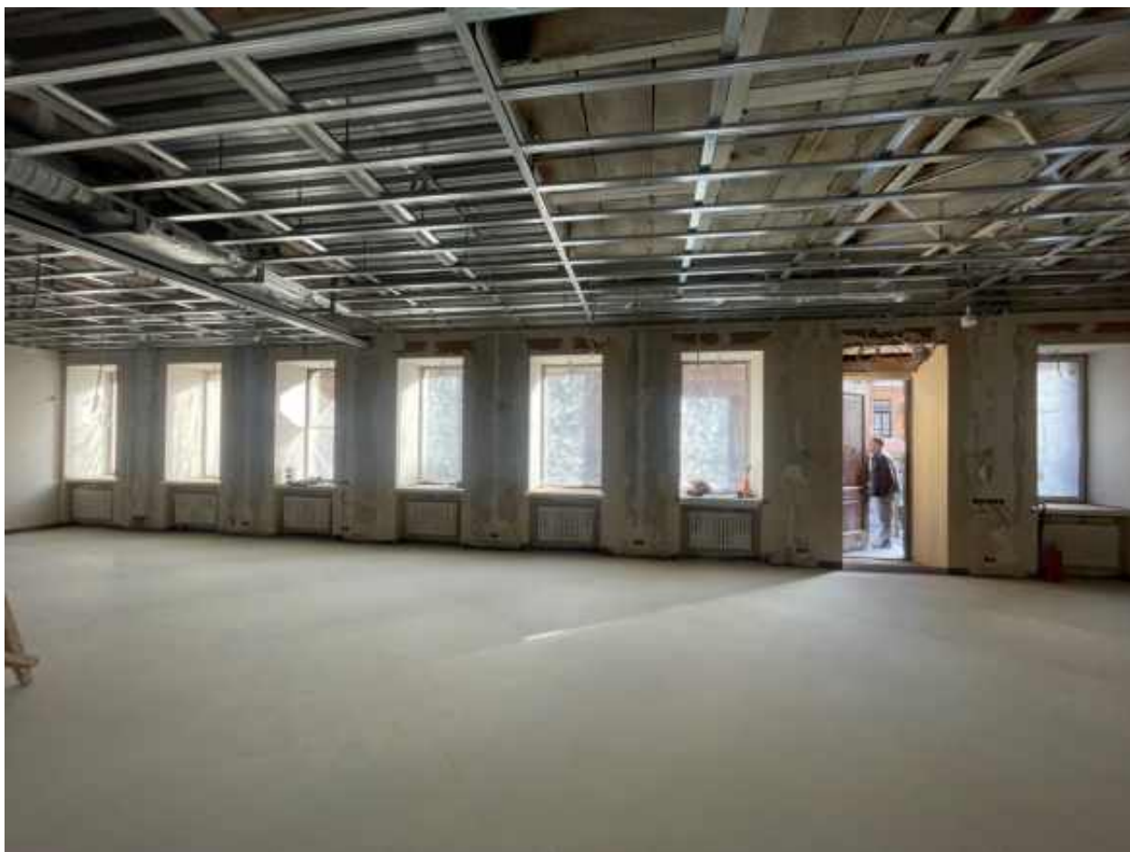
12. Помещение 1 (согласно техническому паспорту). 1 этаж.
