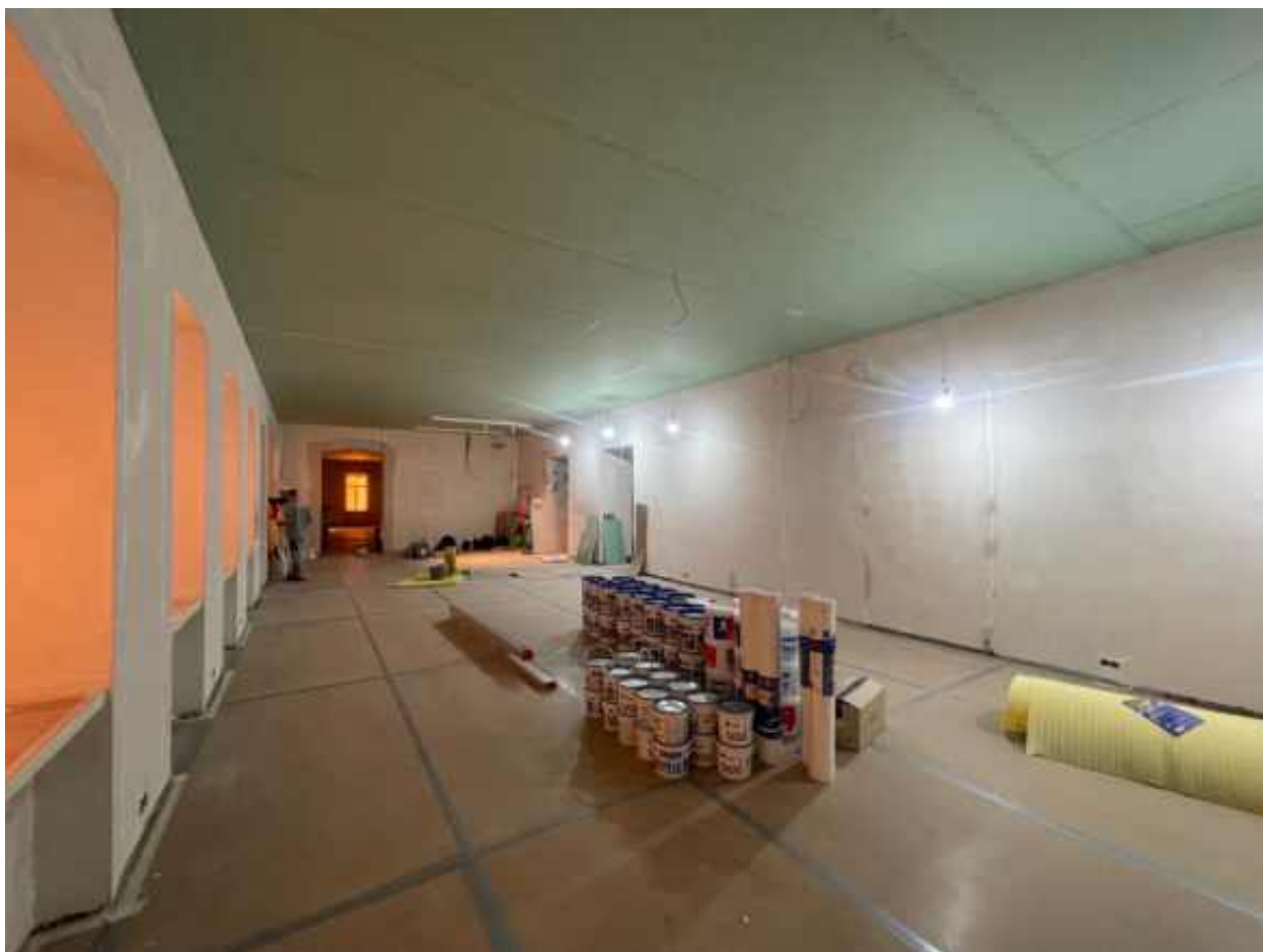
31. Помещение 11 (согласно техническому паспорту). 2 этаж.
