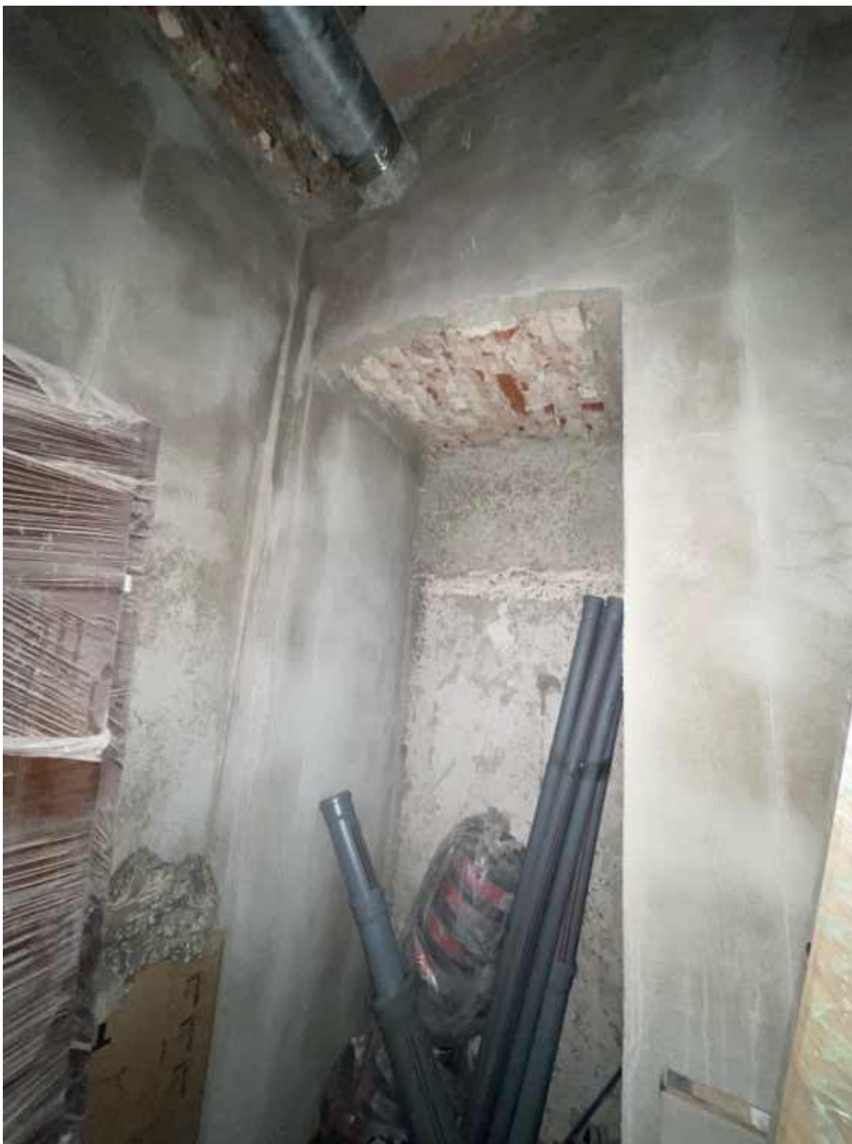
19. Помещение 5 (согласно техническому паспорту). 1 этаж.
