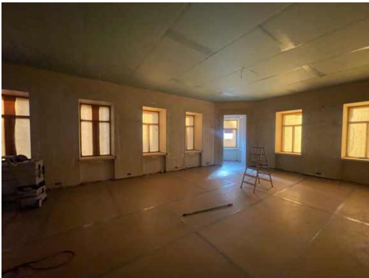
35. Помещение 12 (согласно техническому паспорту). 2 этаж.
