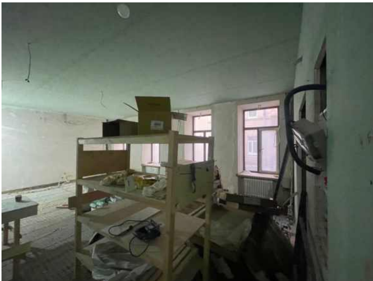
25. Помещение 10 (согласно техническому паспорту). 2 этаж.
