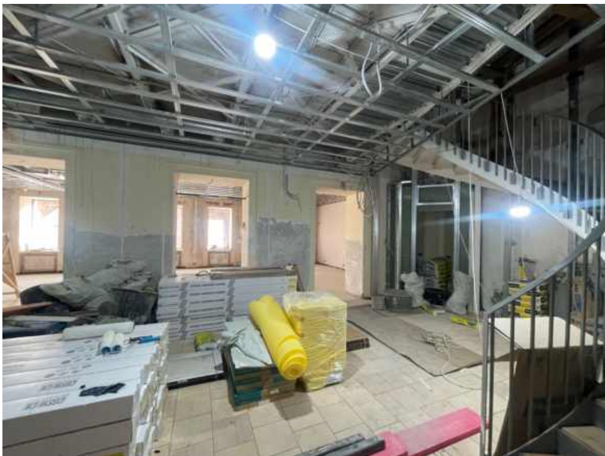
17. Помещение 3 (согласно техническому паспорту). 1 этаж.
