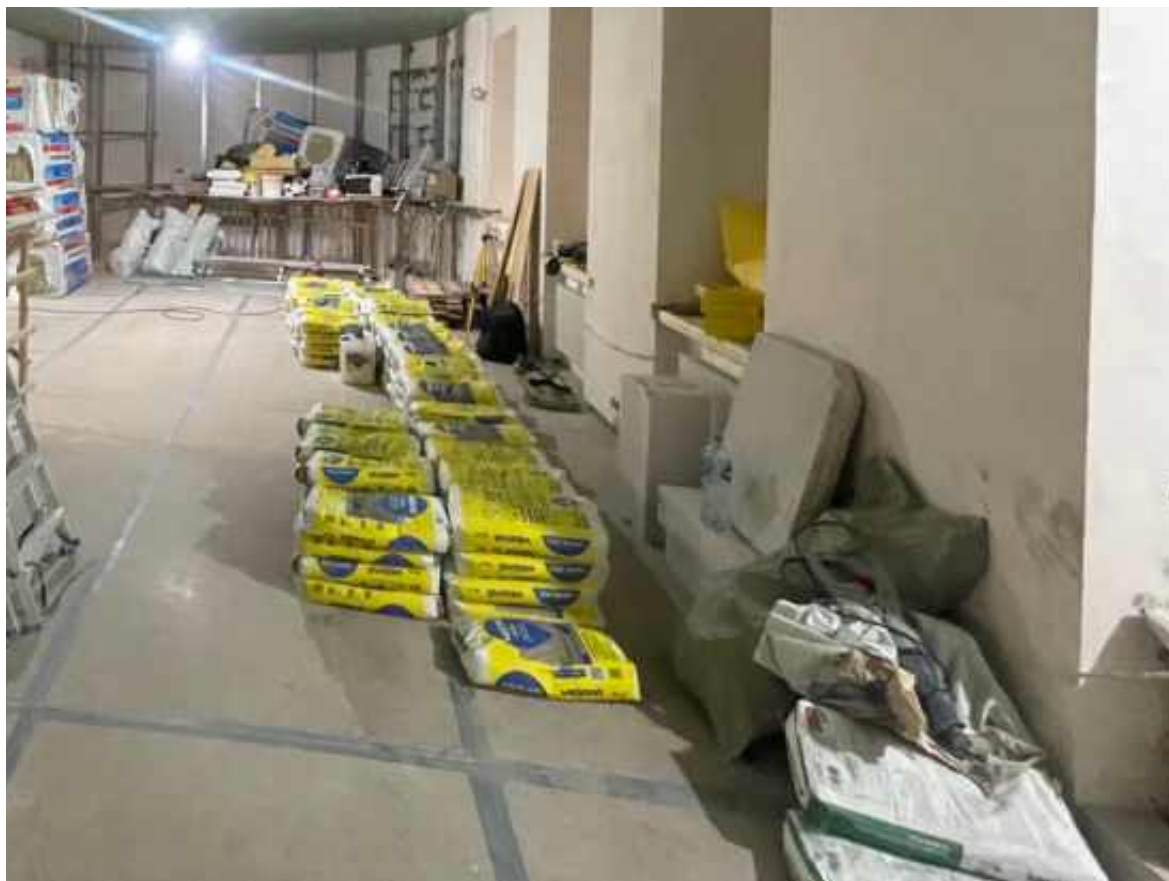
23. Помещение 9 (согласно техническому паспорту). 2 этаж.
