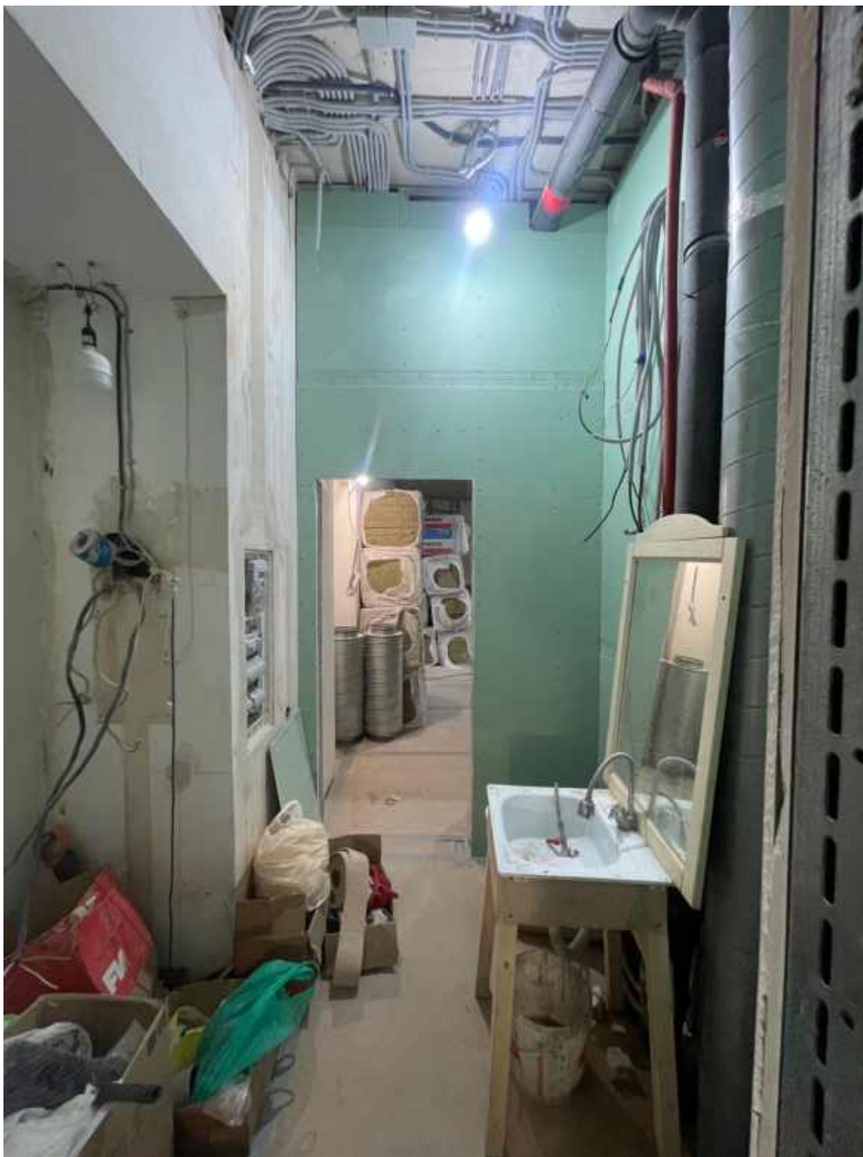
28. Помещение 10 (согласно техническому паспорту). 2 этаж.
