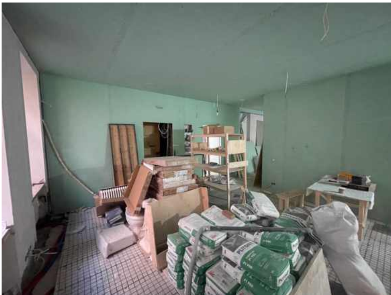
29. Помещение 10 (согласно техническому паспорту). 2 этаж.
