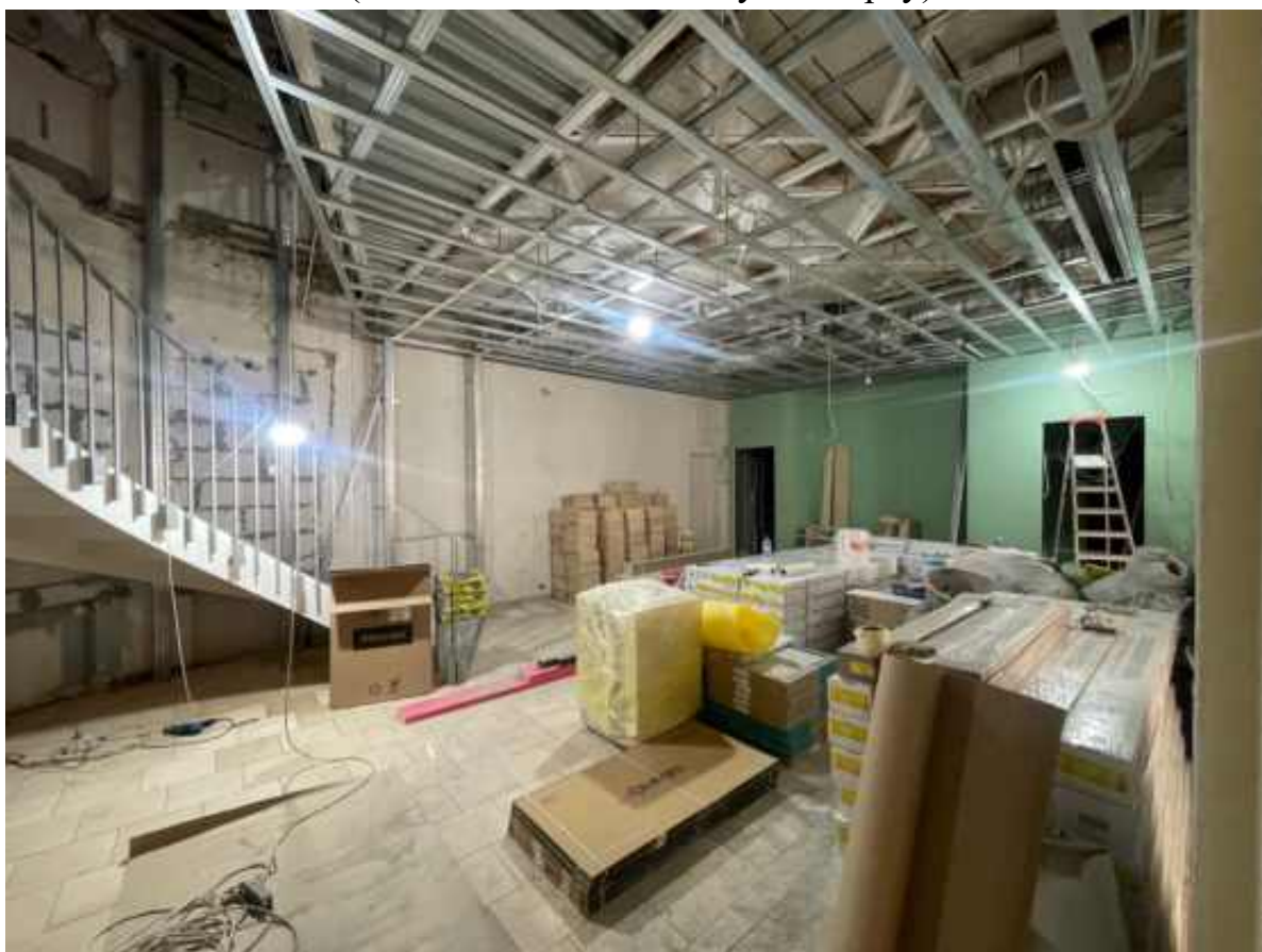
14. Помещение 3 (согласно техническому паспорту). 1 этаж.
