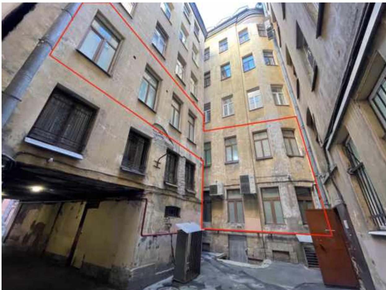
11. Общий вид дворовых фасадов. Красной линией отмечены оконные проемы помещения 41-Н в уровне 1 и 2 этажей.
