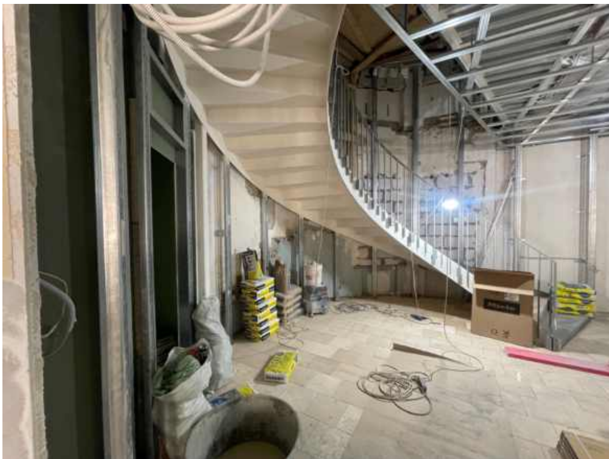
15. Помещение 3 (согласно техническому паспорту). 1 этаж.
