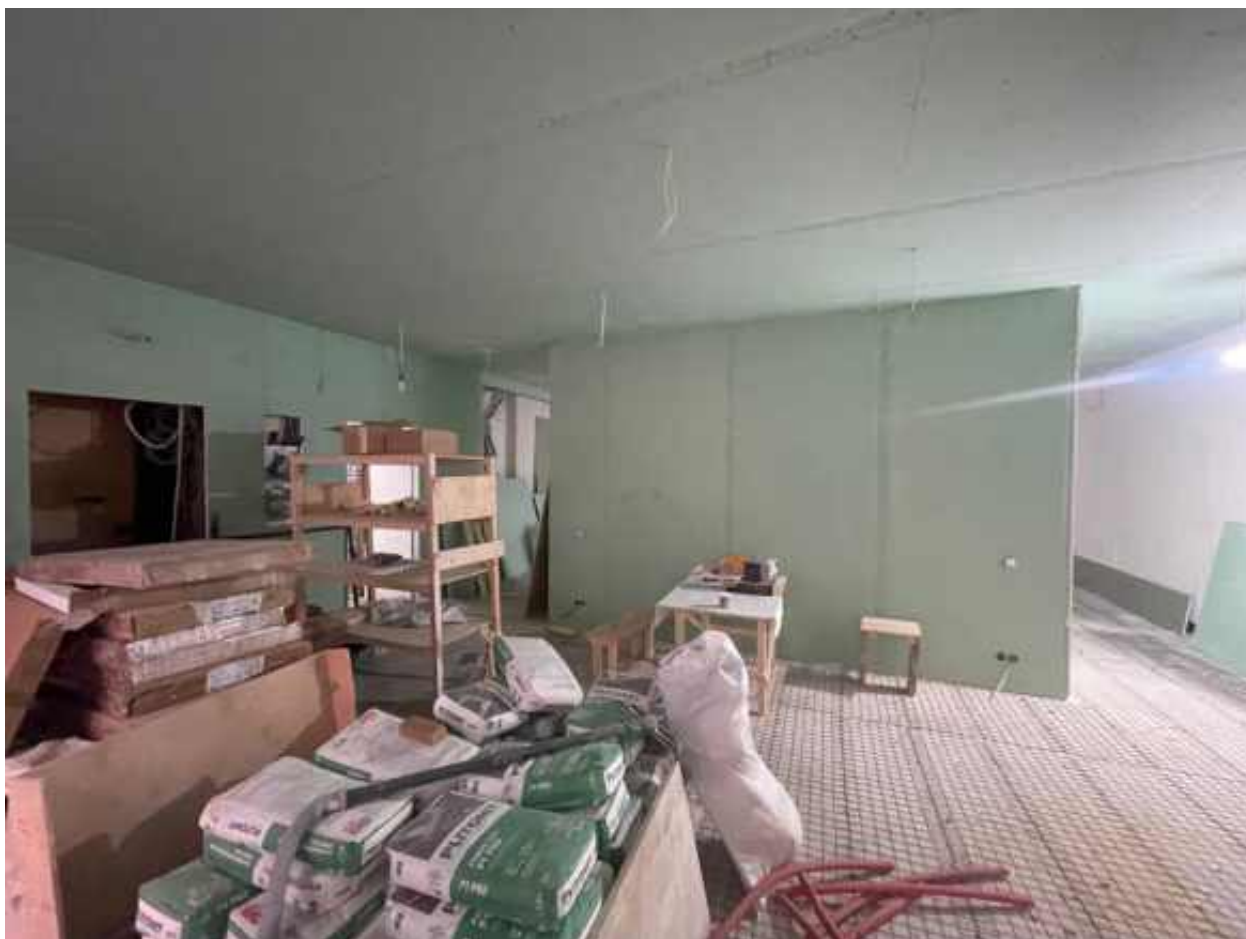
27. Помещение 10 (согласно техническому паспорту). 2 этаж.
