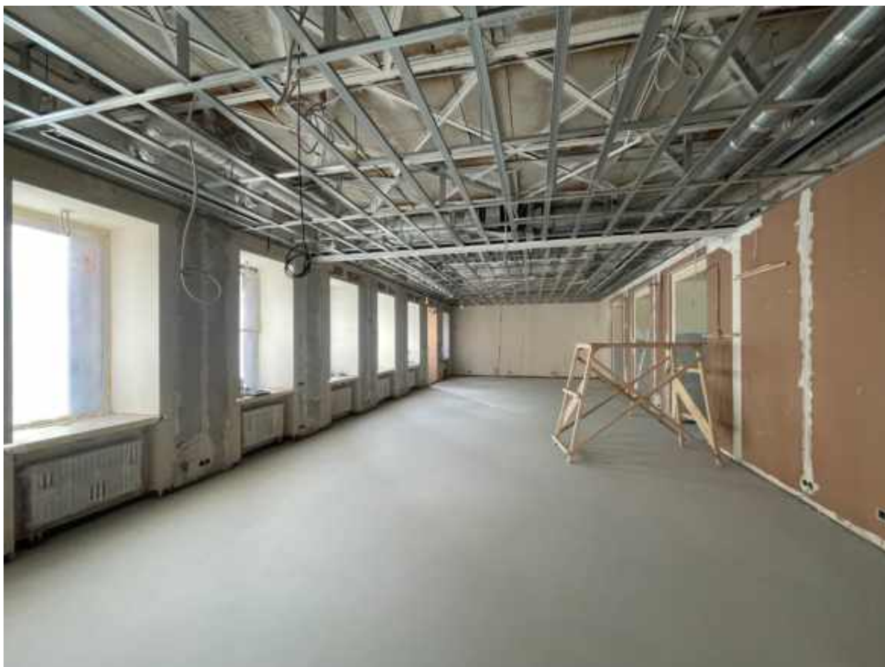
13. Помещение 1 (согласно техническому паспорту). 1 этаж.
