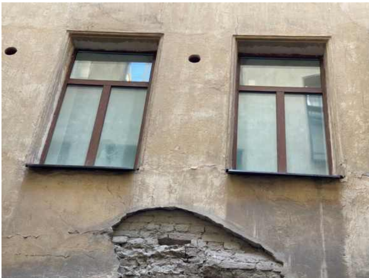
10. Оконные заполнения проемов помещения 41-Н со стороны дворового фасада в уровне 3 этажа.
