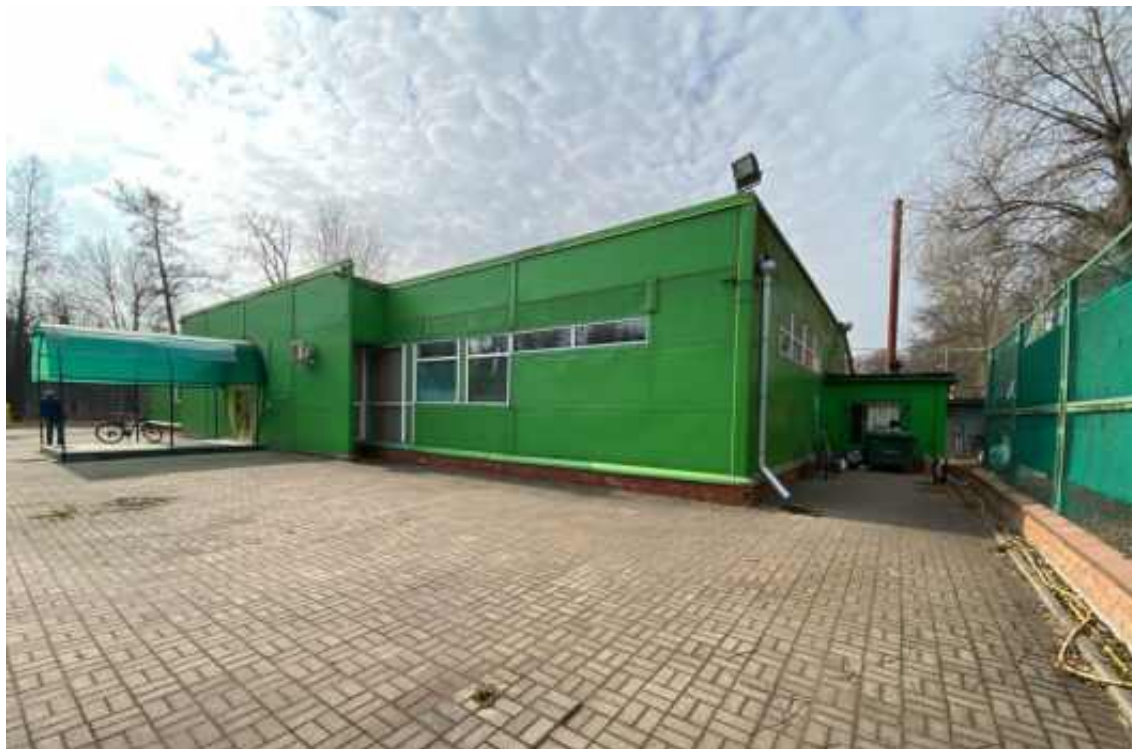
Фото 5. Здание по адресу: г. Санкт-Петербург, Театральная аллея, дом 18, литера Г1. Вид с северо-восточной стороны. Съемка 06.04.2026 г. Полетайкин В.В.
