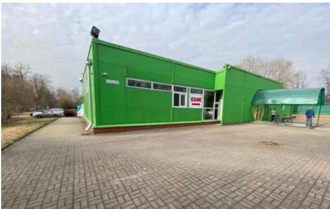
Фото 4. Здание по адресу: г. Санкт-Петербург, Театральная аллея, дом 18, литера Г1. Вид с юго-восточной стороны. Съемка 06.04.2026 г. Полетайкин В.В.
