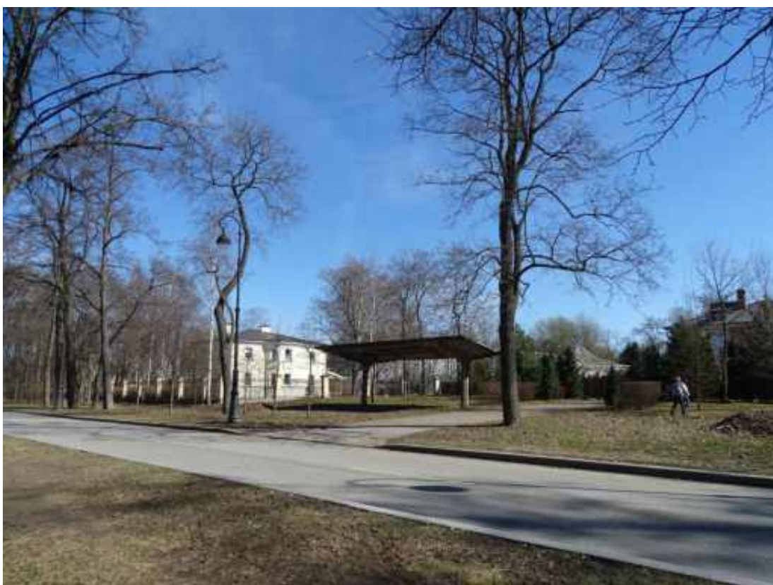
Фото 6. Вид на территорию объекта культурного наследия регионального значения "Жилой дом" с северо-западной стороны. Объект культурного наследия регионального значения «Железобетонный навес товарищества "Железо-бетон"». Съемка 18.04.2023 г. Полетайкин В.В.
