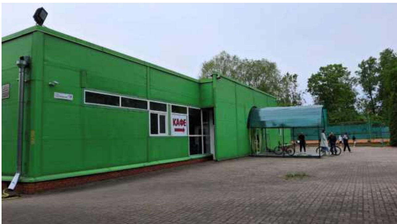
Фото 4. Здание по адресу: г. Санкт-Петербург, Театральная аллея, дом 18, литера Г1. Восточный фасад. Съемка 30.05.2025 г. Полетайкин В.В.
