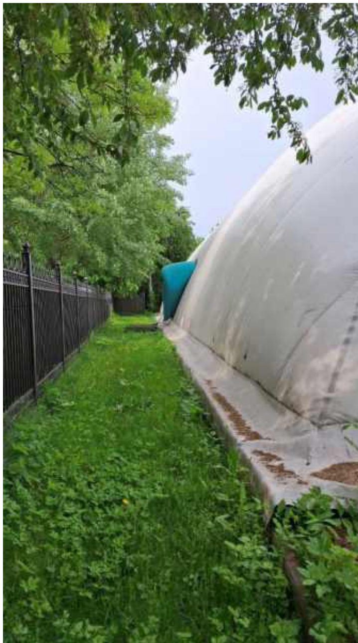
Фото 13. Сооружение по адресу: г. Санкт-Петербург, Театральная аллея, дом 18, литера А. Западная часть здания. Съемка 30.05.2025 г. Полетайкин В.В.
