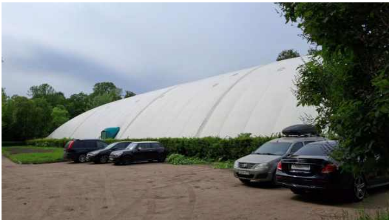
Фото 3. Сооружение по адресу: г. Санкт-Петербург, Театральная аллея, дом 18, литера А. Вид с восточной стороны. Съемка 30.05.2025 г. Полетайкин В.В.
