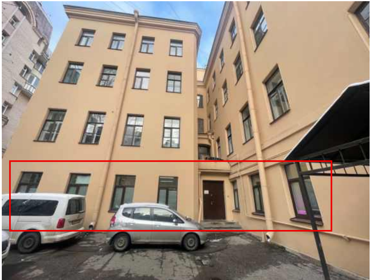
4. Общий вид дворового фасада. Красной линией отмечены оконные и дверной проемы помещения.
