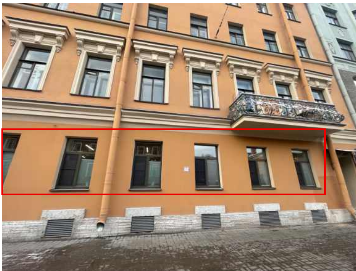
2. Фрагмент лицевого фасада. Красной линией отмечены оконные проемы помещения.
