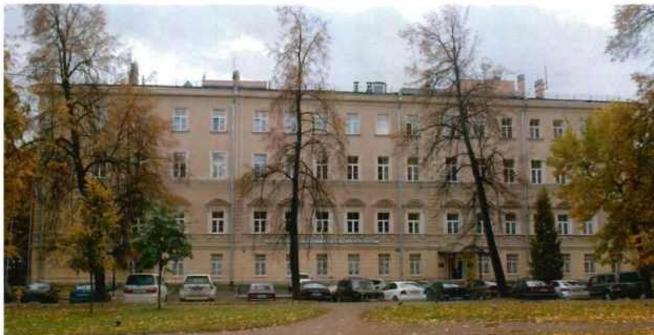
1. Вид на северный фасад объекта культурного наследия
