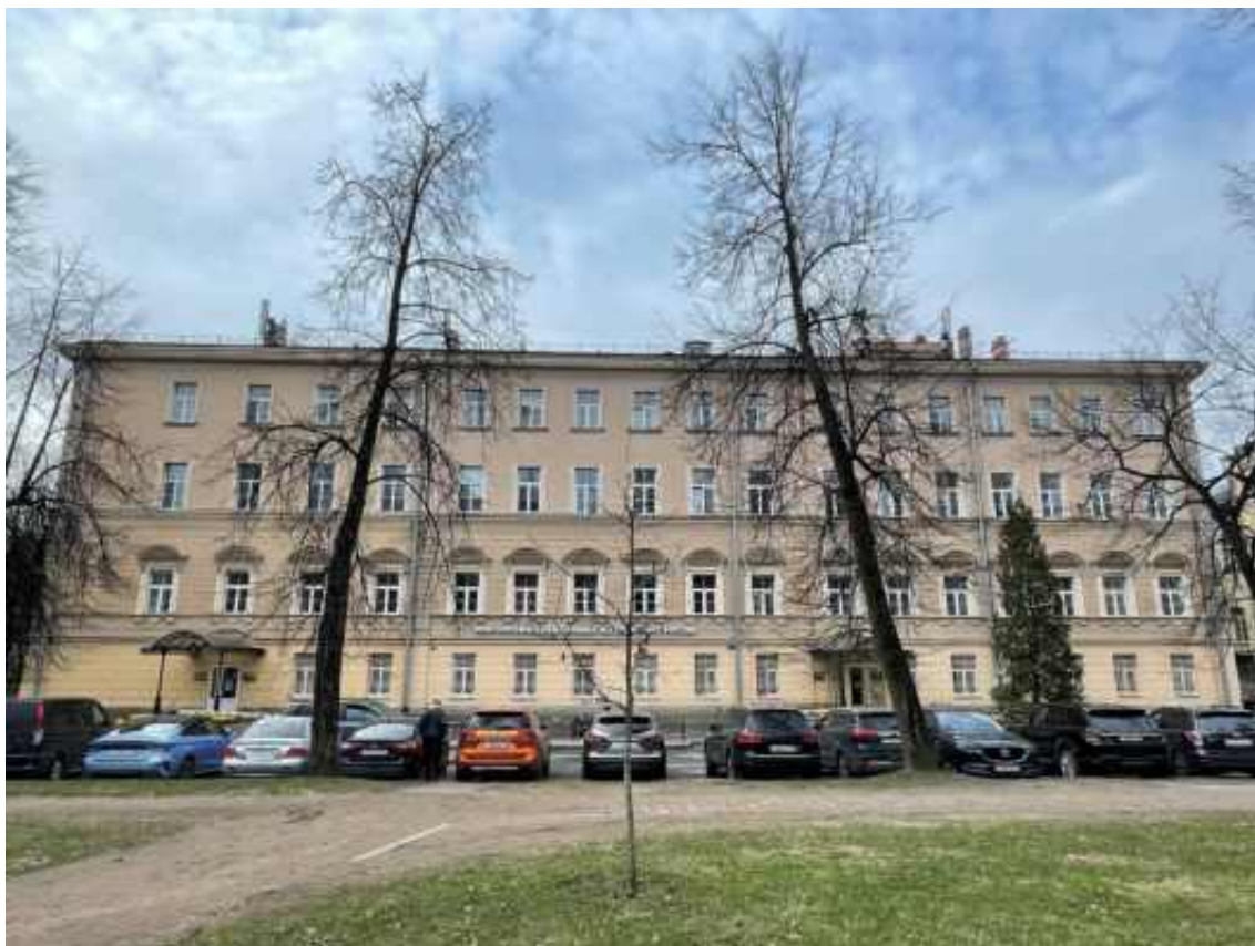
Фото 1. Фрагмент лицевого фасада объекта культурного наследия федерального значения «Школа военно-фельдшерская», входящего в состав объекта культурного наследия федерального значения «Академия Императорская Медико-хирургическая (Военно-Медицинская)» (по Клинической ул.)
