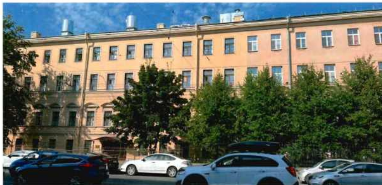
2. Вид на восточный фасад объекта культурного наследия, фрагмент
