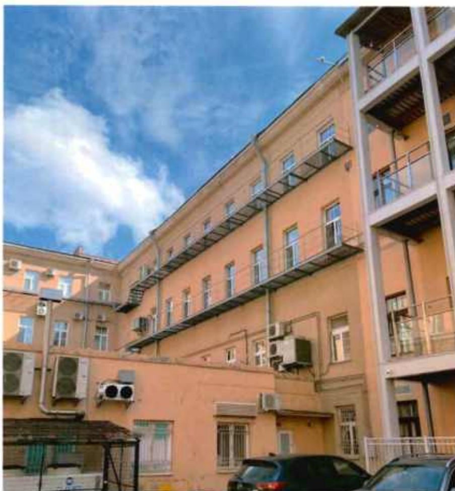
5. Вид на дворовый фасад объекта культурного наследия, фрагмент
