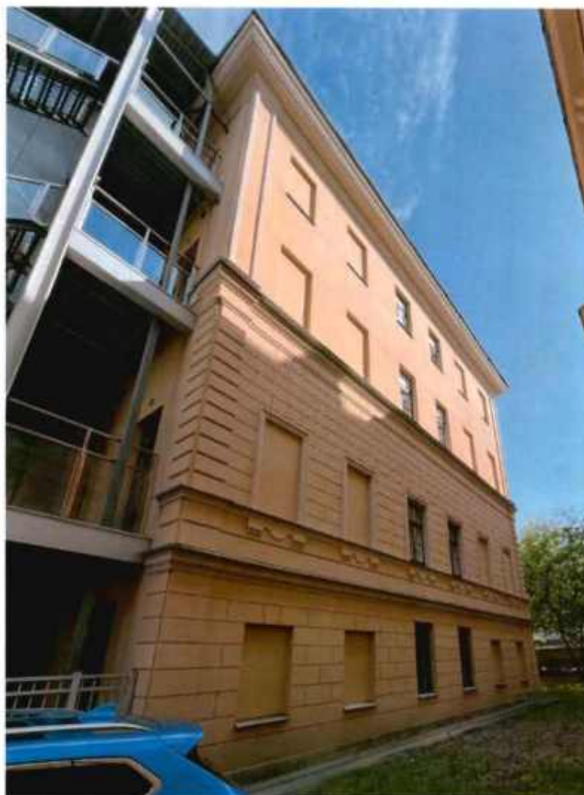
4. Вид на торцевой южный фасад объекта культурного наследия
