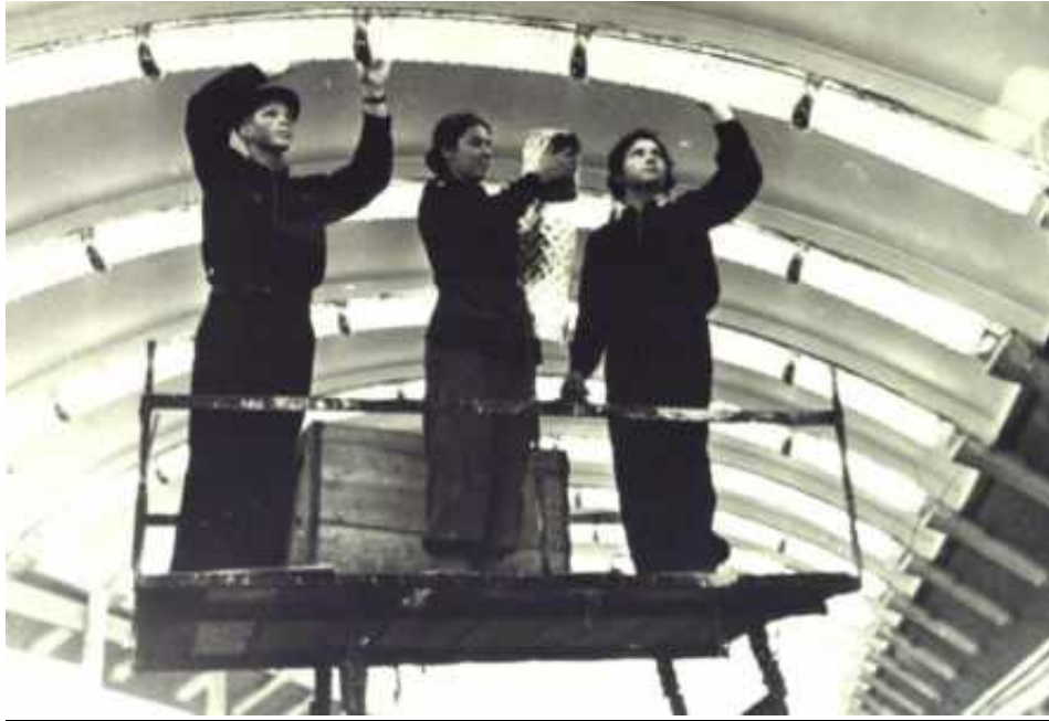
Илл. 24. Электромонтеры за установкой осветительных приборов в подземном вестибюле станции "Площадь Восстания". Дата съемки: 1955 г. Авторы съемки: Лосин Борис Семенович (Соломонович). // ЦГАКФФД СПб. Фотодокументы. Оп.1АР-120. Ед.хр.164988
