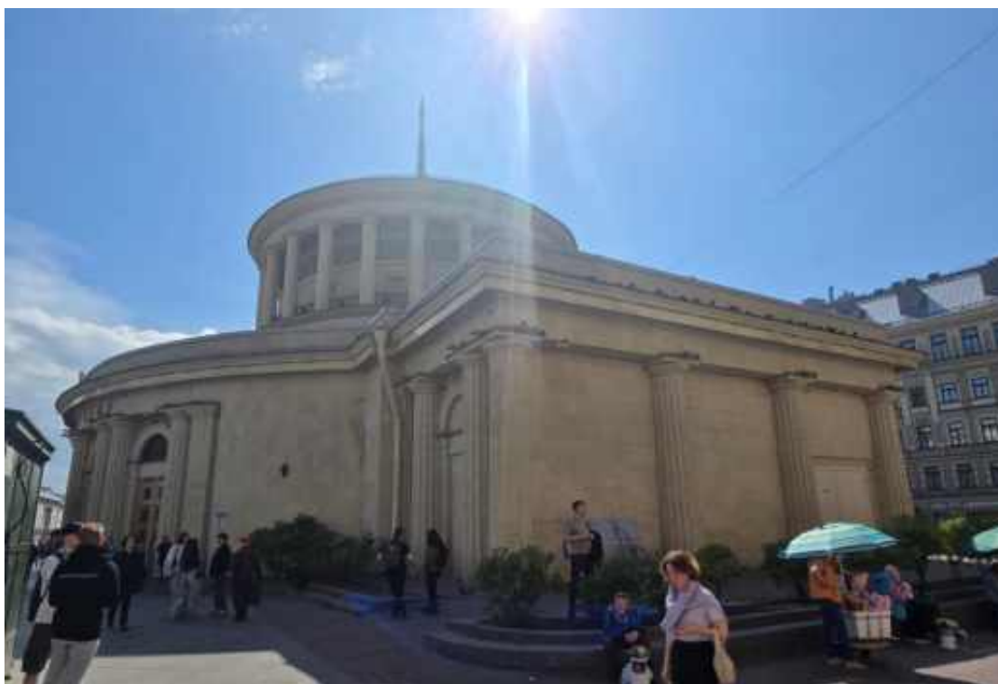
Фото 2. Станция метро «Площадь Восстания», фрагмент северного и восточного фасадов, вид с Лиговского проспекта.
