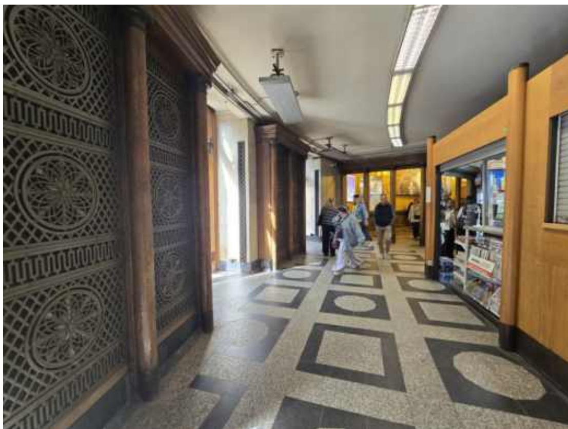
Фото 1.12. 1 этаж, тамбур выхода, помещение 1-Н (9).
