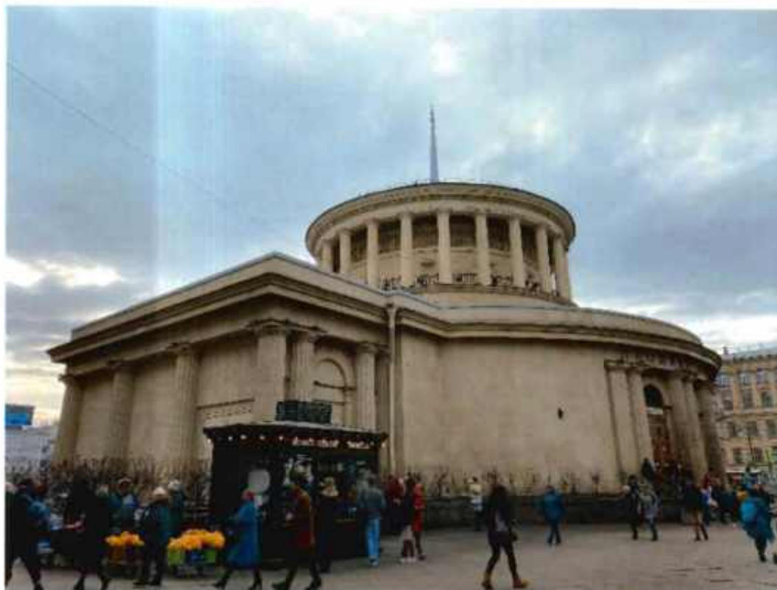
2. Общий вид на объект культурного наследия.
