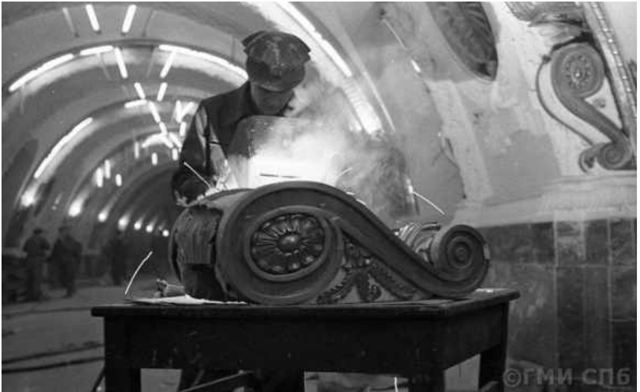
Илл. 22. Строительство станции метро "Площадь Восстания". Сварочные работы в подземном вестибюле. Период создания:1955 г. // https://goskatalog.ru/portal/#/collections?id=25909016 (Номер в Госкаталоге: 25761259. Номер по КП (ГИК): ГМИ СПб 421551. Инвентарный номер: ГМИ СПб Инв.№-II-A-1790 н)
