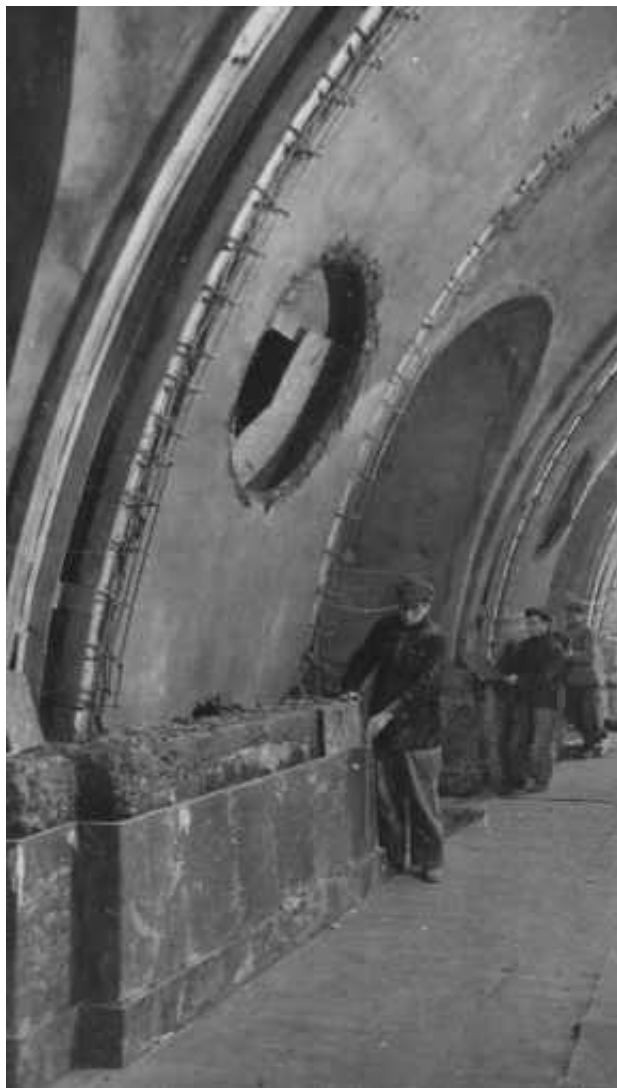
Илл. 25. Отделочные работы на станции метро "Площадь Восстания". Дата съемки: 25 апреля 1955 г. Авторы съемки: Науменков Николай Афанасьевич. // ЦГАКФФД СПб. Фотодокументы. Оп.1АР-81. Ед.хр.121777
