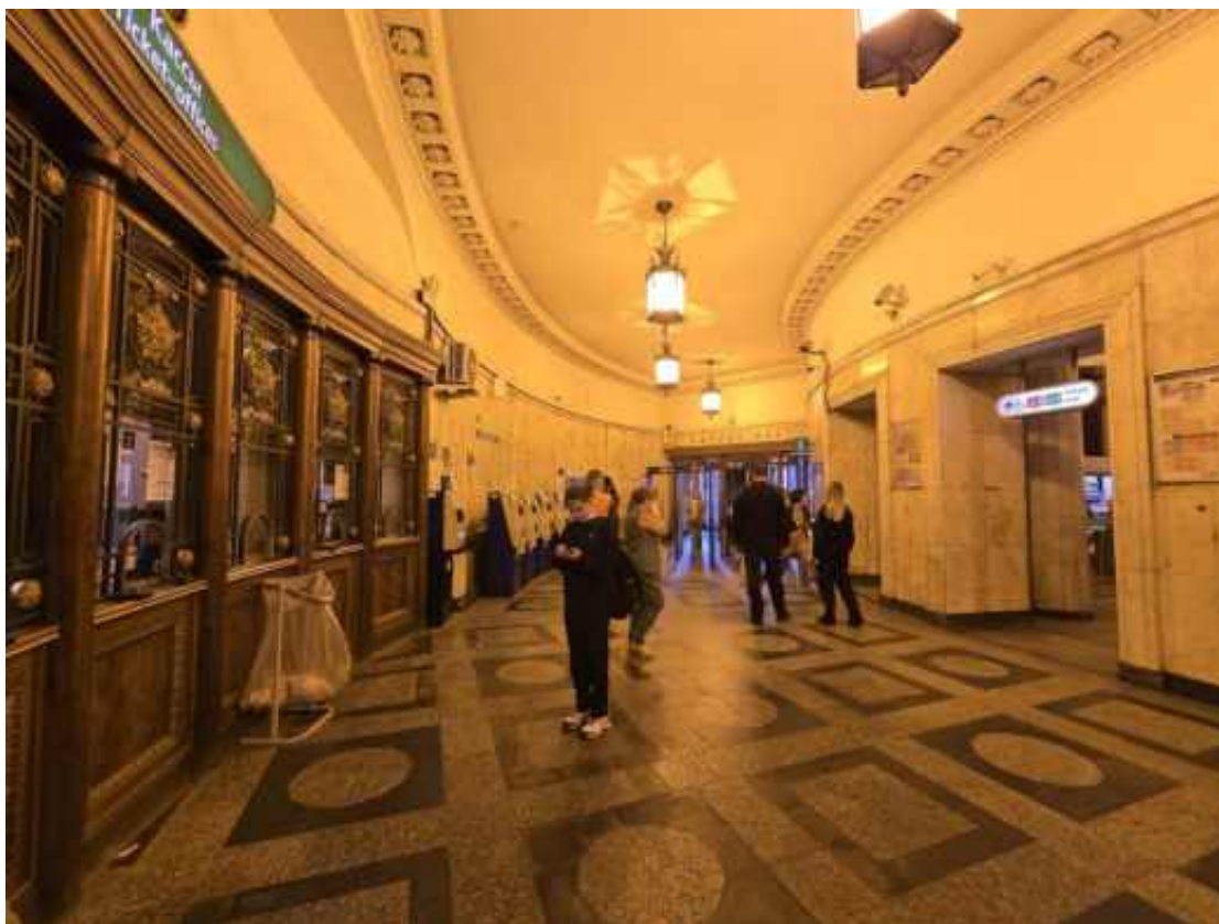
Фото 1.3. 1 этаж, кассовый зал, помещение 1-Н (2).
