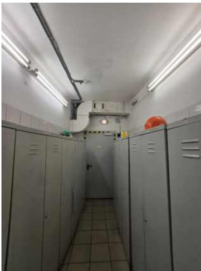
Фото п.14. Подвал, помещение 1-Н (51).
