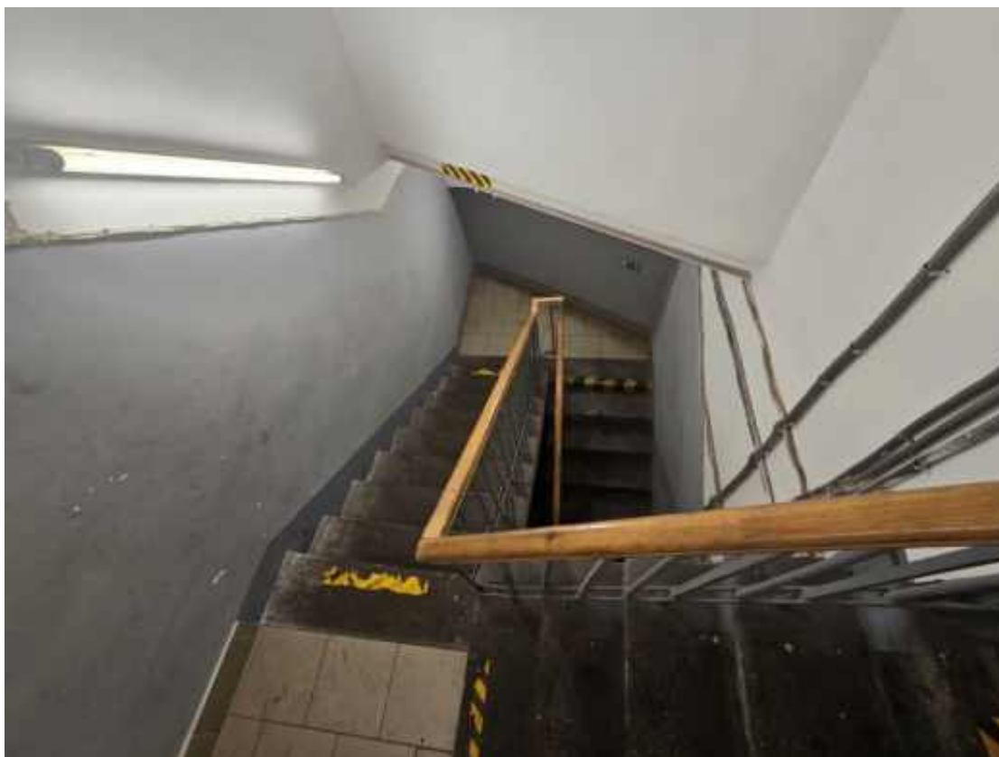
Фото 1.23. 1 этаж, лестница в подвал, помещение 1-Н (45).
