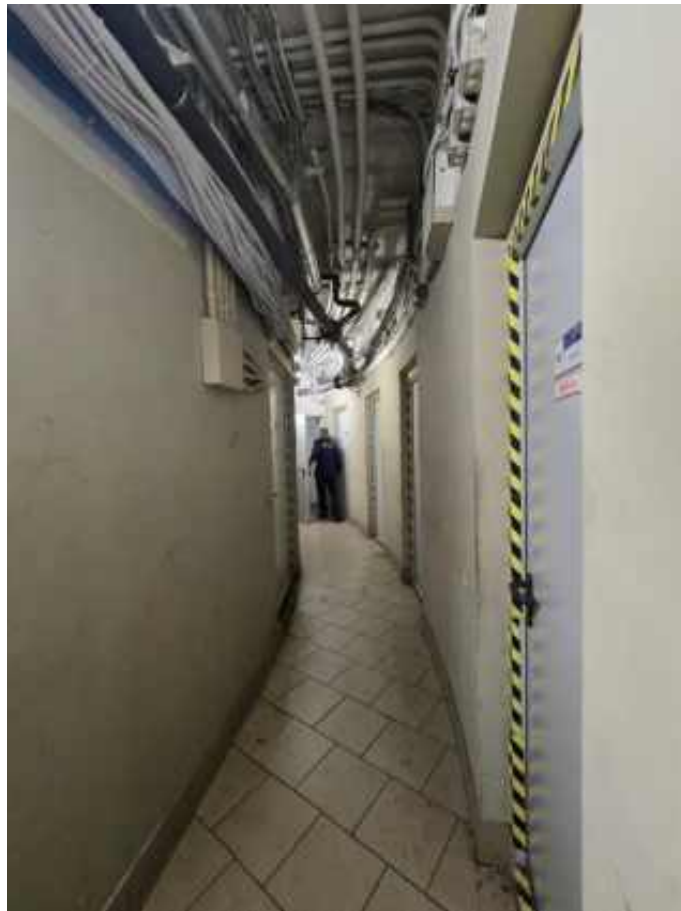
Фото п.7. Подвал, коридор, помещение 1-Н (48).
