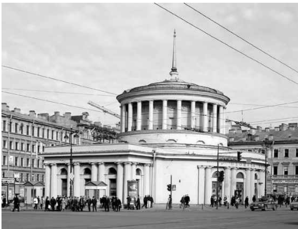
Илл. 67. Станция метрополитена "Площадь Восстания". Фото 2004 г. // https://p0.citywalls.ru/photo_316-324244.jpg?mt=1521299593
