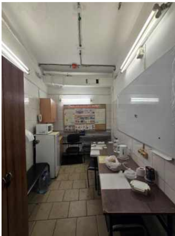
Фото п.17. Подвал, помещение 1-Н (53).
