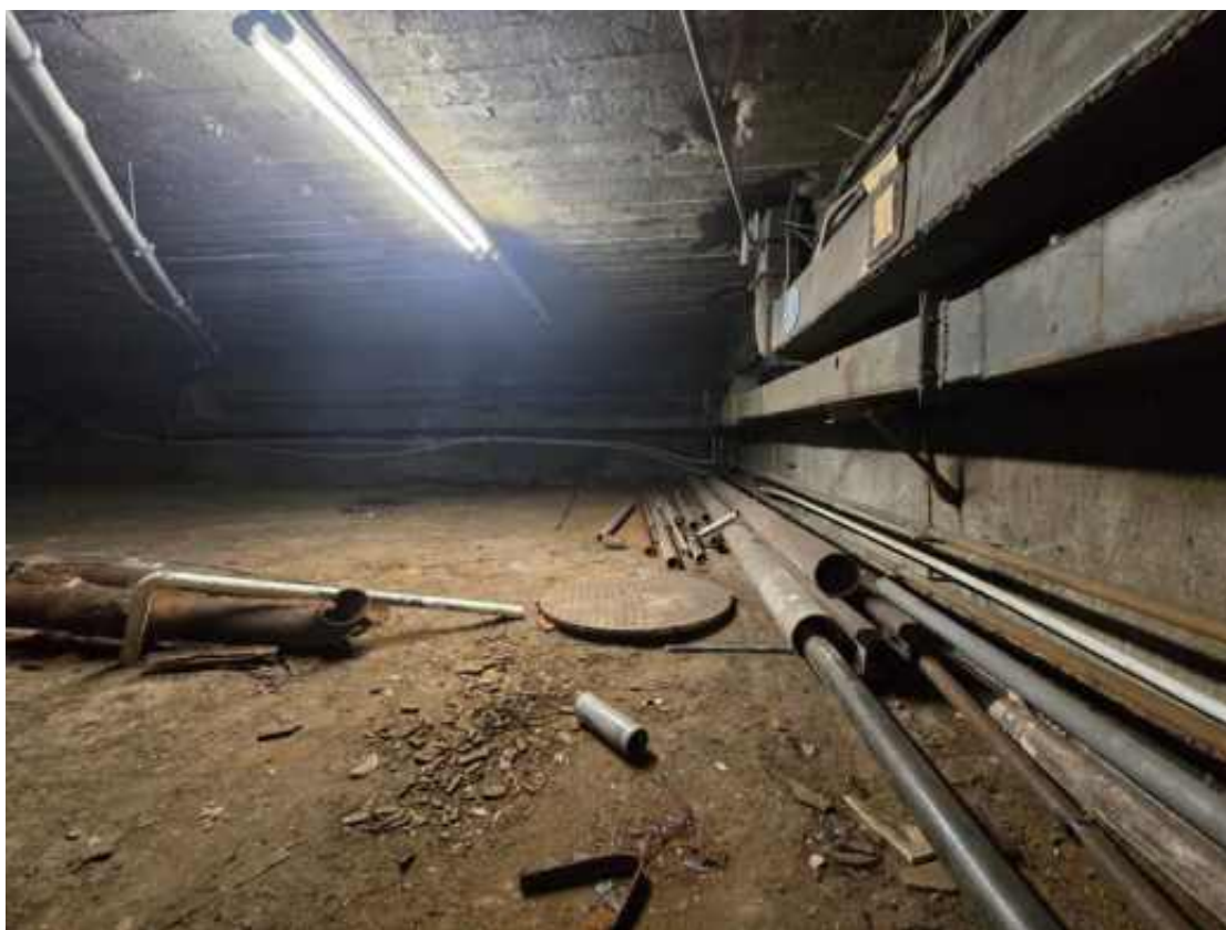
Фото тп.2. Техническое подполье.
