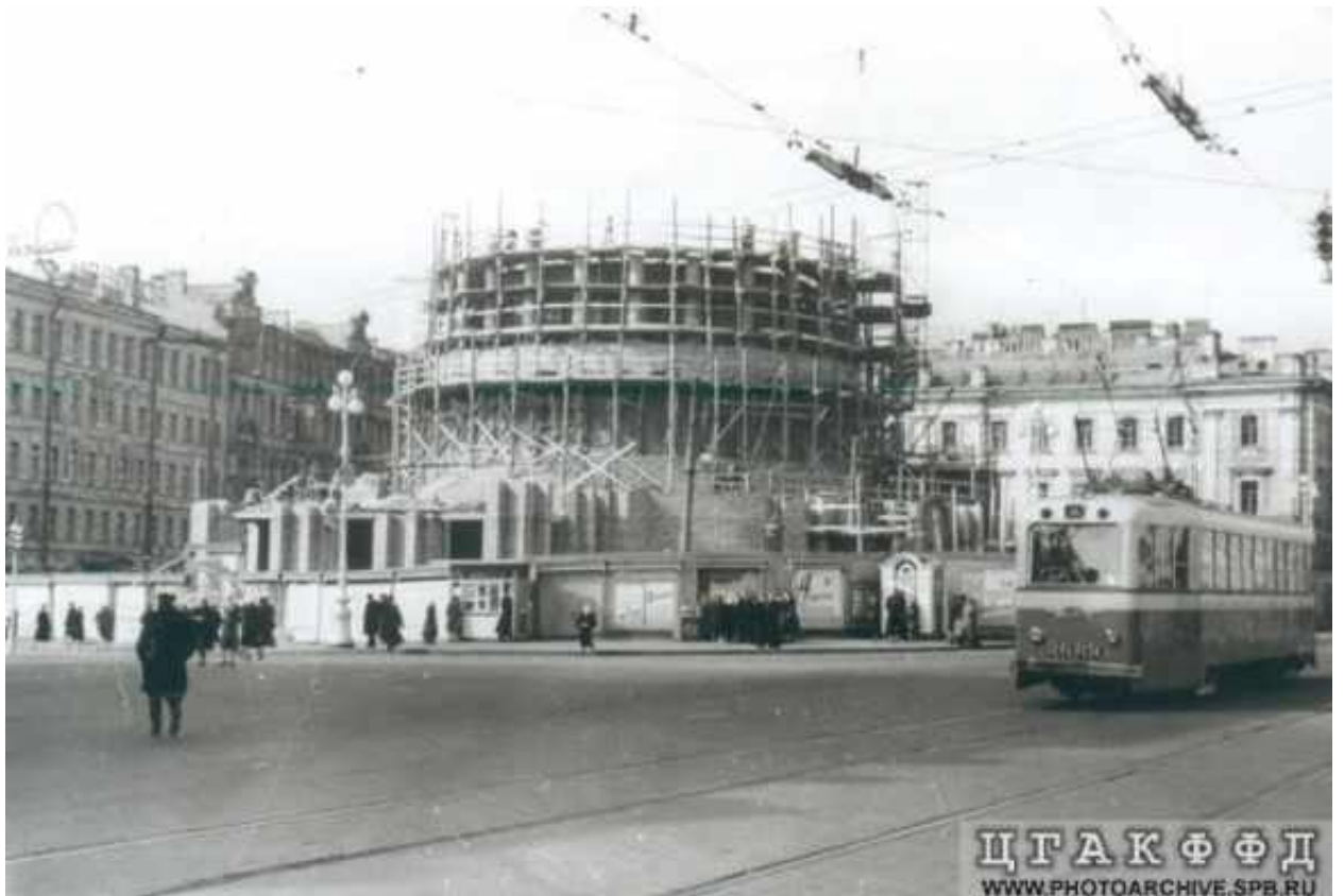
Илл. 20. Вид на строящийся наземный павильон станции метро "Площадь Восстания". Дата съемки: н. 1950-х гг. Авторы съемки: Ананьев Виталий Анатольевич // ЦГАКФФД СПб. Фотодокументы. Оп.1АР-148. Ед.хр.196816
