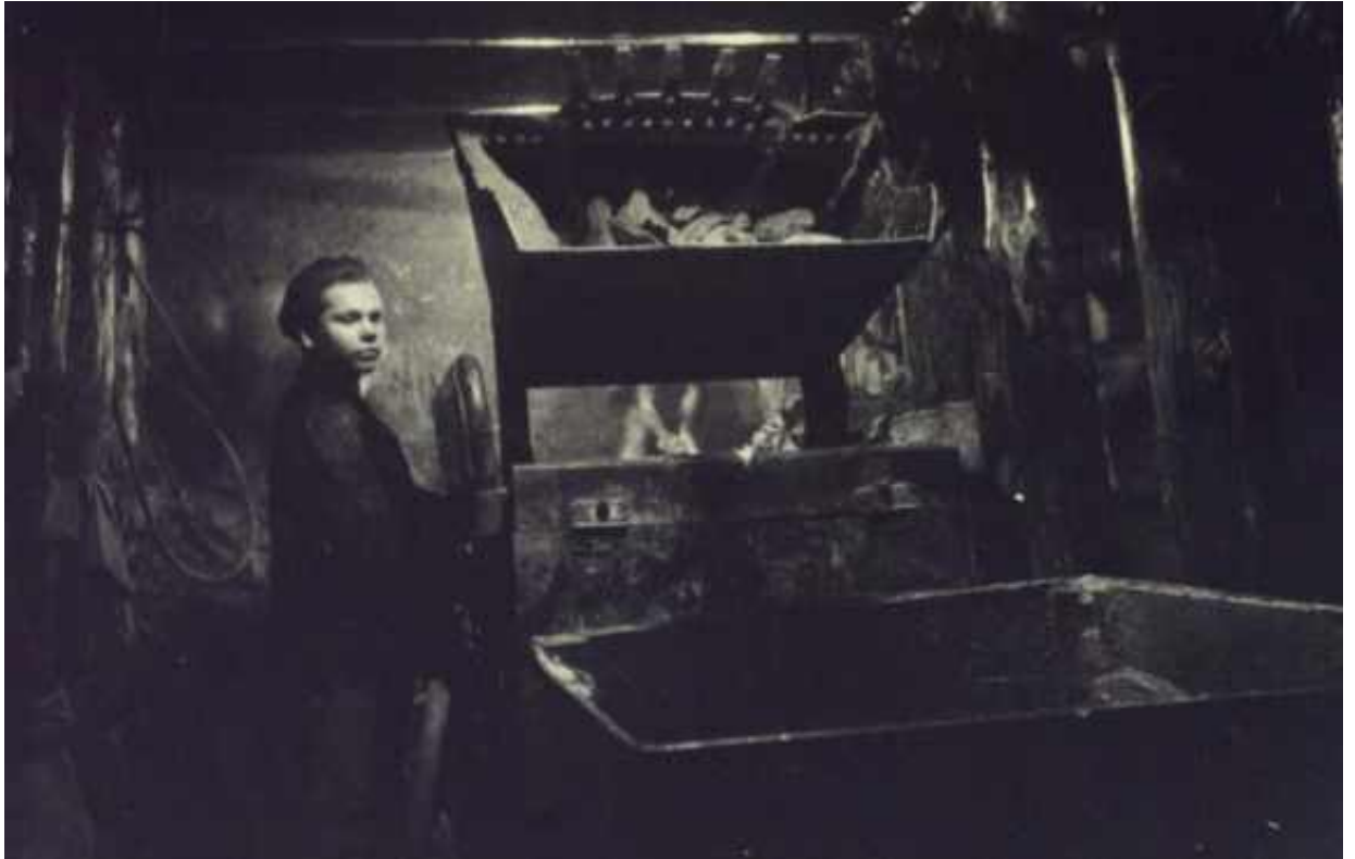
Илл. 19. Строительство станции метро "Площадь восстания". Дата съемки: январь 1949 г. Авторы съемки: Михайлов Александр Алексеевич. // ЦГАКФФД СПб. Фотодокументы. Опись 1АР-46. Ед.хр.76357
