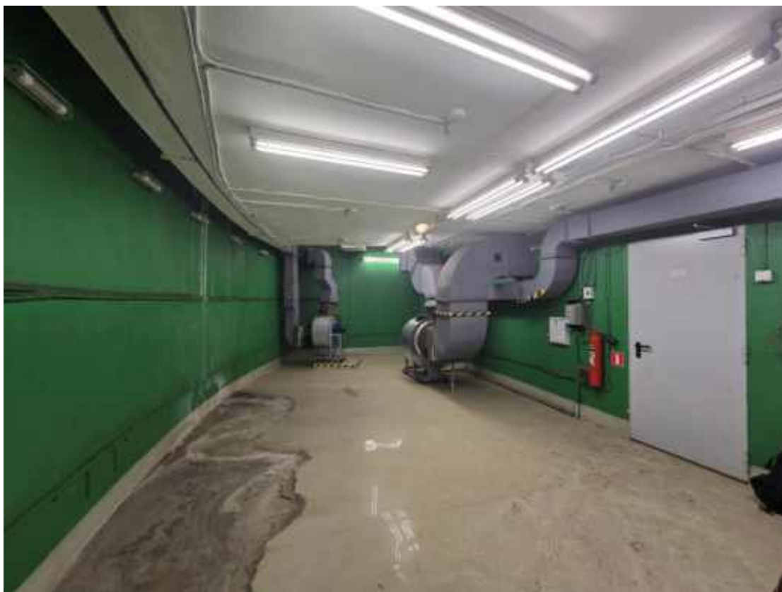
Фото п.3. Подвал, помещение 1-Н (49).
