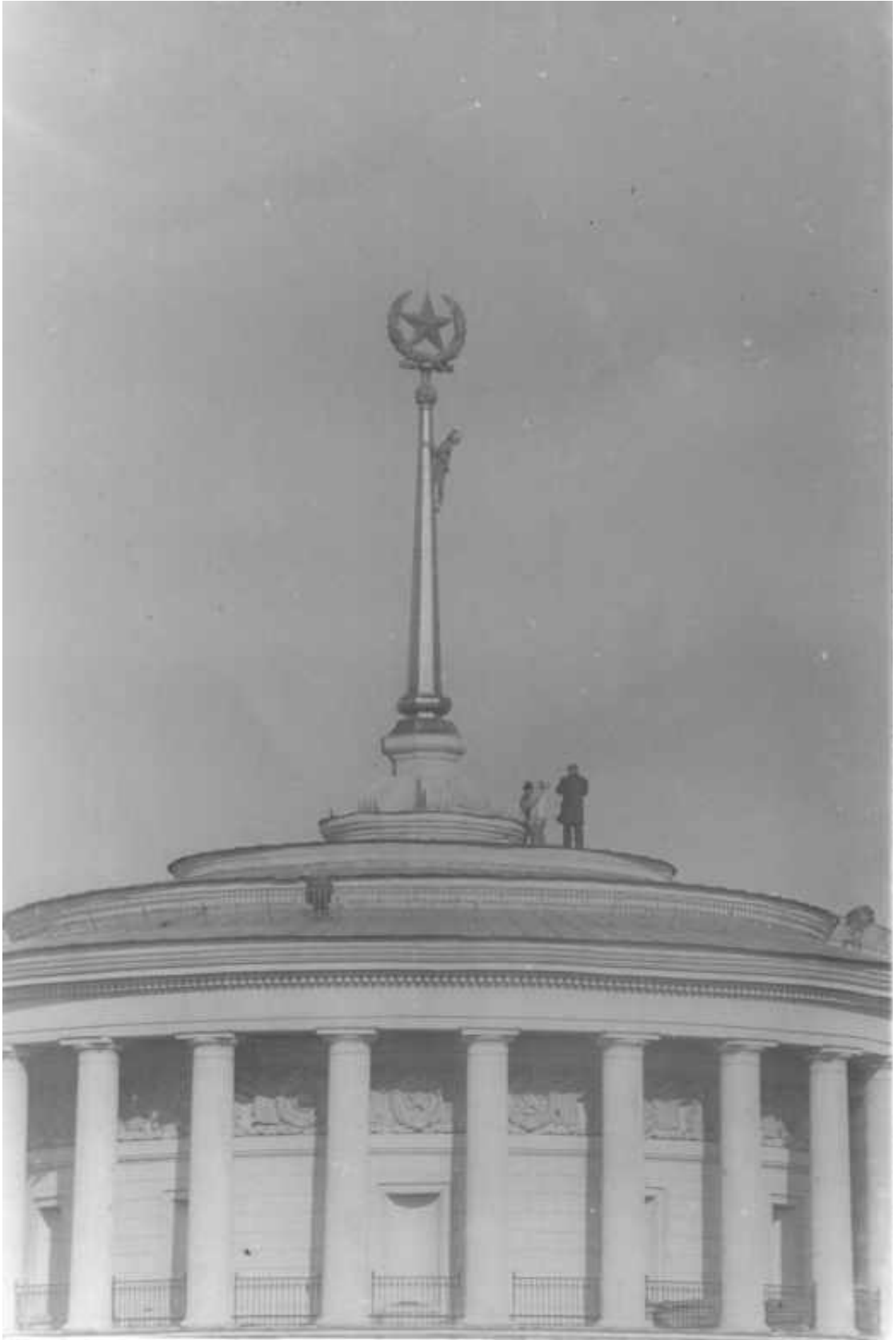
Илл. 62. Демонтаж звезды, венчавшей шпиль наземного павильона станции метро "Площадь Восстания", после завершения установки наверху "Золотая Звезда"obeliska "Городу-Герою Ленинграду". Дата съемки: Апрель 1985 г. Авторы съемки: Брудно Борис Наумович. // ЦГАКФФД СПб. Фотодокументы. Оп.1АР-166. Ед.хр.245949
