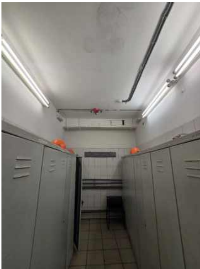
Фото п.13. Подвал, помещение 1-Н (51).
