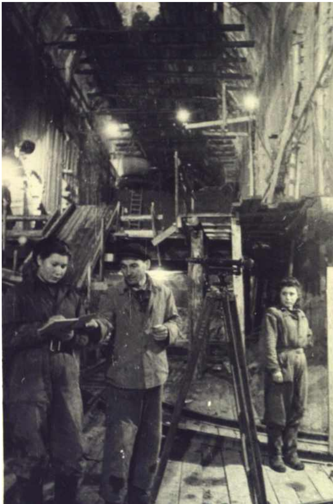
Илл. 18. Строительство станции метро "Площадь восстания". Дата съемки: январь 1949 г. Авторы съемки: Михайлов Александр Алексеевич. // ЦГАКФФД СПб. Фотодокументы. Опись 1АР-46. Ед.хр.76355
