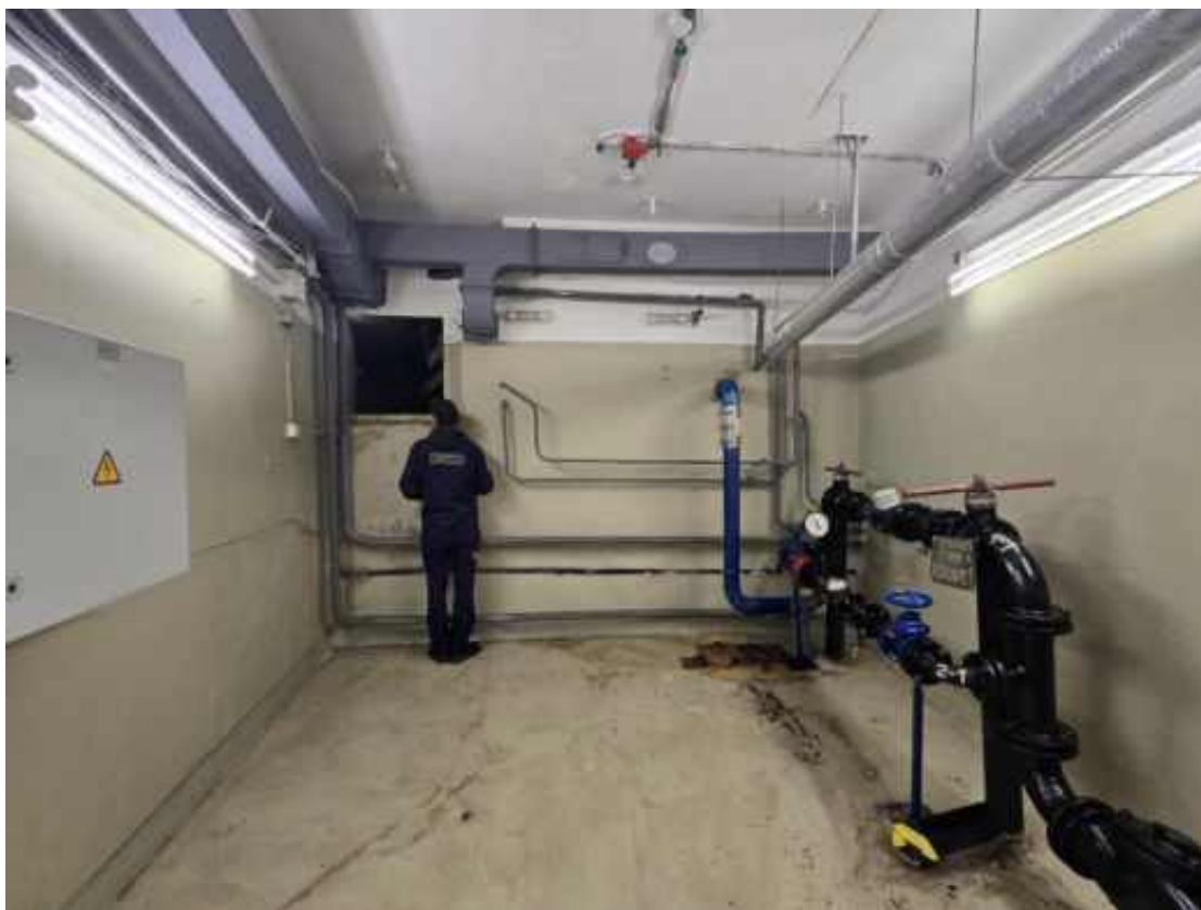
Фото п.9. Подвал, помещение 1-Н (55).
