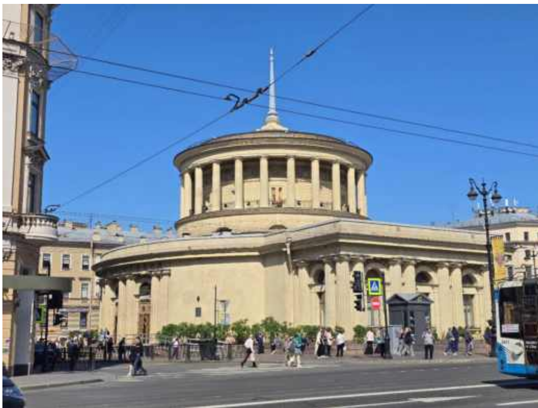
Фото 5. Станция метро «Площадь Восстания», фрагмент южного и западного фасадов, вид с Невского проспекта.
