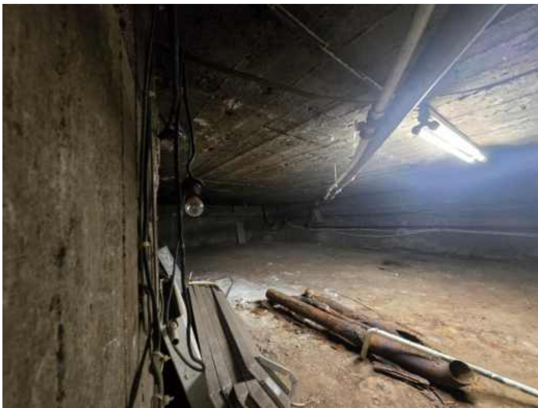
Фото тп.1. Техническое подполье.
