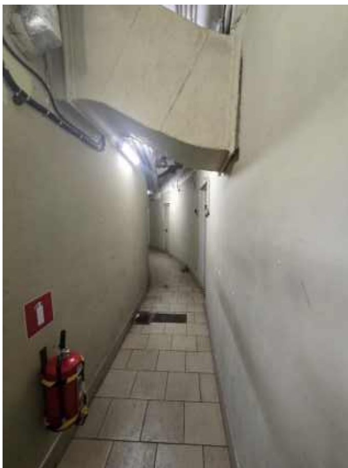
Фото п.2. Подвал, коридор, помещение 1-Н (48).
