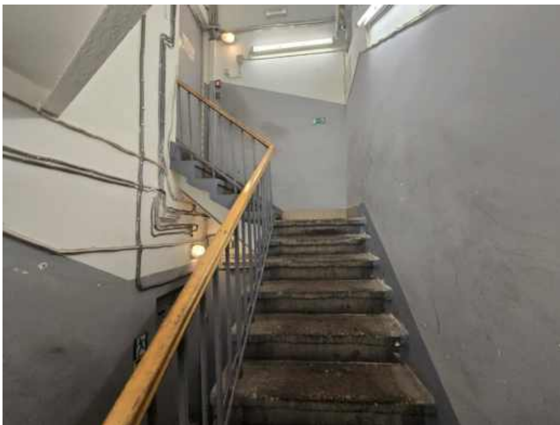
Фото 1.24. 1 этаж, лестница в подвал, помещение 1-Н (45).
