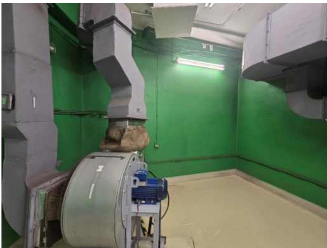
Фото п.4. Подвал, помещение 1-Н (49).
