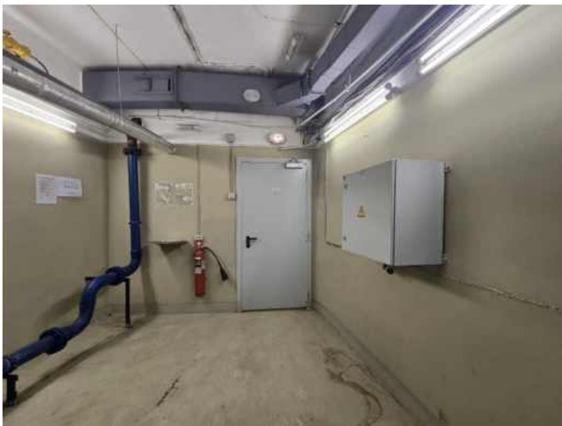
Фото п.10. Подвал, помещение 1-Н (55).
