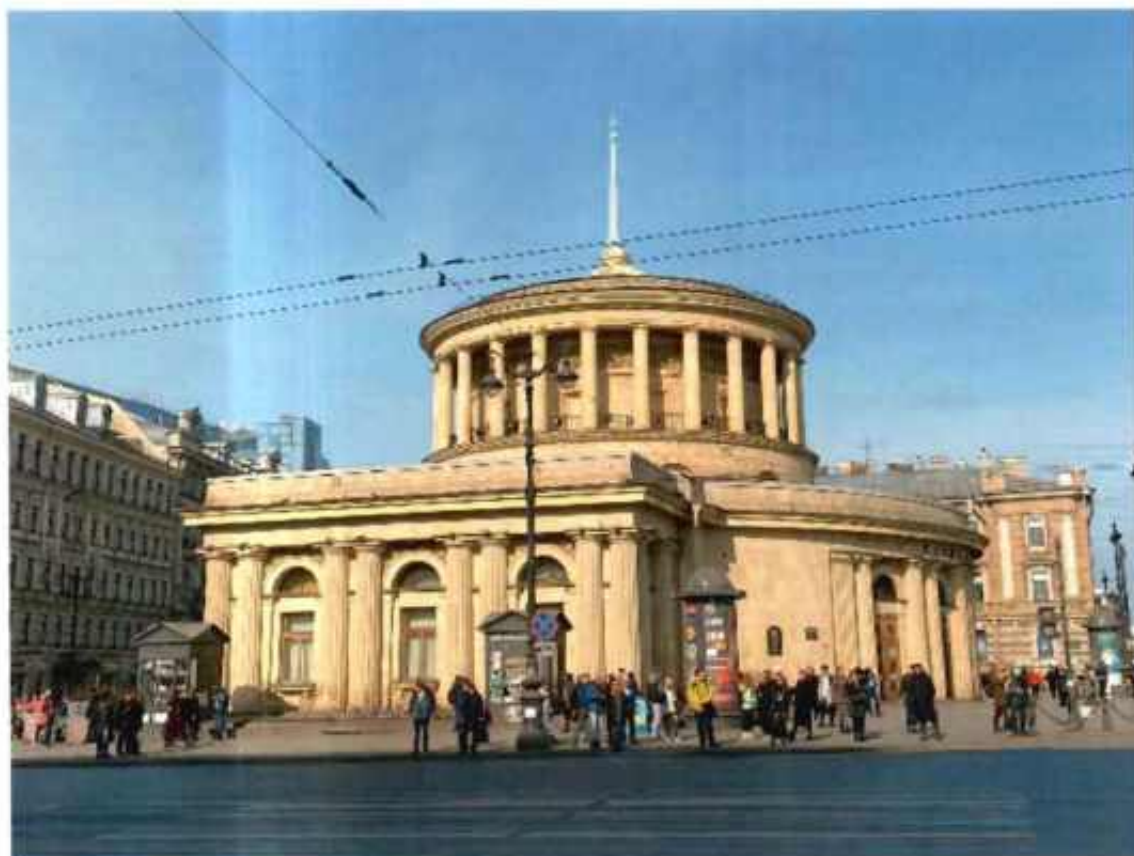
1. Общий вид на объект культурного наследия.
