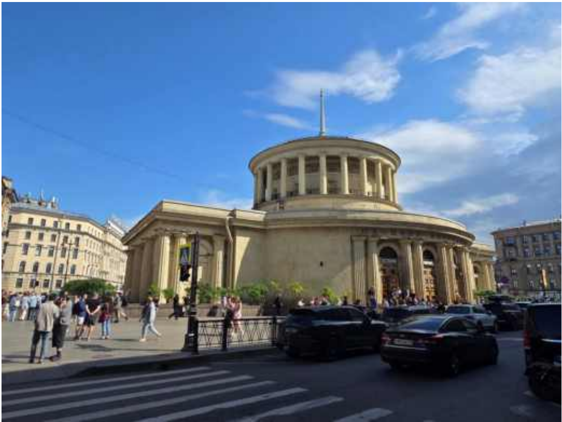
Фото 7. Станция метро «Площадь Восстания», фрагмент западного и северного фасадов, вид улицы Восстания.
