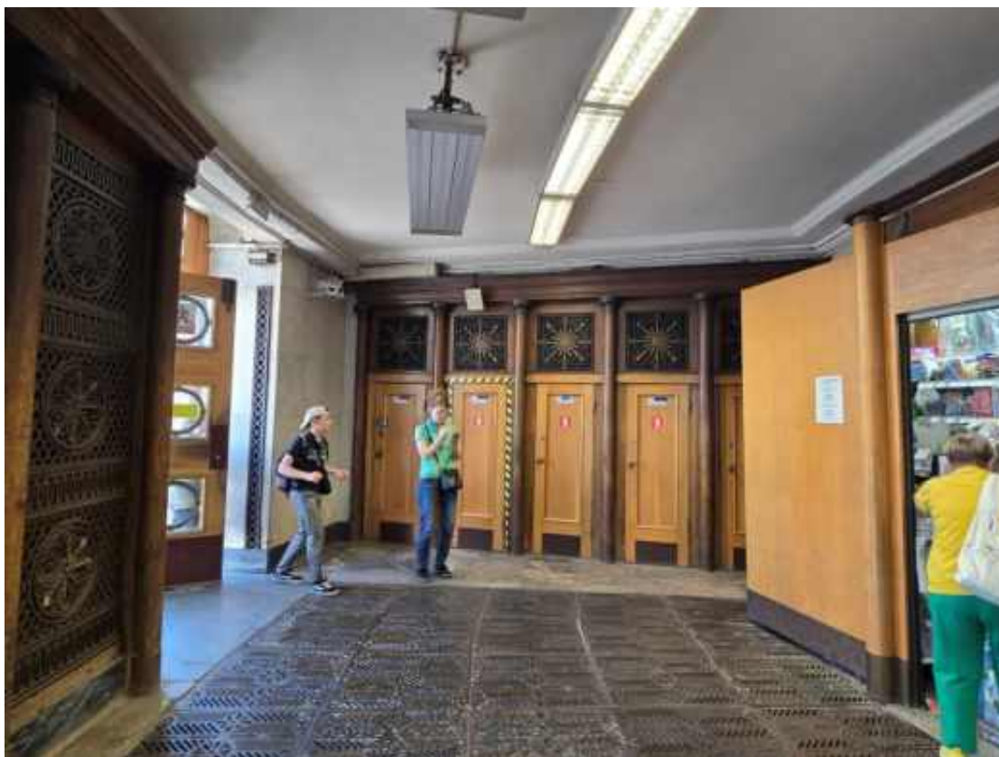
Фото 1.7. 1 этаж, тамбур входа, помещение 1-Н (1).
