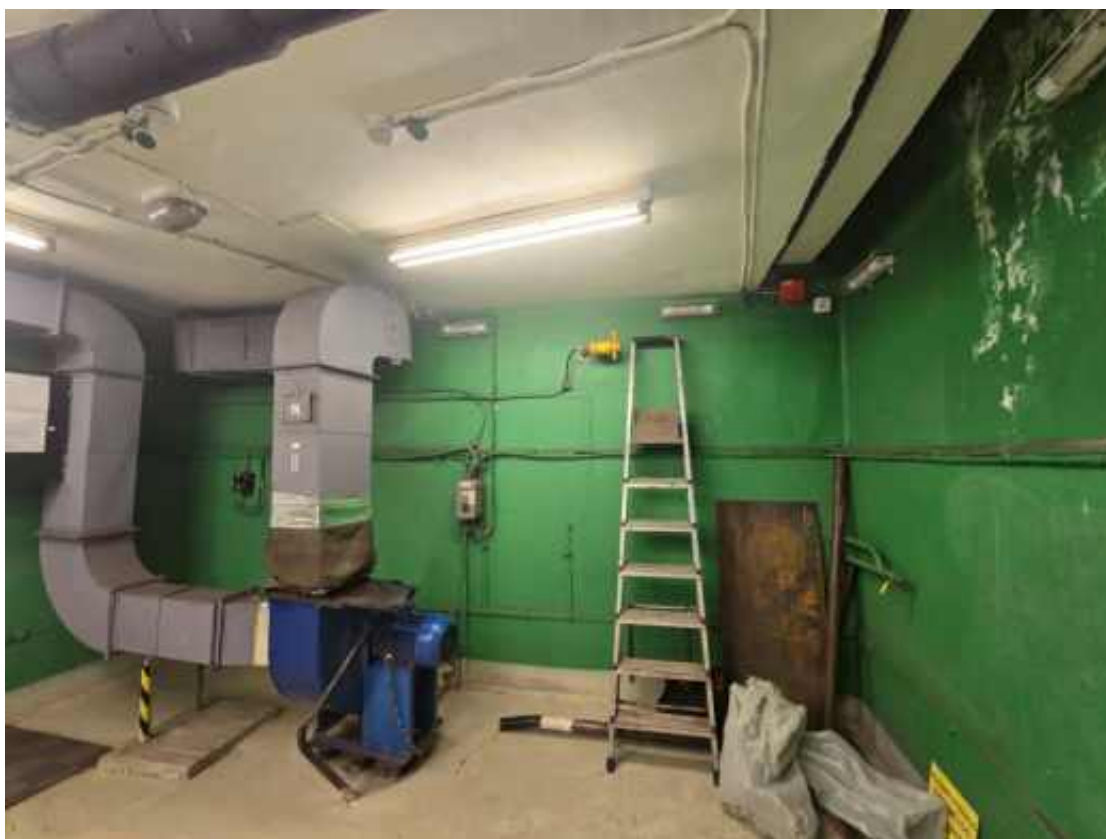
Фото п.6. Подвал, помещение 1-Н (49).
