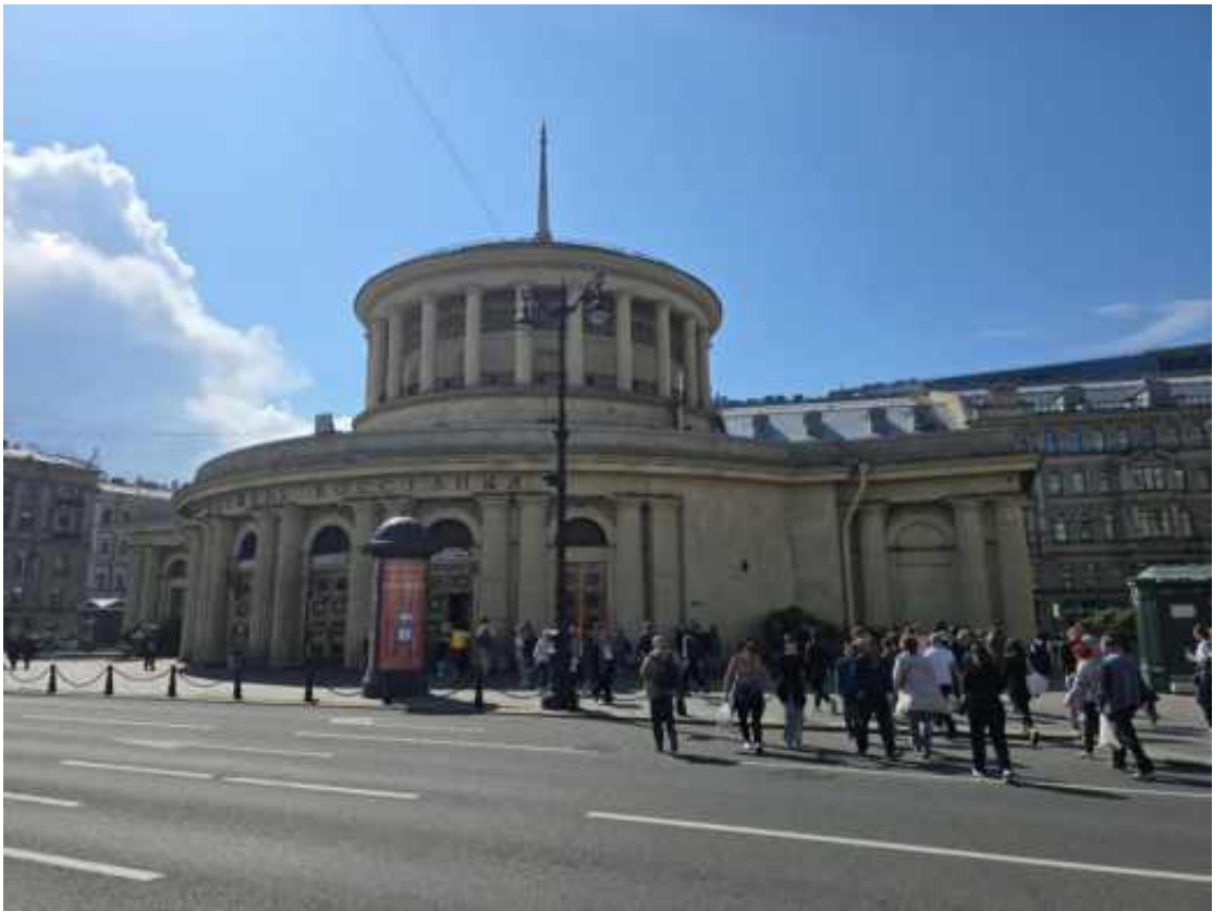
Фото 3. Станция метро «Площадь Восстания», восточный фасад, вид с Лиговского проспекта.
