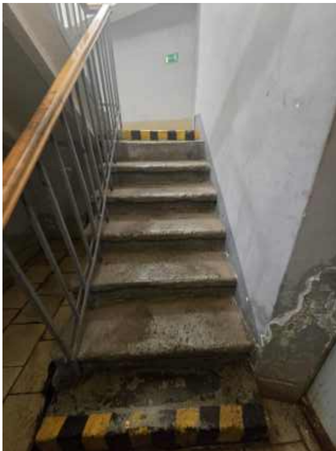
Фото п.1. Подвал, лестница на 1 этаж, помещение 1-Н (46).
