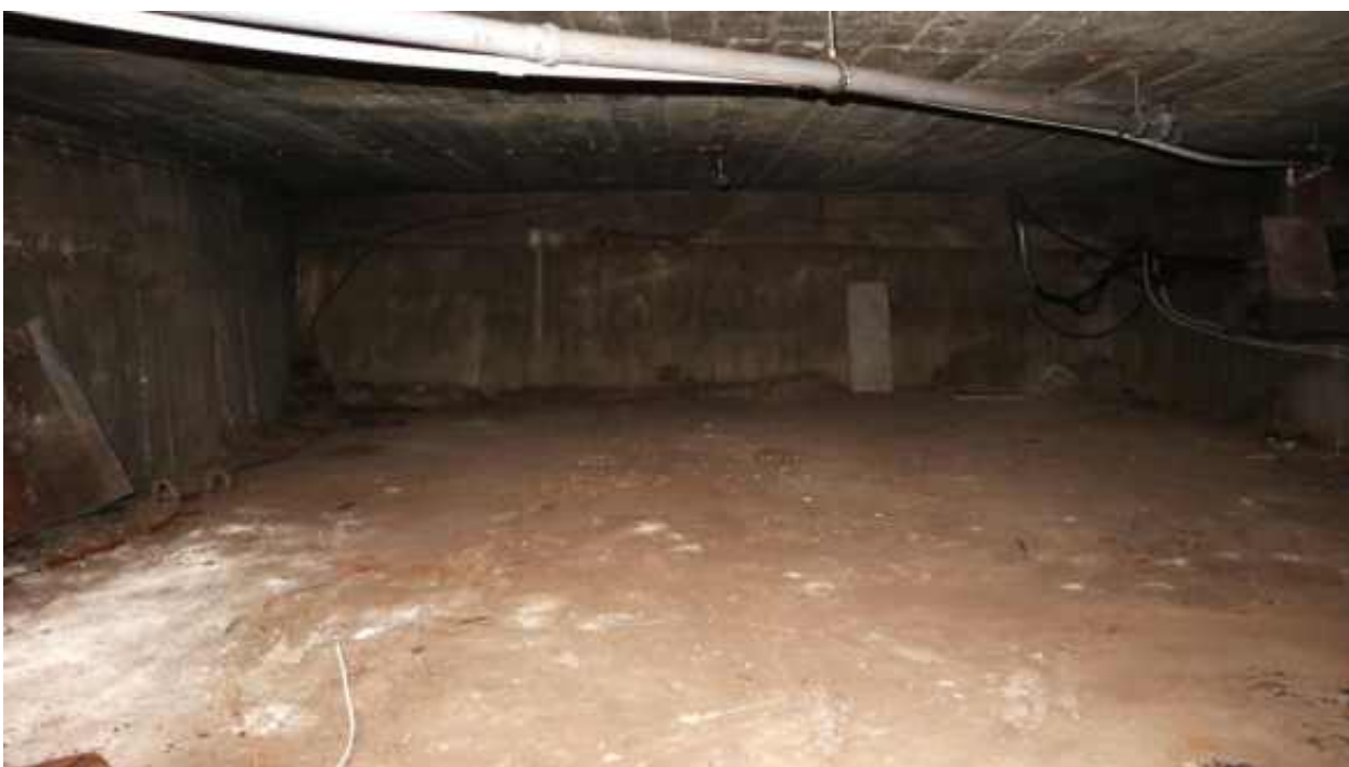
Фото тп.4. Техническое подполье.
