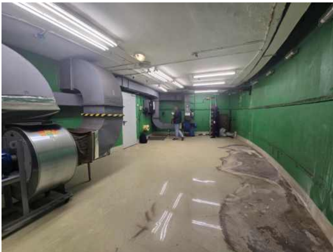
Фото п.5. Подвал, помещение 1-Н (49).
