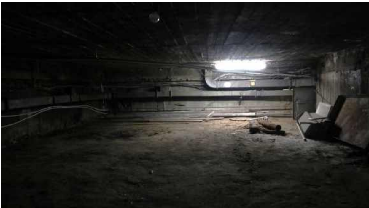
Фото тп.3. Техническое подполье.
