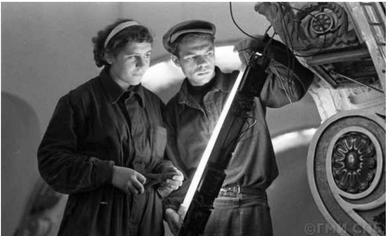
Илл. 23. Строительство станции метро "Площадь Восстания". Работы по подключению освещения в подземном вестибюле. Период создания:1955 г. // https://goskatalog.ru/portal/#/collections?id=25908946 (Номер в Госкаталоге: 25761321. Номер по КП (ГИК): ГМИ СПб 421549. Инвентарный номер: ГМИ СПб Инв.№-II-A-1788 н)
