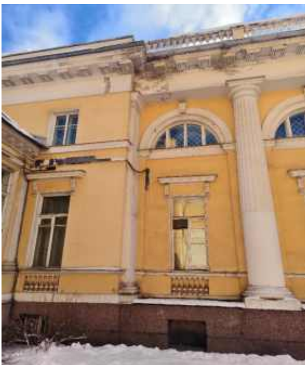
34. «Флигель служебный западный Михайловского дворца» (в составе «Дворец Великого князя Михаила Павловича (Русский музей Императора Александра III)»), г. Санкт-Петербург, Инженерная улица, дом 2-4, литера Г. Западный лицевой фасад. Фрагмент. Фото 03.02.2026г.
