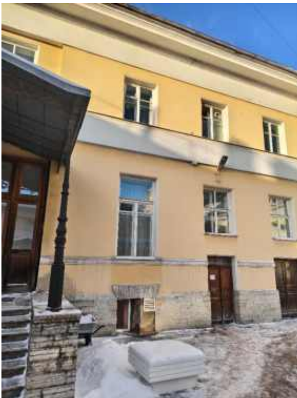
49. «Флигель служебный западный Михайловского дворца» (в составе «Дворец Великого князя Михаила Павловича (Русский музей Императора Александра III)»), г. Санкт-Петербург, Инженерная улица, дом 2-4, литера Г. Западный дворовый фасад. Фрагмент. Фото 03.02.2026г.
