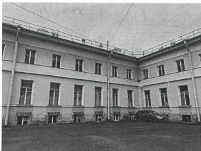
Фото 3. Фрагмент дворового фасада
