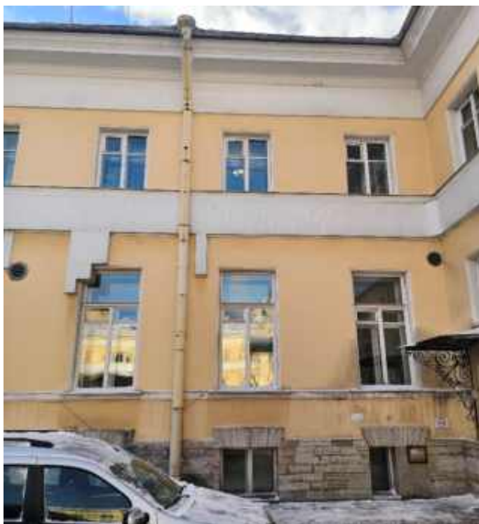
53. «Флигель служебный западный Михайловского дворца» (в составе «Дворец Великого князя Михаила Павловича (Русский музей Императора Александра III)»), г. Санкт-Петербург, Инженерная улица, дом 2-4, литера Г. Южный дворовый фасад. Фрагмент. Фото 03.02.2026г.
