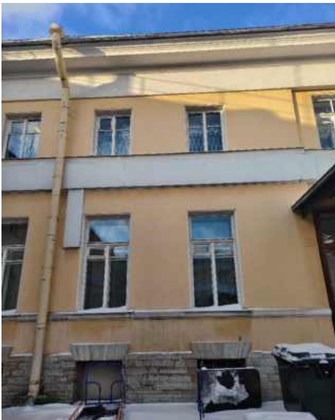
51. «Флигель служебный западный Михайловского дворца» (в составе «Дворец Великого князя Михаила Павловича (Русский музей Императора Александра III)»), г. Санкт-Петербург, Инженерная улица, дом 2-4, литера Г. Западный дворовый фасад. Фрагмент. Фото 03.02.2026г.
