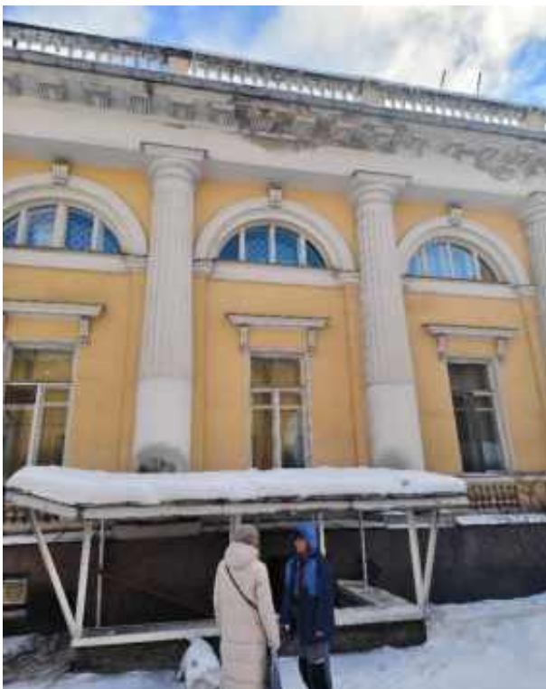
37. «Флигель служебный западный Михайловского дворца» (в составе «Дворец Великого князя Михаила Павловича (Русский музей Императора Александра III)»), г. Санкт-Петербург, Инженерная улица, дом 2-4, литера Г. Западный лицевой фасад. Фрагмент. Фото 03.02.2026г.
