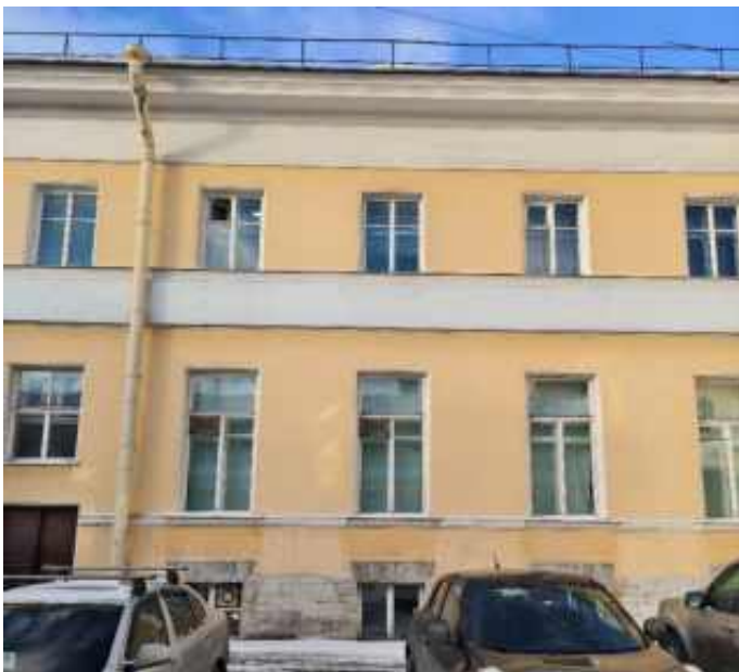
47. «Флигель служебный западный Михайловского дворца» (в составе «Дворец Великого князя Михаила Павловича (Русский музей Императора Александра III)»), г. Санкт-Петербург, Инженерная улица, дом 2-4, литера Г. Западный дворовый фасад. Фрагмент. Фото 03.02.2026г.
