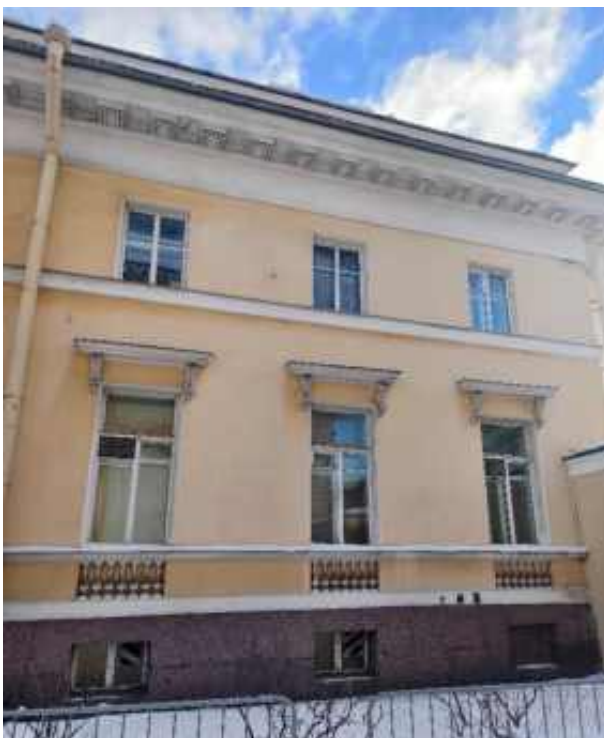
40. «Флигель служебный западный Михайловского дворца» (в составе «Дворец Великого князя Михаила Павловича (Русский музей Императора Александра III)»), г. Санкт-Петербург, Инженерная улица, дом 2-4, литера Г. Западный лицевой фасад. Фрагмент. Фото 03.02.2026г.
