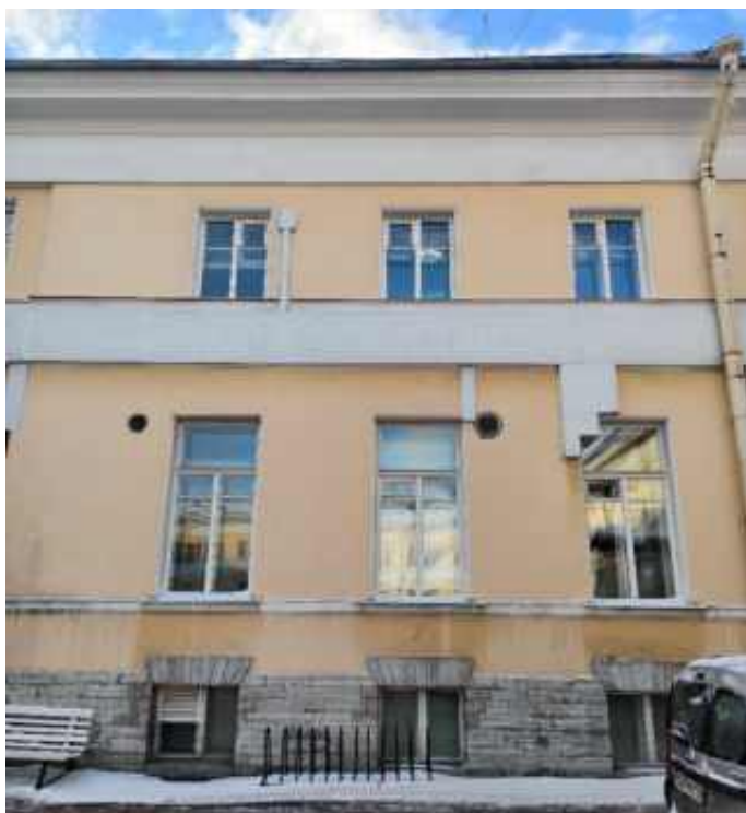
54. «Флигель служебный западный Михайловского дворца» (в составе «Дворец Великого князя Михаила Павловича (Русский музей Императора Александра III)»), г. Санкт-Петербург, Инженерная улица, дом 2-4, литера Г. Южный дворовый фасад. Фрагмент. Фото 03.02.2026г.
