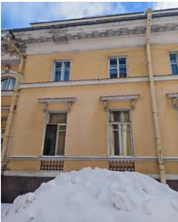
39. «Флигель служебный западный Михайловского дворца» (в составе «Дворец Великого князя Михаила Павловича (Русский музей Императора Александра III)»), г. Санкт-Петербург, Инженерная улица, дом 2-4, литера Г. Западный лицевой фасад. Фрагмент. Фото 03.02.2026г.
