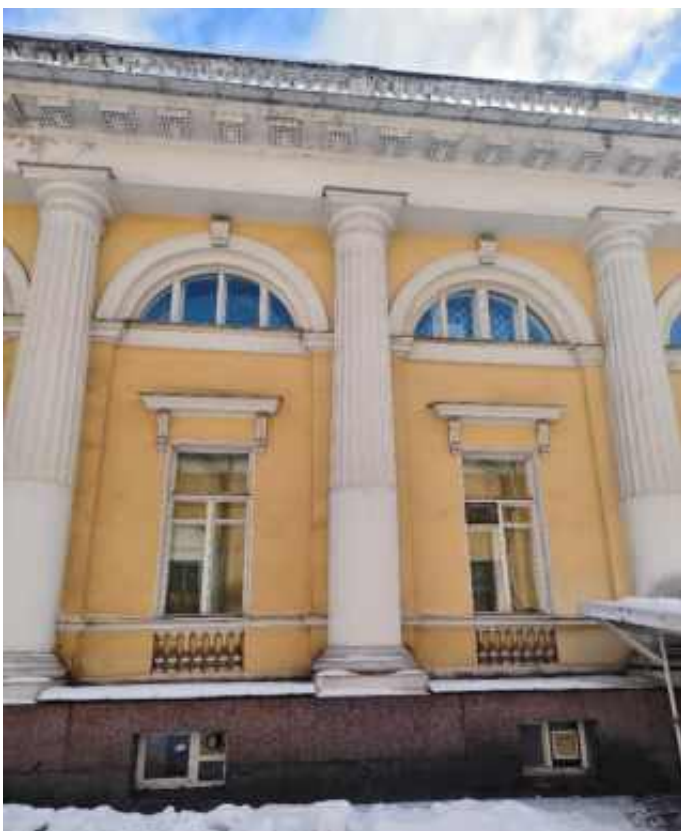
36. «Флигель служебный западный Михайловского дворца» (в составе «Дворец Великого князя Михаила Павловича (Русский музей Императора Александра III)»), г. Санкт-Петербург, Инженерная улица, дом 2-4, литера Г. Западный лицевой фасад. Фрагмент. Фото 03.02.2026г.
