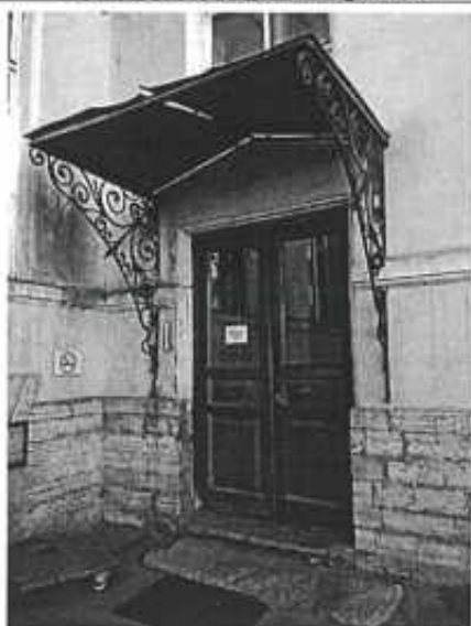
Фото 7. Фрагмент дворового фасада. Входная группа
