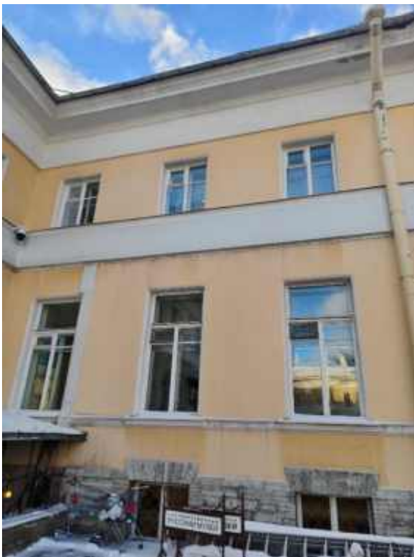
57. «Флигель служебный западный Михайловского дворца» (в составе «Дворец Великого князя Михаила Павловича (Русский музей Императора Александра III)»), г. Санкт-Петербург, Инженерная улица, дом 2-4, литера Г. Южный дворовый фасад. Фрагмент. Фото 03.02.2026г.
