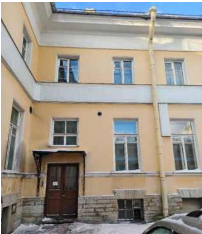
52. «Флигель служебный западный Михайловского дворца» (в составе «Дворец Великого князя Михаила Павловича (Русский музей Императора Александра III)»), г. Санкт-Петербург, Инженерная улица, дом 2-4, литера Г. Западный дворовый фасад. Фрагмент. Фото 03.02.2026г.
