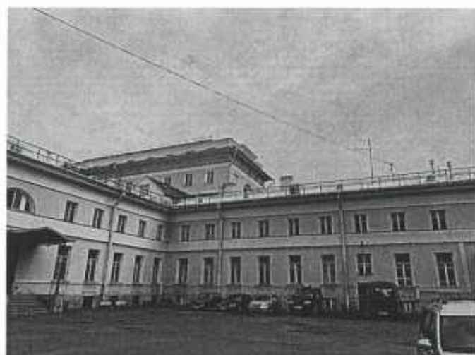
Фото 4. Фрагмент дворового фасада
