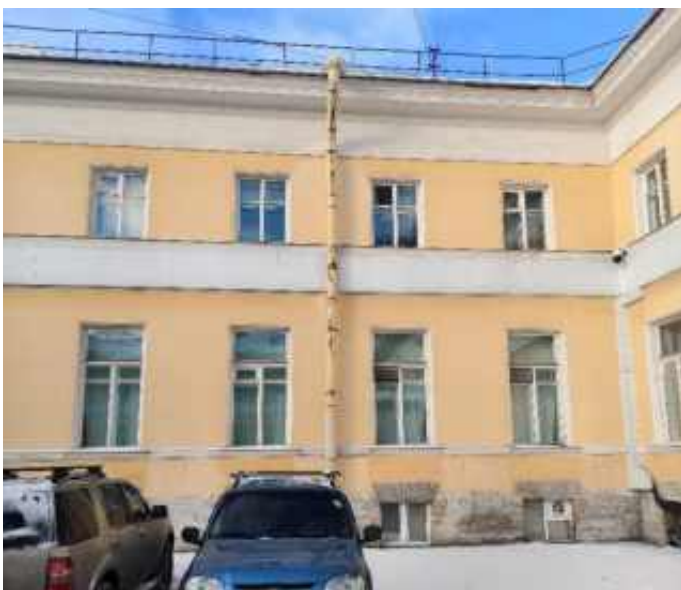
46. «Флигель служебный западный Михайловского дворца» (в составе «Дворец Великого князя Михаила Павловича (Русский музей Императора Александра III)»), г. Санкт-Петербург, Инженерная улица, дом 2-4, литера Г. Западный дворовый фасад. Фрагмент. Фото 03.02.2026г.
