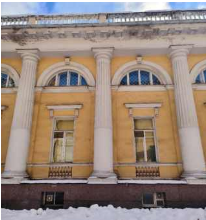
35. «Флигель служебный западный Михайловского дворца» (в составе «Дворец Великого князя Михаила Павловича (Русский музей Императора Александра III)»), г. Санкт-Петербург, Инженерная улица, дом 2-4, литера Г. Западный лицевой фасад. Фрагмент. Фото 03.02.2026г.
