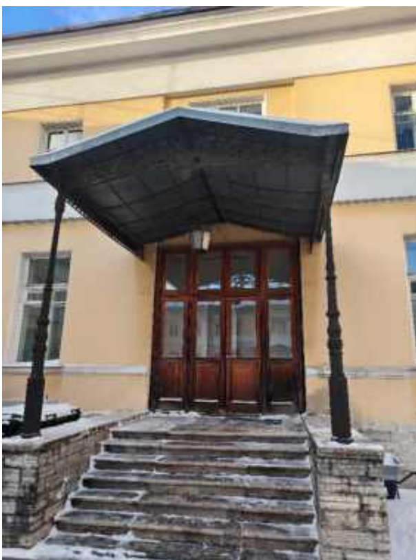
50. «Флигель служебный западный Михайловского дворца» (в составе «Дворец Великого князя Михаила Павловича (Русский музей Императора Александра III)»), г. Санкт-Петербург, Инженерная улица, дом 2-4, литера Г. Западный дворовый фасад. Фрагмент. Фото 03.02.2026г.
