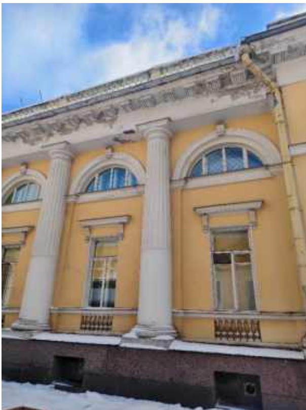
38. «Флигель служебный западный Михайловского дворца» (в составе «Дворец Великого князя Михаила Павловича (Русский музей Императора Александра III)»), г. Санкт-Петербург, Инженерная улица, дом 2-4, литера Г. Западный лицевой фасад. Фрагмент. Фото 03.02.2026г.
