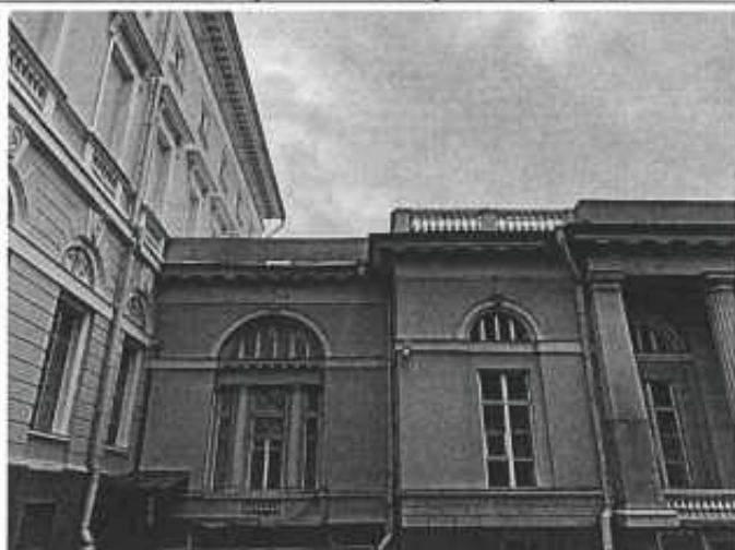
Фото 6. Фрагмент северного фасада
