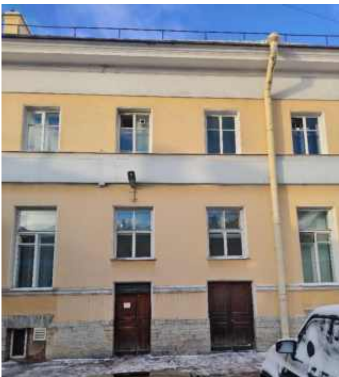
48. «Флигель служебный западный Михайловского дворца» (в составе «Дворец Великого князя Михаила Павловича (Русский музей Императора Александра III)»), г. Санкт-Петербург, Инженерная улица, дом 2-4, литера Г. Западный дворовый фасад. Фрагмент. Фото 03.02.2026г.
