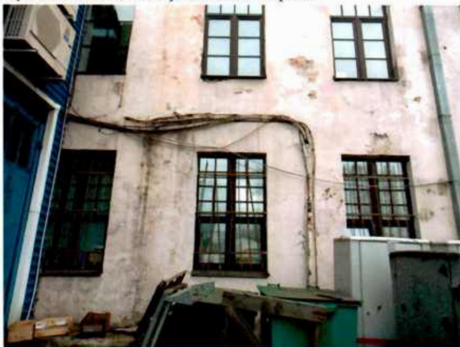
10. Фрагменты стены с северо-западной стороны
