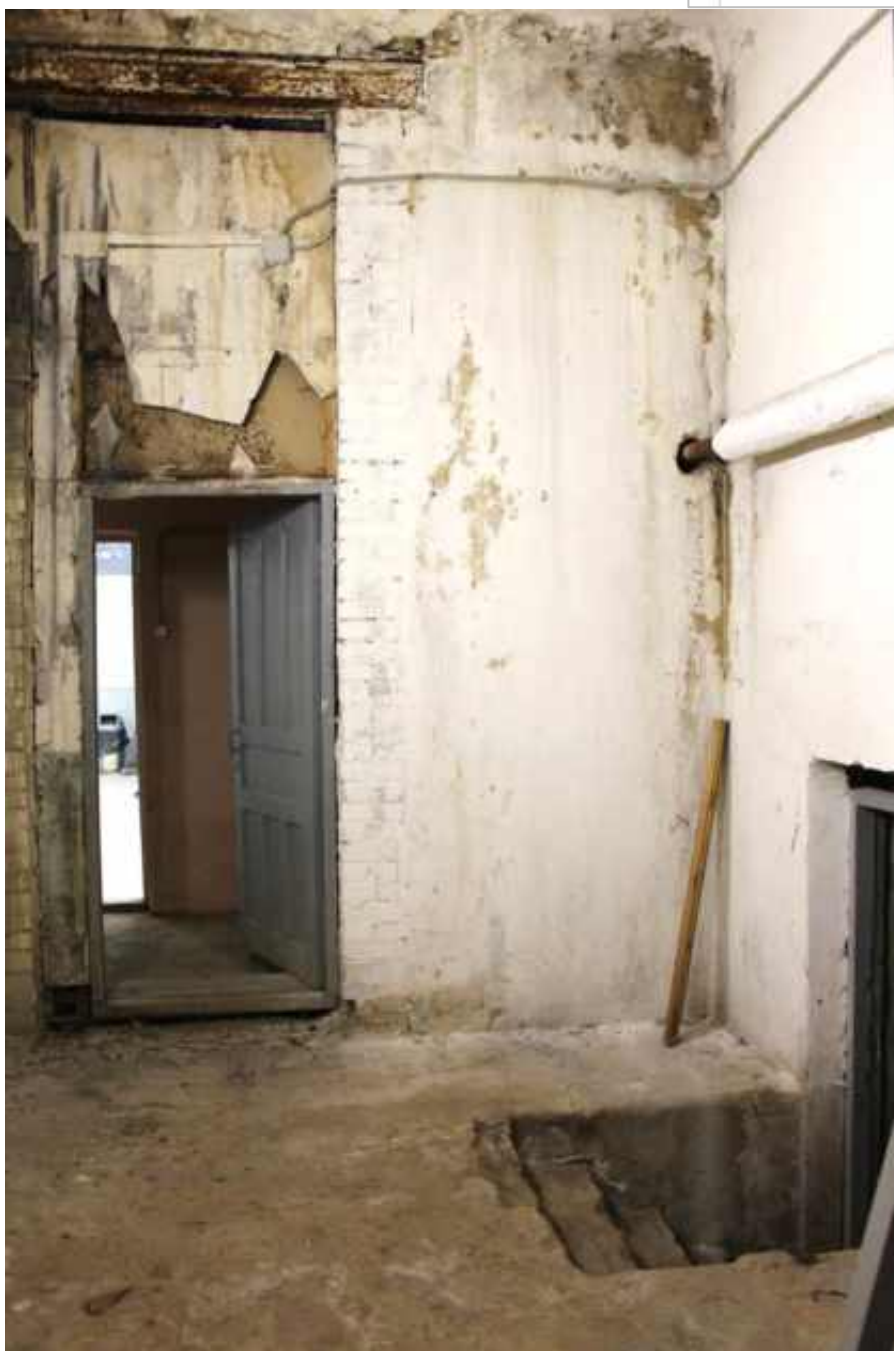
53. Объект культурного наследия регионального значения «Вокзал железнодорожной станции Ланская». 1 этаж, пом. 1-Н(14), общий вид. Помещение, расположенное в железнодорожной насыпи. Справа – вход в подвал. Дата фотофиксации: 23 апреля 2026 года.
