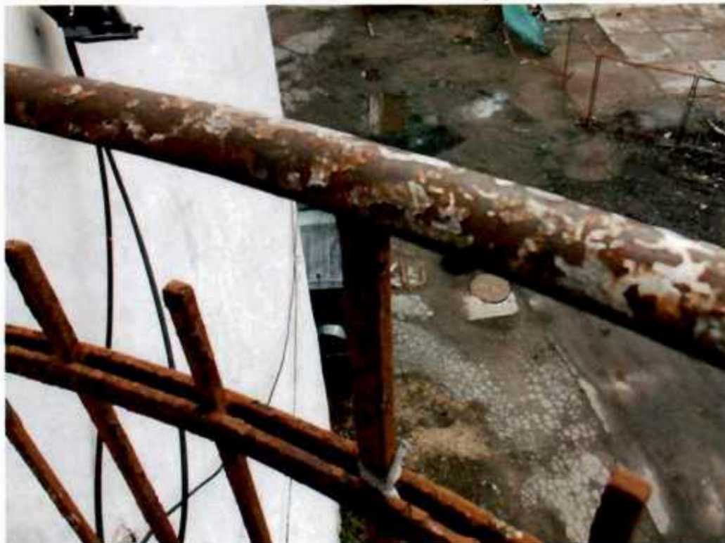
23. Элементы балкона 2ого этажа с юго-западной стороны.
