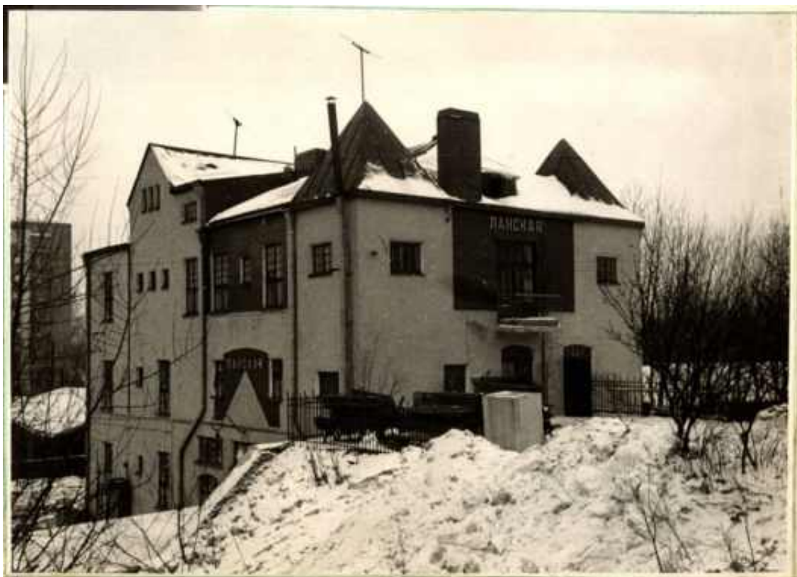
28. Станция Ланская. Вид с юго-востока. Б/д. Из фондов РЖД // URL: https://terijoki.spb.ru/%2F/photos/picture.php?/117099/category/2082 (дата обращения: 10.02.2026).
