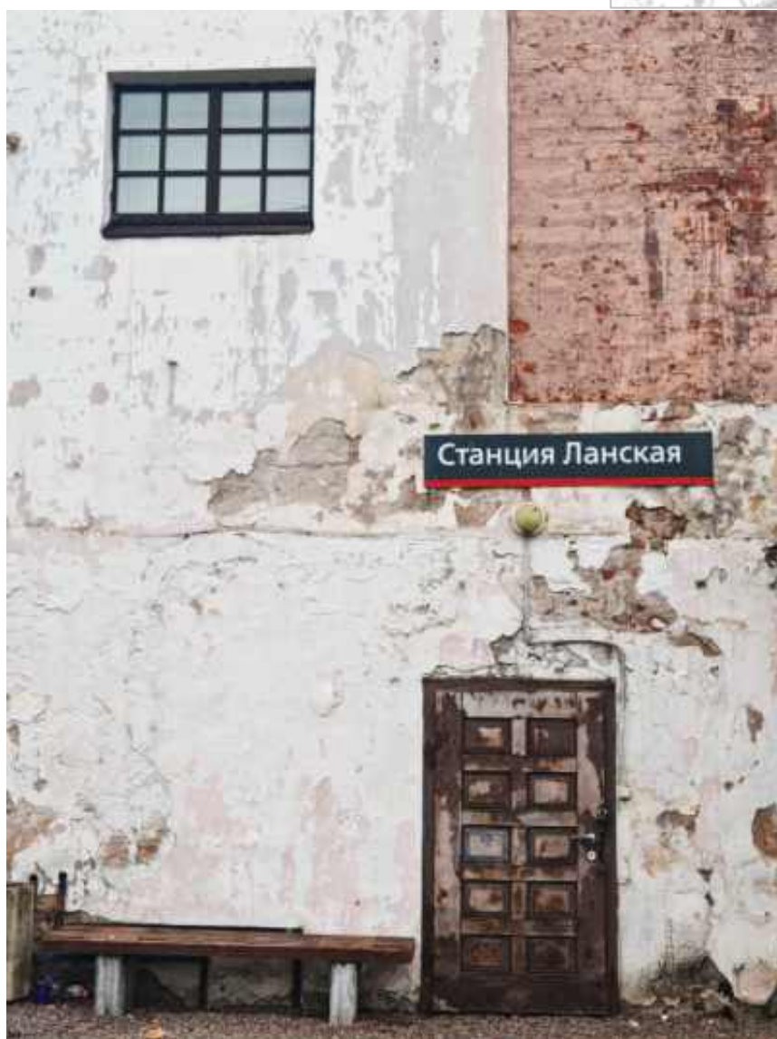
44. Объект культурного наследия регионального значения «Вокзал железнодорожной станции Ланская». Фрагмент восточного фасада здания вокзала. Дата фотофиксации: 23 апреля 2026 года.
