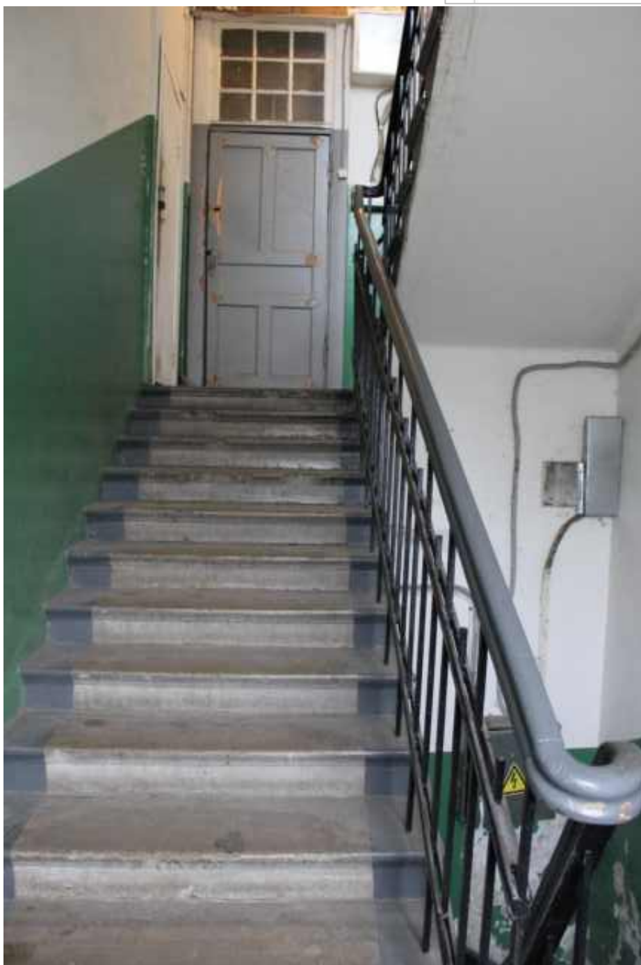
56. Объект культурного наследия регионального значения «Вокзал железнодорожной станции Ланская». Лестница (ЛК-1), общий вид. Дата фотофиксации: 23 апреля 2026 года.
