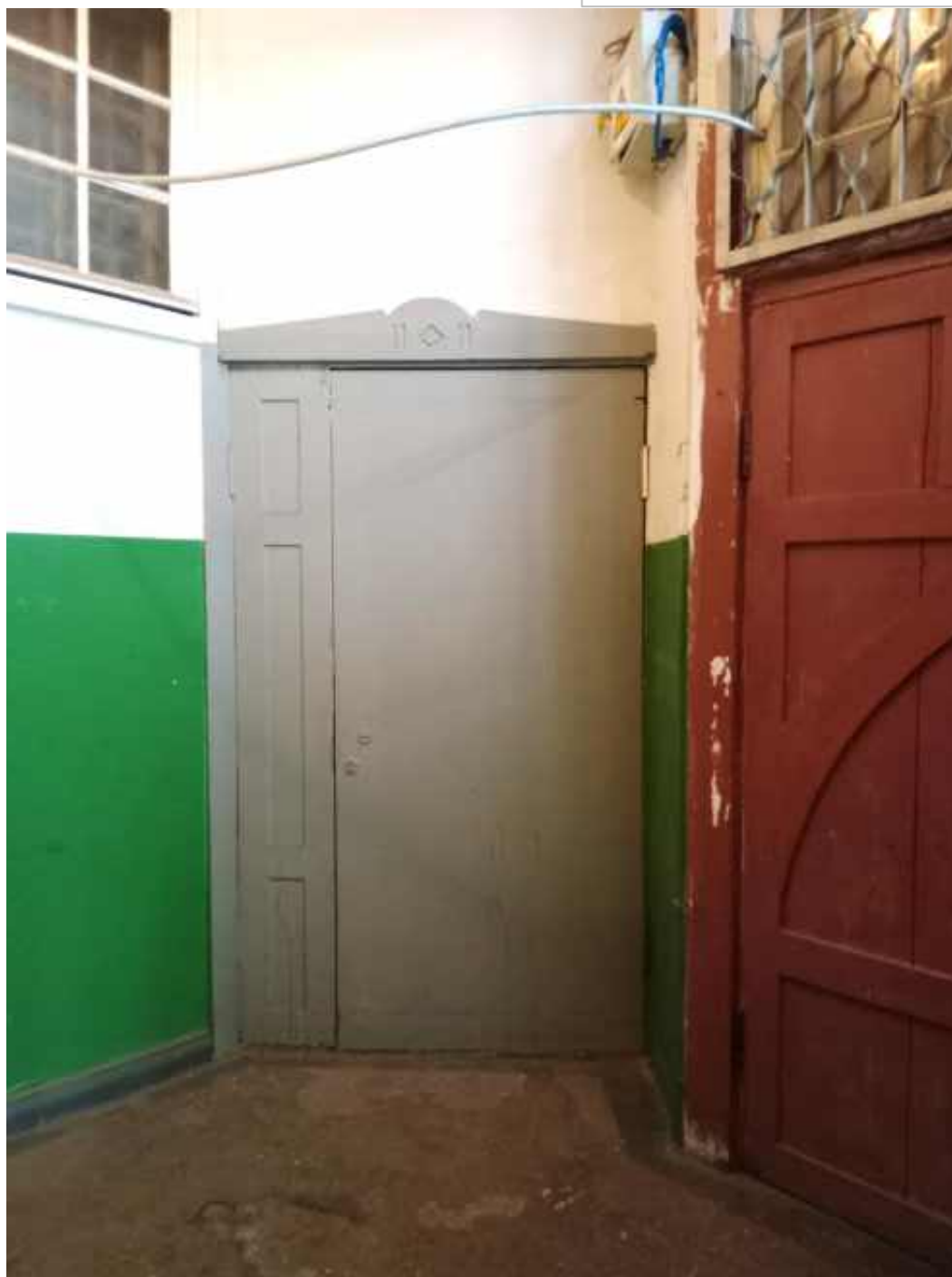
58. Объект культурного наследия регионального значения «Вокзал железнодорожной станции Ланская». Лестница (ЛК-1), фрагмент. Площадка в уровне 3-го этажа. Дата фотофиксации: 23 апреля 2026 года.
