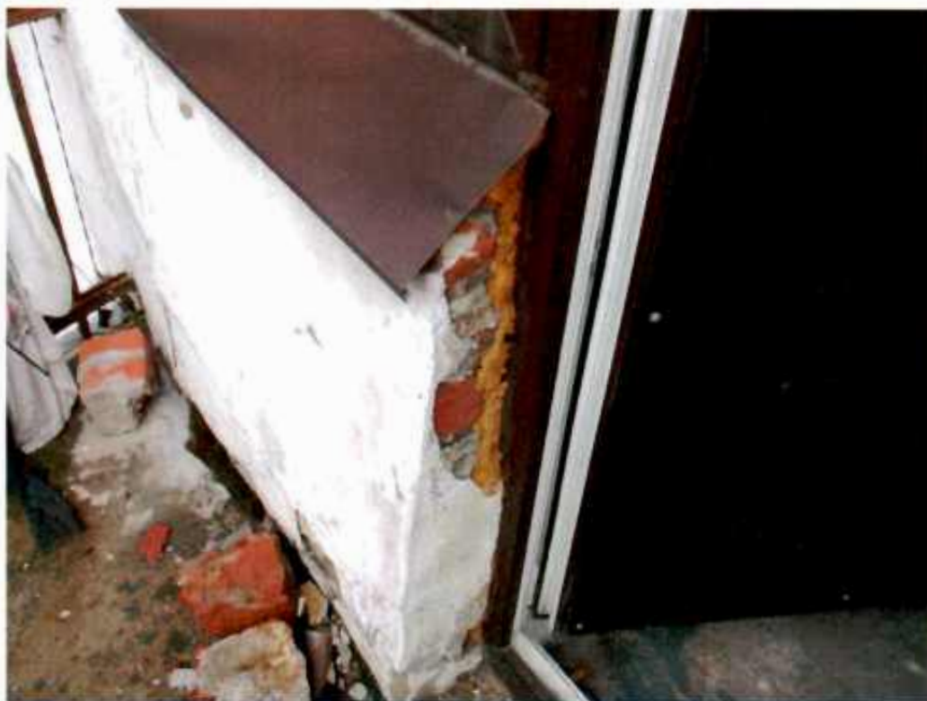
24. Элементы балкона 2ого этажа с юго-западной стороны.
