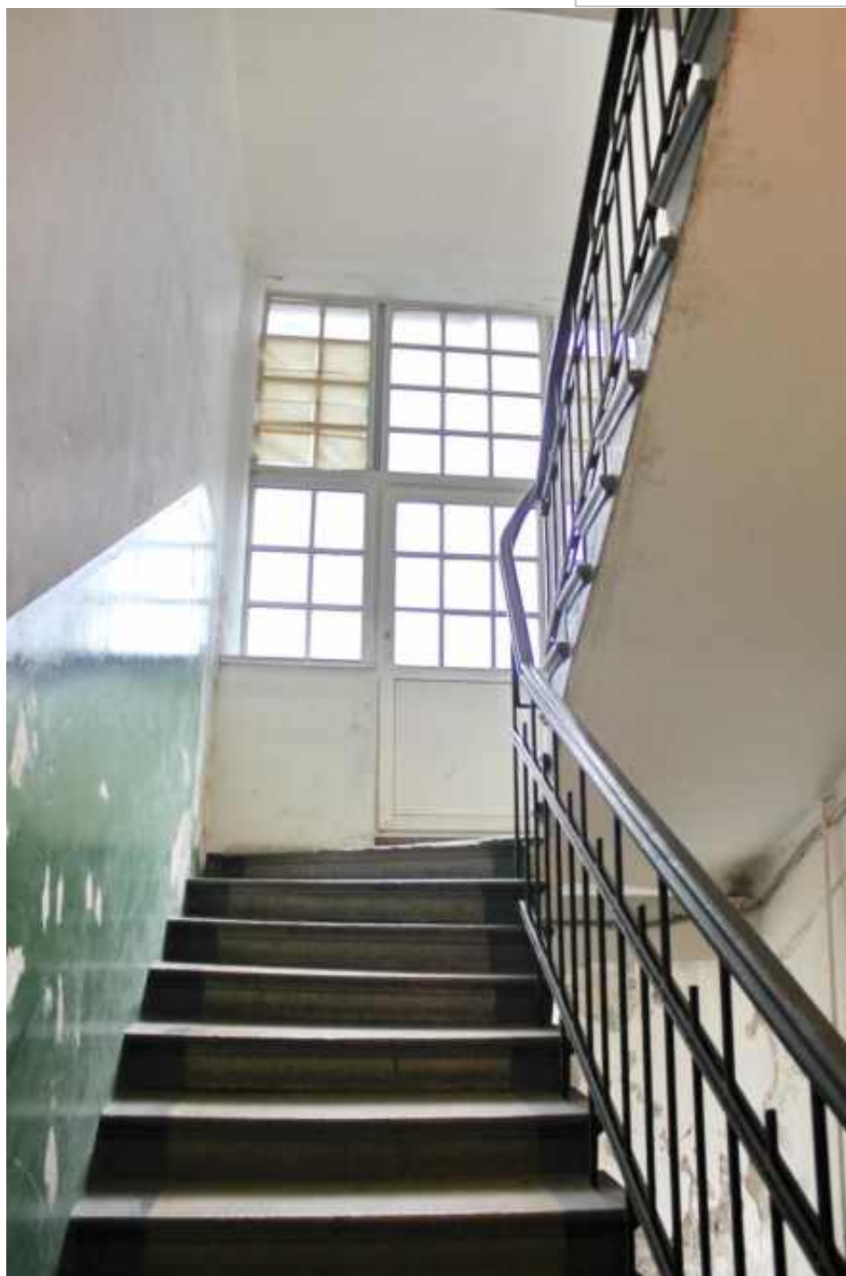
61. Объект культурного наследия регионального значения «Вокзал железнодорожной станции Ланская». Лестница (ЛК-1), общий вид. Дата фотофиксации: 23 апреля 2026 года.
