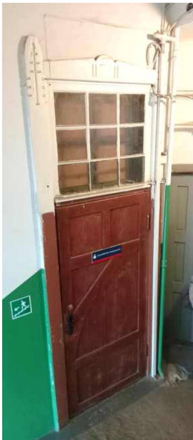
60. Объект культурного наследия регионального значения «Вокзал железнодорожной станции Ланская». Лестница (ЛК-1), фрагмент. Площадка в уровне 3-го этажа. Дата фотофиксации: 23 апреля 2026 года.
