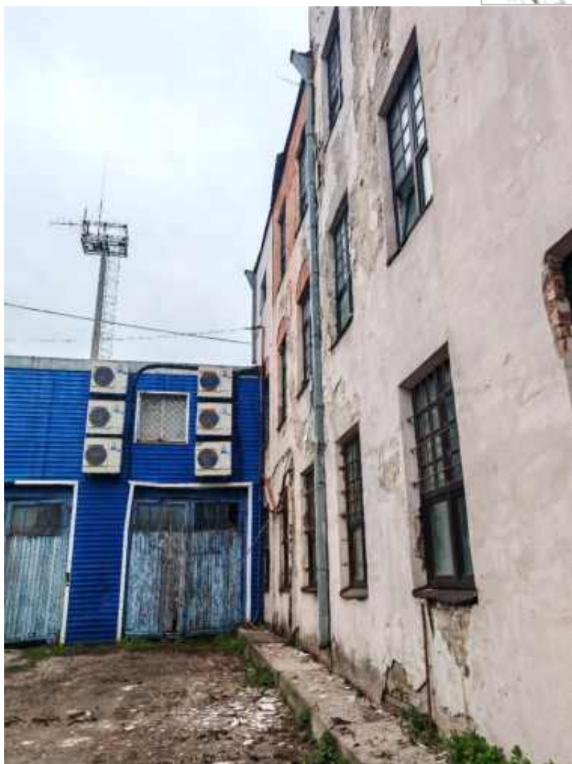
22. Объект культурного наследия регионального значения «Вокзал железнодорожной станции Ланская». Фрагмент северного фасада здания вокзала. Вид с территории объекта культурного наследия. Дата фотофиксации: 23 апреля 2026 года.
