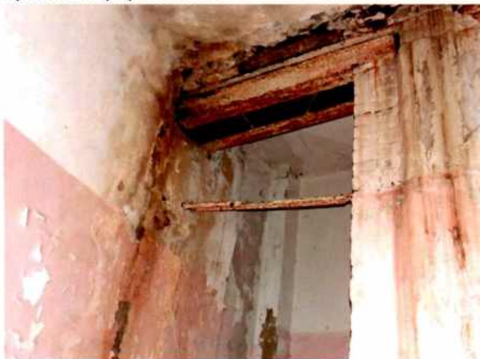
18. Фрагмент интерьера 1ого этажа
