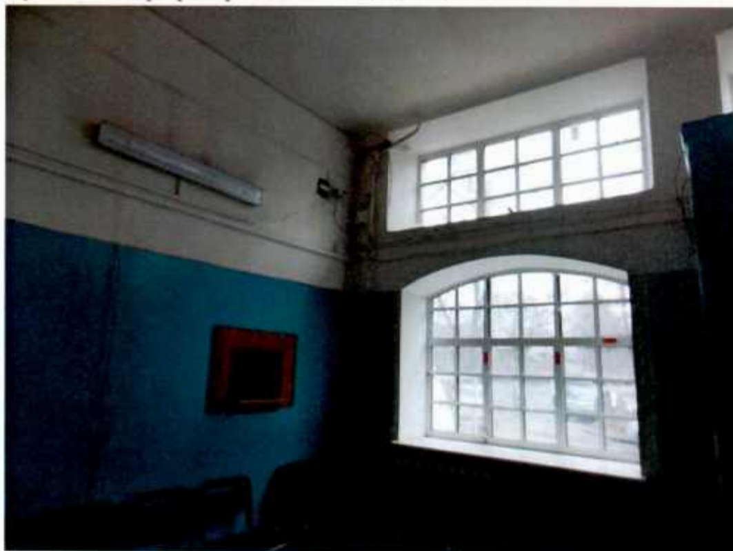
16. Фрагмент интерьера парадного зала ж.д. станции Ланская
