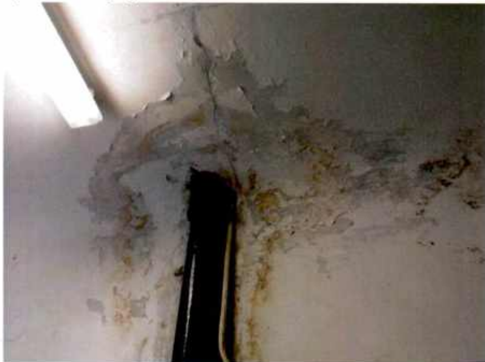
17. Фрагмент интерьера 1ого этажа
