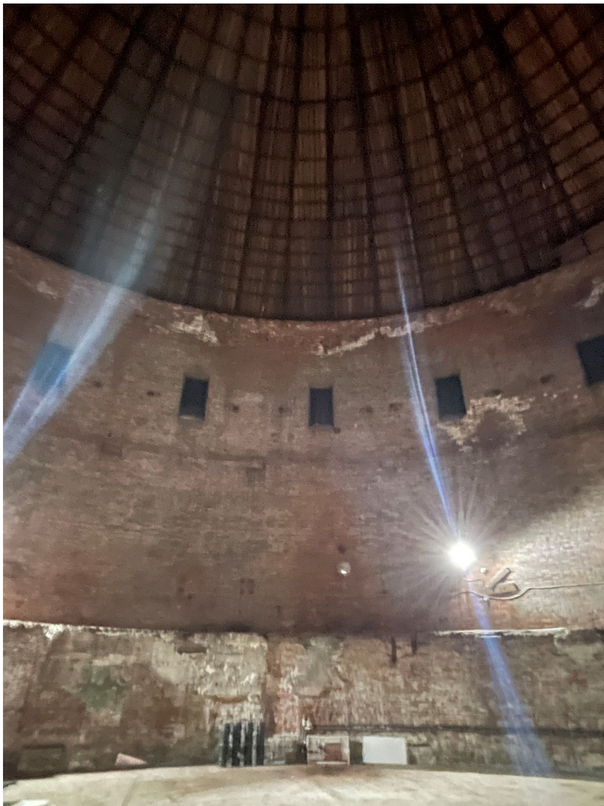
Фото 4. Общий вид на объект.
