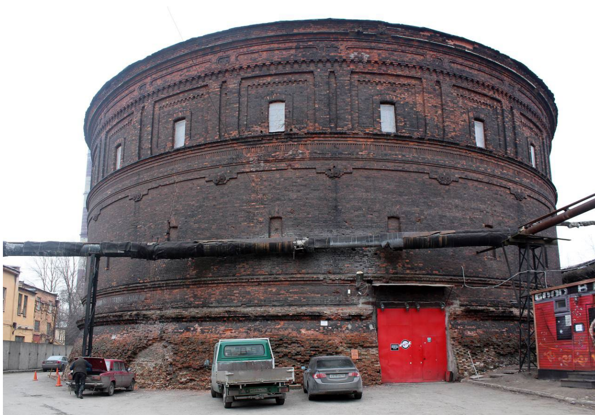
Рис. 33. Главный газовый завод Общества столичного освещения. Газгольдер 2 (наб. Обводного канала, 74, лит. Д). Фото — Виктор М, 25.11.2013. Источник: Citywalls.ru .
