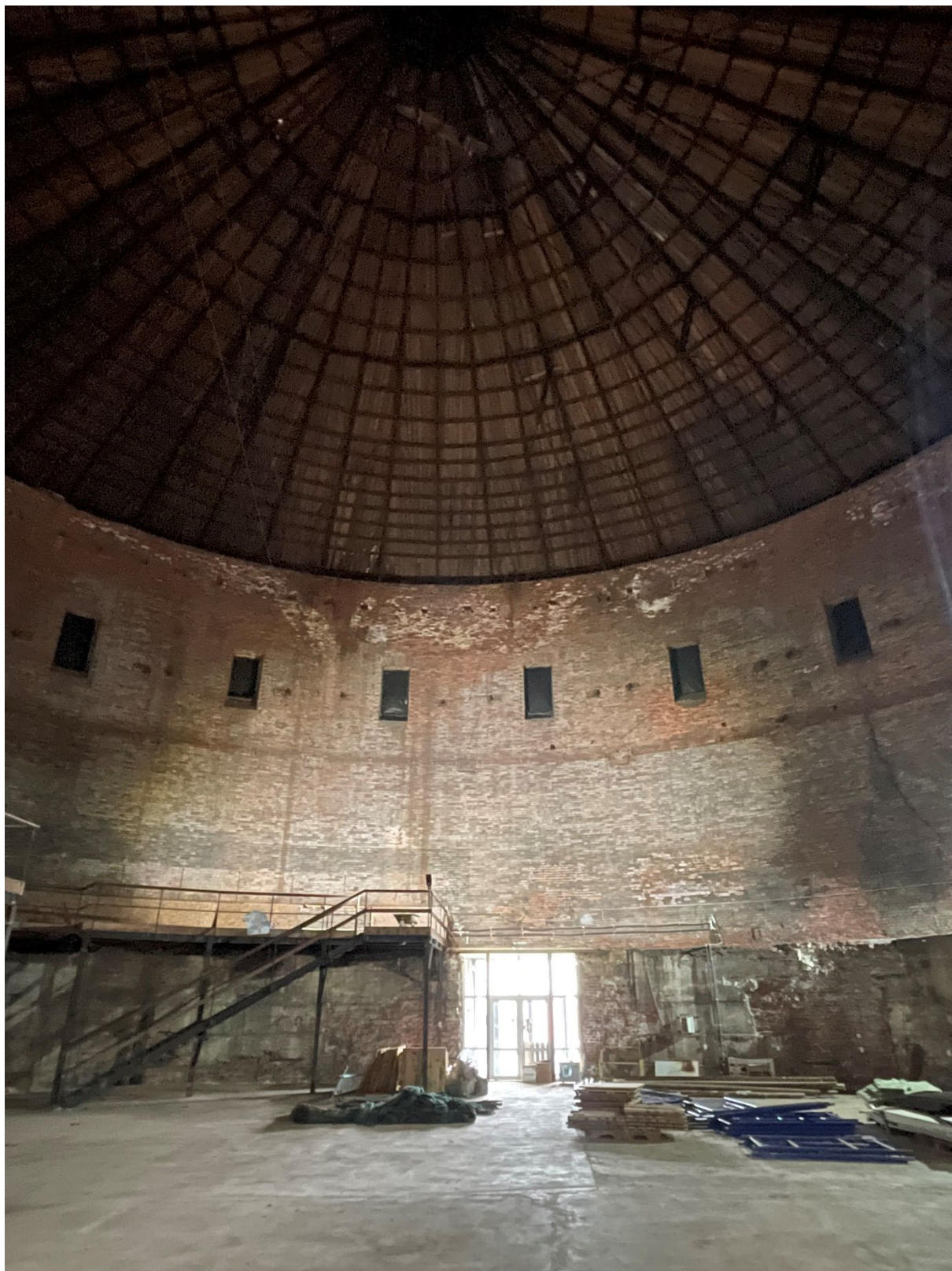
Фото 2. Общий вид на объект.
