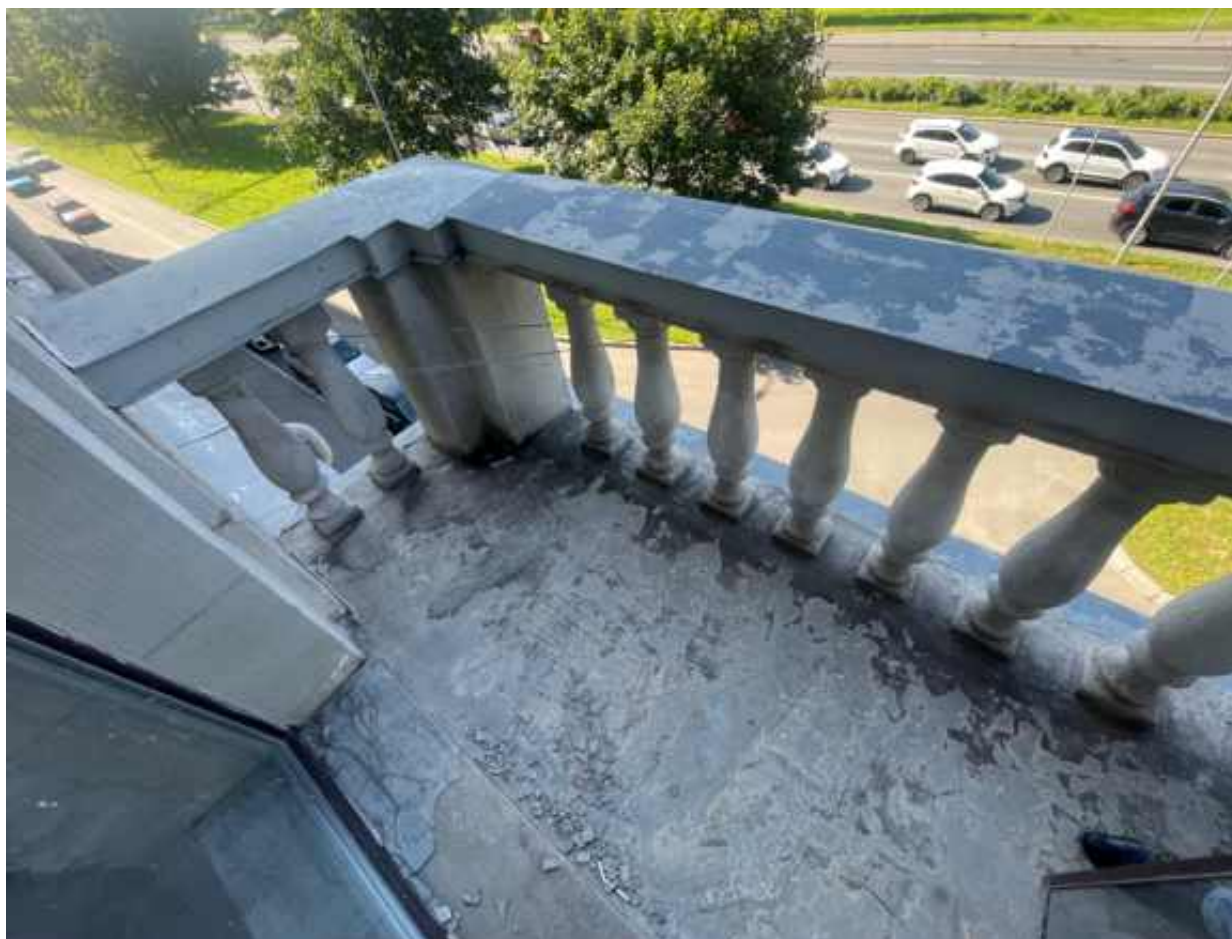
8. Балкон со стороны лицевого фасада.
