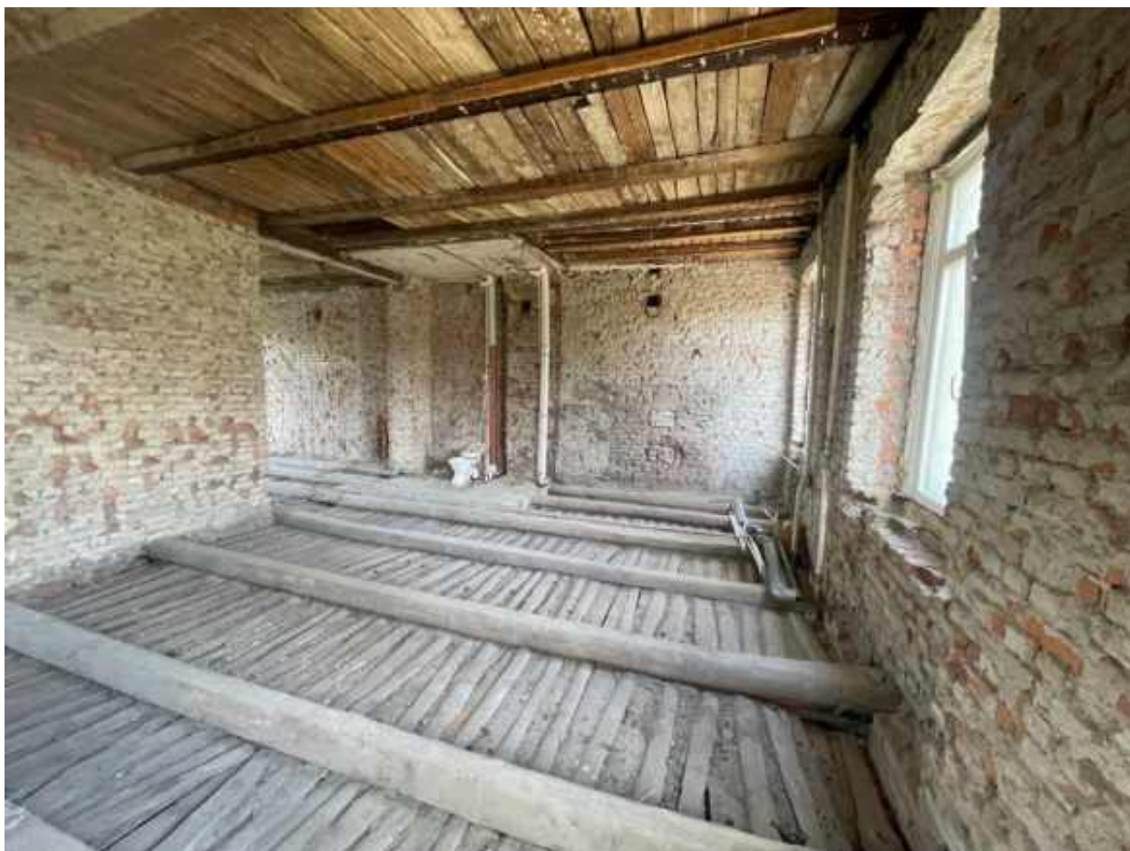
14. Помещение со стороны дворового фасада.
