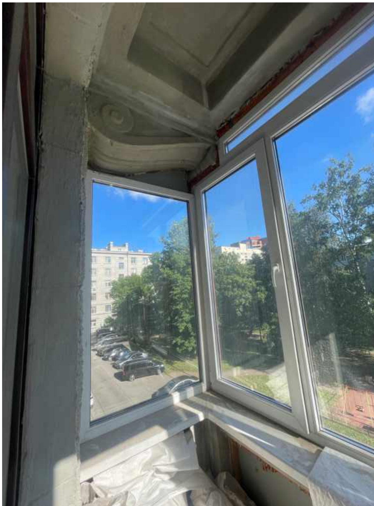
11. Балкон со стороны дворового фасада.
