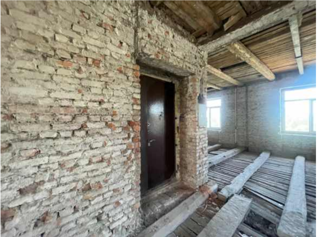
15. Помещение со стороны дворового фасада. Вид на входную дверь.
