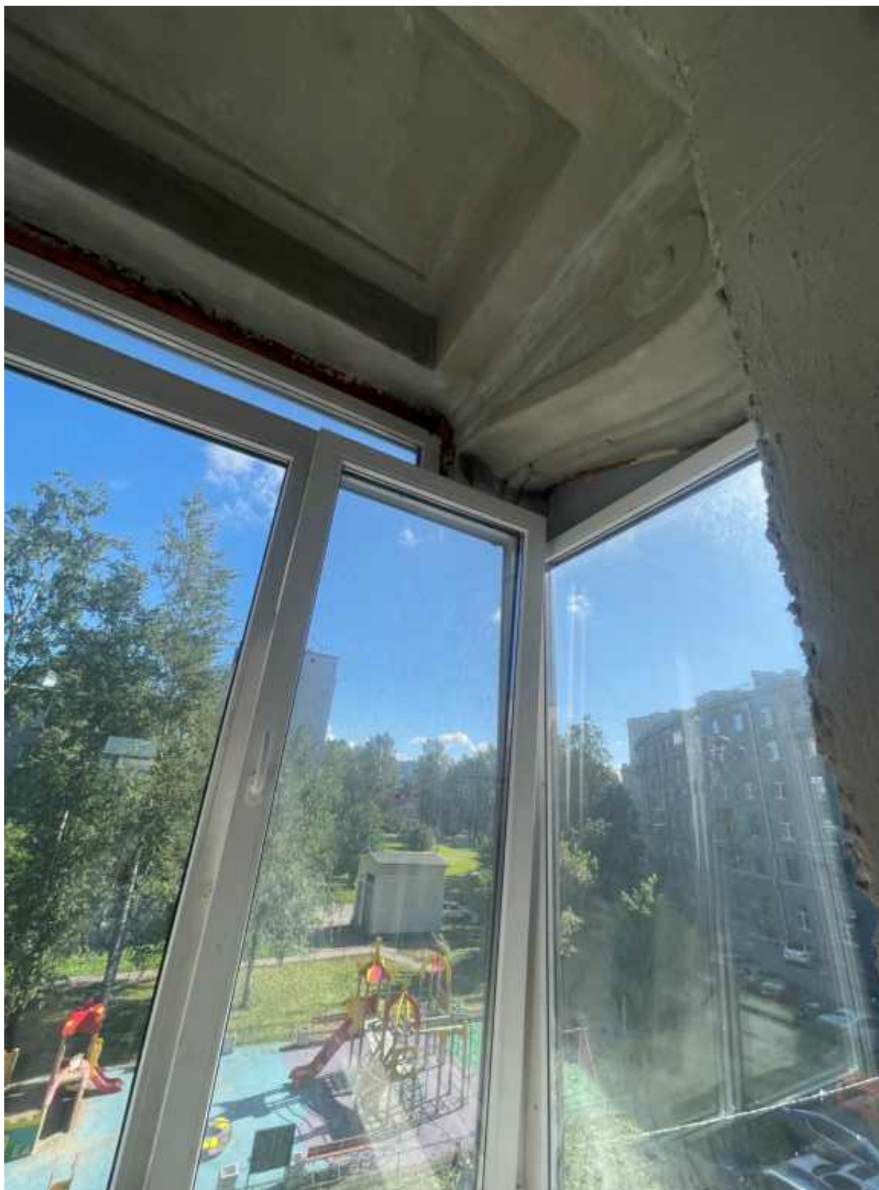
12. Балкон со стороны дворового фасада.
