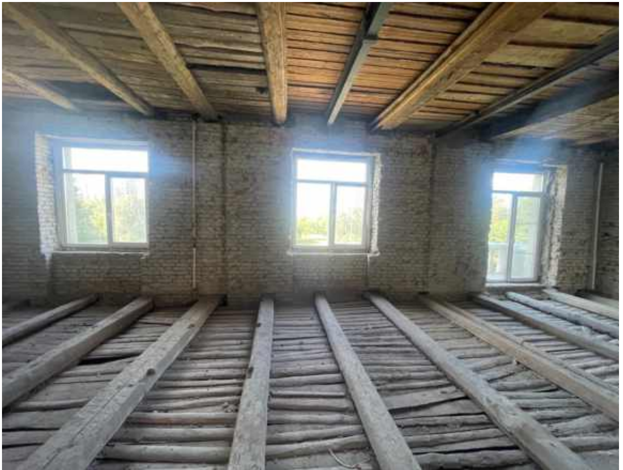
7. Помещение со стороны лицевого фасада.
