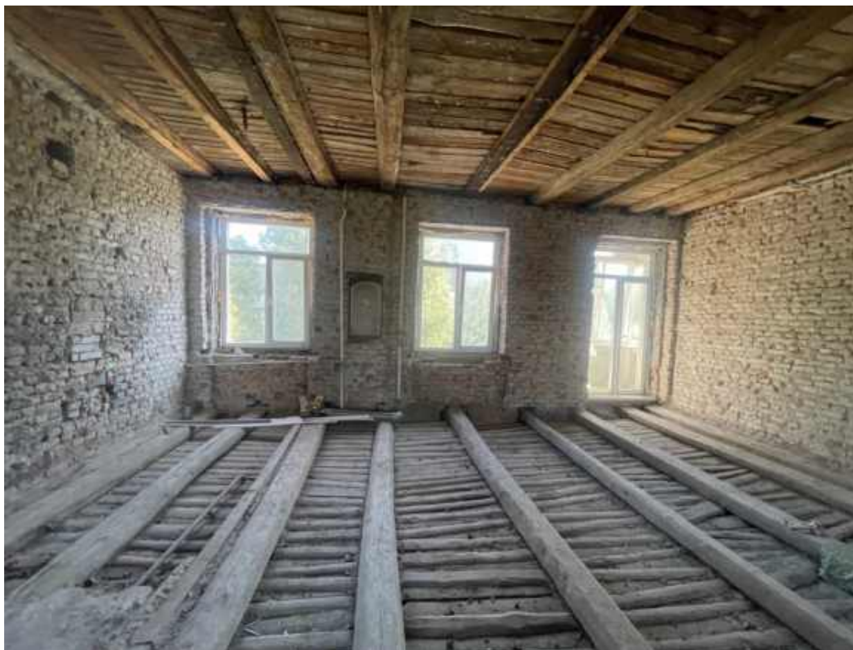
10. Помещения со стороны дворового фасада.
