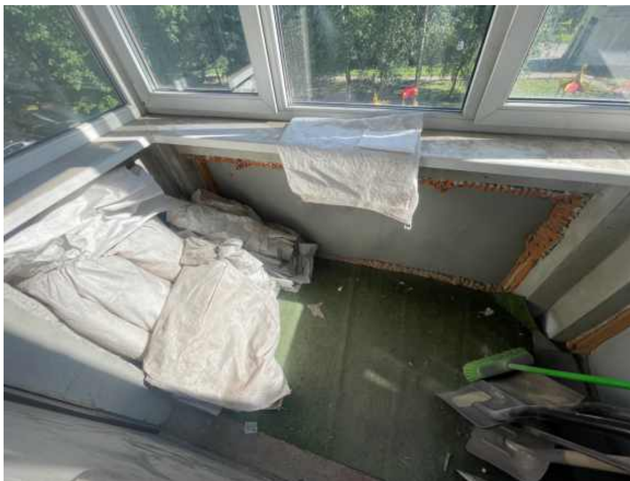
13. Балкон со стороны дворового фасада.
