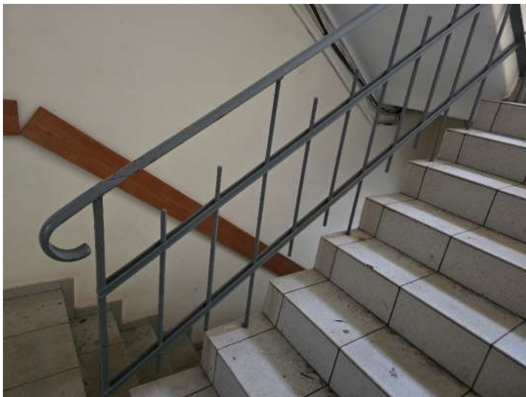
Фото 17. Выявленный объект культурного наследия «Комплекс зданий электромеханической фирмы «Бодо-Эгесторф» (контора, электростанция)», по адресу: Санкт-Петербург, Петровская коса, 3/6. Лестница в здании «конторы».
