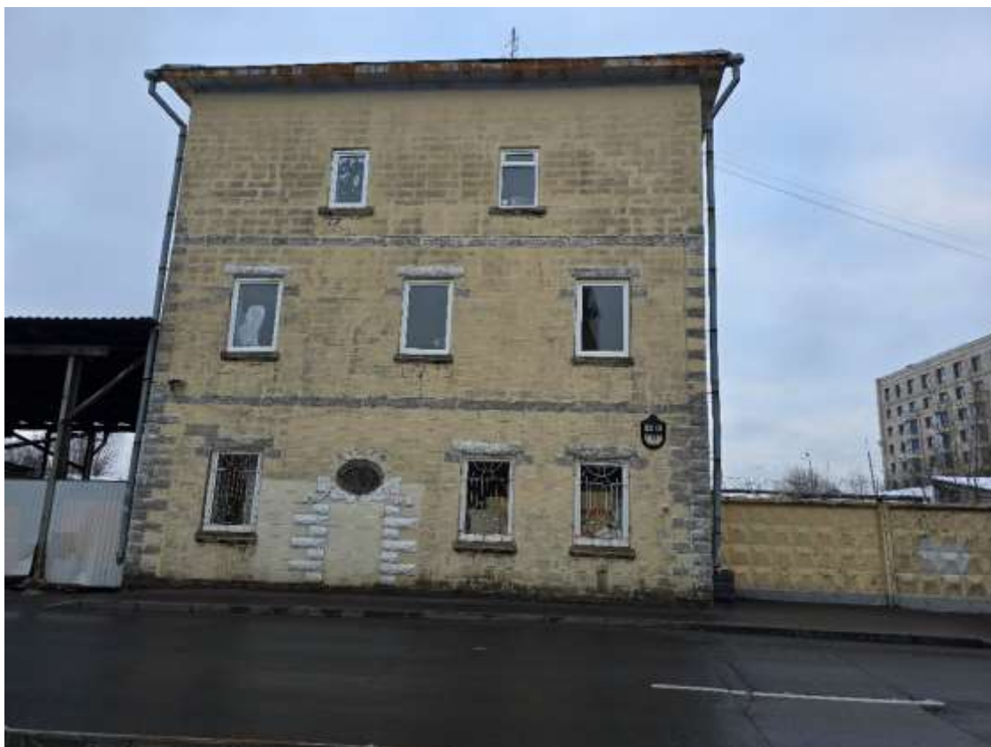
Фото 3. Выявленный объект культурного наследия «Комплекс зданий электромеханической фирмы «Бодо-Эгесторф» (контора, электростанция)», по адресу: Санкт-Петербург, Петровская коса, 3/6. Лицевой (южный) фасад здания «конторы»
