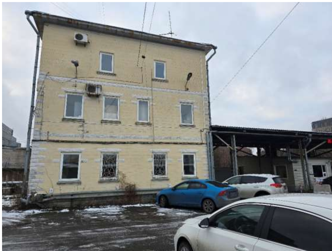
Фото 8. Выявленный объект культурного наследия «Комплекс зданий электромеханической фирмы «Бодо-Эгесторф» (контора, электростанция)», по адресу: Санкт-Петербург, Петровская коса, 3/6. Общий вид на объект со стороны дворовой территории. Северный фасад.
