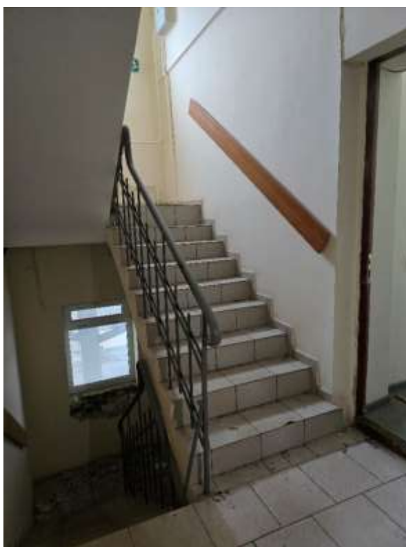
Фото 16. Выявленный объект культурного наследия «Комплекс зданий электромеханической фирмы «Бодо-Эгесторф» (контора, электростанция)», по адресу: Санкт-Петербург, Петровская коса, 3/6. Лестница в здании «конторы».
