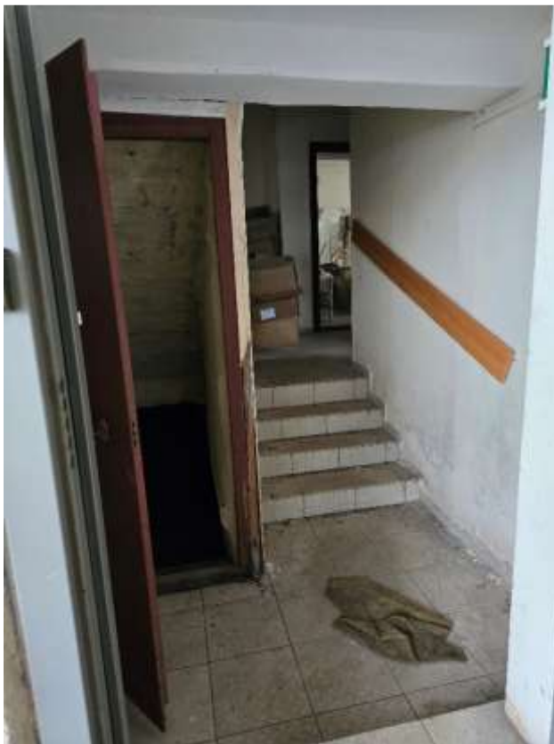
Фото 15. Выявленный объект культурного наследия «Комплекс зданий электромеханической фирмы «Бодо-Эгесторф» (контора, электростанция)», по адресу: Санкт-Петербург, Петровская коса, 3/6. Вестибюль лестничной клетки здания «конторы».
