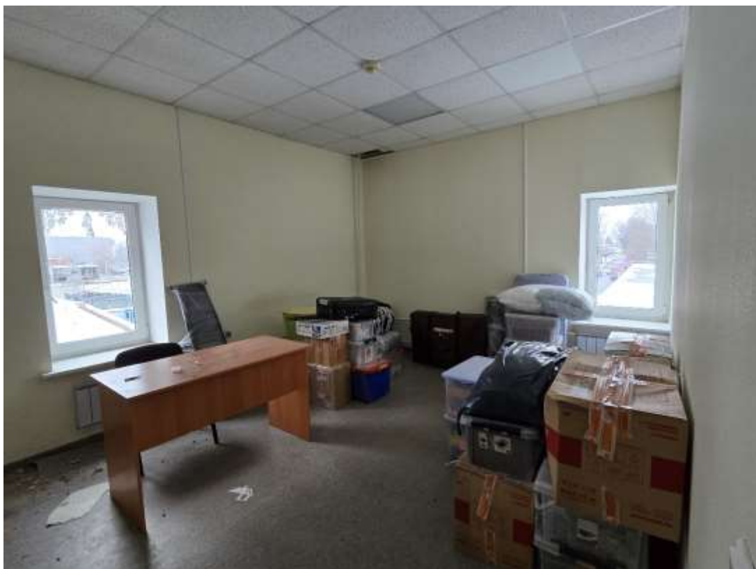
Фото 21. Выявленный объект культурного наследия «Комплекс зданий электромеханической фирмы «Бодо-Эгесторф» (контора, электростанция)», по адресу: Санкт-Петербург, Петровская коса, 3/6. Офисное помещение, 3 этаж
