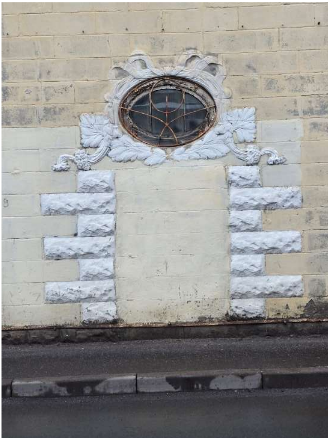
Фото 5. Выявленный объект культурного наследия «Комплекс зданий электромеханической фирмы «Бодо-Эгесторф» (контора, электростанция)», по адресу: Санкт-Петербург, Петровская коса, 3/6. Оформление заложеного дверного проема лицевого (южного) фасада здания «контора»
