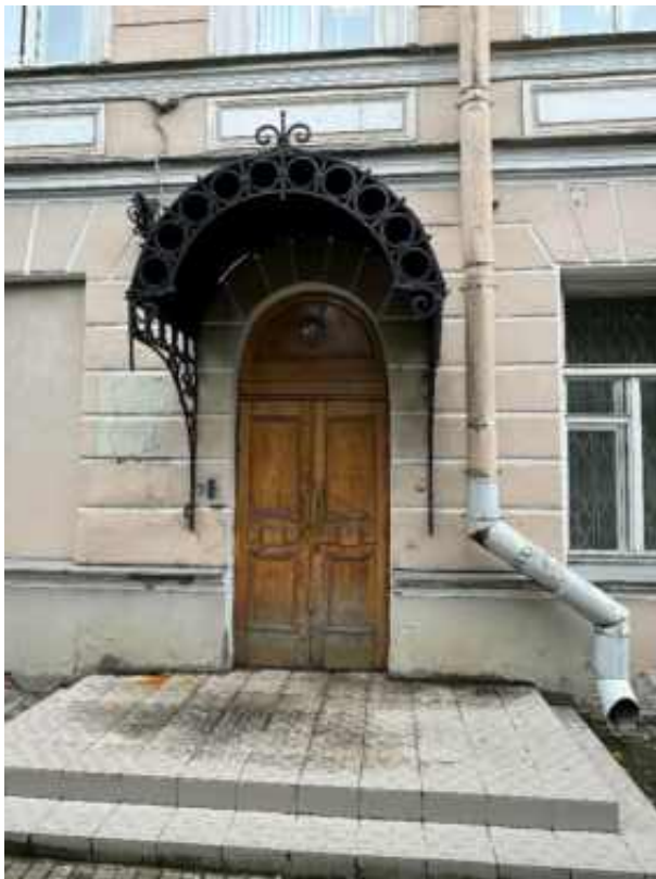
18. «Офицерская казарма», входящая в состав объекта культурного наследия регионального значения «Комплекс казарм Семеновского и Егерского полков», Загородный проспект, дом 54, литера А. Северо-западный фасад. Фрагмент. Фото 02.04.2026г.
