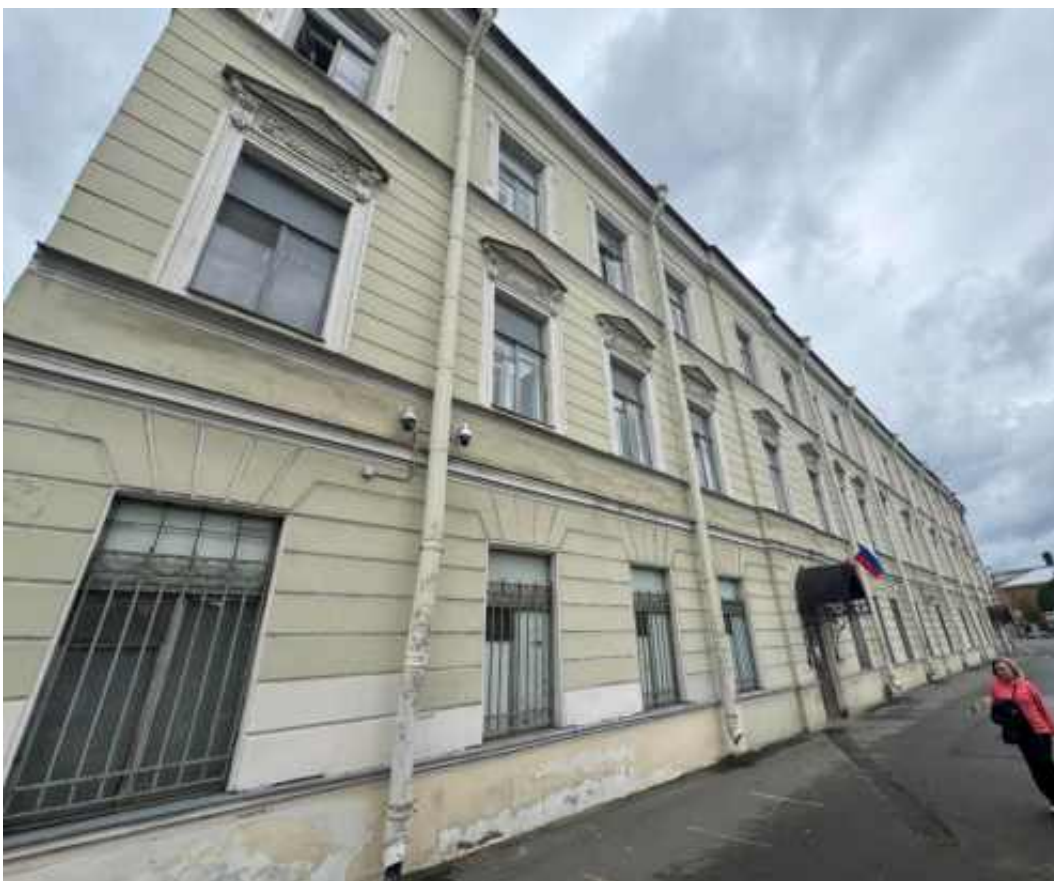
3. «Офицерская казарма», входящая в состав объекта культурного наследия регионального значения «Комплекс казарм Семеновского и Егерского полков», Загородный проспект, дом 54, литера А. Северо-восточный фасад. Общий вид. Фото 02.04.2026г.
