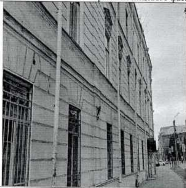
9. Лицевой фасад, общий вид со стороны Введенского канала.
