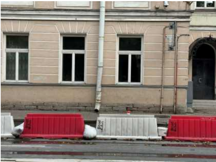
28. «Офицерская казарма», входящая в состав объекта культурного наследия регионального значения «Комплекс казарм Семеновского и Егерского полков», Загородный проспект, дом 54, литера А. Юго-западный фасад. Фрагмент. Фото 02.04.2026г.
