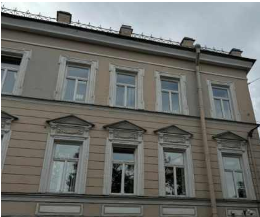
22. «Офицерская казарма», входящая в состав объекта культурного наследия регионального значения «Комплекс казарм Семеновского и Егерского полков», Загородный проспект, дом 54, литера А. Северо-западный фасад. Фрагмент. Фото 02.04.2026г.
