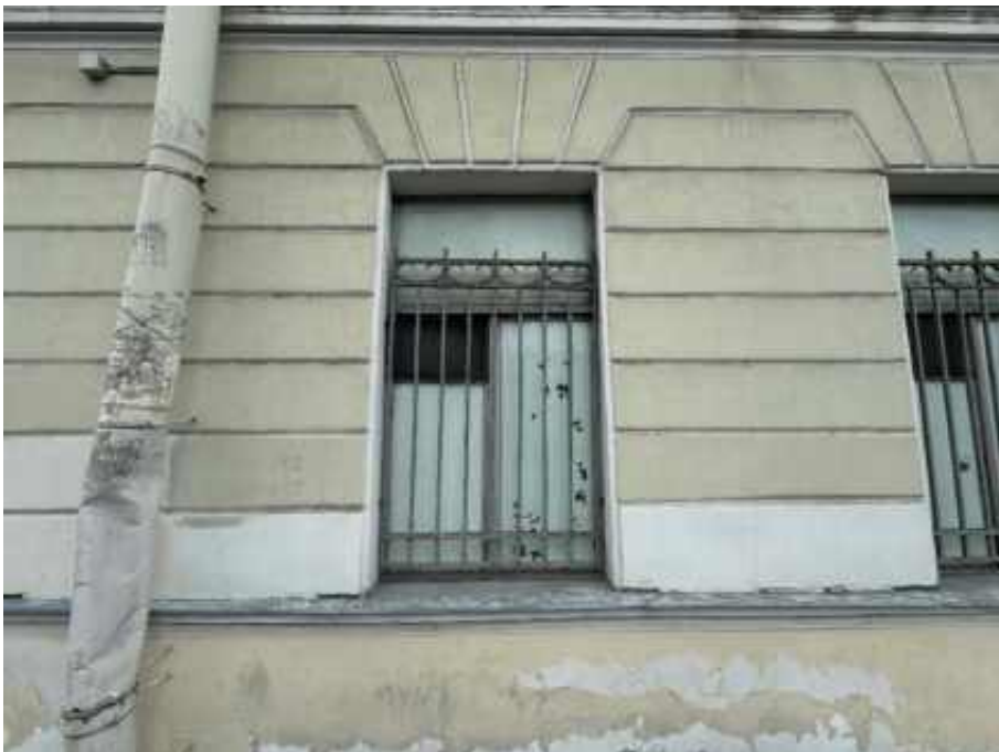
30. «Офицерская казарма», входящая в состав объекта культурного наследия регионального значения «Комплекс казарм Семеновского и Егерского полков», Загородный проспект, дом 54, литера А. Северо-восточный фасад. Фрагмент. Фото 02.04.2026г.
