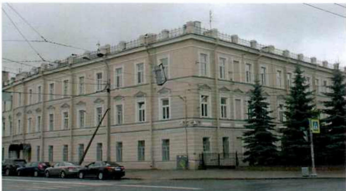
Фото №5. Лицевые фасады. Вид со стороны Загородного проспекта.
