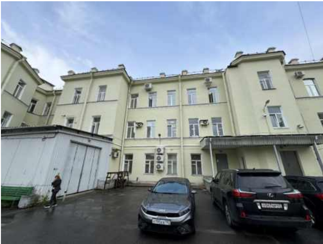
9. «Офицерская казарма», входящая в состав объекта культурного наследия регионального значения «Комплекс казарм Семеновского и Егерского полков», Загородный проспект, дом 54, литера А. Дворовый фасад. Общий вид. Фото 02.04.2026г.
