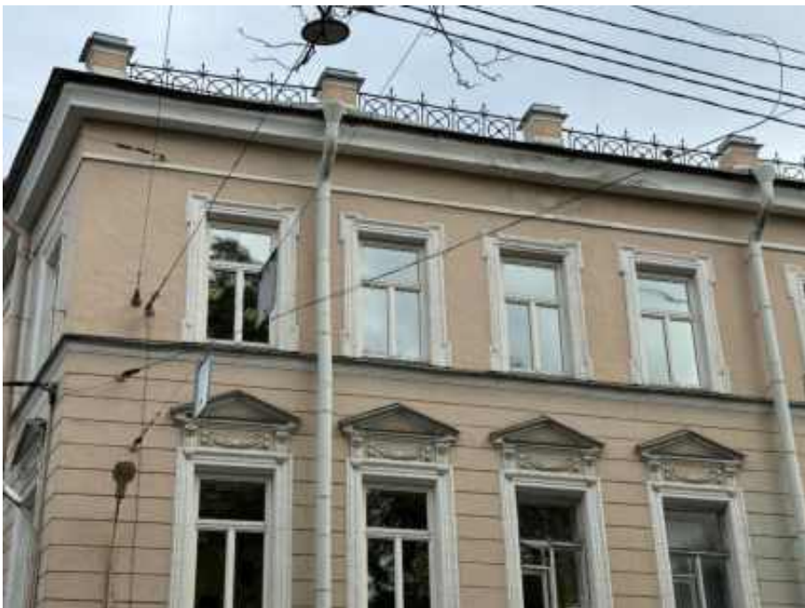
23. «Офицерская казарма», входящая в состав объекта культурного наследия регионального значения «Комплекс казарм Семеновского и Егерского полков», Загородный проспект, дом 54, литера А. Юго-западный фасад. Фрагмент. Фото 02.04.2026г.
