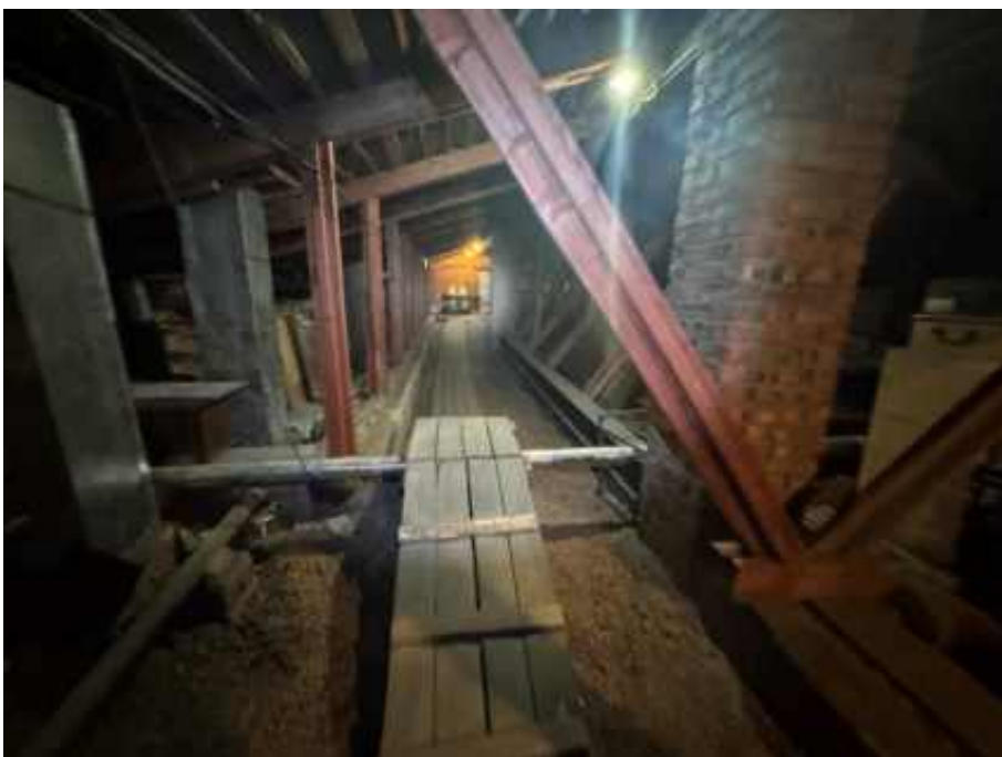
49. «Офицерская казарма», входящая в состав объекта культурного наследия регионального значения «Комплекс казарм Семеновского и Егерского полков», Загородный проспект, дом 54, литера А. Чердак. Общий вид. Фото 02.04.2026г.
