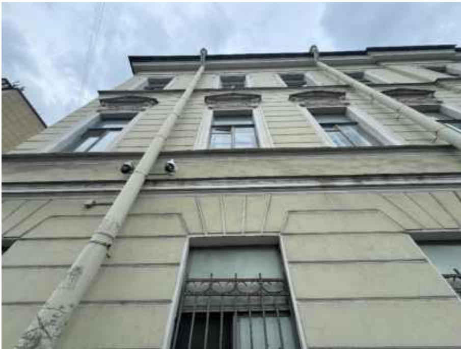
29. «Офицерская казарма», входящая в состав объекта культурного наследия регионального значения «Комплекс казарм Семеновского и Егерского полков», Загородный проспект, дом 54, литера А. Северо-восточный фасад. Фрагмент. Фото 02.04.2026г.
