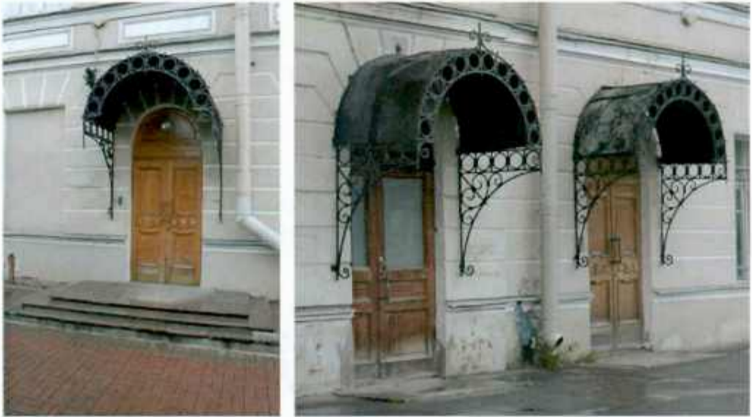
Фото №7, 8. Входные группы лицевых фасадов.
