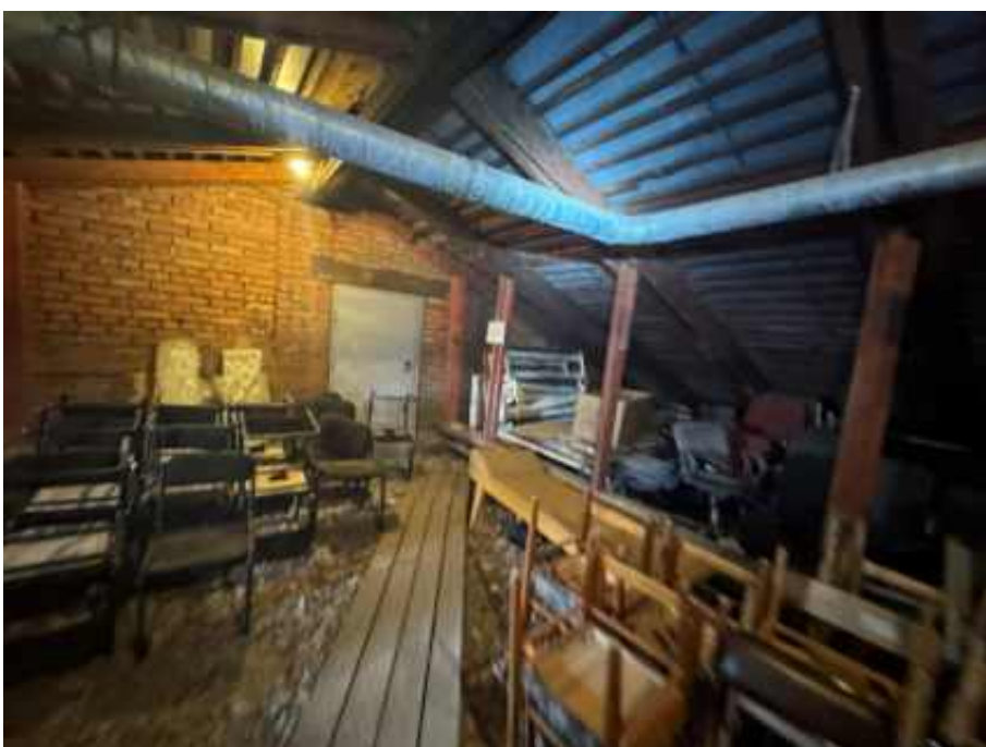
50. «Офицерская казарма», входящая в состав объекта культурного наследия регионального значения «Комплекс казарм Семеновского и Егерского полков», Загородный проспект, дом 54, литера А. Чердак. Общий вид. Фото 02.04.2026г.
