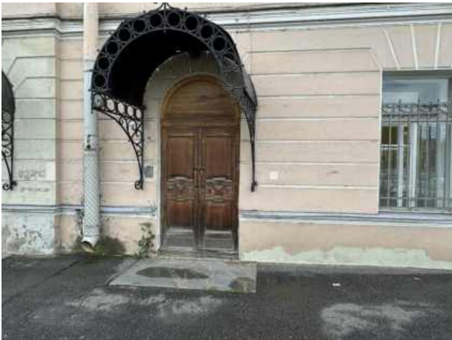
38. «Офицерская казарма», входящая в состав объекта культурного наследия регионального значения «Комплекс казарм Семеновского и Егерского полков», Загородный проспект, дом 54, литера А. Северо-восточный фасад. Фрагмент. Фото 02.04.2026г.
