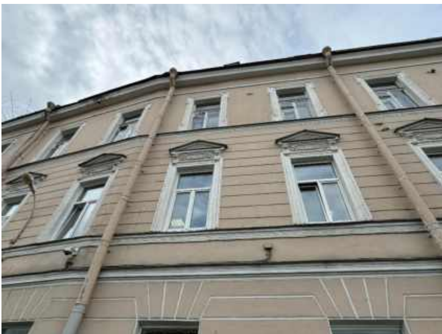
41. «Офицерская казарма», входящая в состав объекта культурного наследия регионального значения «Комплекс казарм Семеновского и Егерского полков», Загородный проспект, дом 54, литера А. Северо-восточный фасад. Фрагмент. Фото 02.04.2026г.
