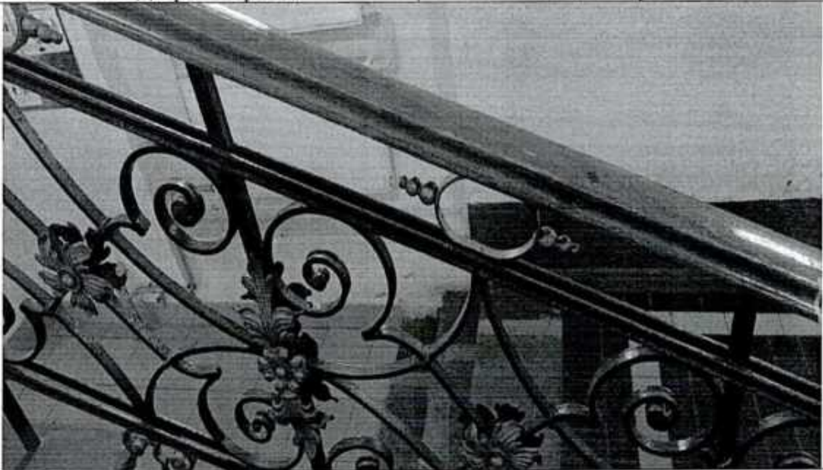
13. Фрагмент главной лестницы.
