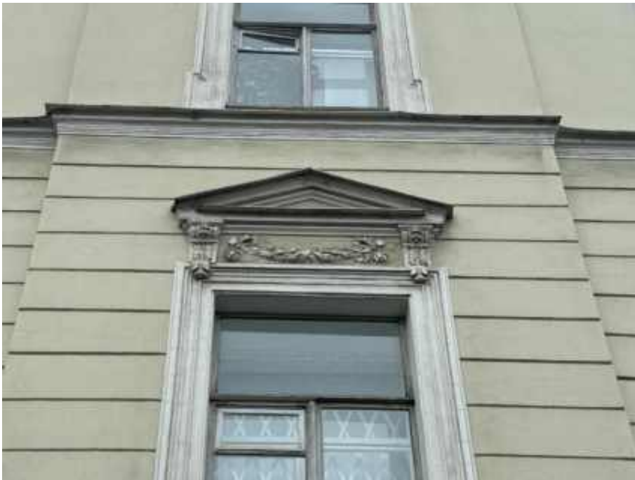
31. «Офицерская казарма», входящая в состав объекта культурного наследия регионального значения «Комплекс казарм Семеновского и Егерского полков», Загородный проспект, дом 54, литера А. Северо-восточный фасад. Фрагмент. Фото 02.04.2026г.
