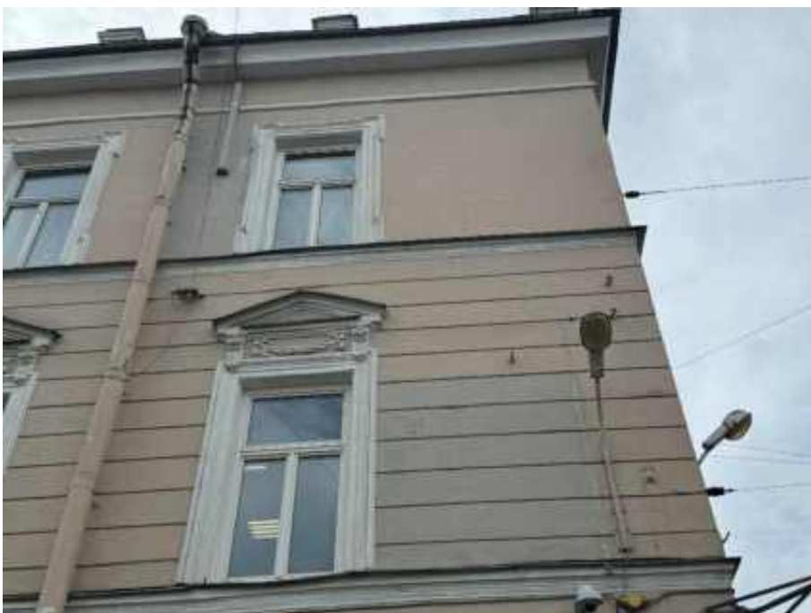
44. «Офицерская казарма», входящая в состав объекта культурного наследия регионального значения «Комплекс казарм Семеновского и Егерского полков», Загородный проспект, дом 54, литера А. Северо-восточный фасад. Фрагмент. Фото 02.04.2026г.
