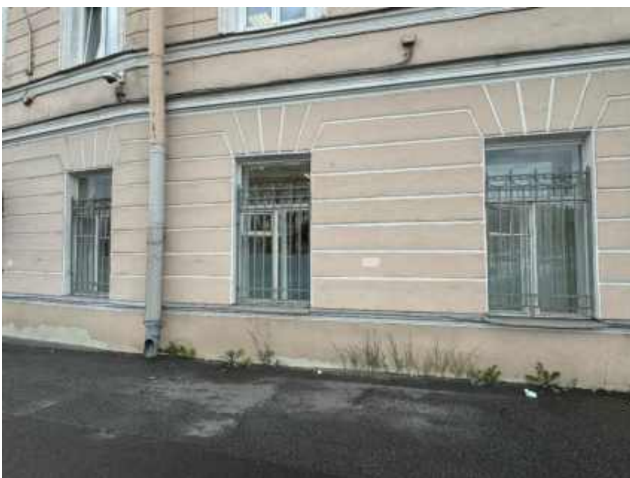
40. «Офицерская казарма», входящая в состав объекта культурного наследия регионального значения «Комплекс казарм Семеновского и Егерского полков», Загородный проспект, дом 54, литера А. Северо-восточный фасад. Фрагмент. Фото 02.04.2026г.
