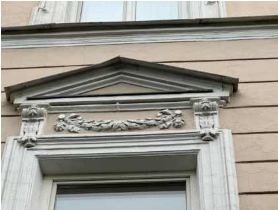
17. «Офицерская казарма», входящая в состав объекта культурного наследия регионального значения «Комплекс казарм Семеновского и Егерского полков», Загородный проспект, дом 54, литера А. Северо-западный фасад. Фрагмент. Фото 02.04.2026г.
