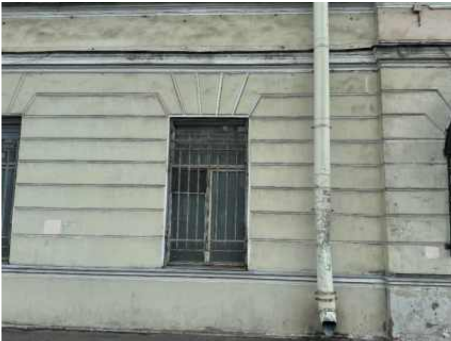
37. «Офицерская казарма», входящая в состав объекта культурного наследия регионального значения «Комплекс казарм Семеновского и Егерского полков», Загородный проспект, дом 54, литера А. Северо-восточный фасад. Фрагмент. Фото 02.04.2026г.
