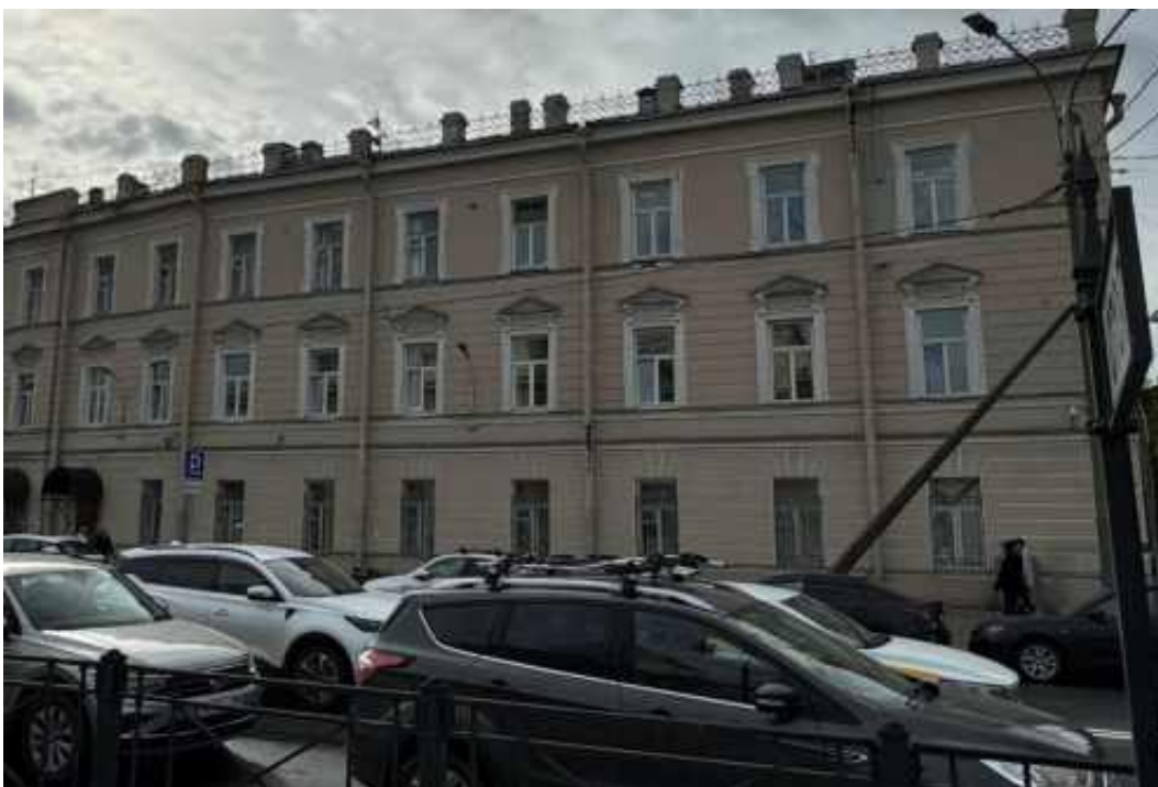
4. «Офицерская казарма», входящая в состав объекта культурного наследия регионального значения «Комплекс казарм Семеновского и Егерского полков», Загородный проспект, дом 54, литера А. Северо-восточный фасад. Общий вид. Фото 02.04.2026г.
