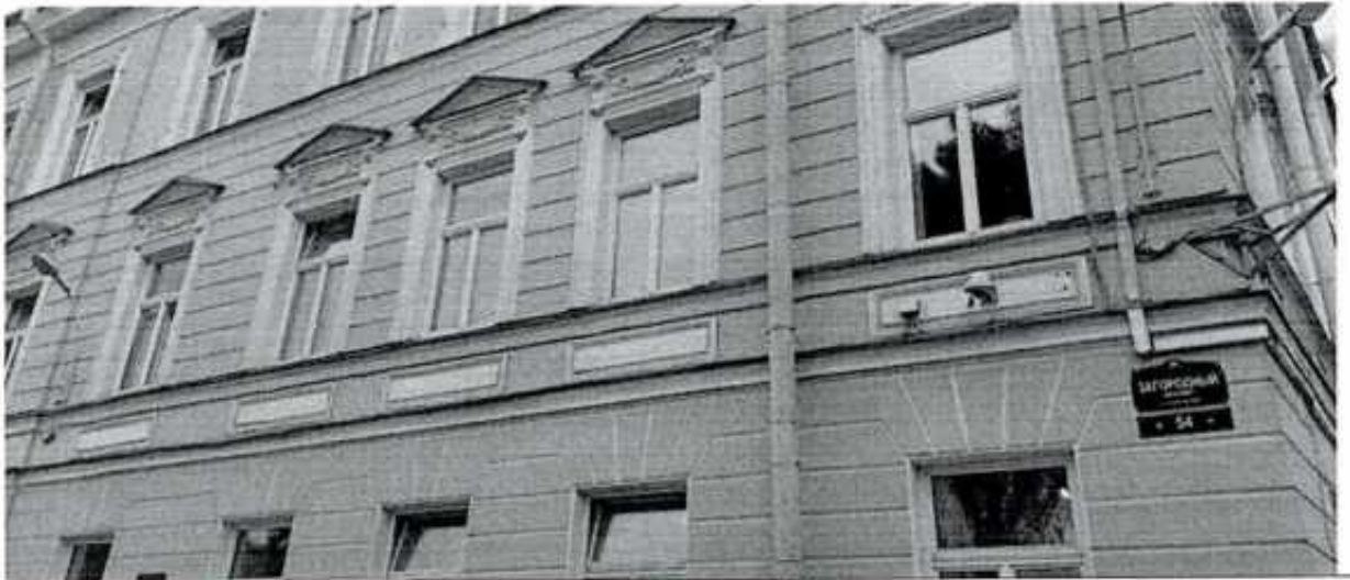
6. Фрагмент лицевого фасада со стороны Загородного проспекта.
