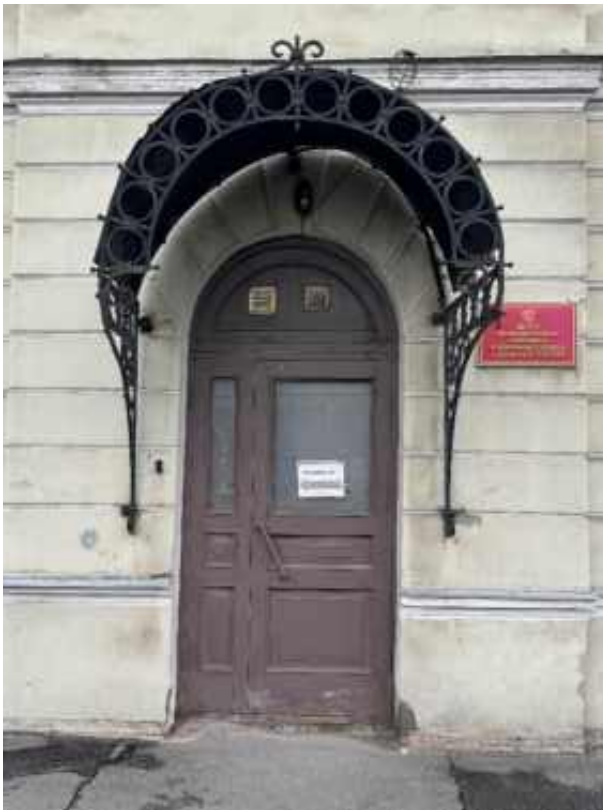
33. «Офицерская казарма», входящая в состав объекта культурного наследия регионального значения «Комплекс казарм Семеновского и Егерского полков», Загородный проспект, дом 54, литера А. Северо-восточный фасад. Фрагмент. Фото 02.04.2026г.
