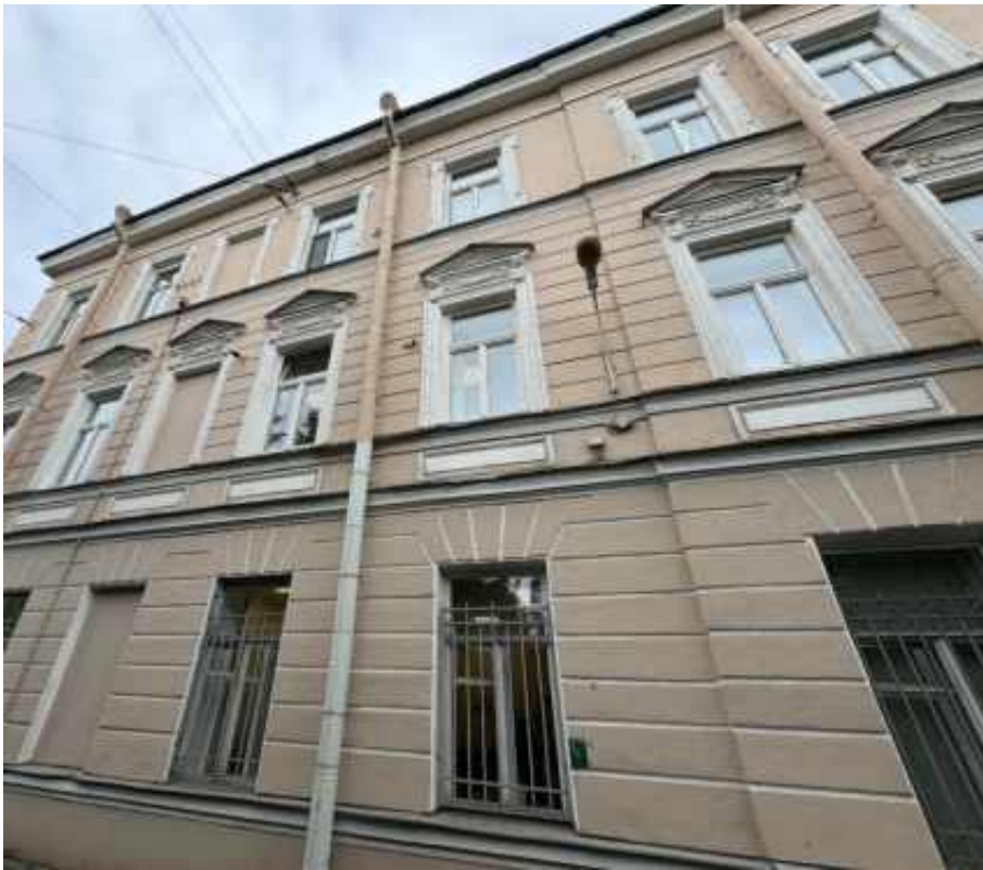
13. «Офицерская казарма», входящая в состав объекта культурного наследия регионального значения «Комплекс казарм Семеновского и Егерского полков», Загородный проспект, дом 54, литера А. Северо-западный фасад. Фрагмент. Фото 02.04.2026г.
