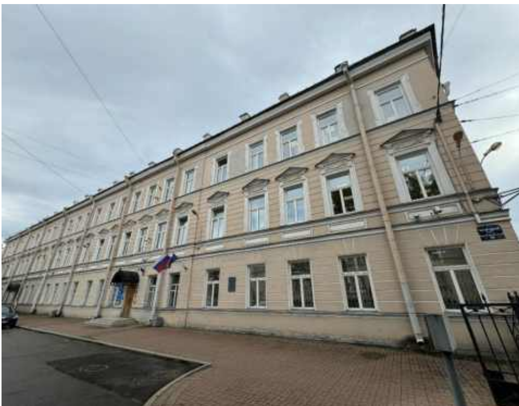
1. «Офицерская казарма», входящая в состав объекта культурного наследия регионального значения «Комплекс казарм Семеновского и Егерского полков», Загородный проспект, дом 54, литера А. Северо-западный фасад. Общий вид. Фото 02.04.2026г.
