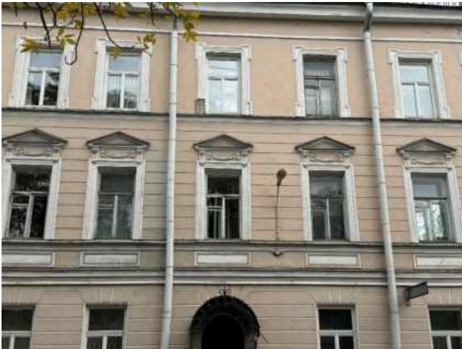
25. «Офицерская казарма», входящая в состав объекта культурного наследия регионального значения «Комплекс казарм Семеновского и Егерского полков», Загородный проспект, дом 54, литера А. Юго-западный фасад. Фрагмент. Фото 02.04.2026г.
