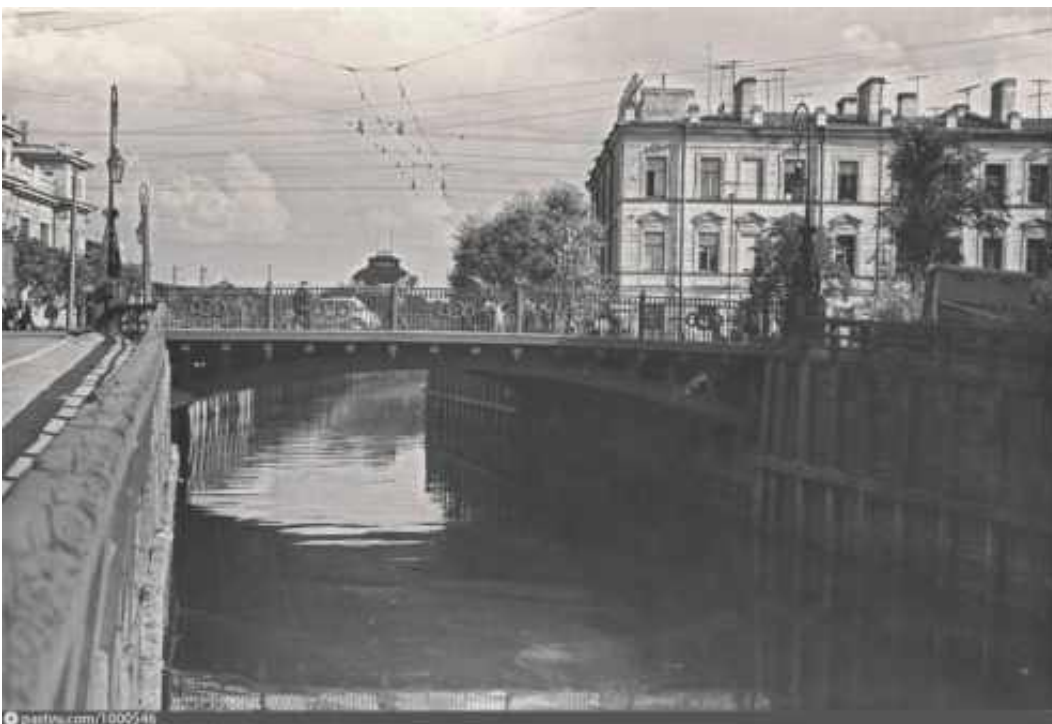
16. Справа фасада со стороны Загородного пр. Фото 1955-1965 гг. https://pastvu.com/p/1000546 .
