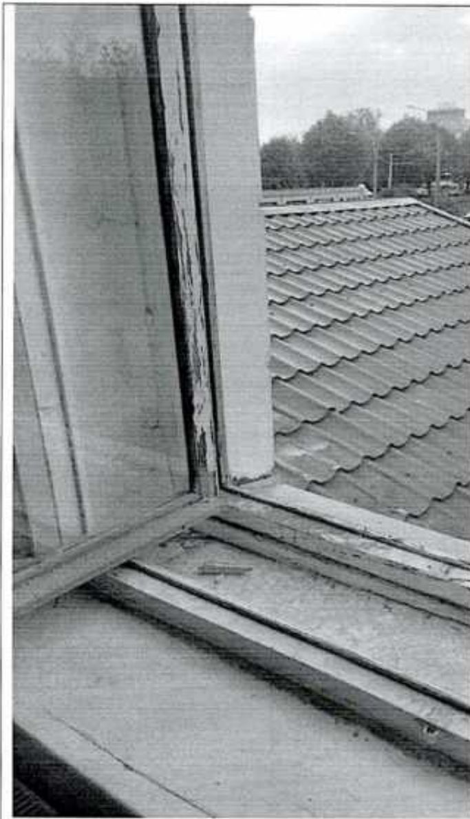
17. Окно в уровне 2 этажа.
