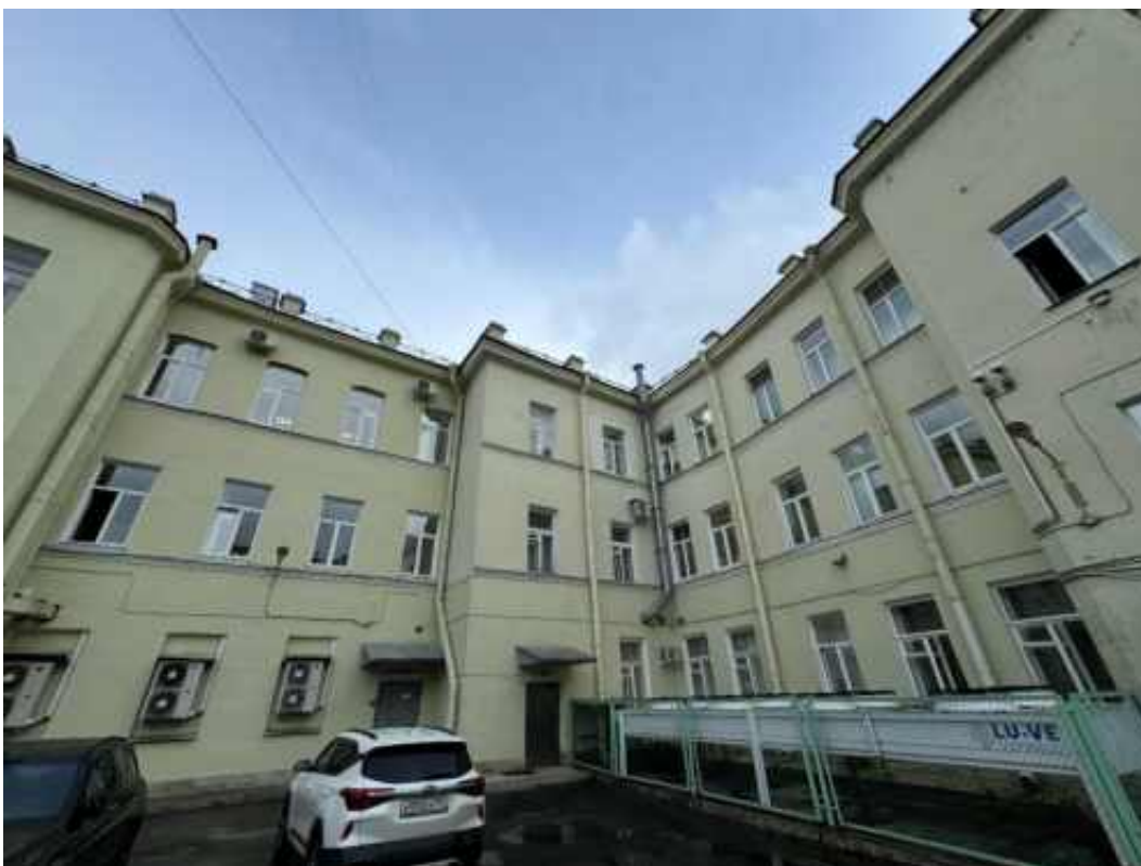
11. «Офицерская казарма», входящая в состав объекта культурного наследия регионального значения «Комплекс казарм Семеновского и Егерского полков», Загородный проспект, дом 54, литера А. Дворовый фасад. Общий вид. Фото 02.04.2026г.
