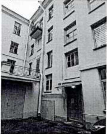
Фрагмент дворового фасада
