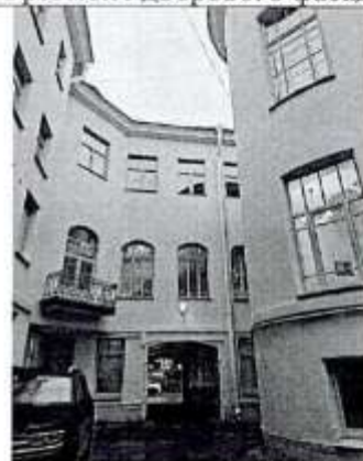
Фрагмент дворового фасада
