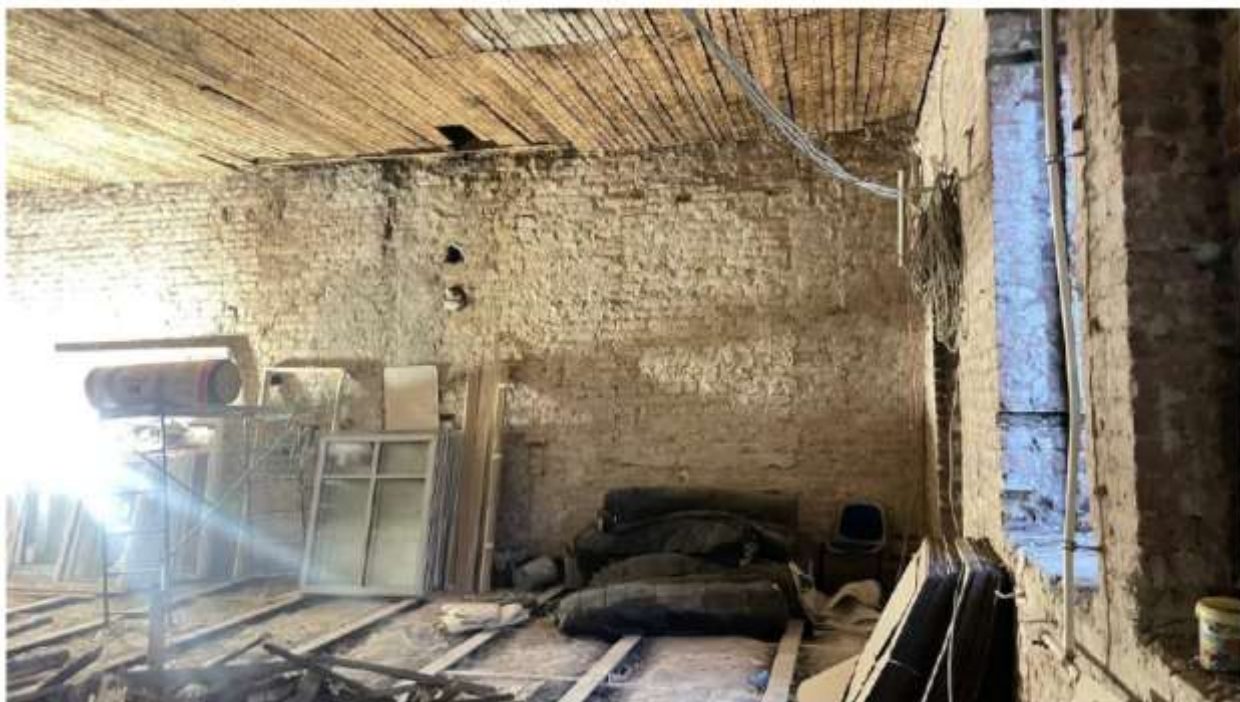
Илл. 26. Объект культурного наследия регионального значения «Особняк Л.Н. Симонova (Столыпиных)», расположенный по адресу: Санкт-Петербург, Гагаринская ул., 5, лит. А. Общий вид помещения в осях 1-3/А-В с демонтированными перегородками и отделочными слоями.
