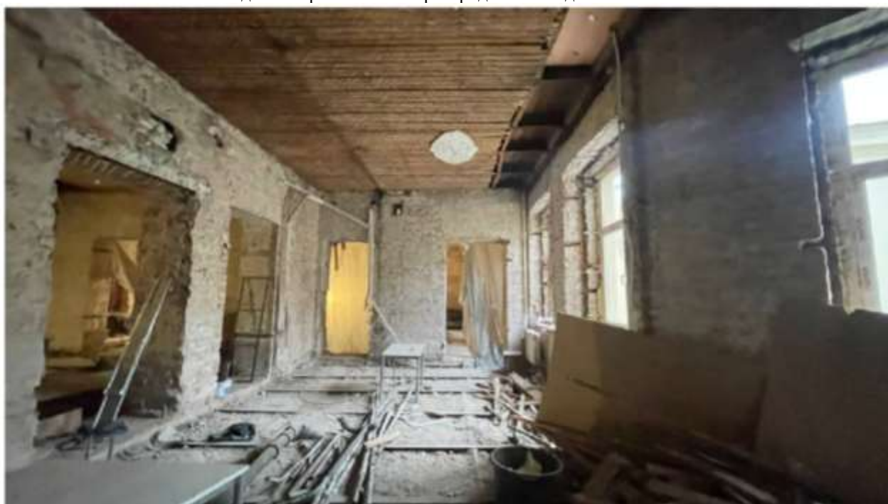
Илл. 33. Объект культурного наследия регионального значения «Особняк Л.Н. Симонова (Столыпиных)», расположенный по адресу: Санкт-Петербург, Гагаринская ул., 5, лит. А. Общий вид помещения в осях 3-5/Б-В с демонтированными перегородками и отделочными слоями.
