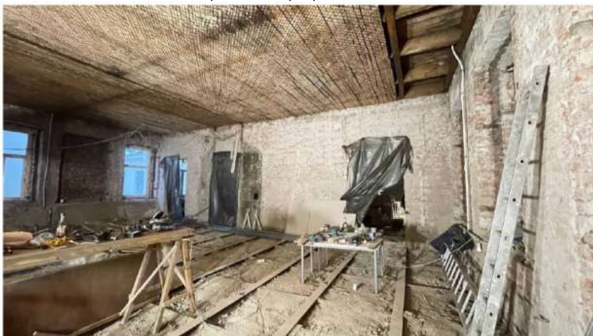
Илл. 27. Объект культурного наследия регионального значения «Особняк Л.Н. Симонova (Столыпиных)», расположенный по адресу: Санкт-Петербург, Гагаринская ул., 5, лит. А. Общий вид помещения в осях 1-3/А-В с демонтированными перегородками и отделочными слоями.
