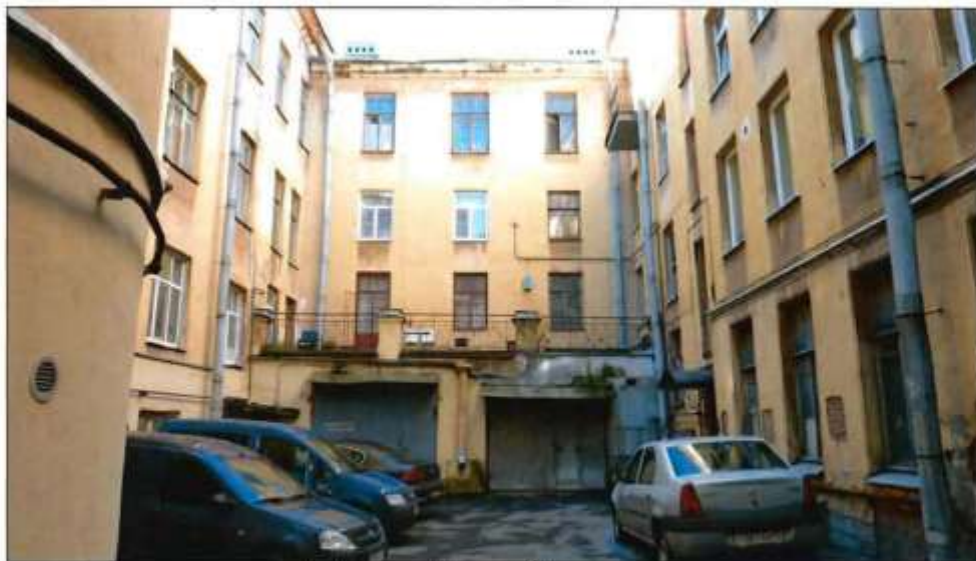
3. Дворовые фасады. Вид с востока.
