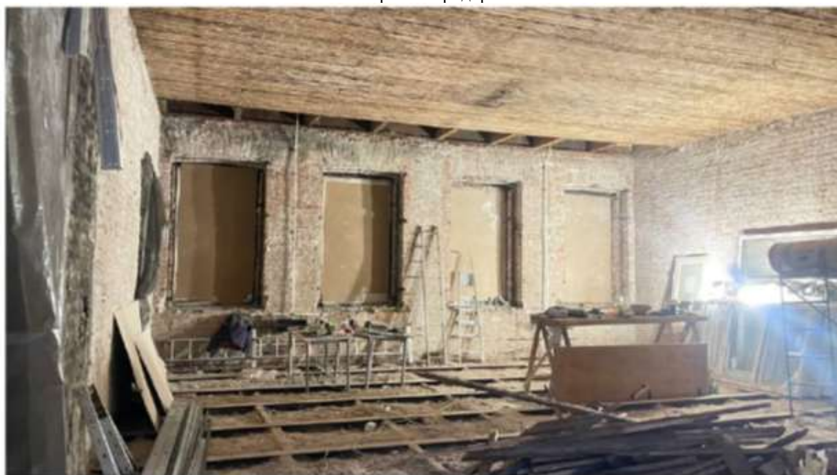
Илл. 25. Объект культурного наследия регионального значения «Особняк Л.Н. Симонова (Столыпиных)», расположенный по адресу: Санкт-Петербург, Гагаринская ул., 5, лит. А. Общий вид помещения в осях 1-3/А-В с демонтированными перегородками и отделочными слоями.
