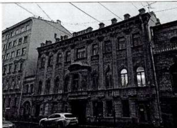
Общий вид лицевого фасада
