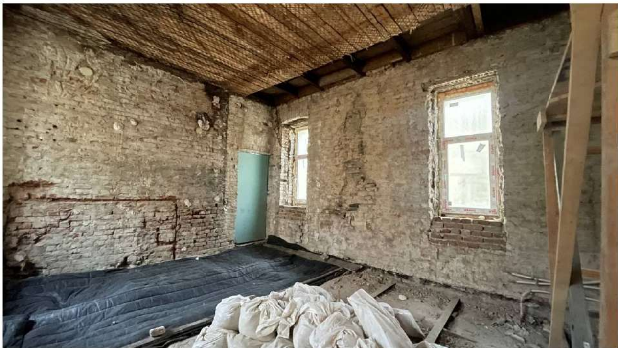
Илл. 34. Объект культурного наследия регионального значения «Особняк Л.Н. Симонова (Столыпиных)», расположенный по адресу: Санкт-Петербург, Гагаринская ул., 5, лит. А. Вид на стену по оси Г и 5 с демонтированными перегородками и отделочными слоями.
