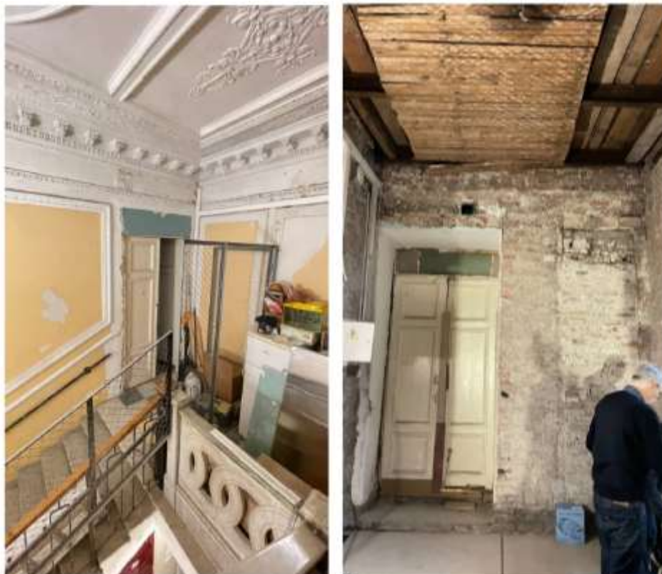
Илл. 23. Объект культурного наследия регионального значения «Особняк Л.Н. Симонова (Столыпиных)», расположенный по адресу: Санкт-Петербург, Гагаринская ул., 5, лит. А. Вид со стороны лестничной клетки на вход в кв.21
