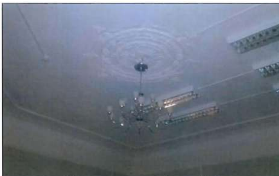
32. Лепная потолочная розетка (квартира № 21).
