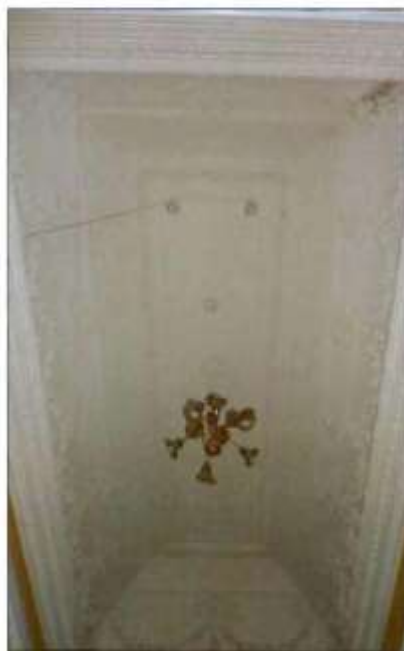
23. Оформление потолка (помещение 2-Н).
