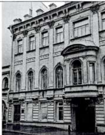
Фрагмент дворового фасада
