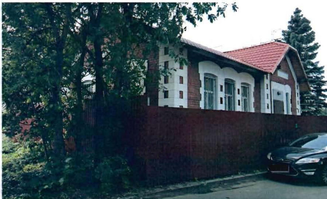
Фото 1. Северо-западный фасад и часть северо-восточного фасада.
