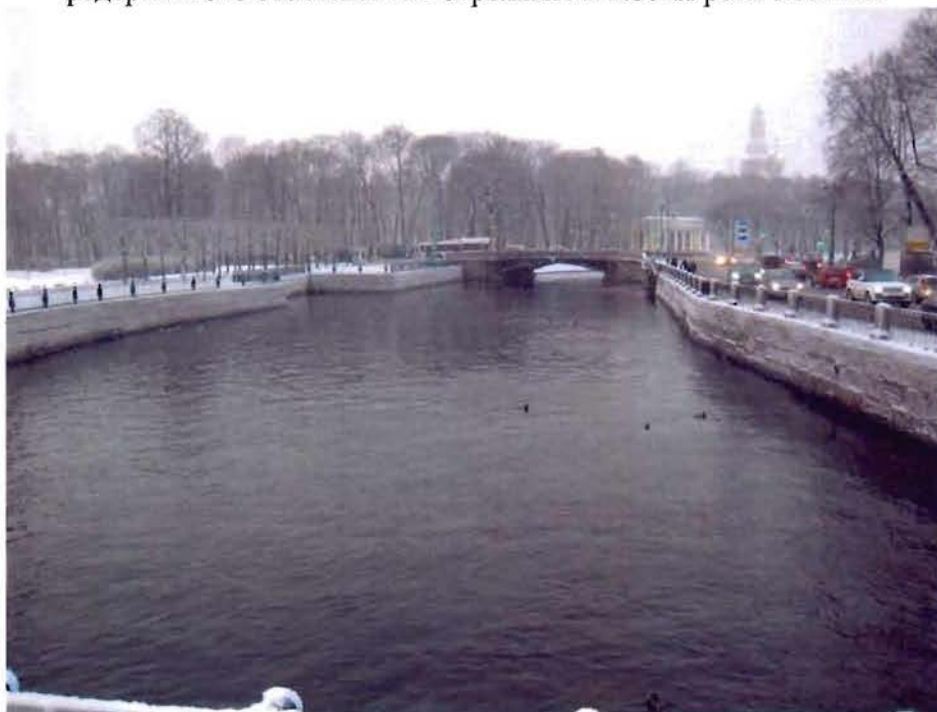
1. Набережные. Вид со стороны Инженерного Первого моста
