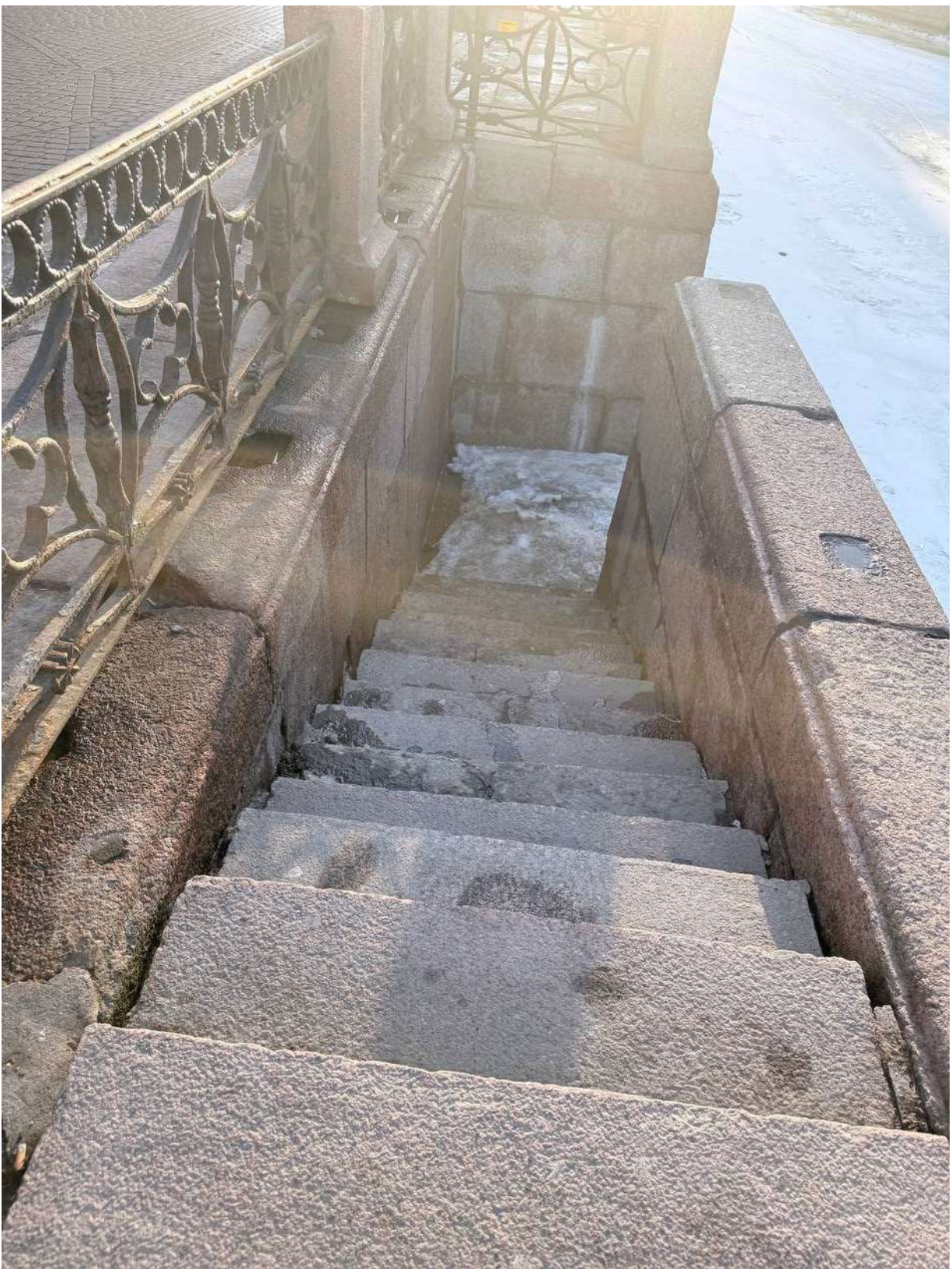
Фото 5. Общий вид на спуск, на котором проектируется устройство настила.
