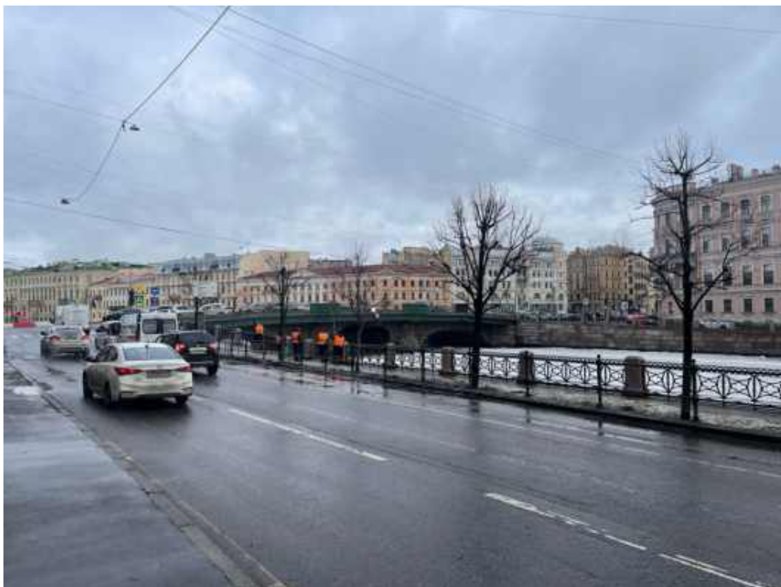
1. Вид на объект культурного наследия федерального значения «Набережные со спусками», 1780–1789 гг. и объект культурного наследия регионального значения «Мост Белинского», 1782–1784 гг., 1858–1859 гг.
