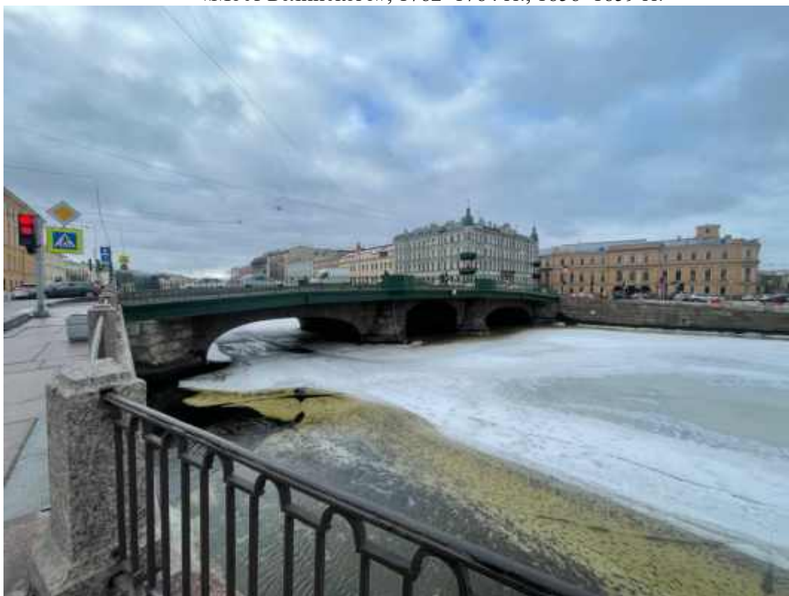
4. Вид на объект культурного наследия федерального значения «Набережные со спусками», 1780–1789 гг. и объект культурного наследия регионального значения «Мост Белинского», 1782–1784 гг., 1858–1859 гг.
