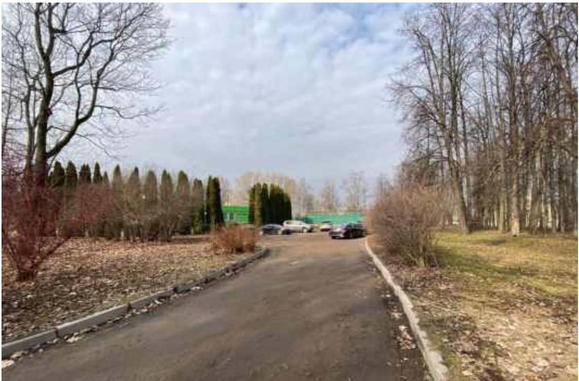
Фото 4. Территория объекта культурного наследия регионального значения «Парк "Тихий отдых"». Вид на реконструируемые объекты с восточной стороны. Съемка 06.04.2026 г. Полетайкин В.В.
