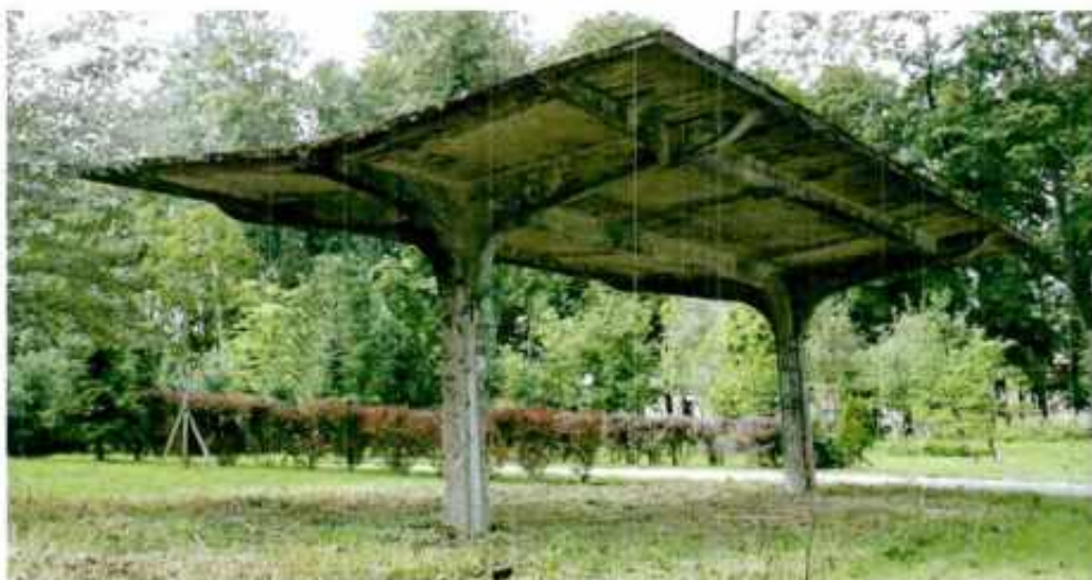
Фото №1. «Железобетонный навес товарищества "Железо-бетон"».
