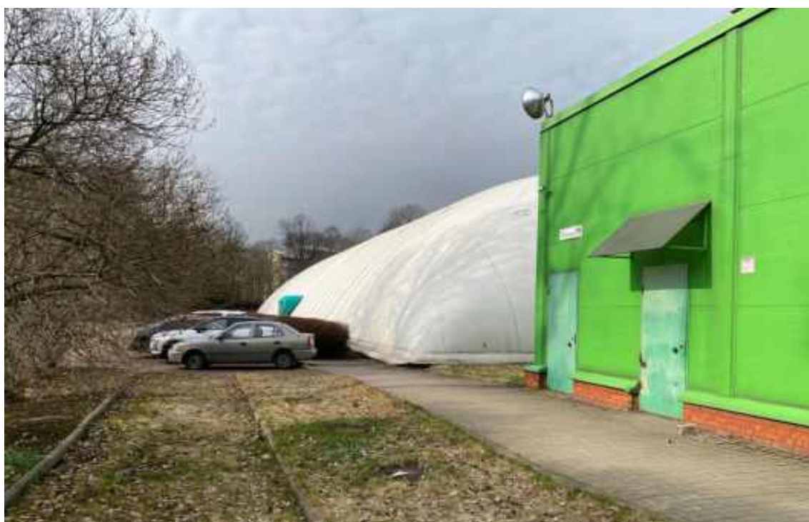
Фото 2. Вид на реконструируемые объекты с восточной стороны. Съемка 06.04.2026 г. Полетайкин В.В.
