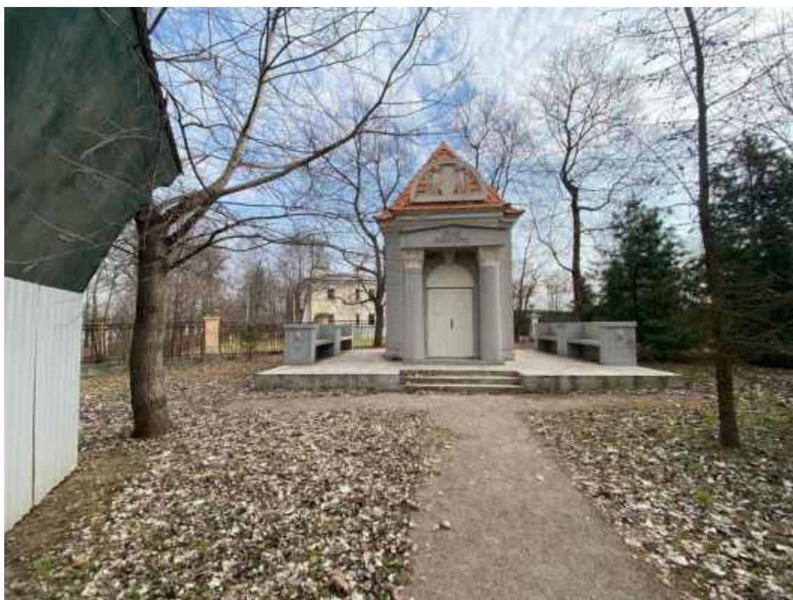
Фото 8. Объект культурного наследия регионального значения «Железобетонная беседка». Вид с западной стороны. Съемка 06.04.2026 г. Полетайкин В.В.
