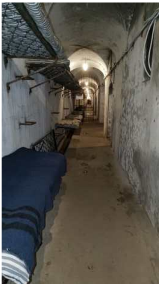
Фото 161. Галереи опытных построек и правого фланга. Общий вид. Дата фотофиксации: 06.10.24
