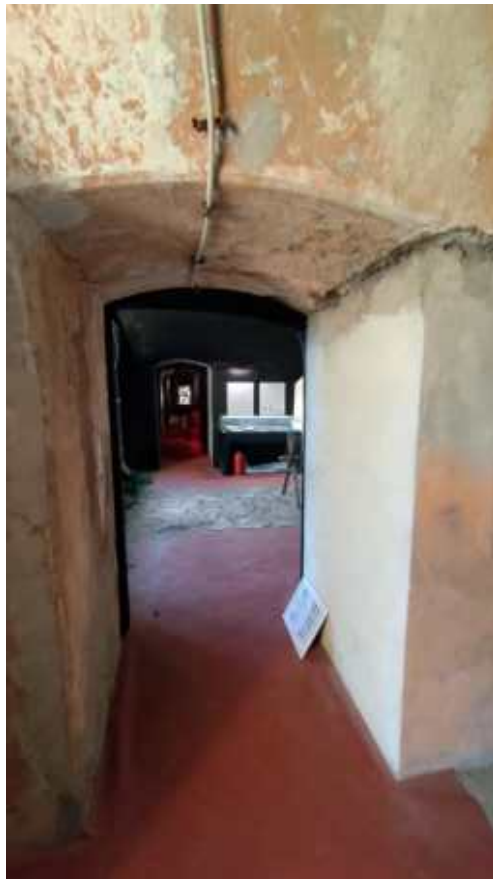
Фото 93. Портал между помещениями 9 и 10, 6-Н. Общий вид. Дата фотофиксации: 06.10.24
