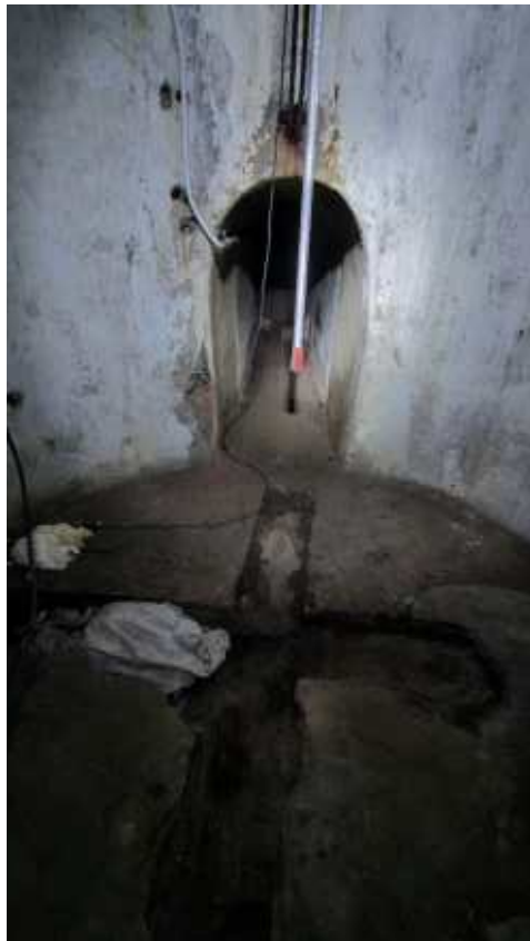
Фото 298. Овальный проём галереи-потерны. Общий вид. Дата фотофиксации: 10.10.24
