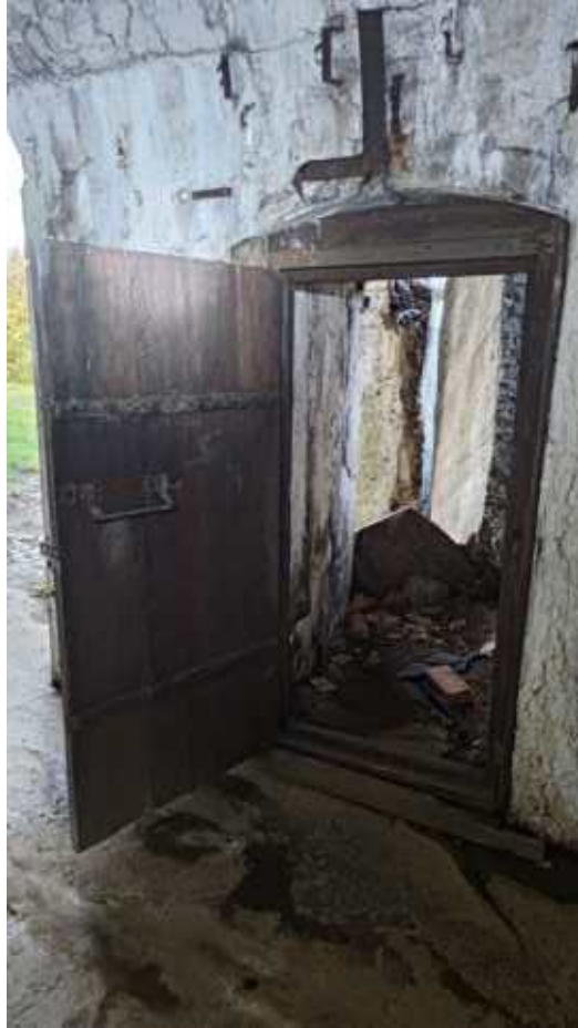
Фото 259. Металлическая прямоугольная одностворчатая дверь во входной галерее Левого фланга. Общий вид. Дата фотофиксации: 06.10.24
