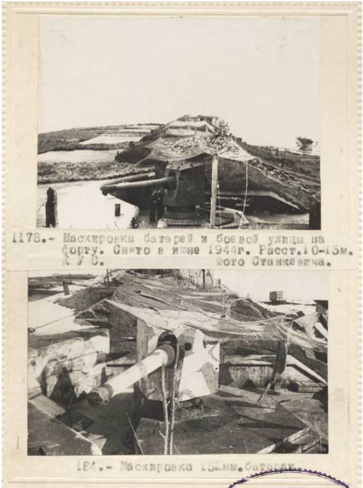
Илл. 109. 6-дм. орудия Канэ на батарее № 131 (правый фланг форта). Фото июня 1944 г. (ЦВМА. Ф. р-92. Оп. 08. Д. 19.) В правых частях обоих снимков видны возведенные в 1930-е гг. бетонные платформы для зарядания орудий, охватывающие штатные тумбы орудийных установок сзади и с боков.
