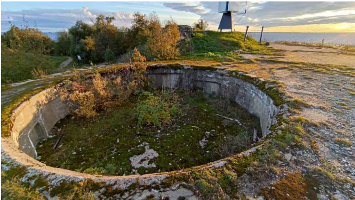
Фото 281. Позиция открытой батареи Правого фланга. Общий вид. Дата фотофиксации: 06.10.24
