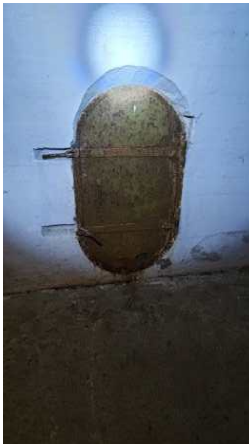
Фото 172. Металлическое овальное в плане дверное заполнение овальных проёмов галерей-потерн на нижнем уровне опытных позиций. Общий вид. Дата фотофиксации: 06.10.24
