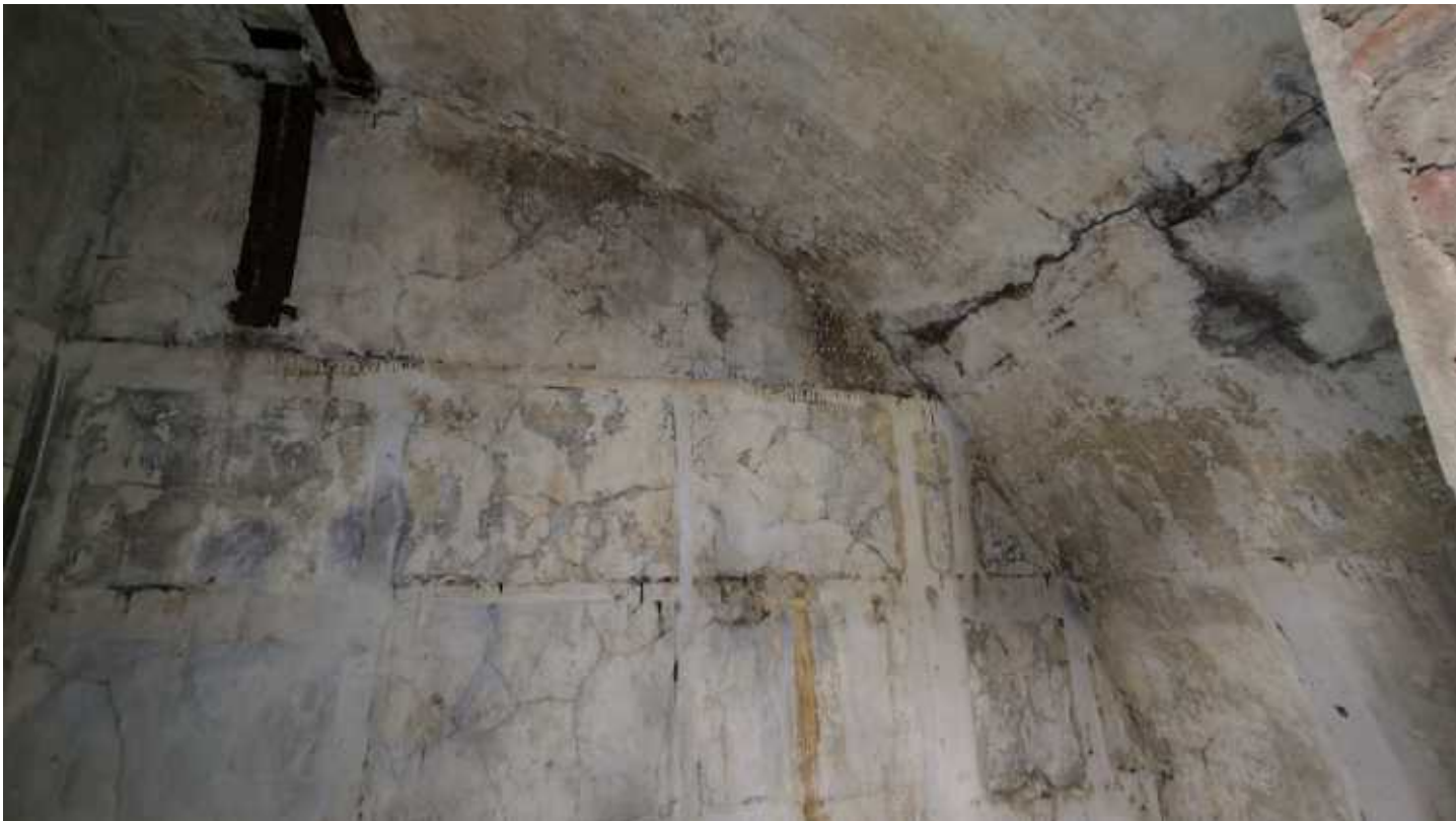
Фото 180. Коробовый свод. Фрагмент. Дата фотофиксации: 06.10.24
