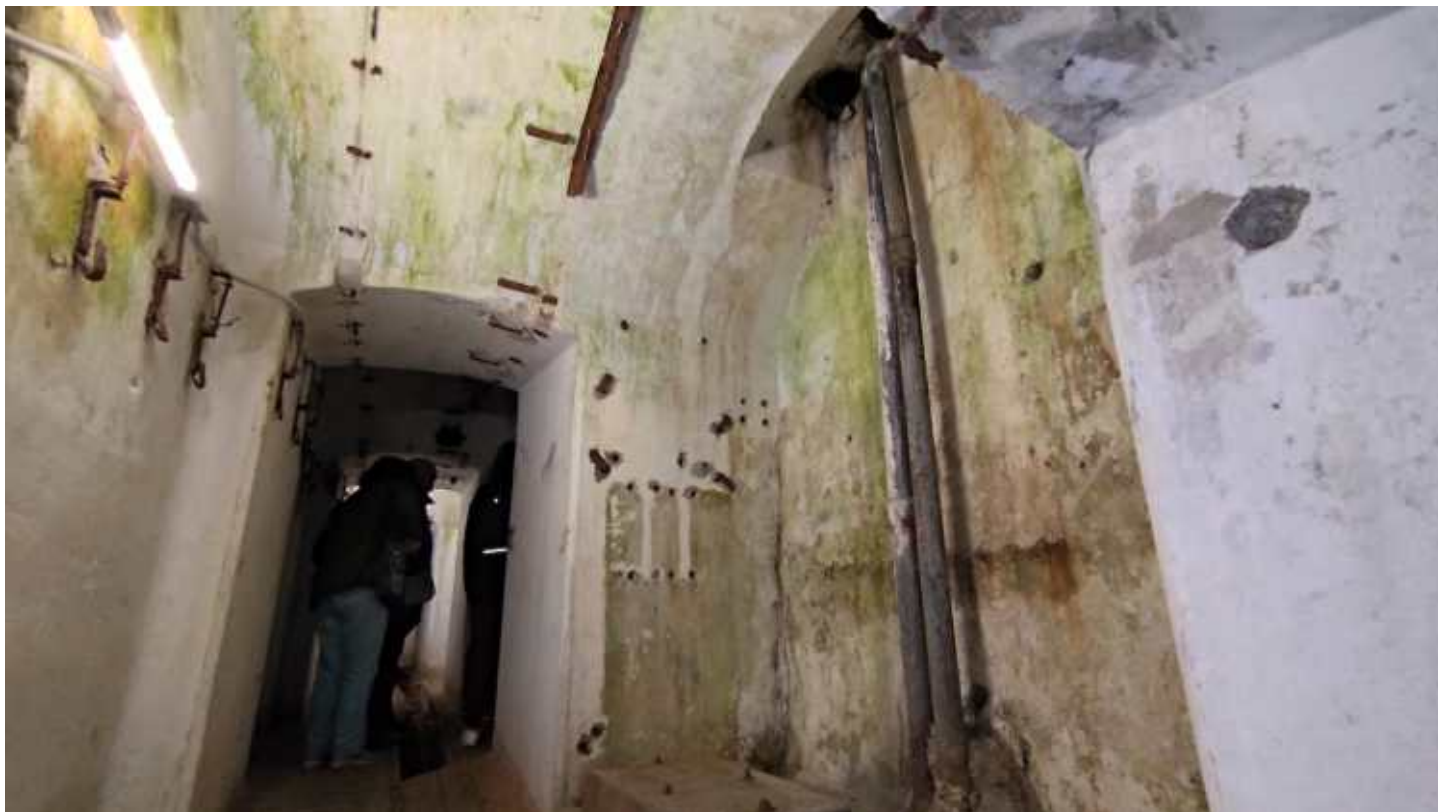
Фото 194. Помещение нижнего уровня опытных построек. Фрагмент. Дата фотофиксации: 06.10.24
