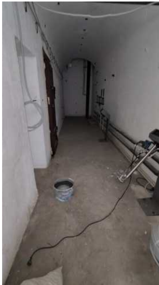
Фото 47. Пространство помещений 2 и 5, 5-Н. Общий вид. Дата фотофиксации: 10.10.24
