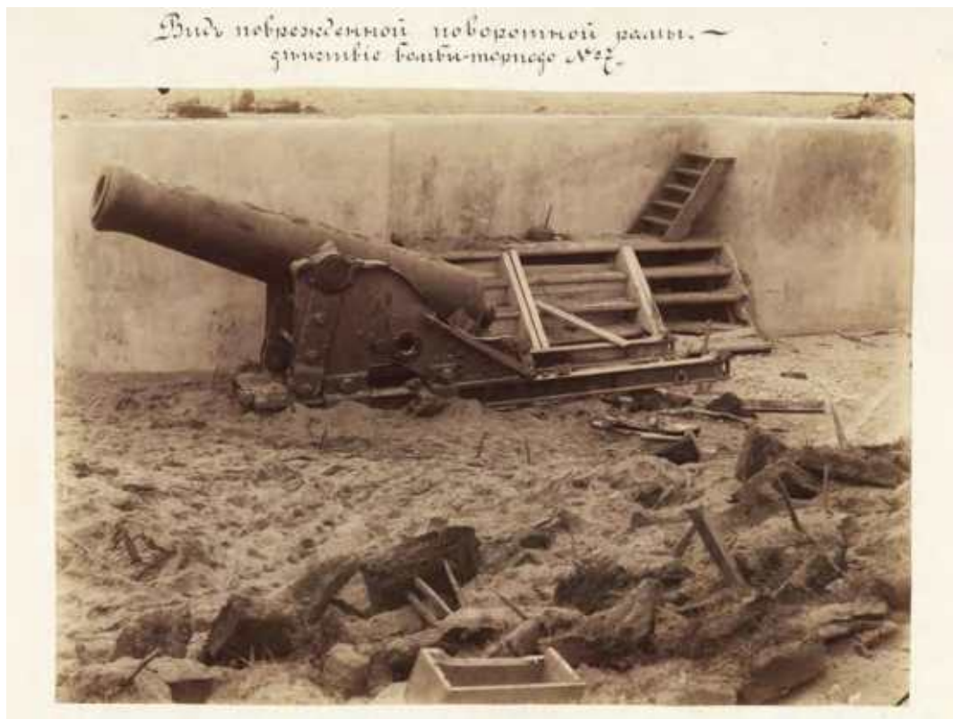
Илл. 14. Вид поврежденной поворотной рамы, — действие бомбы-торпеды № 7. (РГАВМФ. Ф. 1341. Оп. 3. Д. 588).
