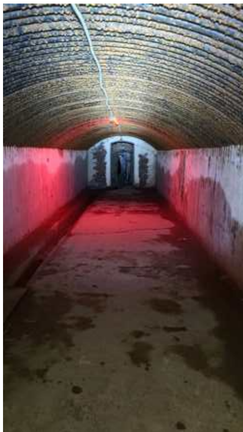
Фото 204. Коробовый свод с металлической подшивкой. Фрагмент. Дата фотофиксации: 06.10.24
