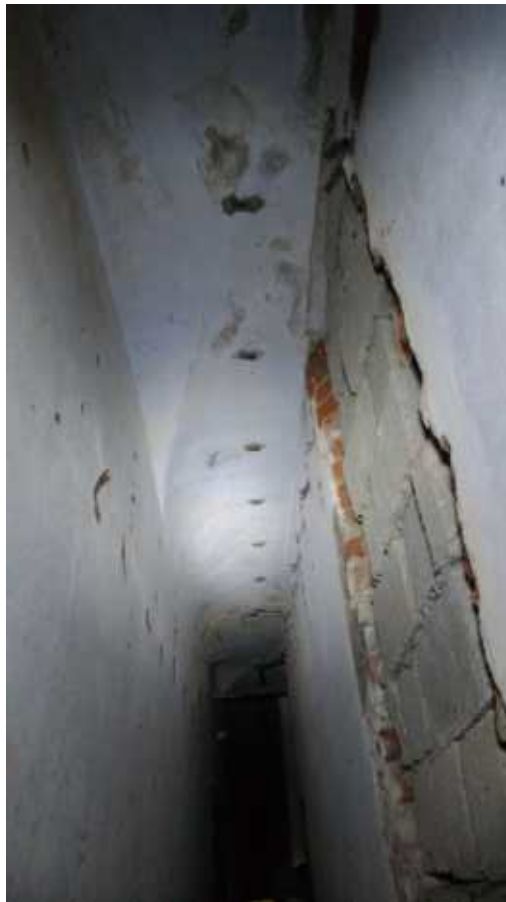
Фото 87. Вентиляционное отверстие. Офицерские казармы. Фрагмент. Дата фотофиксации: 06.10.24
