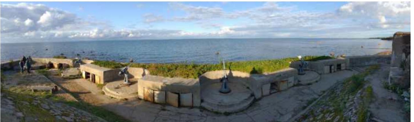
Фото 120. Зенитные противодесантные позиции орудийных батарей. Панорамная съёмка. Общий вид. Дата фотофиксации: 06.10.24
