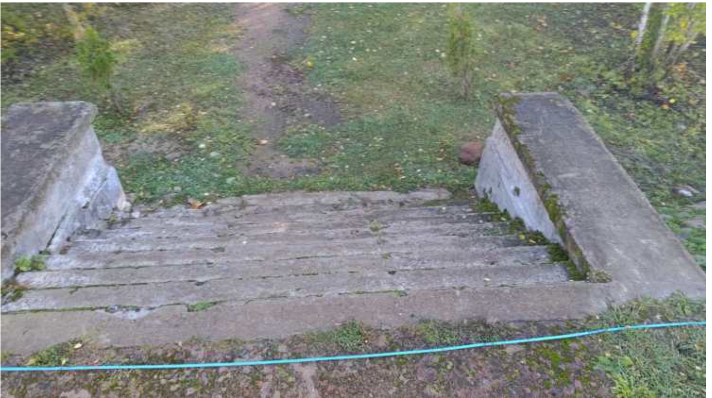
Фото 18. Историческая бетонная лестница. Общий вид. Дата фотофиксации: 10.10.24
