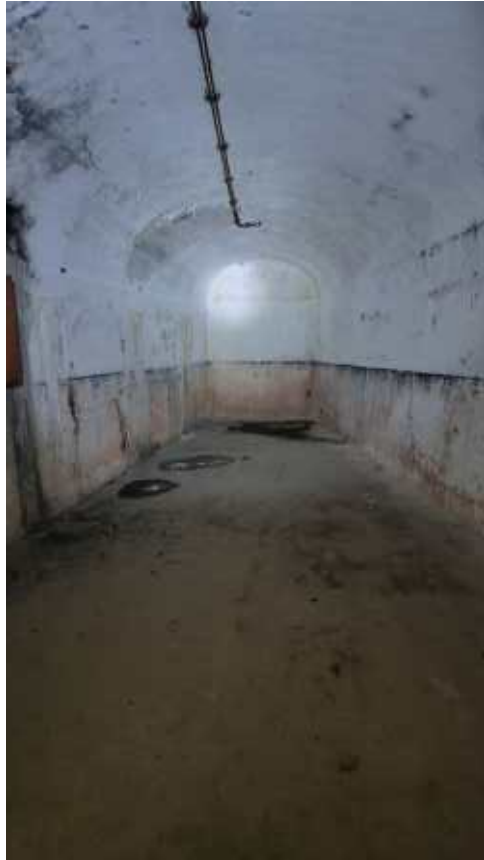
Фото 237. Помещение Главного калибра. Общий вид. Дата фотофиксации: 06.10.24
