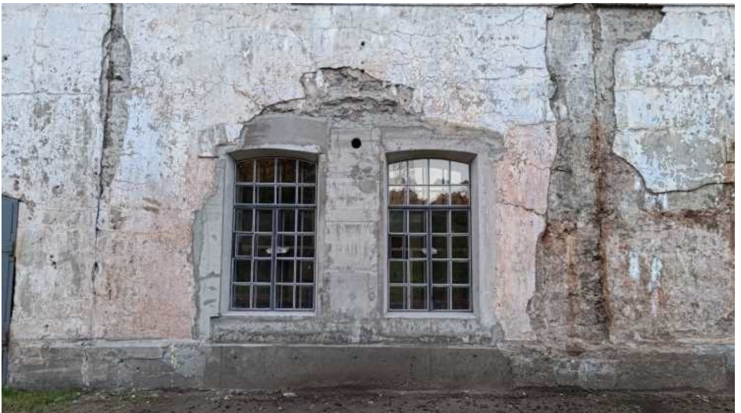
Фото 72. Оконные проёмы с нижними откосами и лучковым завершением. Офицерские казармы. Общий вид. Дата фотофиксации: 10.10.24
