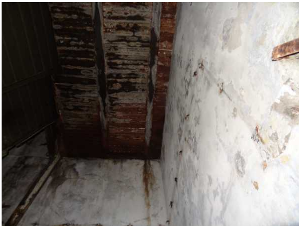
Фото 312. Металлические конструкции помещения 26 правого фланга. Фрагмент. Дата фотофиксации: 10.10.24
