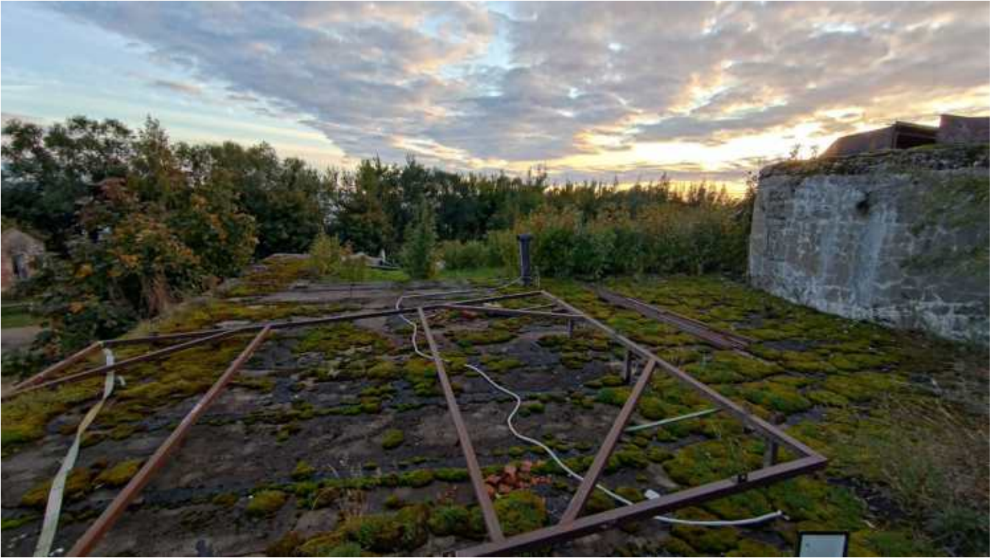
Фото 73. Крыша Офицерских казарм. Фрагмент. Дата фотофиксации: 06.10.24
