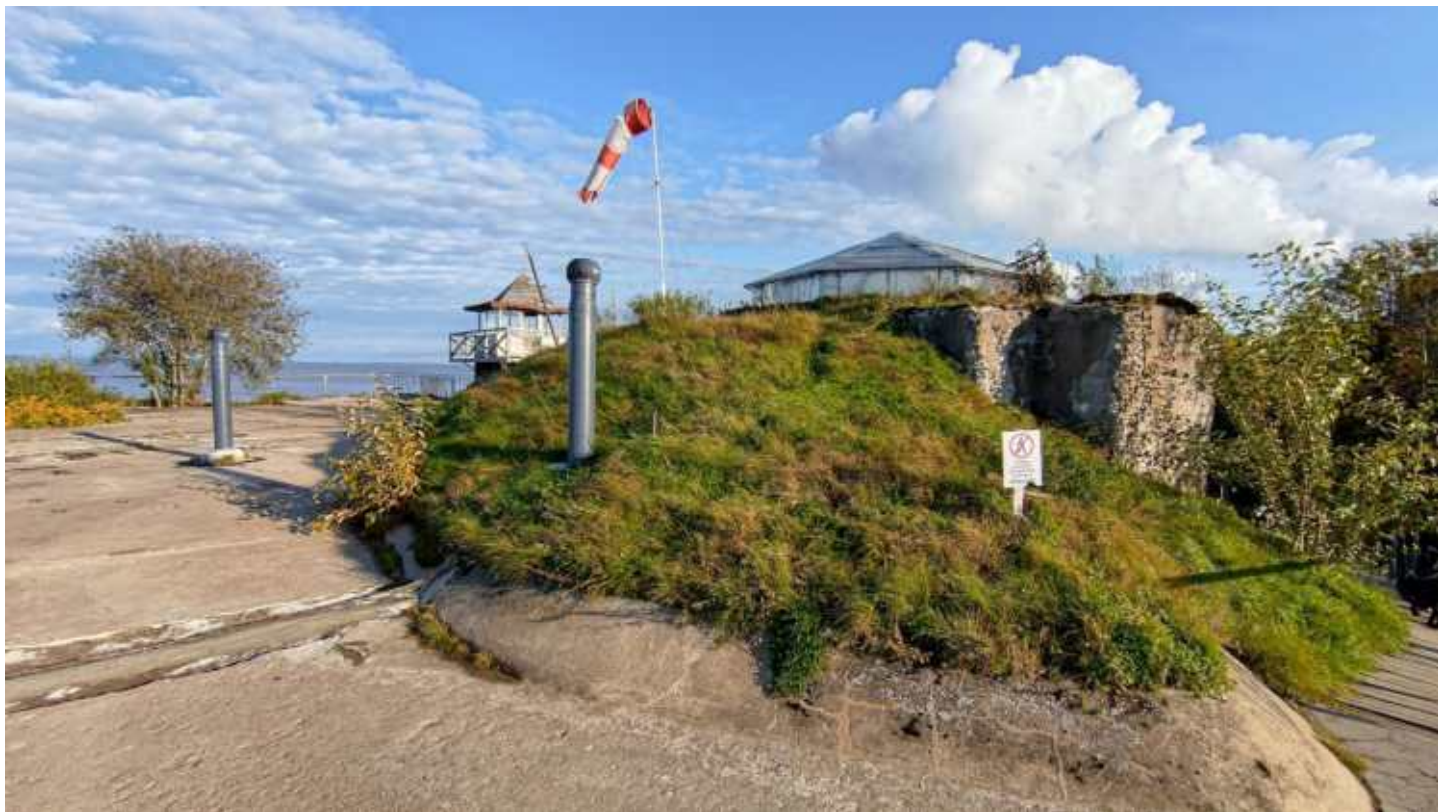
Фото 111. Правый фланг. Фрагмент. Дата фотофиксации: 06.10.24
