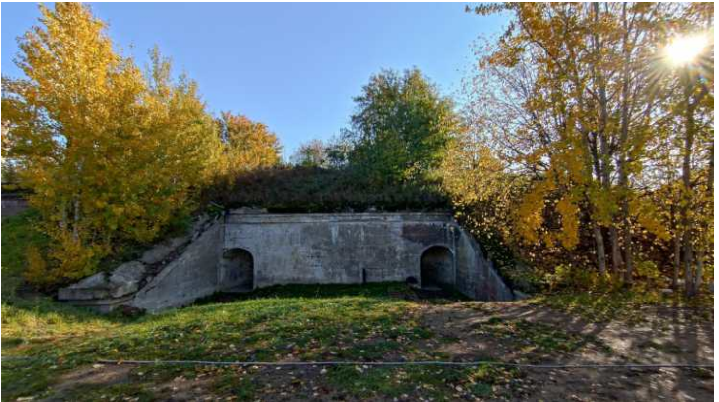
Фото 13. Порталы подземного уровня солдатских казарм. Общий вид. Дата фотофиксации: 10.10.24
