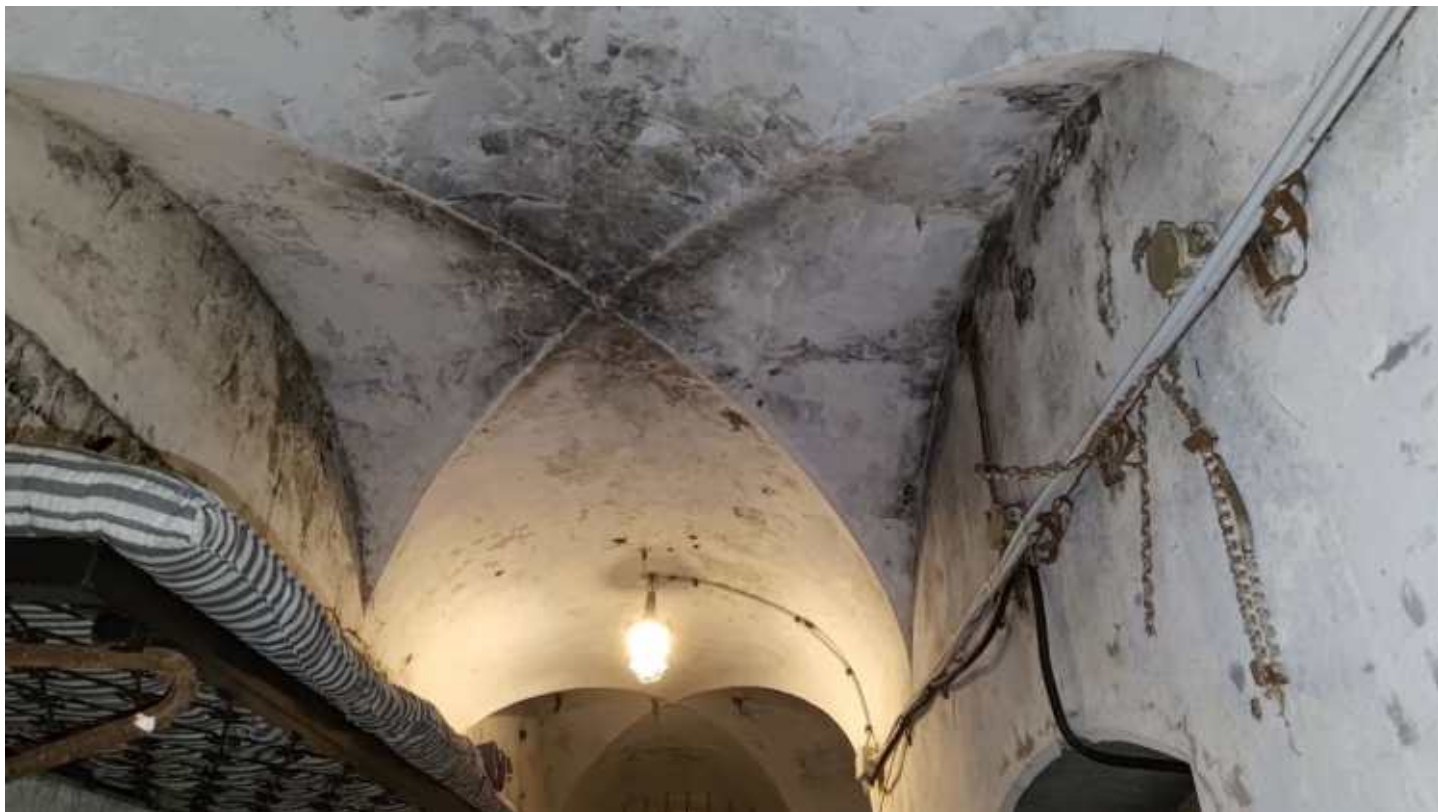
Фото 162. Коробовые своды с распалубками. Фрагмент. Дата фотофиксации: 06.10.24
