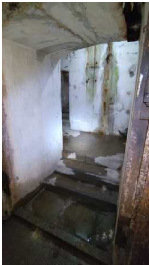
Фото 219. Портал между вспомогательным помещением и коридором. Общий вид. Дата фотофиксации: 06.10.24
