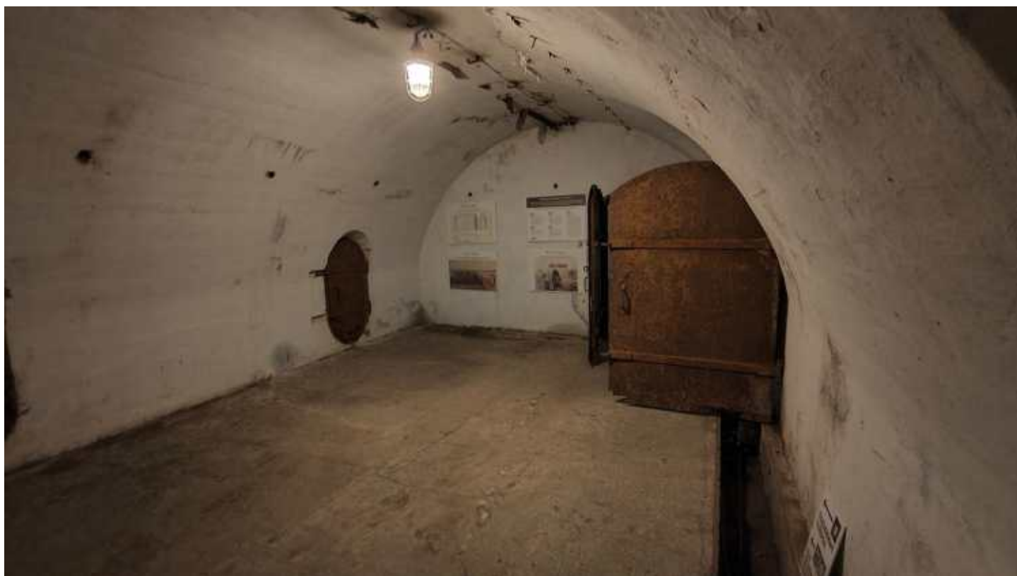
Фото 173. Металлические дверные заполнения одностворчатые с лучковым завершением в проёмах, соединяющих опытные позиции и вспомогательные помещения (казематные помещения). Общий вид. Дата фотофиксации: 06.10.24
