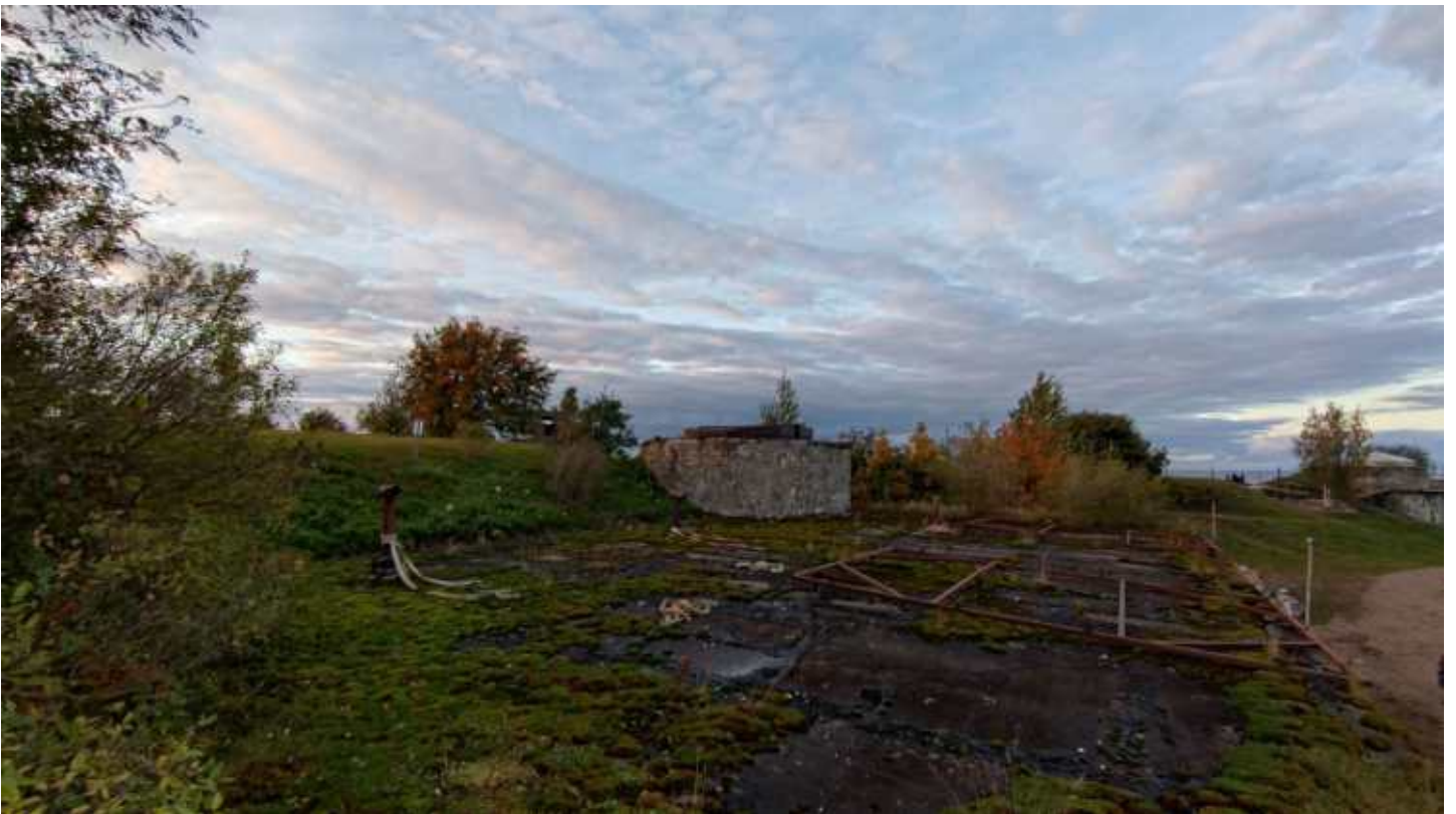
Фото 80. Крыша Офицерских казарм. Фрагмент. Дата фотофиксации: 06.10.24
