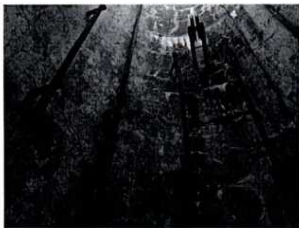
23. Прожекторная шахта. Наблюдаются разрушения отделочных слоев.
