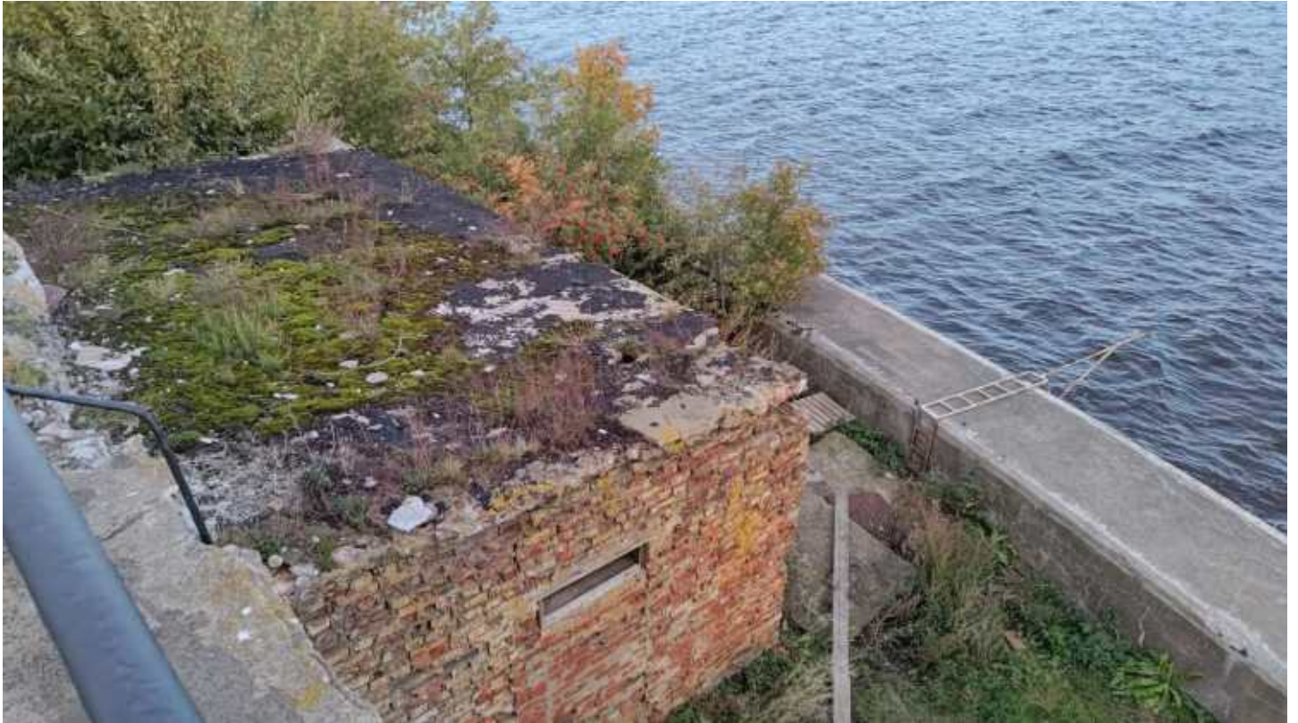
Фото 273. Пристройка Левого фланга. Общий вид. Дата фотофиксации: 10.10.24
