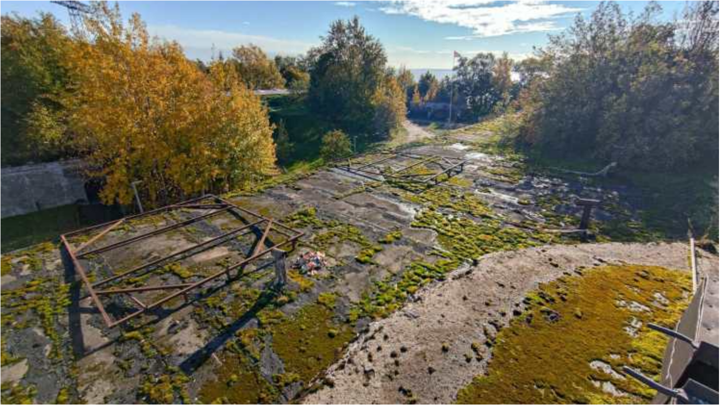
Фото 79. Крыша Офицерских казарм. Фрагмент. Дата фотофиксации: 10.10.24
