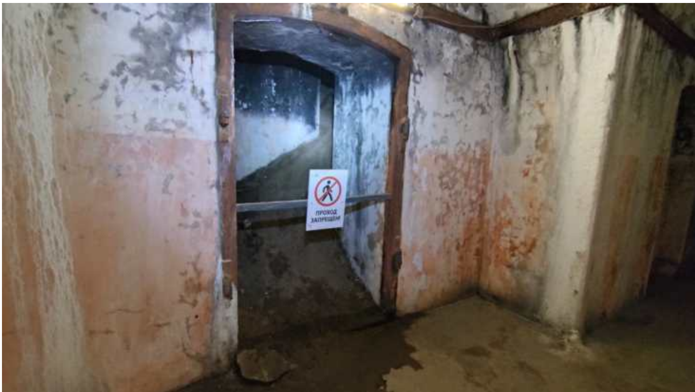
Фото 245. Помещение Главного калибра с обвалкой. Общий вид. Дата фотофиксации: 06.10.24
