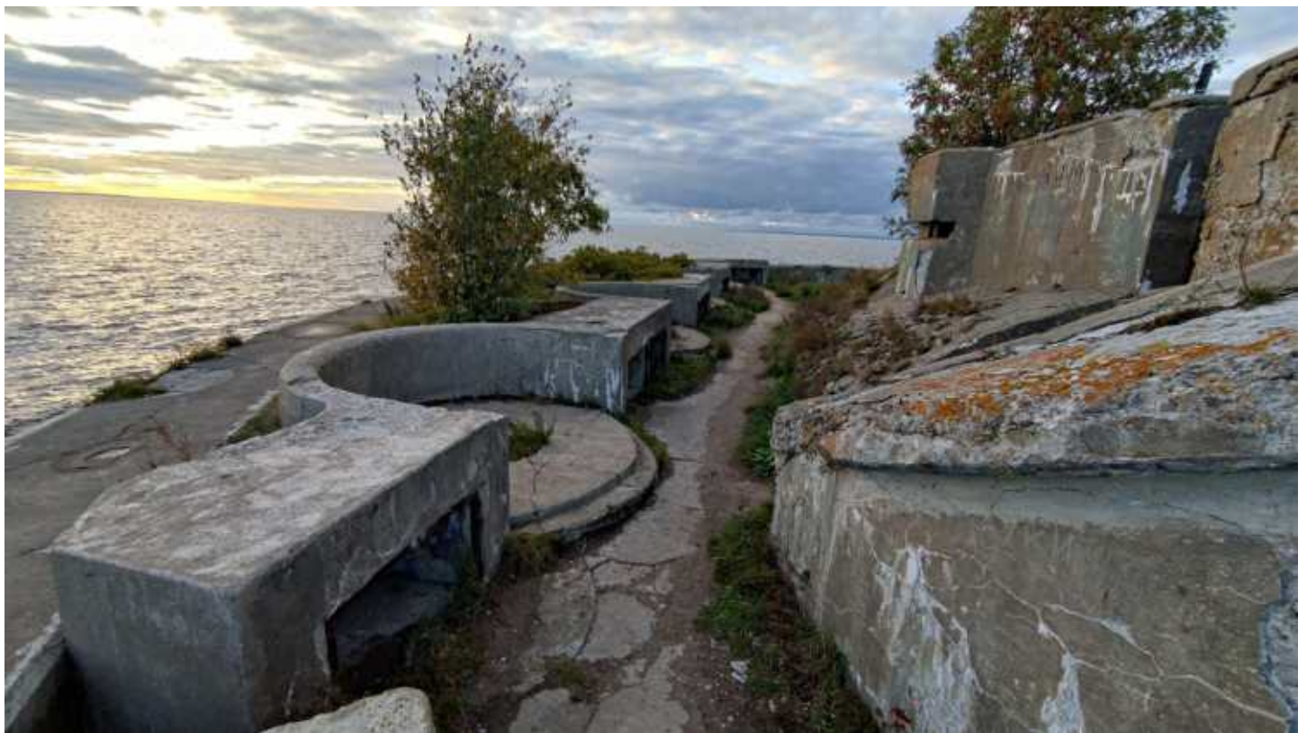
Фото 262. Позиции открытых противодесантных батарей Левого фланга. Общий вид. Дата фотофиксации: 06.10.24
