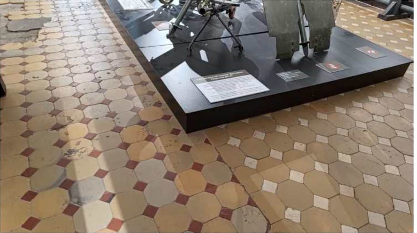
Фото 36. Помещение 8. Оформление пола – метлахская плитка. Фрагмент. Дата фотофиксации: 10.10.24
