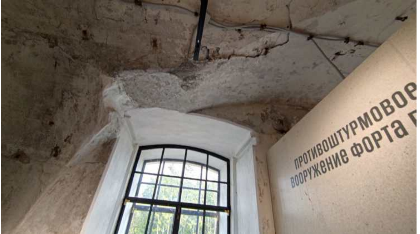
Фото 32. Коробовый свод в помещении 7. Фрагмент. Дата фотофиксации: 10.10.24
