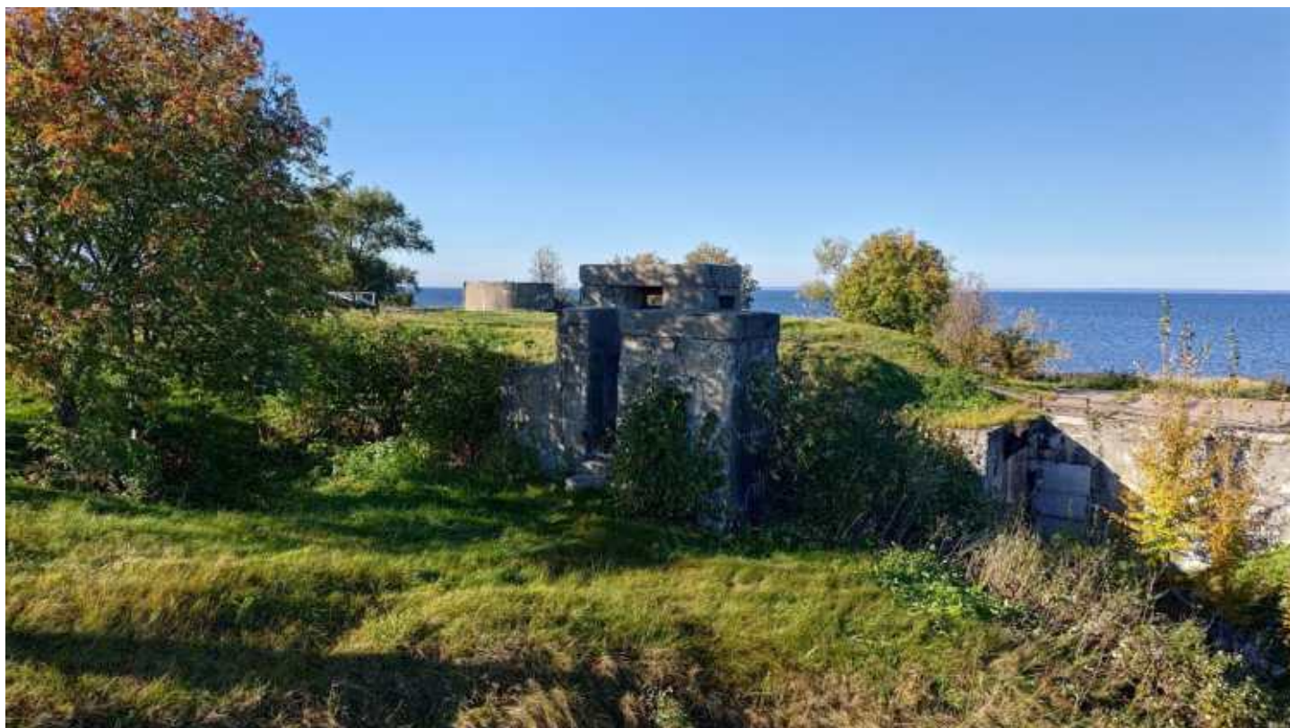
Фото 149. Наблюдательный пункт. Опытные постройки. Общий вид. Дата фотофиксации: 10.10.24
