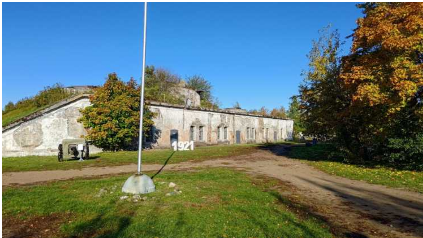
Фото 65. Офицерская казарма. Общий вид. Дата фотофиксации: 10.10.24
