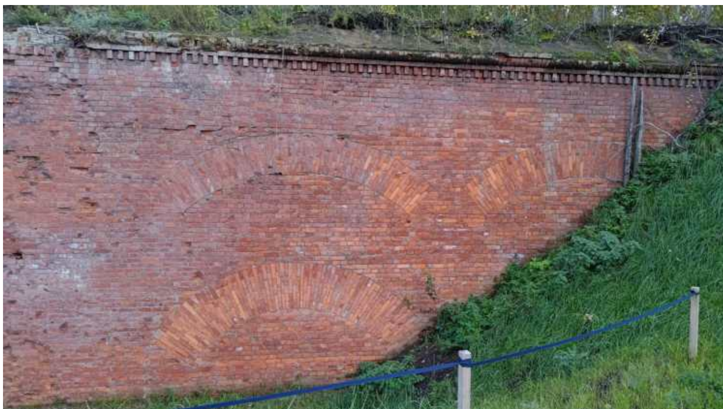
Фото 138. Кирпичная кладка с разгрузочными кирпичными арками. Фрагмент. Дата фотофиксации: 06.10.24
