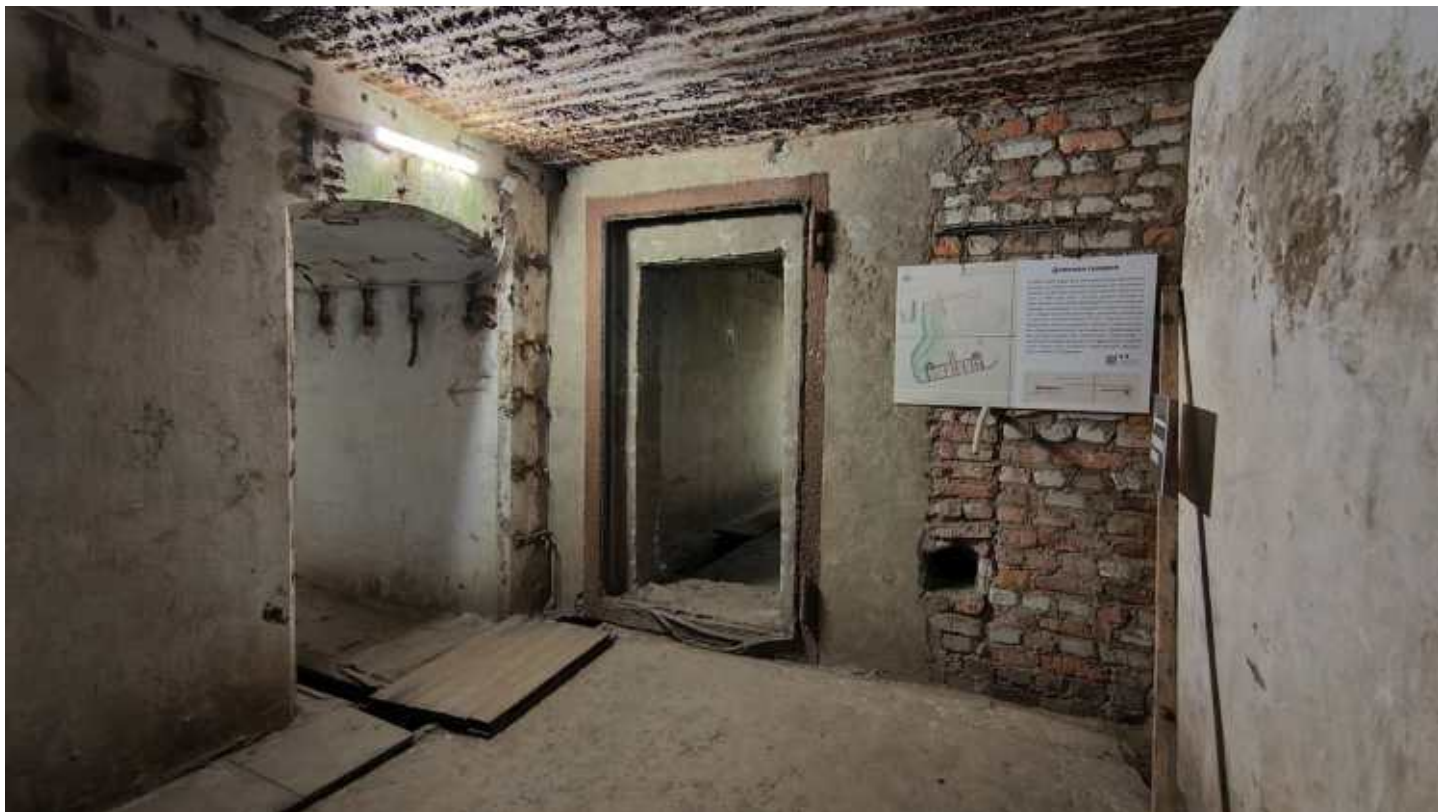
Фото 200. Помещение нижнего уровня опытных сооружений. Общий вид. Дата фотофиксации: 06.10.24
