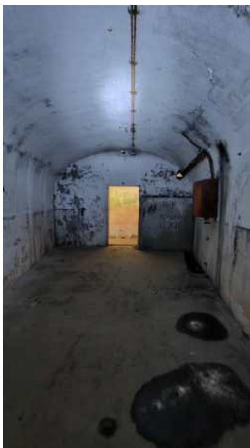
Фото 240. Помещение Главного калибра. Общий вид. Дата фотофиксации: 06.10.24
