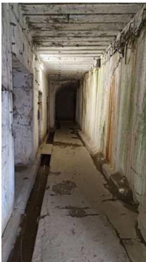
Фото 211. Коридор, соединяющий Главный калибр и опытные сооружения. Фрагмент. Дата фотофиксации: 06.10.24
