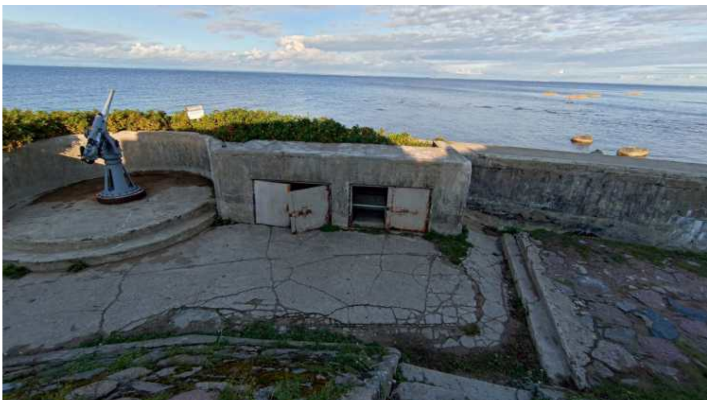
Фото 118. Зенитные противодесантные позиции оружейных батарей. Фрагмент. Дата фотофиксации: 06.10.24
