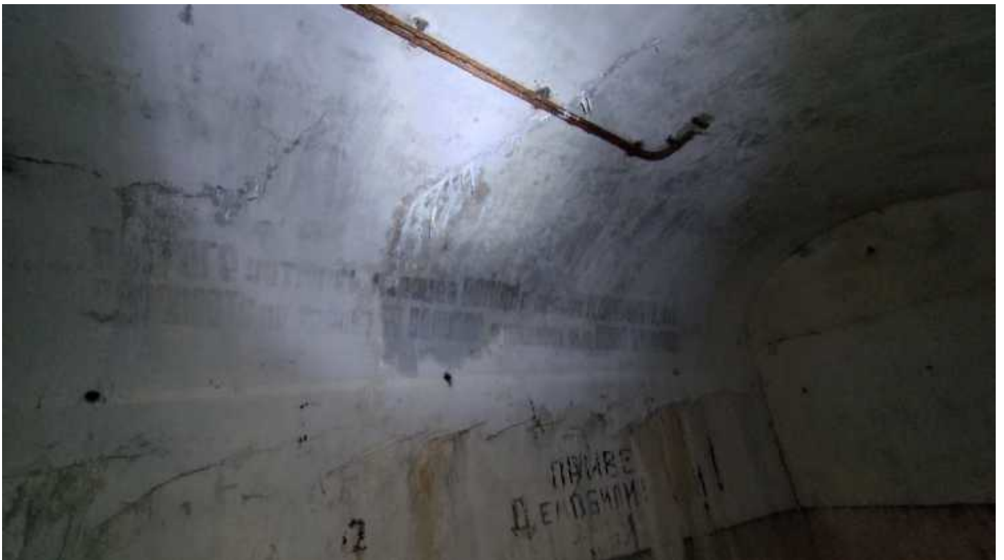
Фото 238. Помещение Главного калибра. Фрагмент. Дата фотофиксации: 06.10.24
