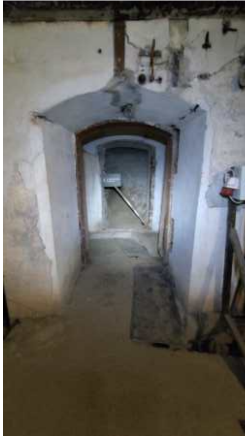
Фото 198. Портал между вспомогательными помещениями опытных построек. Общий вид. Дата фотофиксации: 06.10.24
