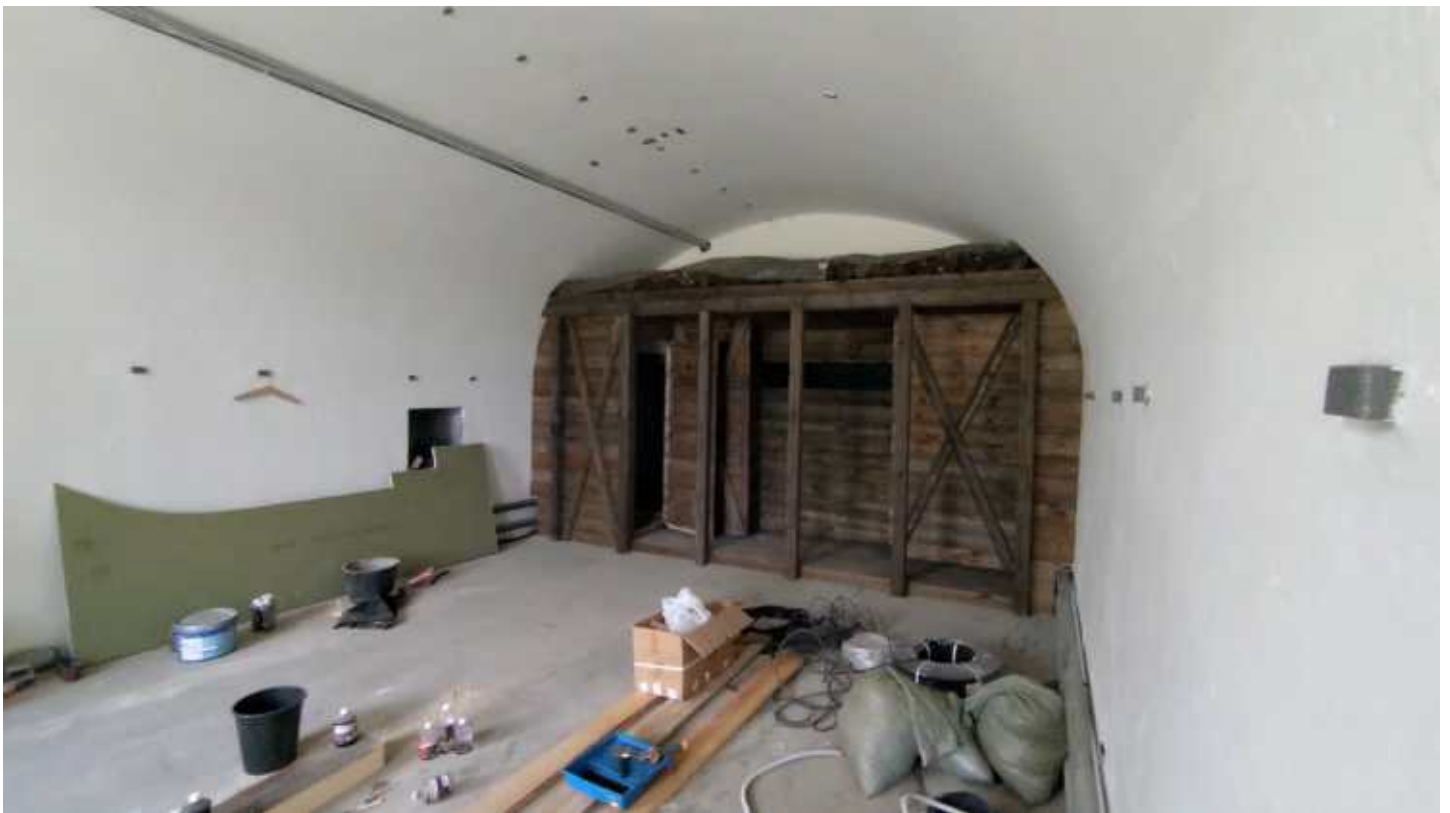
Фото 55. Помещение 2, 4-Н. Общий вид. Дата фотофиксации: 10.10.24
