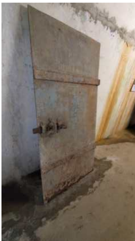
Фото 213. Прямоугольна металлическая дверь – историческая дверь патронных погребов. Местоположение – коридор, соединяющий Главный калибр и опытные сооружения. Общий вид. Дата фотофиксации: 06.10.24
