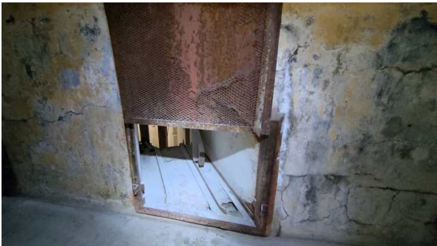
Фото 223. Металлическая заглушка элеватора подачи боеприпасов. Общий вид. Дата фотофиксации: 06.10.24
