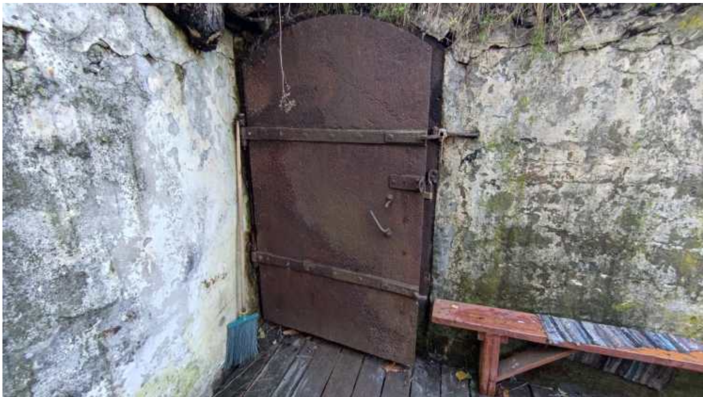
Фото 290. Металлическая одностворчатая прямоугольная дверь с лучковым завершением. Общий вид. Дата фотофиксации: 10.10.24
