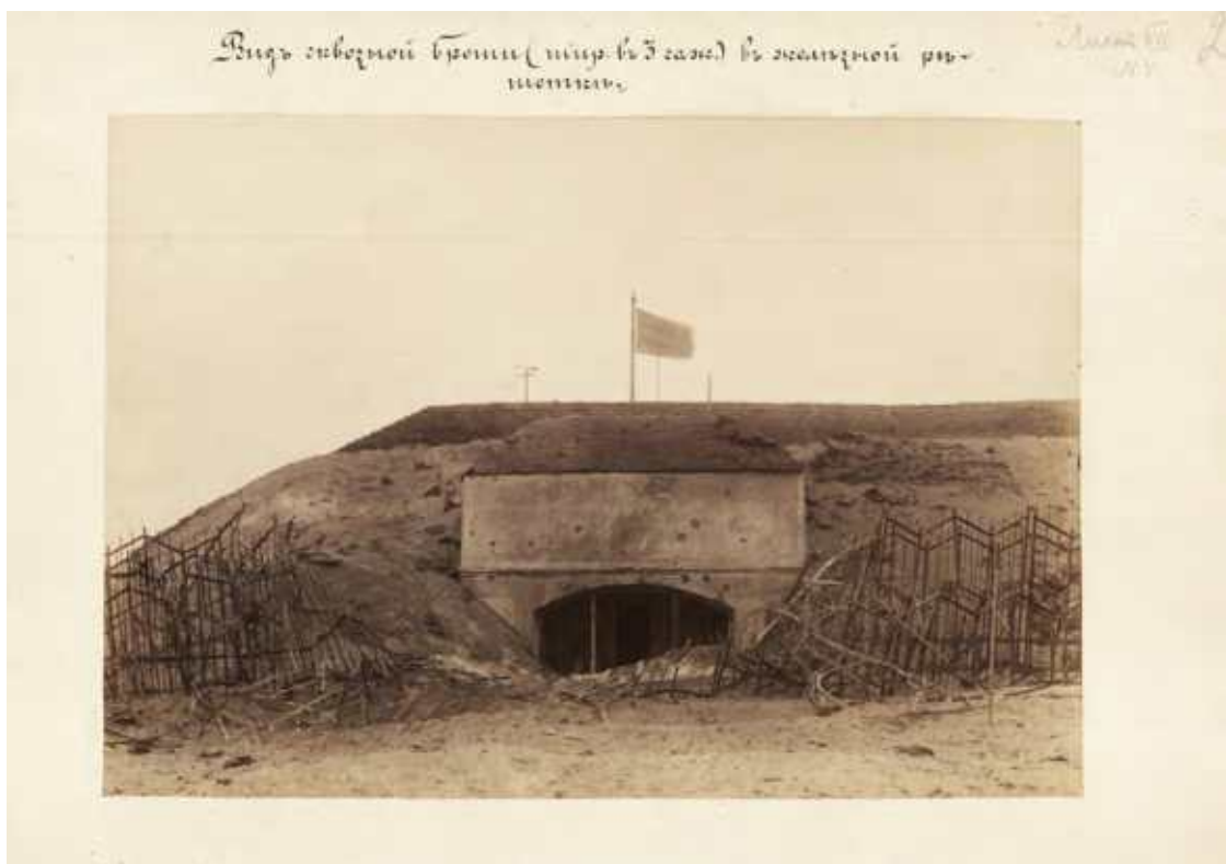
Илл. 11. Вид сквозной брешы (шир. в 3 саж.) в железной решетке. (РГАВМФ. Ф. 1341. Оп. 3. Д. 588). На заднем плане – каземат А, флагшток над ним – обозначение центра координат цели.
