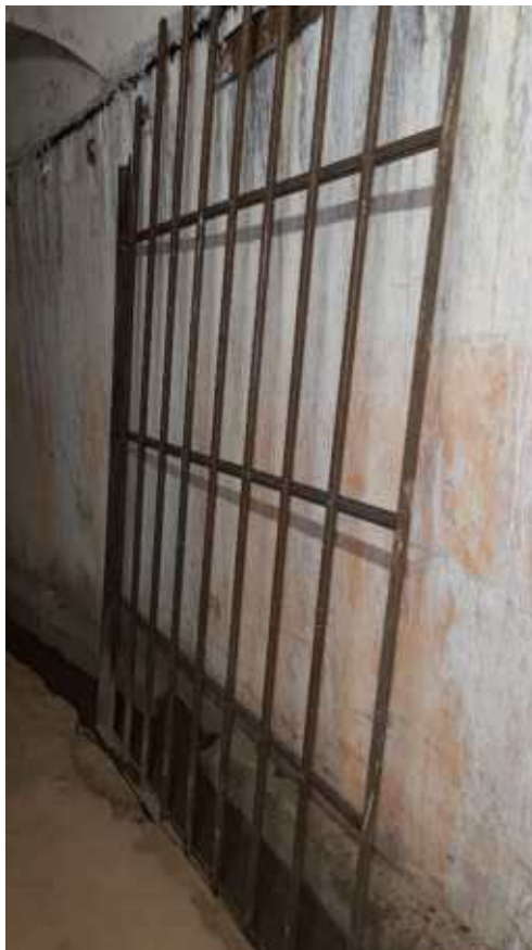
Фото 241. Металлическая решетка, соединяющая коридоры-потерны Главного калибра и Левого фланга. Общий вид. Дата фотофиксации: 06.10.24
