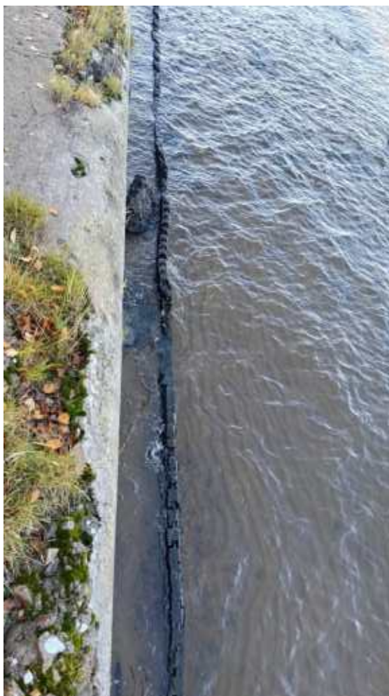
Фото 124. Бетонные конструкции форта. Правый фланг. Фрагмент. Дата фотофиксации: 10.10.24
