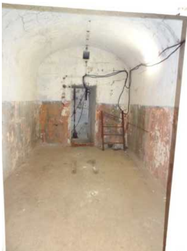
Фото 320. Помещение 18. Общий вид. Дата фотофиксации: 10.10.24
