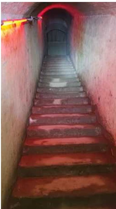
Фото 207. Лестница, соединяющая укрытие и галерею. Общий вид. Дата фотофиксации: 06.10.24
