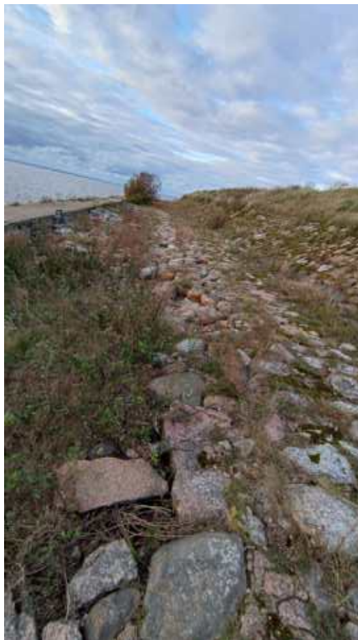
Фото 267. Конструкции основания форта – булыжная засыпка с бетонным ростверком в завершении и свайным основанием под подпорной стенкой. Фрагмент. Дата фотофиксации: 06.10.24
