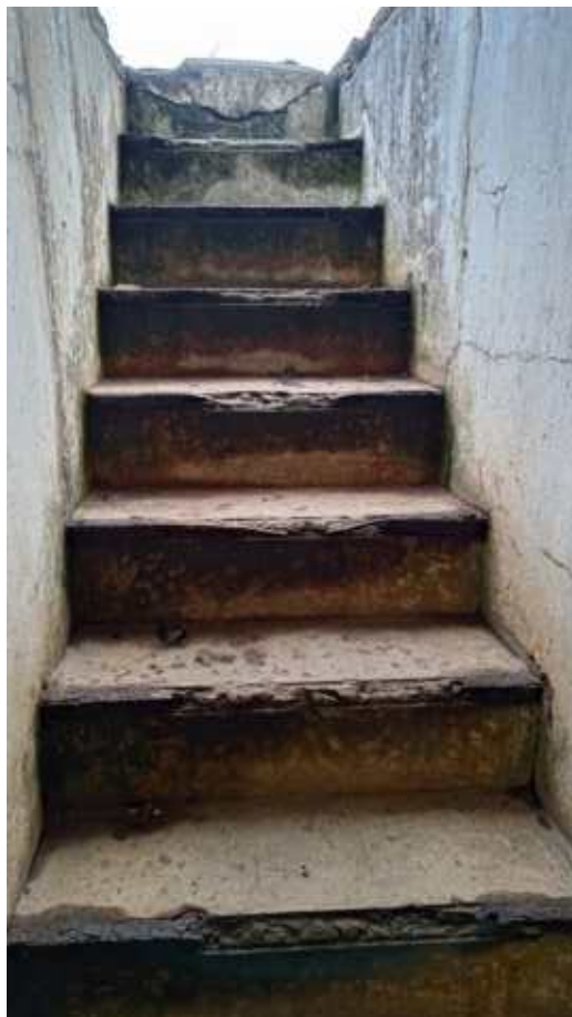
Фото 152. Двойная бетонная лестница опытных построек. Фрагмент. Дата фотофиксации: 06.10.24
