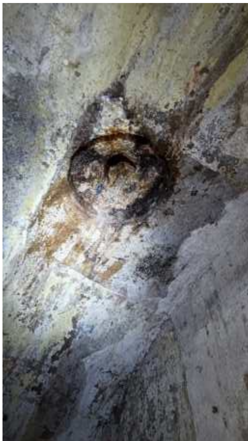
Фото 210. Дымоход котельной опытных сооружений. Общий вид. Дата фотофиксации: 06.10.24
