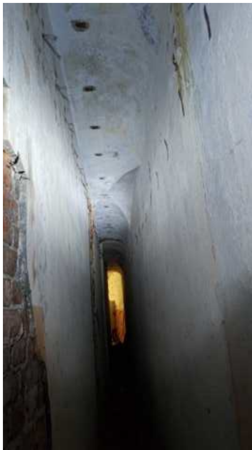
Фото 88. Вентиляционное отверстие. Офицерские казармы. Фрагмент. Дата фотофиксации: 06.10.24
