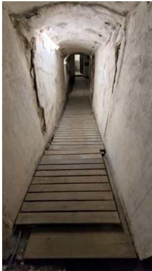
Фото 41. Тоннель в подземную часть солдатских казарм. Общий вид. Дата фотофиксации: 10.10.24
