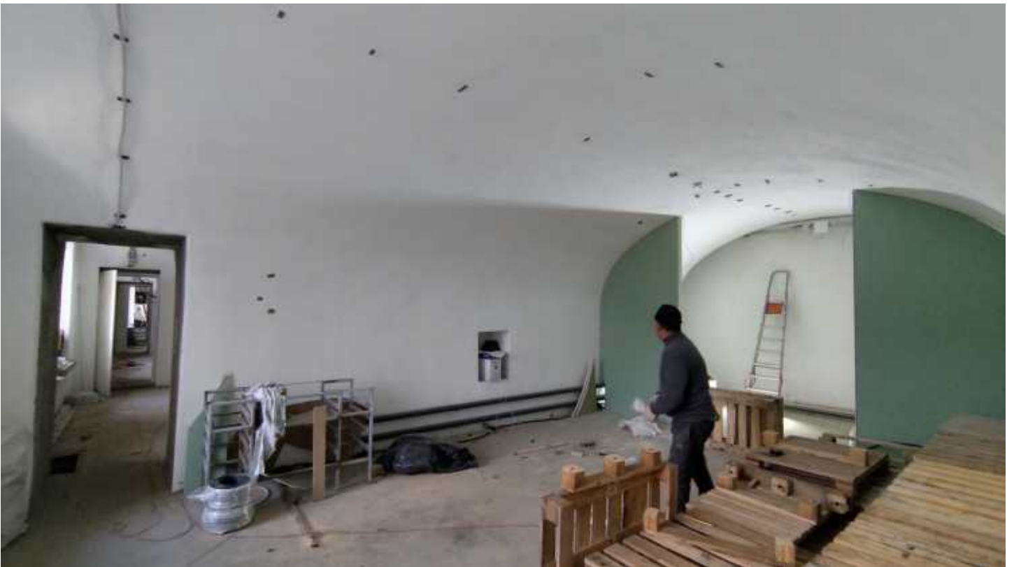
Фото 53. Помещение 4, 5-Н. Общий вид. Дата фотофиксации: 10.10.24
