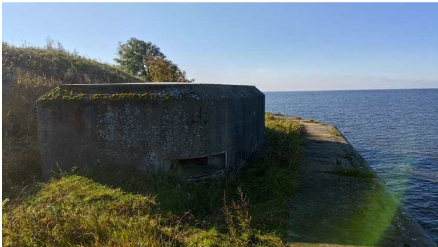
Фото 126. Противодесантный дот. Правый фланг. Общий вид. Дата фотофиксации: 10.10.24
