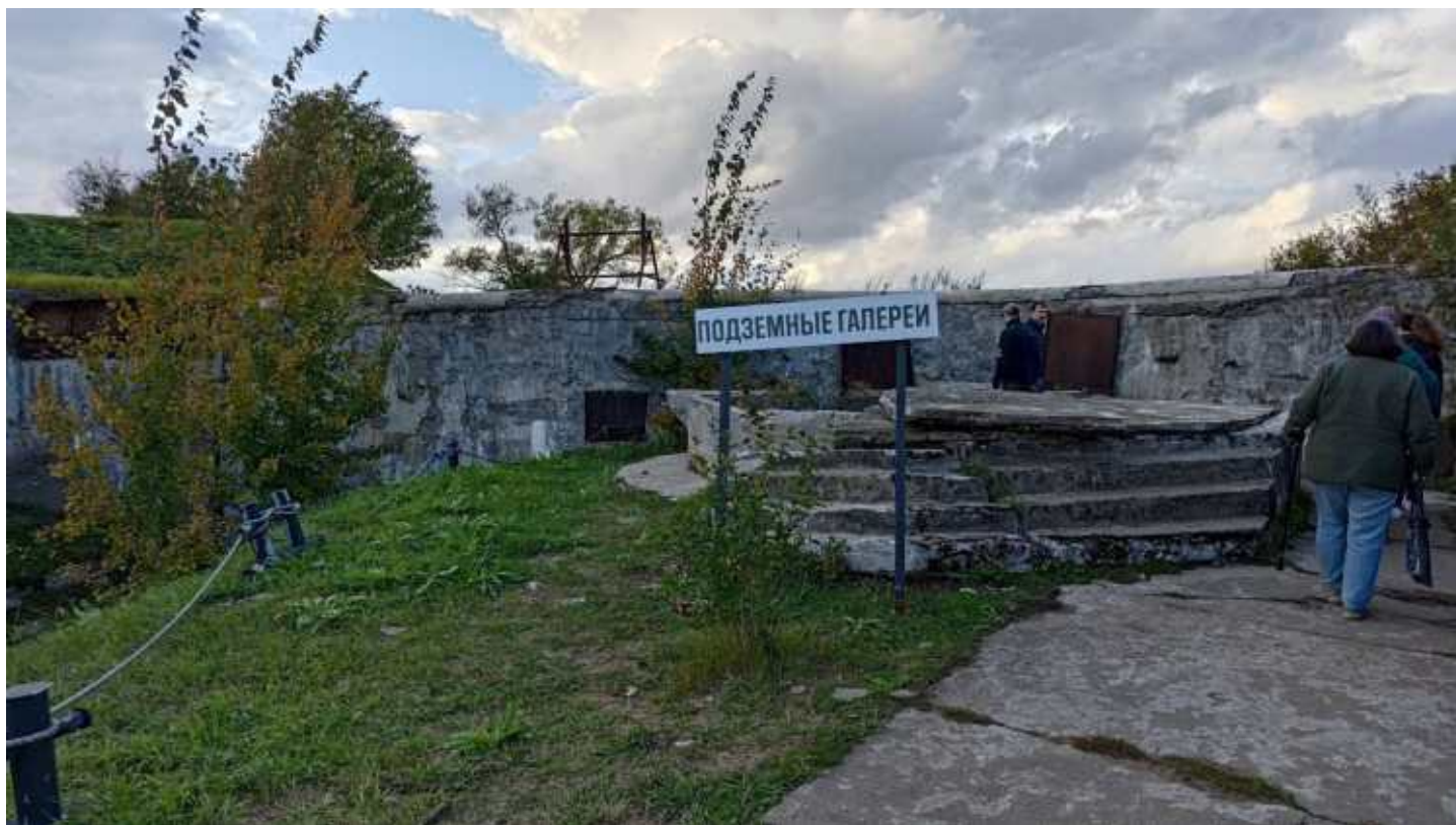
Фото 144. Вход в подземные галереи опытных построек. Орудийная позиция опытных построек. Общий вид. Дата фотофиксации: 06.10.24
