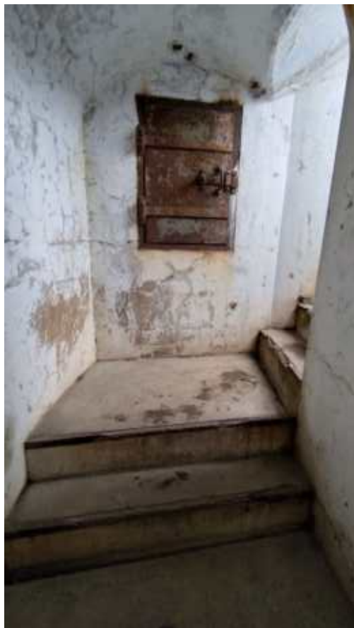
Фото 154. Вентиляционный проём между лестницей и помещением траверсов. Исторические ставни. Общий вид. Дата фотофиксации: 06.10.24
