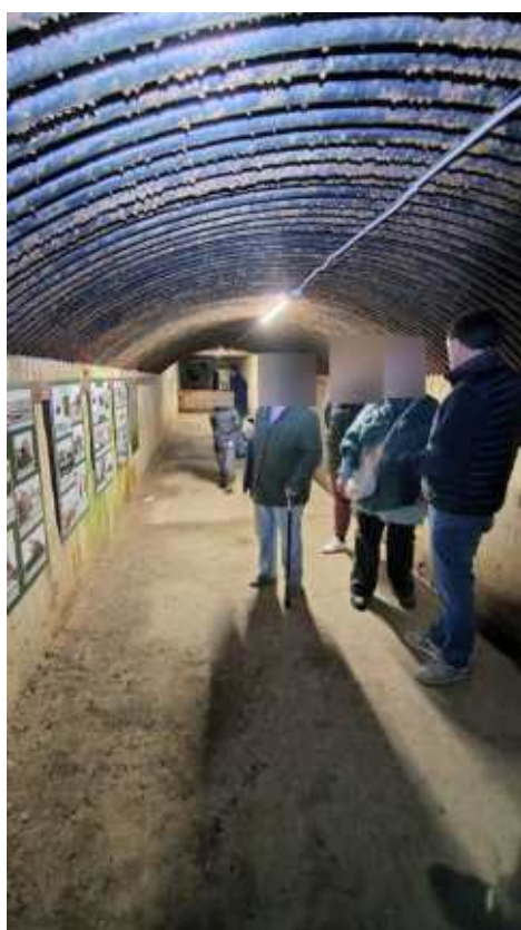
Фото 203. Коробовый свод с металлической подшивкой. Фрагмент. Дата фотофиксации: 06.10.24
