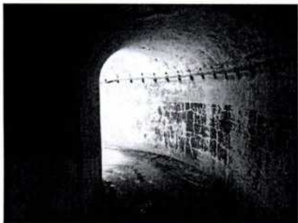
15. Сквозник. Наблюдаются деструкции отделочных слоев.
