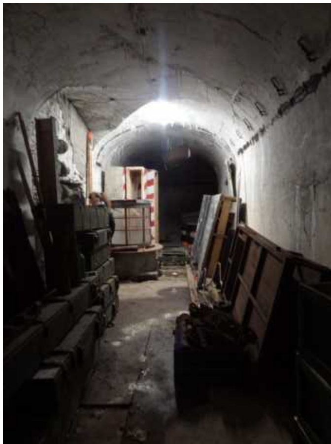
Фото 303. Входная галерея в северной части правого фланга. Фрагмент. Дата фотофиксации: 10.10.24
