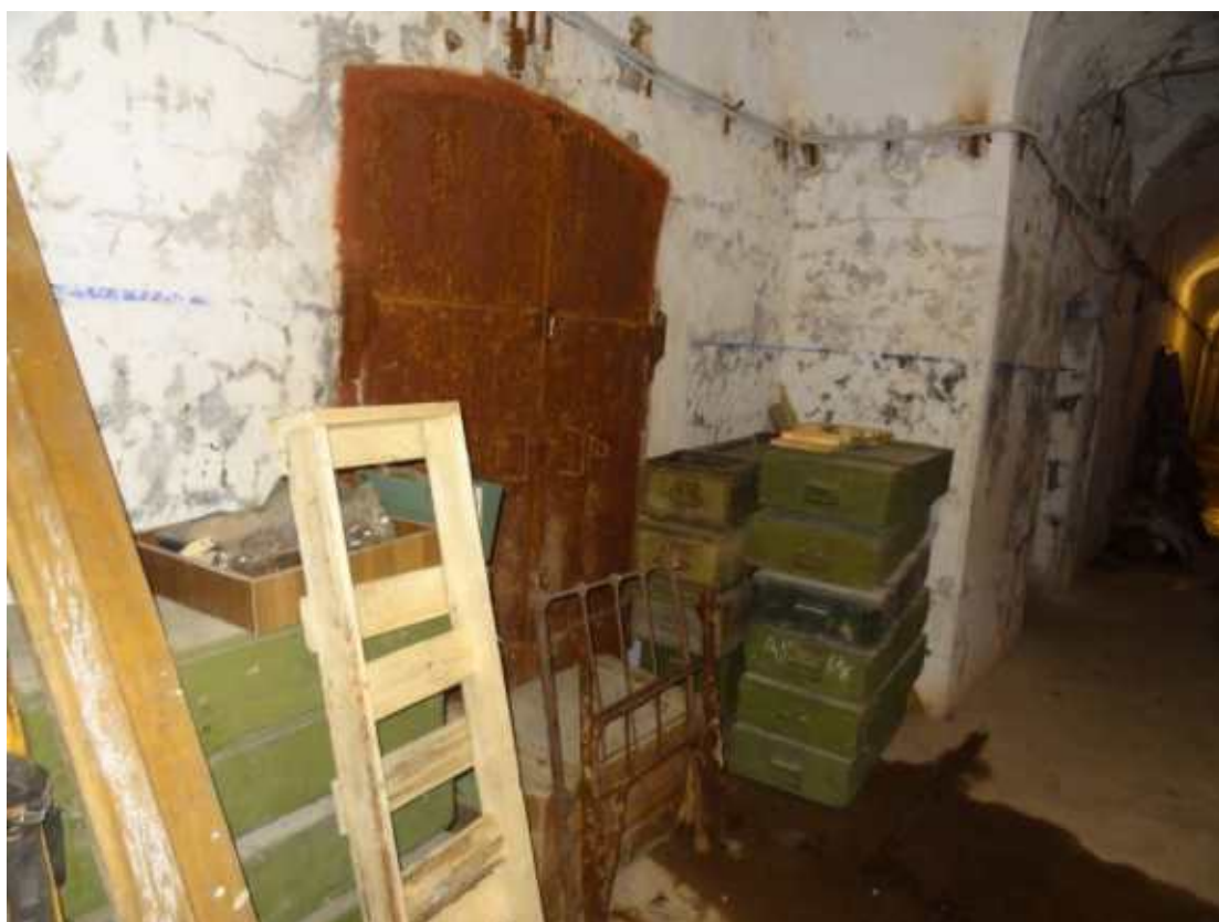
Фото 165. Двустворчатая металлическая дверь с лучковым завершением. Галереи правого фланга. Общий вид. Дата фотофиксации: 06.10.24
