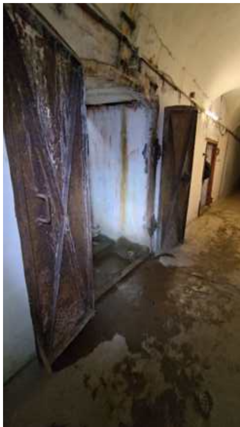
Фото 218. Двустворчатая прямоугольная металлическая дверь, соединяющая коридор и вспомогательные сооружения. Общий вид. Дата фотофиксации: 06.10.24
