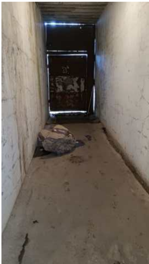
Фото 160. Галереи опытных построек. Фрагмент. Дата фотофиксации: 06.10.24
