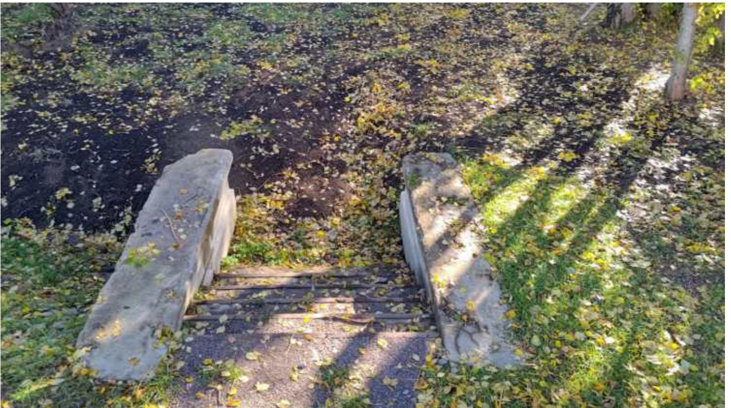
Фото 16. Историческая бетонная лестница. Общий вид. Дата фотофиксации: 10.10.24
