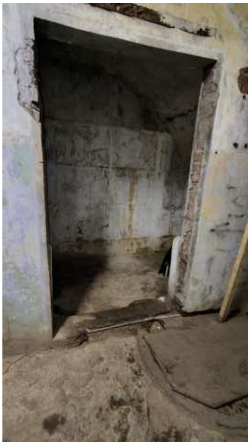
Фото 181. Вспомогательное помещение. Фрагмент. Дата фотофиксации: 06.10.24
