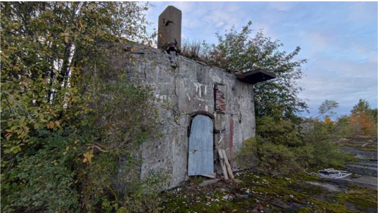
Фото 74. Крыша Офицерских казарм. Фрагмент. Дата фотофиксации: 06.10.24
