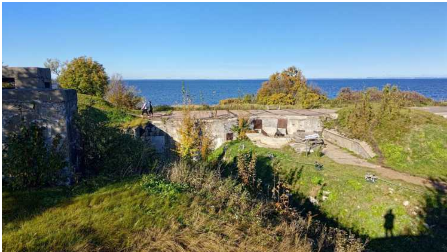
Фото 148. Вход в галереи правого фланга. Общий вид. Дата фотофиксации: 10.10.24
