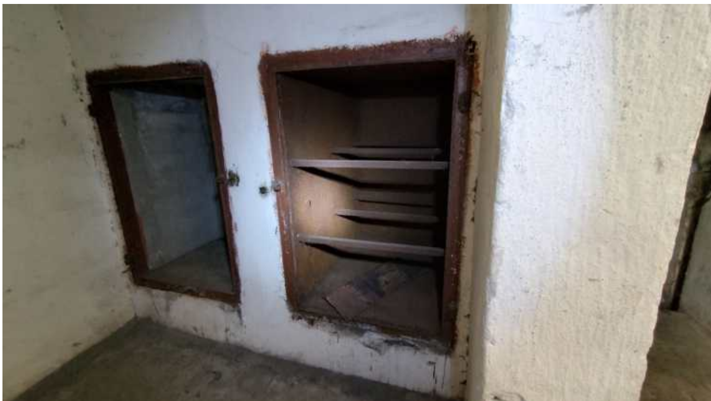
Фото 227. Хранилище боеприпасов. Общий вид. Дата фотофиксации: 06.10.24
