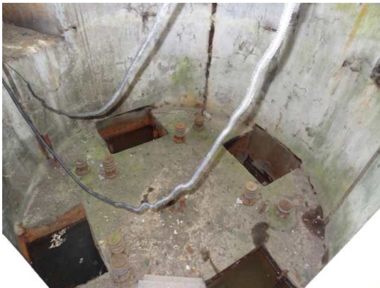
Фото 322. Проекторная шахта, помещение 19 правого фланга. Фрагмент. Дата фотофиксации: 10.10.24
