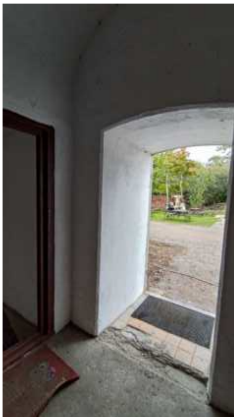
Фото 22. Входной портал в Казармы нижних чинов. Помещение 1, 2-Н. Общий вид. Дата фотофиксации: 10.10.24
