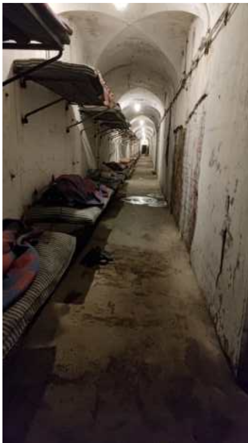
Фото 156. Галереи опытных построек. Своды коробовые с распалубками. Общий вид. Дата фотофиксации: 06.10.24
