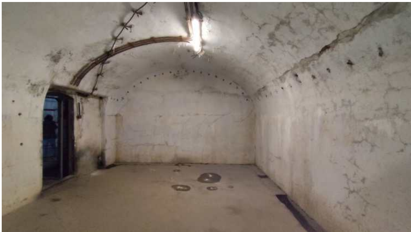
Фото 256. Входная галерея Левого фланга. Общий вид. Дата фотофиксации: 06.10.24
