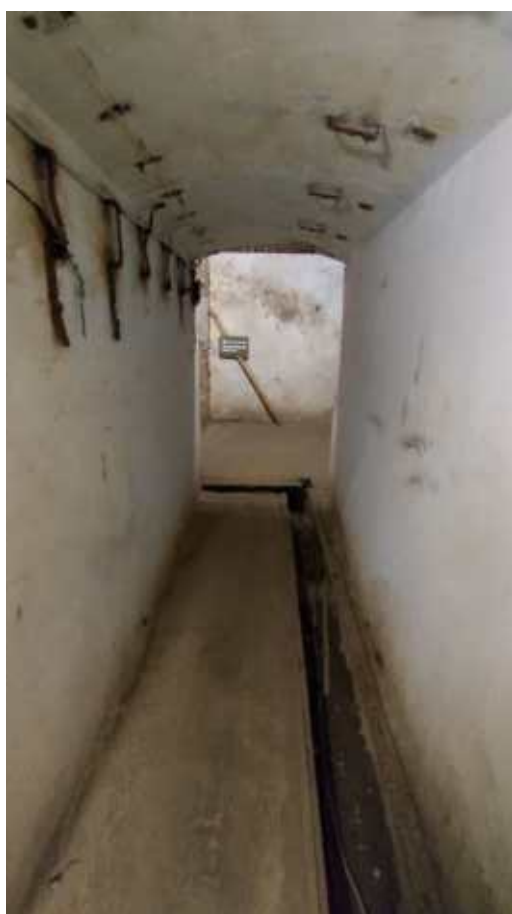
Фото 197. Коридор опытных построек. Фрагмент. Дата фотофиксации: 06.10.24
