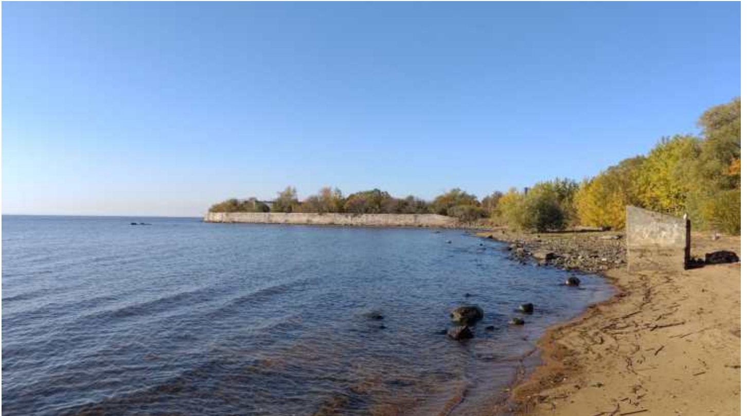
Фото 1. Береговая линия со стороны левого фланга. Бетонные конструкции форта. Общий вид. Дата фотофиксации: 10.10.24
