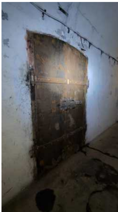
Фото 234. Металлическая двустворчатая дверь в коридоре-потерне. Главного калибра. Общий вид. Дата фотофиксации: 06.10.24
