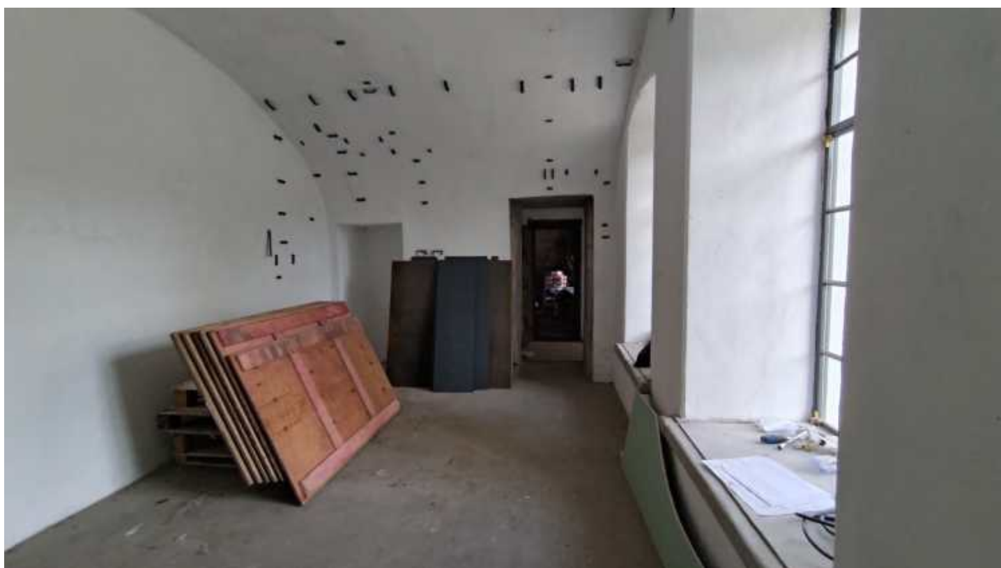
Фото 51. Помещение 3, 5-Н. Общий вид. Дата фотофиксации: 10.10.24
