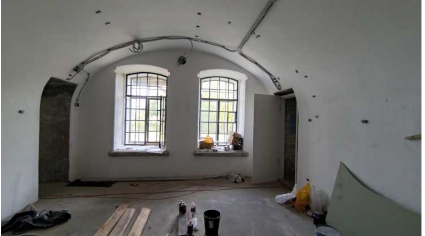
Фото 56. Помещение 2, 4-Н. Общий вид. Дата фотофиксации: 10.10.24
