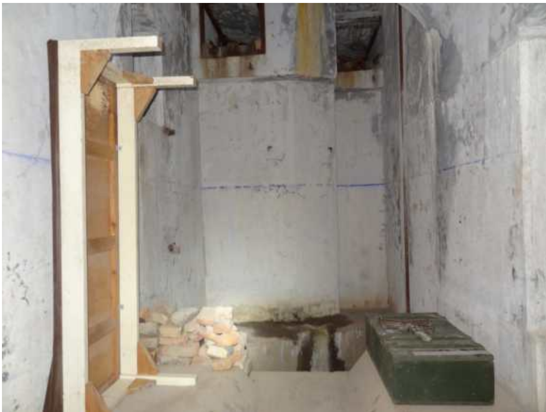
Фото 166. Конструкции элеватора боеприпасов правого фланга. Общий вид. Дата фотофиксации: 06.10.24
