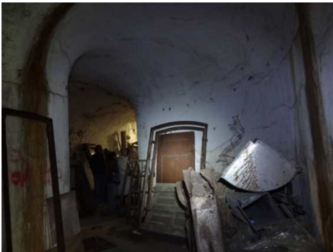
Фото 300. Входная галерея в северной части правого фланга. Фрагмент. Дата фотофиксации: 10.10.24
