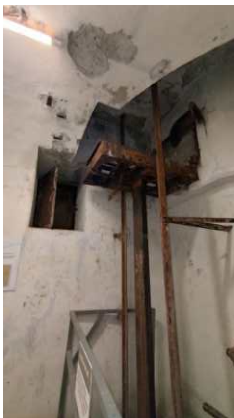
Фото 232. Исторические конструкции элеваторов. Фрагмент. Дата фотофиксации: 06.10.24
