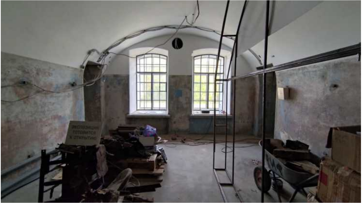
Фото 58. Помещение 1, 4-Н. Общий вид. Дата фотофиксации: 10.10.24
