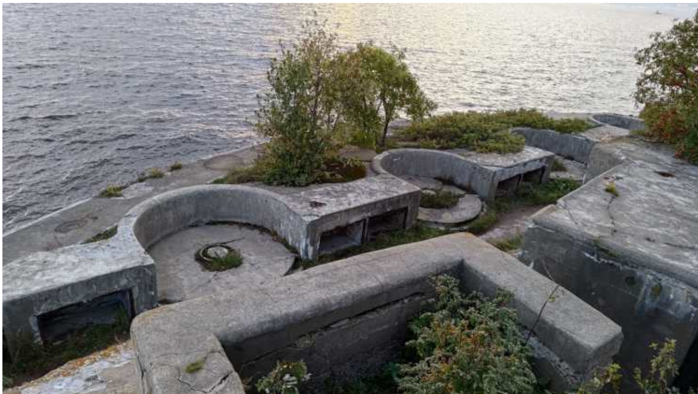
Фото 263. Позиции открытых противодесантных батарей левого фланга. Общий вид. Дата фотофиксации: 06.10.24
