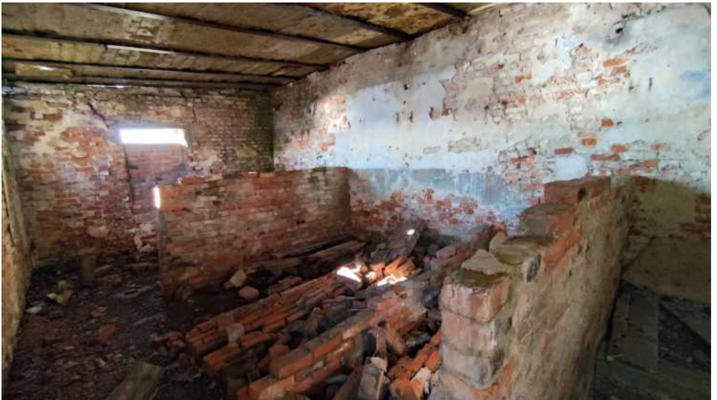
Фото 274. Пристройка левого фланга. Интерьер. Фрагмент. Дата фотофиксации: 10.10.24
