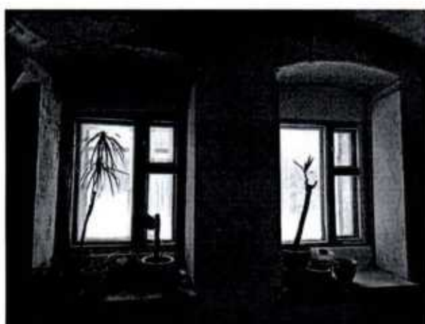
12. Солдатская казарма. Оконные проемы.
