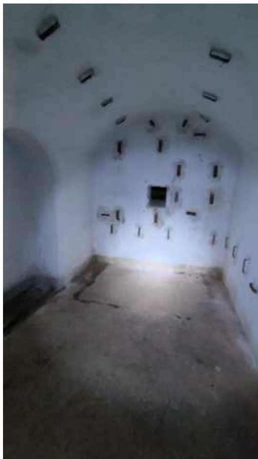
Фото 196. Помещение нижнего уровня опытных построек. Общий вид. Дата фотофиксации: 06.10.24
