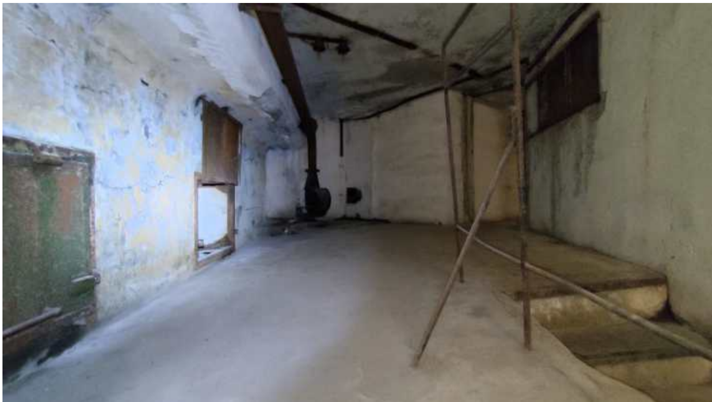
Фото 222. Орудийный дворик. Фрагмент. Металлическая заглушка элеватора подачи боеприпасов. Общий вид. Дата фотофиксации: 06.10.24
