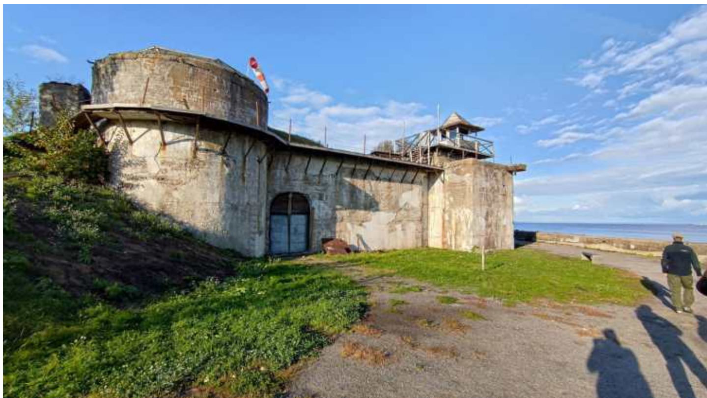
Фото 109. Правый фланг. Фрагмент. Дата фотофиксации: 06.10.24
