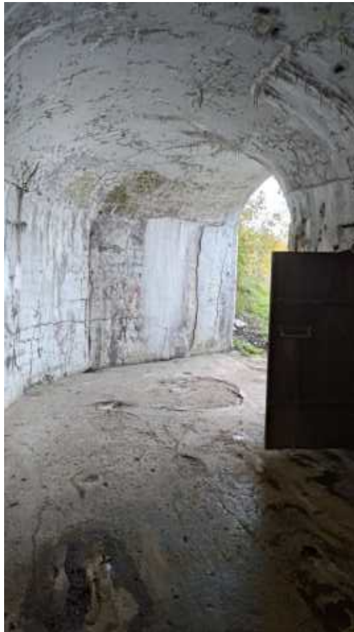
Фото 258. Входная галерея Левого фланга. Фрагмент. Дата фотофиксации: 06.10.24
