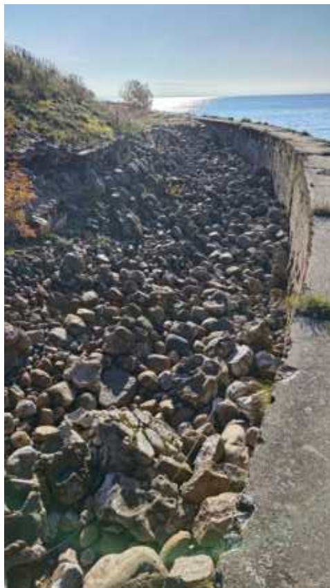
Фото 133. Конструкции основания форта – булыжная засыпка с бетонным ростверком в завершении и свайным основанием под подпорной стенкой. Правый фланг. Фрагмент. Дата фотофиксации: 10.10.24
