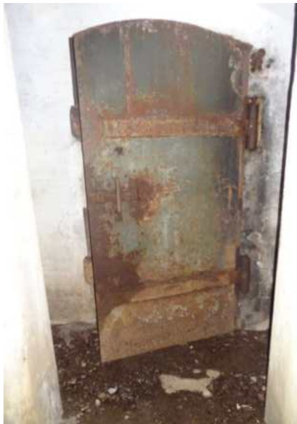
Фото 313. Металлическая, прямоугольная дверь с лучкообразным завершением. Правый фланг. Общий вид. Дата фотофиксации: 10.10.24
