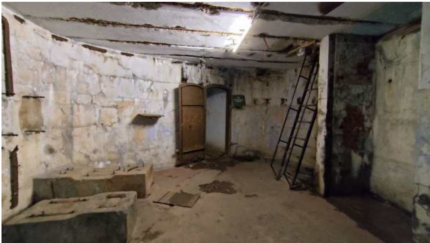
Фото 182. Помещение опытных сооружений. Общий вид. Дата фотофиксации: 06.10.24
