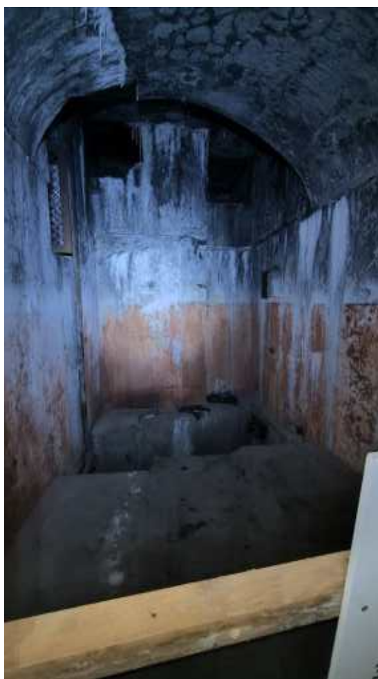
Фото 246. Орудийный погреб главного калибра. Общий вид. Дата фотофиксации: 06.10.24
