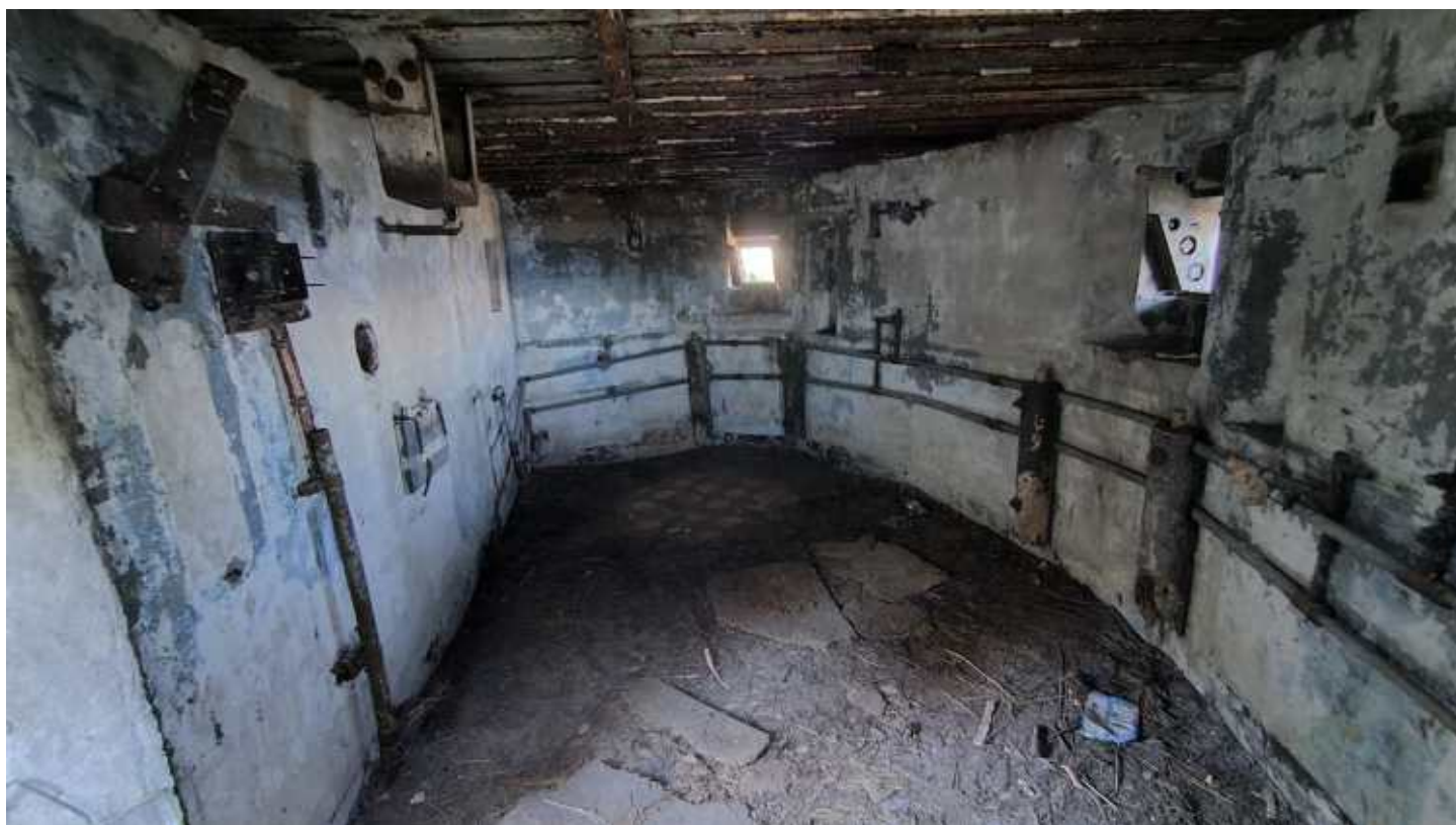
Фото 128. Интерьер противодесантного дота правого фланга. Общий вид. Дата фотофиксации: 10.10.24
