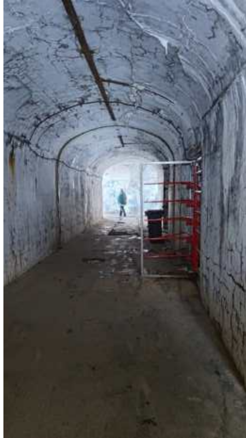
Фото 257. Входная галерея Левого фланга. Фрагмент. Дата фотофиксации: 06.10.24
