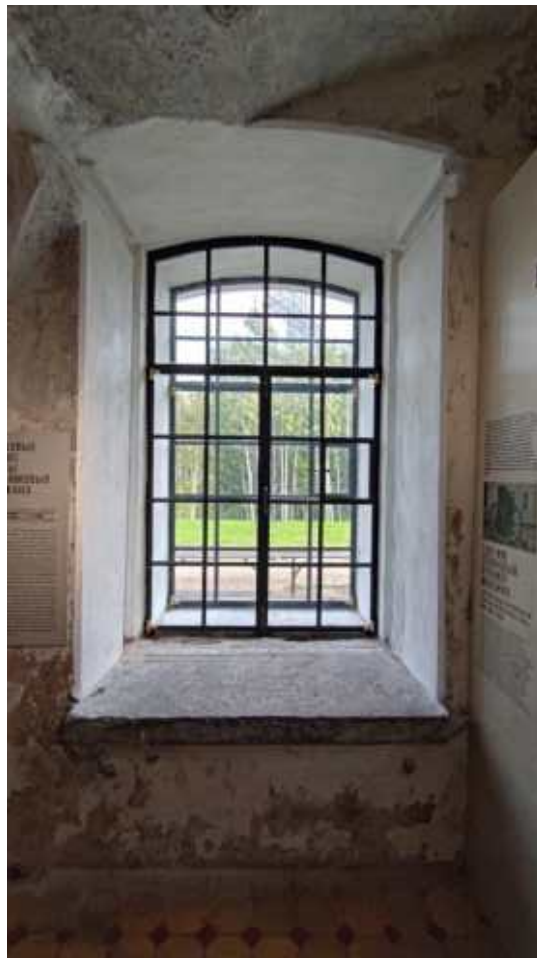
Фото 33. Оконное заполнение в помещении 7. Общий вид. Дата фотофиксации:
