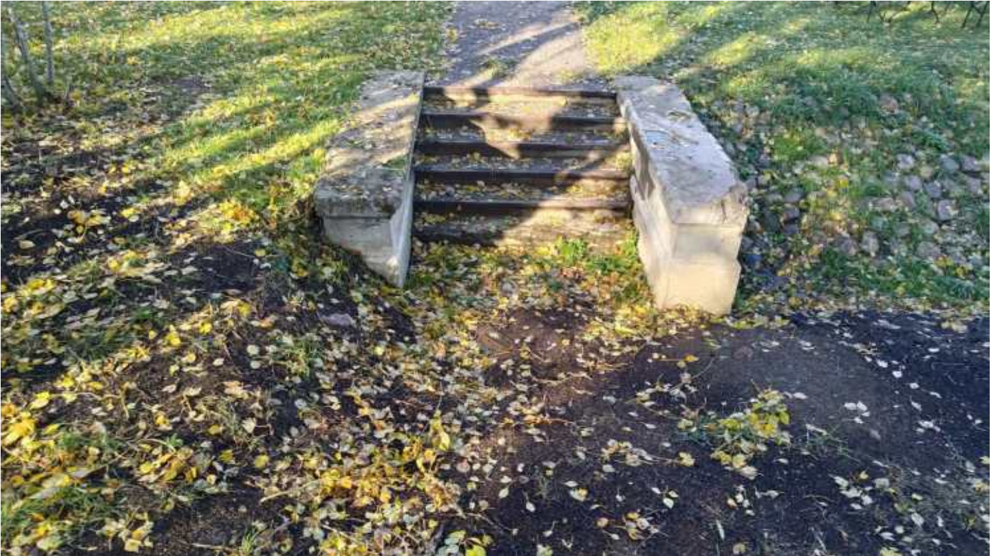
Фото 17. Историческая бетонная лестница. Общий вид. Дата фотофиксации: 10.10.24
