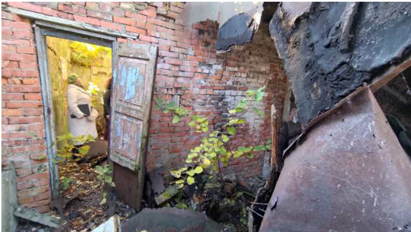
Фото 275. Пристройка левого фланга. Интерьер. Фрагмент. Дата фотофиксации: 10.10.24
