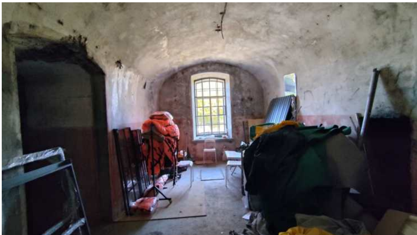
Фото 82. Помещение 2, 6-Н. Офицерские казармы. Общий вид. Дата фотофиксации: 10.10.24
