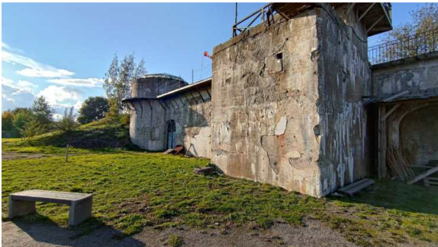
Фото 114. Правый фланг. Фрагмент. Дата фотофиксации: 06.10.24
