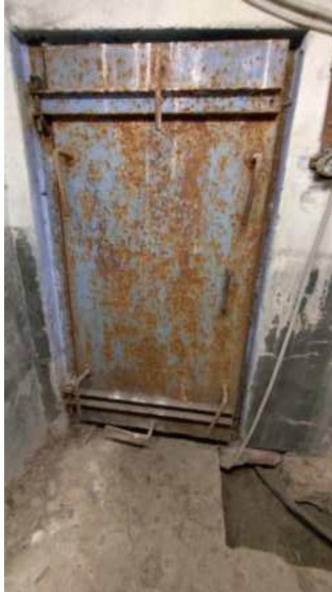
Фото 46. Прямоугольная металлическая дверь во входной галерее подземной части солдатских казарм. Общий вид. Дата фотофиксации: 10.10.24
