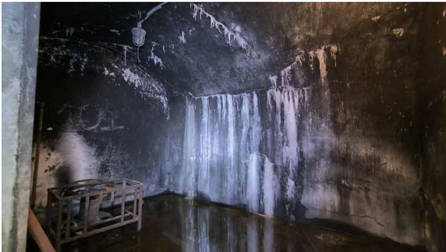
Фото 158. Помещение опытных построек. Общий вид. Дата фотофиксации: 06.10.24
