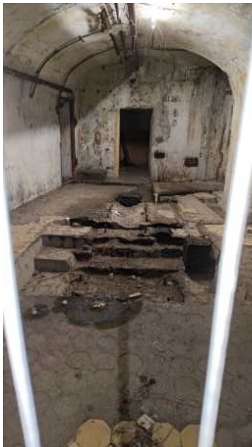
Фото 243. Помещение Главного калибра. Общий вид. Дата фотофиксации: 06.10.24
