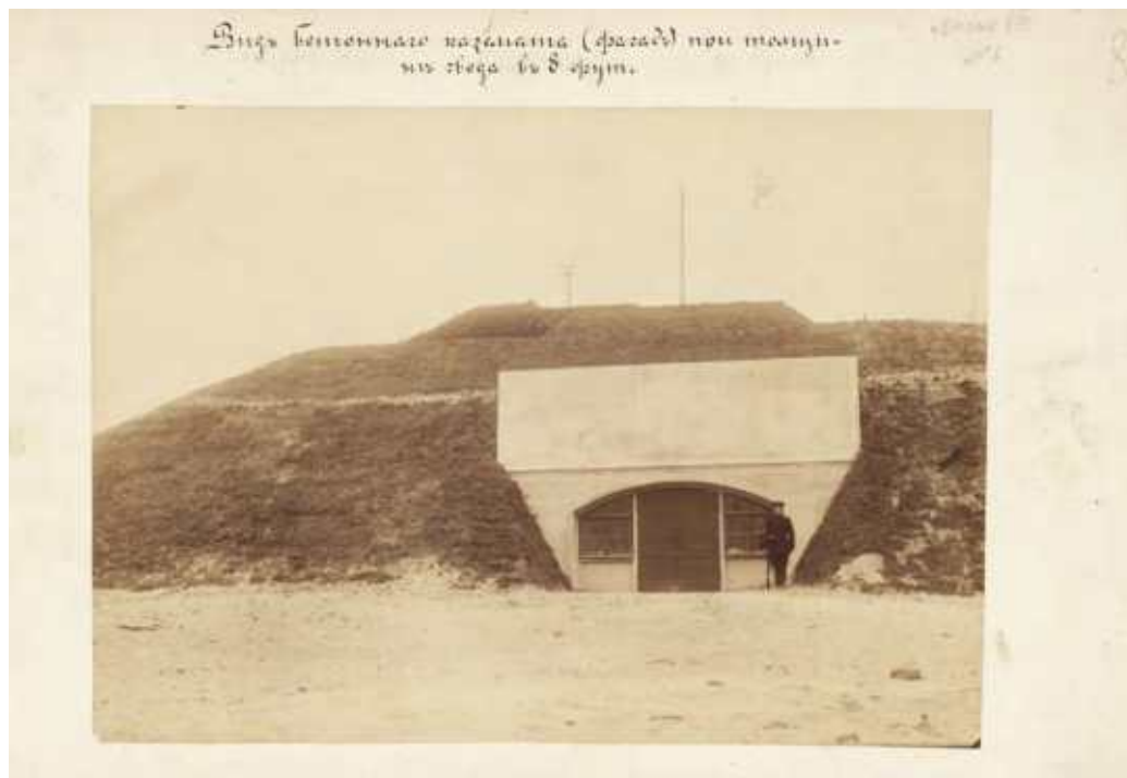
Илл. 17. Вид бетонного каземата (фасад) при толщине свода в 8 фут. (Каземат А с деревянной тыльной стенкой до обстрела.). (РГАВМФ. Ф. 1341. Оп. 3. Д. 588).
