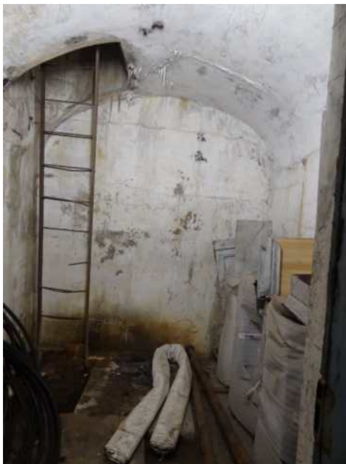
Фото 304. Помещение 27 правого фланга. Общий вид. Дата фотофиксации: 10.10.24
