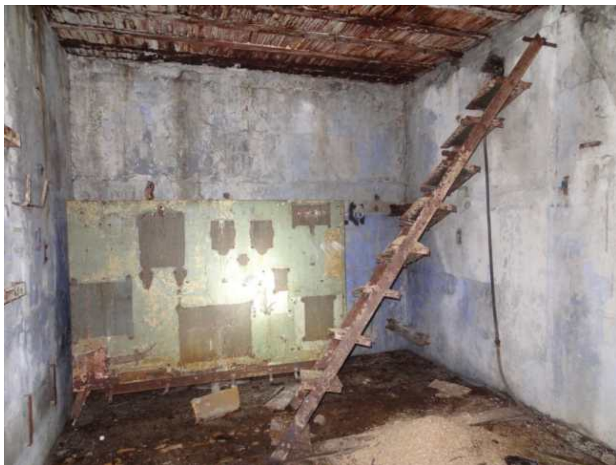
Фото 308. Помещение 26 правого фланга. Общий вид. Дата фотофиксации: 10.10.24
