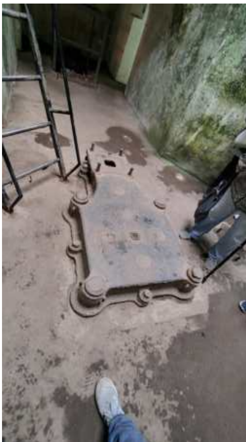
Фото 191. Конструкции скрывающейся броневой башни. Фрагмент Дата фотофиксации: 06.10.24
