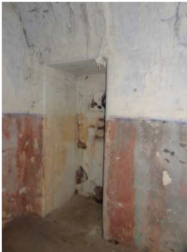
Фото 321. Заложенный портал в помещении 18 правого фланга. Общий вид. Дата фотофиксации: 10.10.24
