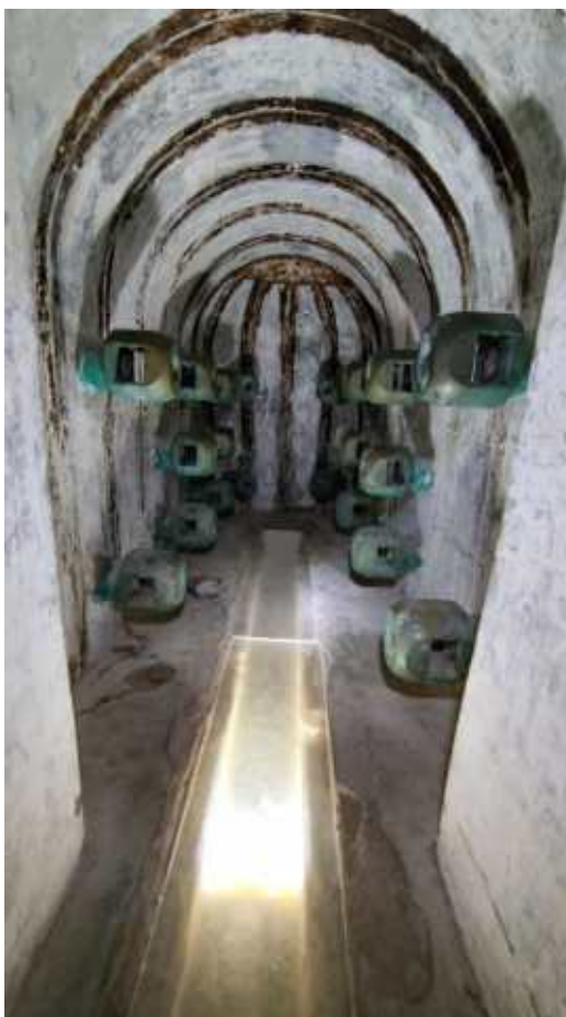
Фото 142. Конструкции артиллерийской системы капонира. Общий вид. Дата фотофиксации: 06.10.24
