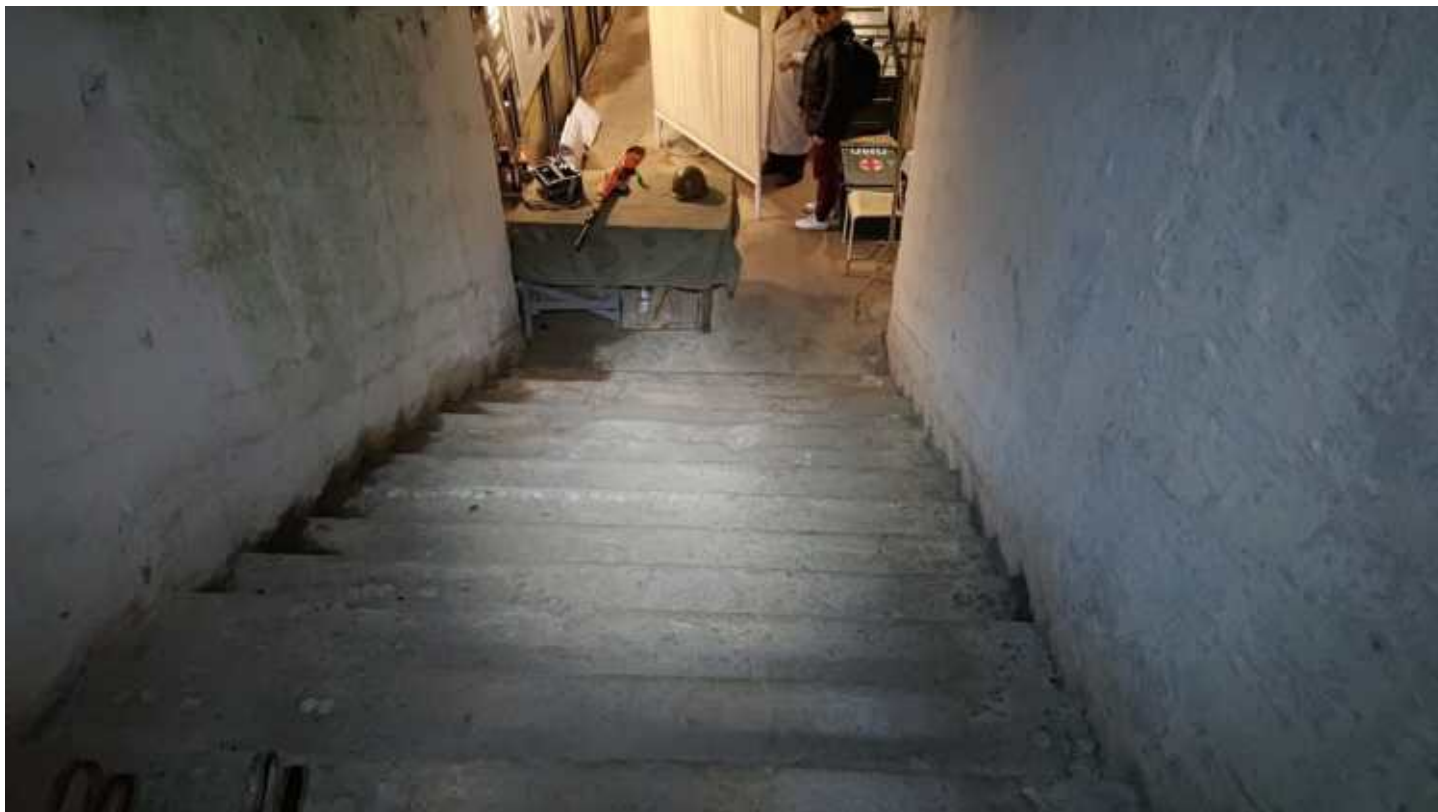
Фото 292. Бетонная лестница, ведущая в нижний уровень опытных построек. Фрагмент. Дата фотофиксации: 10.10.24
