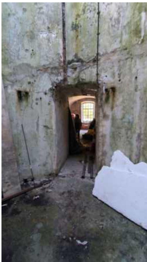
Фото 86. Прожекторная шахта. Офицерские казармы. Фрагмент. Дата фотофиксации: 06.10.24
