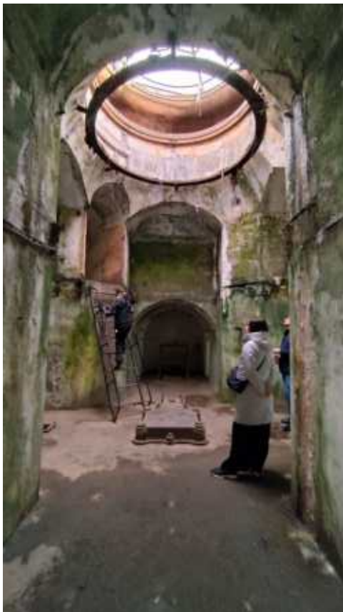
Фото 190. Помещение скрывающейся броневой башни в центре тыловой части эскарпа. Общий вид. Дата фотофиксации: 06.10.24
