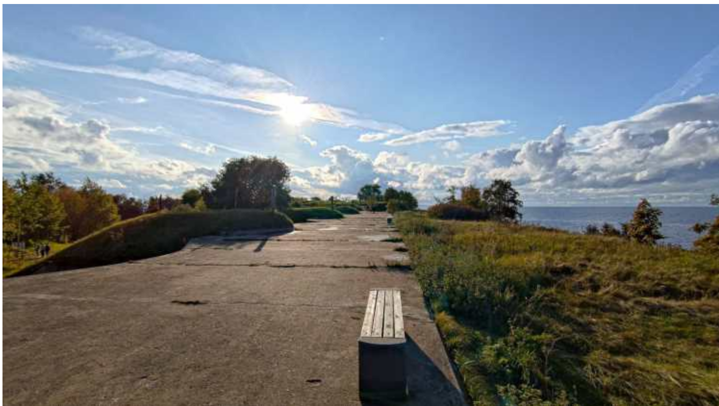
Фото 112. Правый фланг. Фрагмент. Дата фотофиксации: 06.10.24
