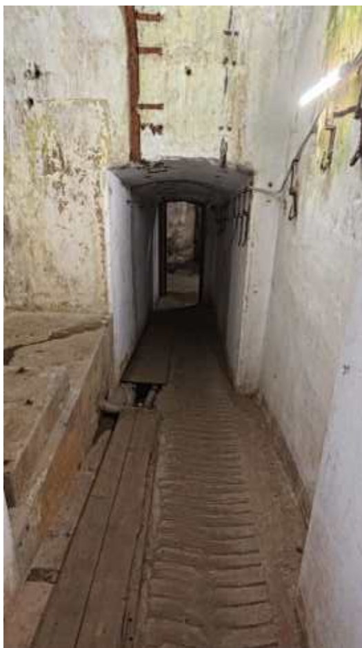
Фото 195. Коридор, соединяющий помещения опытных построек и галереи. Дата фотофиксации: 06.10.24
