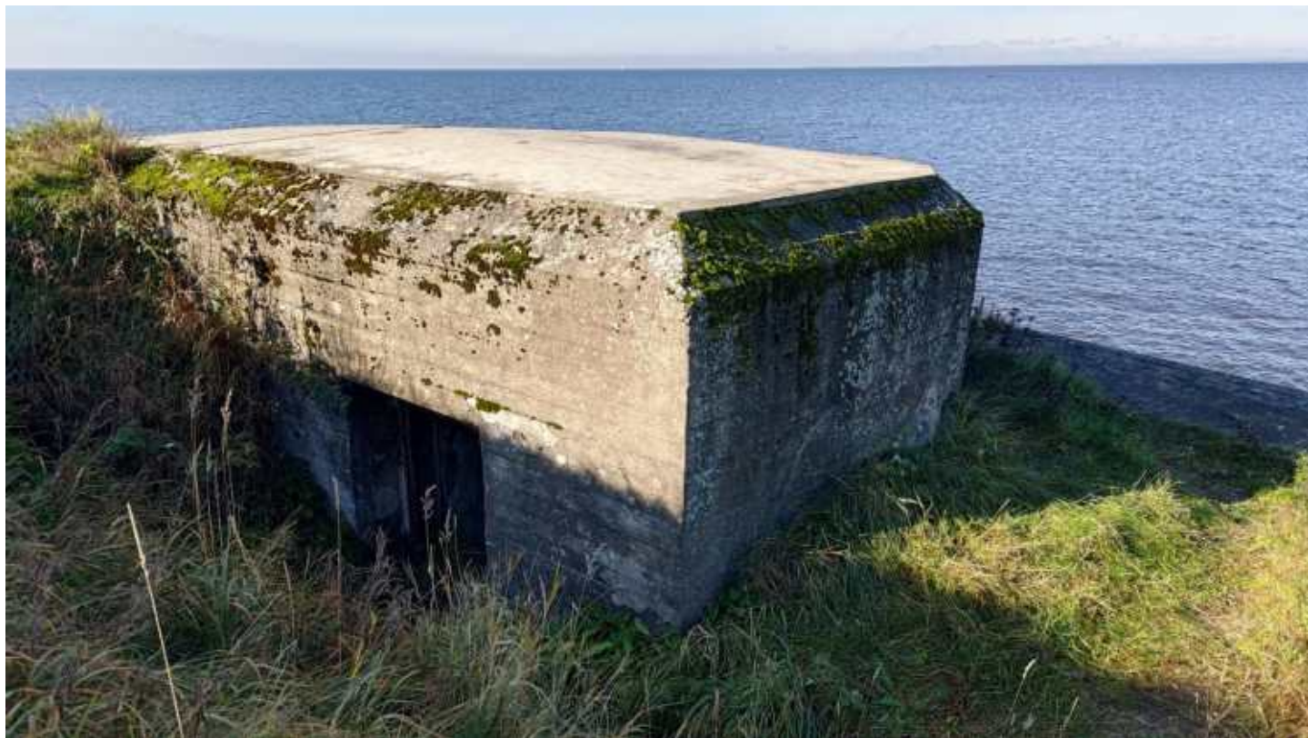
Фото 125. Противодесантный дот. Правый фланг. Общий вид. Дата фотофиксации: 10.10.24
