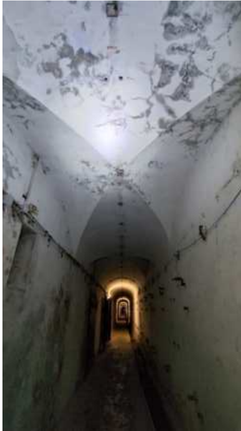
Фото 216. Своды – коробовые с распалубками. Общий вид. Дата фотофиксации: 06.10.24
