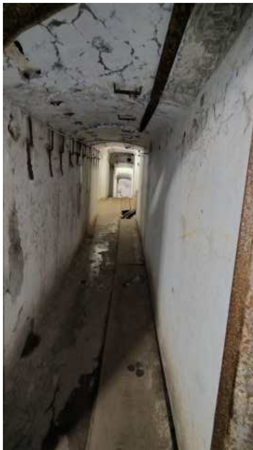
Фото 184. Коридор опытных построек. Общий вид. Дата фотофиксации: 06.10.24
