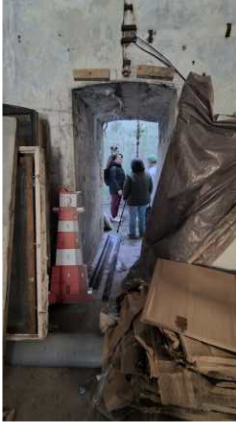
Фото 83. Портал между помещениями 2 и 3, 6-Н. Офицерские казармы. Общий вид. Дата фотофиксации: 06.10.24
