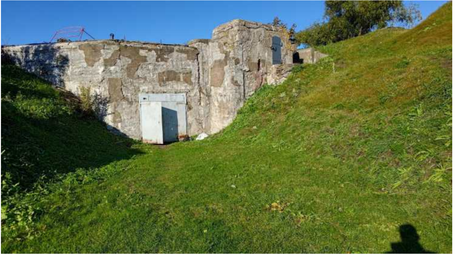
Фото 108. Бетонные конструкции Главного калибра. Фрагмент. Дата фотофиксации: 10.10.24
