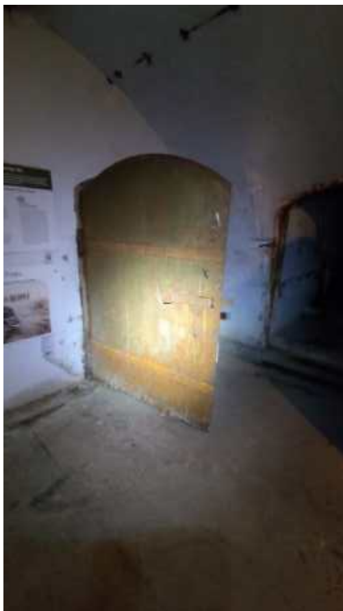
Фото 174. Одностворчатая металлическая дверь с лучковым завершением. Общий вид. Дата фотофиксации: 06.10.24
