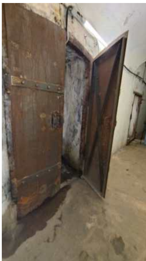
Фото 236. Металлическая двустворчатая дверь в коридоре-потерне. Главного калибра. Общий вид. Дата фотофиксации: 06.10.24
