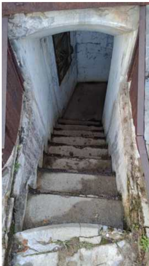
Фото 150. Двойная бетонная лестница опытных построек. Фрагмент. Дата фотофиксации: 06.10.24
