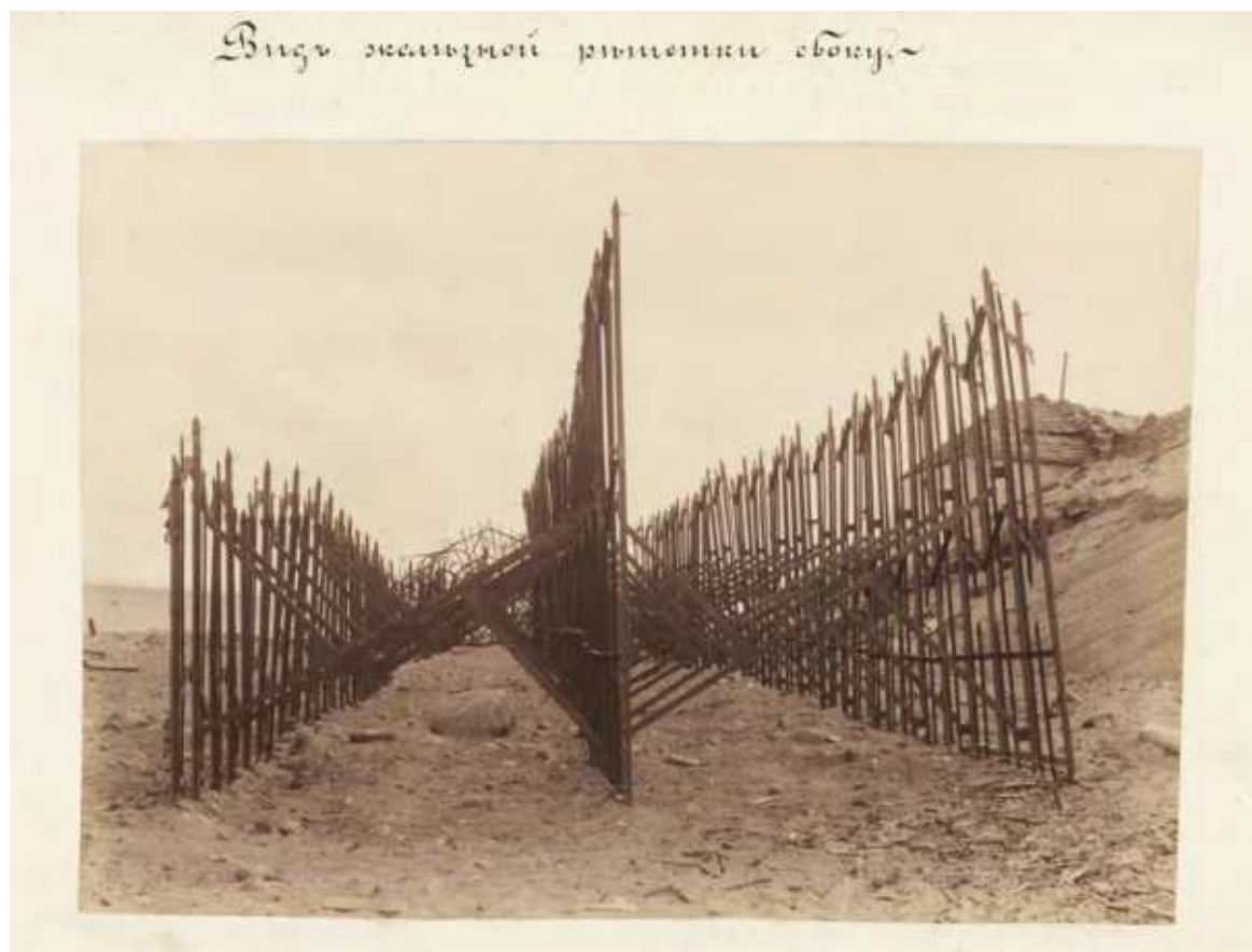
Илл. 13. Вид железной решетки сбоку (противоштурмовая решетка полковника Ощевского-Круглика). (РГАВМФ. Ф. 1341. Оп. 3. Д. 588).
