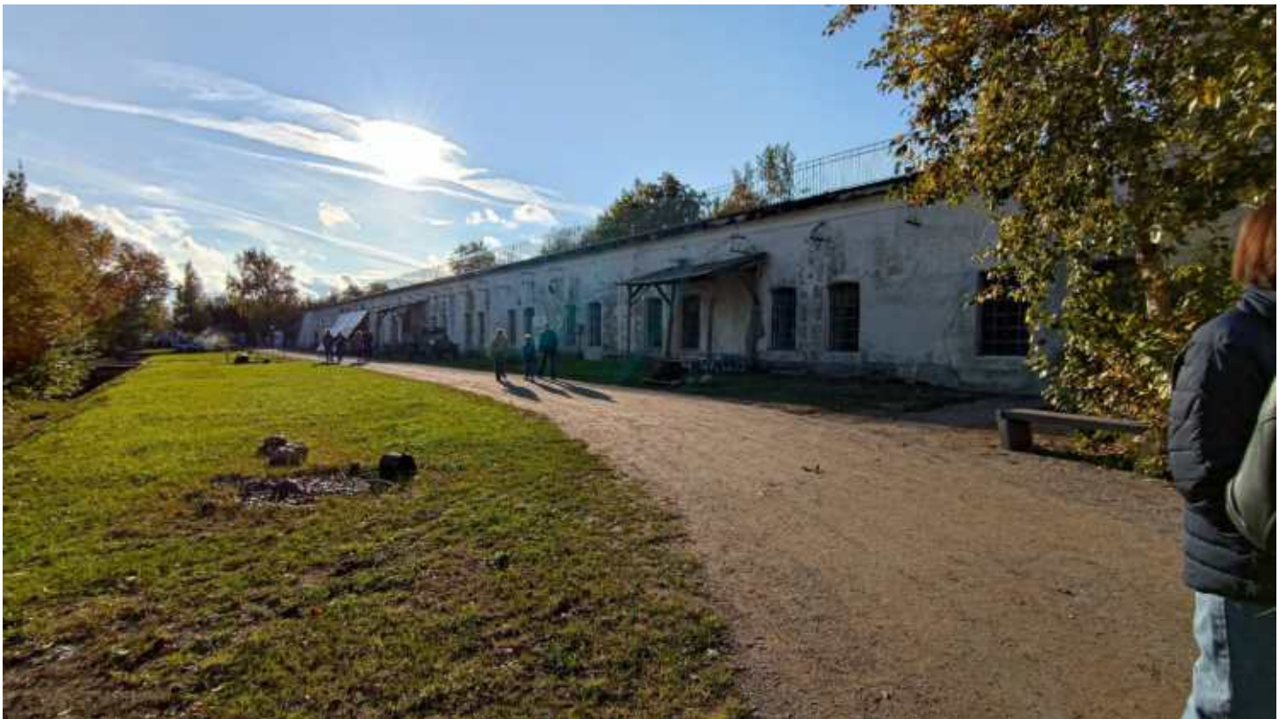
Фото 10. Восточный фасад солдатских казарм. Общий вид. Дата фотофиксации: 10.10.24
