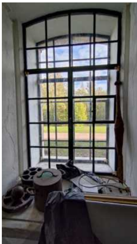
Фото 60. Оконное заполнение в помещении 1, 3-Н. Общий вид. Дата фотофиксации: 10.10.24
