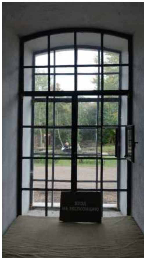
Фото 27. Оконное заполнение в помещении 4. Общий вид. Дата фотофиксации: 10.10.24
