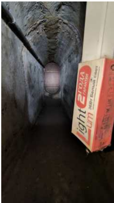
Фото 297. Овальный проём галереи-потерны. Общий вид. Дата фотофиксации: 10.10.24
