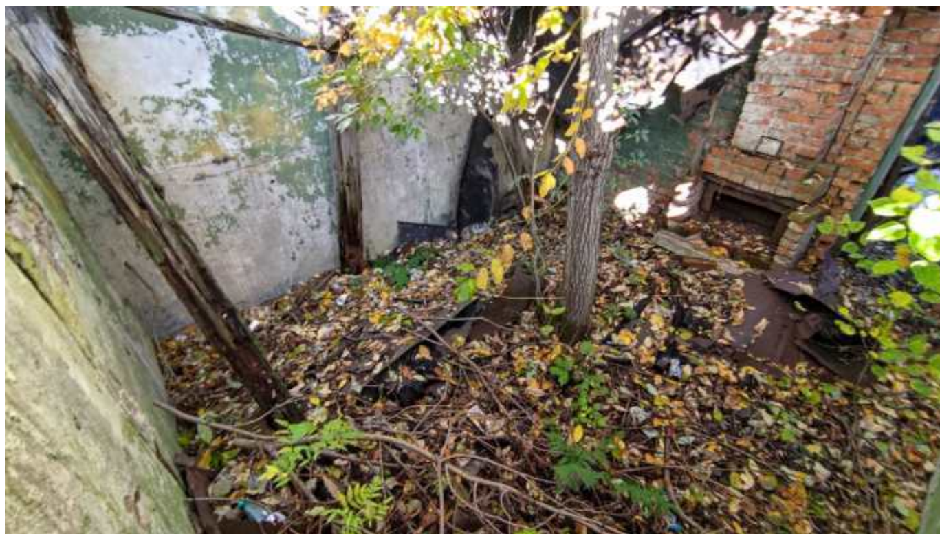
Фото 278. Пристройка левого фланга. Интерьер. Фрагмент. Дата фотофиксации: 10.10.24
