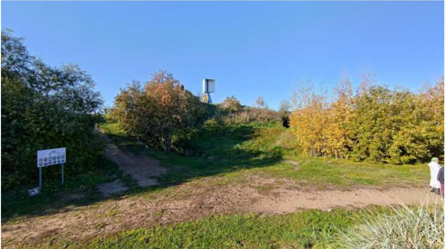
Фото 102. Главный калибр и опытные сооружения. Фрагмент. Дата фотофиксации: 10.10.24
