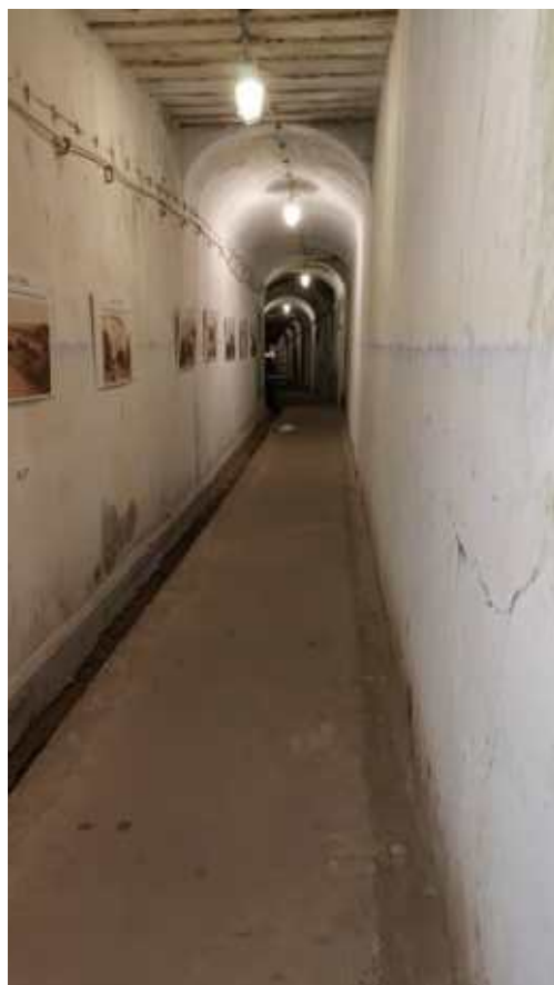
Фото 171. Галереи опытных построек. Фрагмент. Дата фотофиксации: 06.10.24
