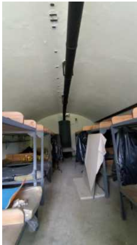
Фото 59. Помещение 1, 3-Н. Общий вид. Дата фотофиксации: 10.10.24
