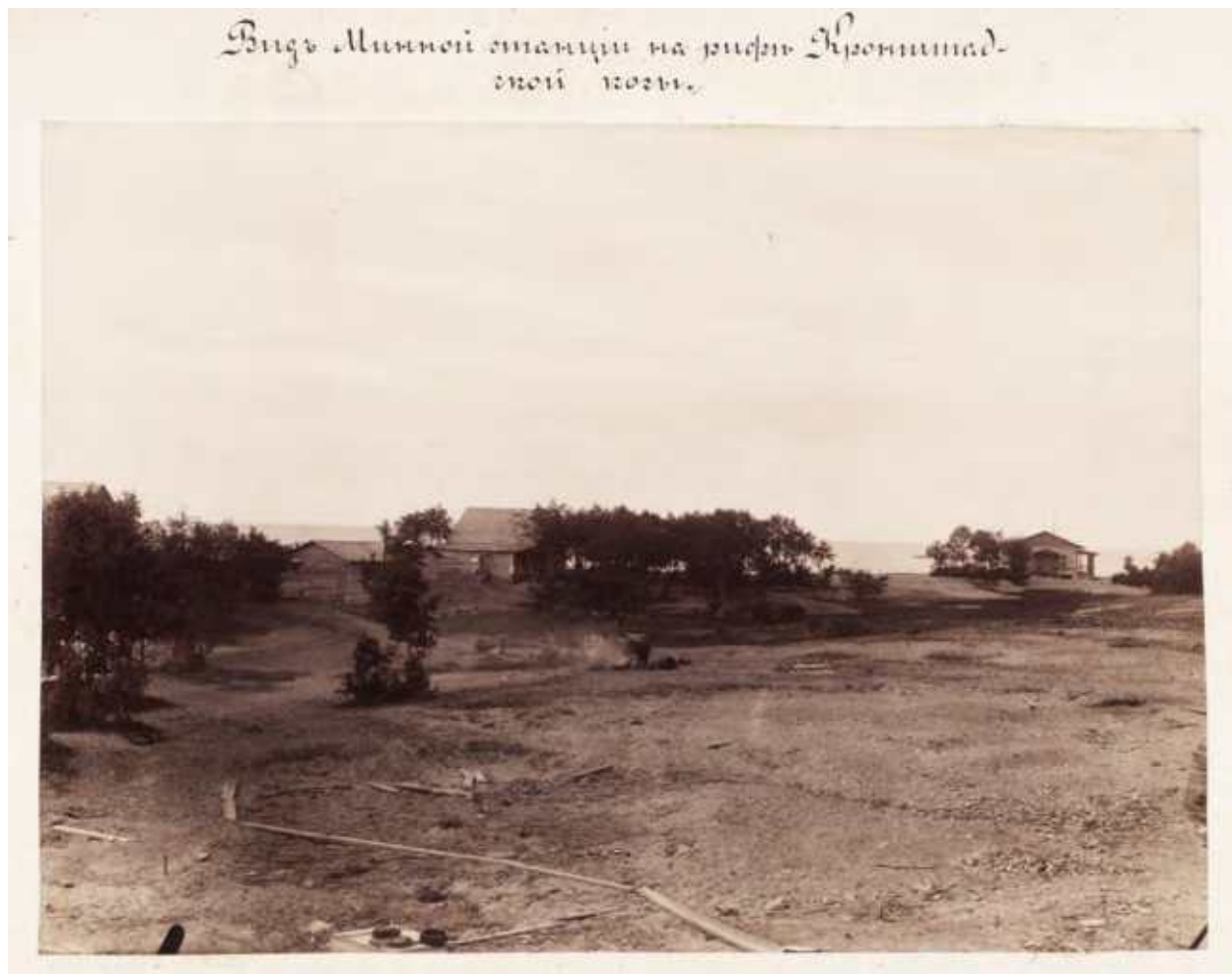
Илл. 27. Вид Минной станции на рифе Кронштадтской косы. (РГАВМФ. Ф. 1341. Оп. 03. Д. 603). Вид с насыпи опытных построек в сторону запада. Собственно здание минной станции располагается на заднем плане справа. На переднем плане, слева – комплекс строений рабочих опытного полигона. В настоящее время вся эта часть острова размыта.
