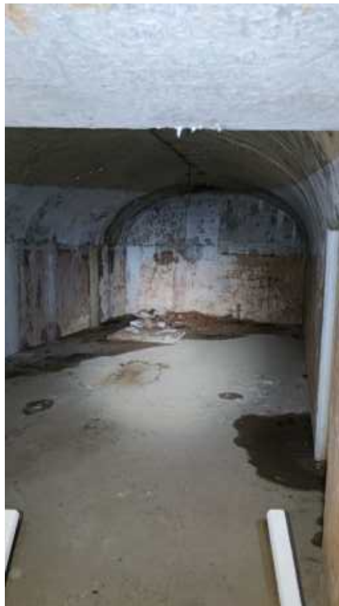
Фото 209. Помещение котельной опытных сооружений. Общий вид. Дата фотофиксации: 06.10.24
