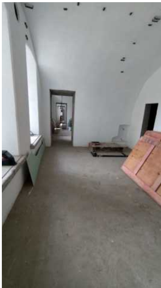
Фото 50. Помещение 3, общий вид. Дата фотофиксации: 10.10.24
