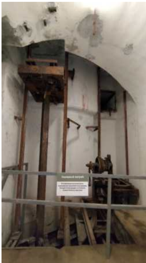
Фото 231. Исторические конструкции элеваторов. Зарядный погреб. Общий вид. Дата фотофиксации: 06.10.24
