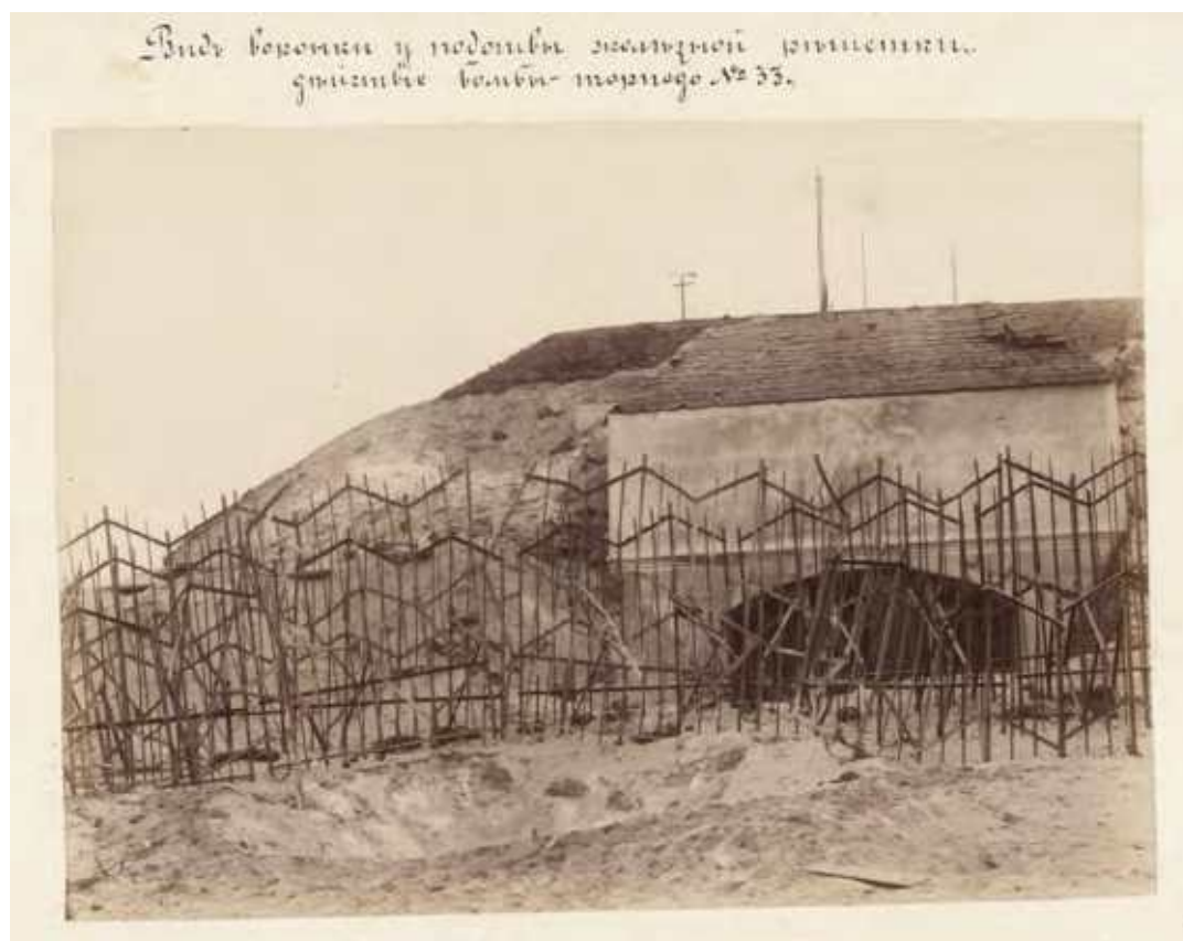
Илл. 15. Вид воронки у подошвы железной решетки, действие бомбы-торпеды № 33. (РГАВМФ. Ф. 1341. Оп. 3. Д. 588).
