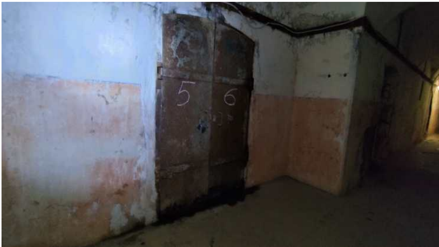
Фото 249. Металлические двустворчатые прямоугольные двери с лучковым завершением в галереи Левого фланга. Общий вид. Дата фотофиксации: 06.10.24
