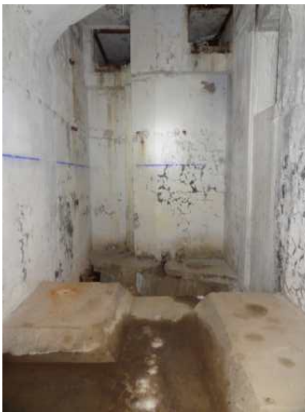
Фото 167. Конструкции элеватора боеприпасов правого фланга. Общий вид. Дата фотофиксации: 06.10.24
