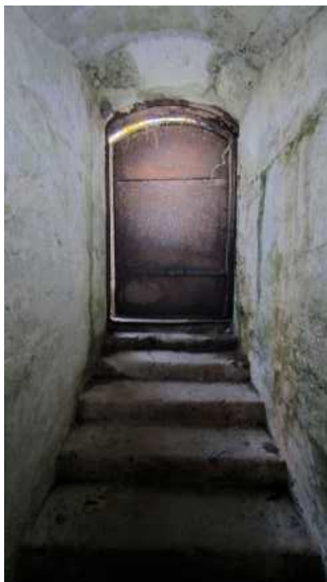
Фото 289. Металлическая одностворчатая прямоугольная дверь с лучковым завершением. Общий вид. Дата фотофиксации: 10.10.24
