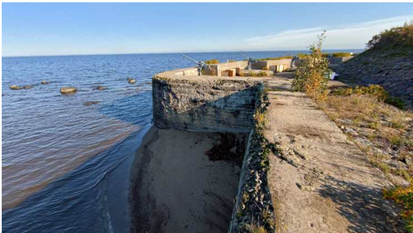
Фото 122. Бетонные конструкции форта. Правый фланг. Фрагмент. Дата фотофиксации: 10.10.24
