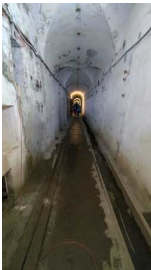
Фото 215. Коридор, соединяющий Главный калибр и опытные сооружения. Своды – коробовые с распалубками. Фрагмент. Дата фотофиксации: 06.10.24
