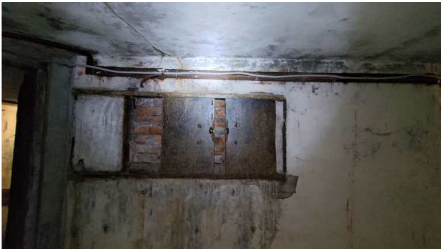
Фото 224. Металлически ставни. Общий вид. Дата фотофиксации: 06.10.24
