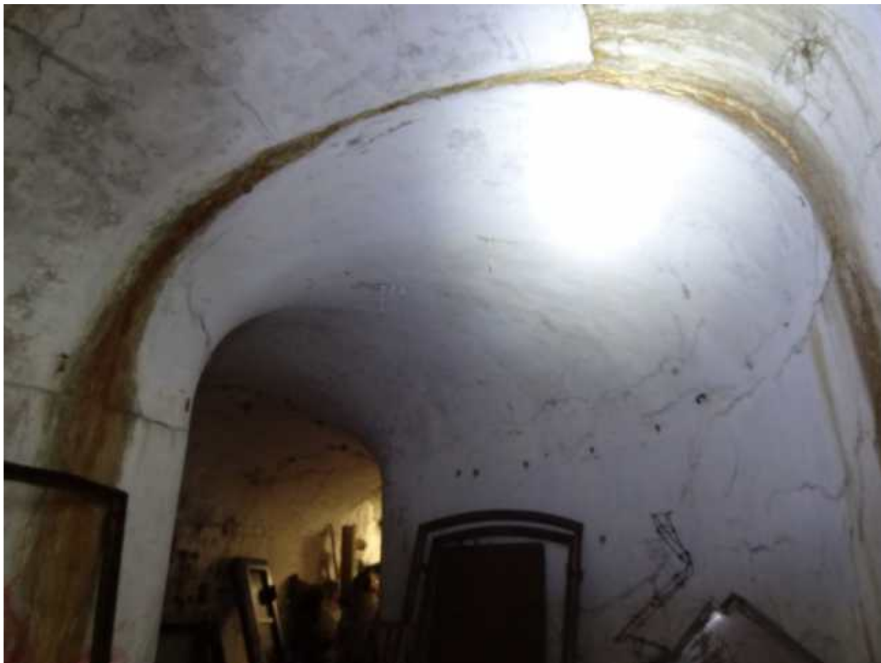
Фото 301. Коробовые своды правого фланга. Фрагмент. Дата фотофиксации: 10.10.24
