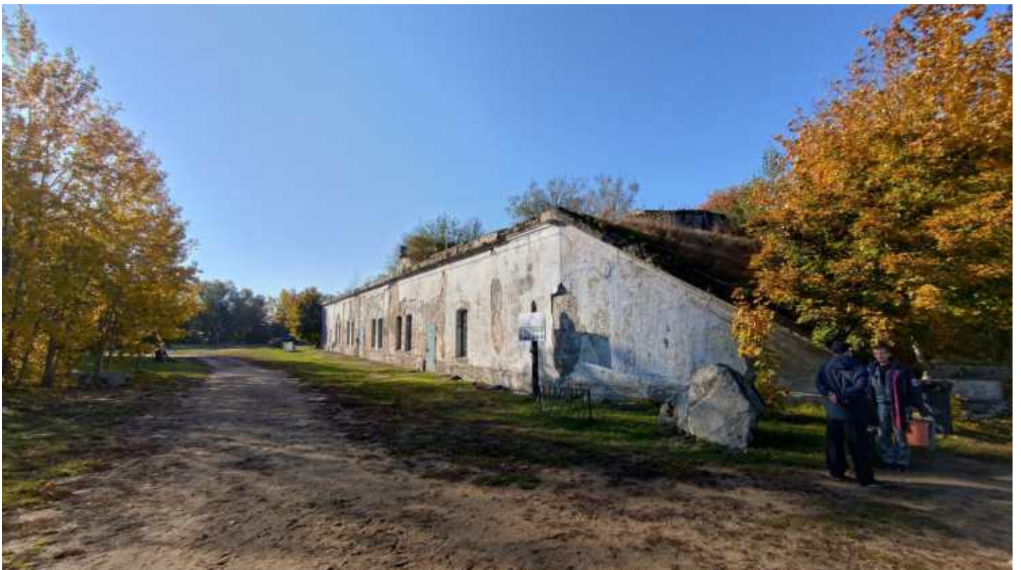
Фото 68. Офицерская казарма. Общий вид. Дата фотофиксации: 10.10.24
