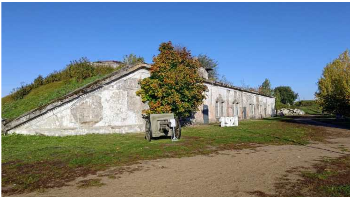
Фото 66. Офицерская казарма. Общий вид. Дата фотофиксации: 10.10.24
