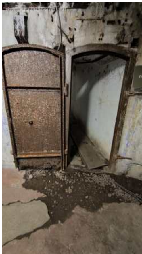
Фото 183. Прямоугольная одностворчатая металлическая дверь. Общий вид. Дата фотофиксации: 06.10.24
