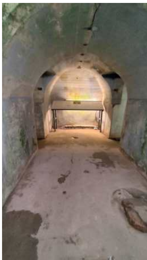
Фото 189. Помещение нижнего уровня опытных построек. Общий вид. Дата фотофиксации: 06.10.24
