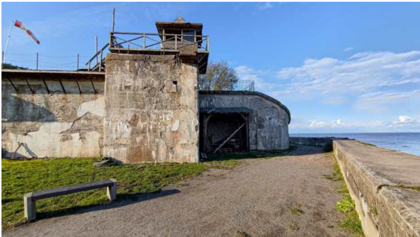
Фото 113. Правый фланг. Фрагмент. Дата фотофиксации: 06.10.24
