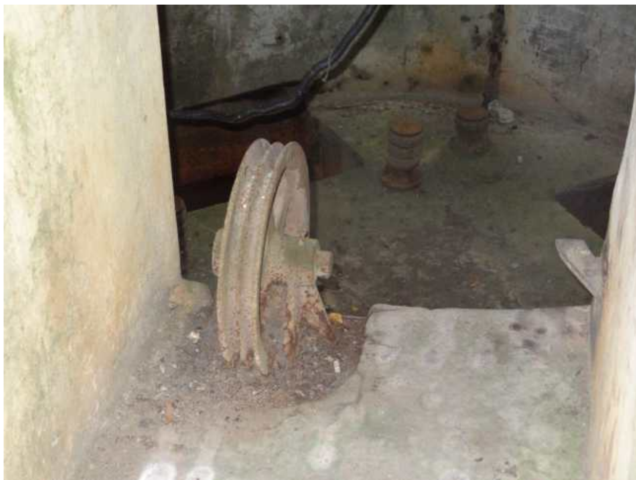
Фото 326. Фрагменты металлических конструкций прожекторной шахты, помещение 19 правого фланга. Дата фотофиксации: 10.10.24
