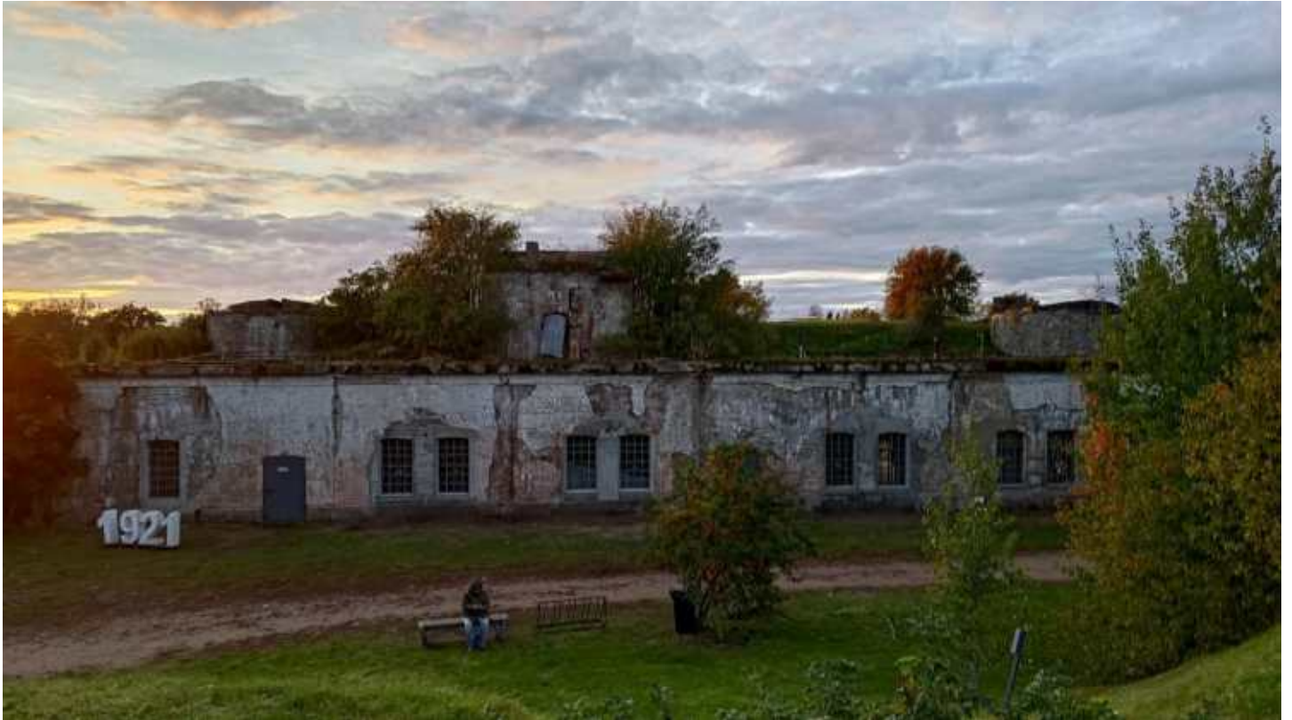
Фото 69. Офицерская казарма. Общий вид. Дата фотофиксации: 06.10.24
