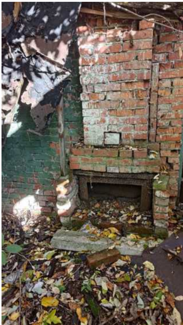
Фото 276. Кирпичная печь в пристройке левого фланга. Общий вид. Дата фотофиксации: 10.10.24
