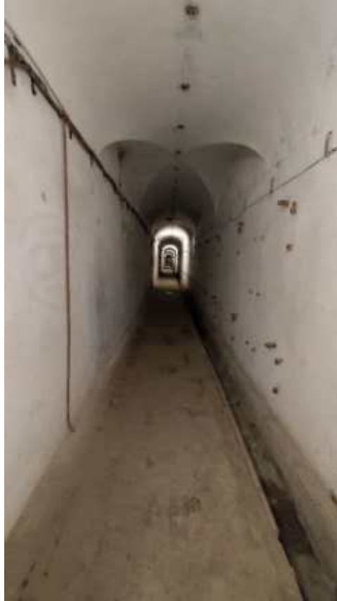
Фото 229. Коридор-потерна Главного калибра. Общий вид. Дата фотофиксации: 06.10.24
