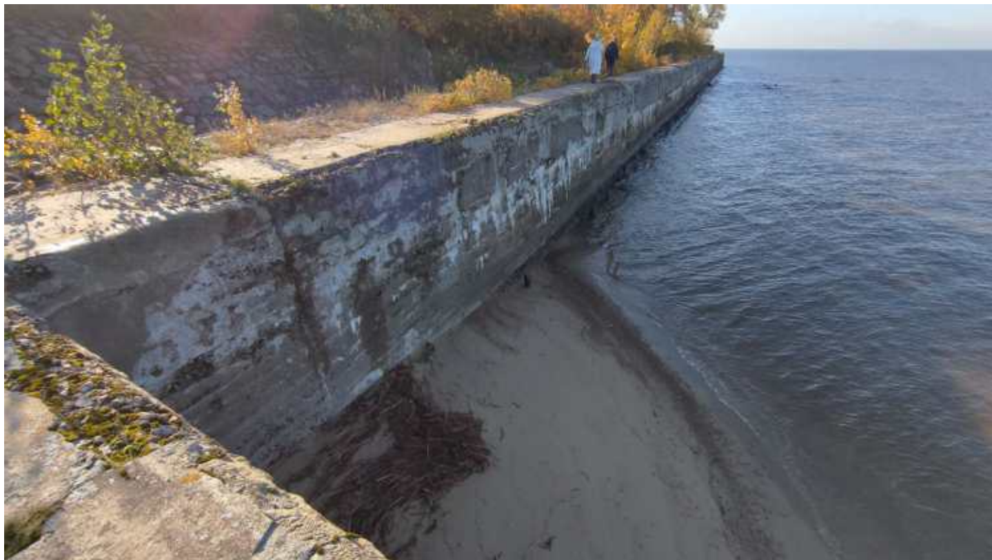
Фото 121. Бетонные конструкции форта. Правый фланг. Фрагмент. Дата фотофиксации: 10.10.24
