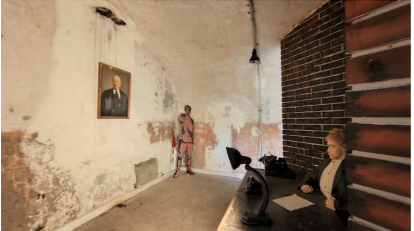
Фото 91. Помещение 10, 6-Н. Офицерские казармы. Фрагмент. Дата фотофиксации: 06.10.24
