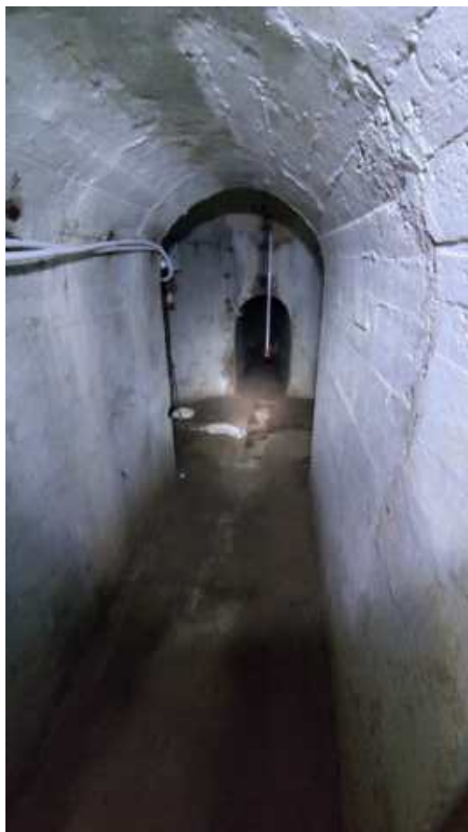
Фото 296. Коридор, соединяющий помещение медчасти и вспомогательные помещения. Фрагмент. Дата фотофиксации: 10.10.24
