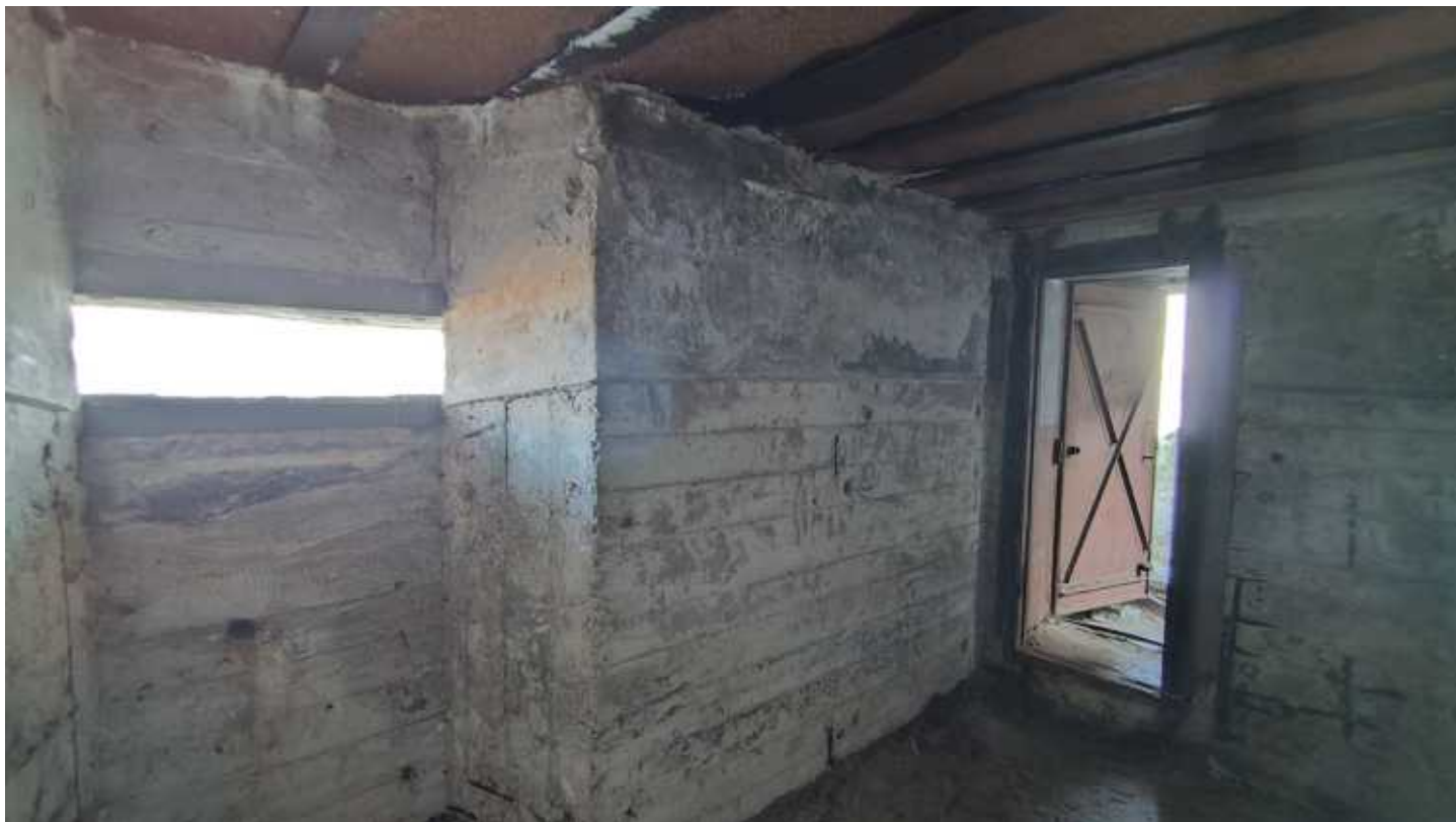
Фото 117. Укреплённые оружейные позиции правого фланга. Интерьер. Фрагмент. Дата фотофиксации: 06.10.24
