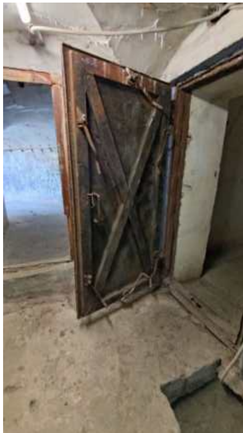
Фото 45. Прямоугольная металлическая дверь во входной галерее подземной части солдатских казарм. Общий вид. Дата фотофиксации: 10.10.24
