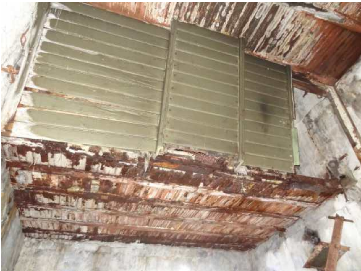
Фото 311. Металлические конструкции помещения 26 правого фланга. Фрагмент. Дата фотофиксации: 10.10.24
