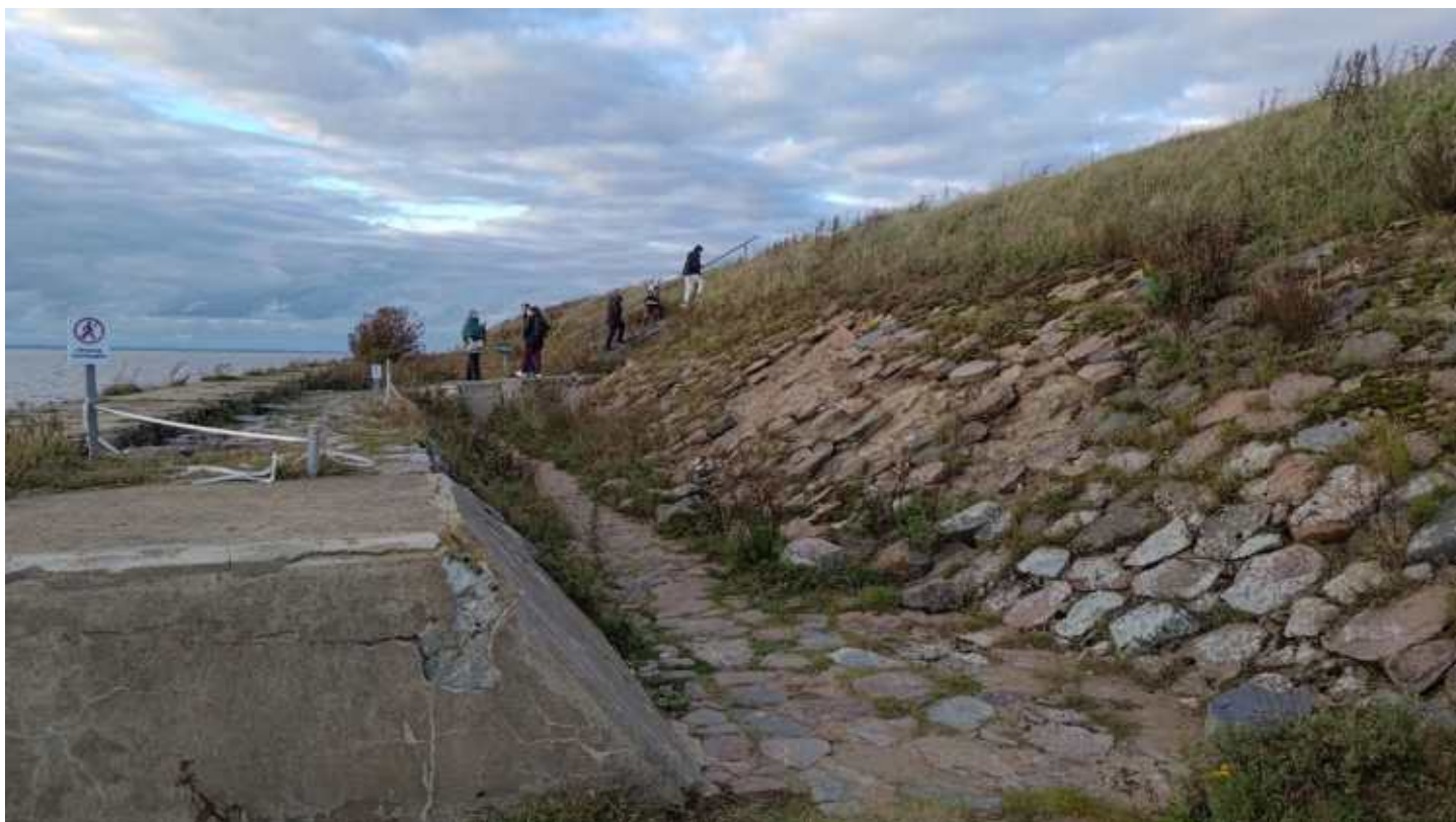
Фото 266. Конструкции основания форта – булыжная засыпка с бетонным ростверком в завершении и свайным основанием под подпорной стенкой. Фрагмент. Дата фотофиксации: 06.10.24
