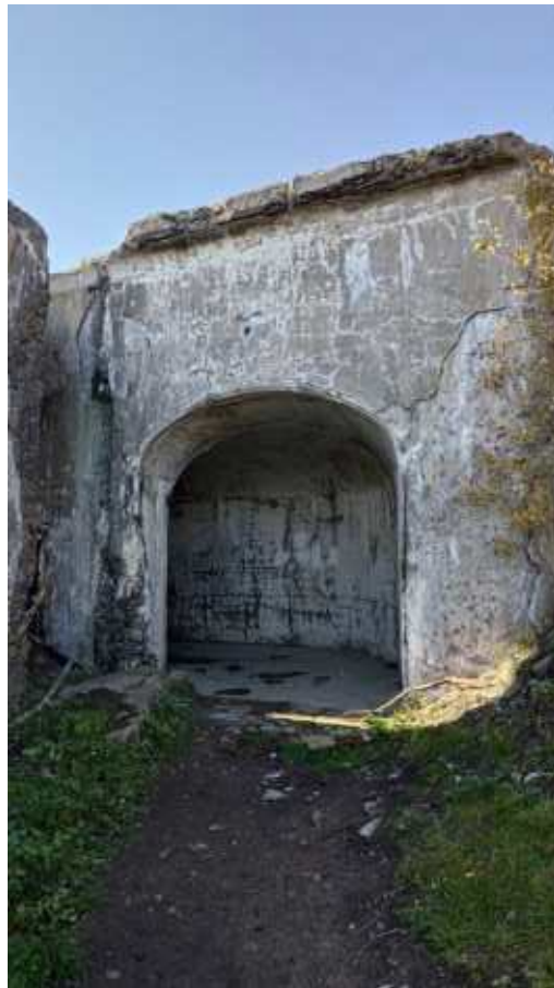
Фото 261. Портал входной галереи левого фланга. Общий вид. Дата фотофиксации: 06.10.24
