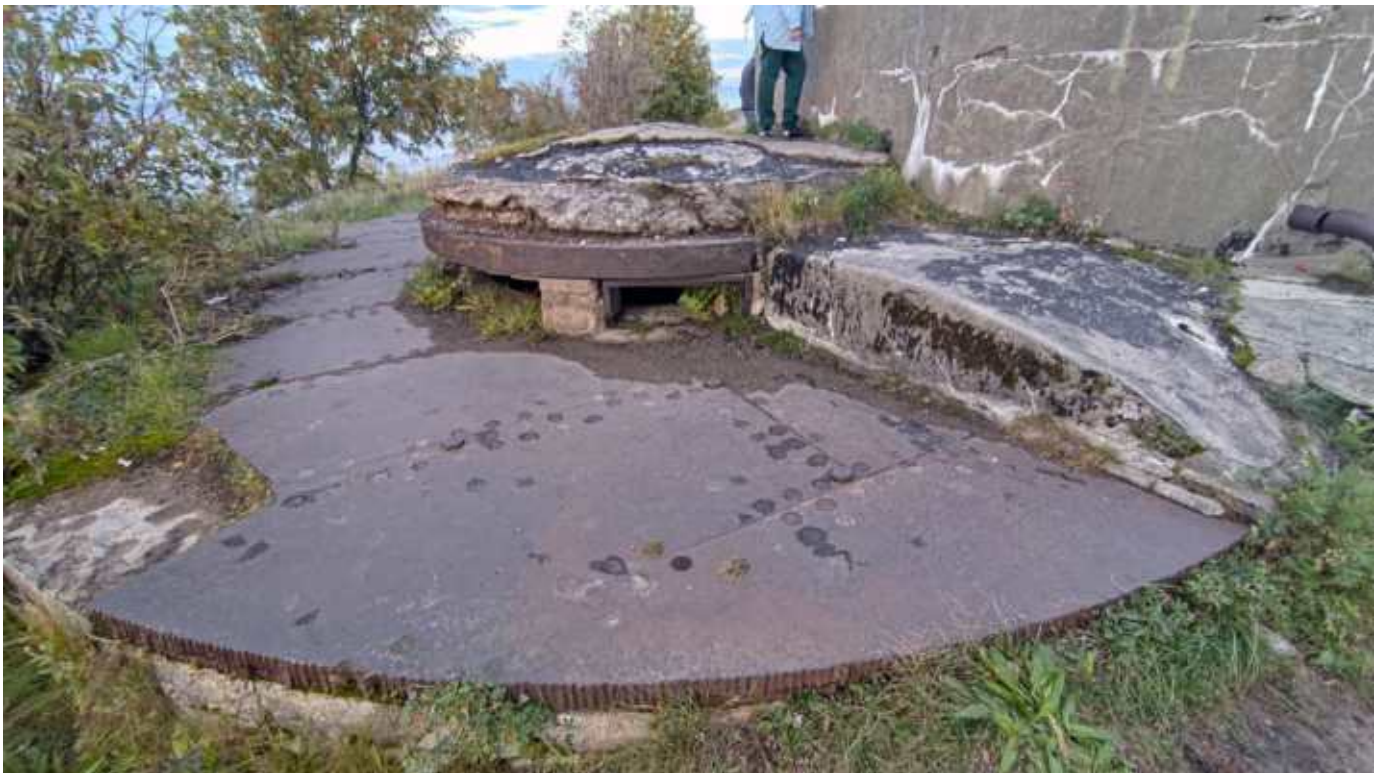
Фото 286. Дальномерный пост. Опытные постройки. Фрагмент. Дата фотофиксации: 06.10.24
