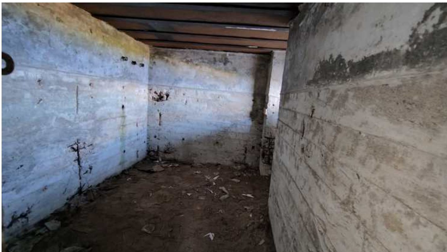
Фото 116. Укреплённые орудийные позиции правого фланга. Интерьер. Общий вид. Дата фотофиксации: 06.10.24
