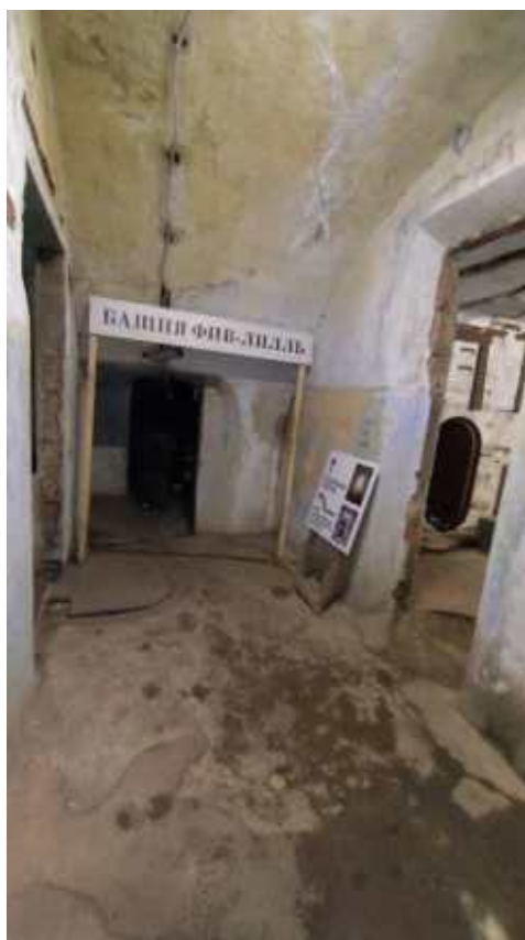
Фото 179. Помещение опытных сооружений. Общий вид. Дата фотофиксации: 06.10.24
