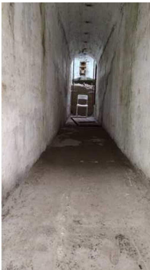
Фото 193. Коридор, соединяющий помещение скрывающейся броневой башни в центре тыловой части эскарпа и орудийные позиции. Общий вид. Дата фотофиксации: 06.10.24
