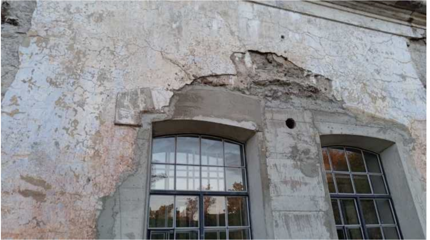
Фото 71. Оконные проёмы с нижними откосами и лучковым завершением. Фрагмент. Дата фотофиксации: 10.10.24
