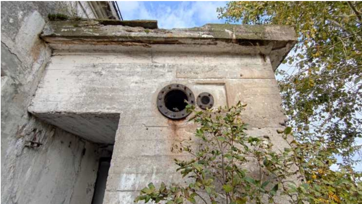
Фото 11. Технологические отверстия, восточный фасад солдатских казарм. Общий вид. Дата фотофиксации: 10.10.24
