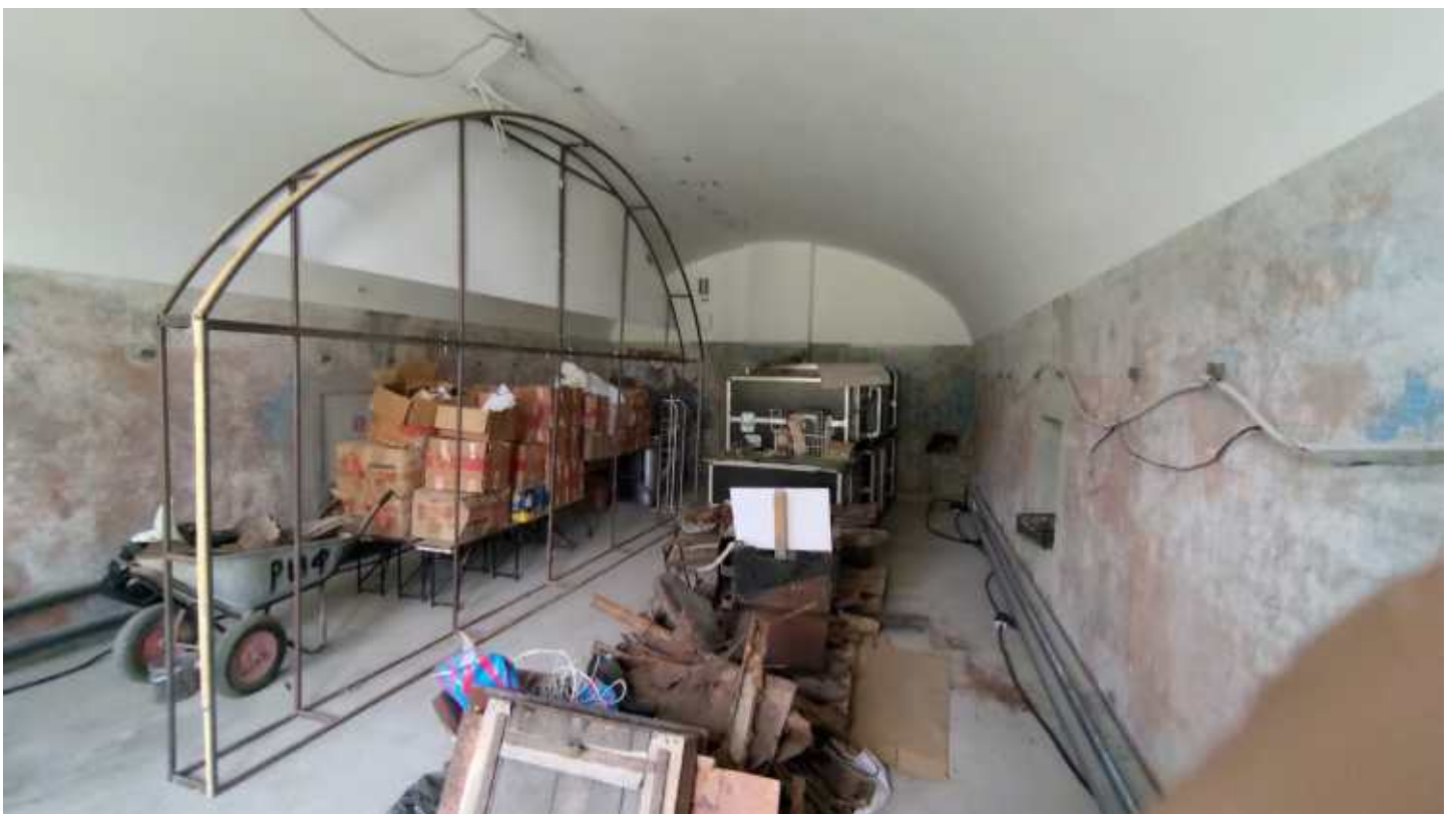
Фото 57. Помещение 1, 4-Н. Общий вид. Дата фотофиксации: 10.10.24
