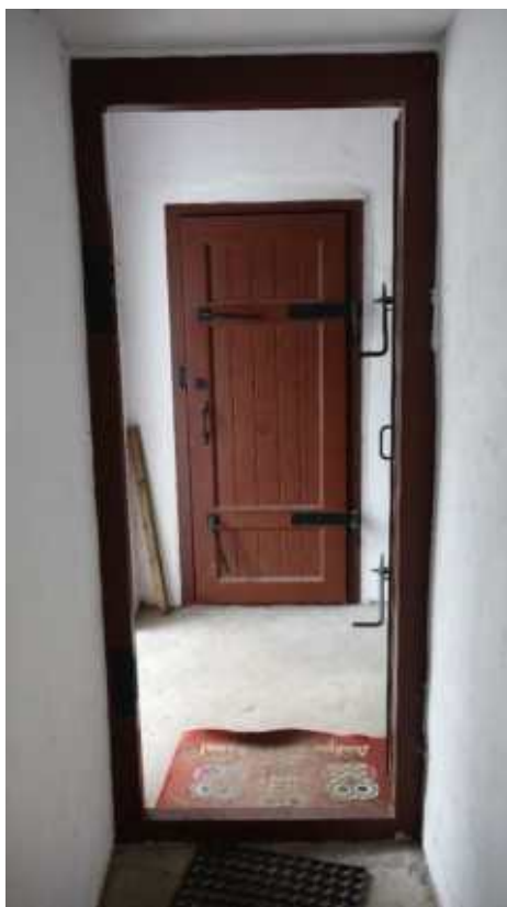
Фото 23. Портал между помещениями 1 и 3. Дата фотофиксации: 10.10.24
