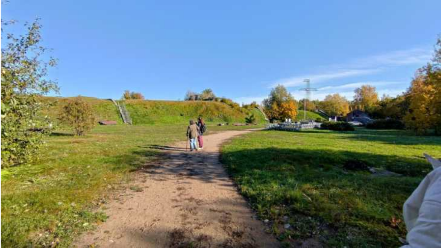
Фото 106. Опытные сооружения. Фрагмент. Дата фотофиксации: 10.10.24
