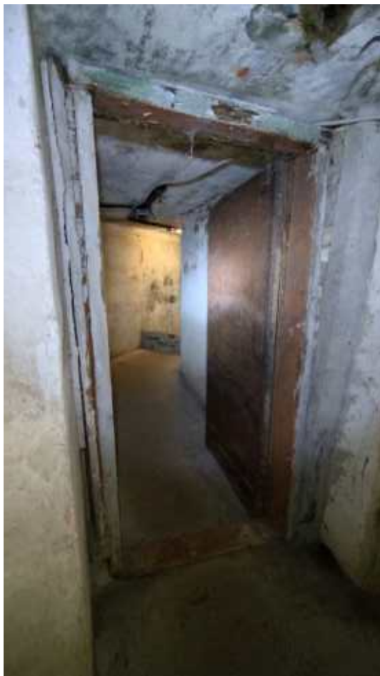
Фото 225. Металлическая прямоугольная дверь между помещениями оружейного дворика. Общий вид. Дата фотофиксации: 06.10.24
