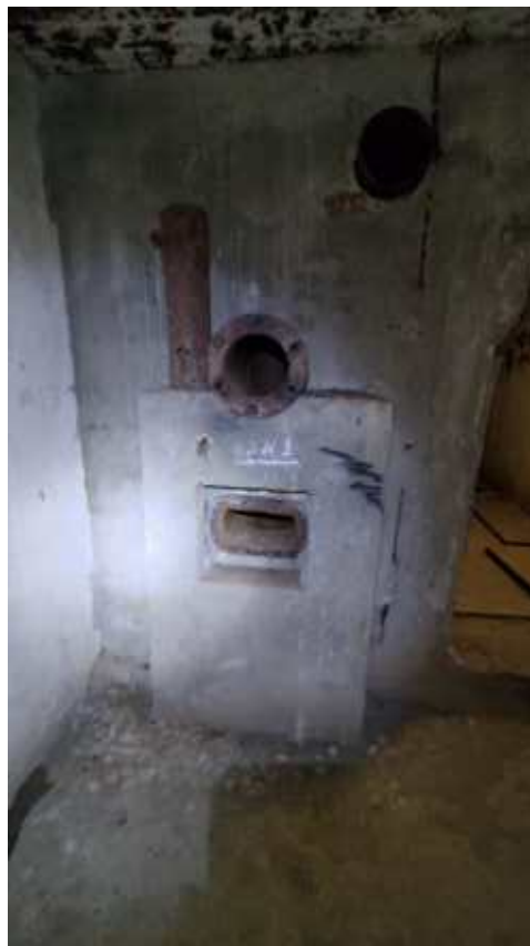
Фото 202. Технологические отверстия длинной галереи. Общий вид. Дата фотофиксации: 06.10.24
