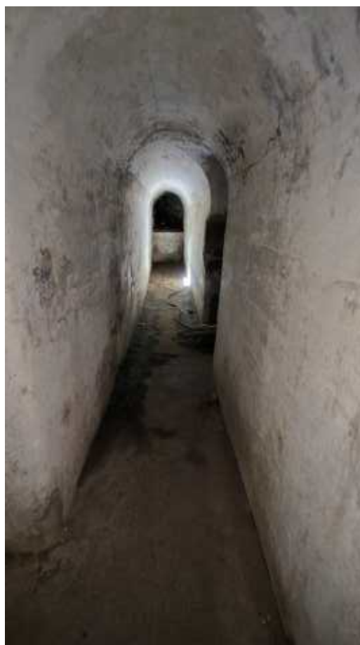
Фото 185. Коридор опытных построек. Общий вид. Дата фотофиксации: 06.10.24
