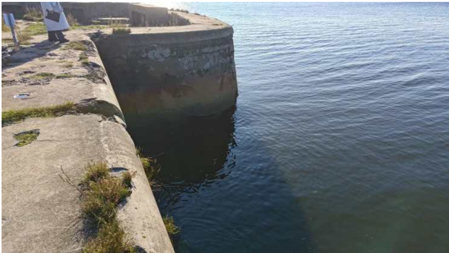
Фото 269. Бетонные конструкции форта. Левый фланг. Фрагмент. Дата фотофиксации: 10.10.24
