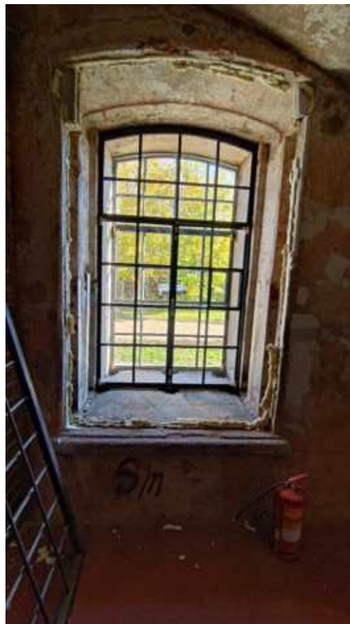
Фото 92. Оконное заполнение с лучковым завершением. Помещение 10, 6-Н. Общий вид. Дата фотофиксации: 06.10.24
