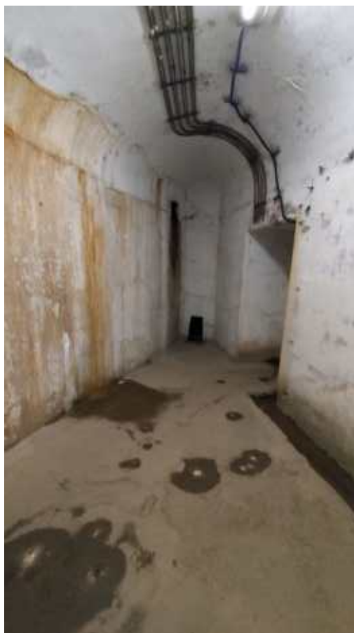
Фото 254. Входная галерея. Фрагмент. Дата фотофиксации: 06.10.24
