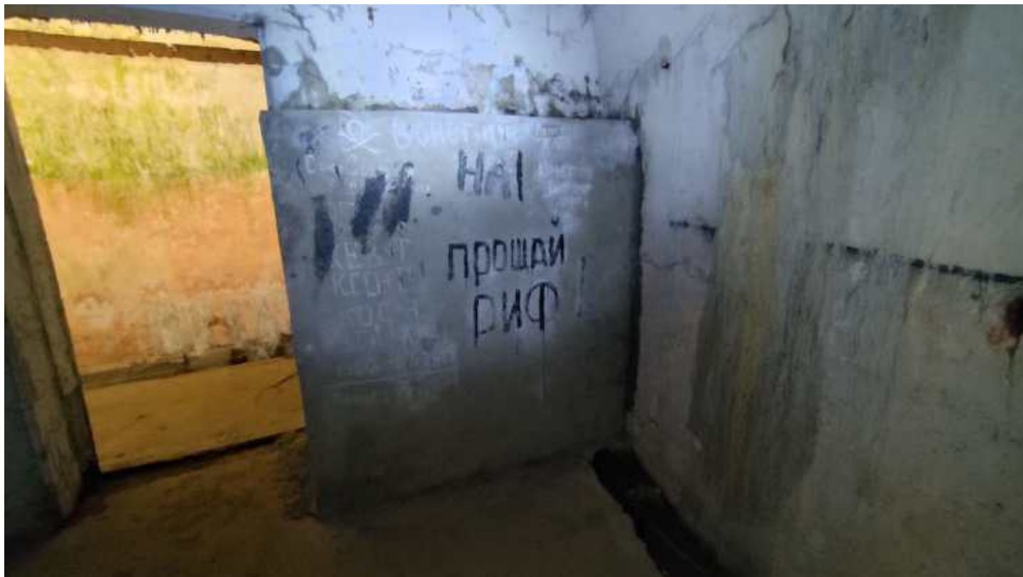
Фото 239. Помещение Главного калибра. Фрагмент. Дата фотофиксации: 06.10.24
