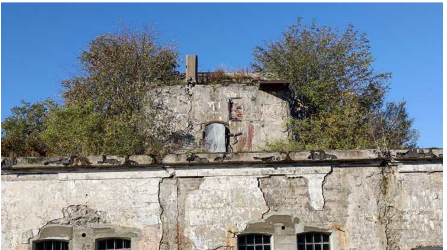
Фото 70. Крыша Офицерских казарм. Фрагмент. Дата фотофиксации: 10.10.24
