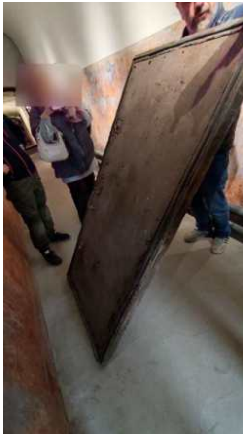
Фото 39. Историческая металлическая дверь. Местоположение – помещение 9. Общий вид. Дата фотофиксации: 10.10.24
