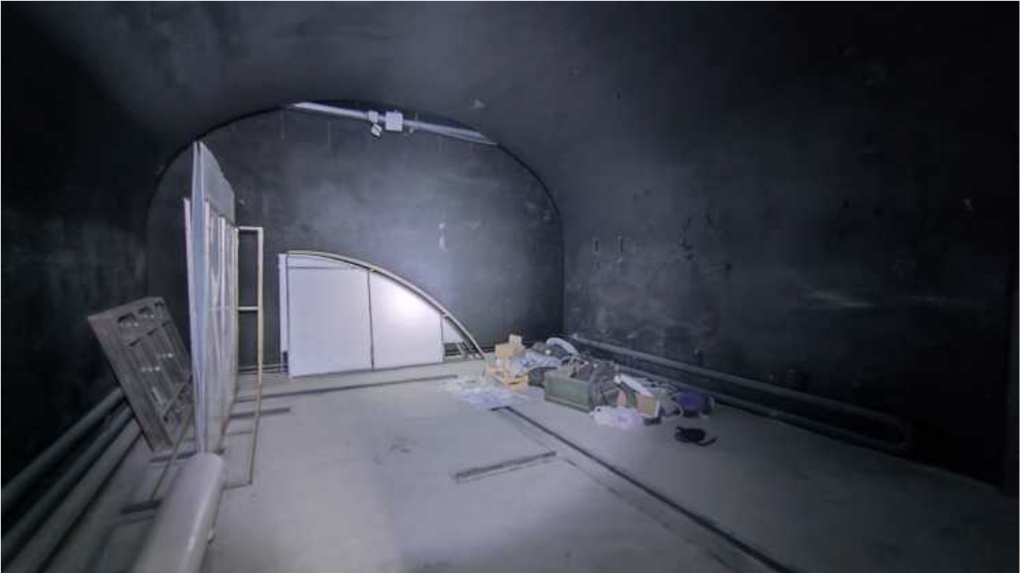
Фото 52. Помещение 6, 5-Н. Общий вид. Дата фотофиксации: 10.10.24
