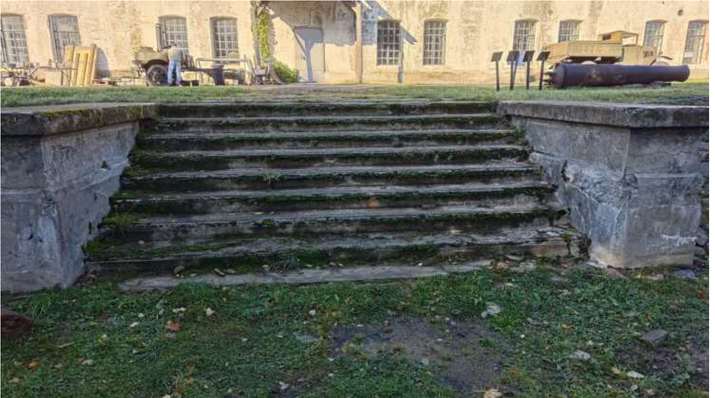
Фото 19. Историческая бетонная лестница. Общий вид. Дата фотофиксации: 10.10.24
