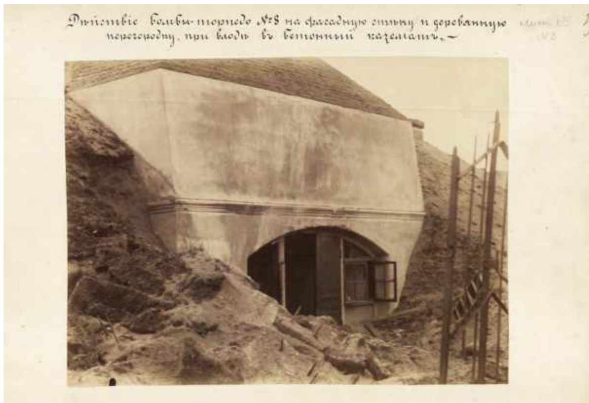
Илл. 12. Действие бомбы-торпеды №8 на фасадную стену и деревянную перегородку, при входе в бетонный каземат [А]. РГАВМФ. Ф. 1341. Оп. 3. Д. 588).
