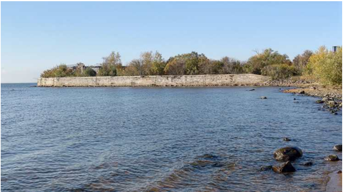
Фото 2. Береговая линия со стороны левого фланга. Бетонные конструкции форта. Фрагмент. Дата фотофиксации: 10.10.24
