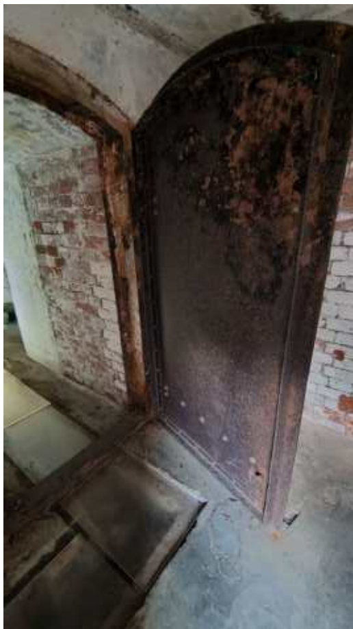
Фото 141. Историческая двустворчатая металлическая дверь с полуциркульным завершением. Фрагмент. Дата фотофиксации: 06.10.24
