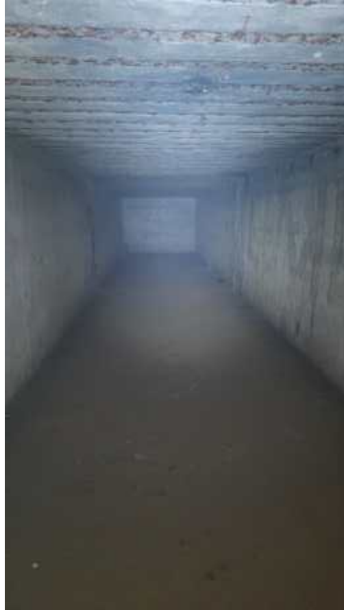
Фото 208. Укрытие опытных сооружений («Дымная» галерея). Общий вид. Дата фотофиксации: 06.10.24
