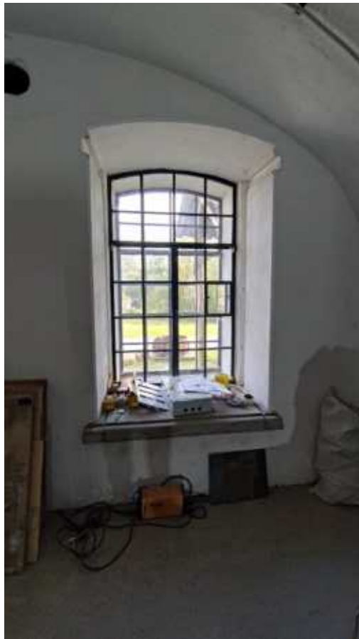
Фото 54. Оконное заполнение в помещении 4, 5-Н. Общий вид. Дата фотофиксации: 10.10.24
