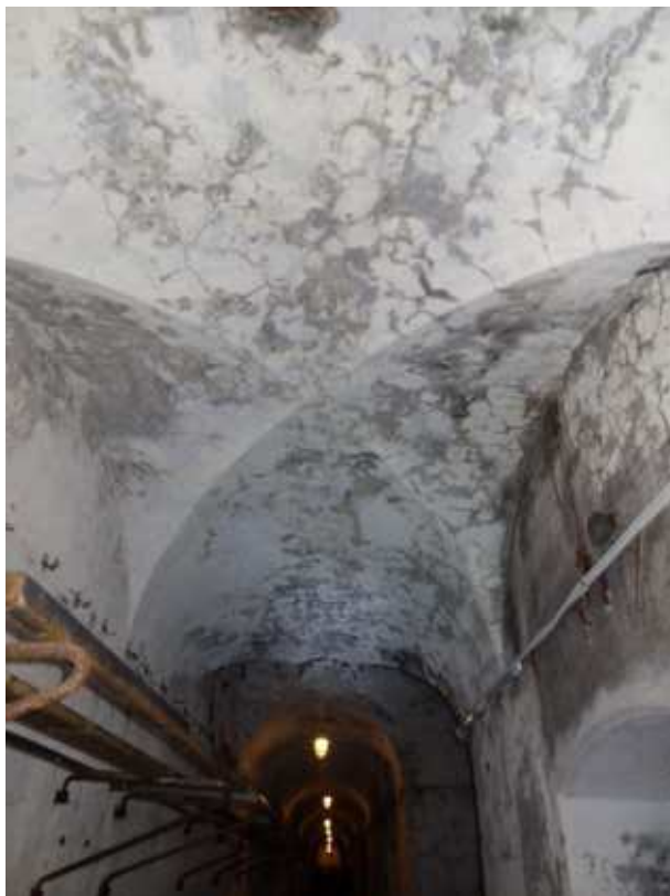
Фото 164. Коробовые с распалубками своды галереи правого фланга. Общий вид. Дата фотофиксации: 06.10.24
