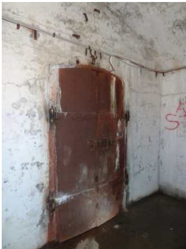
Фото 170. Двустворчатая металлическая дверь с лучковым завершением. Галереи правого фланга. Общий вид. Дата фотофиксации: 06.10.24
