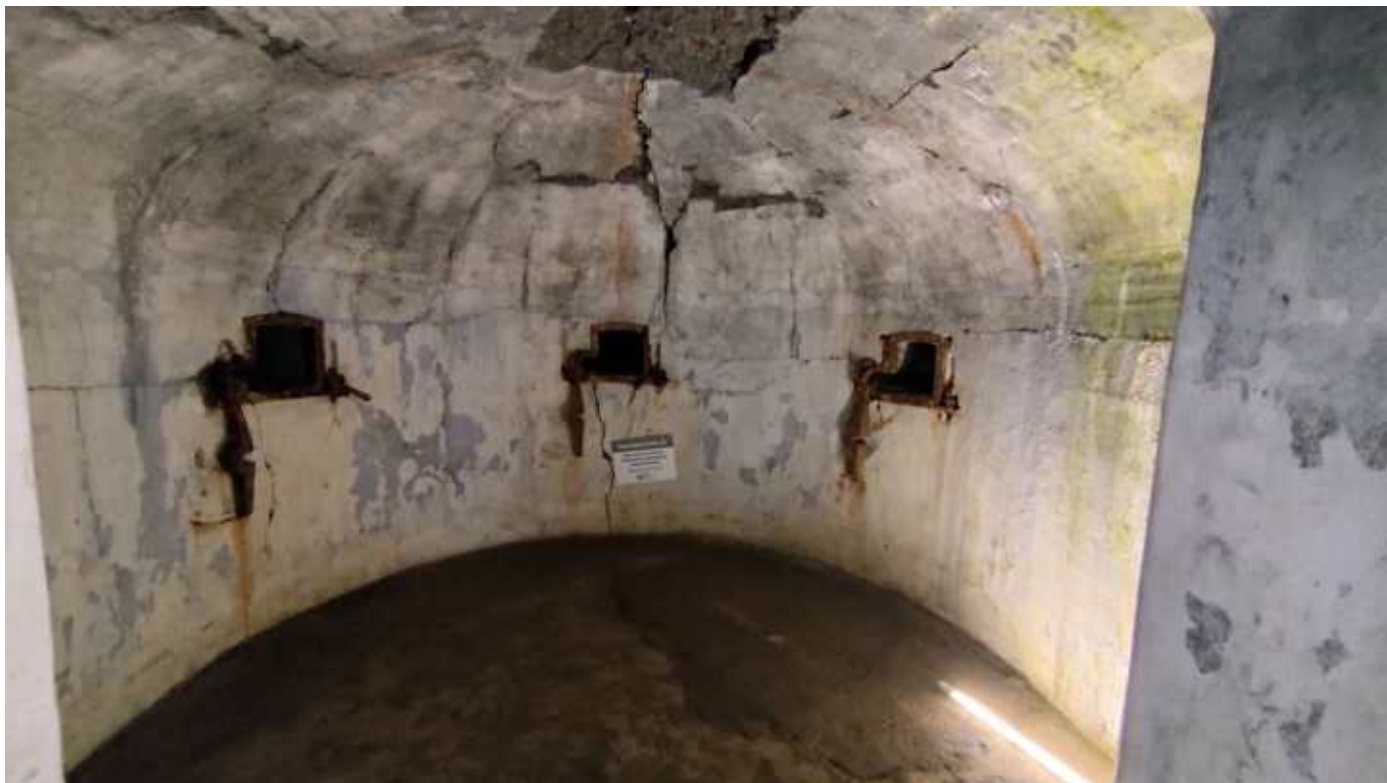
Фото 178. Капонир опытных сооружений. Общий вид. Дата фотофиксации: 06.10.24
