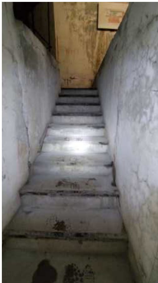
Фото 220. Бетонная лестница, соединяющая помещение с элеваторами для подачи боеприпасов (орудийный дворик) и вспомогательное помещение. Общий вид. Дата фотофиксации: 06.10.24
