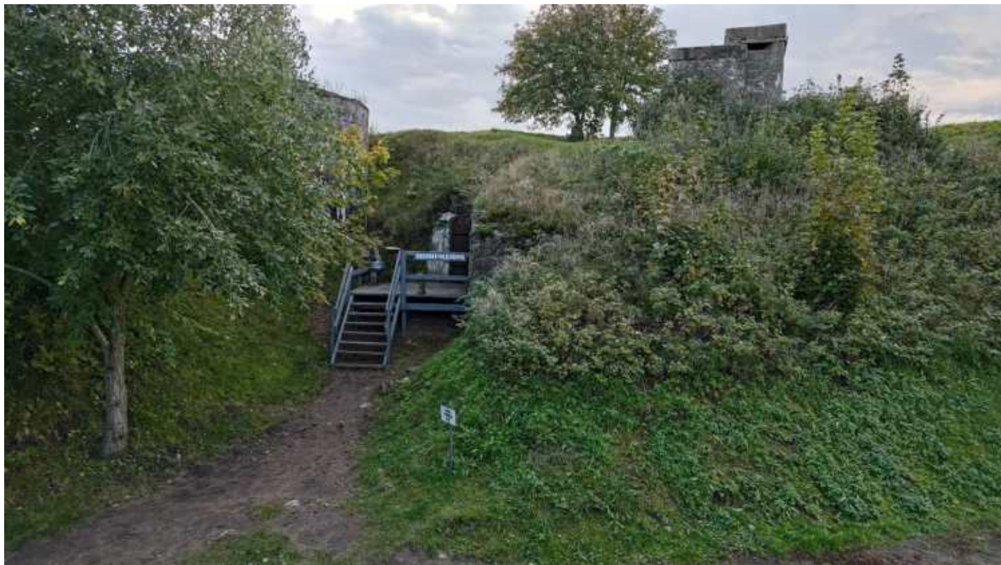
Фото 288. Вход в опытные постройки. Общий вид. Дата фотофиксации: 06.10.24
