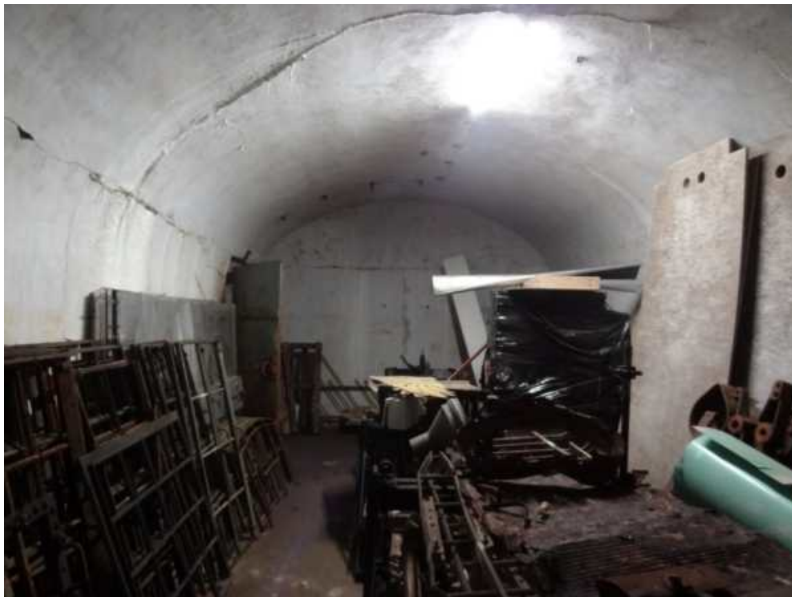
Фото 305. Пороховое хранилище в северной части правого фланга (помещение 22). Фрагмент. Дата фотофиксации: 10.10.24
