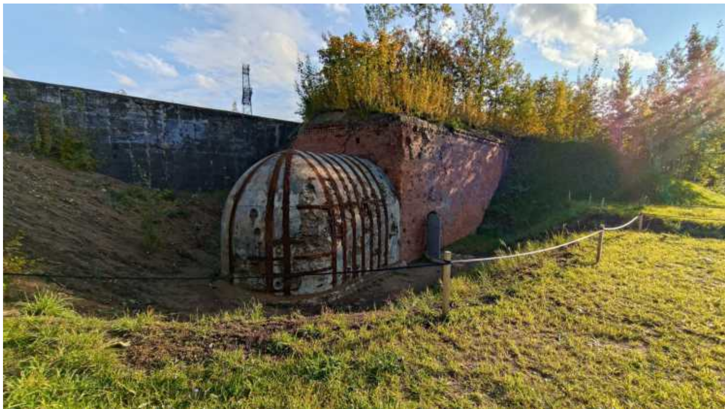
Фото 135. Капонир. Общий вид со стороны северного фасада. Дата фотофиксации: 06.10.24
