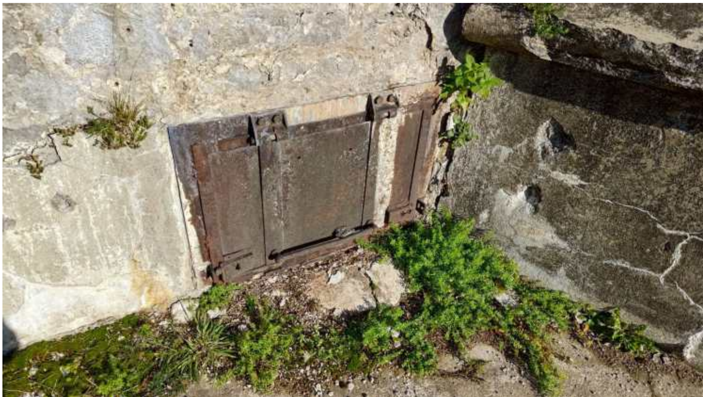
Фото 146. Металлические ставни элеваторов подачи боеприпасов. Общий вид. Дата фотофиксации: 10.10.24
