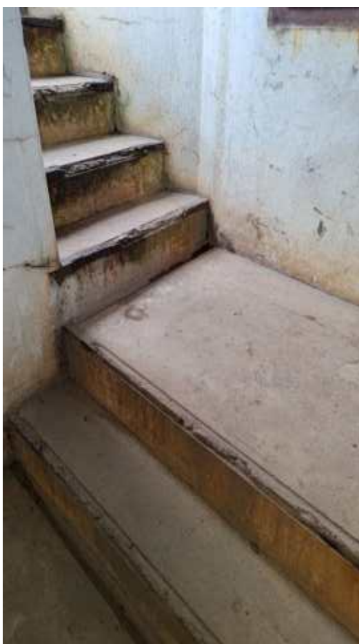
Фото 151. Двойная бетонная лестница опытных построек. Фрагмент. Дата фотофиксации: 06.10.24
