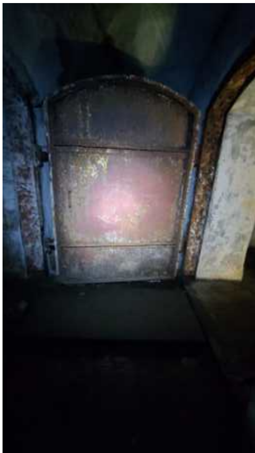
Фото 176. Одностворчатая металлическая дверь с лучковым завершением. Общий вид. Дата фотофиксации: 06.10.24
