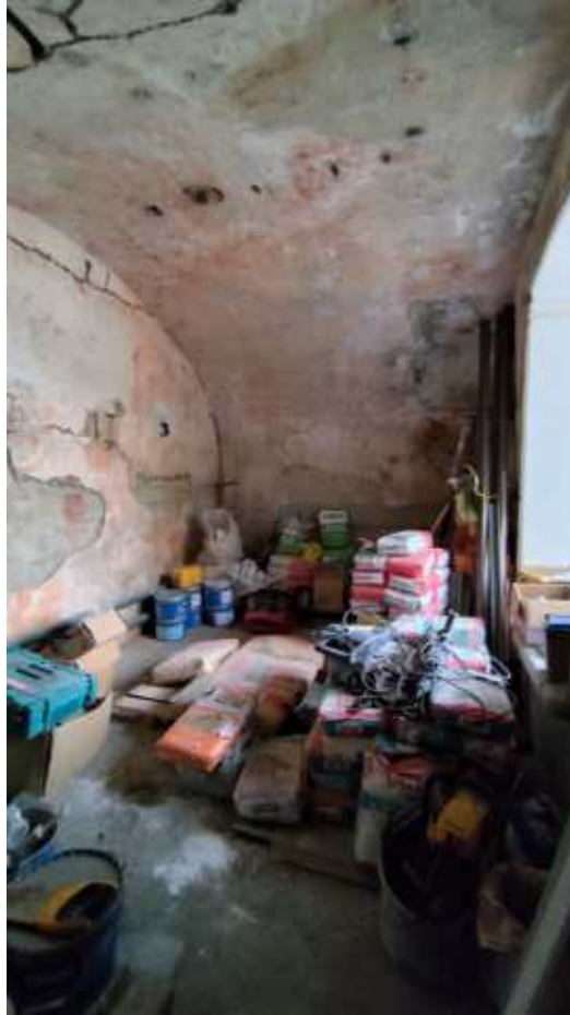
Фото 48. Помещение 7, 5-Н. Общий вид. Дата фотофиксации: 10.10.24
