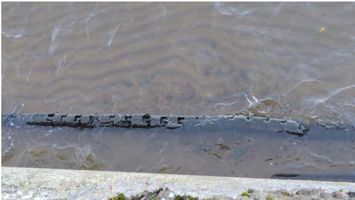
Фото 123. Бетонные конструкции форта. Правый фланг. Фрагмент. Дата фотофиксации: 10.10.24
