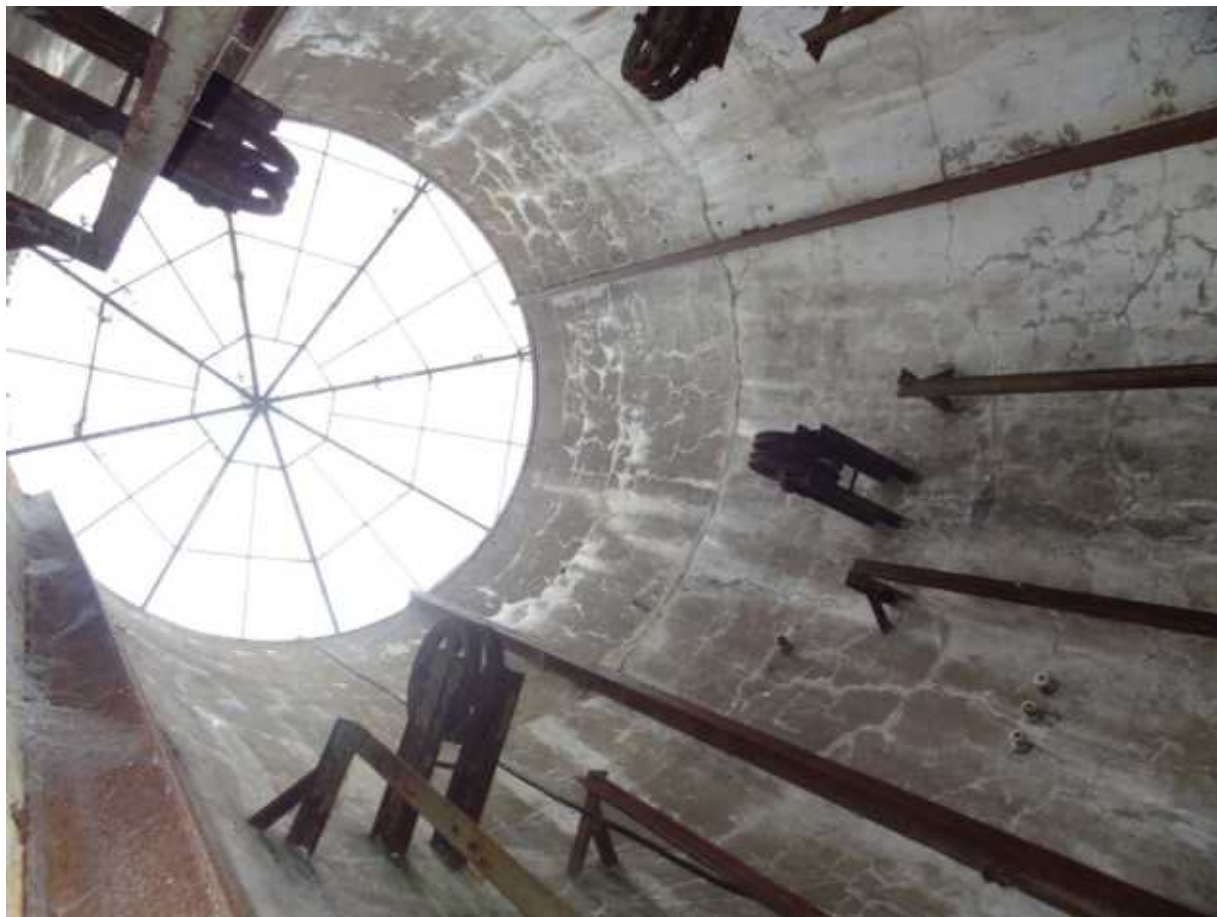
Фото 323. Конструкции прожекторной шахты, помещение 19 правого фланга. Фрагмент. Дата фотофиксации: 10.10.24
