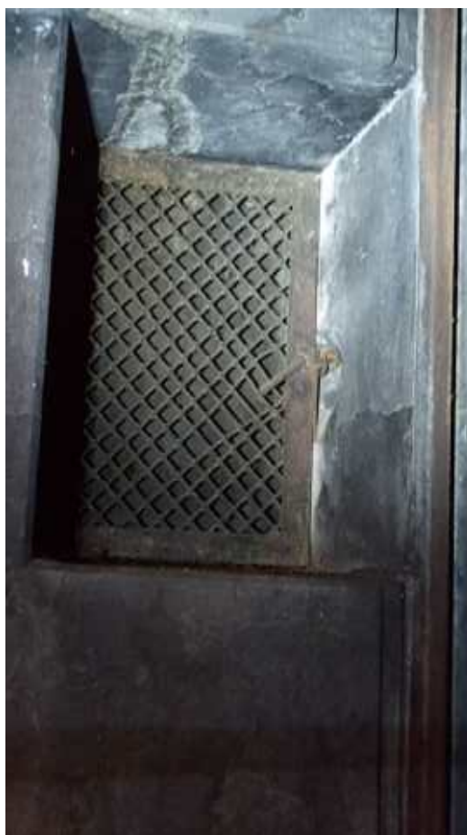
Фото 155. Историческая вентиляционная решетка между помещениями траверсов. Общий вид. Дата фотофиксации: 06.10.24
