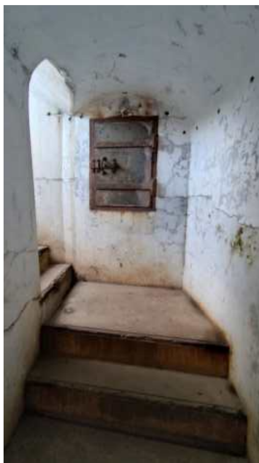
Фото 153. Двойная бетонная лестница опытных построек. Фрагмент. Дата фотофиксации: 06.10.24
