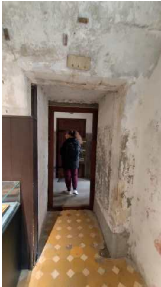
Фото 37. Портал между помещениями 8 и 9. Общий вид. Дата фотофиксации: 10.10.24
