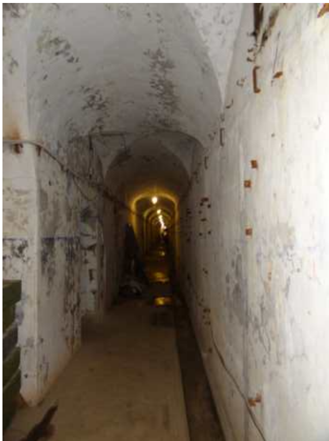
Фото 163. Галереи правого фланга. Общий вид. Дата фотофиксации: 06.10.24
