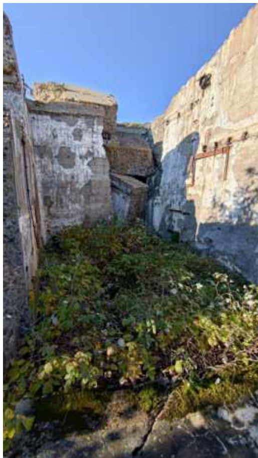
Фото 279. Бетонные конструкции левого фланга. Башня. Фрагмент. Дата фотофиксации: 10.10.24
