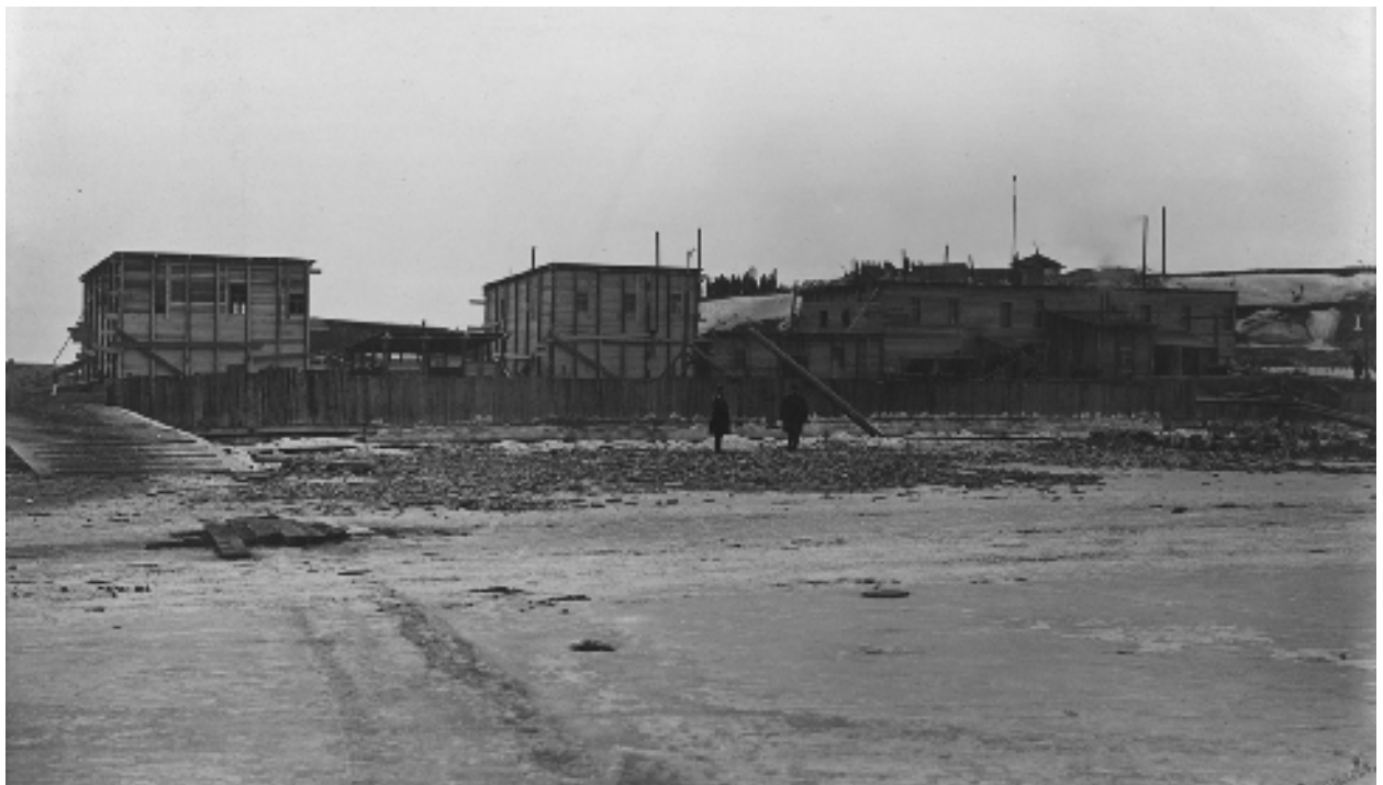
Илл. 98. Рифские батареи. Теплушки над основаниями правофланговой 4-х орудийной батарее. Фото марта 1910 г. (РГАВМФ. Ф. 418. Оп. 1. Д. 6090)
