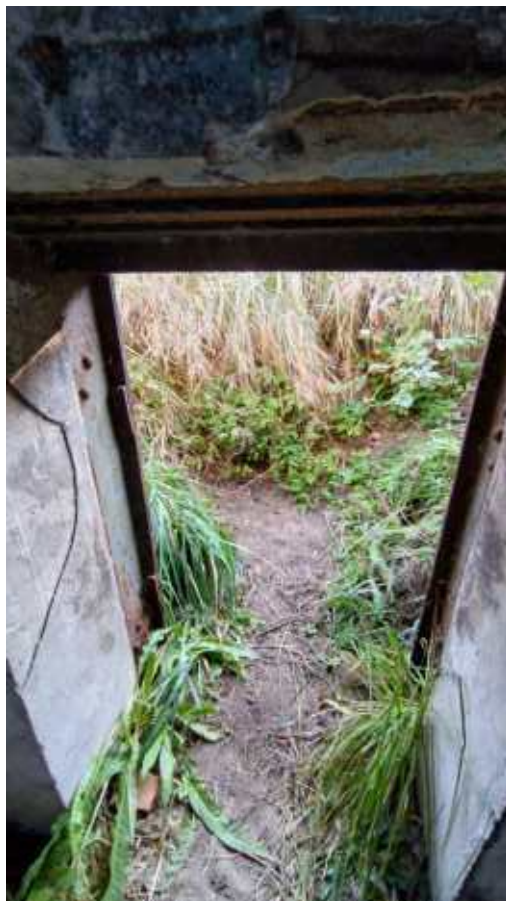
Фото 127. Портал противодесантного дота. Общий вид. Дата фотофиксации: 10.10.24
