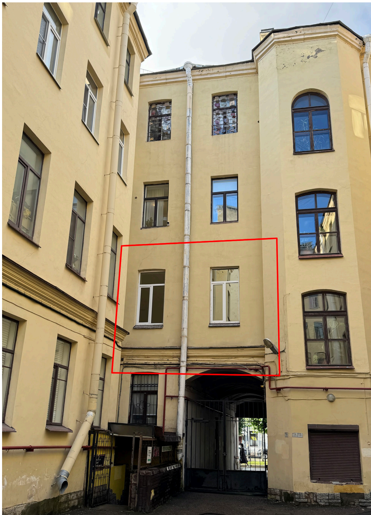
3. Дворовый фасад дома № 25 по Фурштатской ул. Красной рамкой показана часть фасада, относящаяся к квартире № 2. Дата съемки: 29.08.2025.
