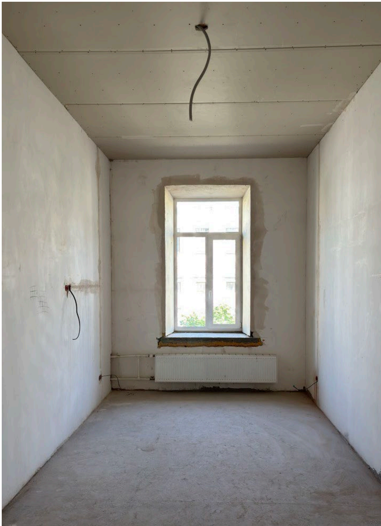
24. Помещение 8. Дата съемки: 29.08.2025
