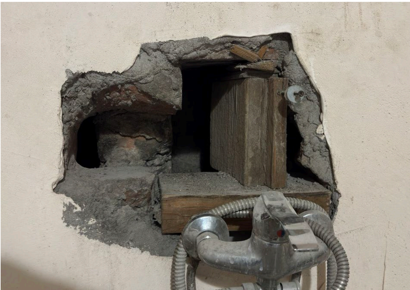
12. Помещение 5. Дата съемки: 29.08.2025
