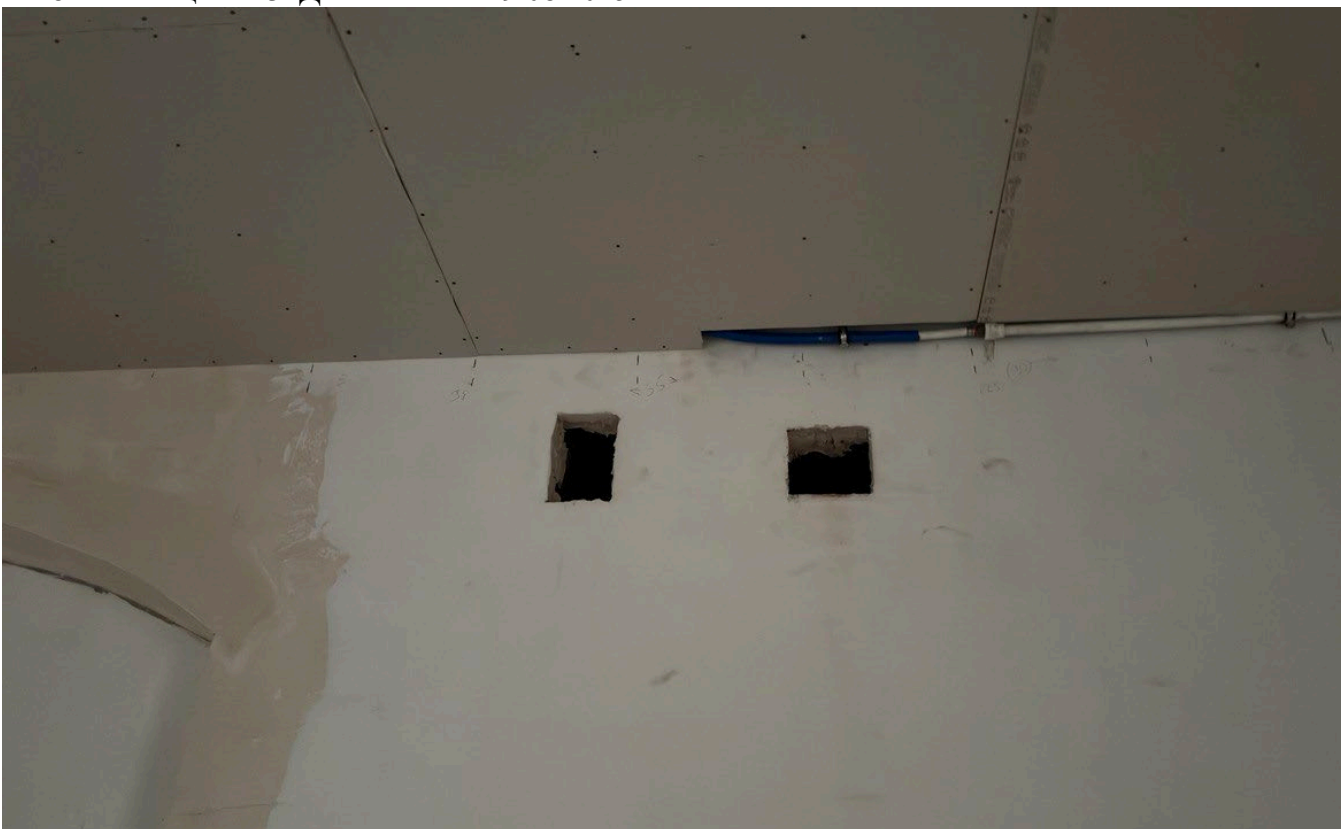
9. Помещение 3. Дата съемки: 29.08.2025
