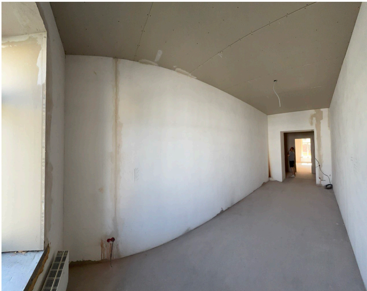
23. Помещение 8. Дата съемки: 29.08.2025.
