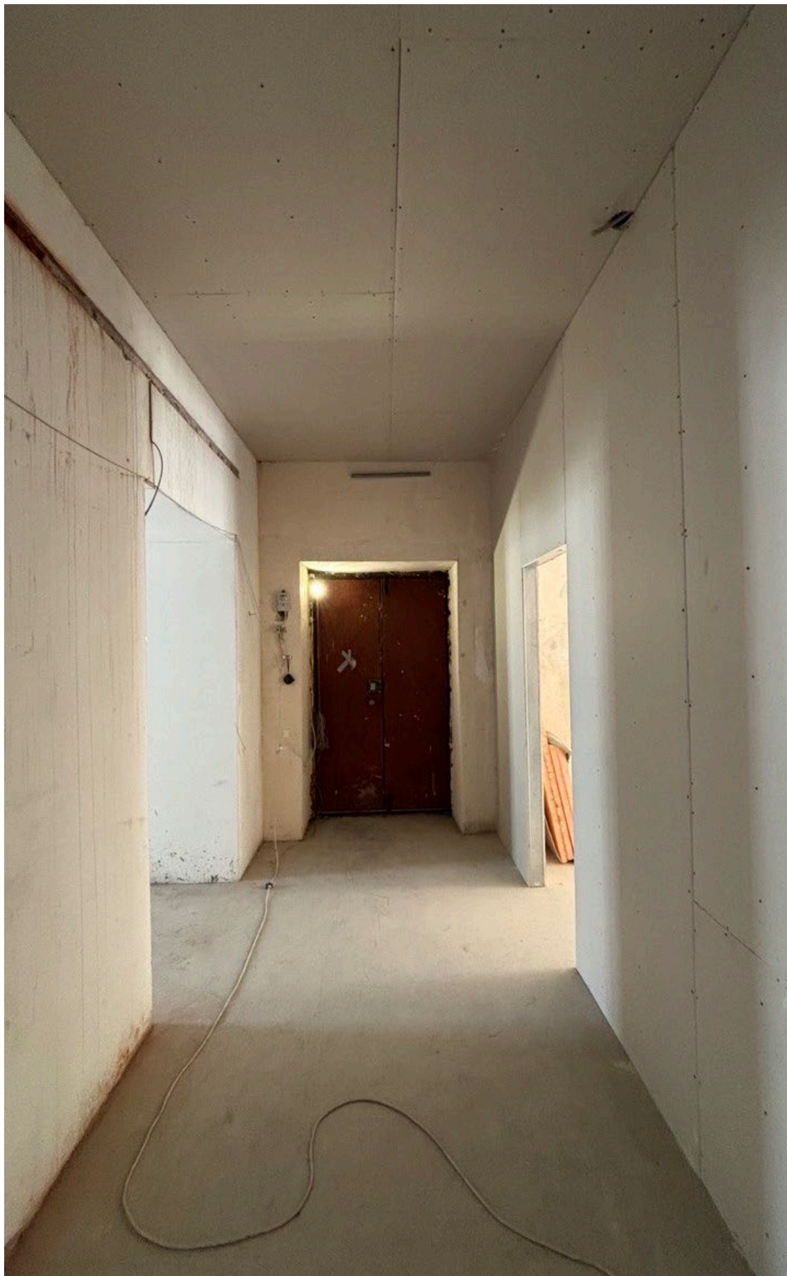
3. Помещение 4. Дата съемки: 29.08.2025.
