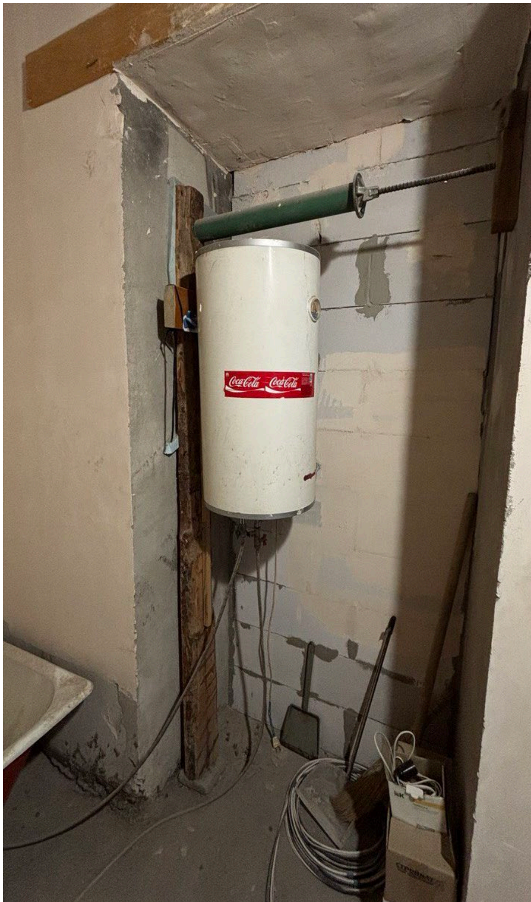
10. Помещение 5. Дата съемки: 29.08.2025.
