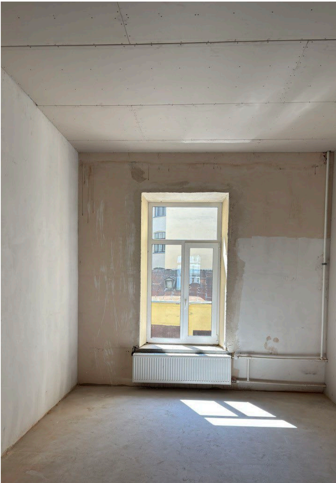
5. Помещение 1. Дата съемки: 29.08.2025
