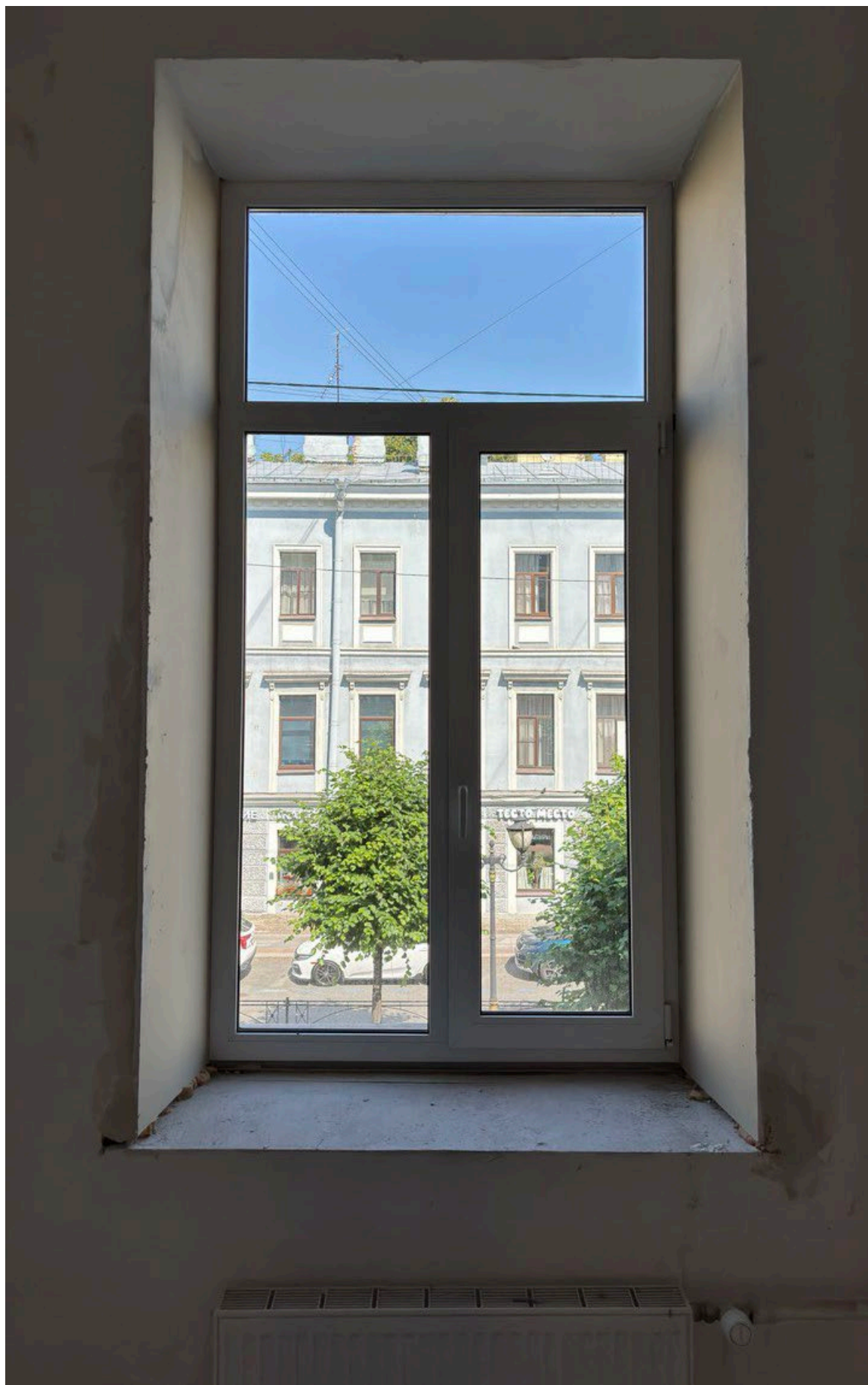
22. Помещение 7. Дата съемки: 29.08.2025.
