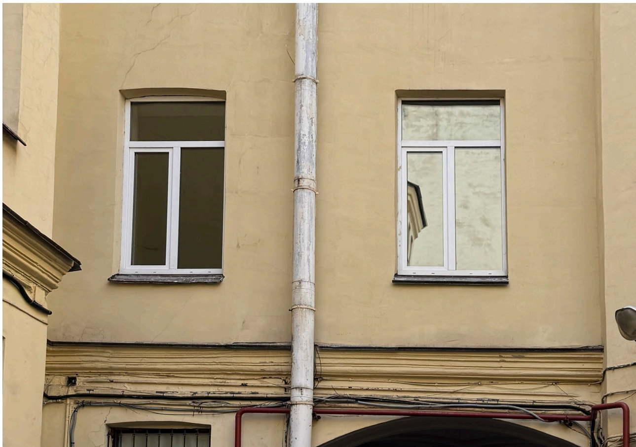
4. Окна квартиры № 2, выходящие во двор. Дата съемки: 29.08.2025.
