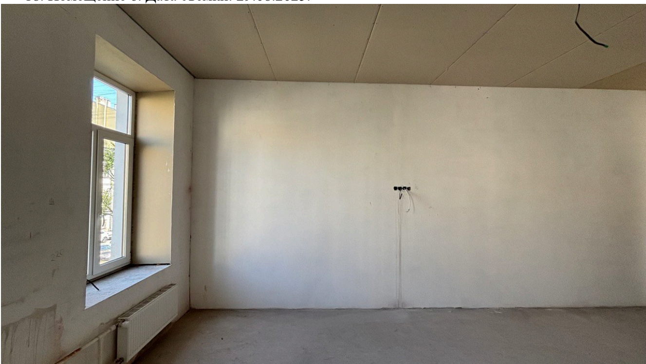
19. Помещение 6. Дата съемки: 29.08.2025.
