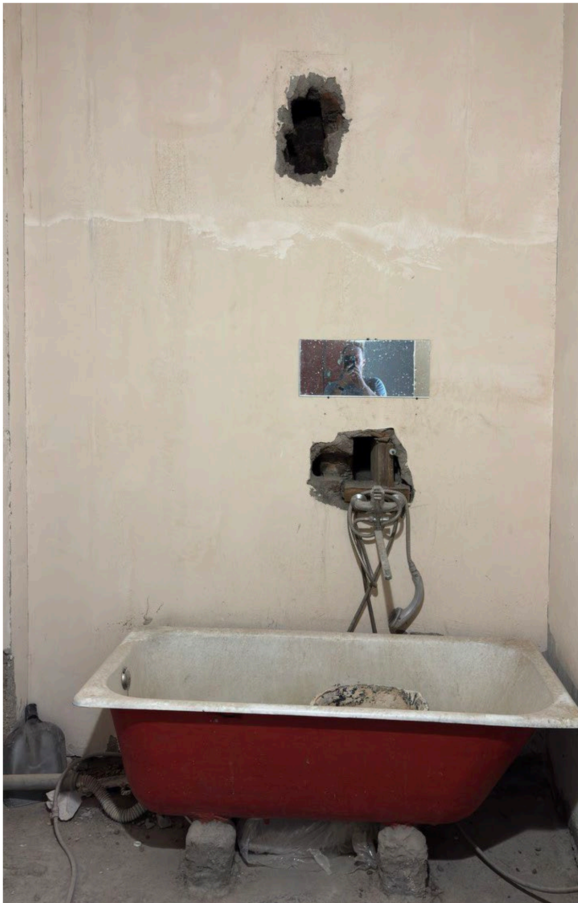
11. Помещение 5. Дата съемки: 29.08.2025.
