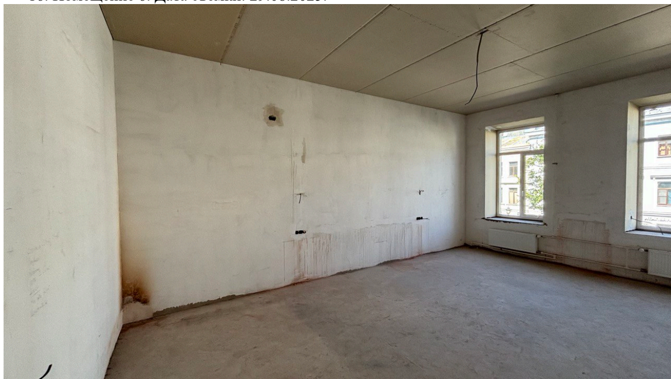
17. Помещение 6. Дата съемки: 29.08.2025.
