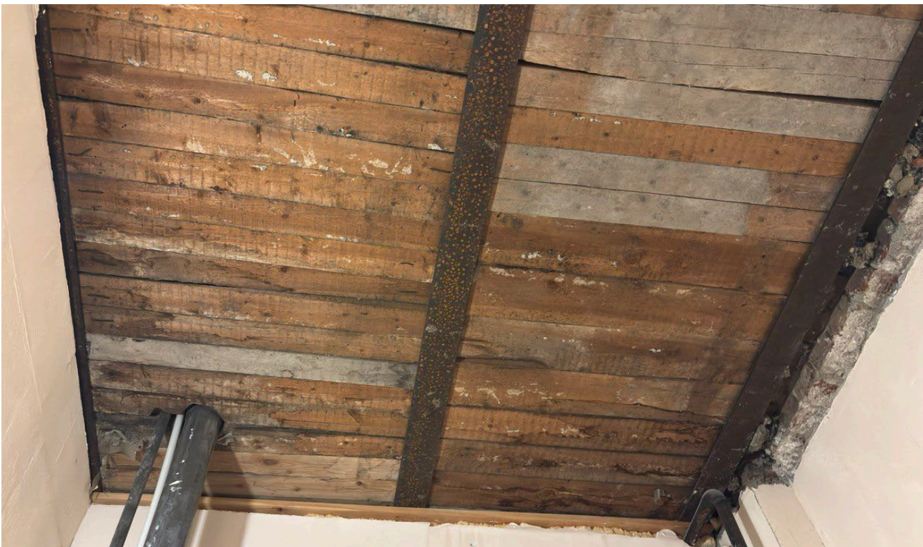
14. Помещение 5. Дата съемки: 29.08.2025.
