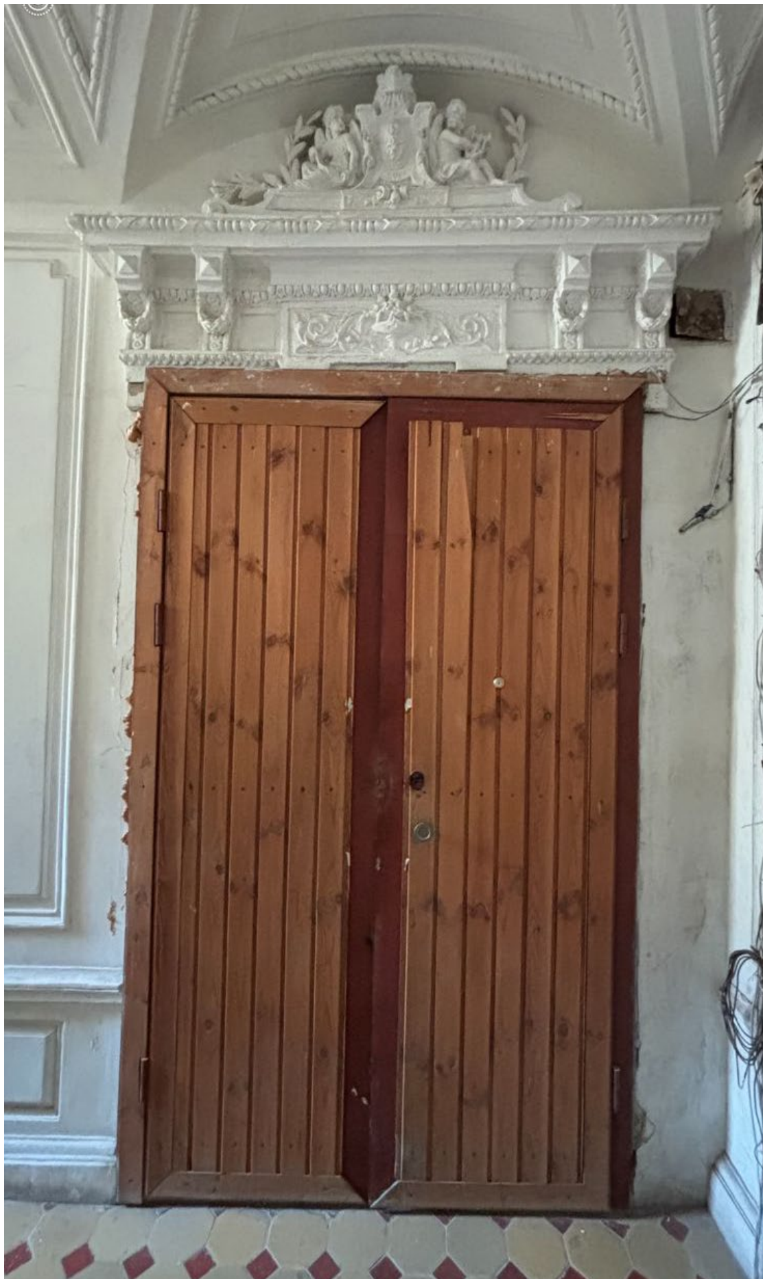
1. Вход в квартиру № 2, вид с лестничной клетки. Дата съемки: 29.08.2025.
