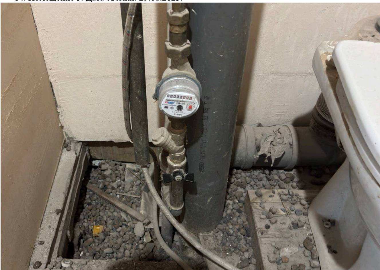
15. Помещение 5. Дата съемки: 29.08.2025.
