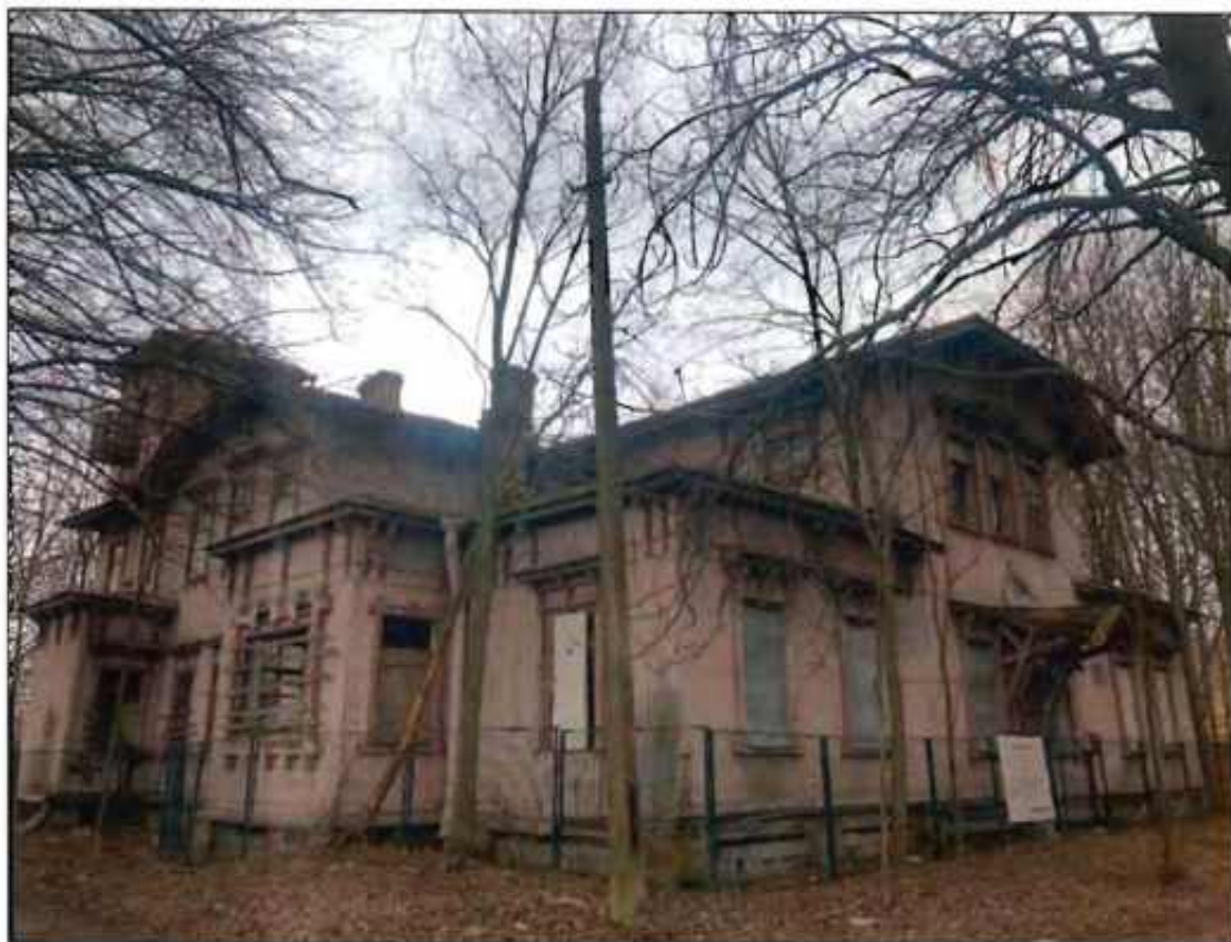
2. Общий вид с юго-запада.
