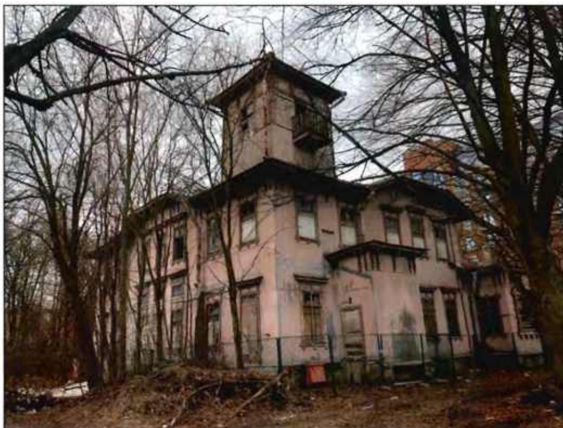
3. Общий вид с северо-запада.
