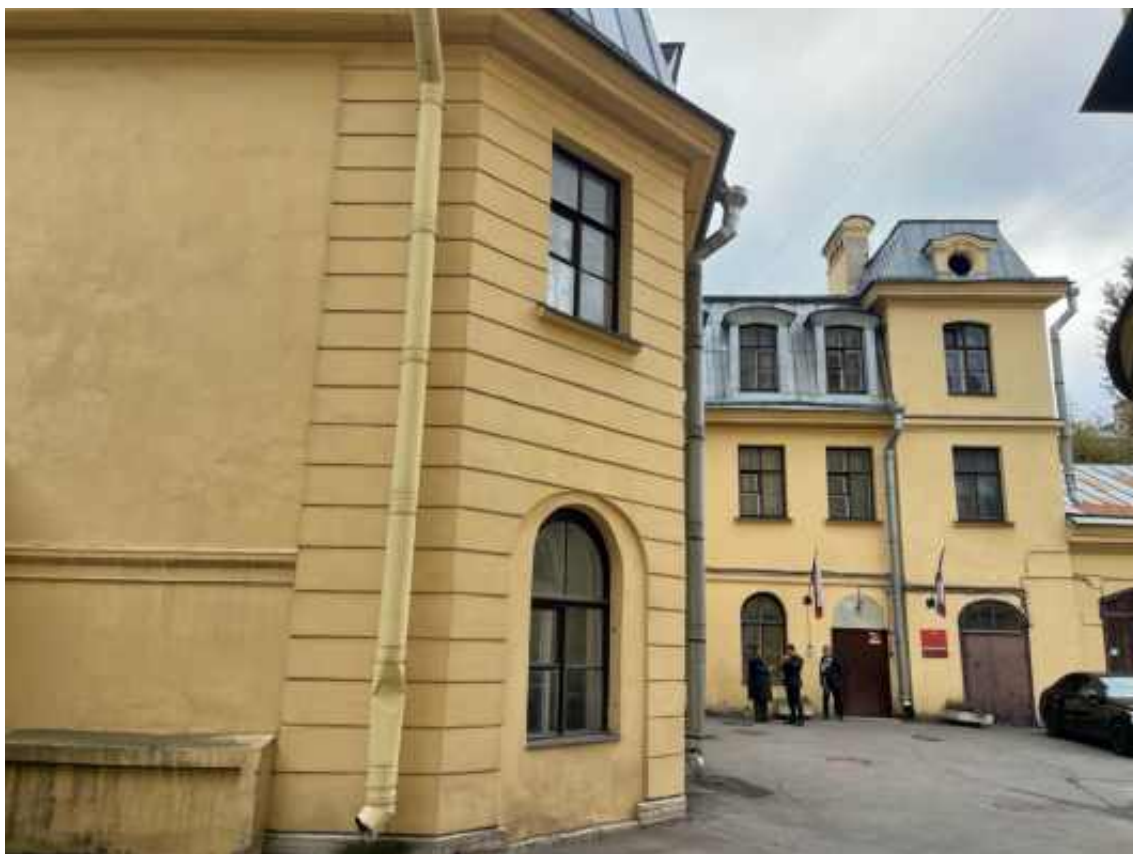
4. Вид на западные фасады со стороны двора
