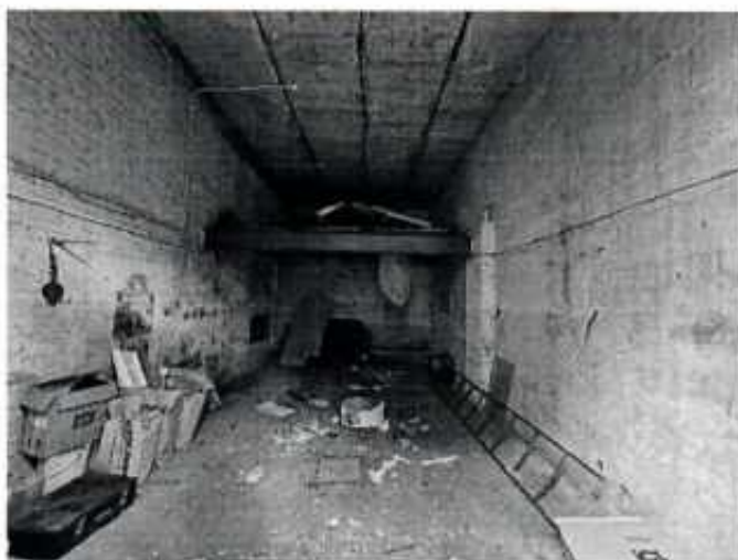
Фрагмент интерьера (пом. 1-го эт)
