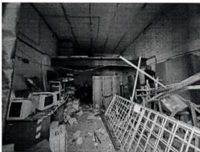
Фрагмент интерьера (пом. 1-го эт)
