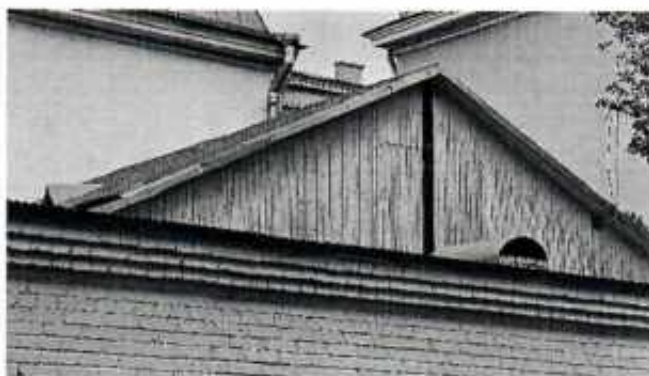
4. Фрагмент крыши здания (с южной стороны)
