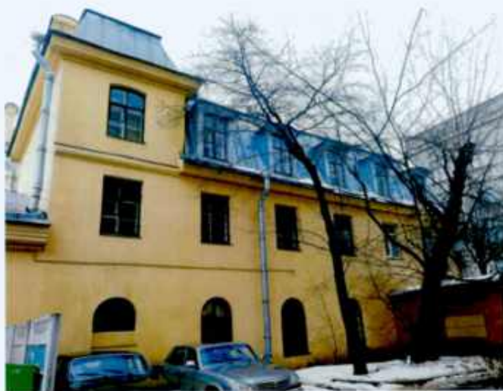
2. Общий вид. Восточный фасад объекта культурного наследия.
