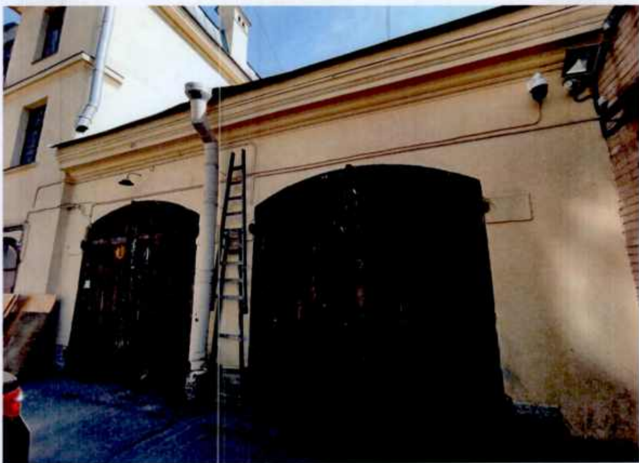
2. Вид на западный фасад объекта культурного наследия.
