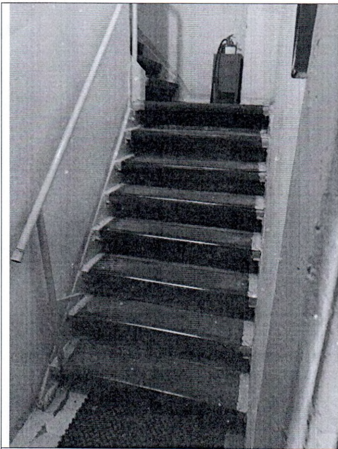
19. Интерьер. Пом. 1-Н(1). Лестница.
