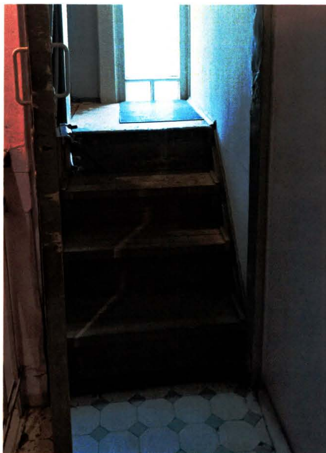
8. Интерьер объекта культурного наследия. Помещение № 1-Н.
