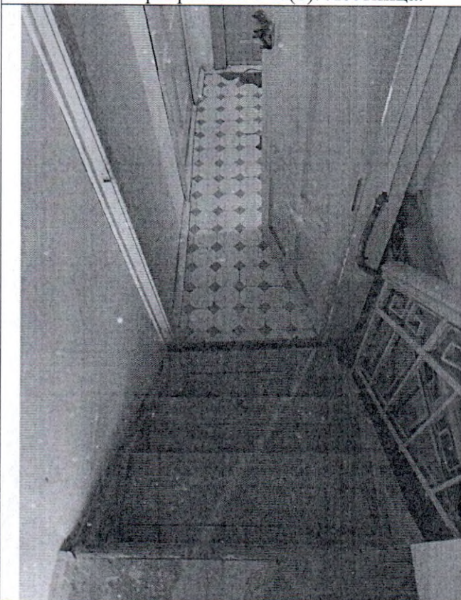
21. Интерьер. Пом. 1-Н(12). Лестница.
