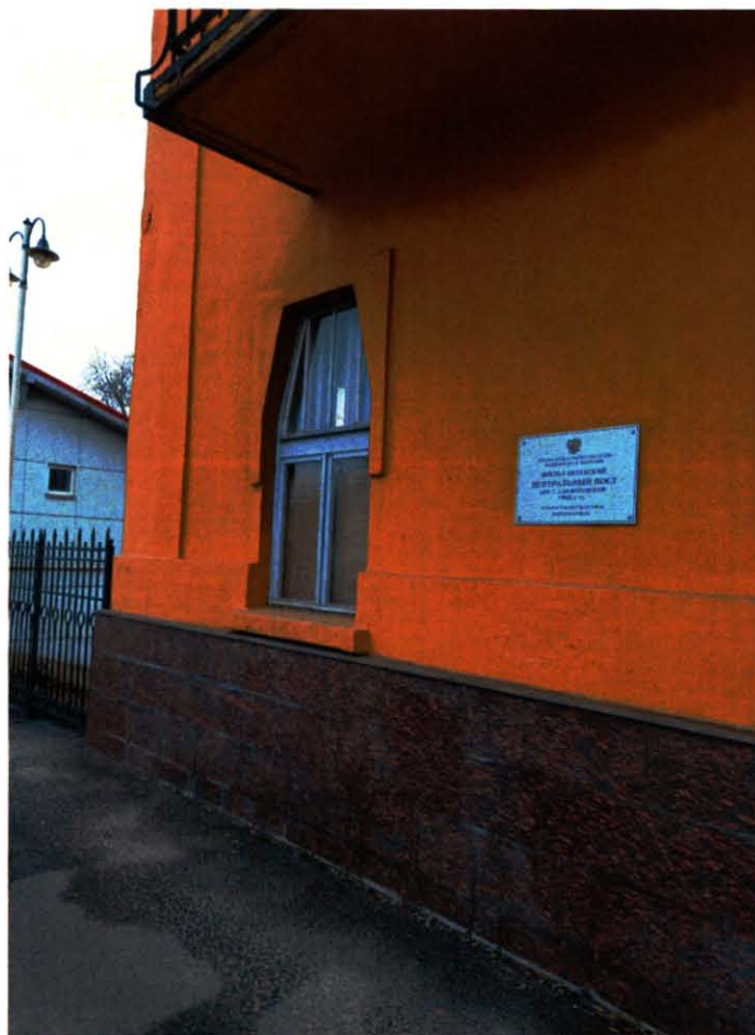
4. Фрагмент западного фасада объекта культурного наследия.
