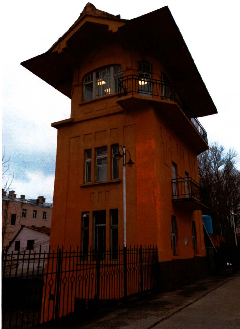
1. Общий вид северного и западного фасадов объекта культурного наследия.
