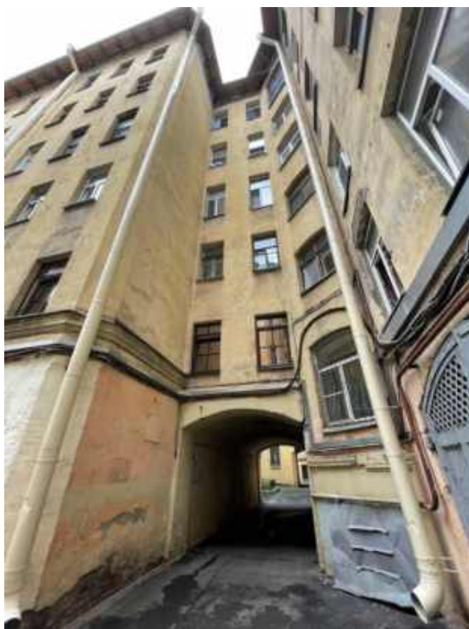
Фото 4. Фрагмент дворового фасада выявленного объекта культурного наследия «Дом Н.П. Фадеевой (О.В. Серебряковой)»
