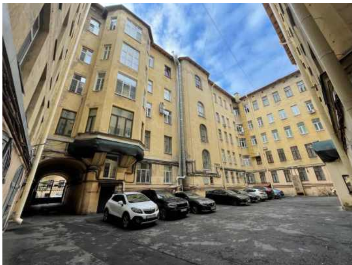
Фото 2. Фрагмент дворового фасада выявленного объекта культурного наследия «Дом Н.П. Фадеевой (О.В. Серебряковой)»
