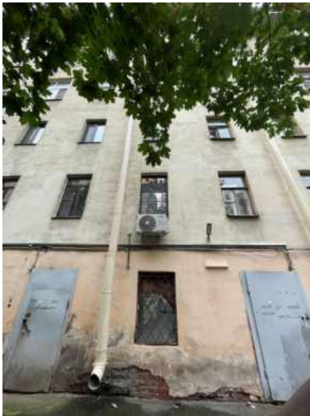
Фото 5. Фрагмент дворового фасада выявленного объекта культурного наследия «Дом Н.П. Фадеевой (О.В. Серебряковой)»
