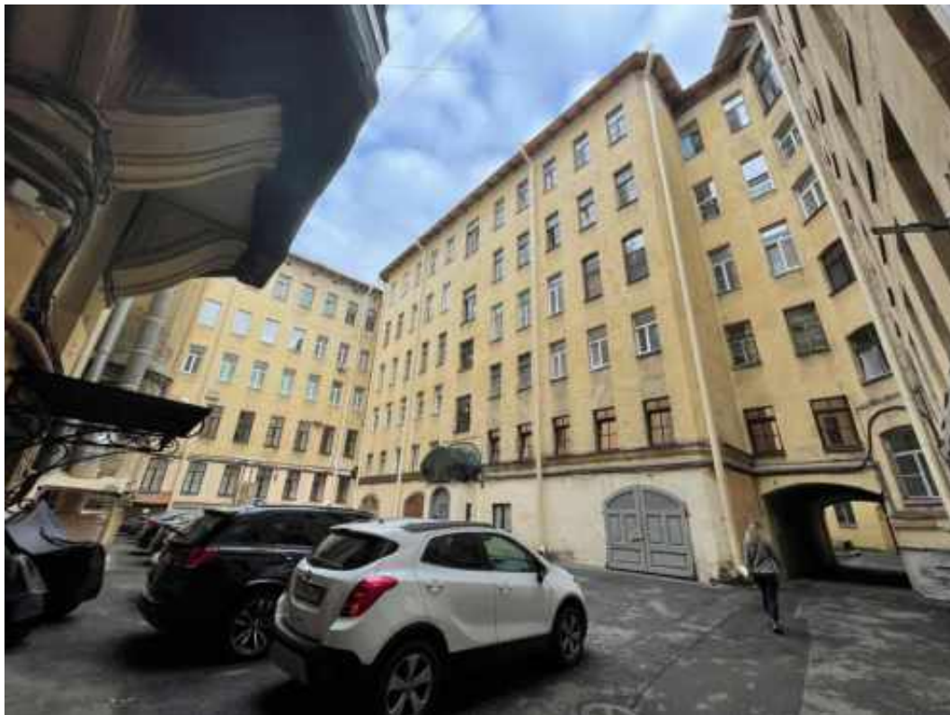
Фото 3. Фрагмент дворового фасада выявленного объекта культурного наследия «Дом Н.П. Фадеевой (О.В. Серебряковой)»
