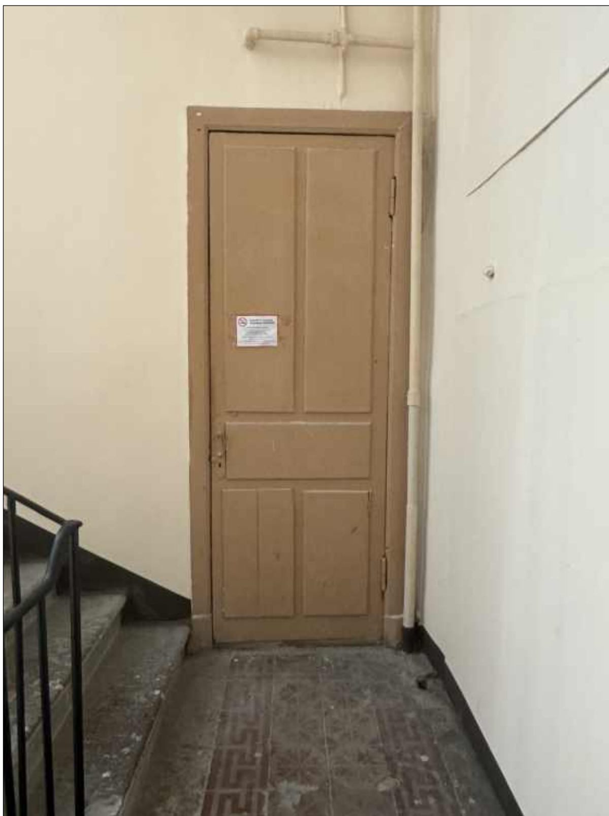
6. «Чёрная» лестница (Л-12). Сохранившаяся историческая входная дверь*.
