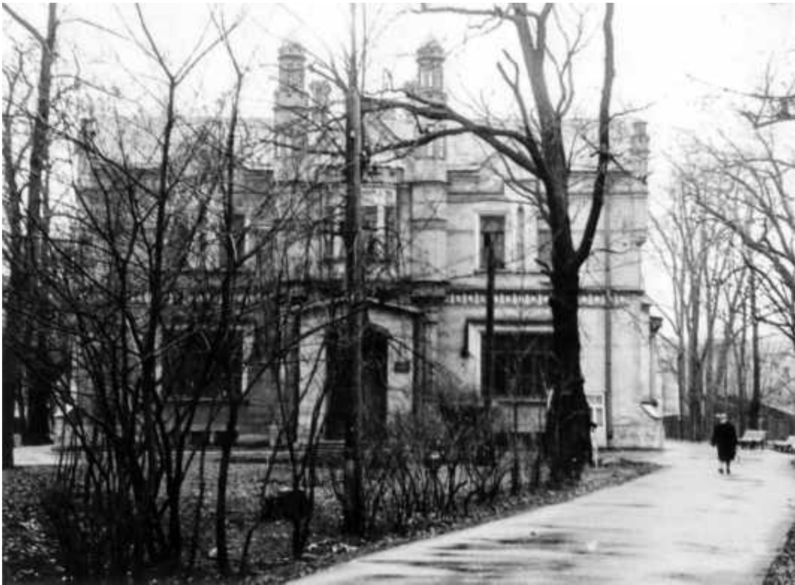
26. Дача Салтыковых. Восточный фасад. 1967 г. Источник: https://pastvu.com
