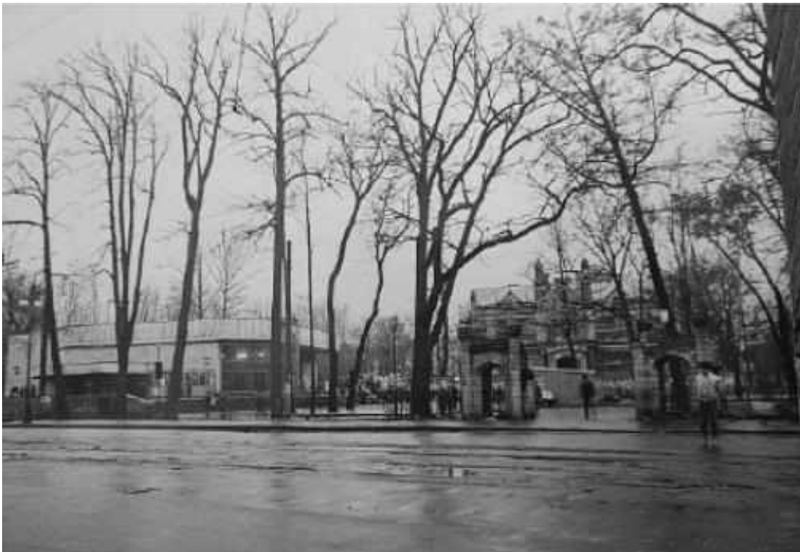
43. Дача Салтыковых. Ансамбль. Вид на дом и ворота. 1992 г. Источник: архив КГИОП 634-П.
