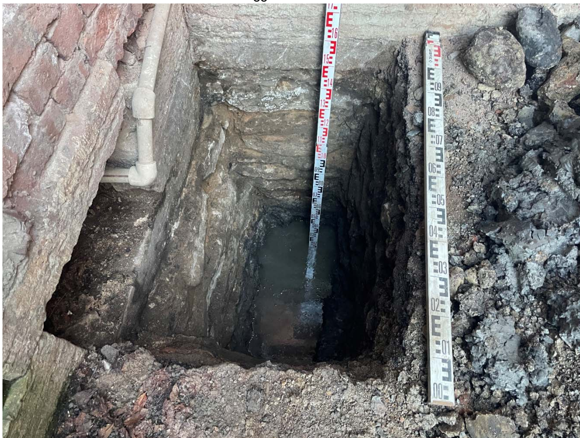
Рис. 22. СПБ-25. Лахтинская ул., 25а, Лит. А. Шурф 1, северо-восточная стенка.
