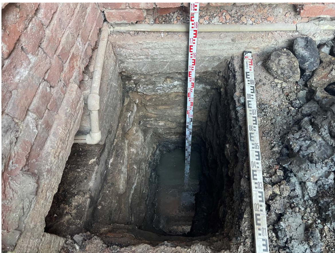
Рис. 21. СПб-25. Лахтинская ул., 25а, Лит. А. Шурф 1, фиксация по уровню окончания работ, вид с юго-запада.
