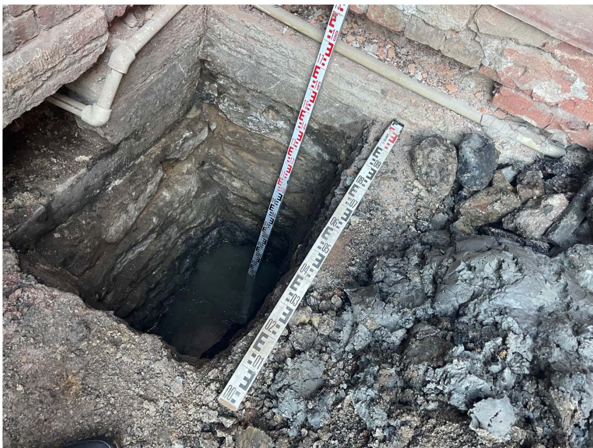
Рис. 23. СПБ-25. Лахтинская ул., 25а, Лит. А. Шурф 1, фиксация по уровню окончания работ, вид с юга.
