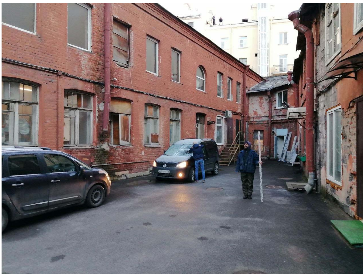
Рис. 17. СПб-25. Лахтинская ул., 25а, Лит. А. Точка фотофиксации 1, вид с юго-востока.
