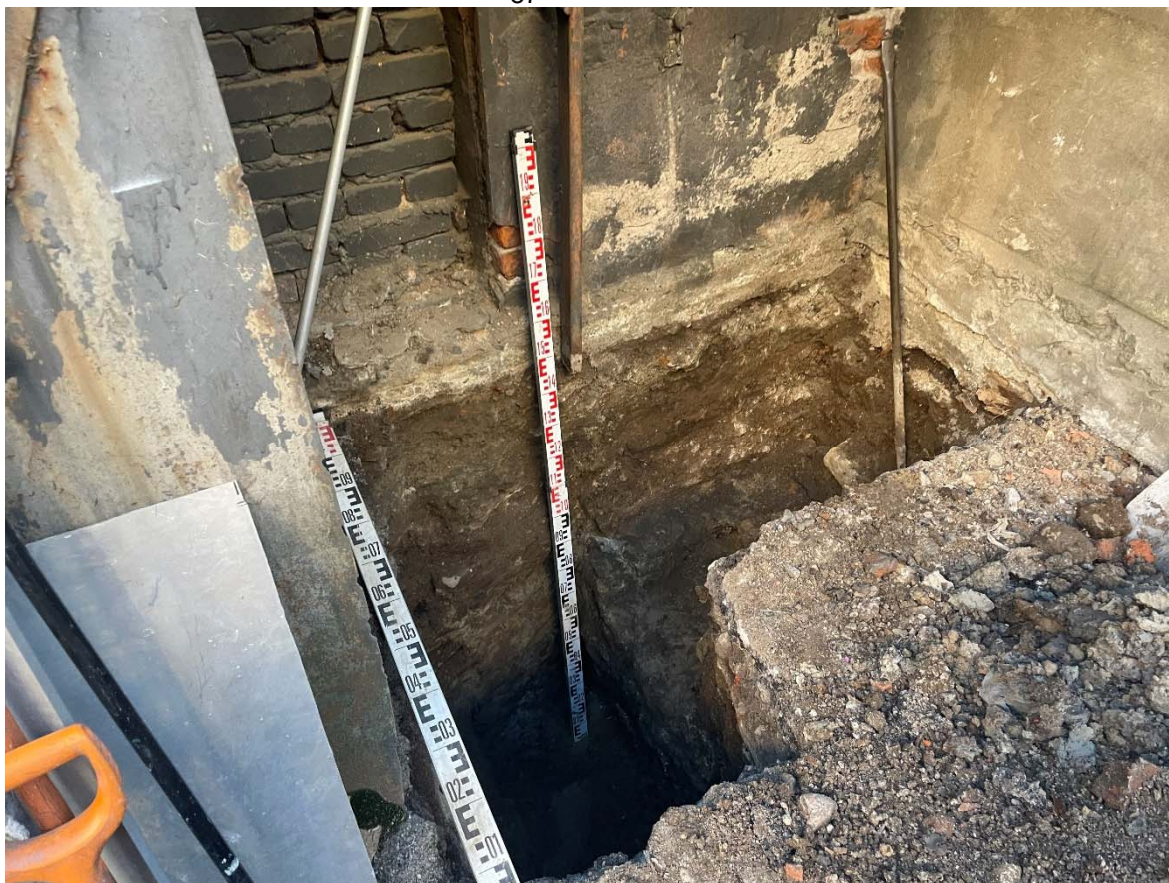
Рис. 26. СПБ-25. Лахтинская ул., 25а, Лит. А. Шурф 2, фиксация по уровню окончания работ, вид с северо-запада.
