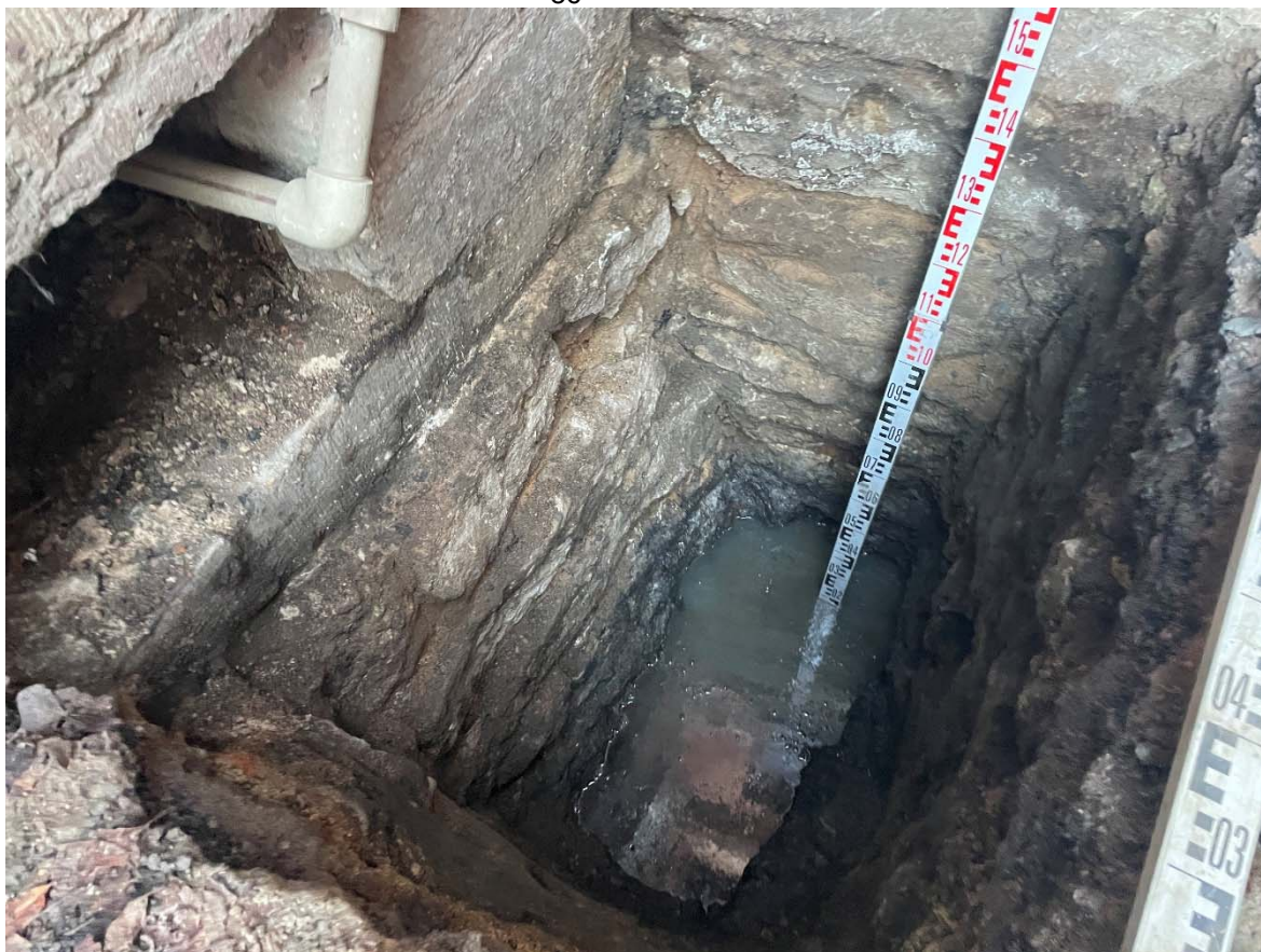
Рис. 24. СПБ-25. Лахтинская ул., 25а, Лит. А. Шурф 1, северо-восточная и северо-западные стенки.
