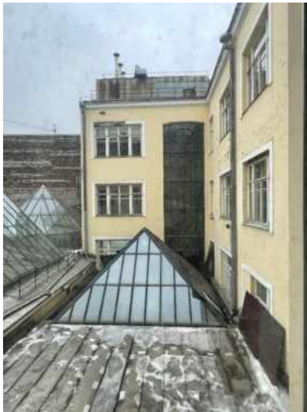
24. ОКН регионального значения «"Дом фирмы "Юнкер и Ко" (с дворовыми флигелями)» (г. Санкт-Петербург, Невский проспект, дом 12, литера А.
