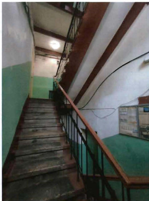
15. Лестничная клетка 6-ЛК (фотофиксация 07.03.2024).
