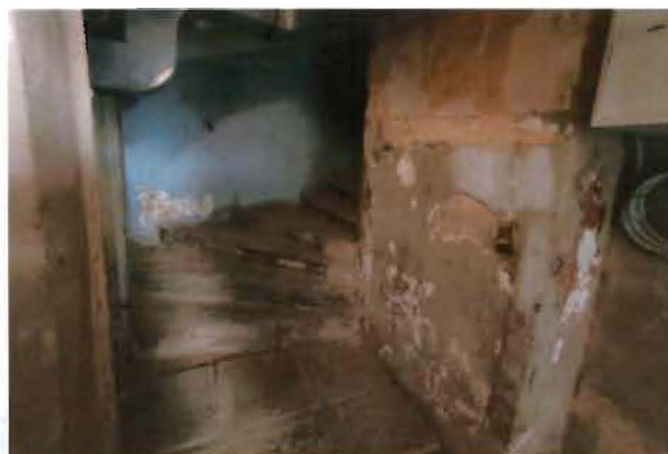
12. Лестничная клетка 4-ЛК (фотофиксация 28.03.2024).
