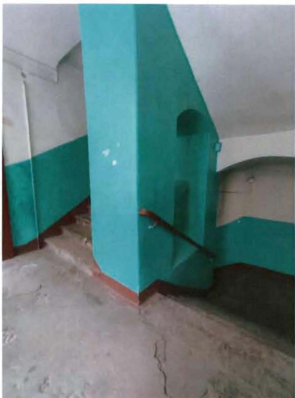
9. Лестничная клетка Л-7 (в настоящее время 1-ЛК) (фотофиксация 07.03.2024).
