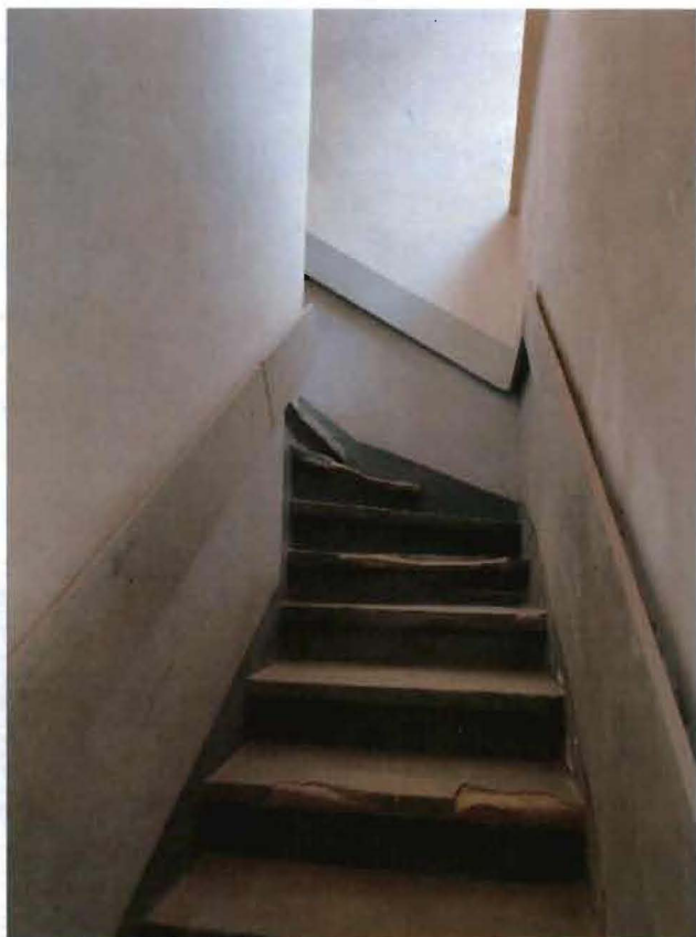
14. Лестничная клетка 5-ЛК (фотофиксация 07.03.2024).
