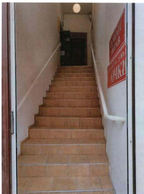
10. Лестничная клетка 2-ЛК (фотофиксация 28.03.2024).
