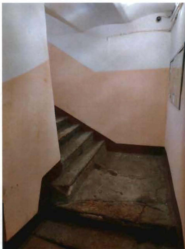
11. Лестничная клетка 3-ЛК (фотофиксация 07.03.2024).
