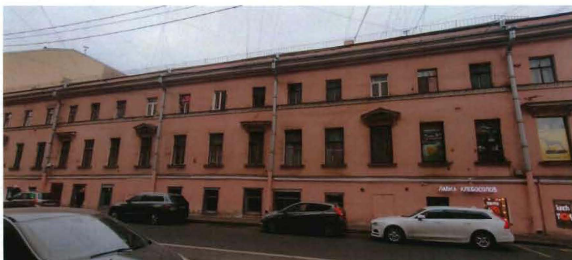
2. Юго-восточный фасад объекта культурного наследия (фотофиксация 07.03.2024).
