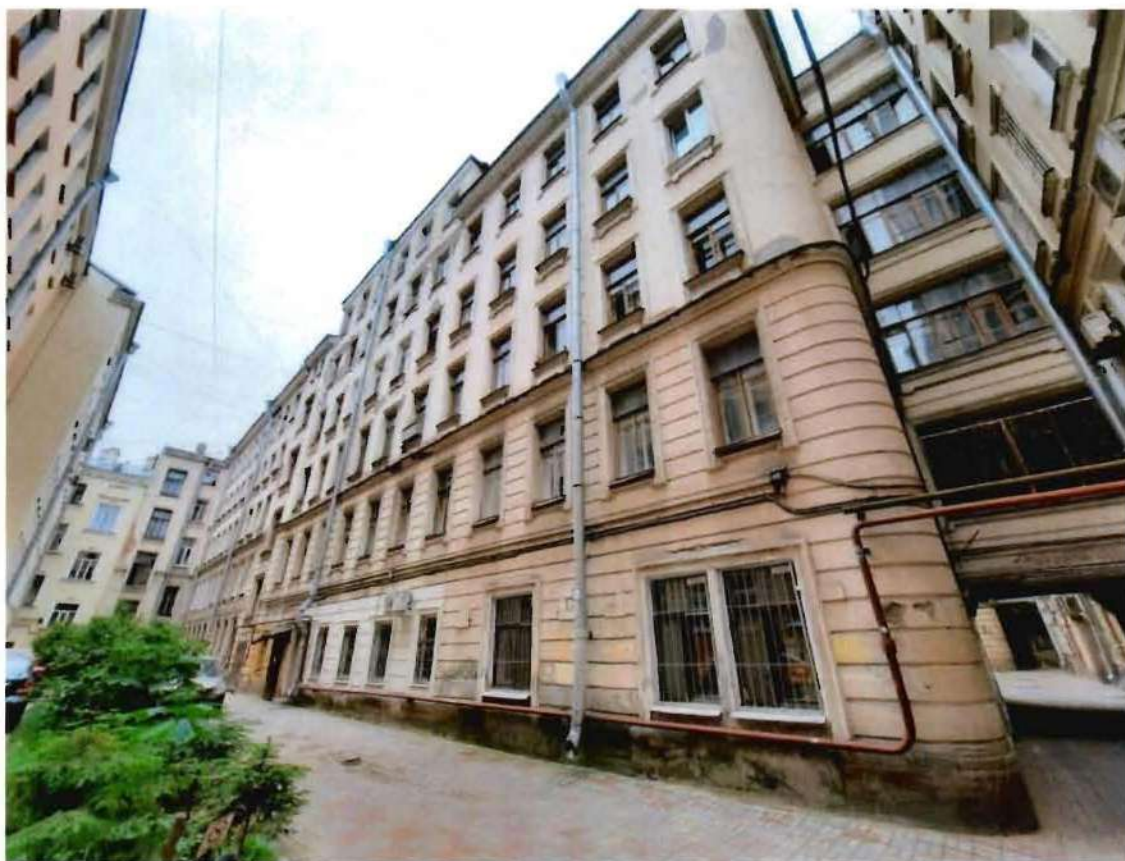
4. Общий вид на северо-западный фасад объекта культурного наследия
