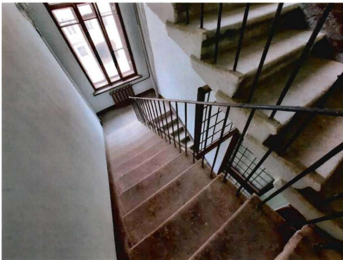
15. Интерьеры объекта культурного наследия. Лестница 3ЛК
