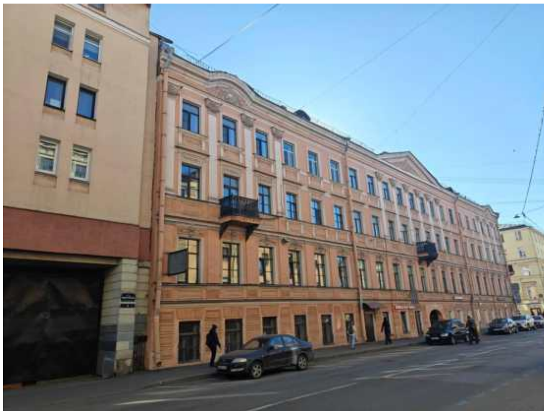
Фото 1. Фрагмент лицевого фасада выявленного объекта культурного наследия «Дом В.И. Бурды»
