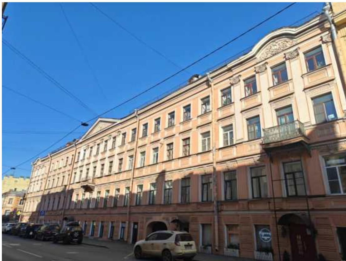
Фото 5. Фрагмент лицевого фасада выявленного объекта культурного наследия «Дом В.И. Бурды»
