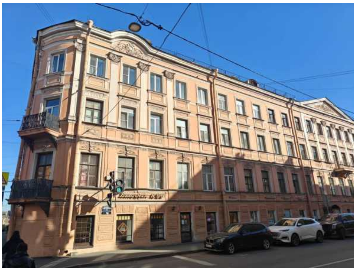
Фото 4. Фрагмент лицевого фасада выявленного объекта культурного наследия «Дом В.И. Бурды»
