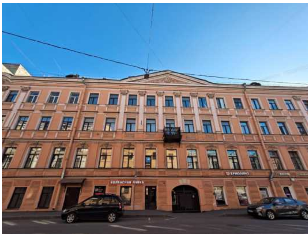
Фото 2. Фрагмент лицевого фасада выявленного объекта культурного наследия «Дом В.И. Бурды»
