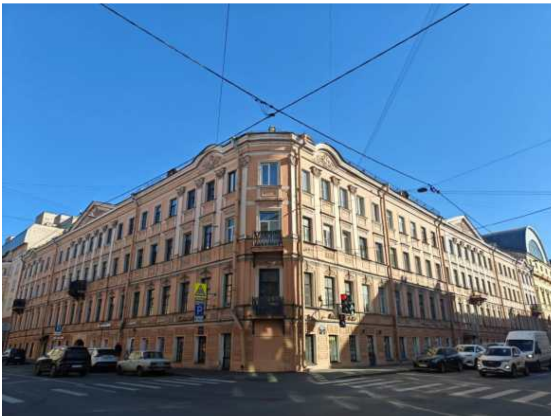
Фото 3. Фрагмент лицевого фасада выявленного объекта культурного наследия «Дом В.И. Бурды»
