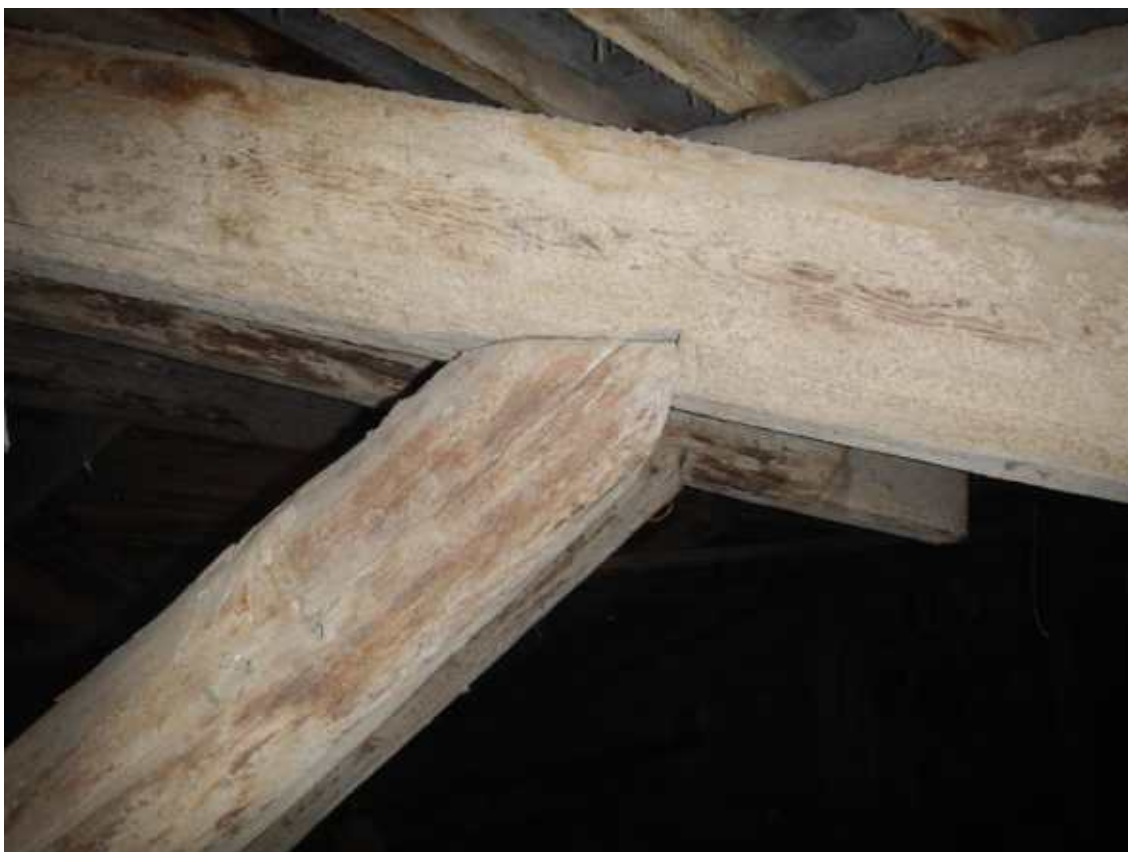
Фото 5. Общий вид сопряжения подкоса и стропильной ноги.
