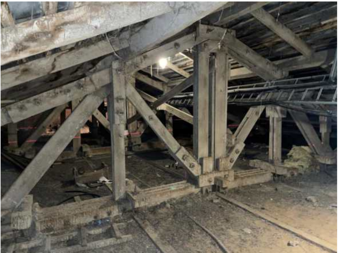
Фото 16. Общий вид стропильной системы крыши.
