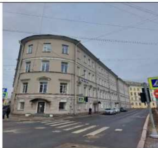
Рис. 2. Вид здания с южной стороны (с перекрестка наб. кан. Грибоедова и пер. Гривцова).
