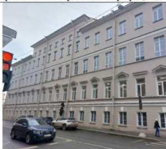
Рис. 4. Общий вид здания с северо-западной стороны (с о стороны Казанской ул.).
