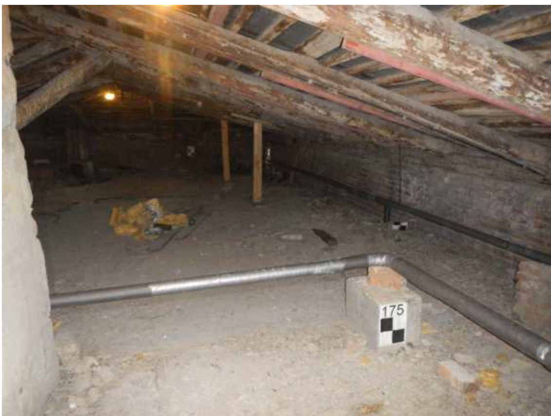
Фото 8. Общий вид чердачного помещения.
