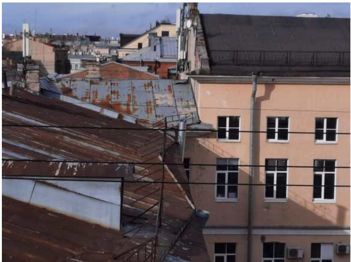
Фото 4. Общий вид кровли.
