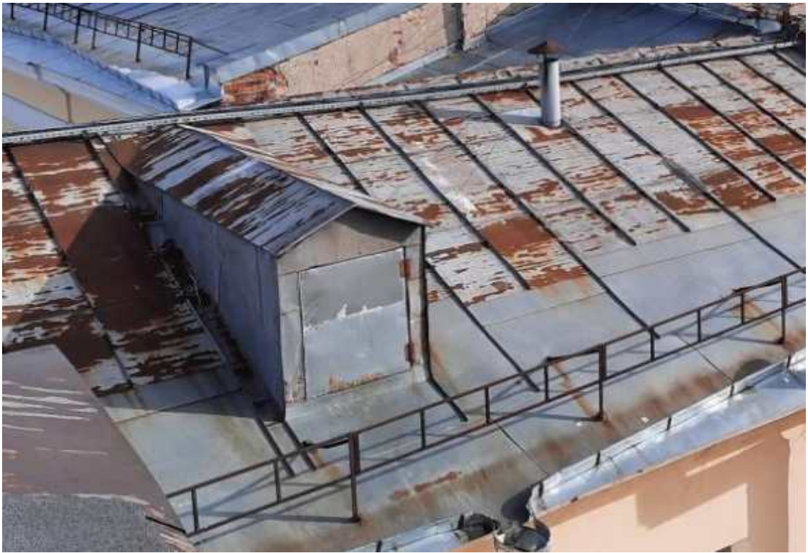
Фото 7. Общий вид слухового окна.
