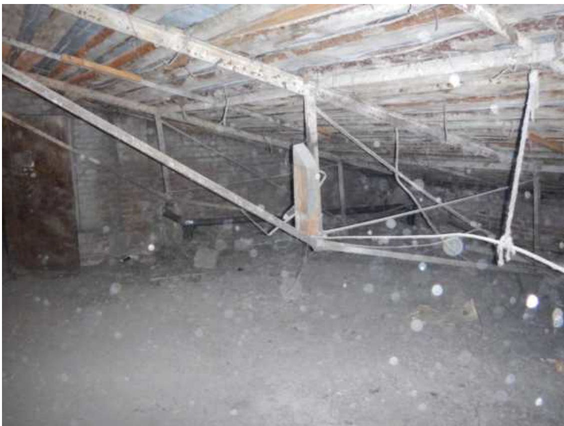
Фото 3. Общий вид стропильных конструкции крыши.
