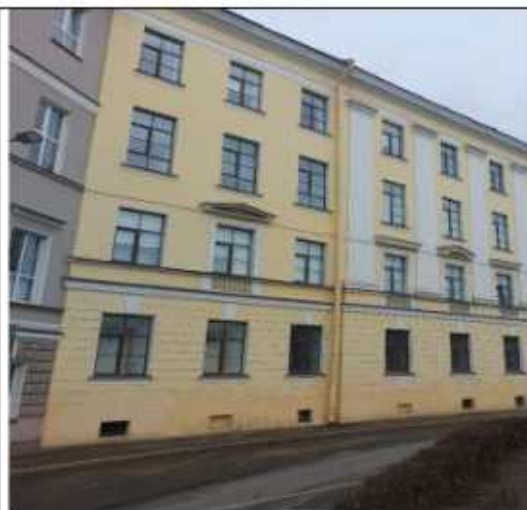
Рис. 1. Общий вид здания с юго-восточной стороны (с наб. кан. Грибоедова).
