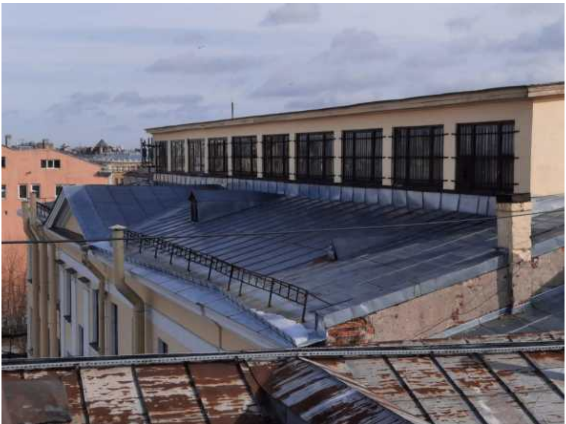
Фото 8. Общий вид кровли.
