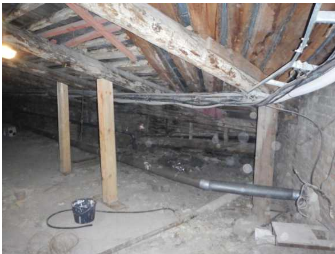
Фото 6. Общий вид чердачного помещения
