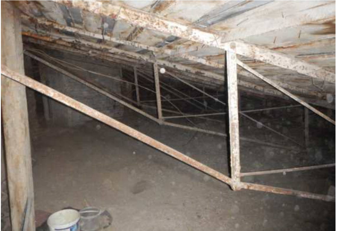
Фото 1. Общий вид стропильных конструкции крыши.
