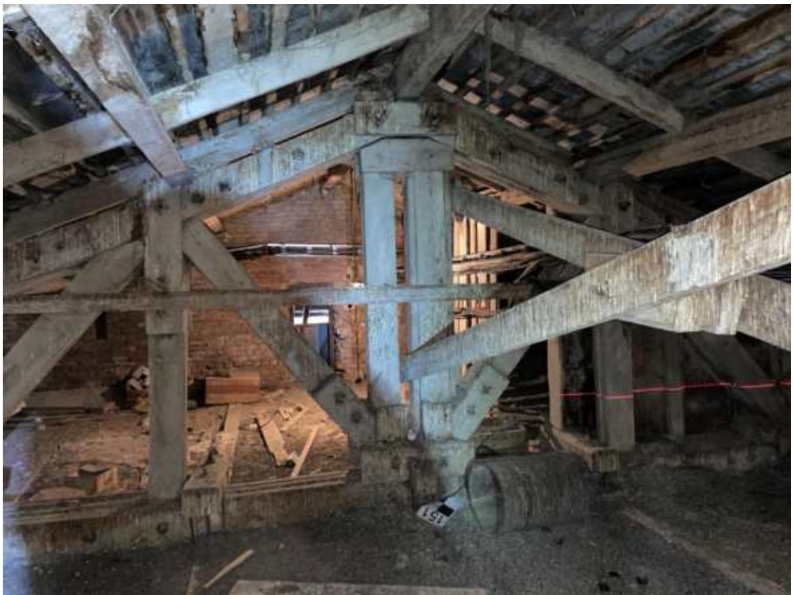
Фото 17. Общий вид стропильной системы крыши.
