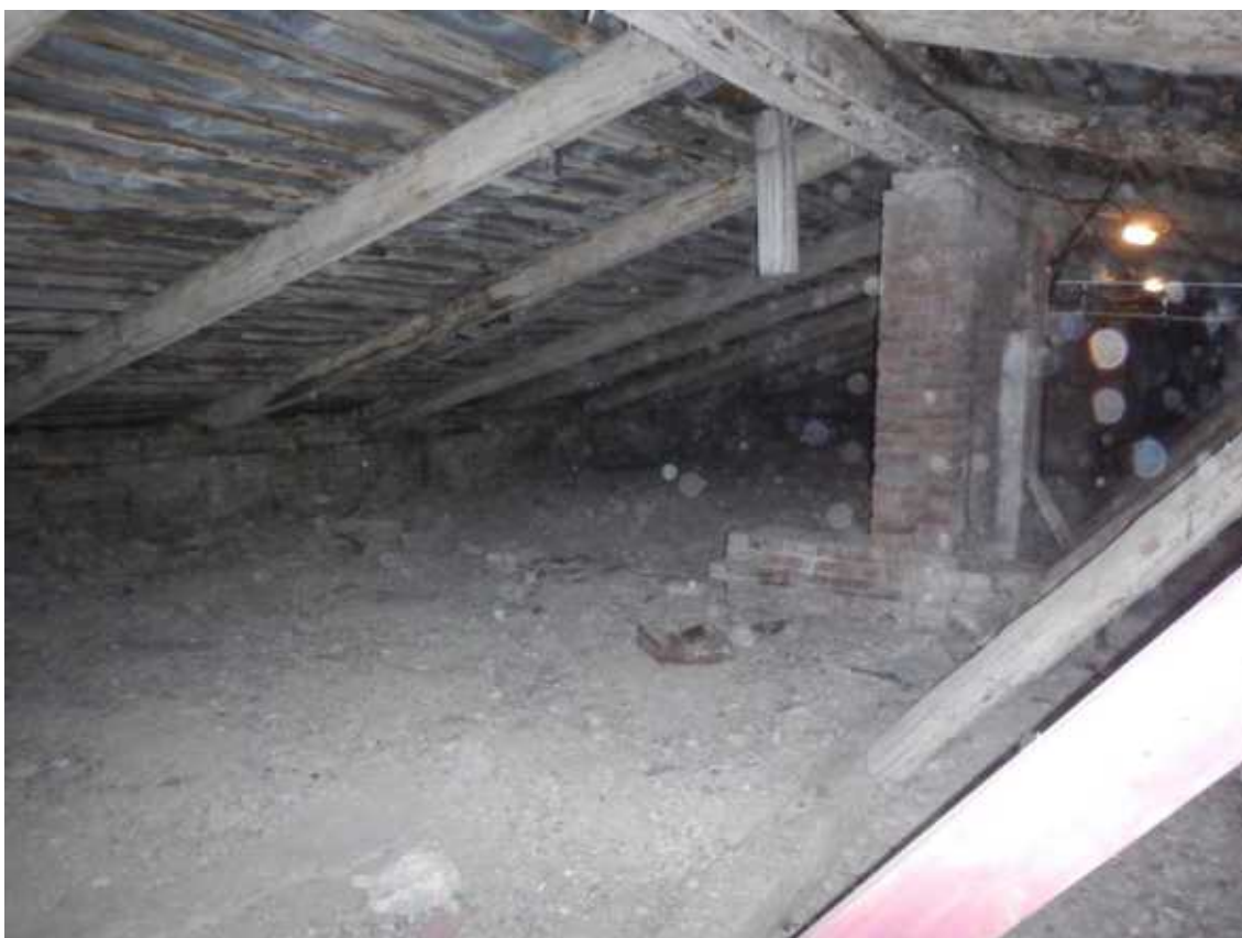
Фото 12. Общий вид чердачного помещения
