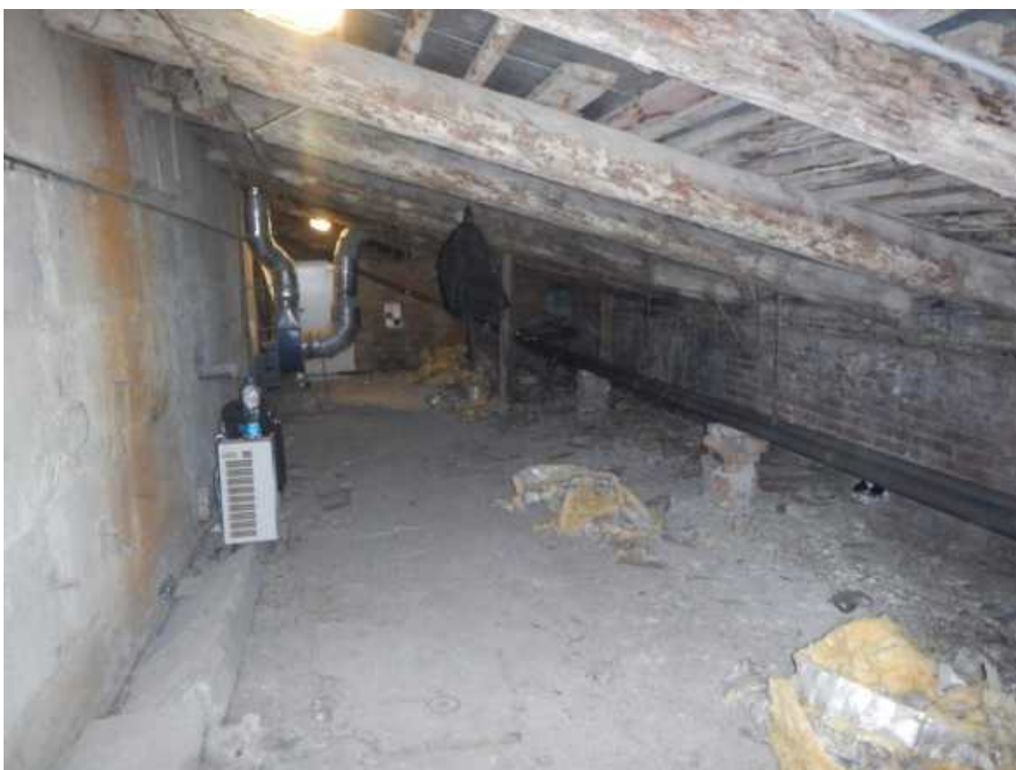
Фото 10. Общий вид чердачного помещения.
