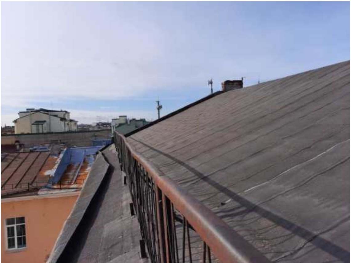
Фото 3. Общий вид кровли.
