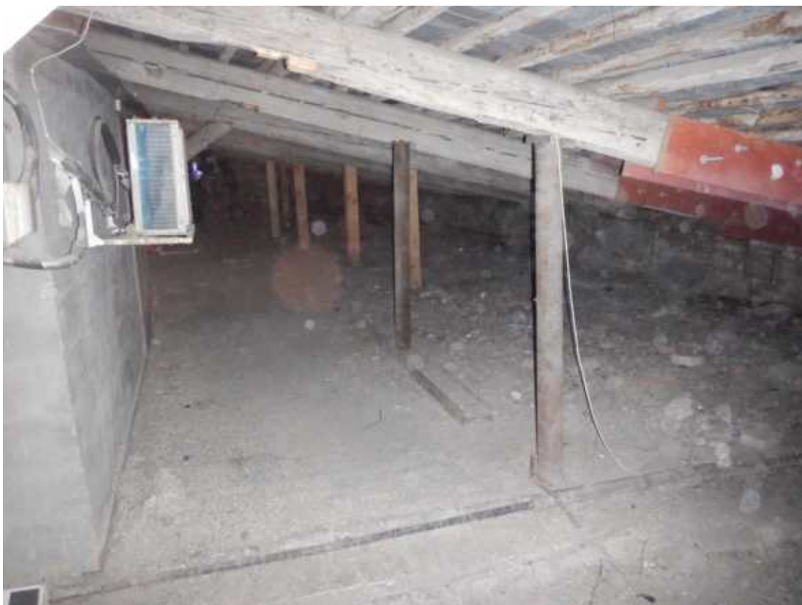
Фото 13. Общий вид стропильной системы крыши
