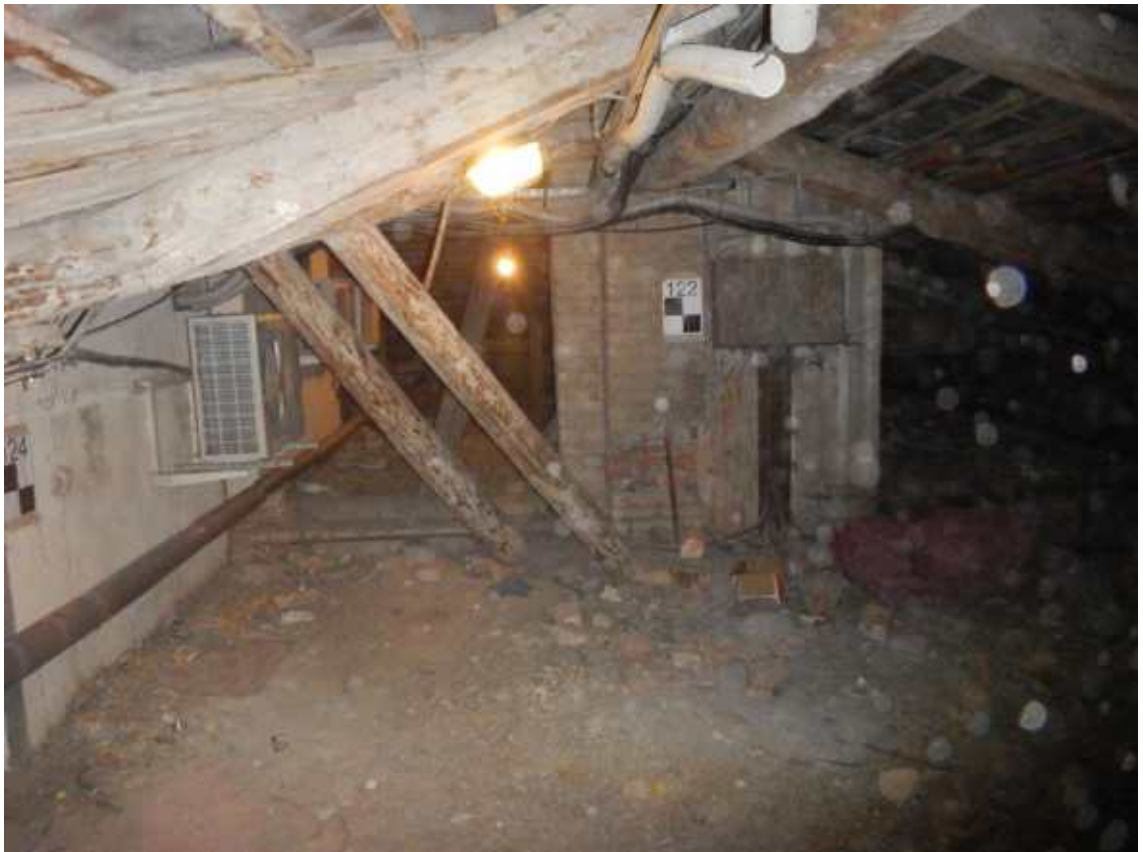
Фото 19. Устройство подкосов стропильной системы.
