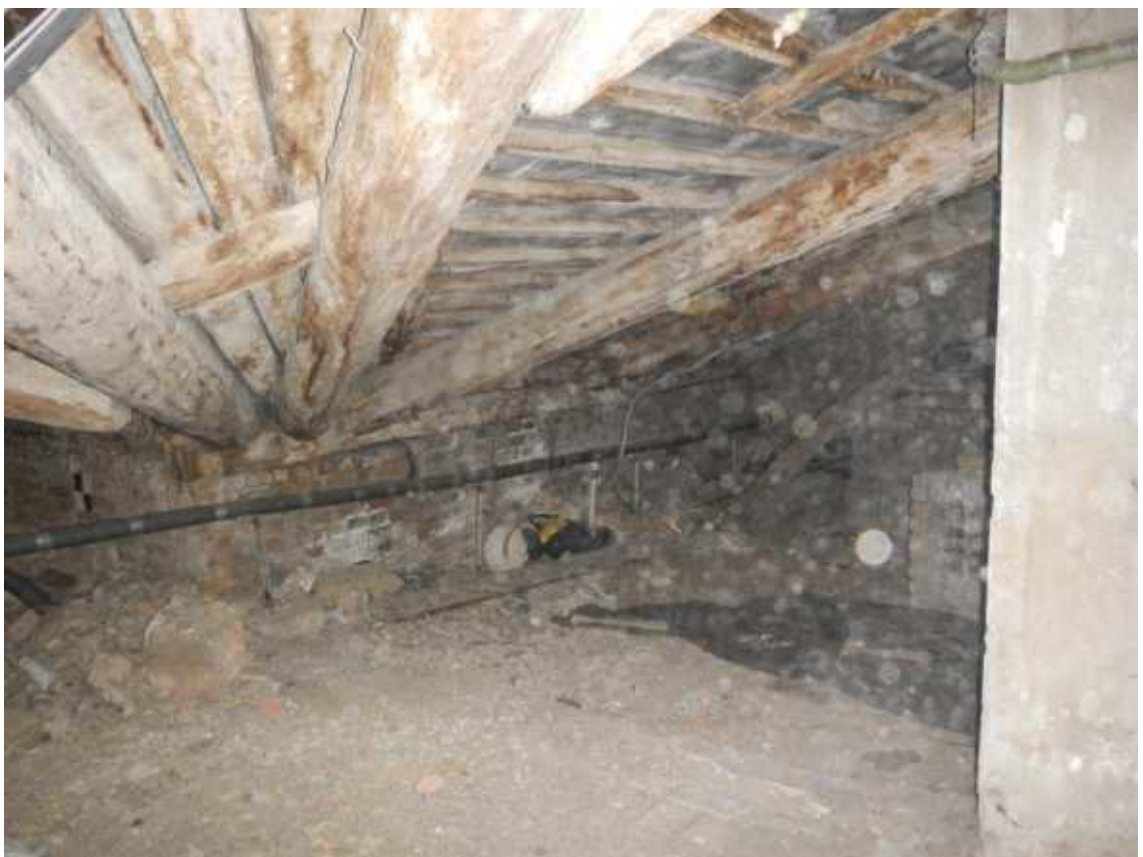
Фото 18. Устройство ендовы крыши.
