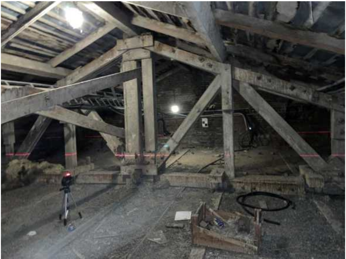
Фото 15. Общий вид стропильной системы крыши.
