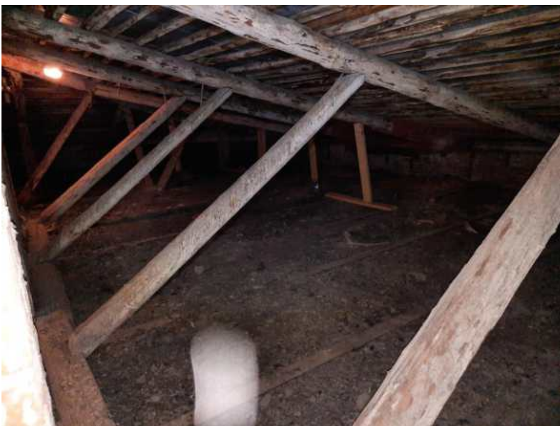
Фото 14. Общий вид стропильной системы крыши.
