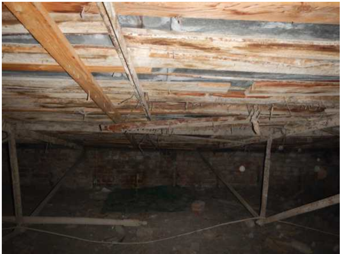
Фото 2. Общий вид стропильных конструкции крыши.
