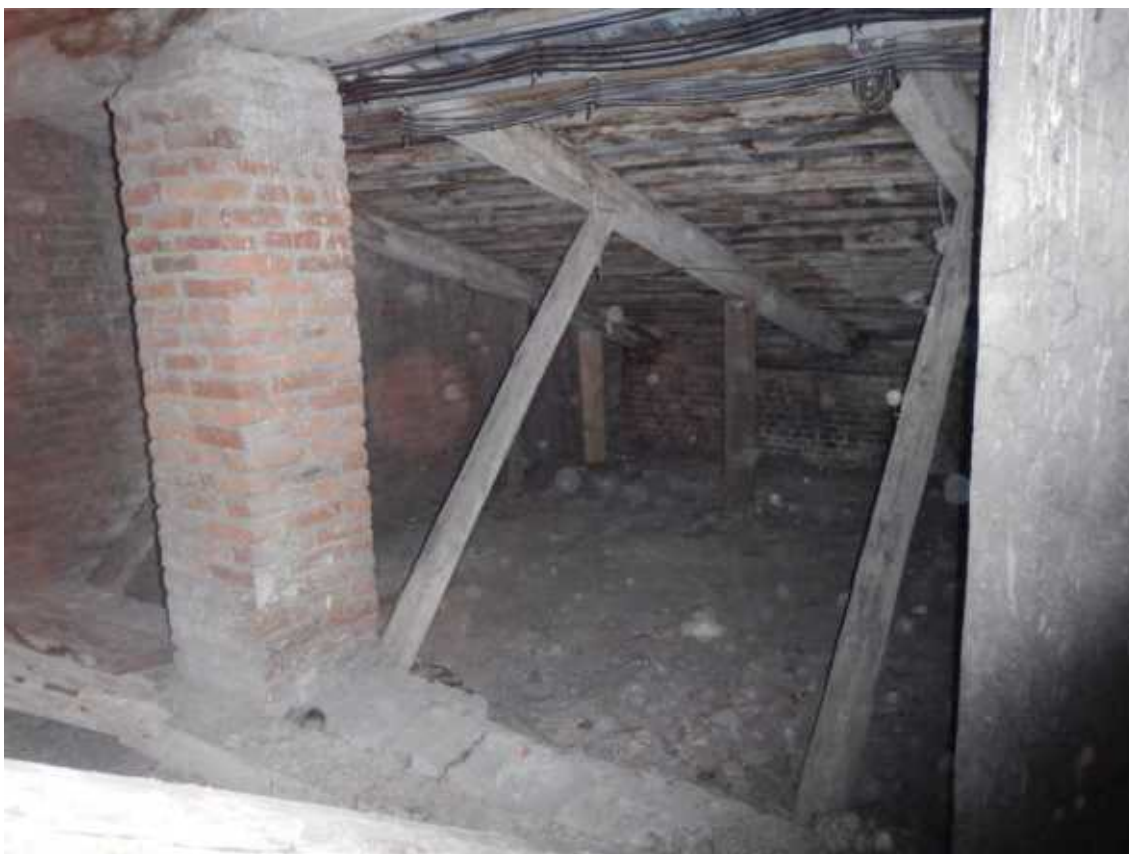
Фото 11. Общий вид стропильной системы крыши
