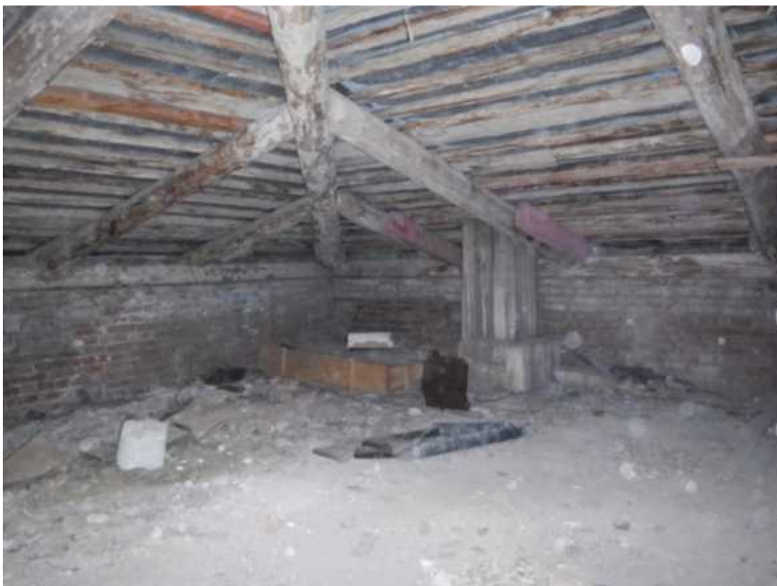
Фото 9. Общий вид чердачного помещения.
