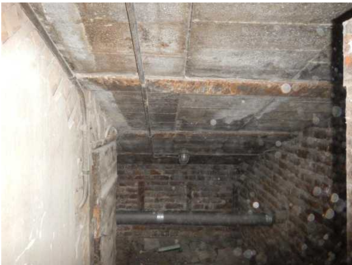
Фото 21. Общий вид стропильной системы крыши.
