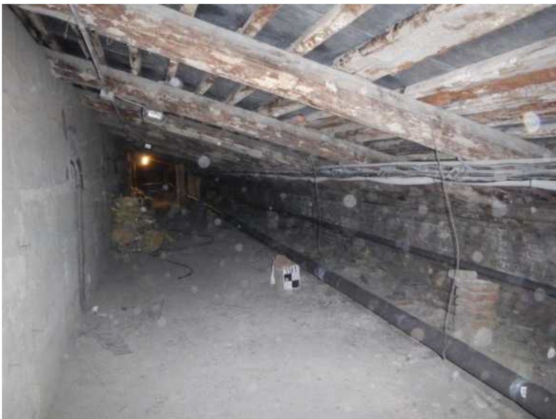
Фото 7. Общий вид чердачного помещения.
