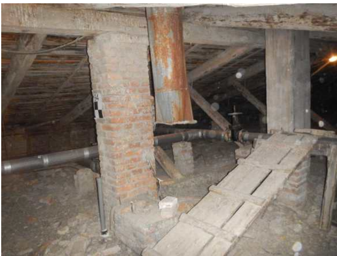
Фото 4. Общий вид чердачного помещения в осях «10-11//И/12-К/12».
