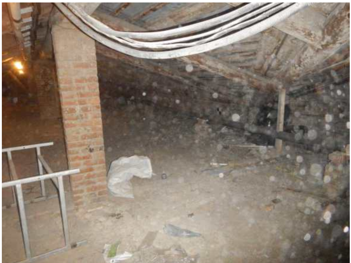
Фото 20. Фрагмент чердачного помещения.
