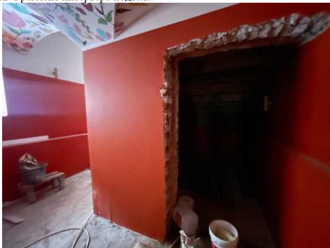
13. Фрагмент интеръера подвала.
