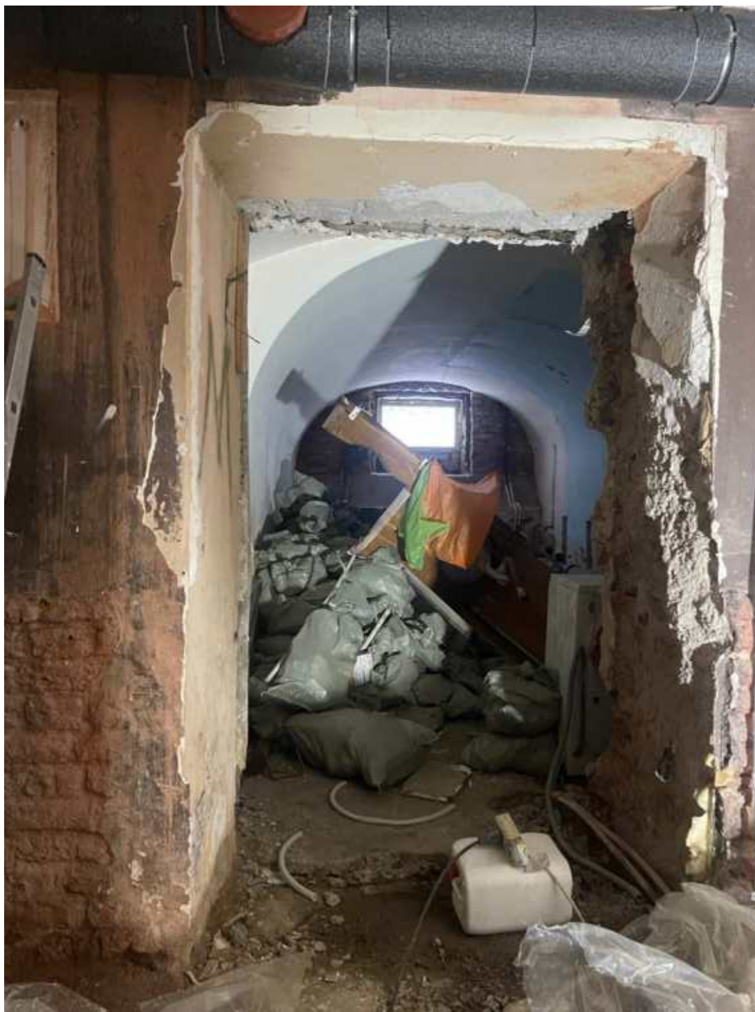
16. Фрагмент интерьера подвала.
