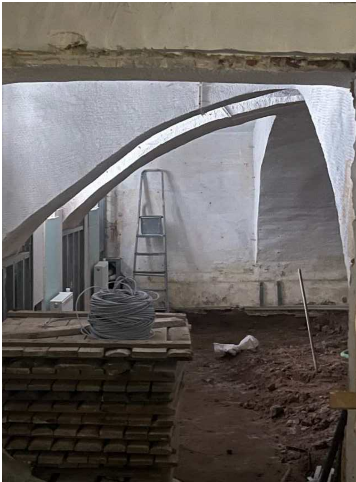
20. Фрагмент интеръера подвала.
