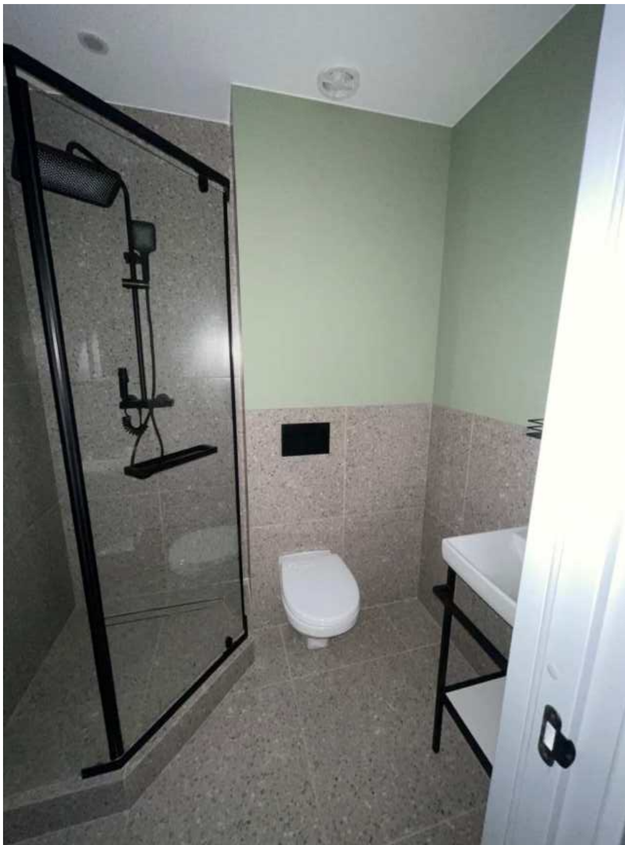
7. Фрагмент интерьера совмещенного санузла.
