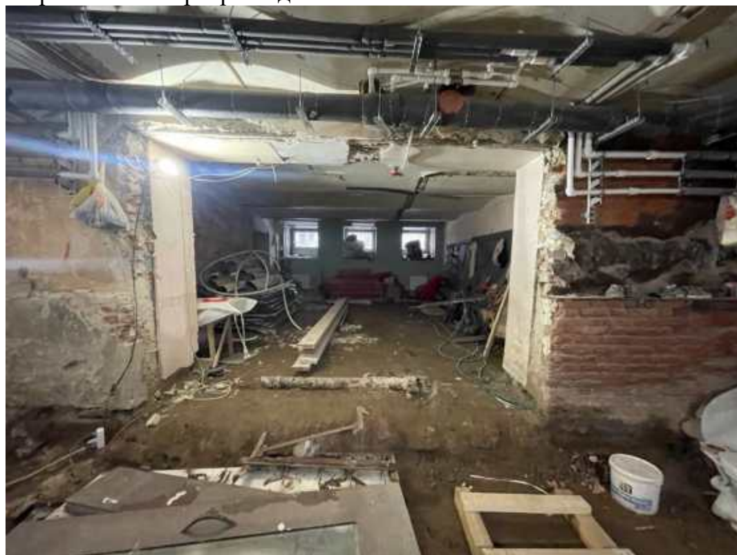
9. Фрагмент интеръера подвала.
