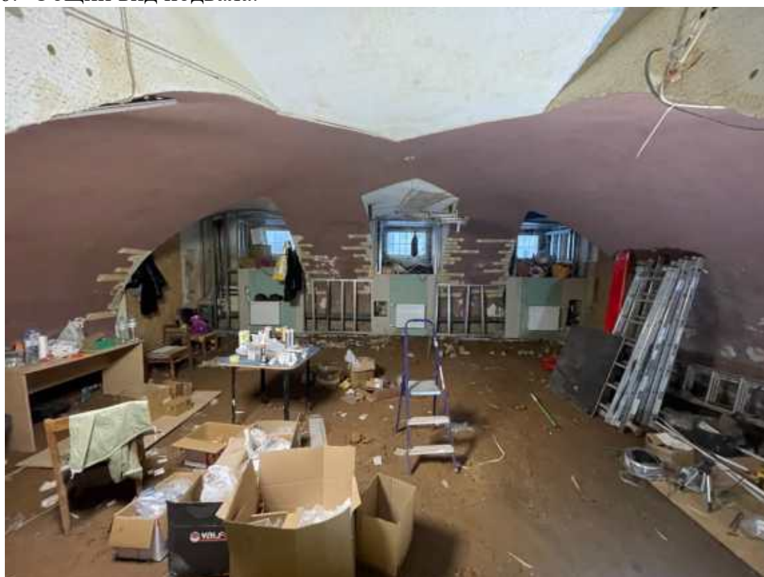
7. Фрагмент интерьера подвала.
