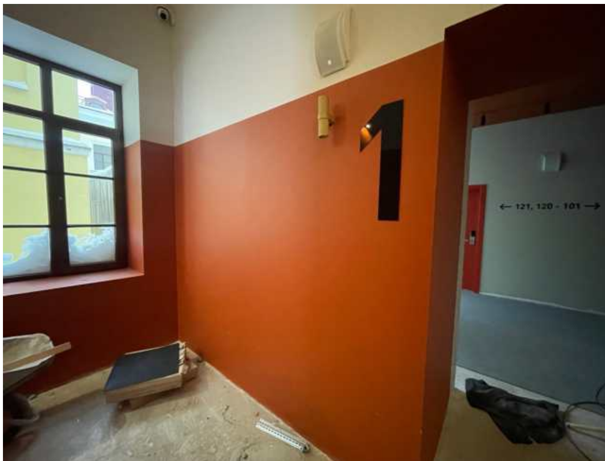
1. Фрагмент лестничной площадки первого этажа.
