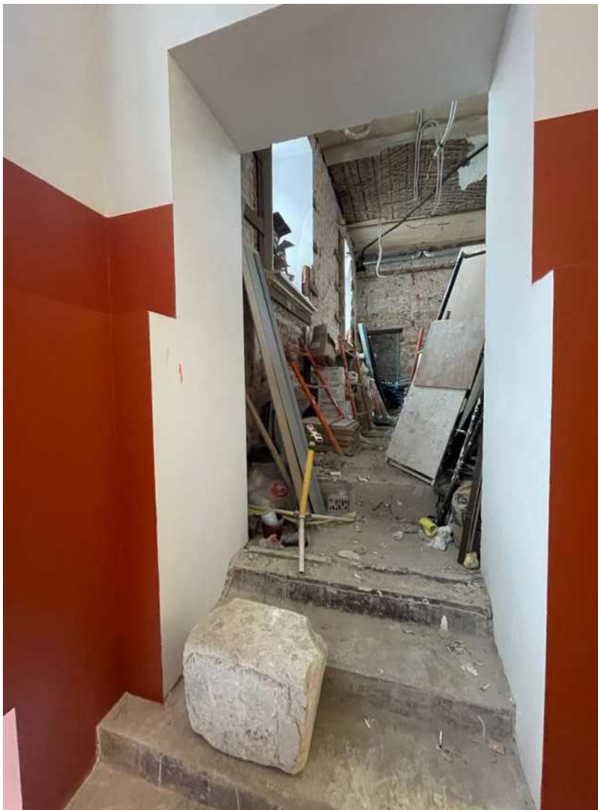
1. Вид на лестницу.
