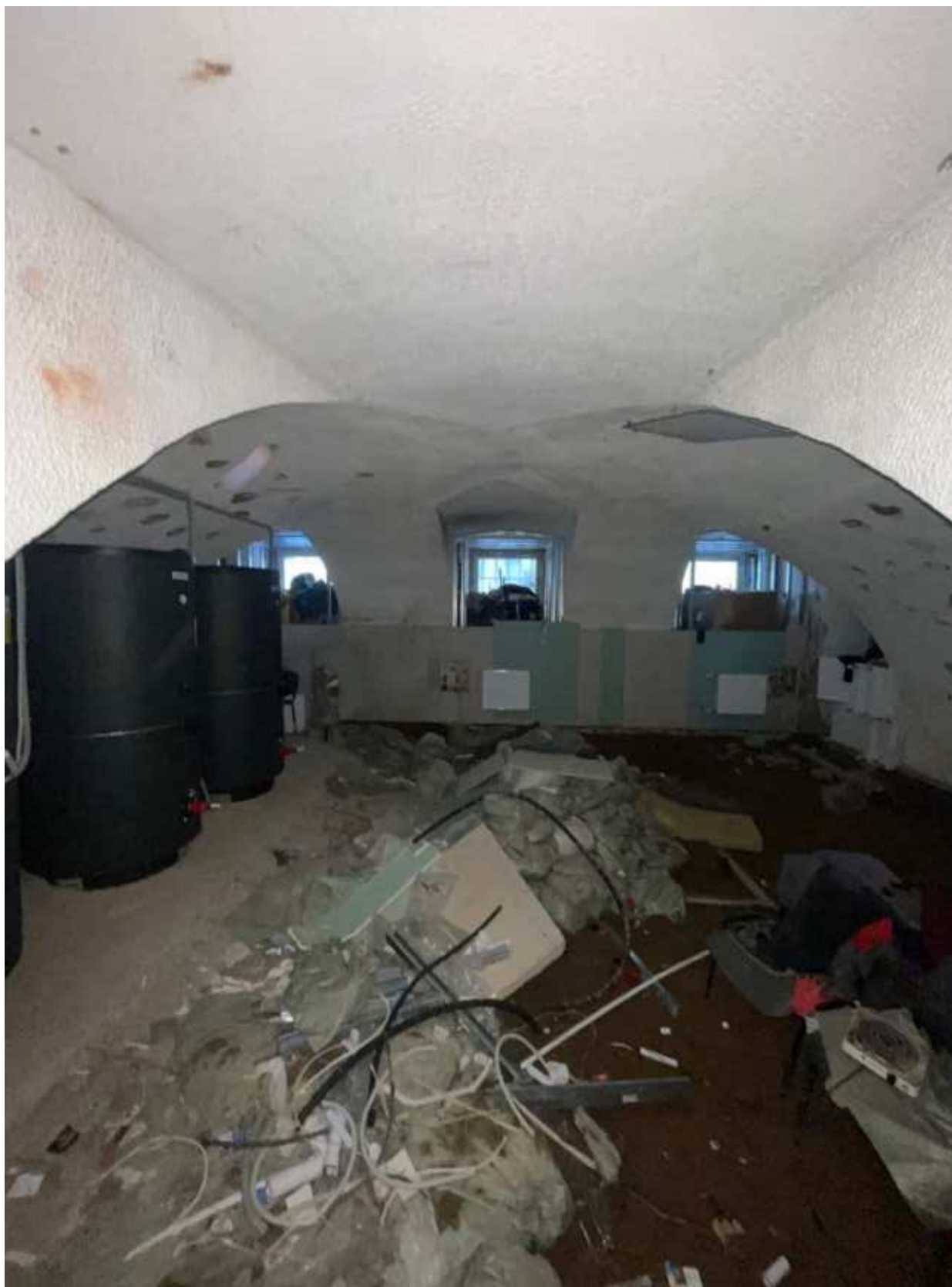
5. Фрагмент интерьера подвала.
