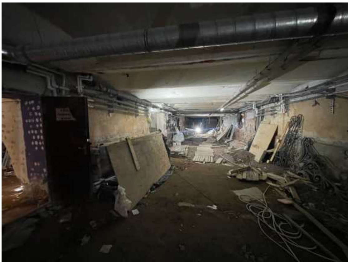
6. Общий вид подвала.
