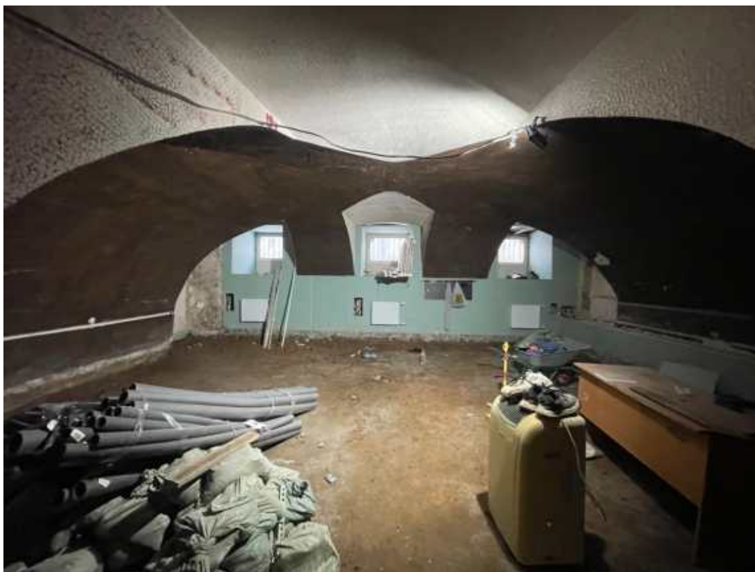
12. Фрагмент интеръера подвала.
