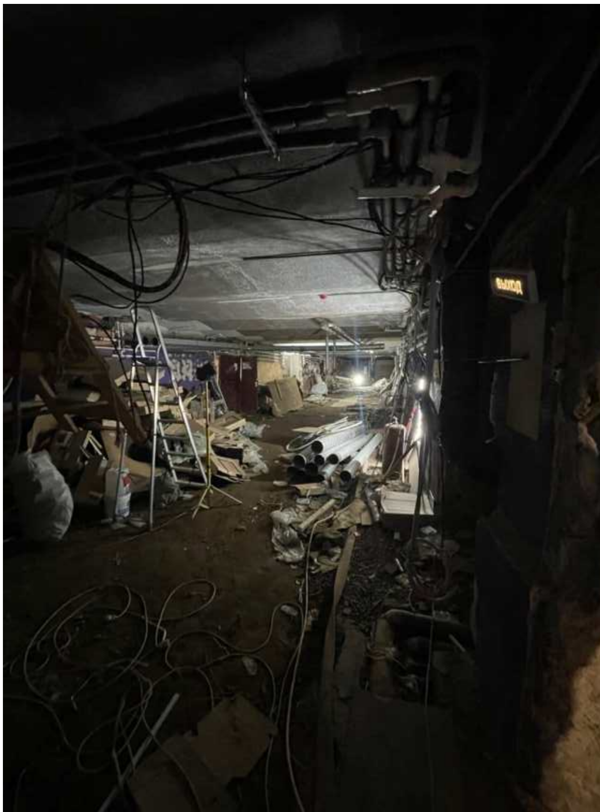
4. Вид на подвал.
