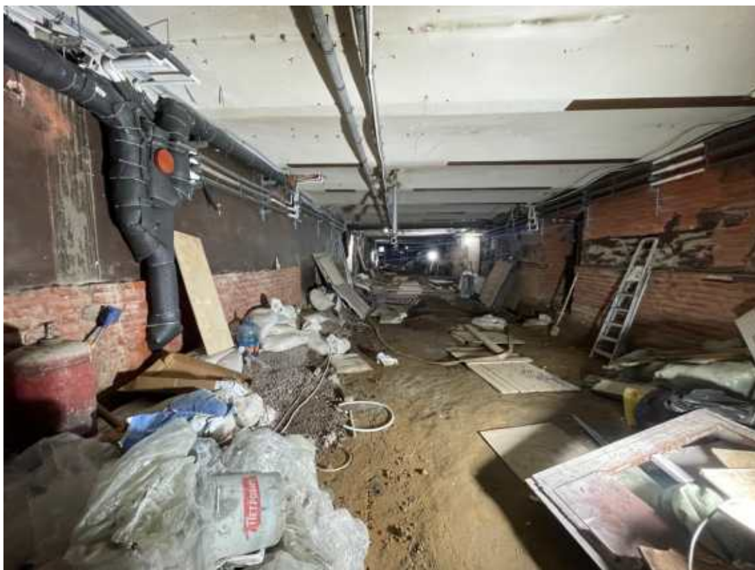
15.Общий вид подвала.
