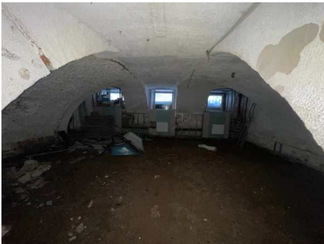
19.Фрагмент интерьера подвала.
