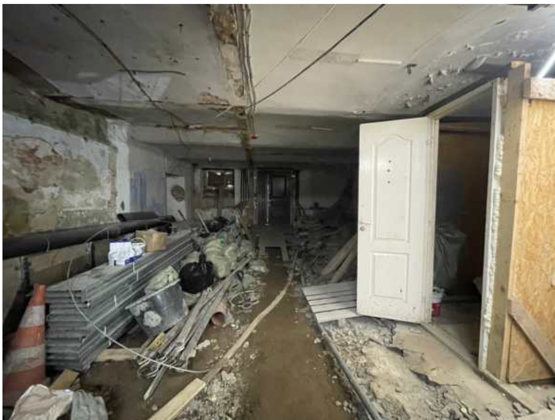
17.Фрагмент интерьера подвала.
