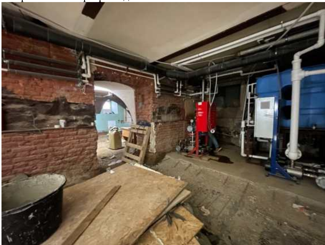
11. Фрагмент интеръера подвала.
