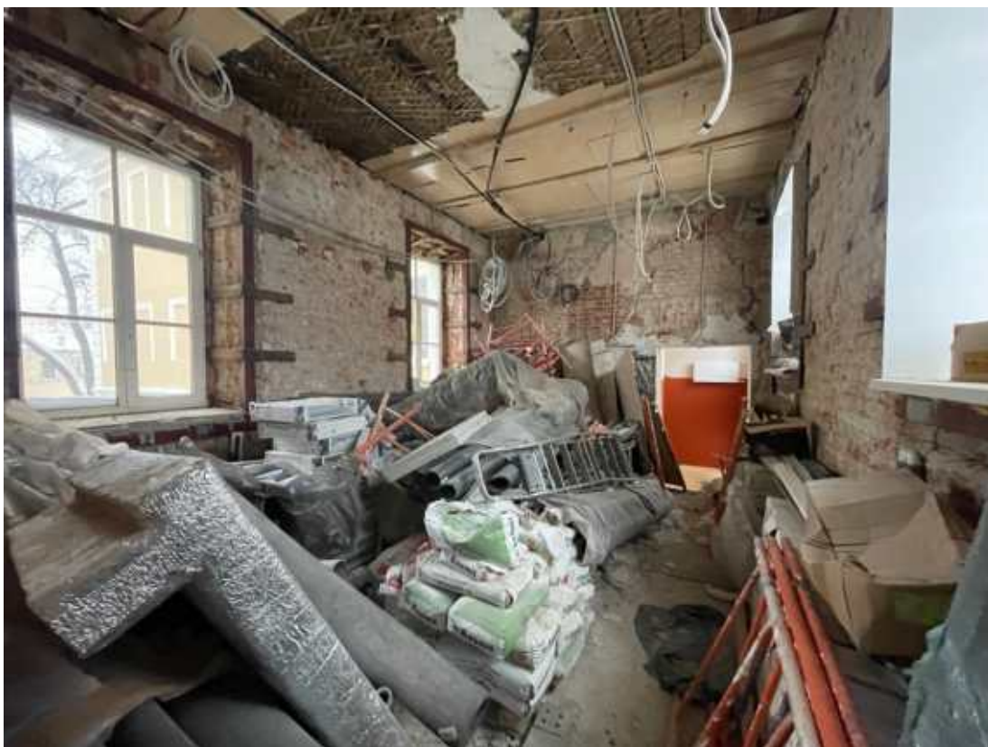
2. Фрагмент интерьера помещения на втором этаже.
