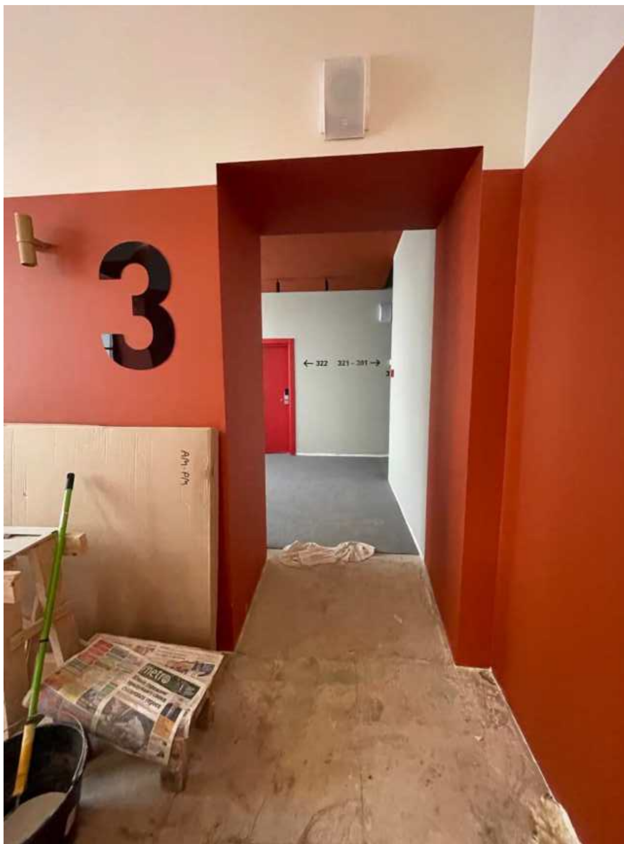
1. Общий вид лестницы.
