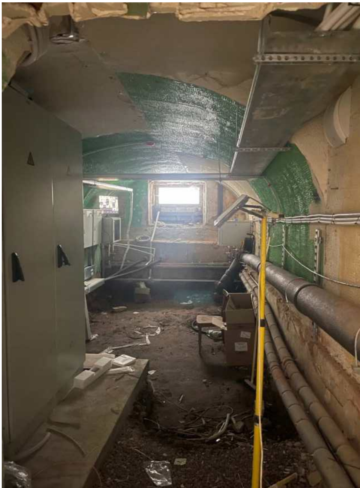
21.Фрагмент интерьера подвала.
