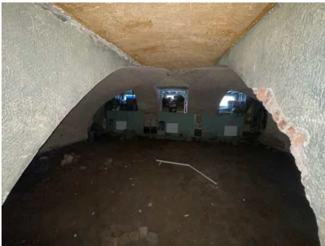
10. Фрагмент интеръера подвала.
