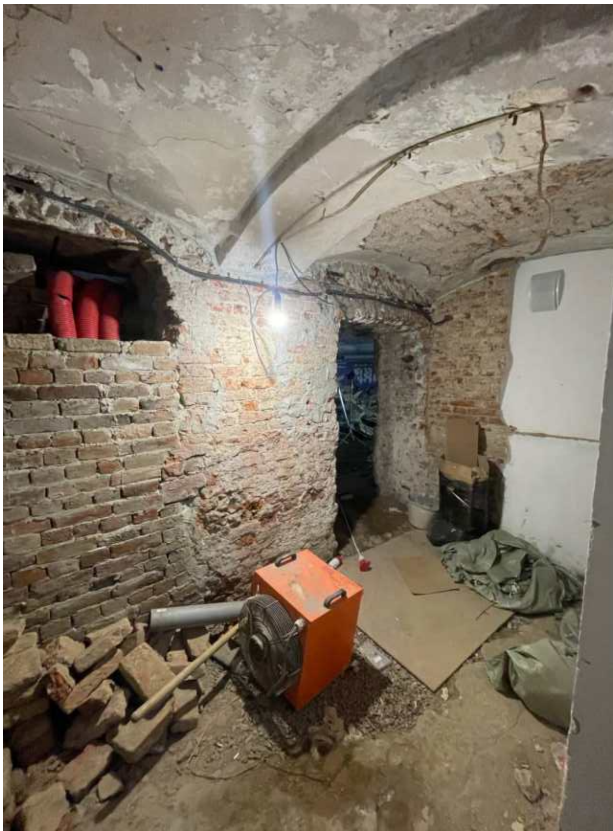
1. Вид на вход в подвал.
