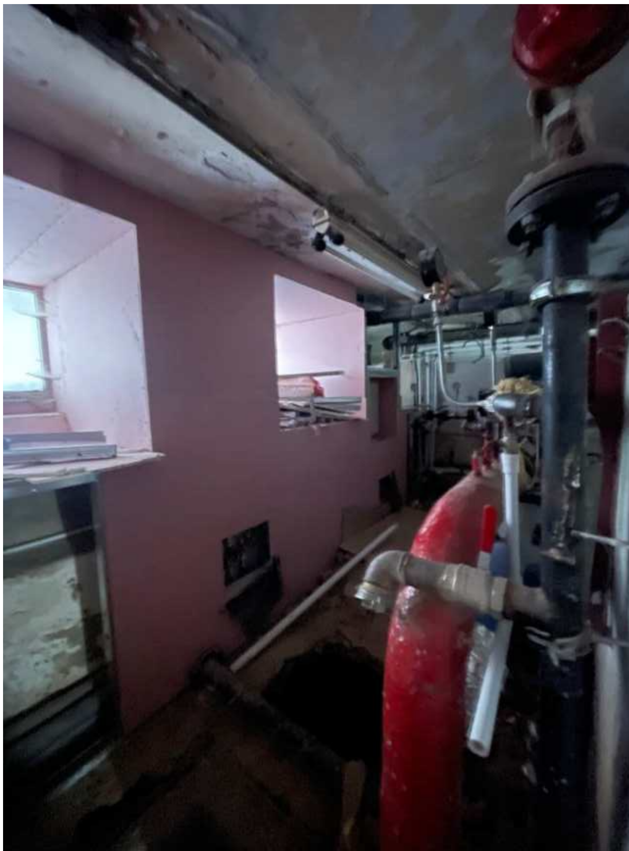
3. Фрагмент интерьера подвала.
