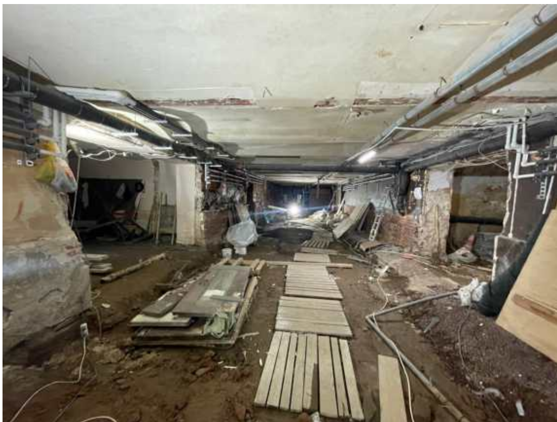
8. Фрагмент интеръера подвала.
