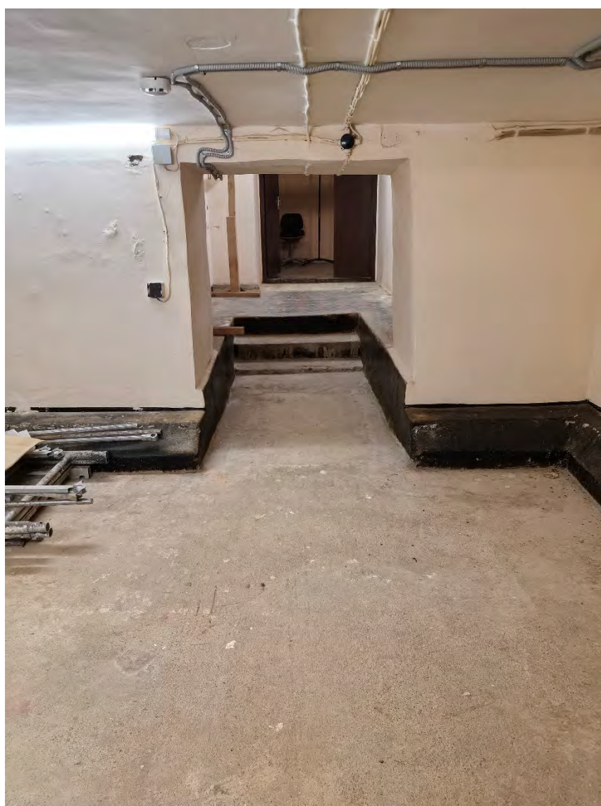
10. Объект культурного наследия федерального значения «Общество кредитное городское Санкт-Петербургское с дворовым флигелем», по адресу: Санкт-Петербург, пл. Островского, д. 7, лит. А (Островского пл., 7). Помещение подвала. Дата съемки: 20.03.2026г.
