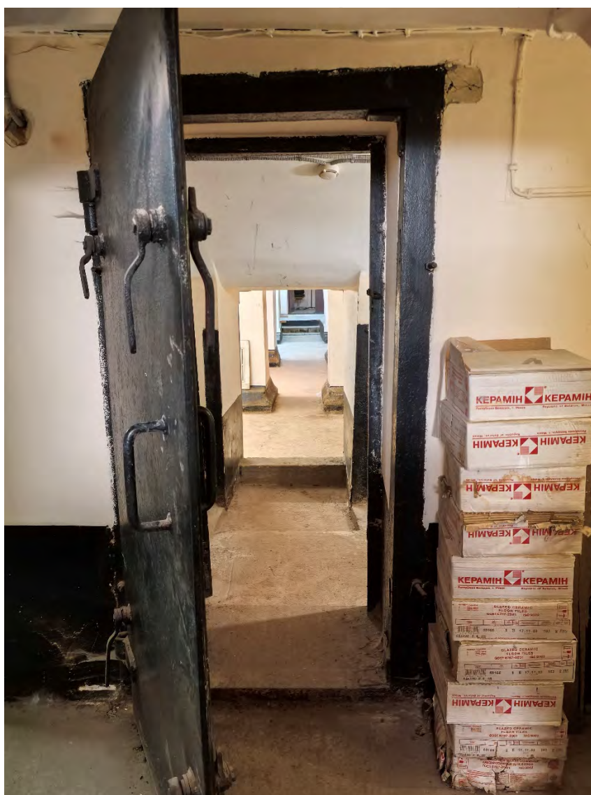
15. Объект культурного наследия федерального значения «Общество кредитное городское Санкт-Петербургское с дворовым флигелем», по адресу: Санкт-Петербург, пл. Островского, д. 7, лит. А (Островского пл., 7). Помещение подвала. Дата съемки: 20.03.2026г.
