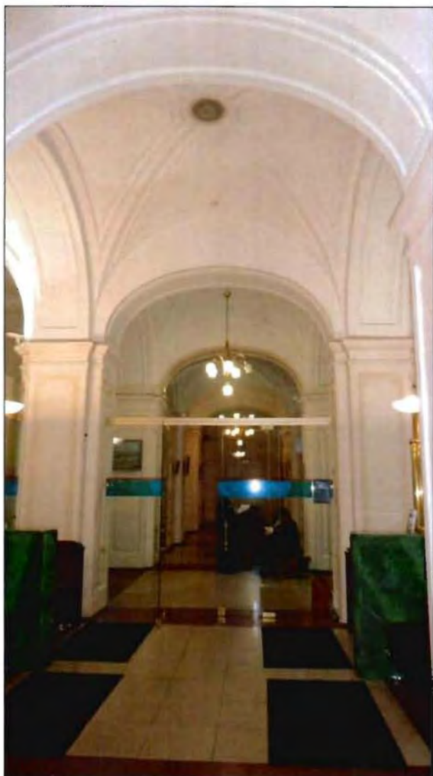
11. Своды в уровне второго этажа.
