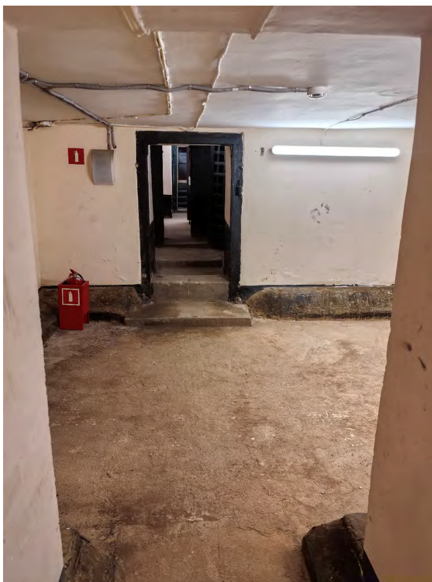
12. Объект культурного наследия федерального значения «Общество кредитное городское Санкт-Петербургское с дворовым флигелем», по адресу: Санкт-Петербург, пл. Островского, д. 7, лит. А (Островского пл., 7). Помещение подвала. Дата съемки: 20.03.2026г.
