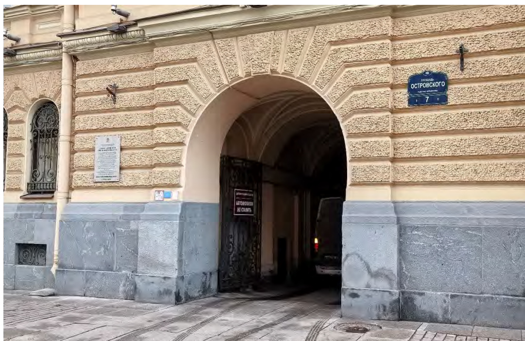
2. Объект культурного наследия федерального значения «Общество кредитное городское Санкт-Петербургское с дворовым флигелем», по адресу: Санкт-Петербург, пл. Островского, д. 7, лит. А (Островского пл., 7). Проездная арка. Дата съемки: 20.03.2026г.
