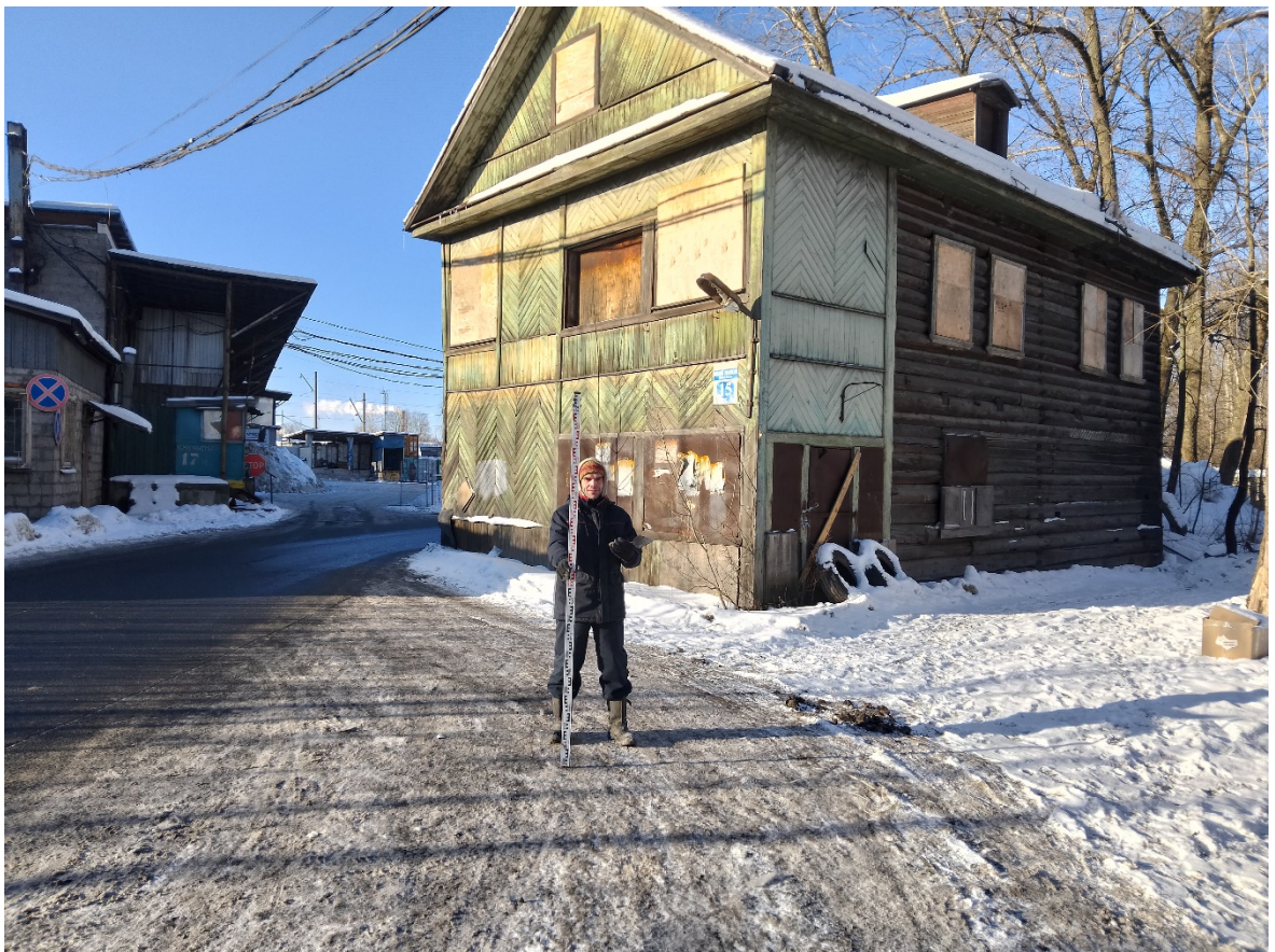
Рис. 17. СПб-2026. Продолжение Б. Смоленского проспекта. Точка фотофиксации 2, вид с востока.
