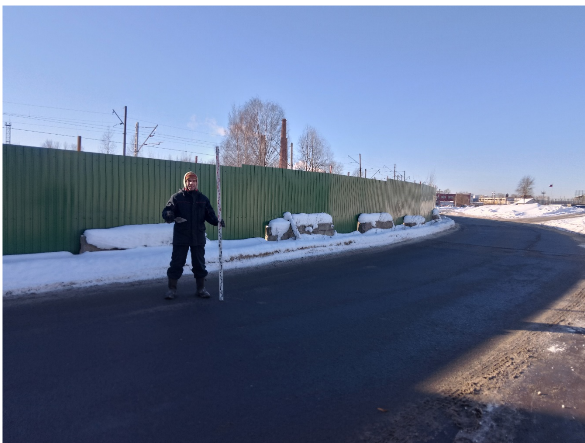
Рис. 23. СПб-2026. Продолжение Б. Смоленского проспекта. Точка фотофиксации 4, вид с востока.
