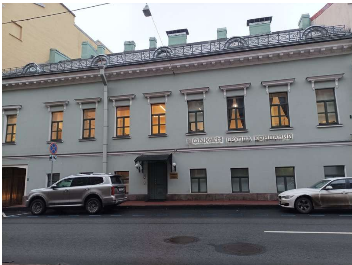
1. Лицевой фасад по Шпалерной улице
