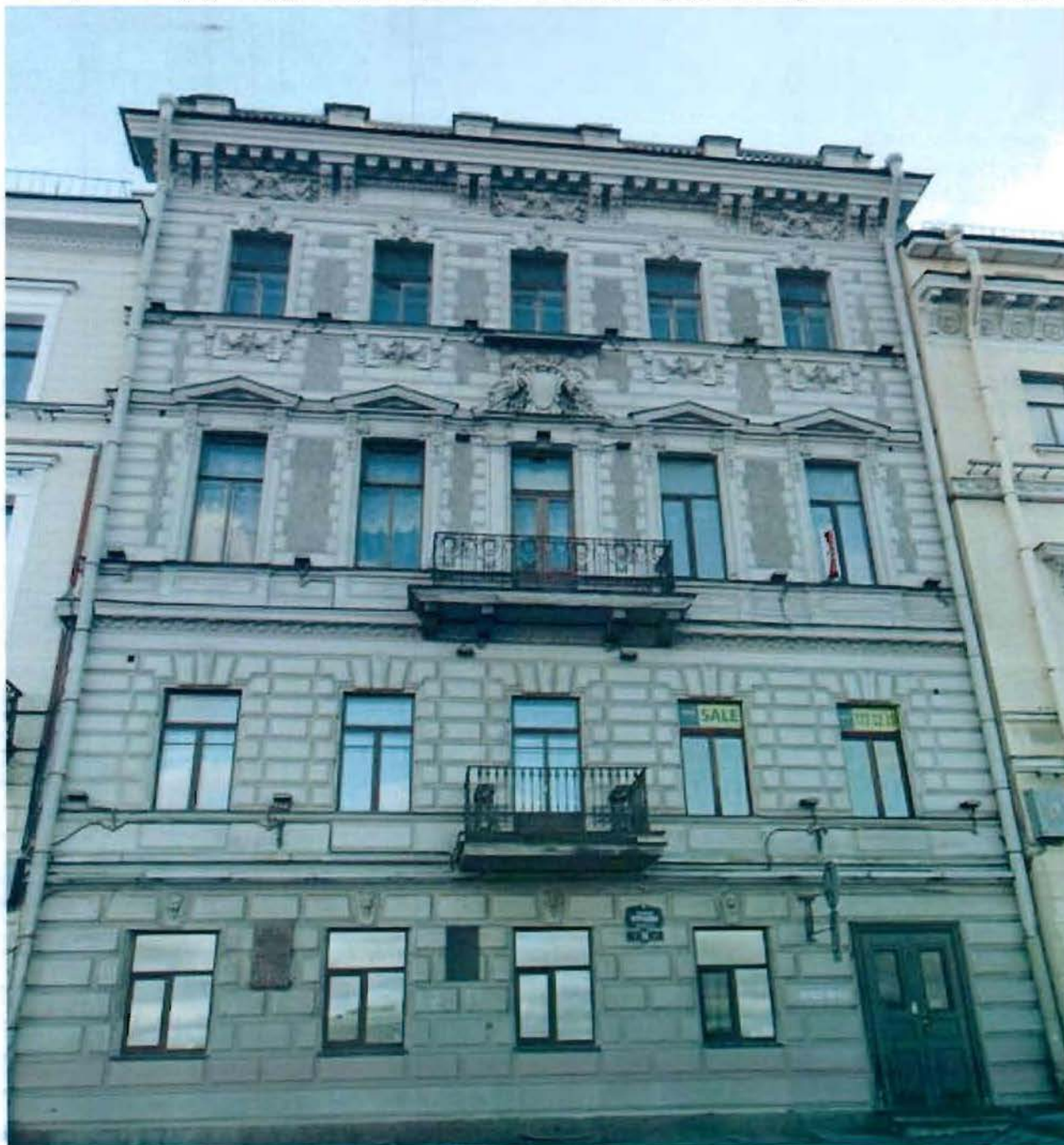
1. Фасад со стороны набережной Кутузова.
